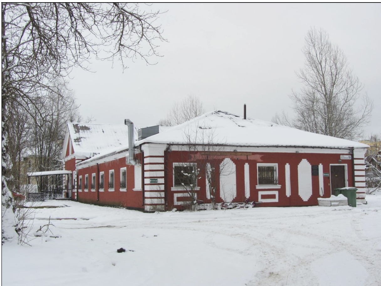
2. Служебное здание (Манежная, 8А).Общий вид с Манежной улицы.
