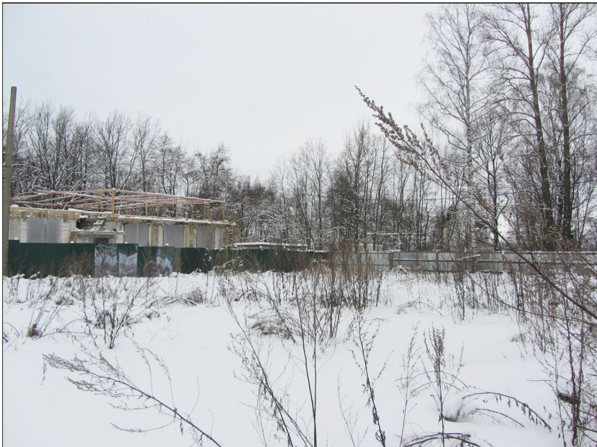
21. Выявленный объект культурного наследия «Служебное здание». Общий вид участка.
