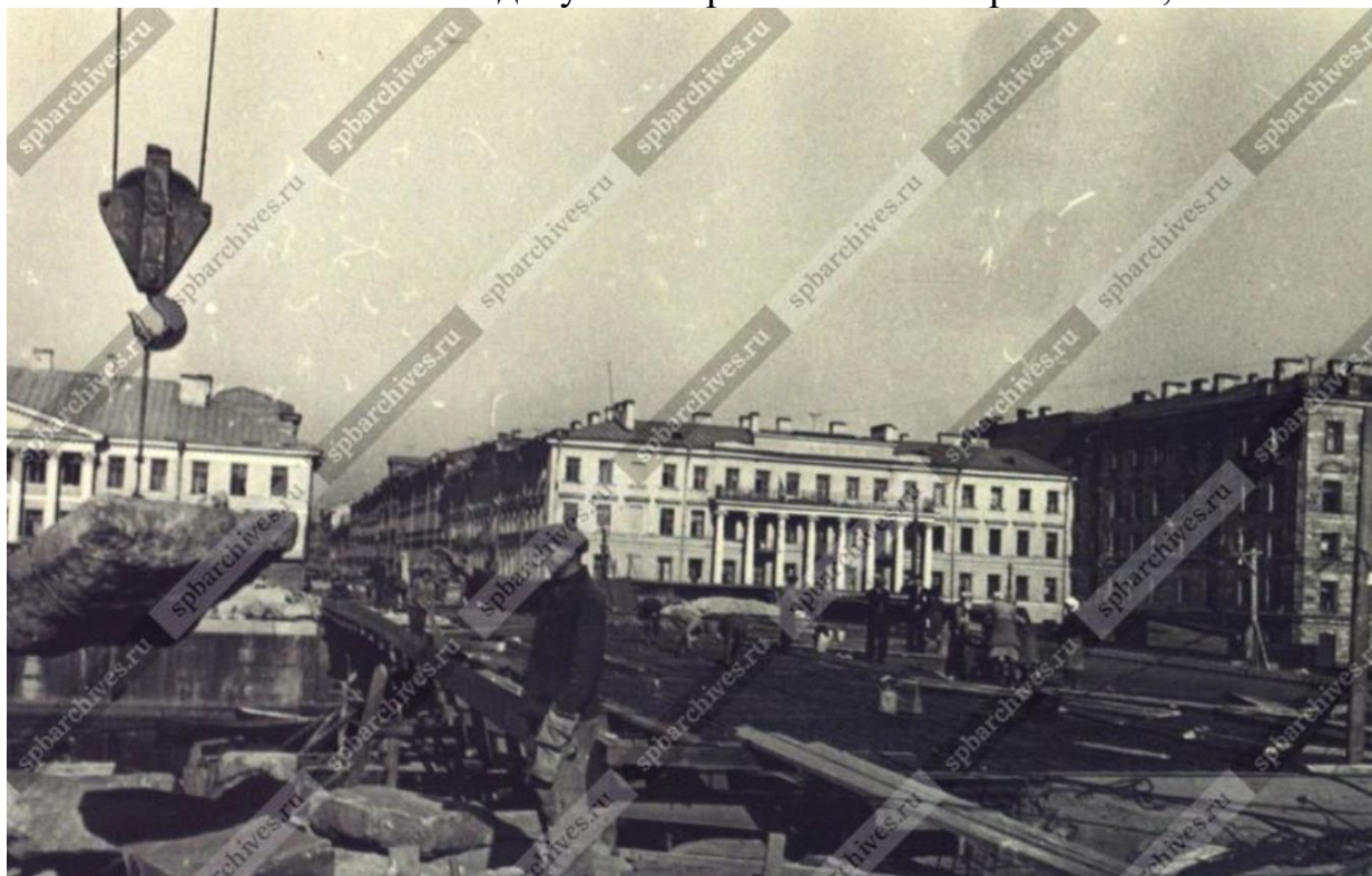
22. Реконструкция Семеновского моста через р. Фонтанку. ЦГАКФФД СПб. Фотодокумент Ар 76372. Сентябрь 1949 г.;
