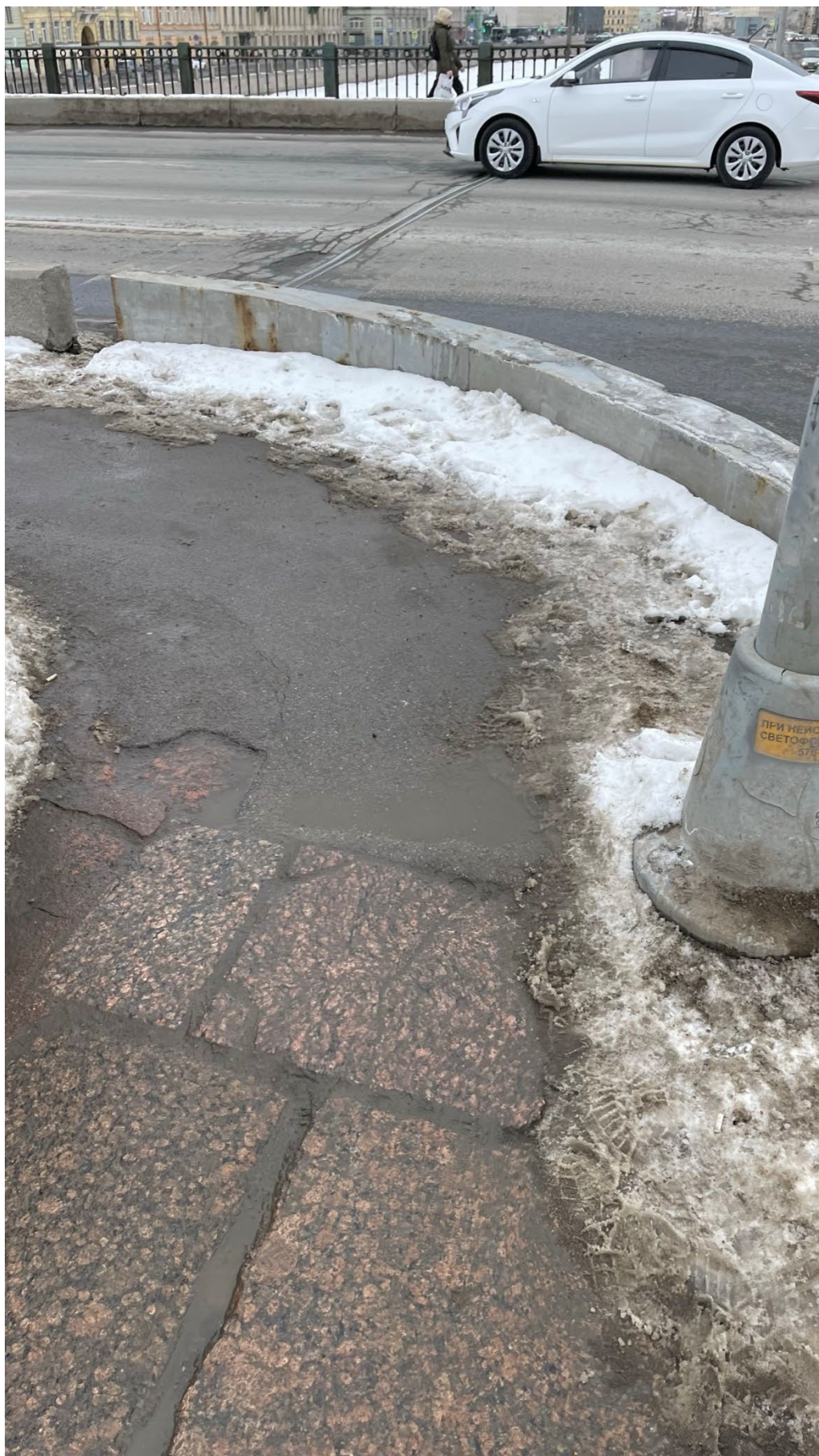
16. Левобережный верховой тротуар у Семеновского моста;
