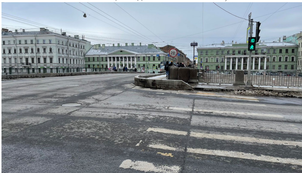
11.Левобережный верховой тротуар у Семеновского моста;
