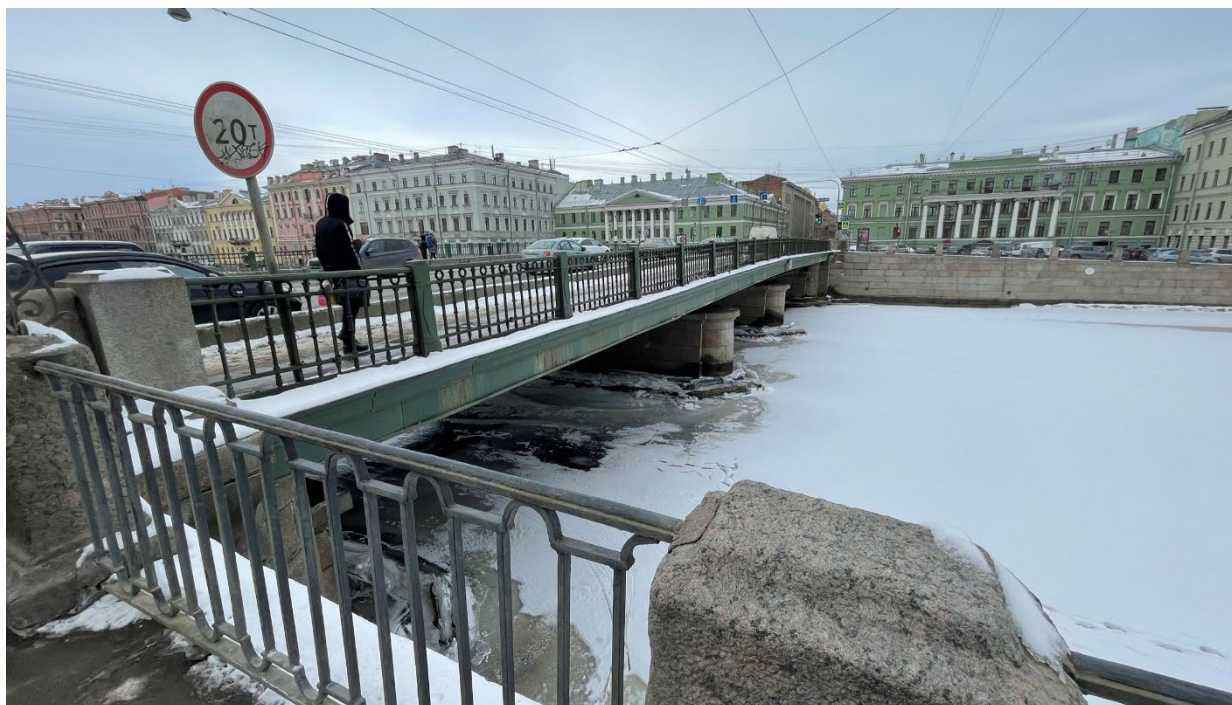
10.Общий вид Семеновского моста;
