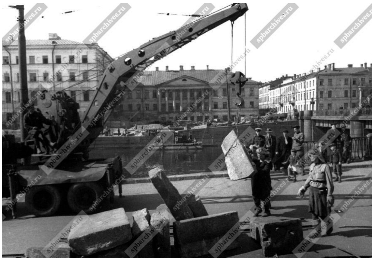
19. Разборка набережной на месте укладки готового дюкера через реку Фонтанку у Семеновского моста. ЦГАКФФД СПб. Фотодокумент Ар 14474. 7 мая 1947 г.;
