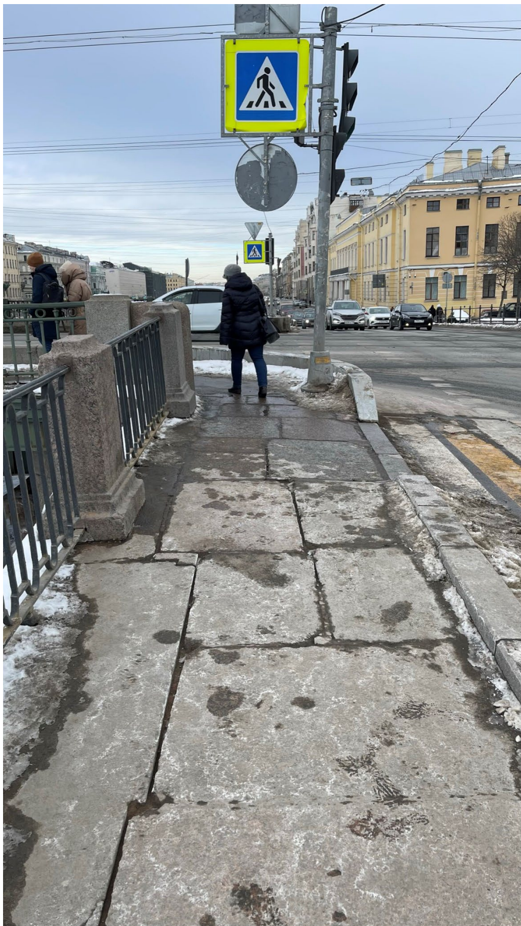
15. Левобережный верховой тротуар у Семеновского моста;
