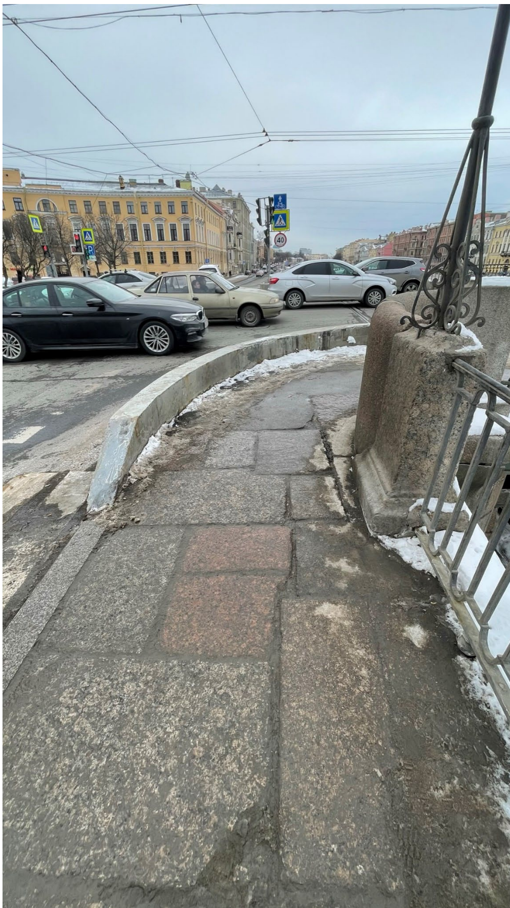
8. Левобережный верховой тротуар у Семеновского моста;
