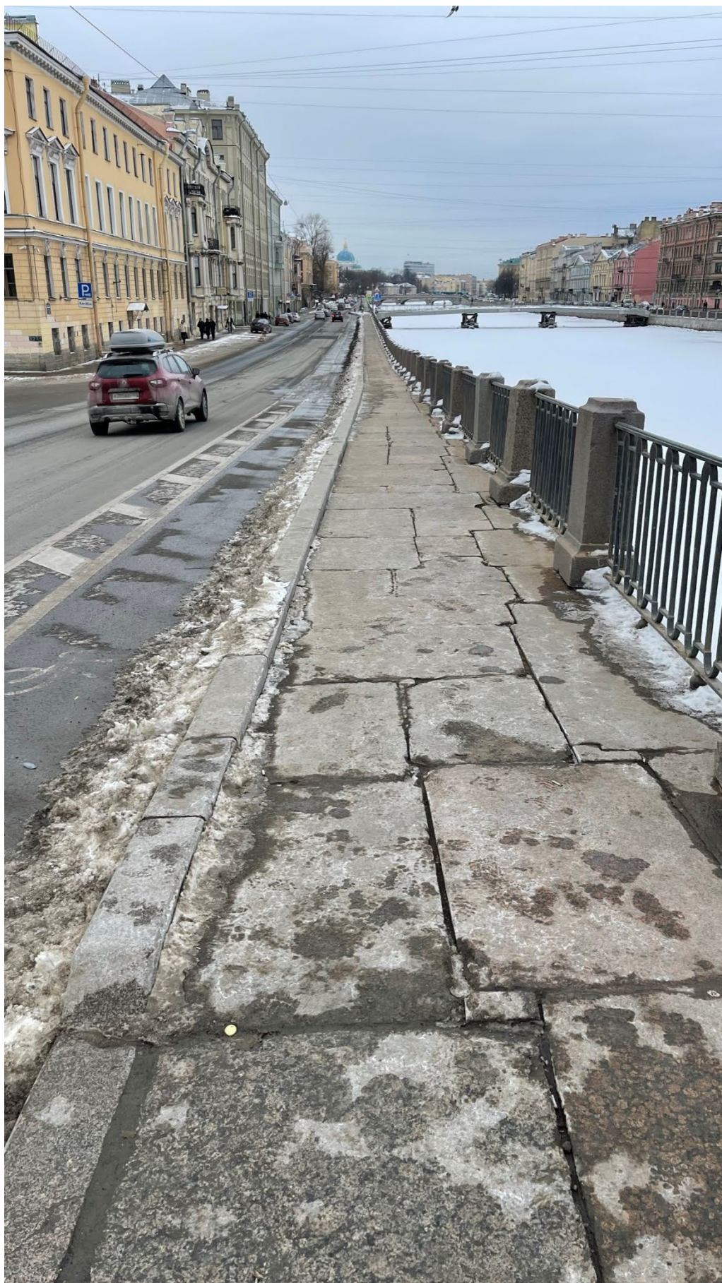
14. Левобережный верховой тротуар у Семеновского моста;
