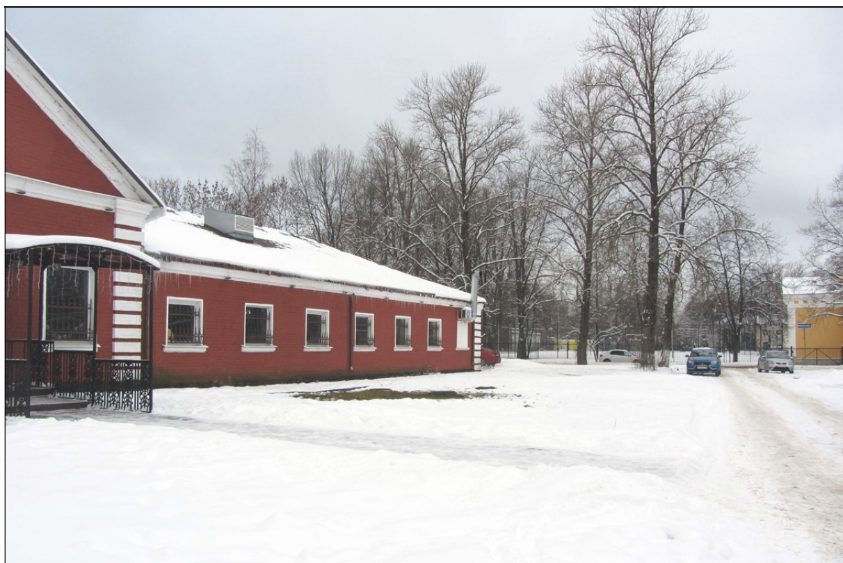
6. Выявленный объект культурного наследия «Служебное здание». Общий вид в сторону Экзерциргауза лейб-гвардии Волынского полка. Слева – Служебное здание (Манежная, 8А)
