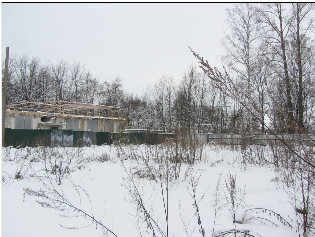
21. Выявленный объект культурного наследия «Службное здание». Общий вид участка.
