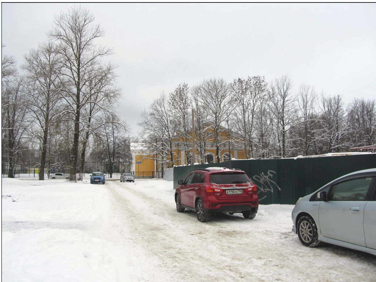
7. Выявленный объект культурного наследия «Служебное здание». Общий вид в сторону Экзерциргауза лейб-гвардии Волынского полка.
