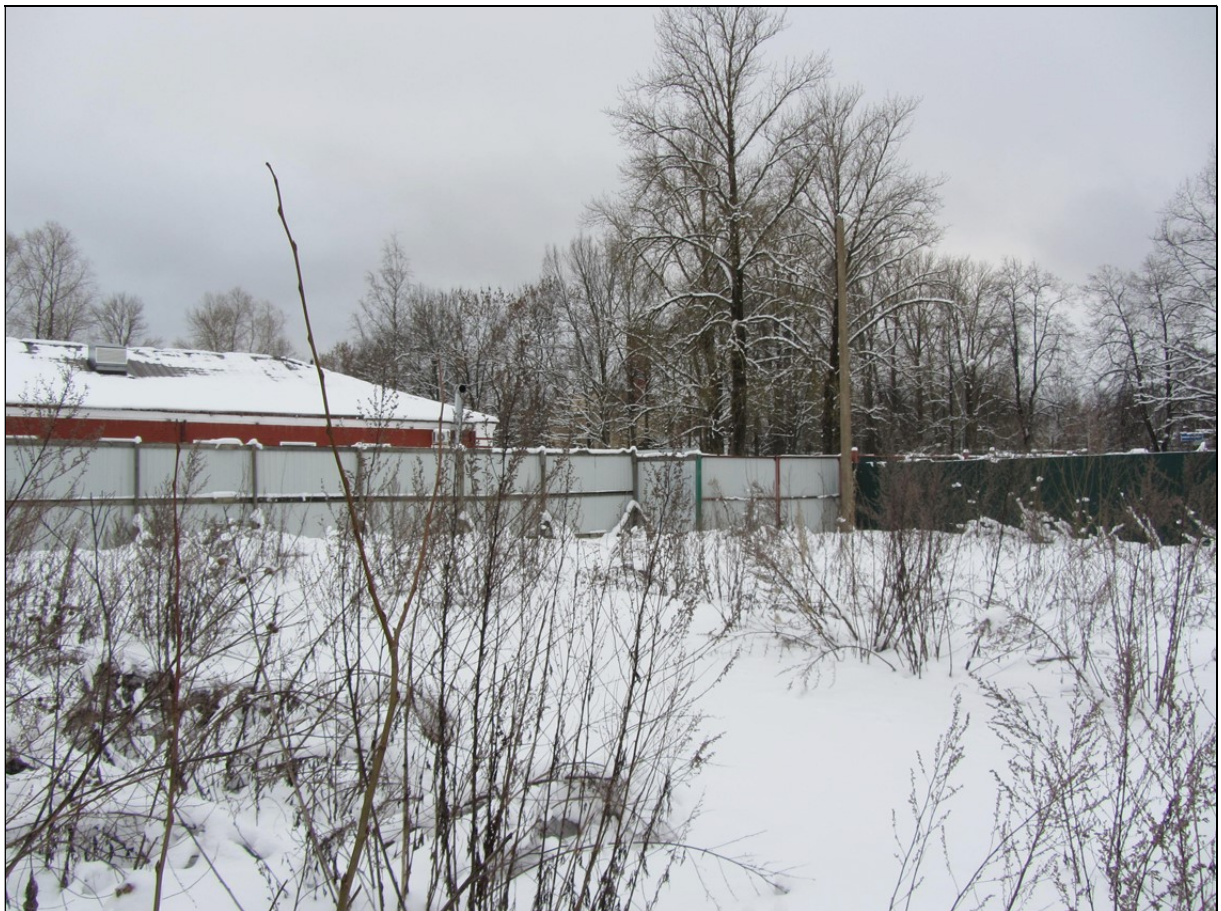
25. Выявленный объект культурного наследия «Службное здание». Общий вид участка.
