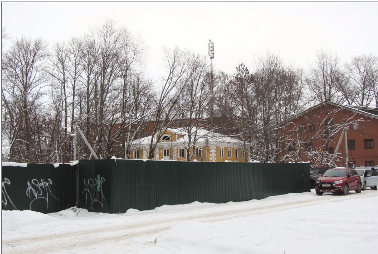
4. Выявленный объект культурного наследия «Служебное здание». Общий вид от Манежной улицы.
