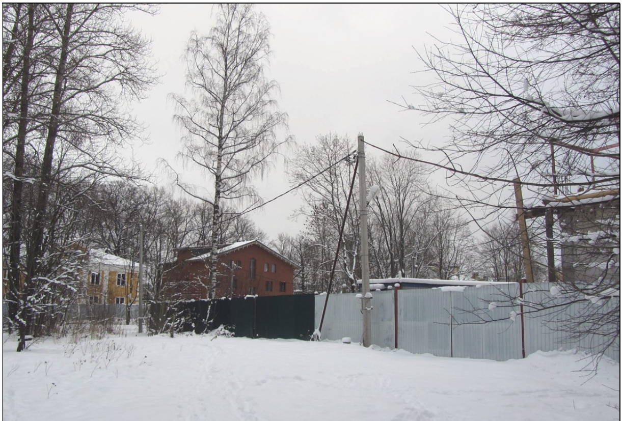
13. Выявленный объект культурного наследия «Службное здание». Общий вид с северо-запада.
