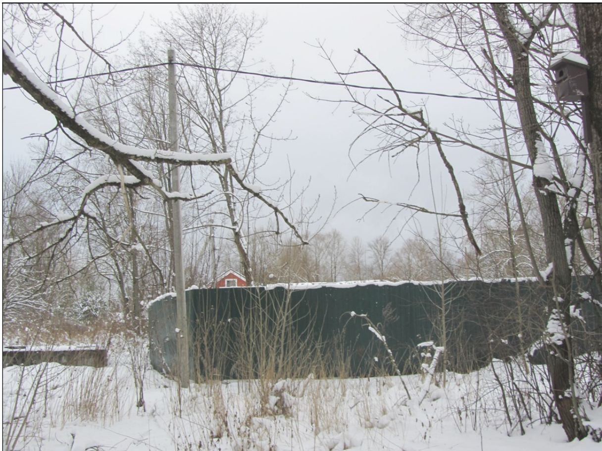
10. Выявленный объект культурного наследия «Служебное здание». Общий вид с северо-востока.
