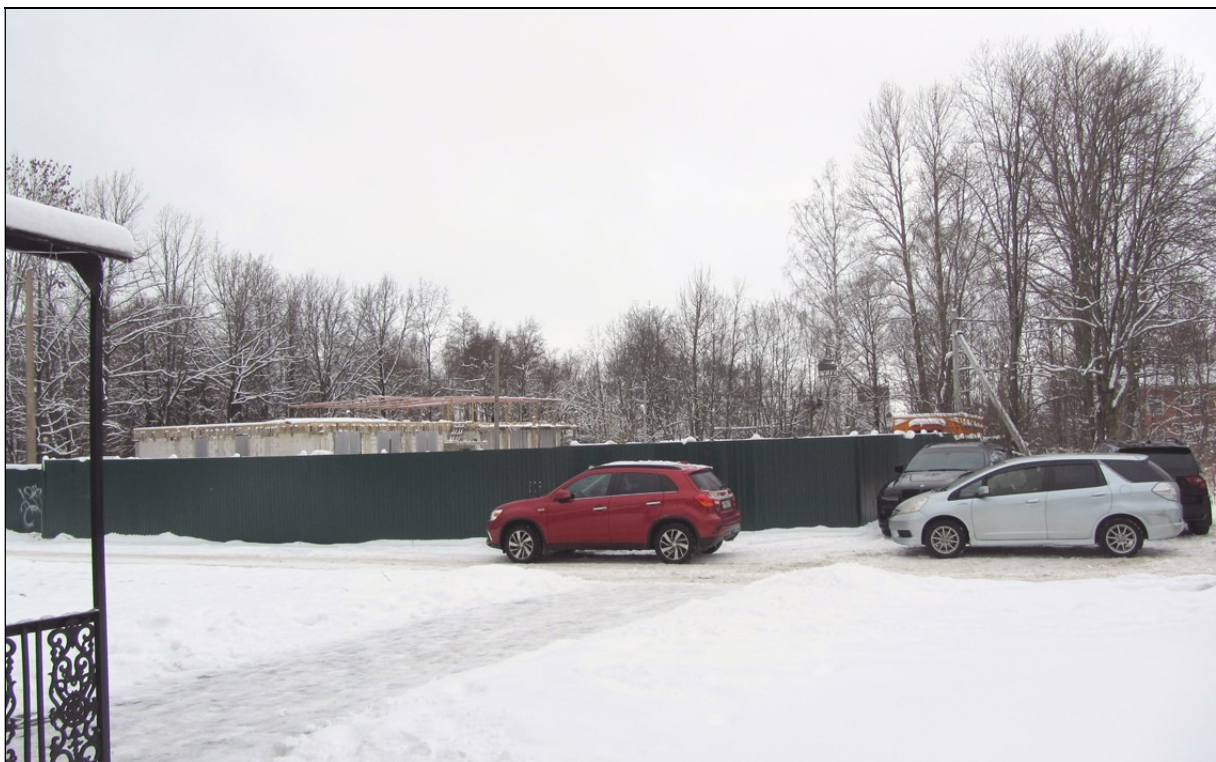
5. Выявленный объект культурного наследия «Службное здание». Общий вид с юга от Службного здания (Манежная, 8А).
