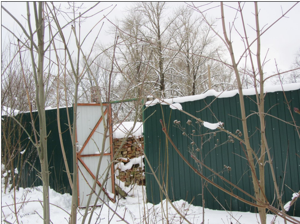
16. Выявленный объект культурного наследия «Служебное здание». Вход на участок.
