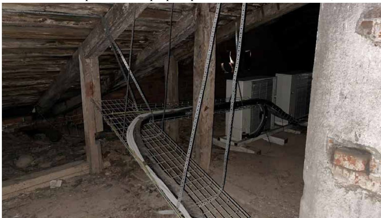
93.Фрагмент интерьера чердака в южной части здания;
