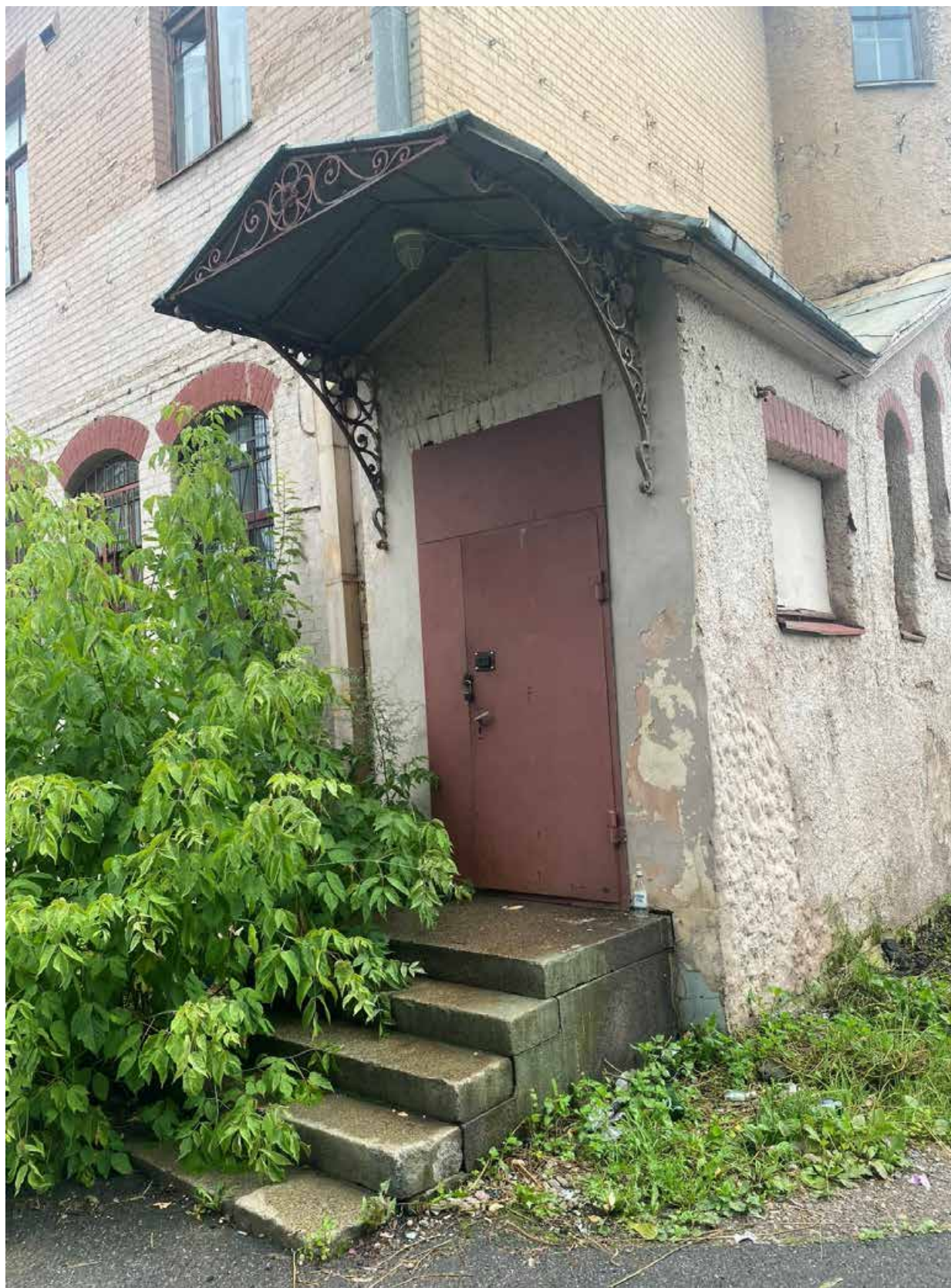
12. Входная дверь на южную лестницу;
