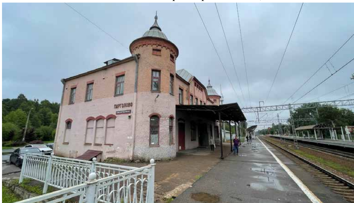
4. Вид на северо-западный фасад здания;
