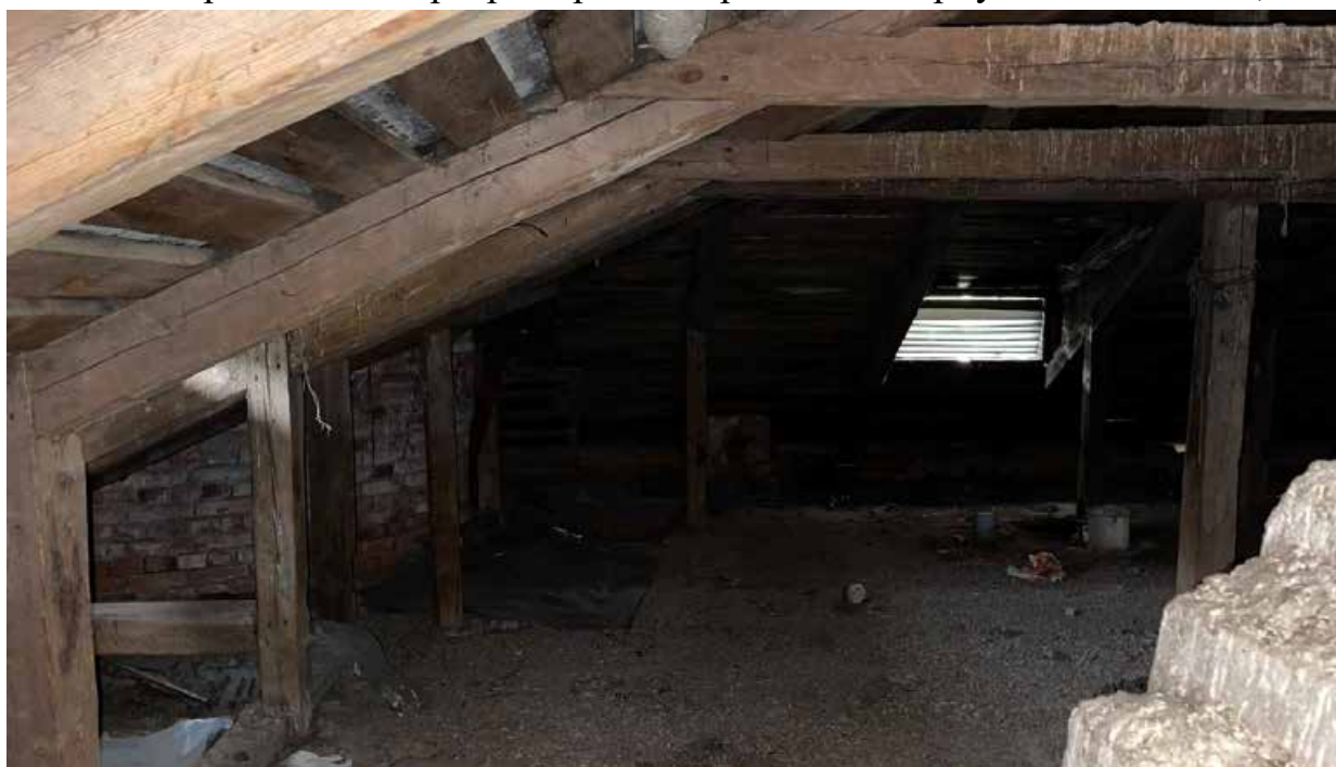
97.Северная часть чердака;
