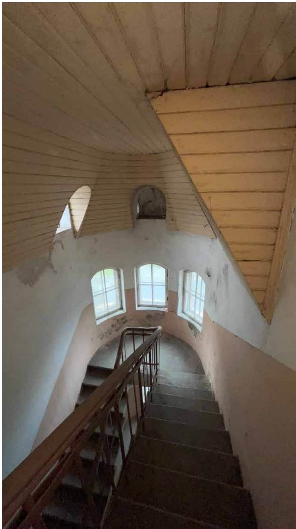
107. Вид на лестницу в северной части здания;
