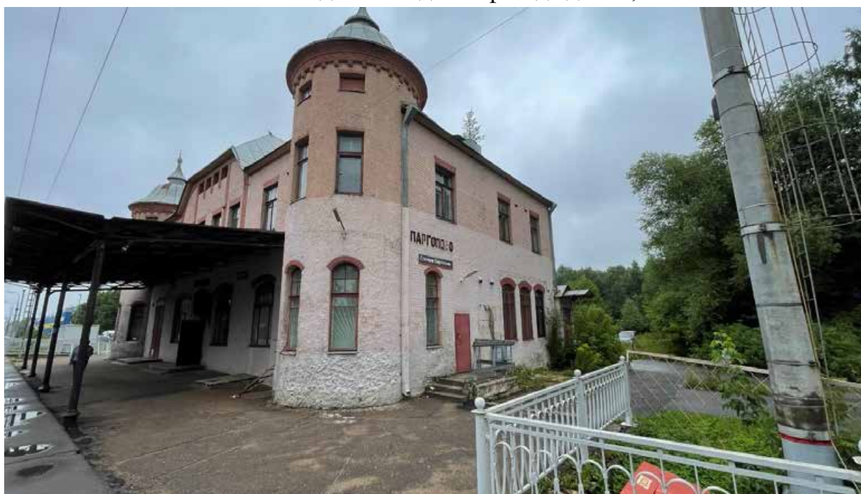
6. Вид на юго-восточный фасад здания;
