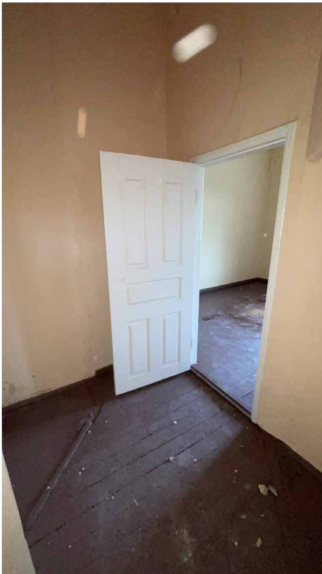
66. Фрагмент интерьера коридора;
