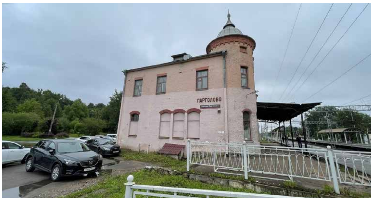
3. Вид на северный фасад здания;
