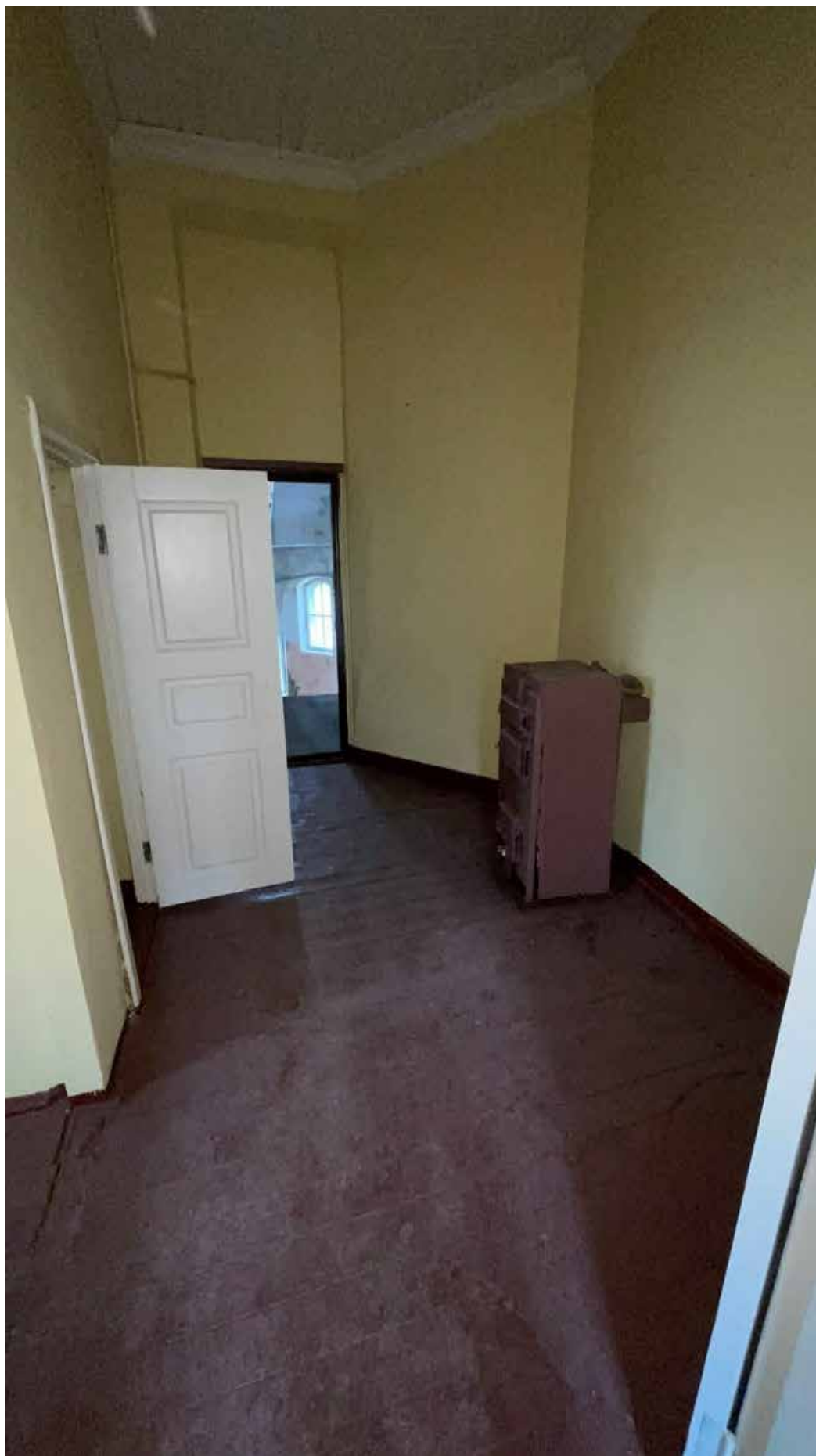
81.Фрагмент интерьера коридора;
