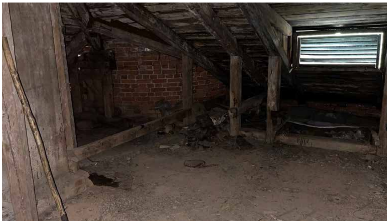
92.Фрагмент интерьера чердака в южной части здания;
