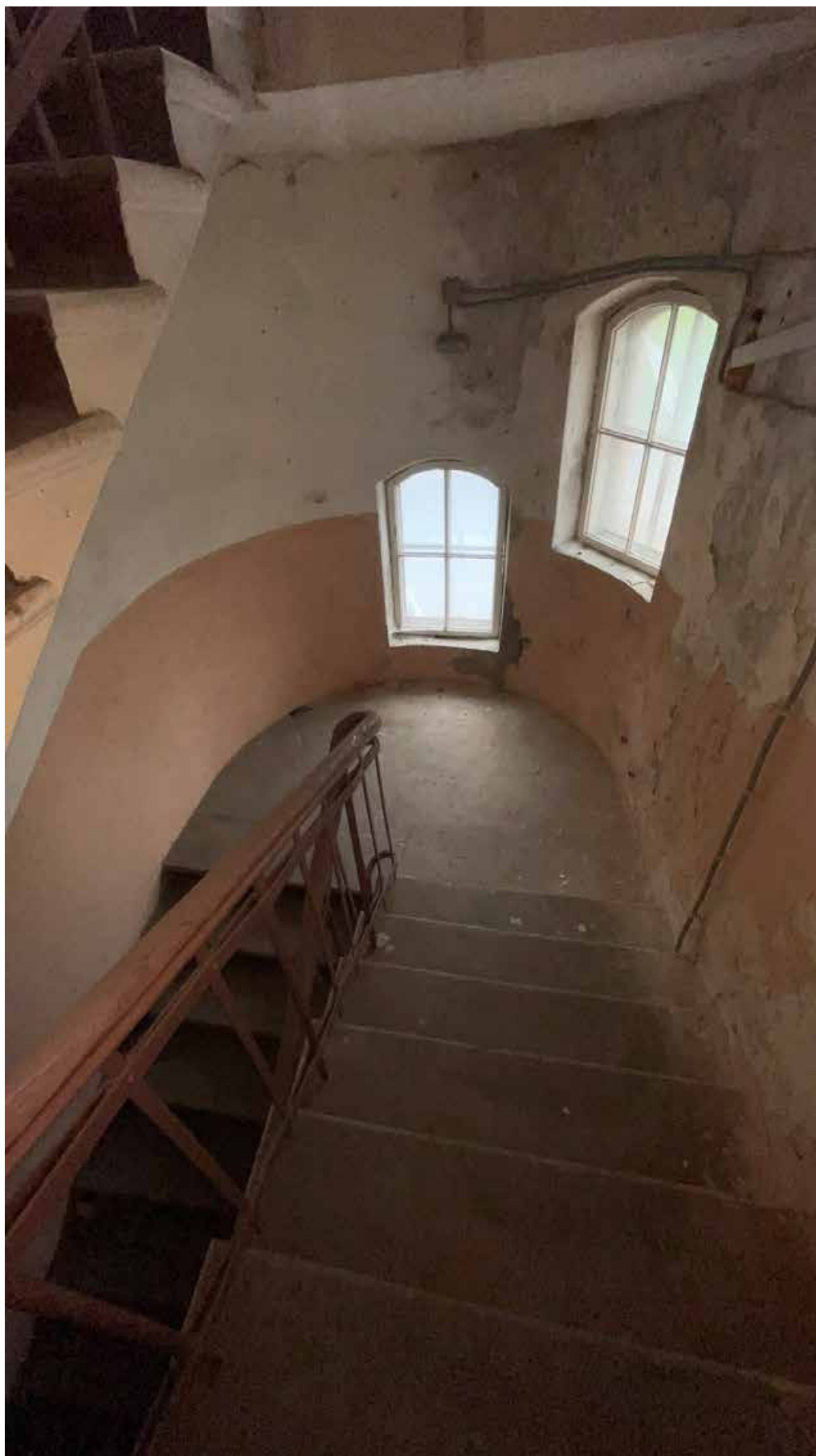
90. Вид на лестницу в северной части здания;
