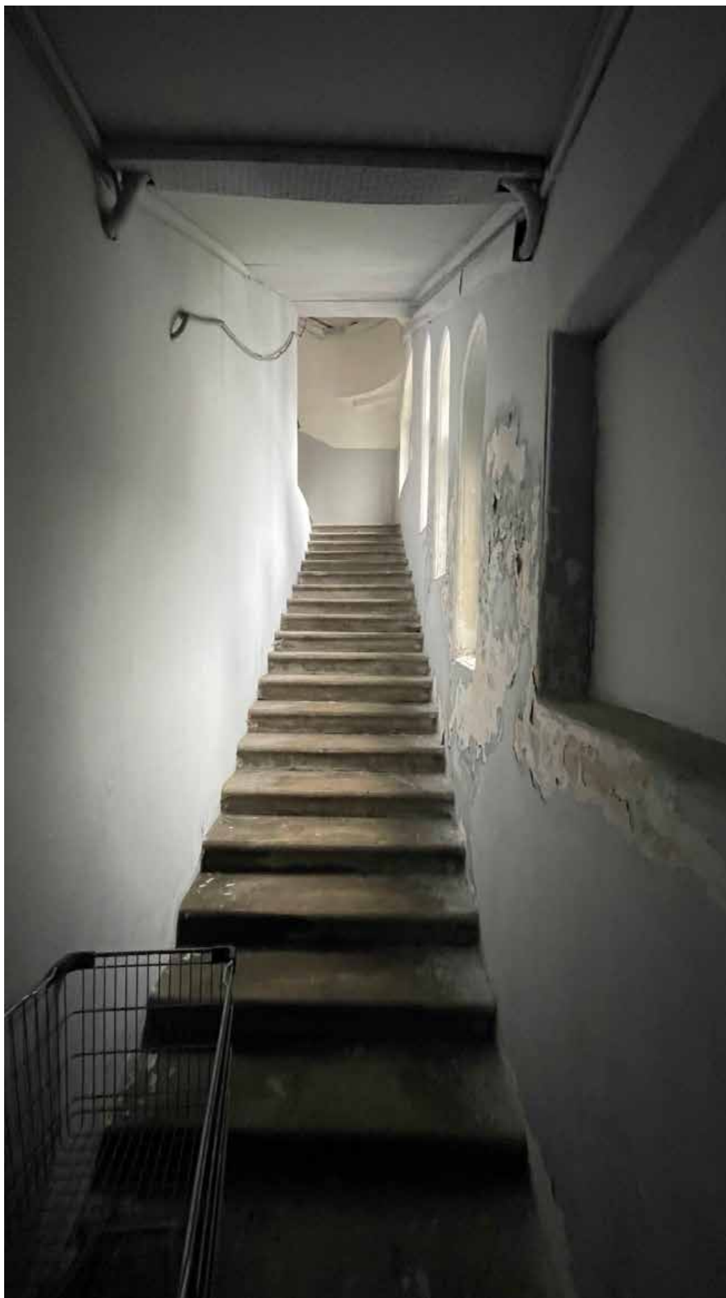
35. Вид на южную лестницу;
