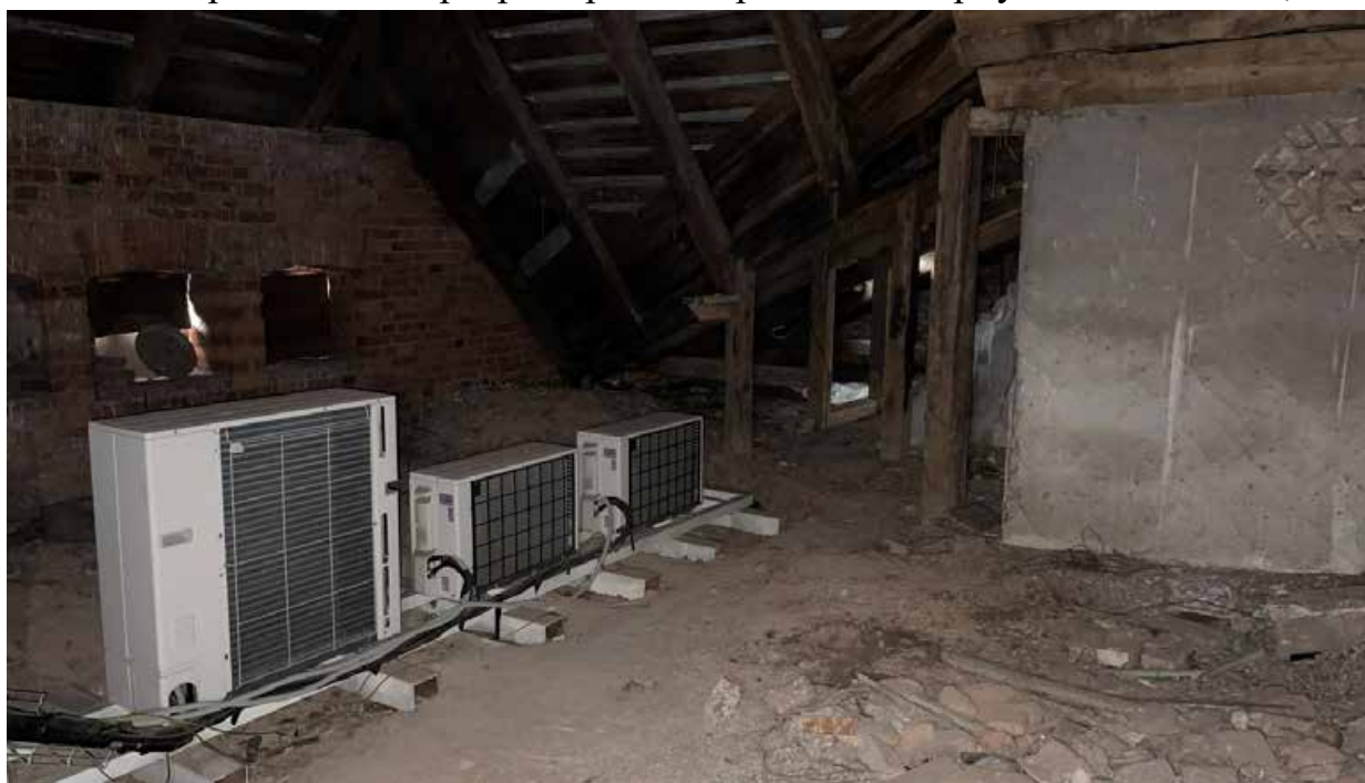
95.Фрагмент интерьера чердака. Проход в северную часть здания;
