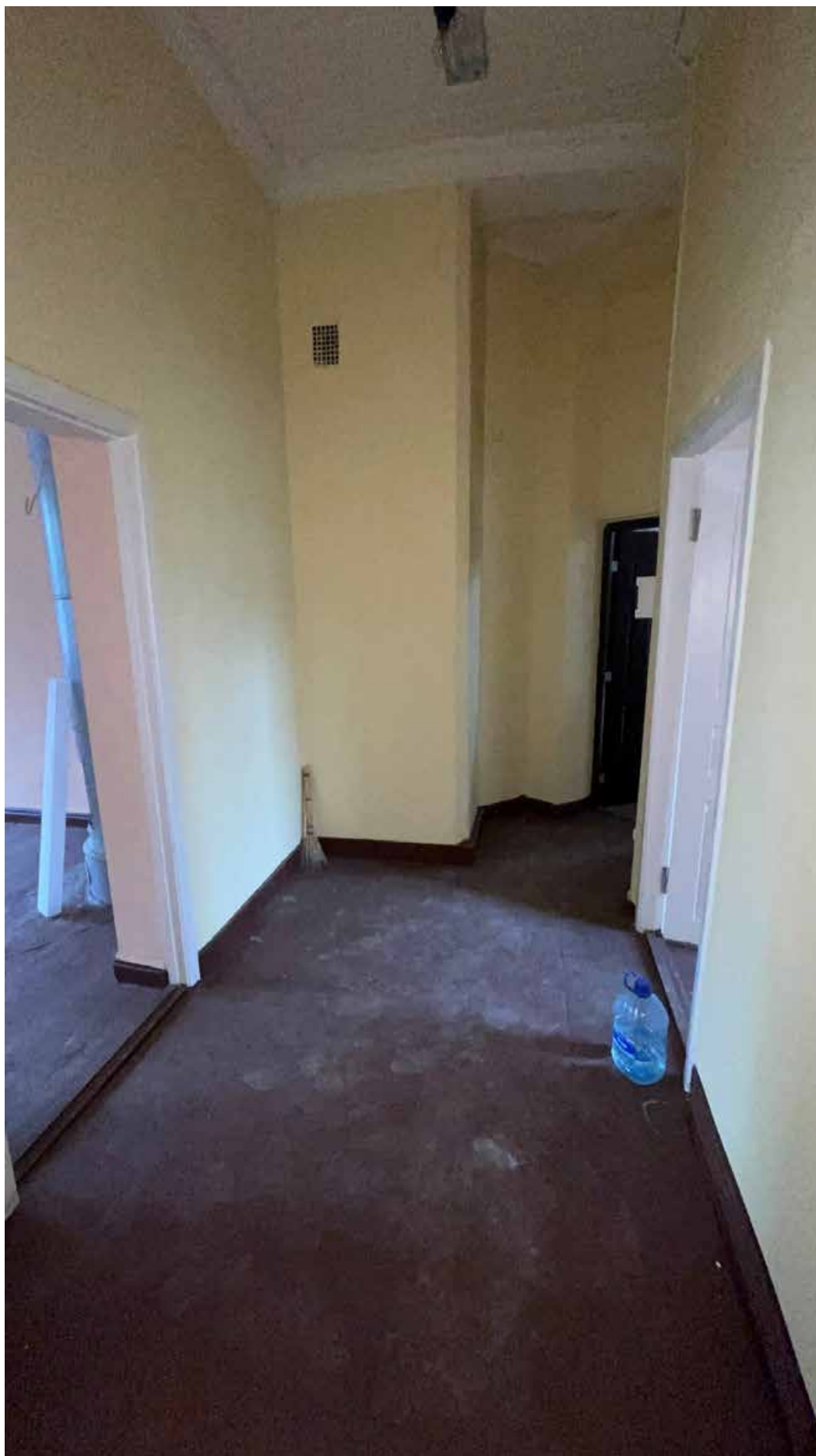
86. Фрагмент интерьера коридора;
