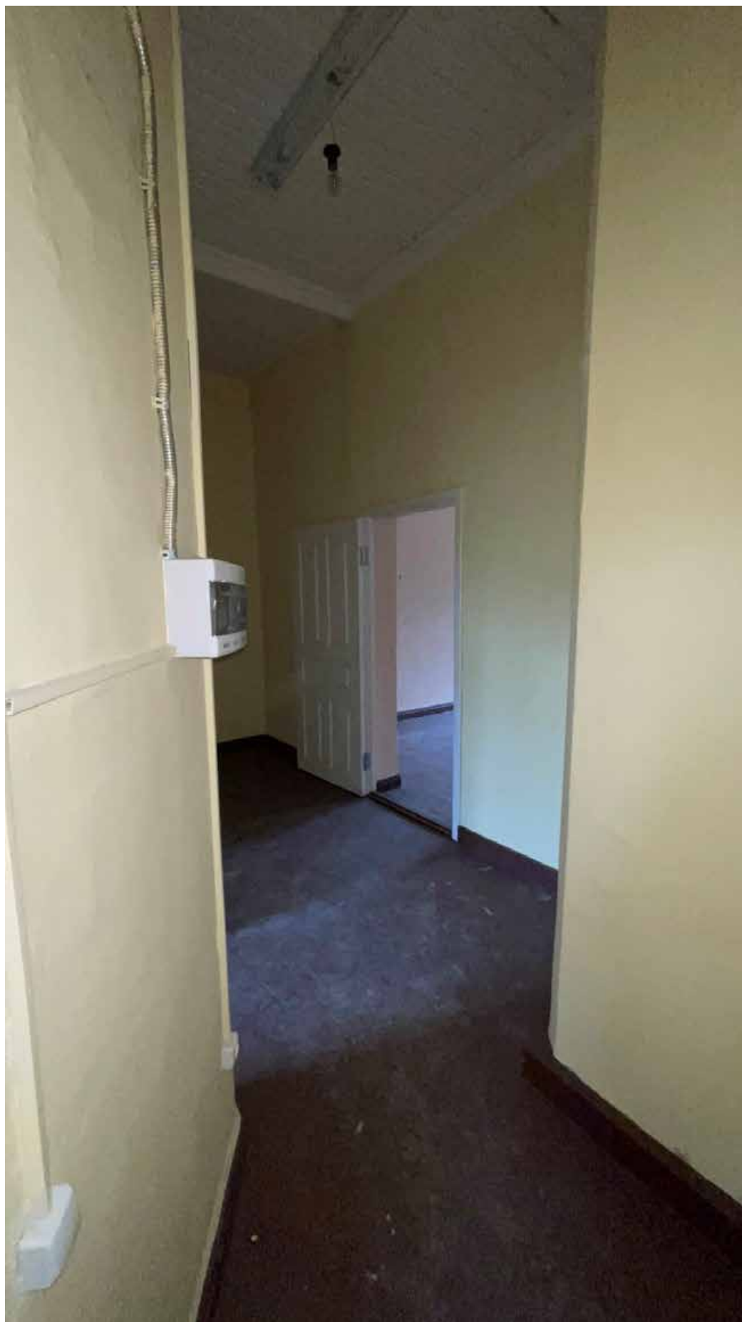
82. Фрагмент интерьера коридора;
