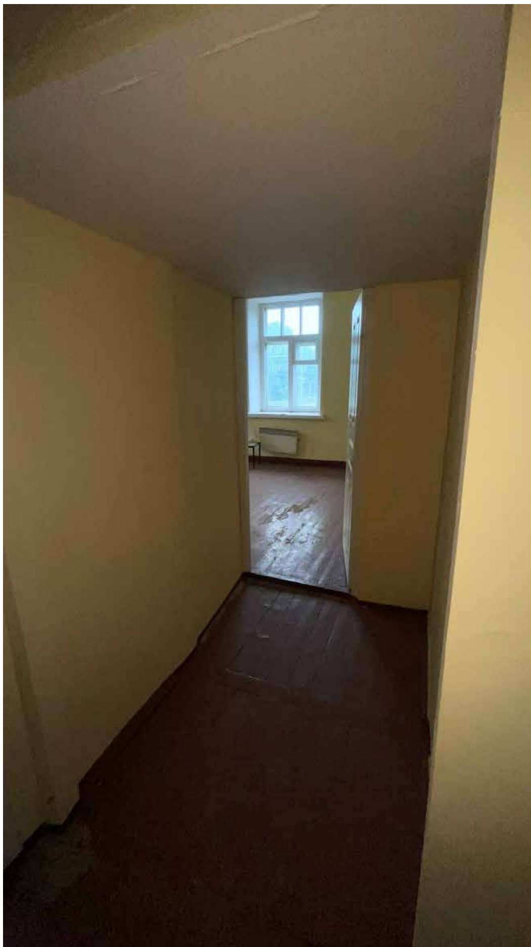
75. Фрагмент интерьера коридора;
