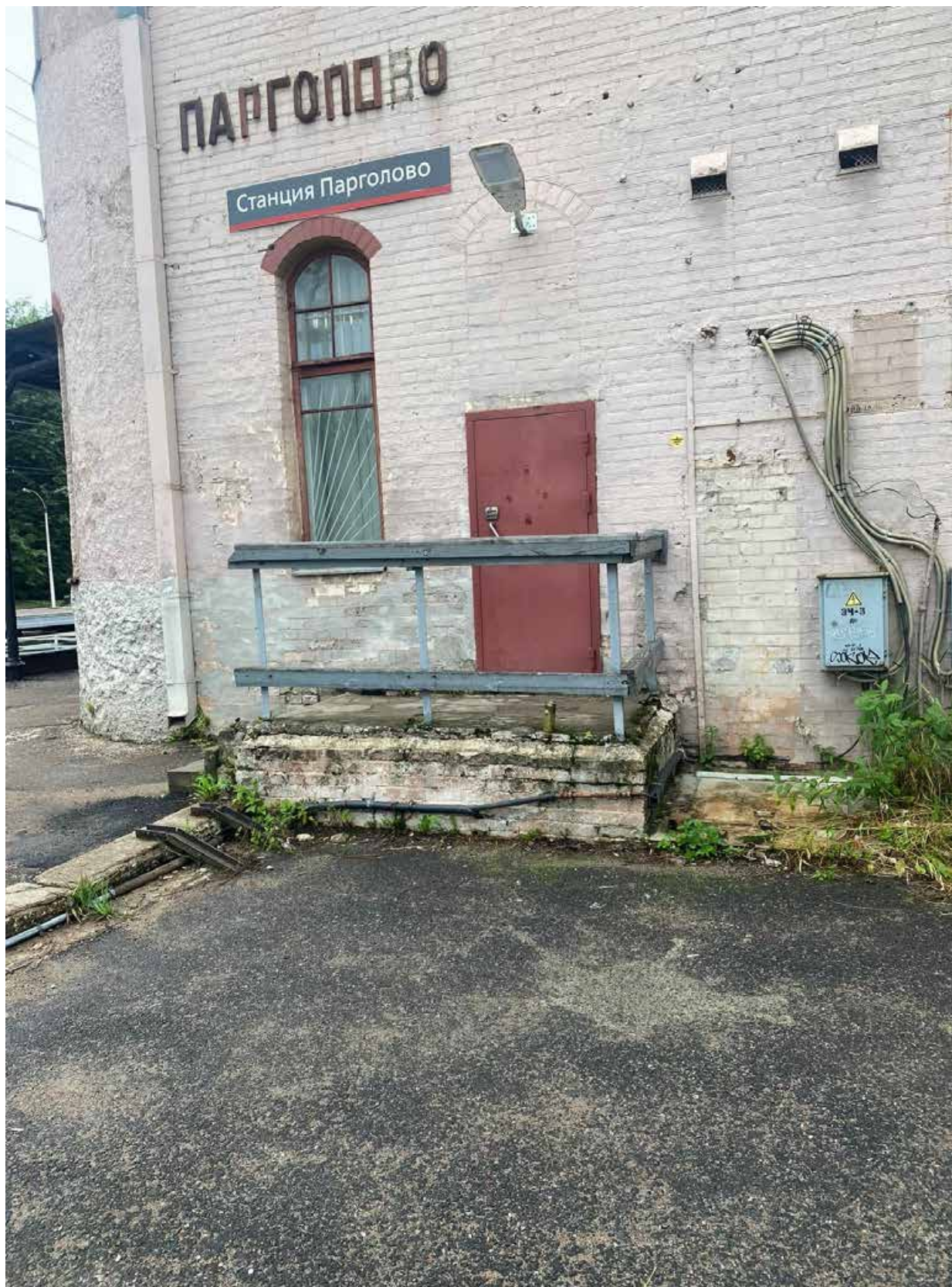
13.Общий вид станции Парголово;
