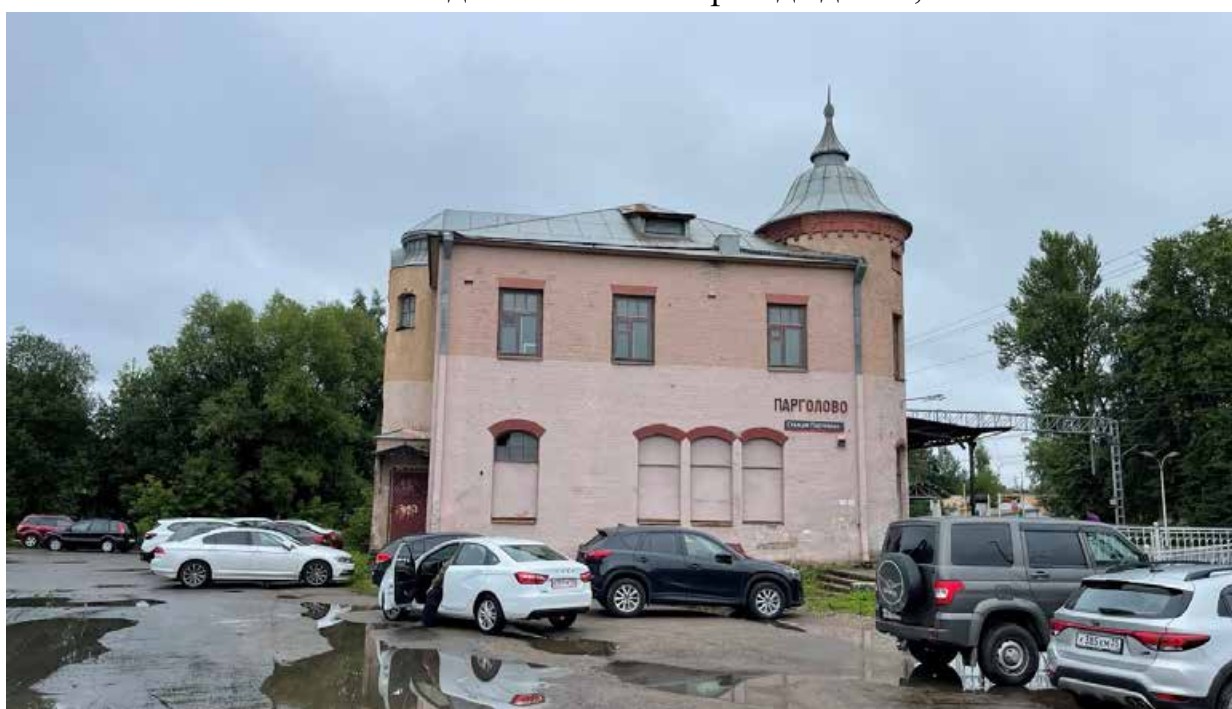
2. Вид на северный фасад здания;
