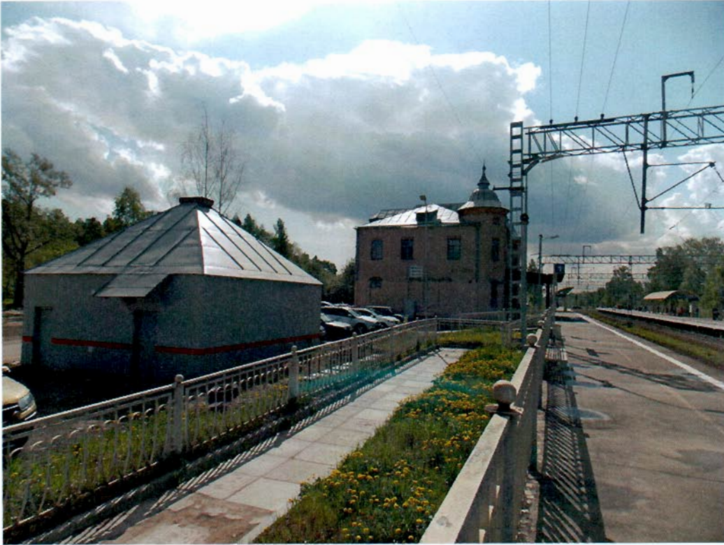
10. Служебный корпус, здание вокзала (вид с северо-запада).
