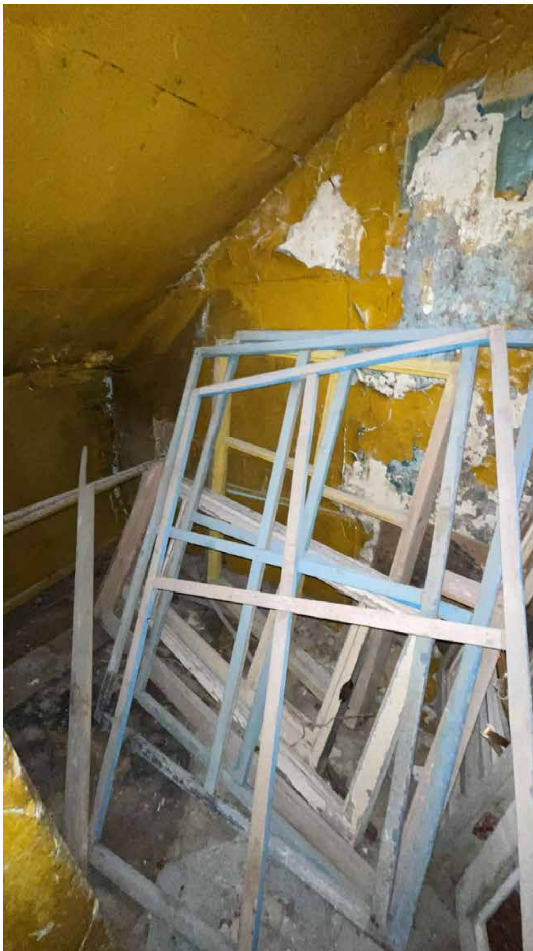
33. Вид на помещение под северной лестницей;
