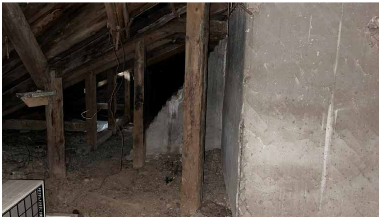
96.Фрагмент интерьера чердака. Проход в северную часть здания;
