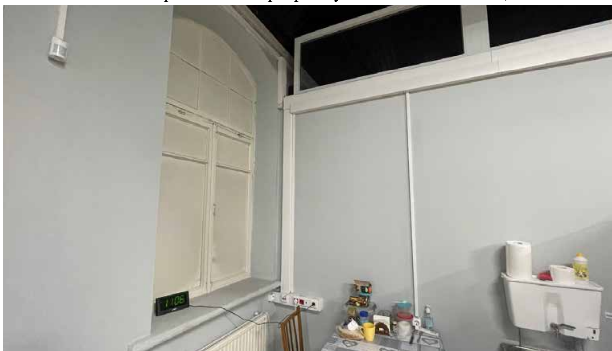
22.Фрагмент интерьера служебного помещения;
