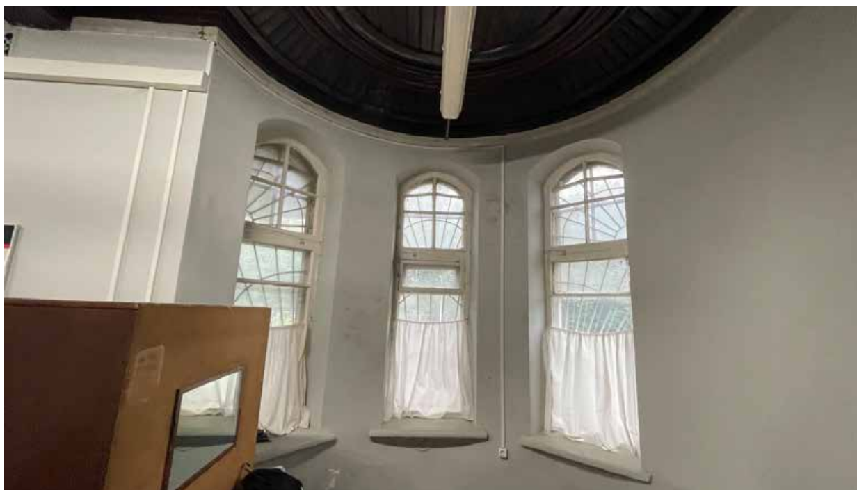
21.Фрагмент интерьера служебного помещения;
