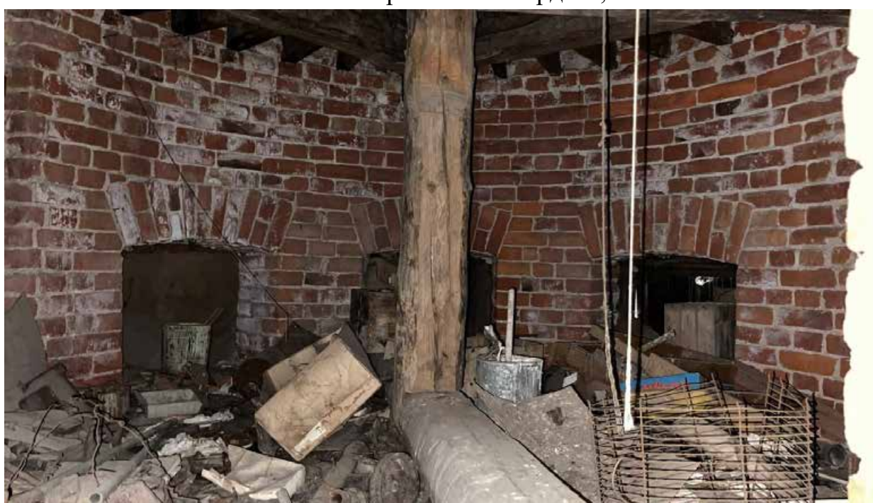
99. Фрагмент интерьера внутри башни;
