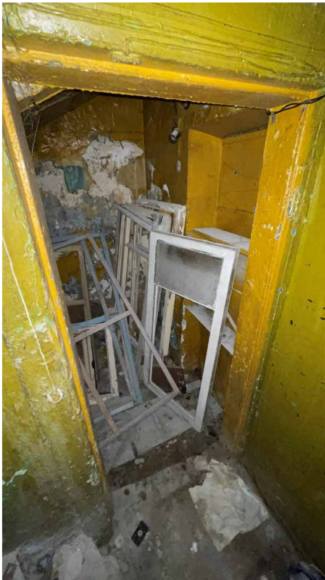
32. Вид на помещение под северной лестницей;
