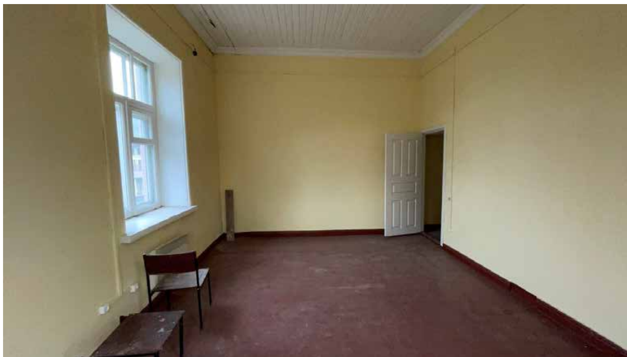
78.Общий вид комнаты на втором этаже;
