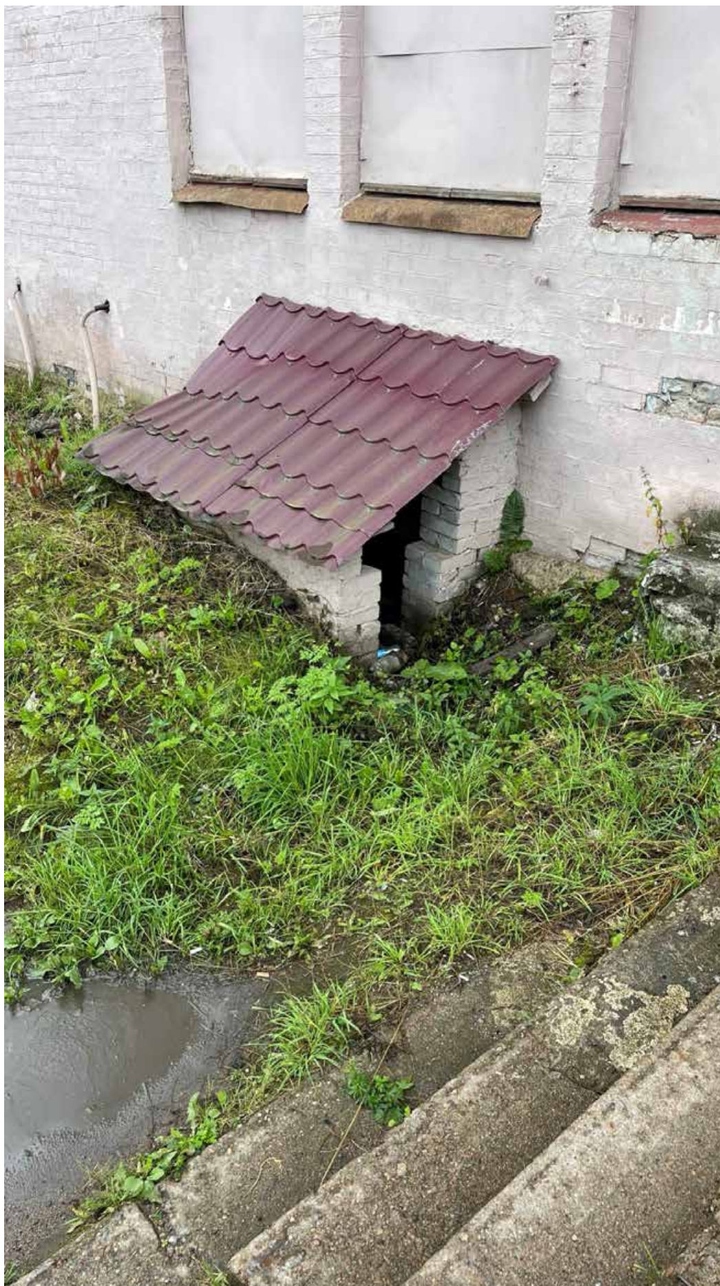
11.Общий вид станции Парголово;
