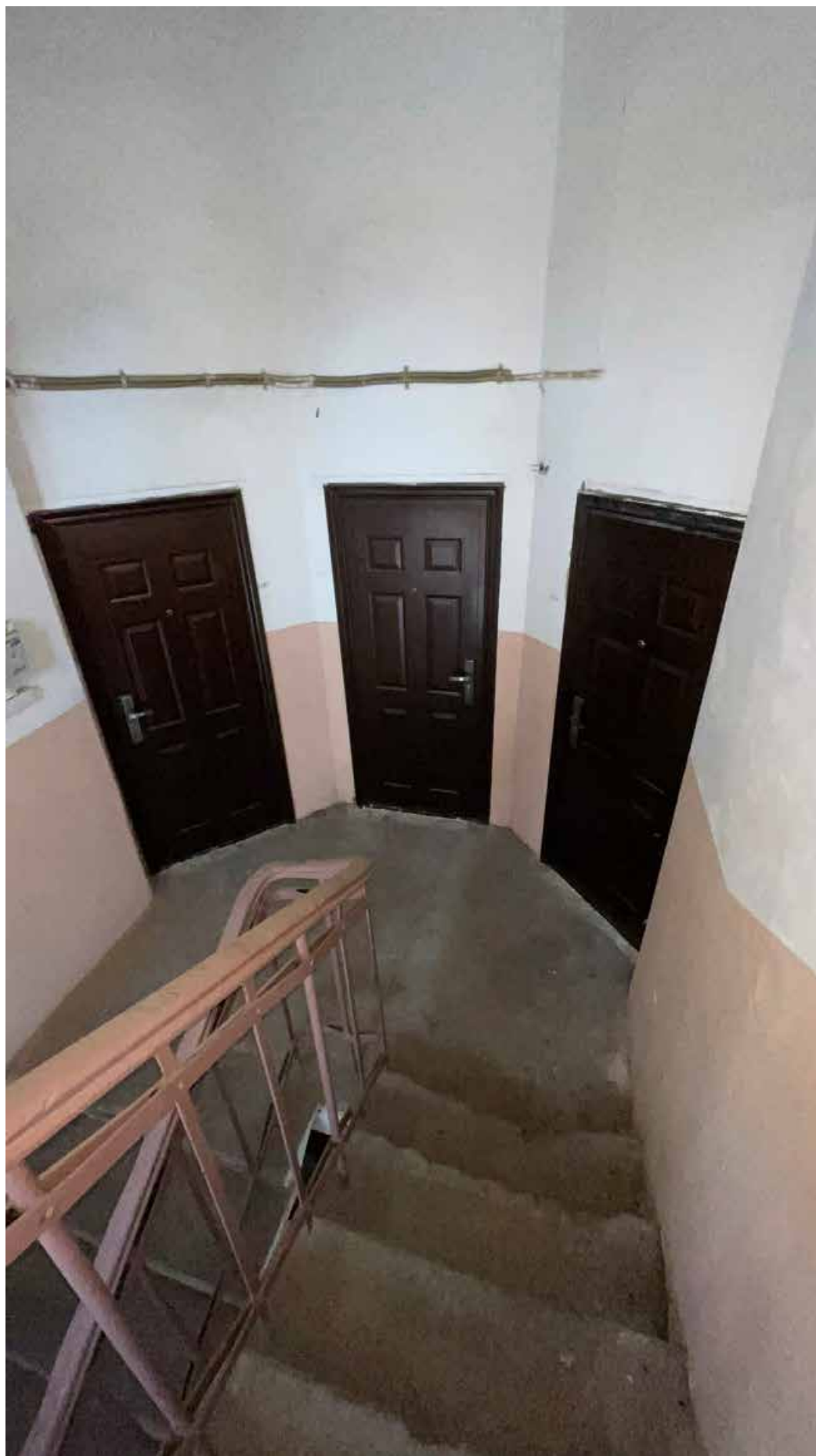
65.Общий вид на входные двери в северной части здания;
