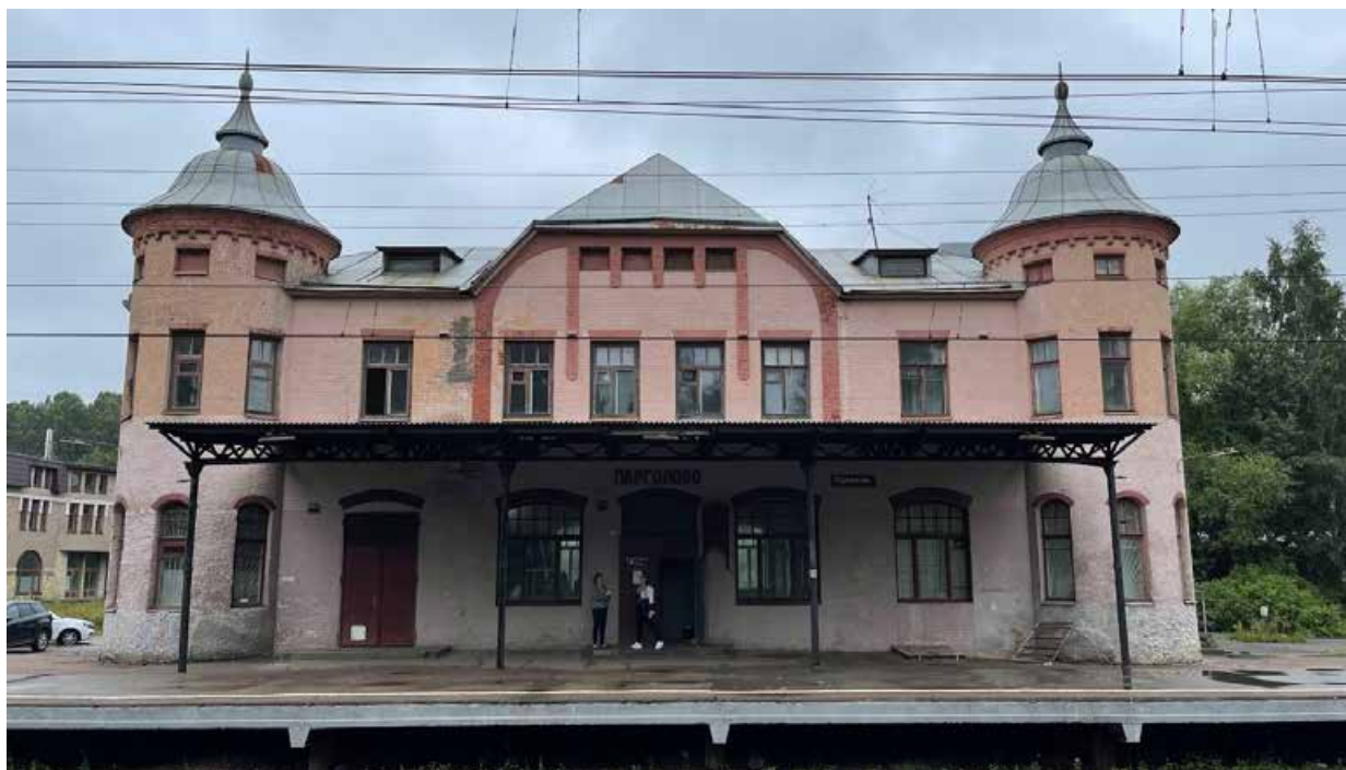
5. Вид на западный фасад здания;
