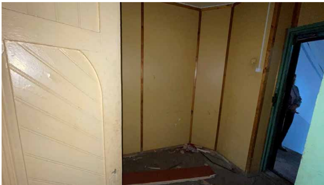
60.Фрагмент интерьера коридора;
