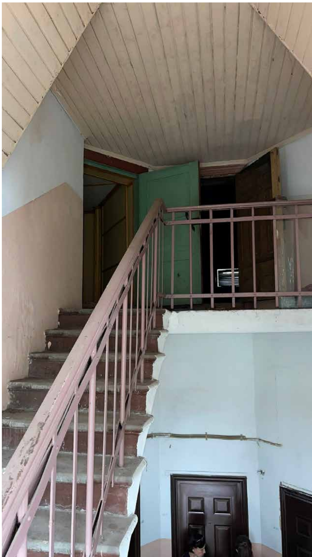
108. Общий вид на вход на чердак и вход в жилое помещение.
