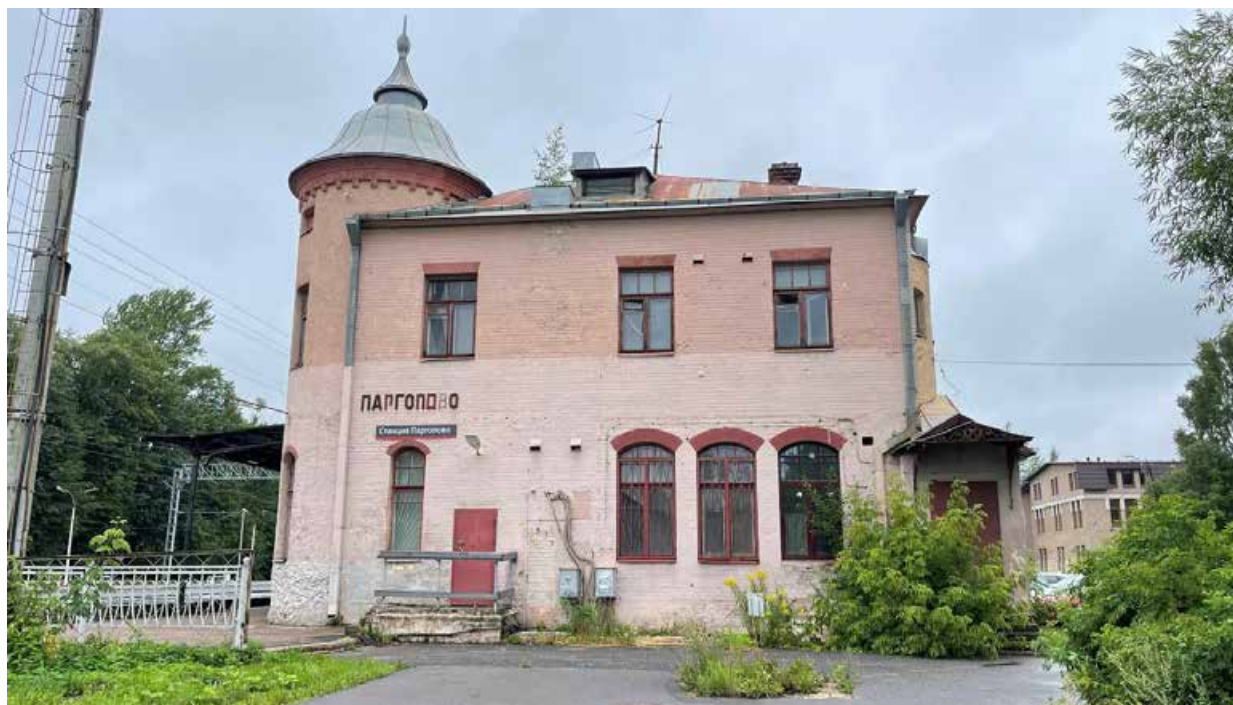
7. Вид на южный фасад здания;
