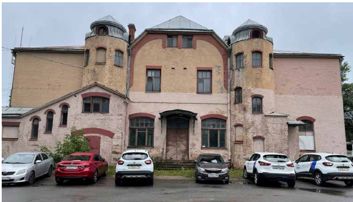
1. Вид на восточный фасад здания;
