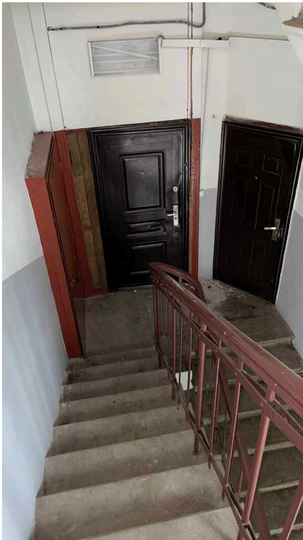
64.Общий вид на входные двери в южной части здания;
