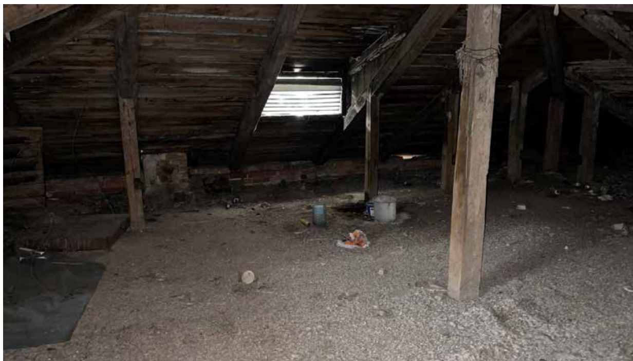
98. Северная часть чердака;
