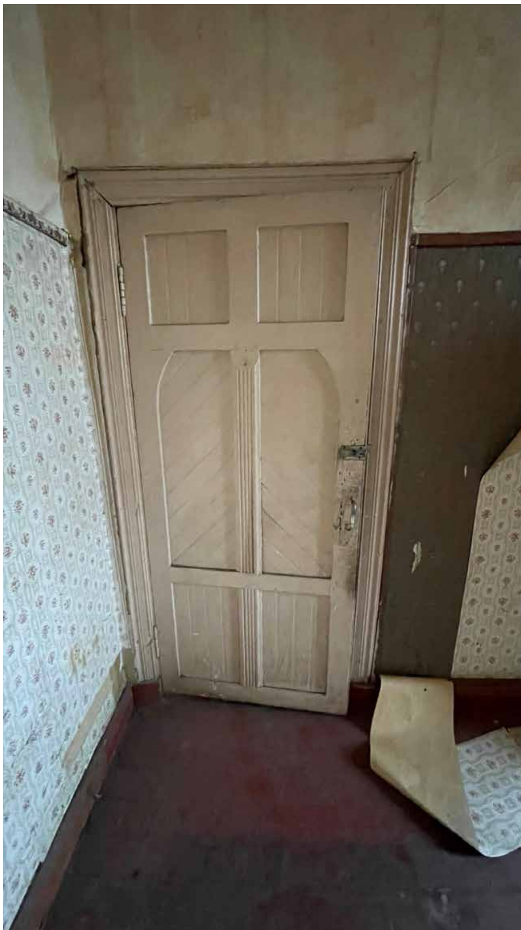
49. Вид на входную дверь в помещении;
