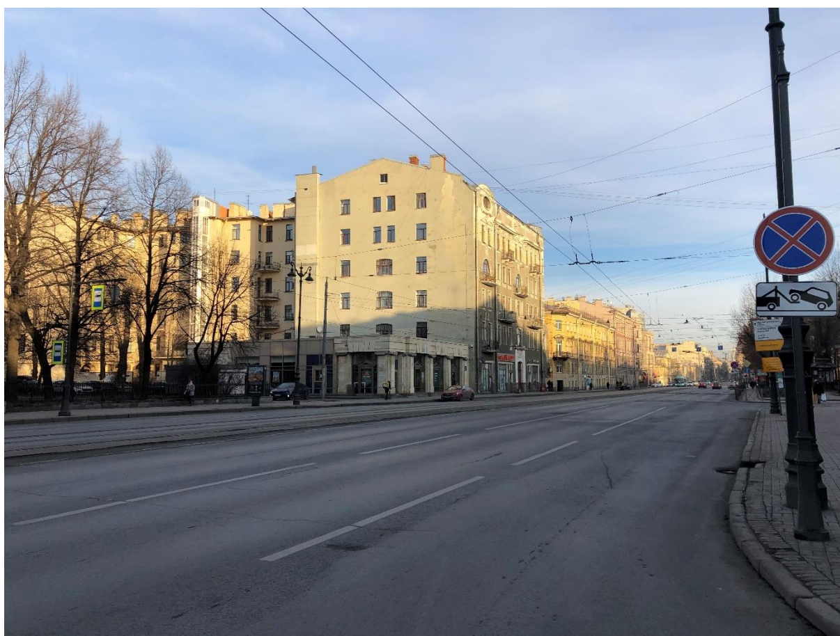
Фото 5. Дворовые и торцевые фасады дома № 45 по Загородному проспекту.
