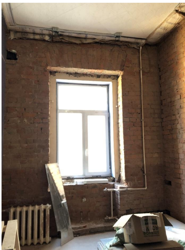
Фото 35. Вид на помещение № 62.
