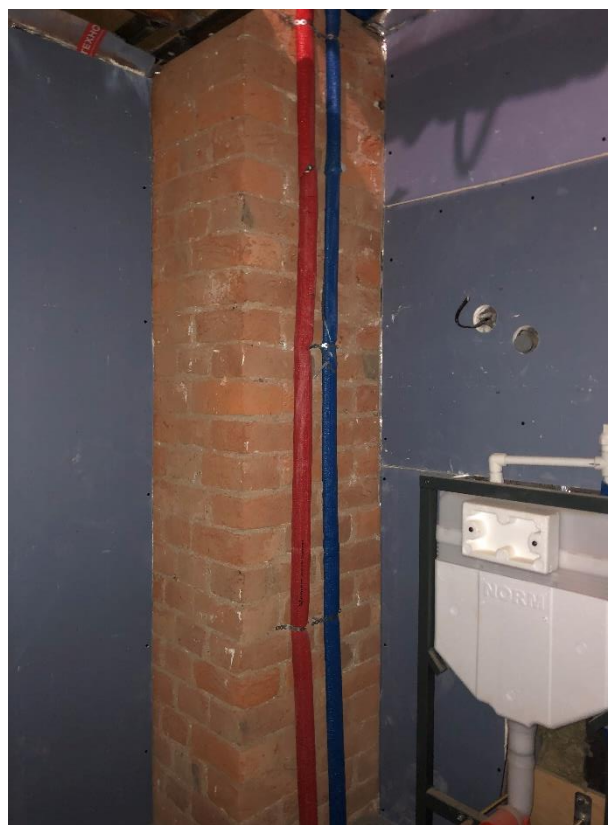
Фото 49. Вид на помещение № 42.
