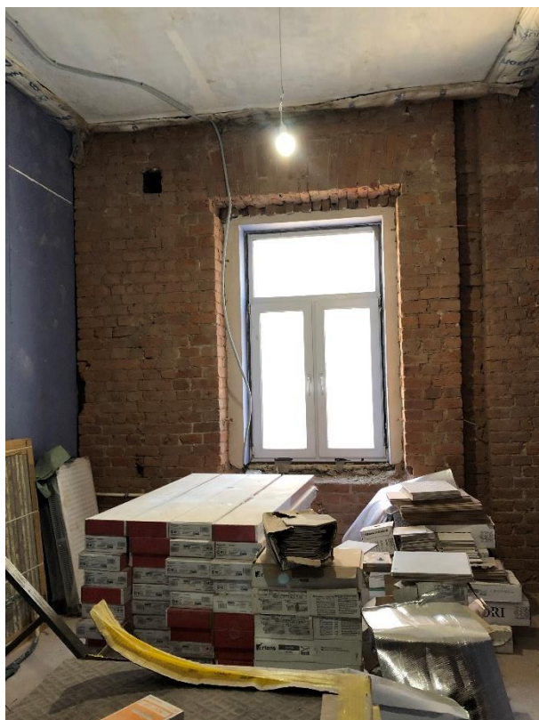
Фото 42. Вид на помещение № 59.
