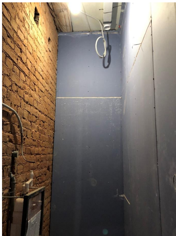
Фото 41. Вид на помещение № 60.
