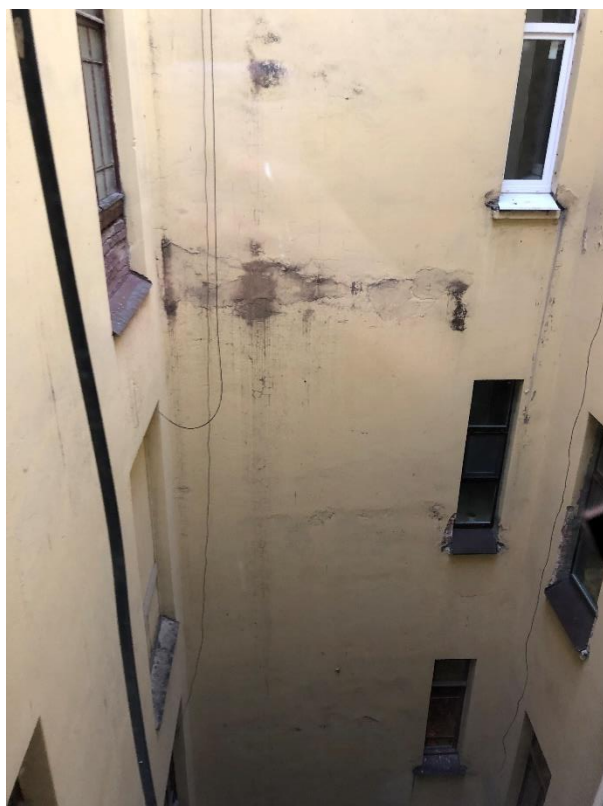
Фото 31. Вид на дворовые фасады из окна исследуемой квартиры.
