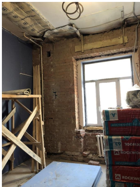
Фото 11. Вид на помещение № 12.
