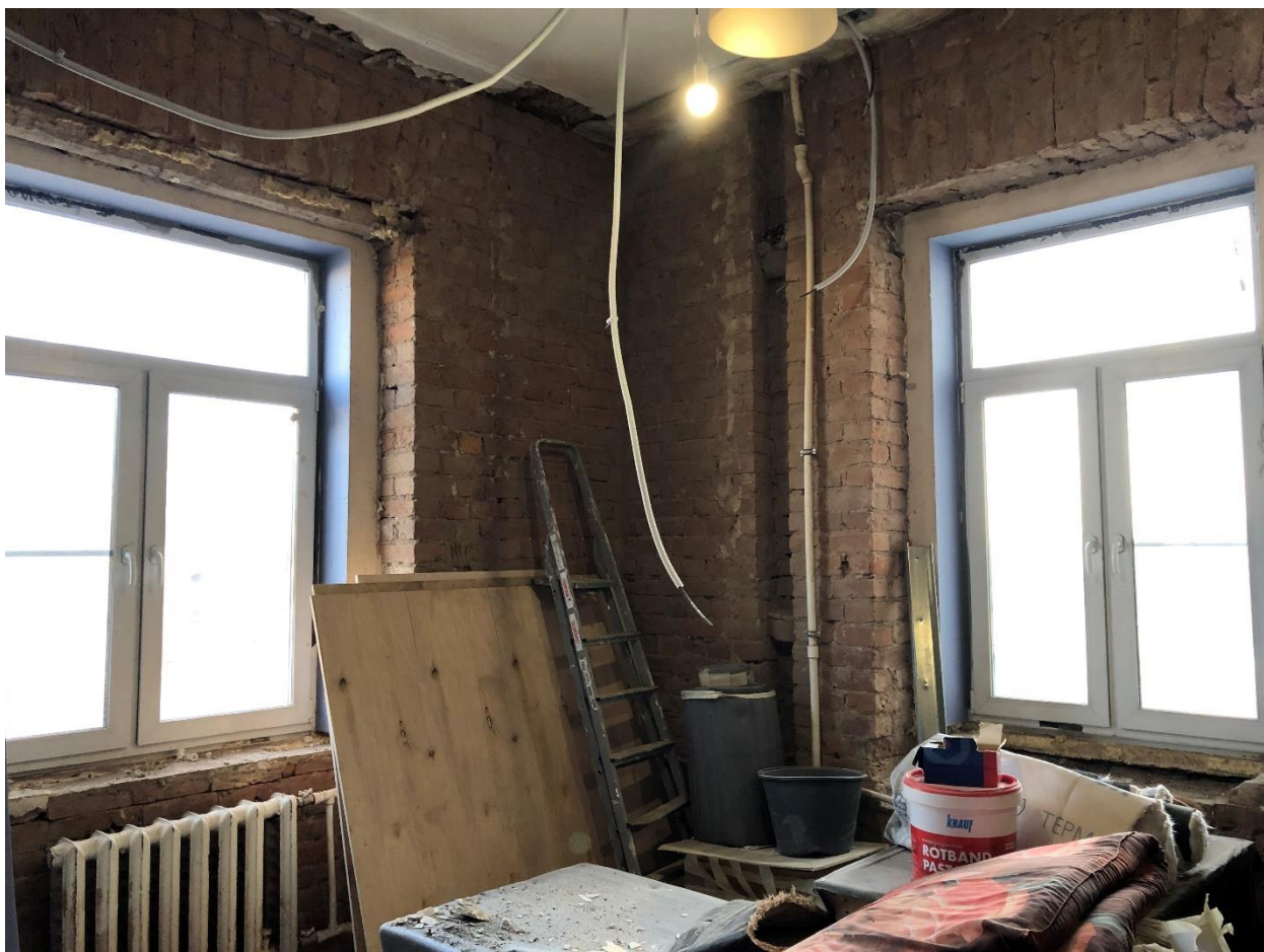
Фото 26. Вид на помещение № 29.
