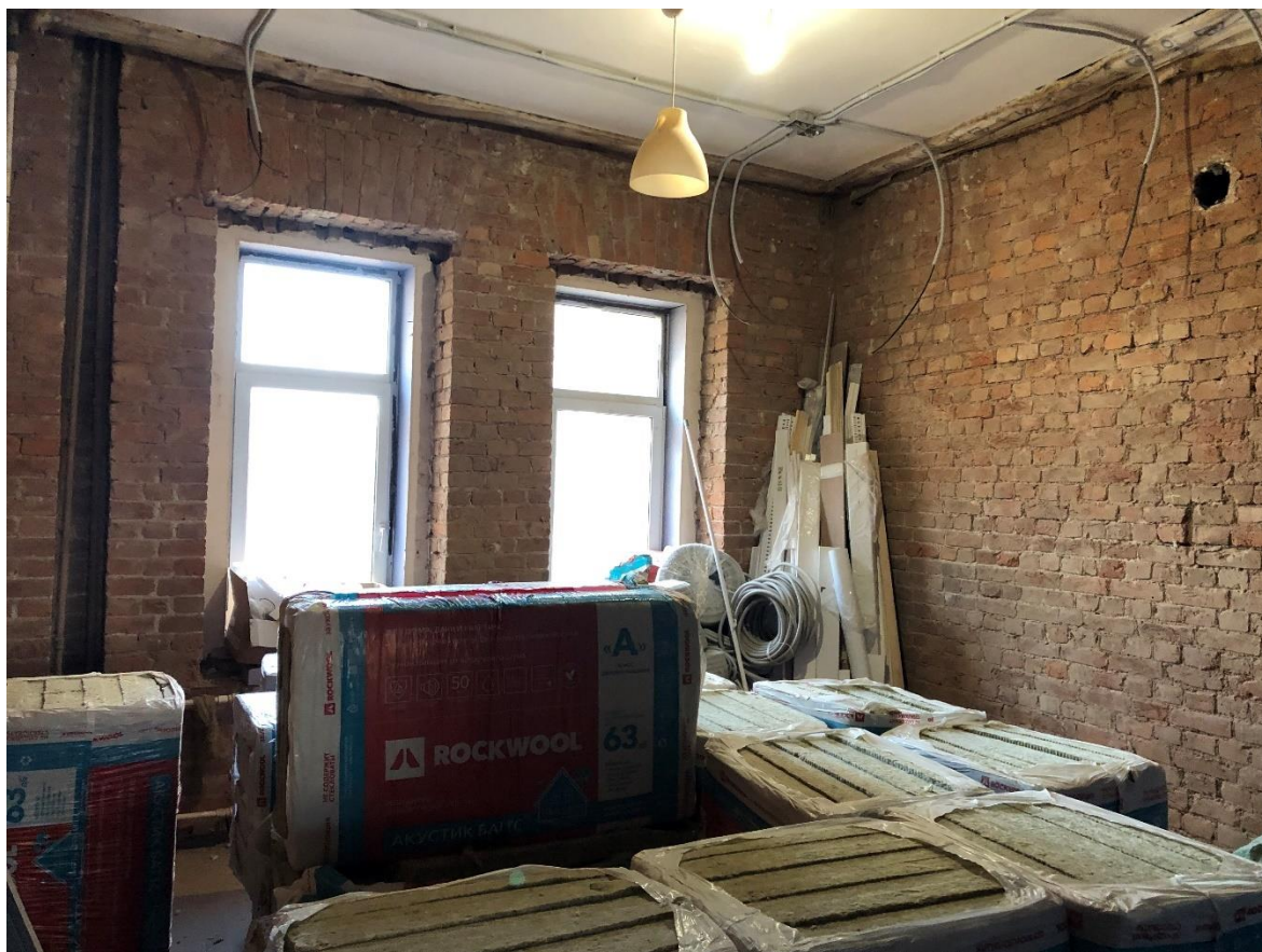
Фото 5. Вид на помещение № 6.
