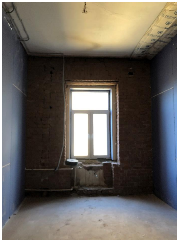
Фото 52. Вид на помещение № 53.
