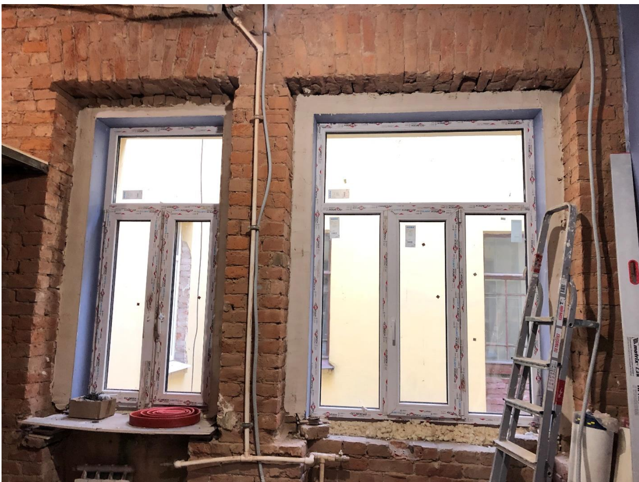
Фото 37. Вид на помещение № 34.
