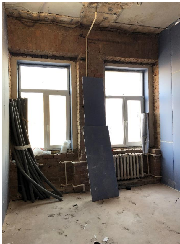
Фото 18. Вид на помещение № 19.
