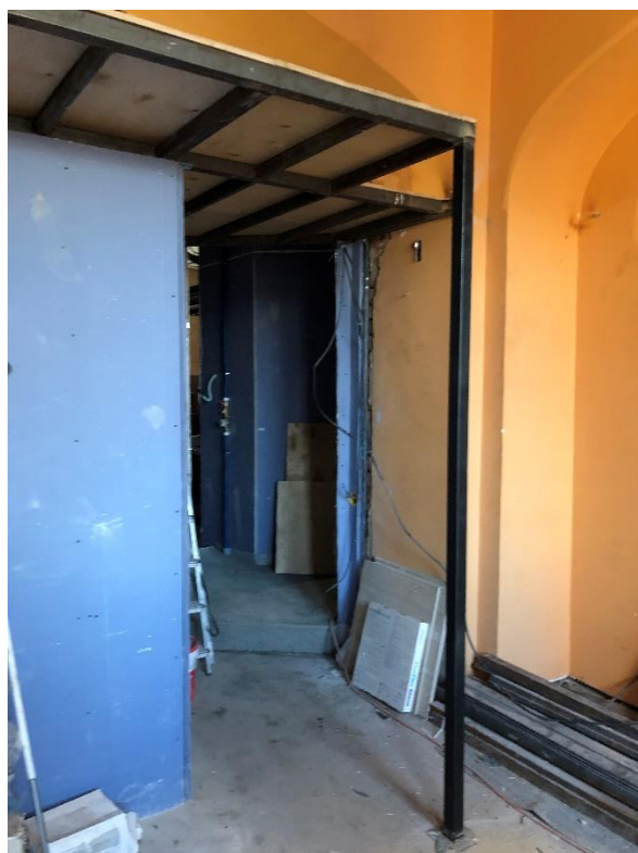
Фото 3. Вид на помещение № 2.
