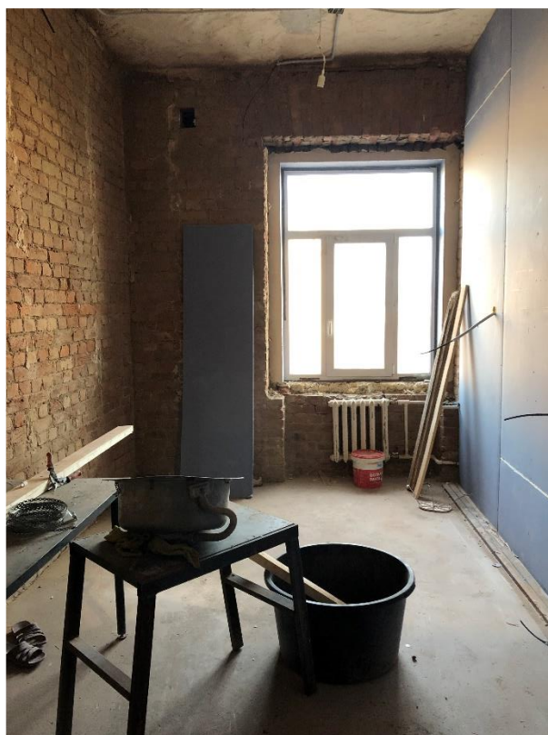
Фото 24. Вид на помещение № 26.
