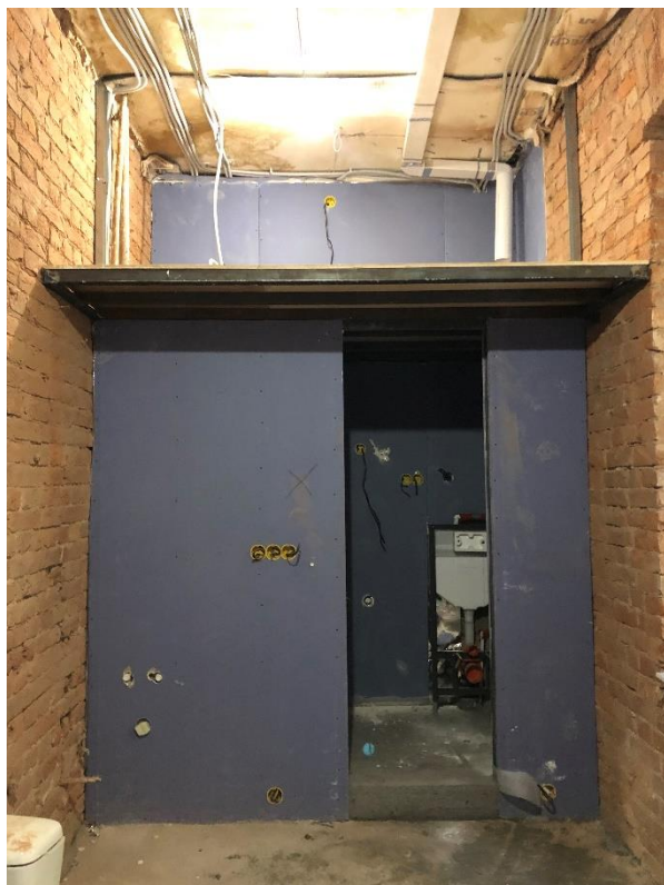
Фото 38. Вид на помещение № 34.
