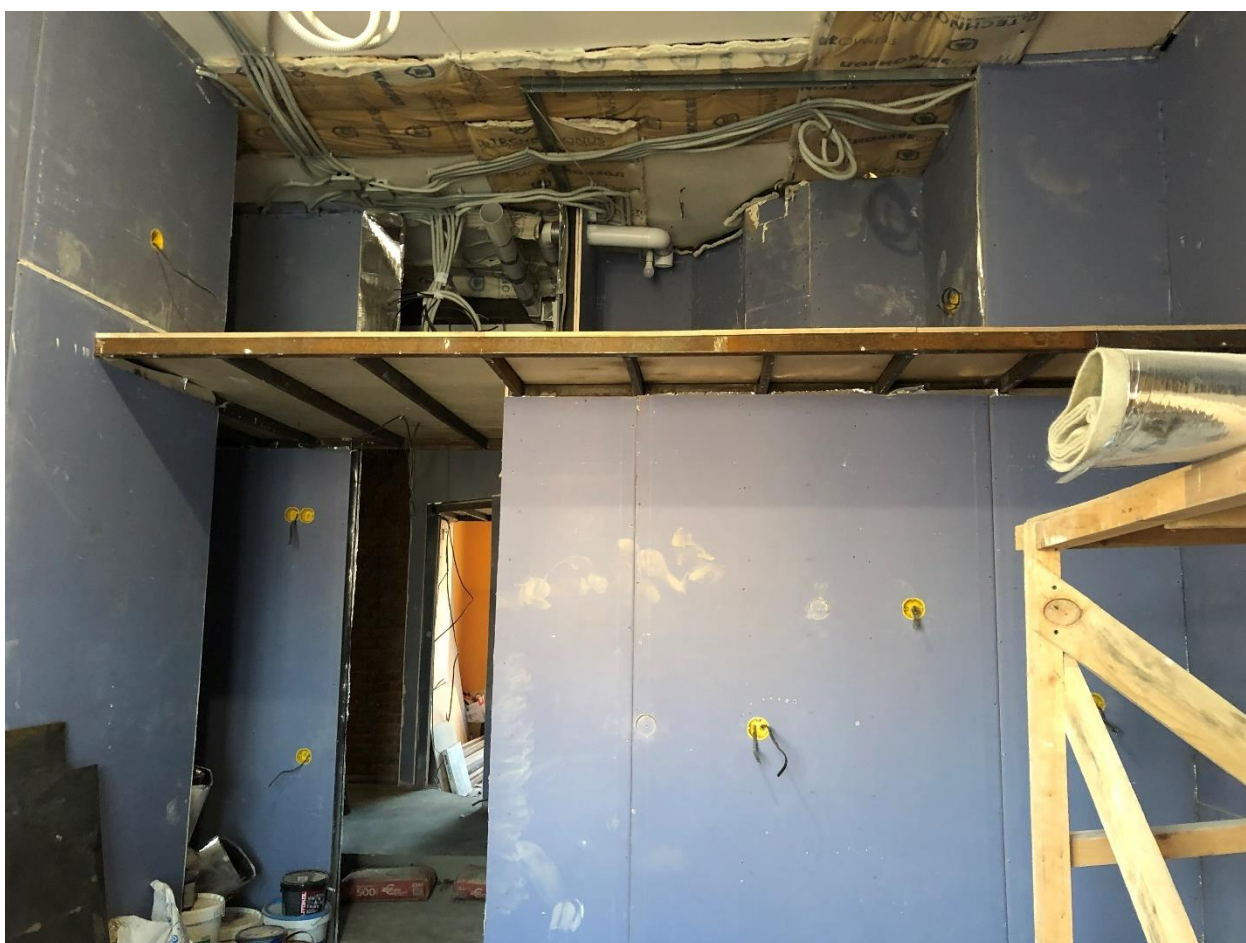
Фото 12. Вид на помещение № 12.
