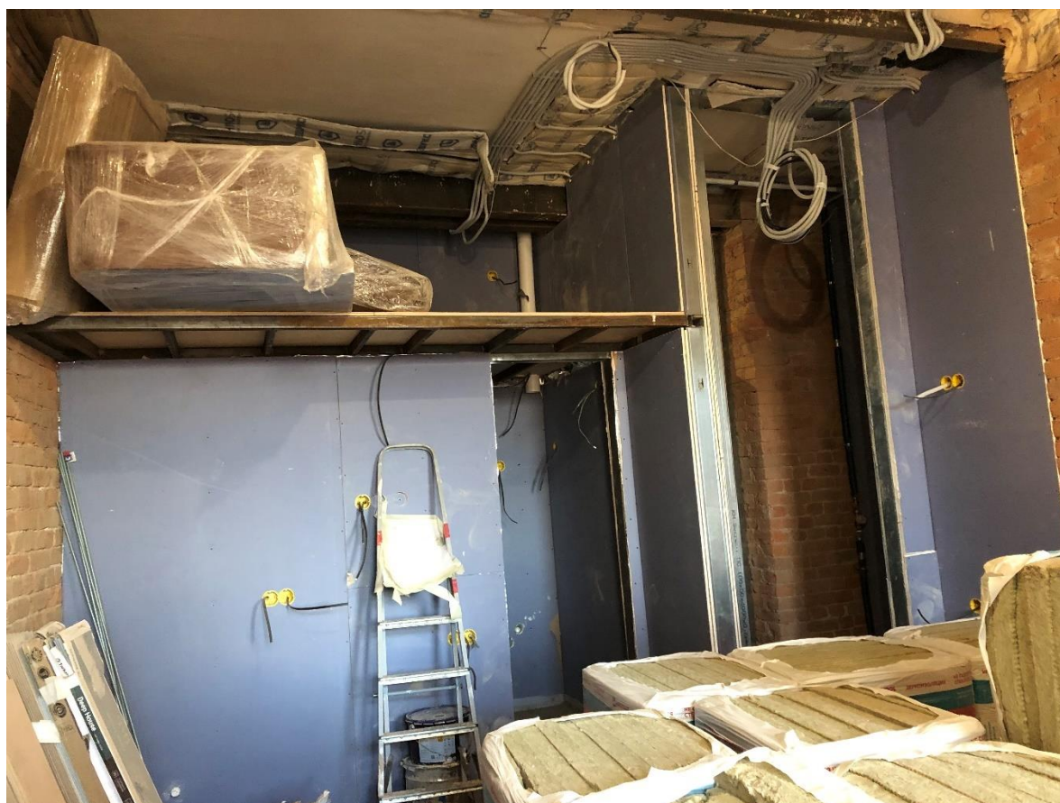
Фото 6. Вид на помещение № 6.
