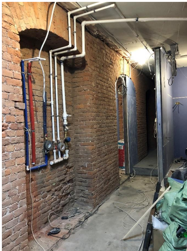
Фото 22. Вид на часть коридора.
