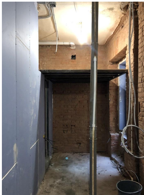
Фото 30. Вид на помещение № 32.
