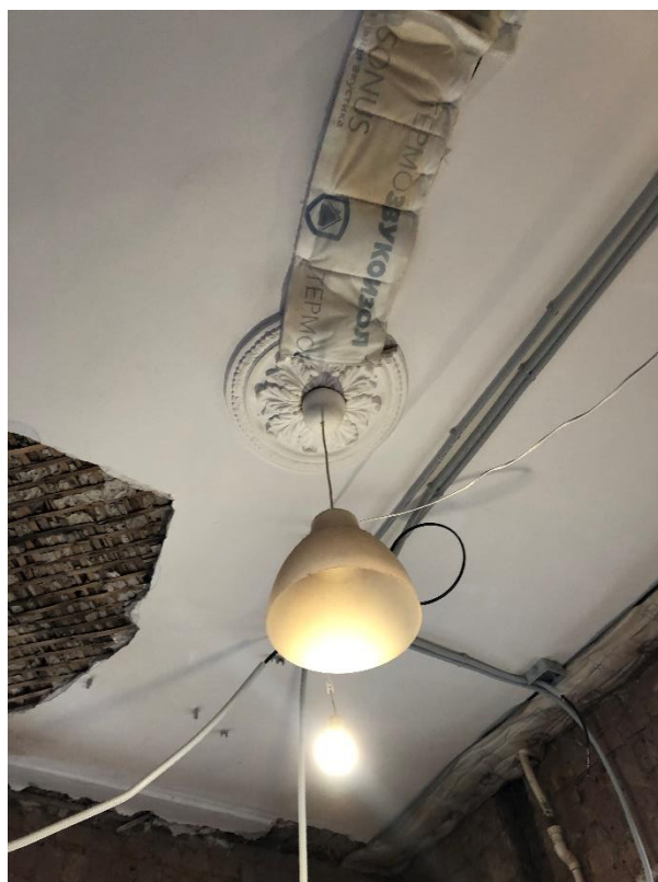
Фото 27. Вид на часть помещения № 29.
