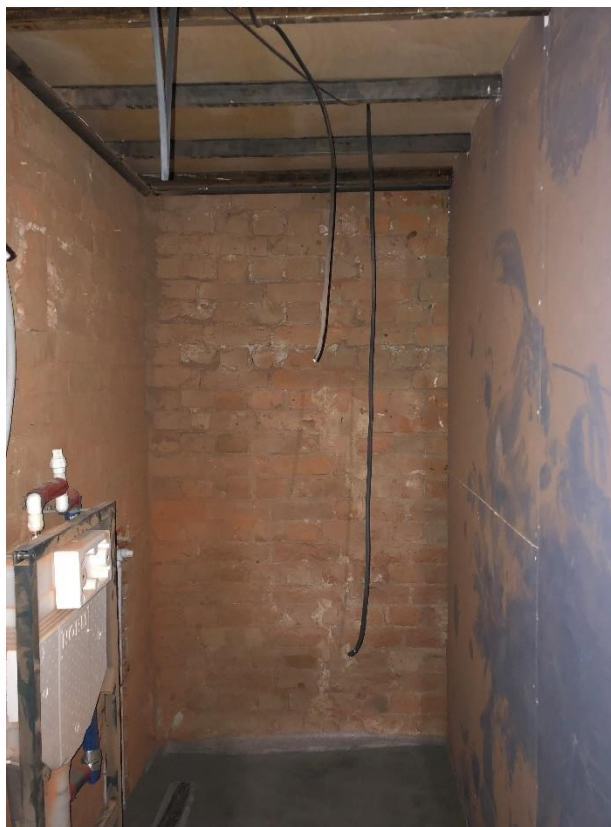
Фото 29. Вид на проектируемый санузел.
