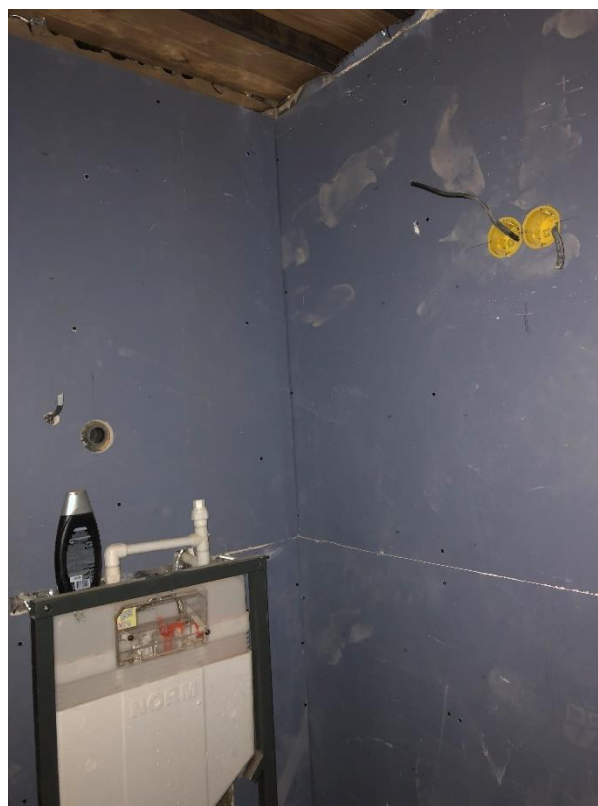
Фото 32. Вид на проектируемый санузел.
