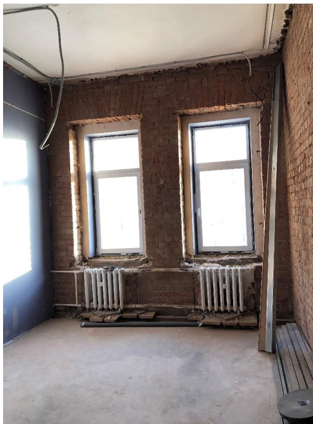
Фото 54. Вид на помещение № 44.
