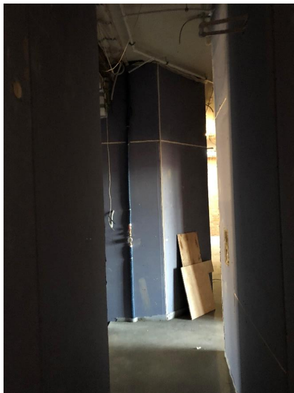
Фото 9. Вид на часть коридора.
