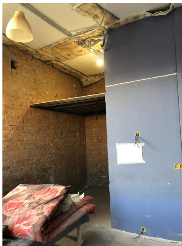
Фото 28. Вид на помещение № 29.
