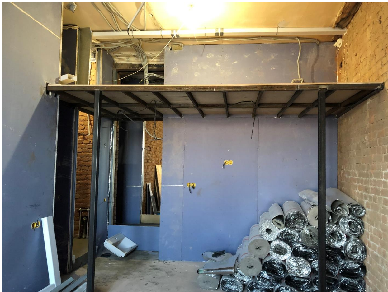
Фото 7. Вид на помещение № 9.
