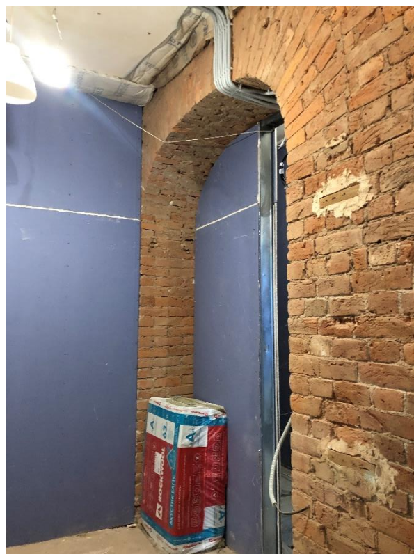
Фото 39. Вид на помещение № 34.
