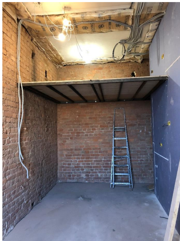
Фото 21. Вид на помещение № 23.
