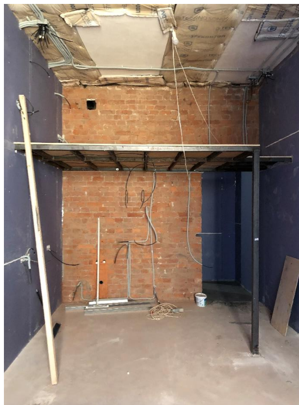
Фото 53. Вид на помещение № 55.
