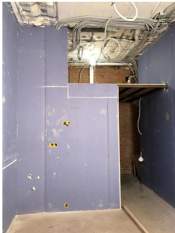
Фото 51. Вид на помещение № 41.
