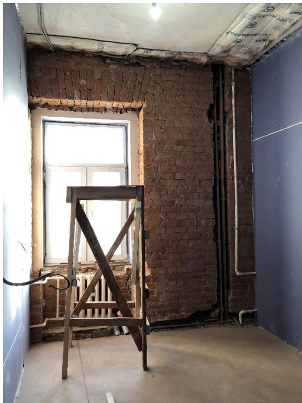
Фото 50. Вид на помещение № 41.
