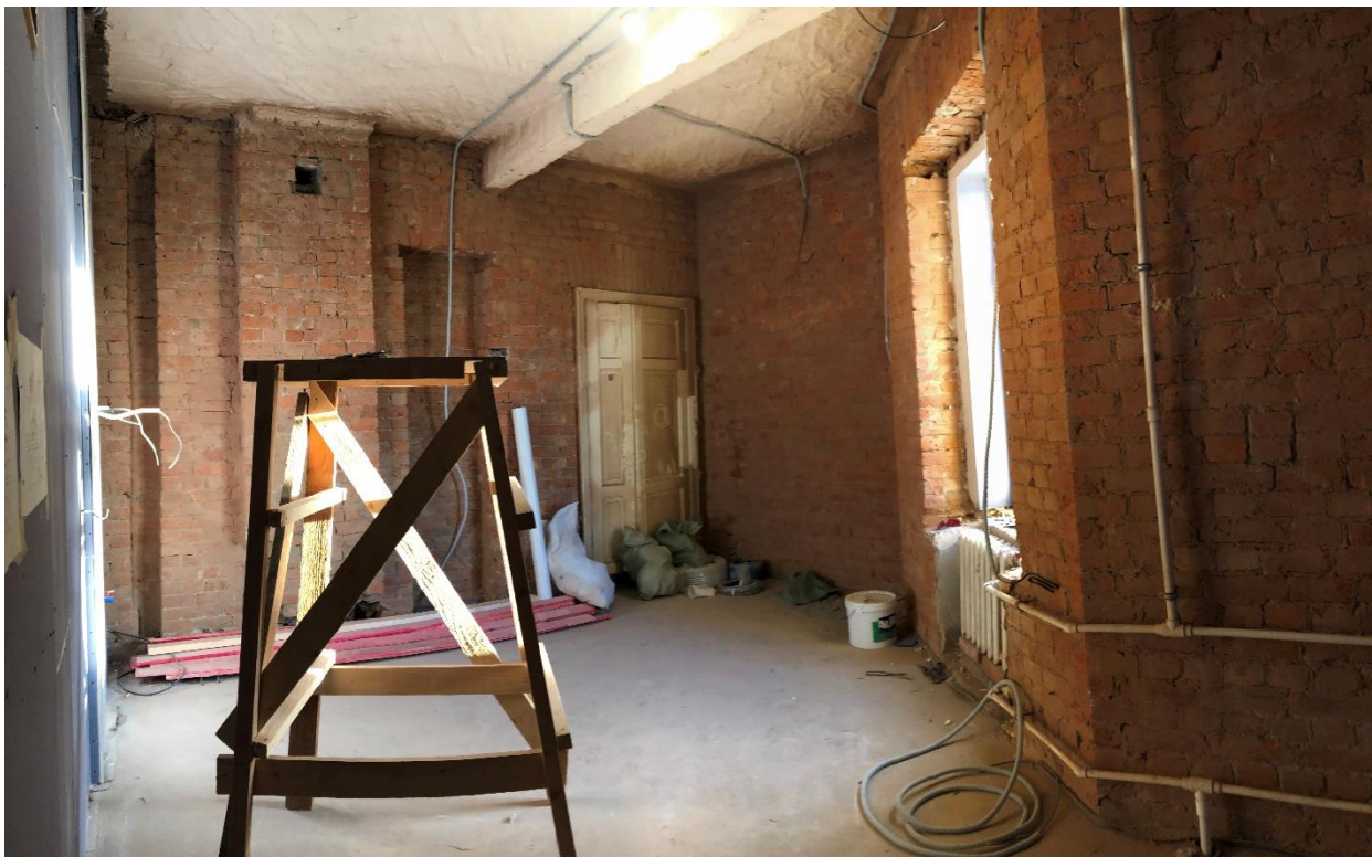
Фото 47. Вид на помещение № 38.
