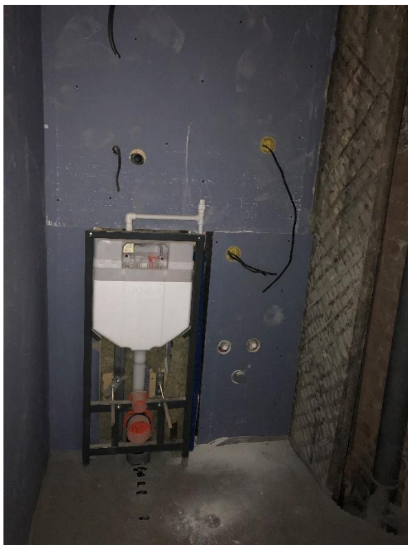
Фото 33. Вид на помещение № 64.
