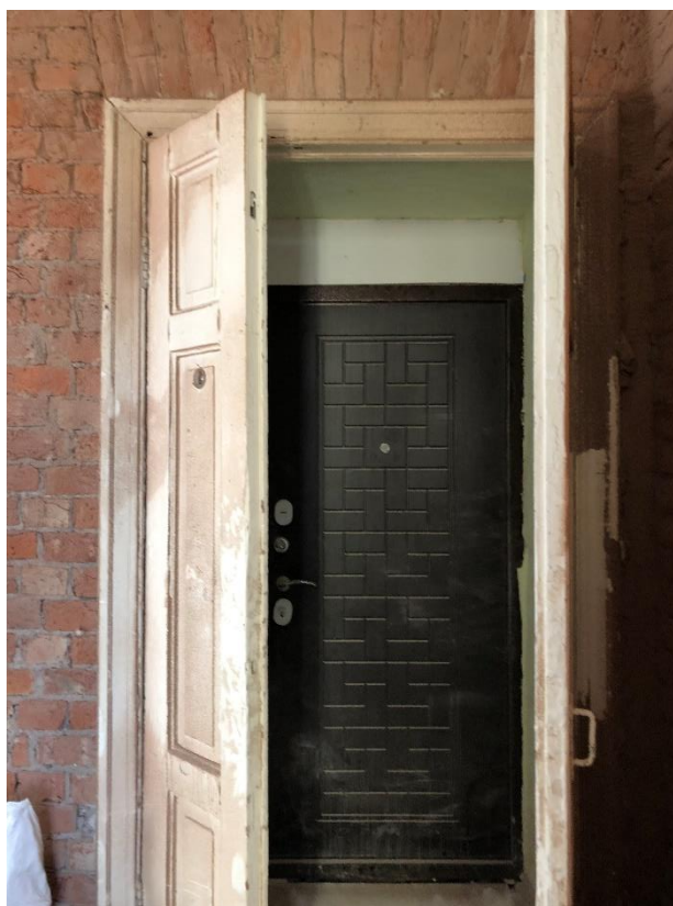
Фото 48. Вид на вторую входную дверь в исследуемую квартиру.
