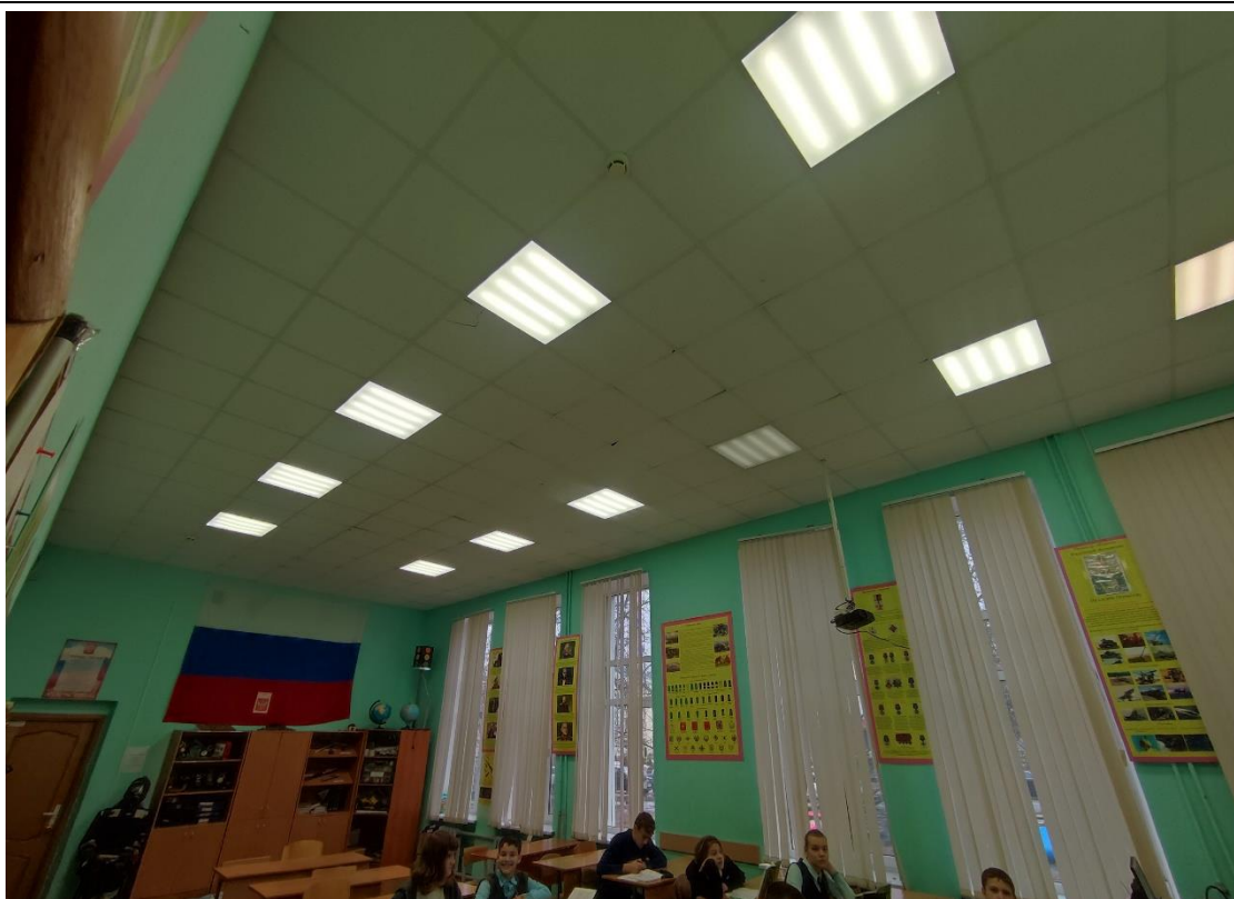
28. Объект культурного наследия регионального значения «Женская гимназия Павловой», расположенный по адресу: Санкт-Петербург, город Петергоф, Эрлеровский бульвар, дом 1/35, литера А. Общий вид пом. 1-Н (38) 1-го этажа.
