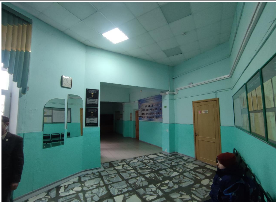
15. Объект культурного наследия регионального значения «Женская гимназия Павловой», расположенный по адресу: Санкт-Петербург, город Петергоф, Эрлеровский бульвар, дом 1/35, литера А. Общий вид пом. 1-Н (1) 1-го этажа.
