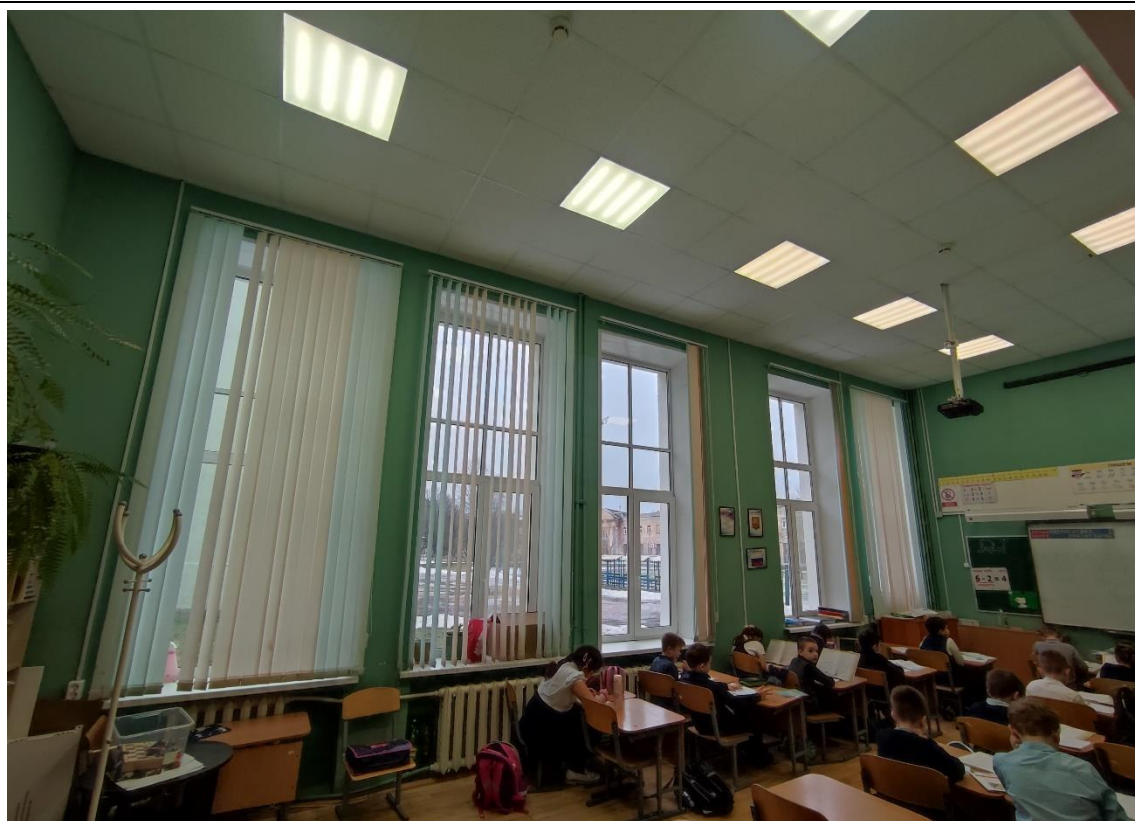
27. Объект культурного наследия регионального значения «Женская гимназия Павловой», расположенный по адресу: Санкт-Петербург, город Петергоф, Эрлеровский бульвар, дом 1/35, литера А. Общий вид пом. 1-Н (35) 1-го этажа.
