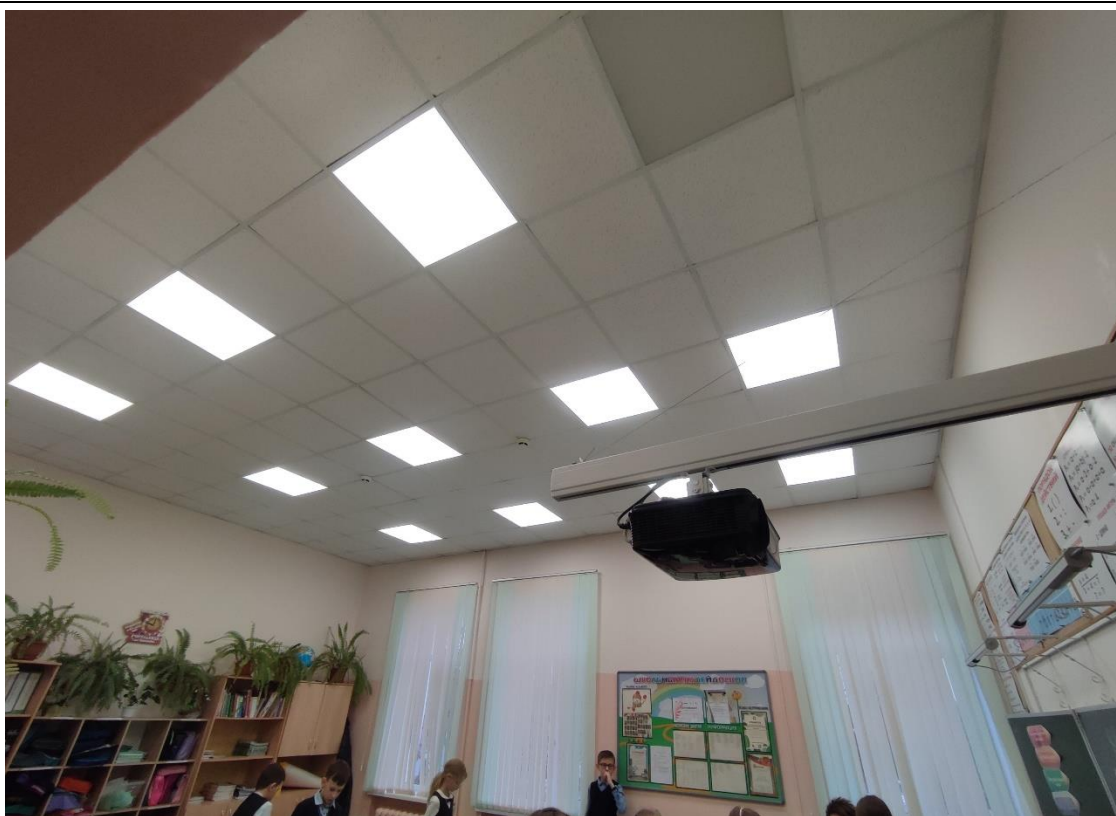
57. Объект культурного наследия регионального значения «Женская гимназия Павловой», расположенный по адресу: Санкт-Петербург, город Петергоф, Эрлеровский бульвар, дом 1/35, литера А. Общий вид пом. 3-Н (31) 3-го этажа.
