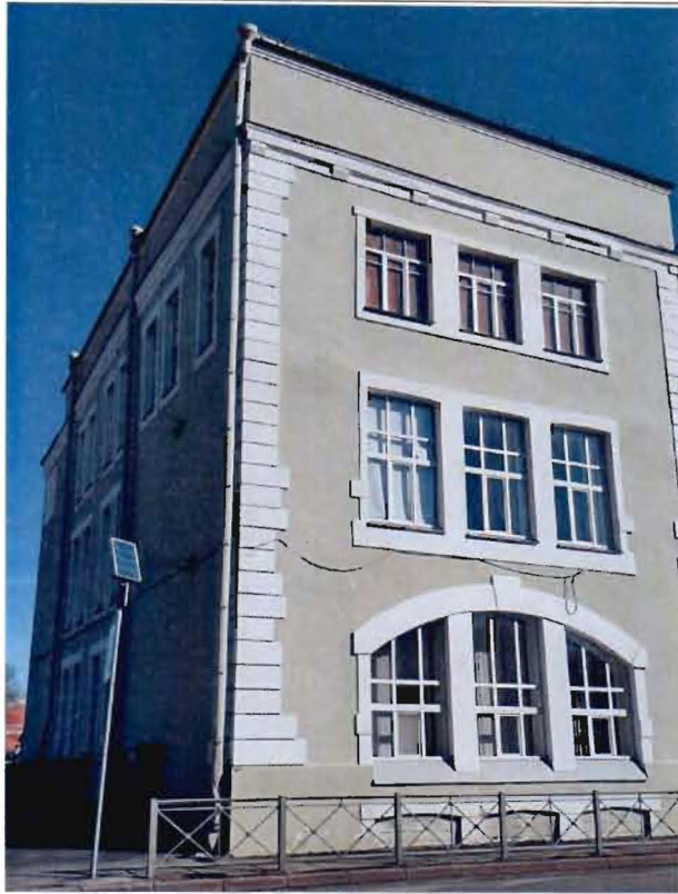
4. Фрагмент юго-западного фасада
