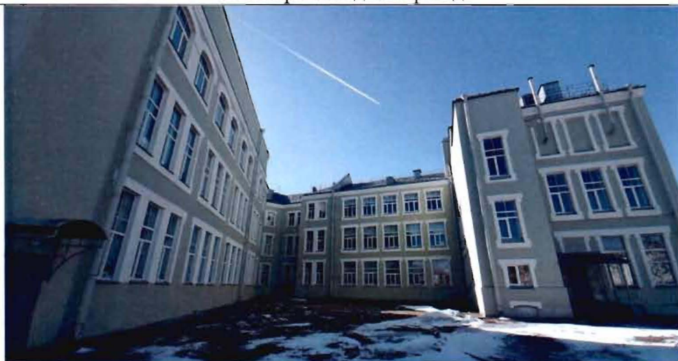
7. Фрагмент дворового фасада
