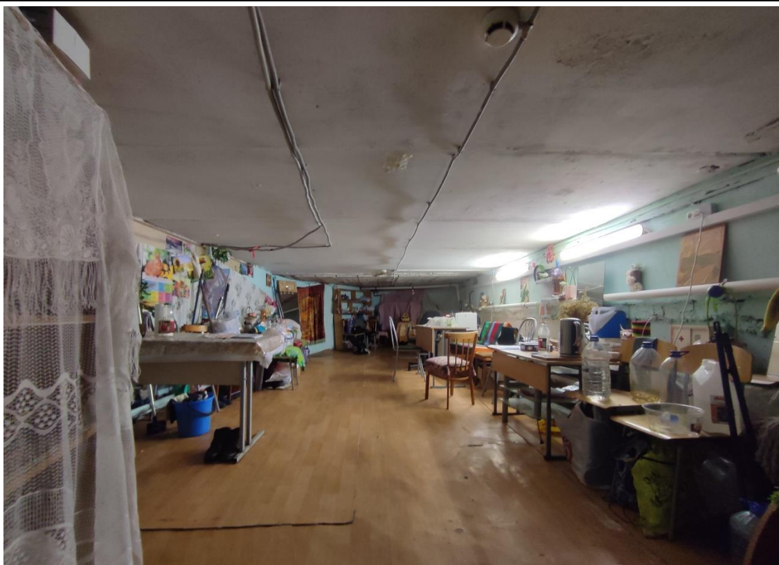
9. Объект культурного наследия регионального значения «Женская гимназия Павловой», расположенный по адресу: Санкт-Петербург, город Петергоф, Эрлеровский бульвар, дом 1/35, литера А. Общий вид пом. 5-Н (19) подвального этажа.
