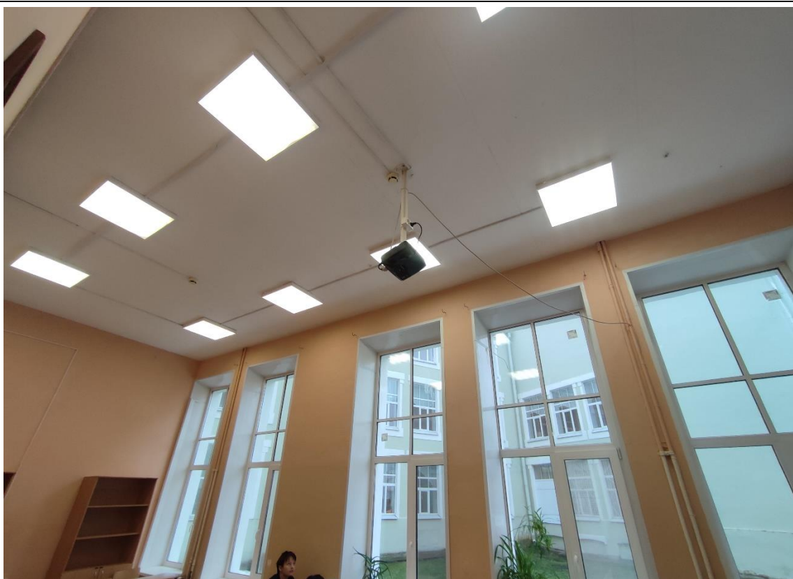
26. Объект культурного наследия регионального значения «Женская гимназия Павловой», расположенный по адресу: Санкт-Петербург, город Петергоф, Эрлеровский бульвар, дом 1/35, литера А. Общий вид пом. 1-Н (33) 1-го этажа.
