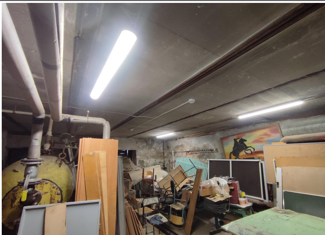
12. Объект культурного наследия регионального значения «Женская гимназия Павловой», расположенный по адресу: Санкт-Петербург, город Петергоф, Эрлеровский бульвар, дом 1/35, литера А. Общий вид пом. 5-Н (10) подвального этажа.
