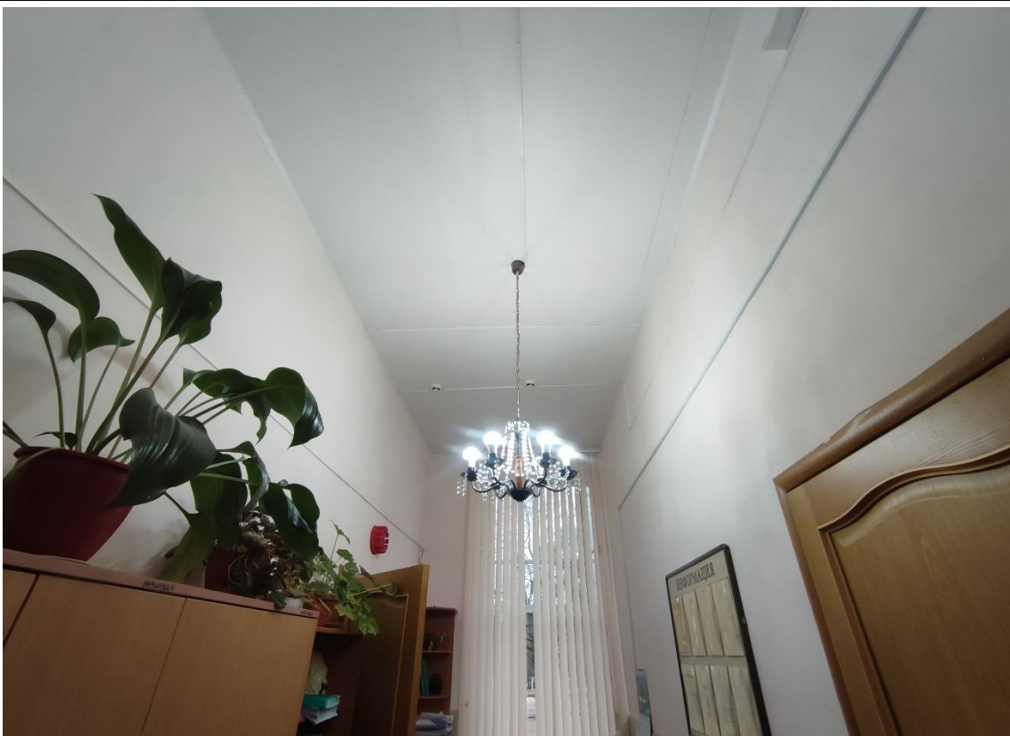
22. Объект культурного наследия регионального значения «Женская гимназия Павловой», расположенный по адресу: Санкт-Петербург, город Петергоф, Эрлеровский бульвар, дом 1/35, литера А. Общий вид пом. 1-Н (43) 1-го этажа.
