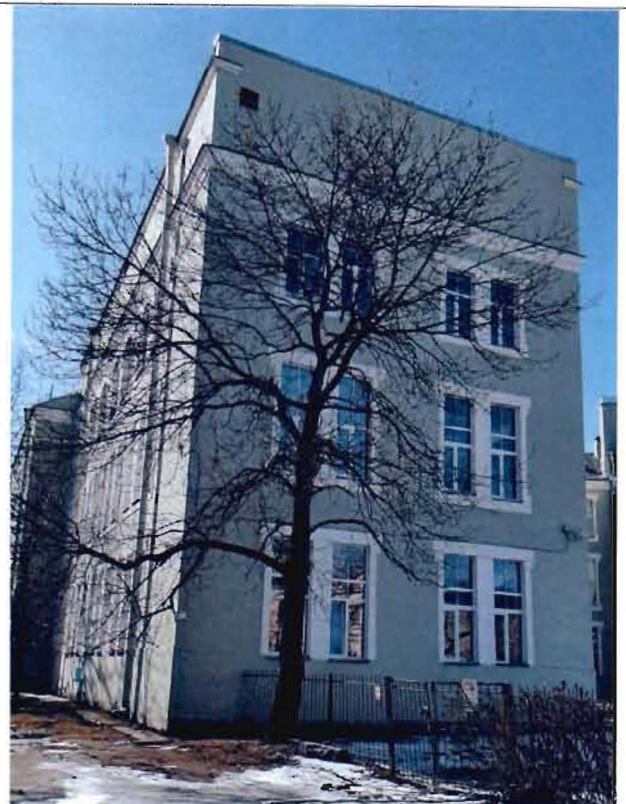
5. Фрагмент северо-восточного фасада
