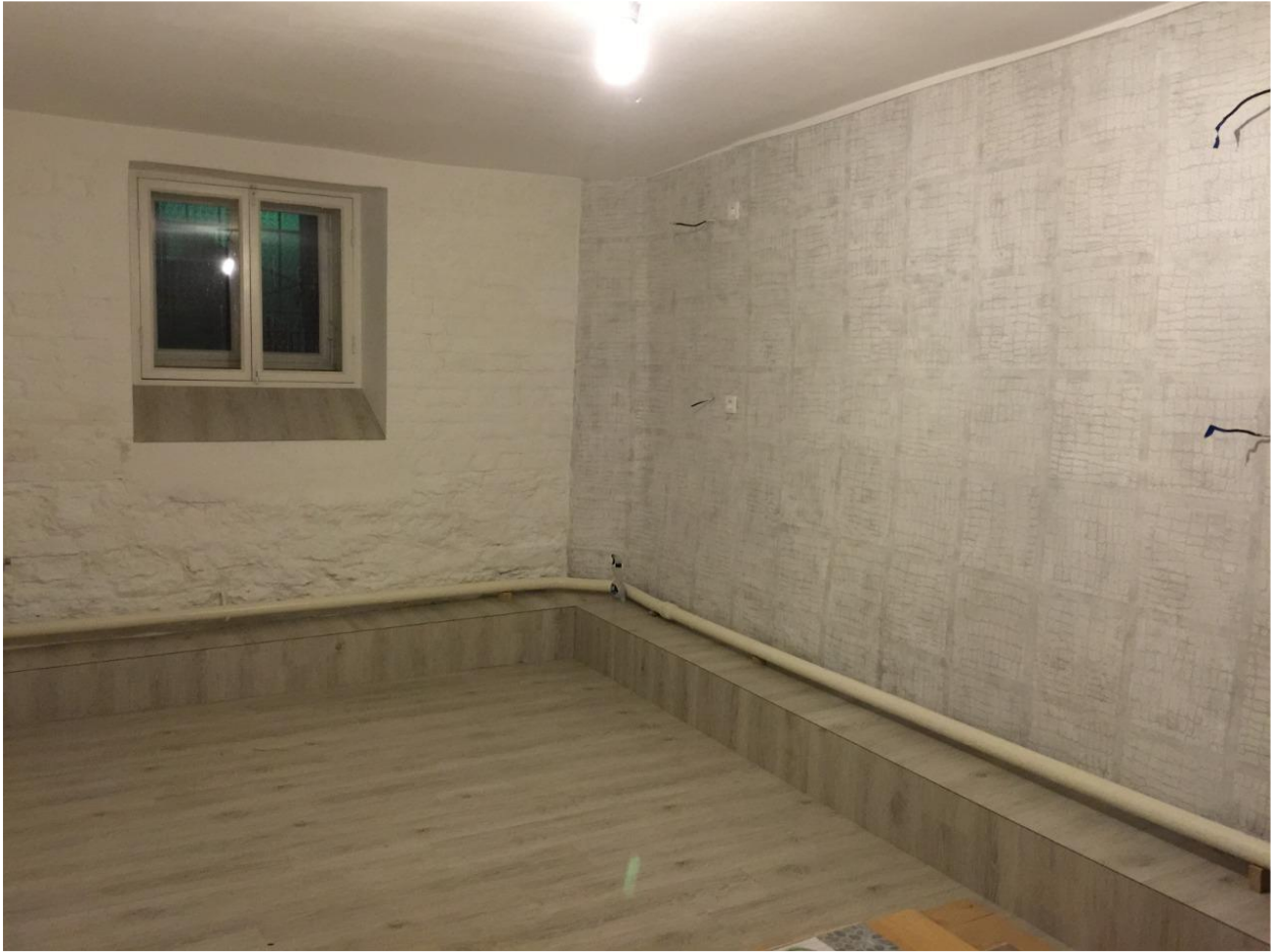
Помещение 4-Н. Исполкомская ул., 5, литера А
