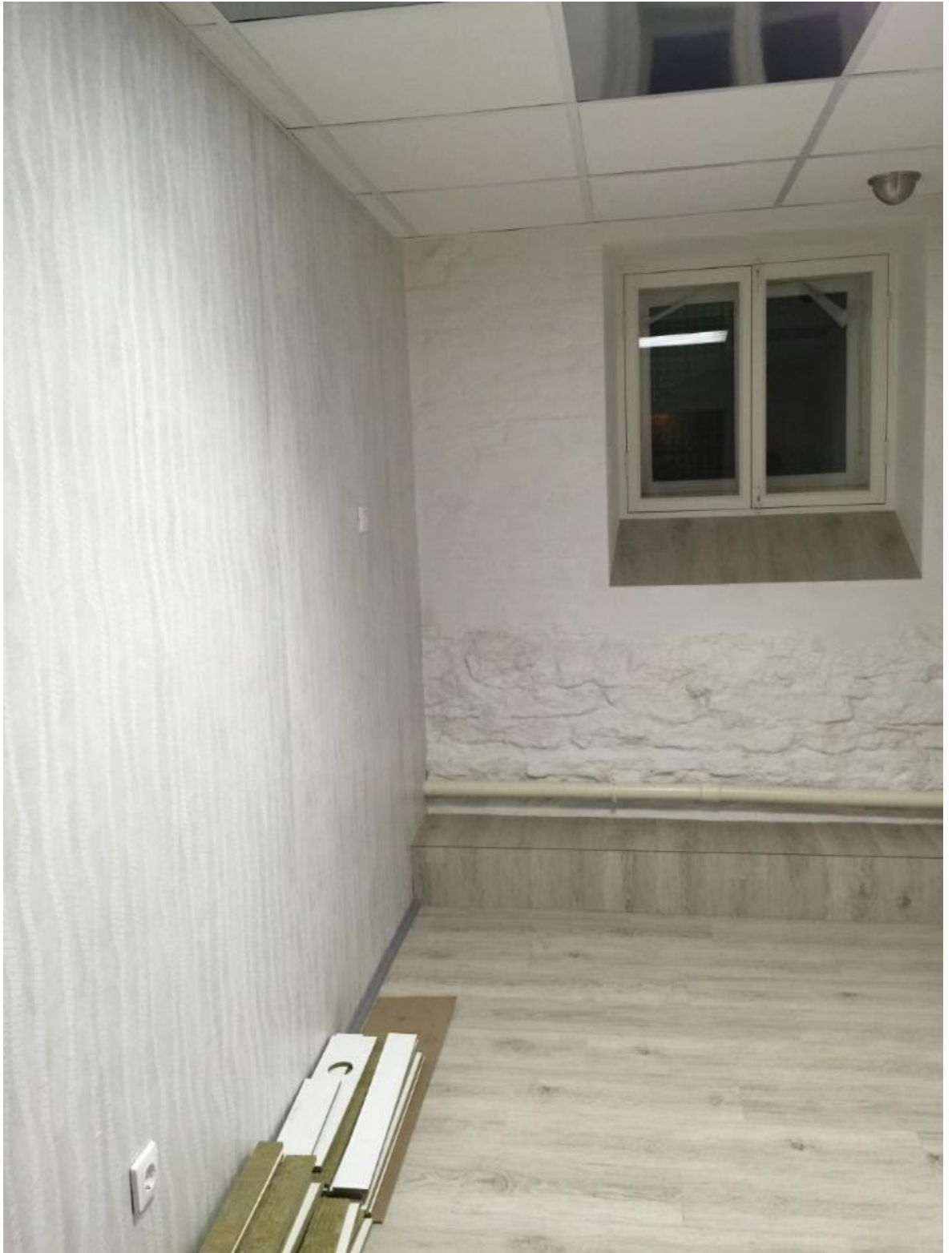
Помещение 4-Н. Исполкомская ул., 5, литера А
