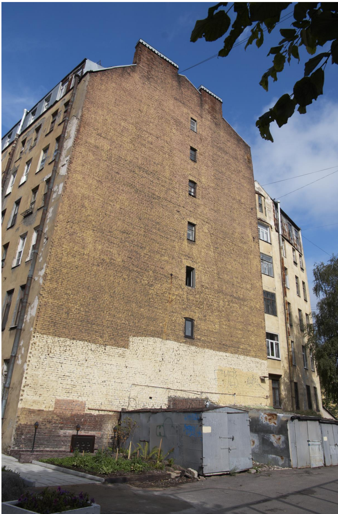
3. Дворовый фасад (юго-восточный). Исполкомская ул., 5, литера А
