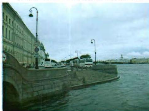
14. Участок набережной, примыкающий к Эрмитажному мосту
