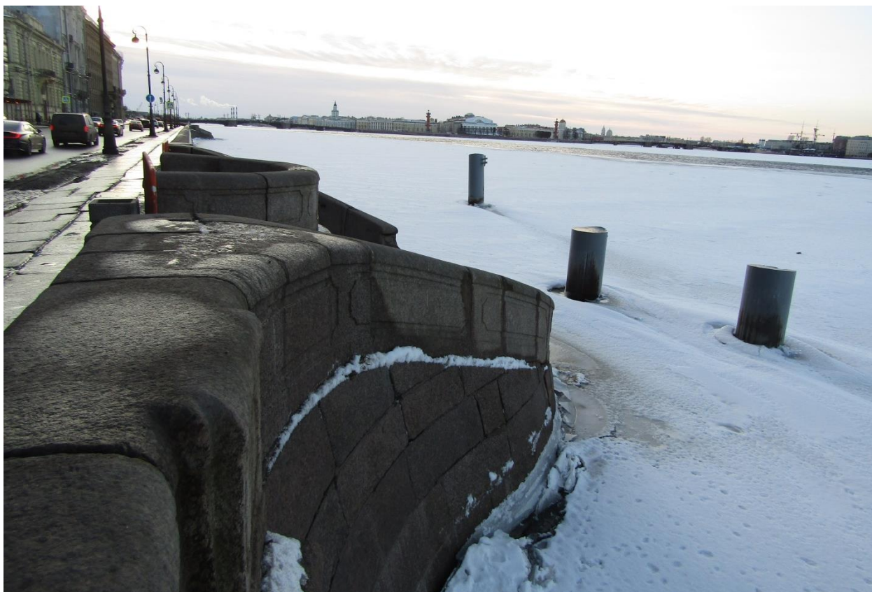
Фото 11. Вид на спуск №4 объекта культурного наследия федерального значения «Спуски лестничные»
