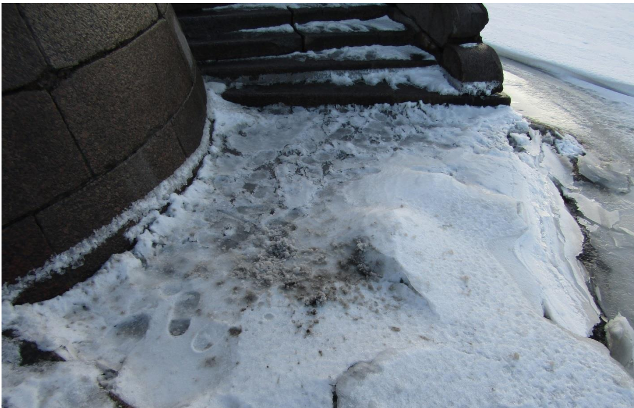
Фото 9. Вид на нижнюю площадку спуска № 4 объекта культурного наследия федерального значения «Спуски лестничные»
