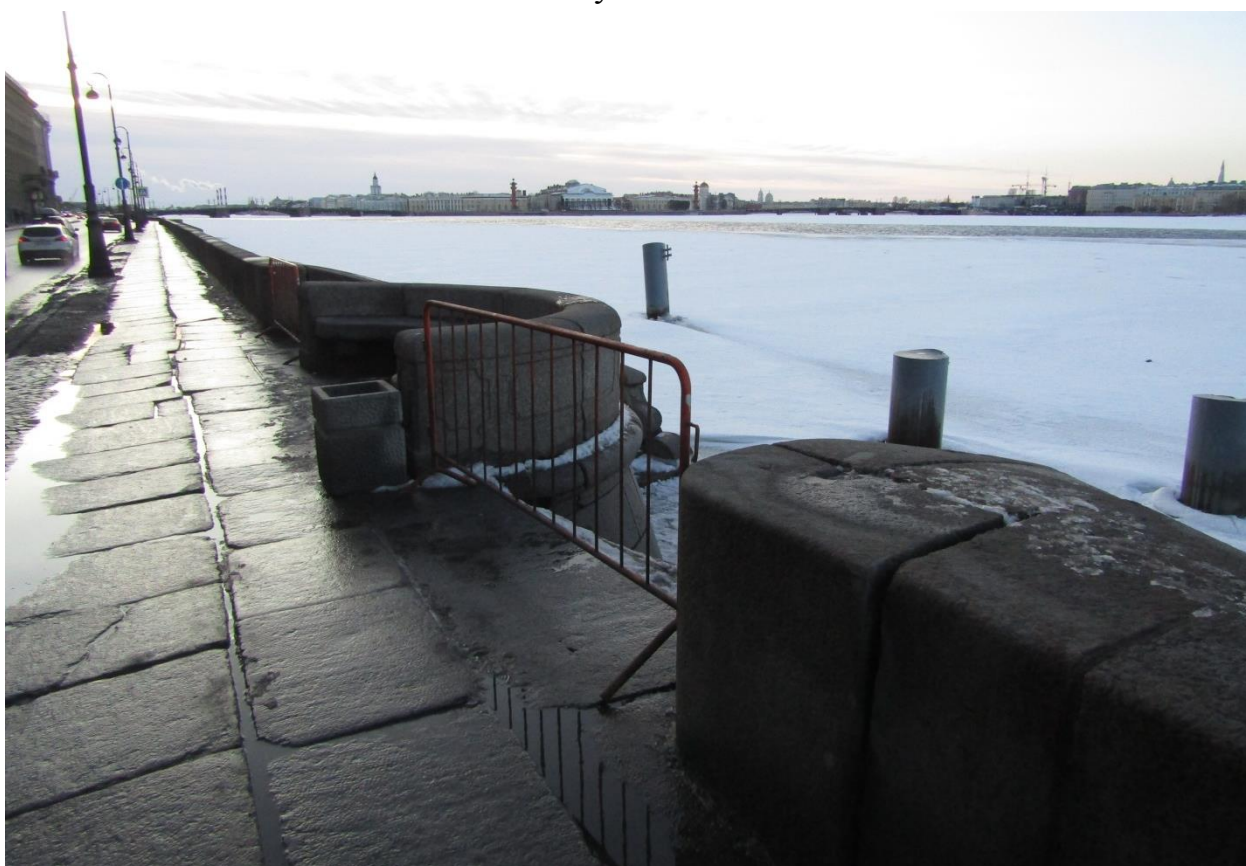
Фото 12. Вид на спуск №4 объекта культурного наследия федерального значения «Спуски лестничные»
