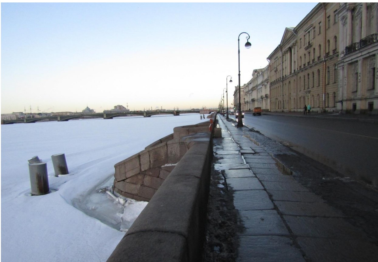
Фото 3. Вид на спуск № 4 объекта культурного наследия федерального значения «Спуски лестничные»
