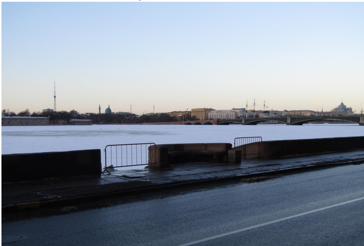
Фото 1. Вид на спуск № 4 объекта культурного наследия федерального значения «Спуски лестничные»
