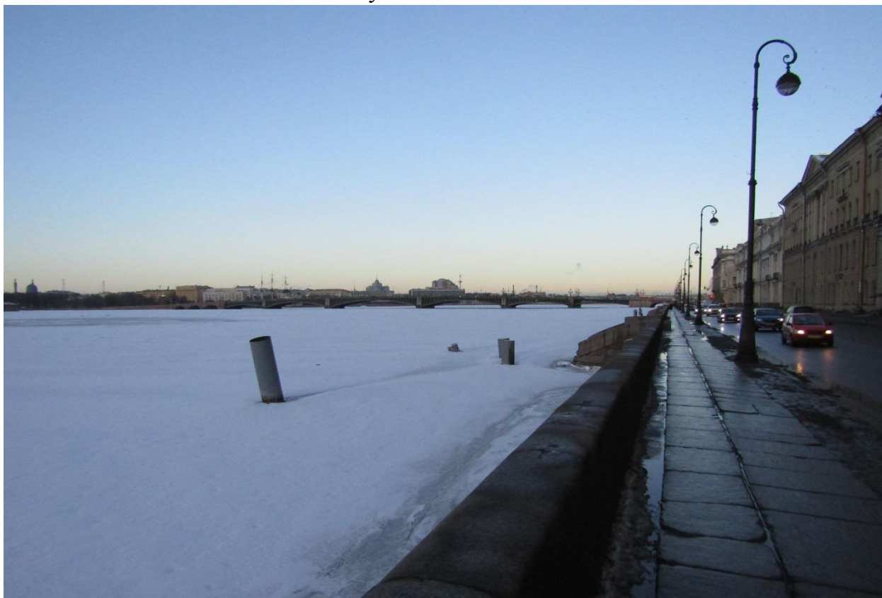
Фото 2. Вид на спуск № 4 объекта культурного наследия федерального значения «Спуски лестничные»
