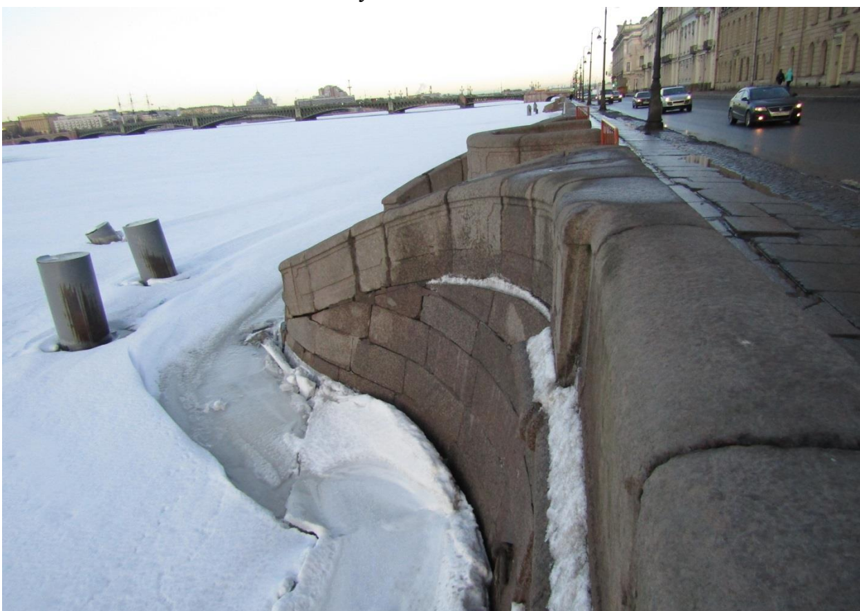
Фото 4. Вид на спуск №4 объекта культурного наследия федерального значения «Спуски лестничные»
