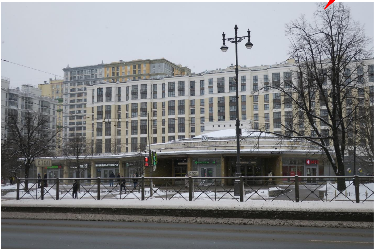
13. Объект реконструкции - здание, расположенное по адресу: г. Санкт-Петербург, Московский пр., д. 71, литера А. Зона производства работ. 07.03.2023
