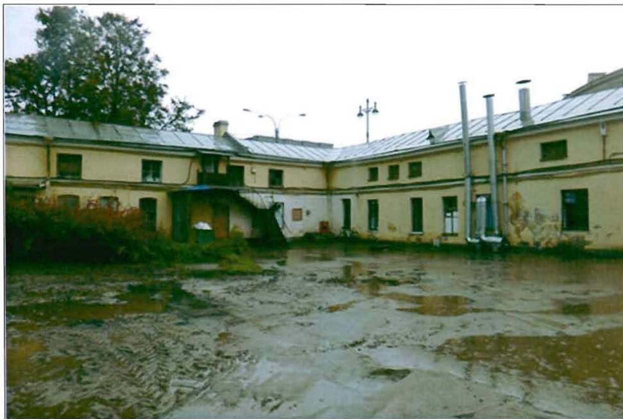
9. Северный флигель. Общий вид с юго-запада.
