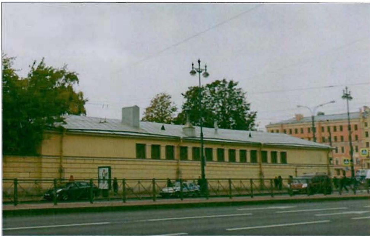
8. Северный флигель. Общий вид с юго-востока
