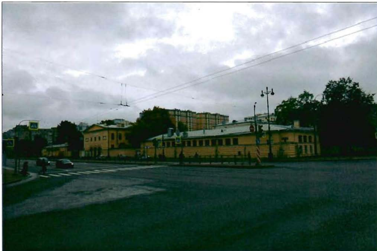
1. Общий вид с северо-востока.
