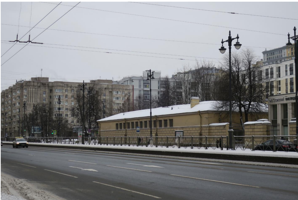
2. Вид на объект культурного наследия федерального значения «Скотопригонный двор. Флигели (два). Флигель», расположенного по адресу: г. Санкт-Петербург, Московский пр., д. 65, литера Ц, и объект реконструкции, в линии Московского проспекта. 07.03.2023
