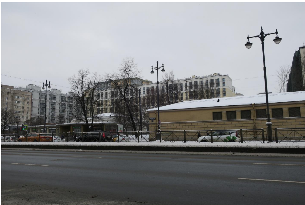
10. Восточный фасад объекта культурного наследия федерального значения «Скотопригонный двор. Флигели (два). Флигель», расположенного по адресу: г. Санкт-Петербург, Московский пр., д. 65, литера Ц. Фрагмент. 07.03.2023
