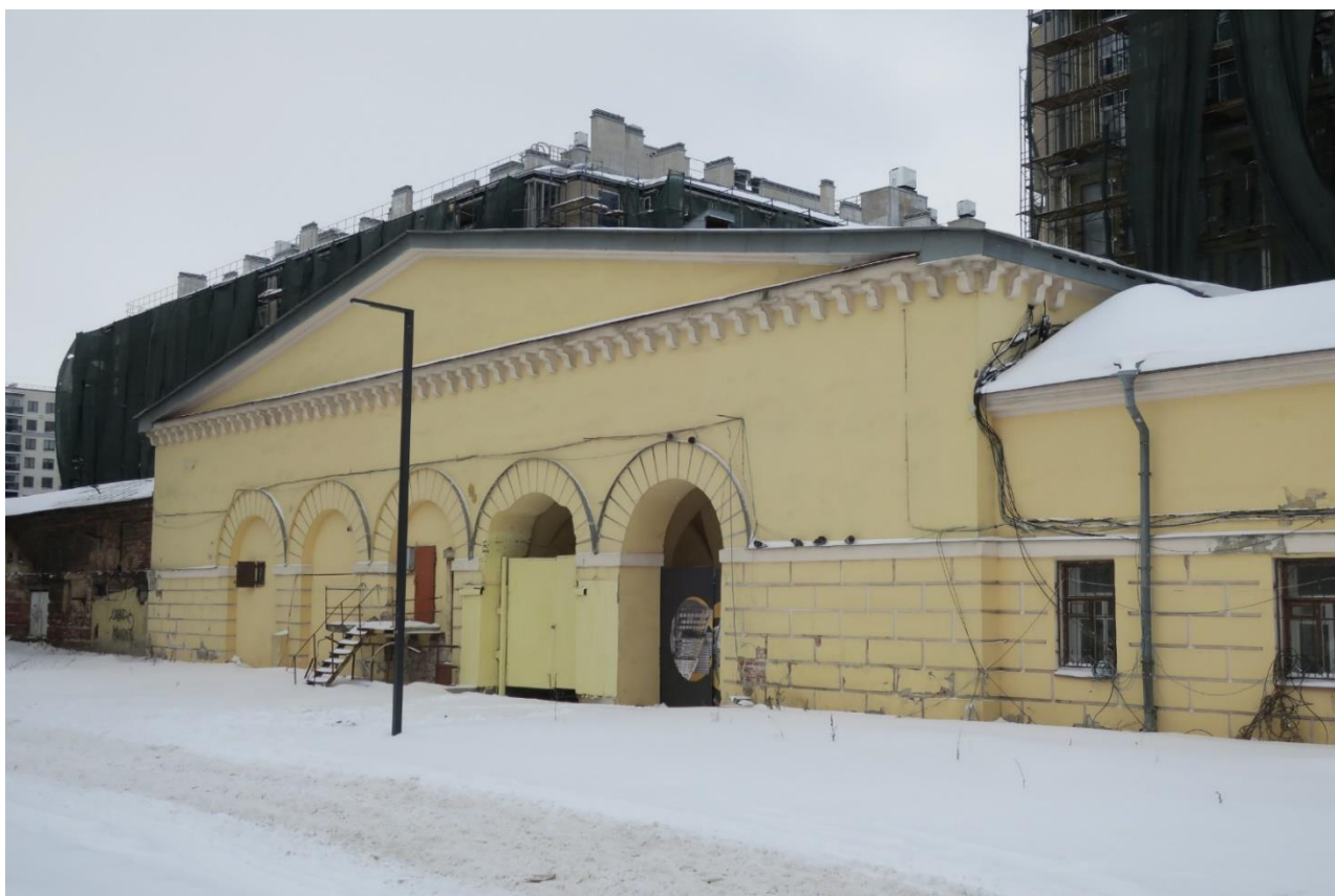
8. Южный фасад объекта культурного наследия федерального значения «Скотопригонный двор. Флигели (два). Флигель», расположенного по адресу: г. Санкт-Петербург, Московский пр., д. 65, литера Ц. Фрагмент. 07.03.2023
