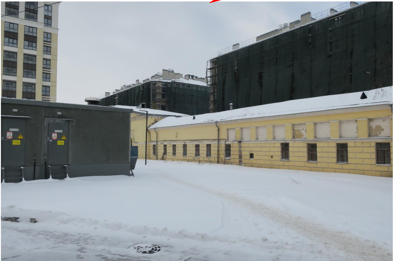
7. Южный фасад объекта культурного наследия федерального значения «Скотопригонный двор. Флигели (два). Флигель», расположенного по адресу: г. Санкт-Петербург, Московский пр., д. 65, литера Ц. Фрагмент. 07.03.2023
