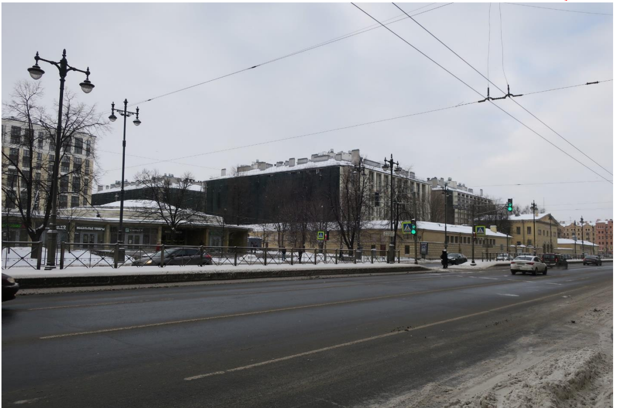
1. Вид на объект культурного наследия федерального значения «Скотопригонный двор. Флигели (два). Флигель», расположенного по адресу: г. Санкт-Петербург, Московский пр., д. 65, литера Ц, и объект реконструкции в линии Московского проспекта. 07.03.2023
