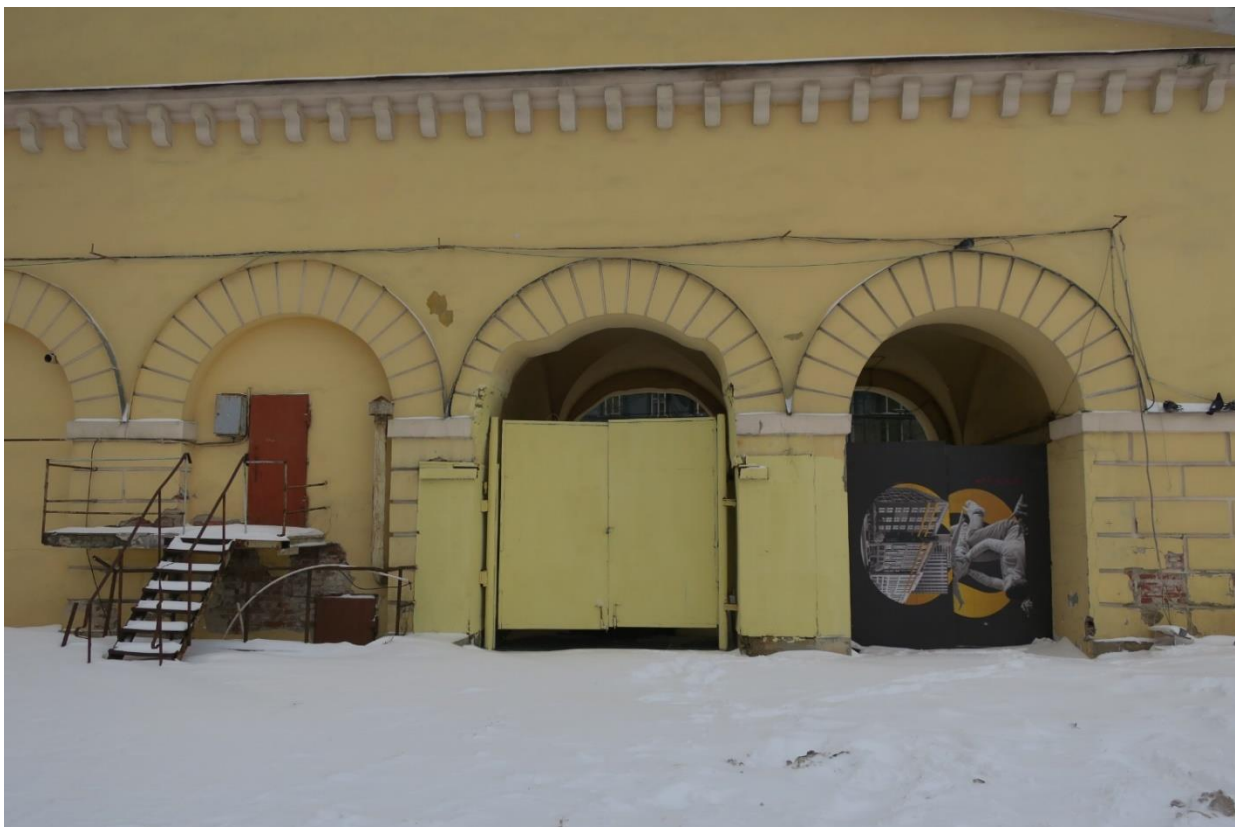
9. Южный фасад объекта культурного наследия федерального значения «Скотопригонный двор. Флигели (два). Флигель», расположенного по адресу: г. Санкт-Петербург, Московский пр., д. 65, литера Ц. Фрагмент. 07.03.2023
