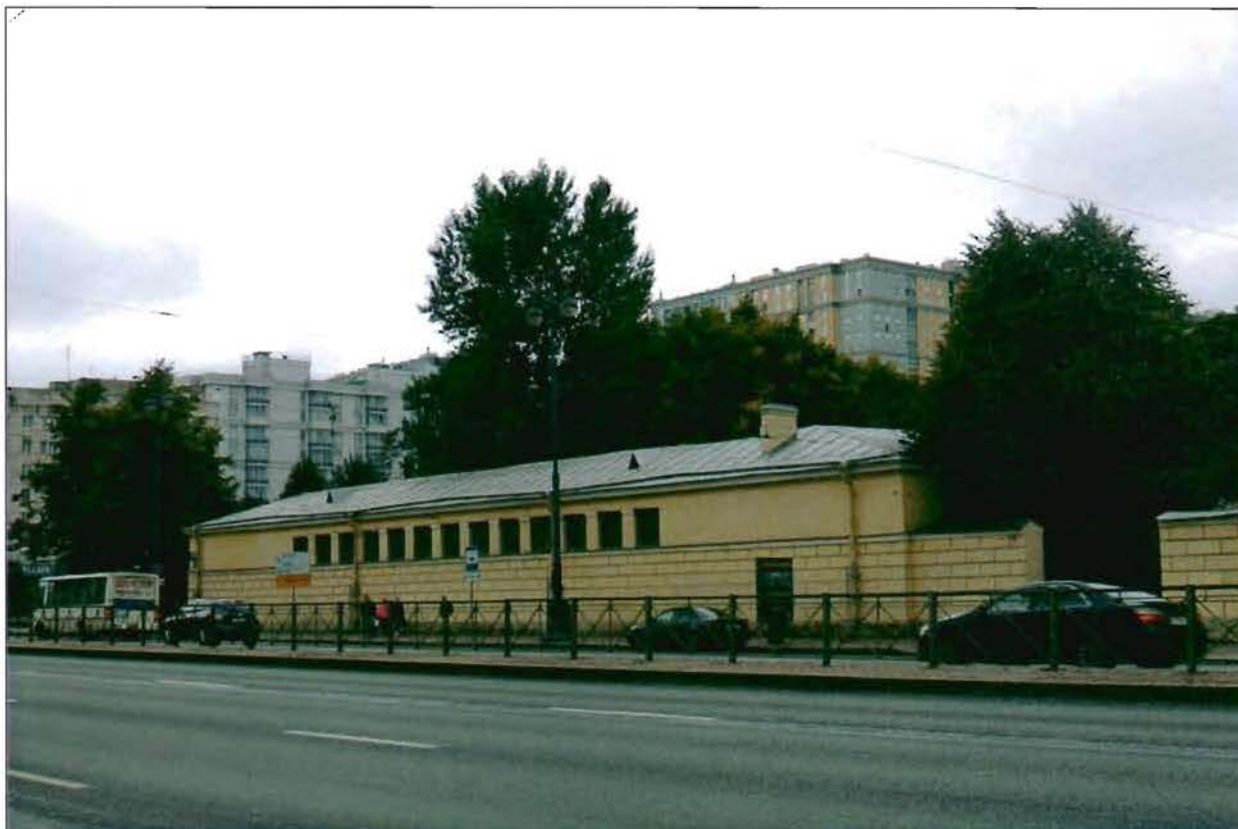
4. Южный флигель. Общий вид с северо-востока
