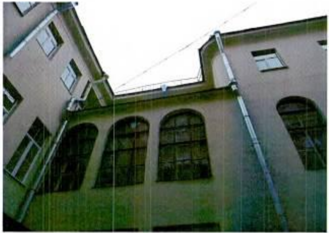
3. Фасады дворовых флигелей.
