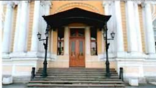
2. Фрагмент лицевого фасада
