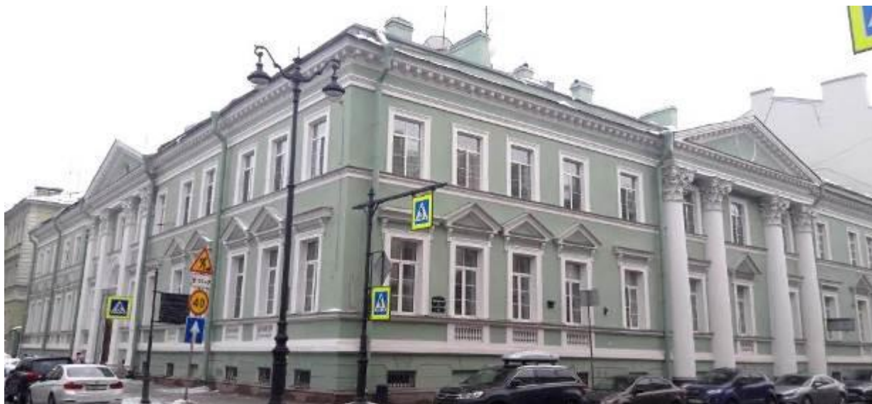
28. Главная аптека. Миллионная улица, дом 4/1, литера А. Лицевой фасад. Фото мест установки оборудования и кабельных трасс. Штиглиц М.С. 10.01.2022.
