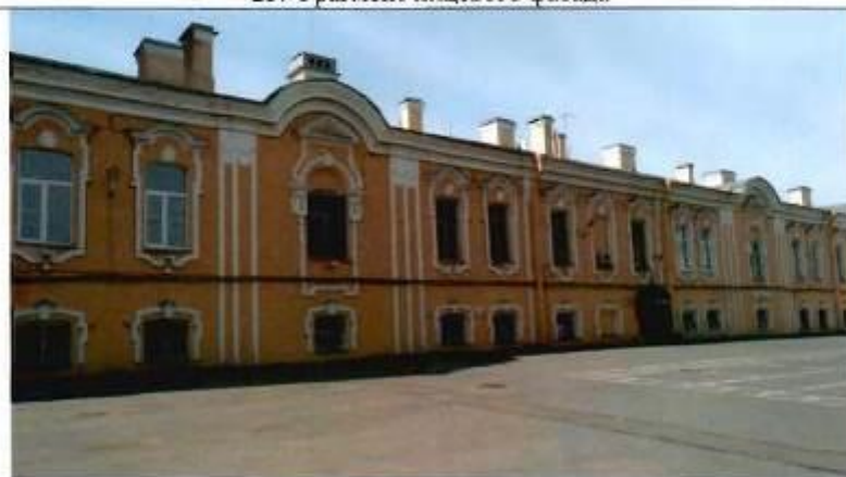
24. Фрагмент дворового фасада
