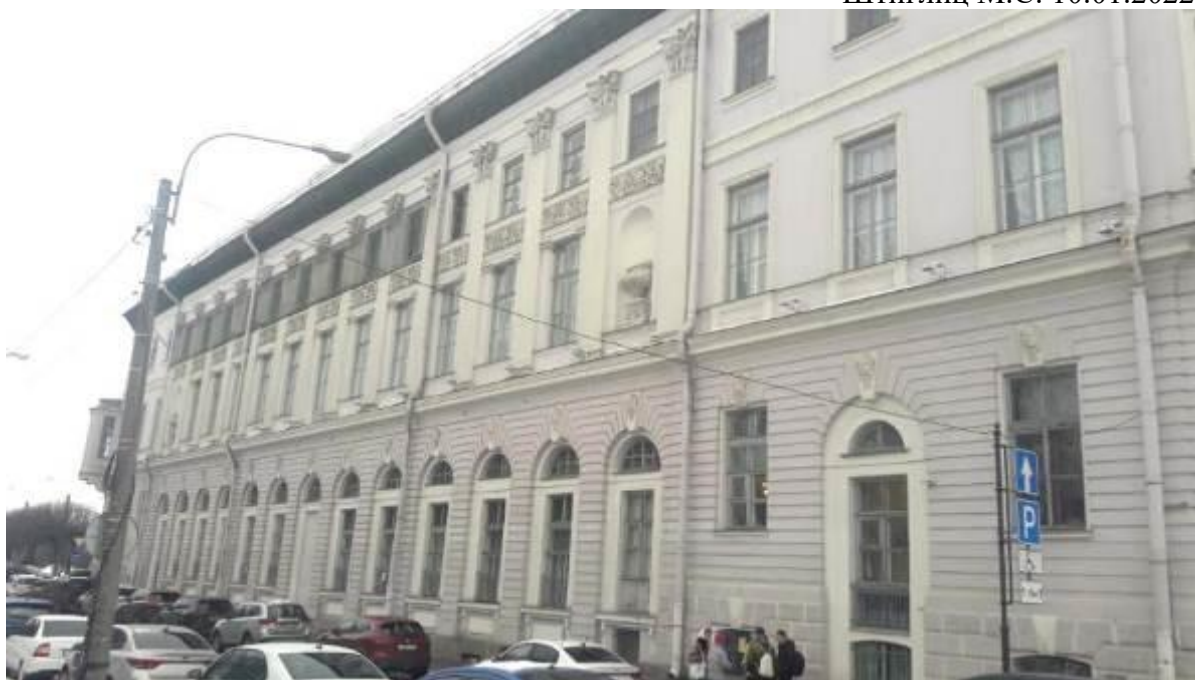
25. Дом Бецкого И.И. (принца Ольденбургского П.Г.). Миллионная улица, дом 1, литера А. Лицевой фасад. Фото мест установки оборудования и кабельных трасс. Штиглиц М.С. 10.01.2022.
