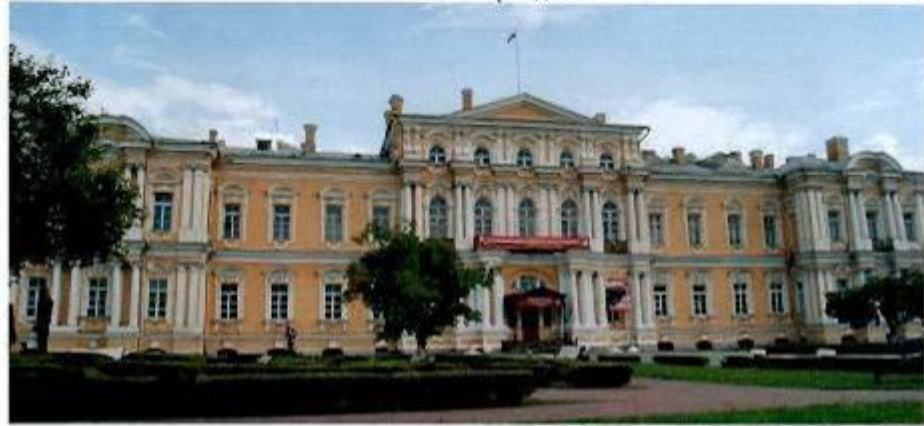
2. Фрагмент лицевого фасада.
