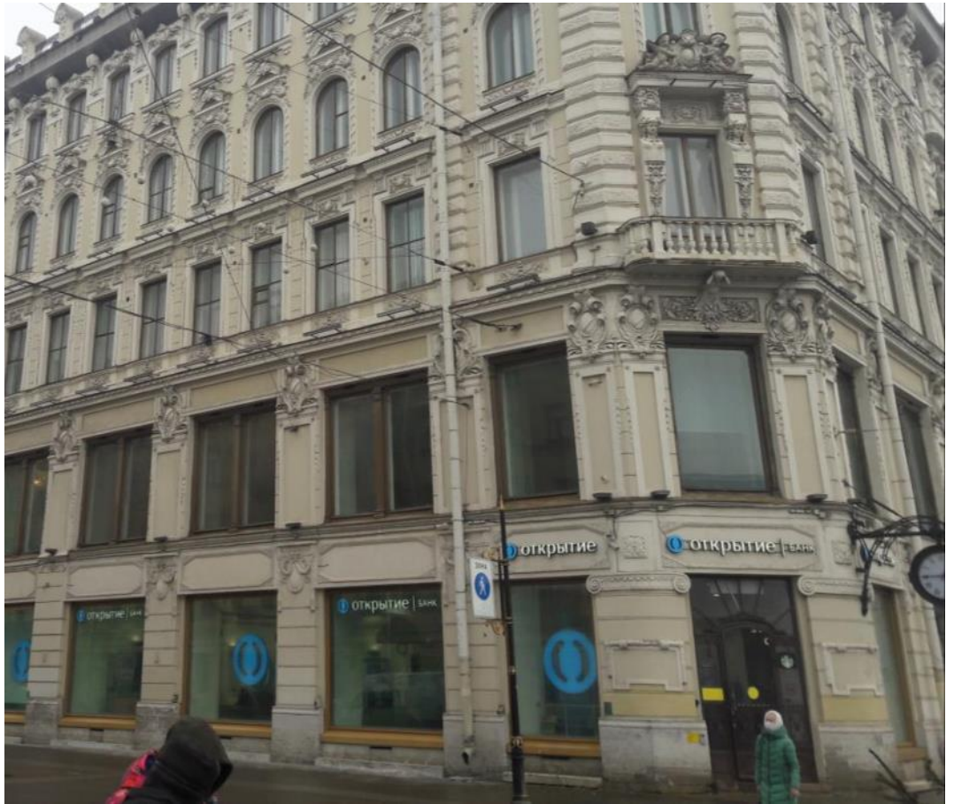
20. Дом Г.И. Гансена. Малая Конюшенная улица, дом 16/26, литера А. Лицевой фасад. Фото мест установки оборудования и кабельных трасс. Штиглиц М.С. 10.01.2022.
