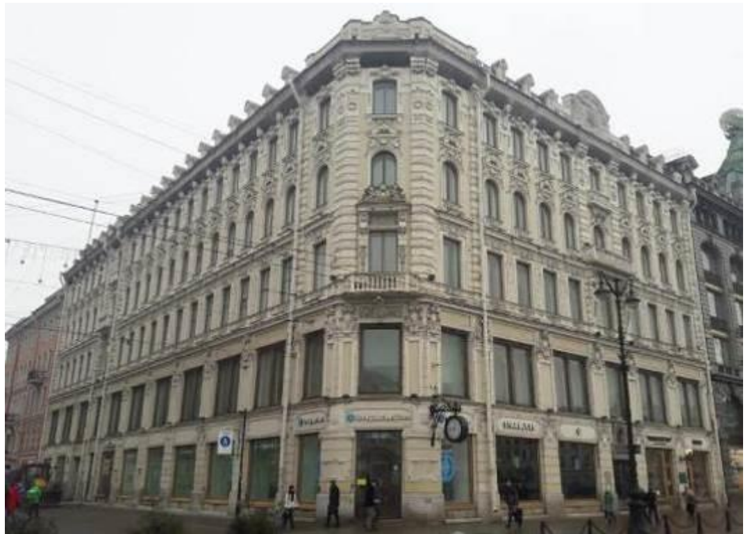
19. Дом Г.И. Гансена. Малая Конюшенная улица, дом 16/26, литера А. Лицевой фасад. Фото мест установки оборудования и кабельных трасс. Штиглиц М.С. 10.01.2022.
