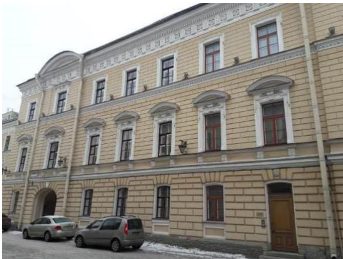
39. Главное здание (концертный зал с учебными флигелями). Капелла Придворная певческая. Набережная реки Мойки, дом 20, литера А. Лицевой фасад. Фото мест установки оборудования и кабельных трасс. Штиглиц М.С. 10.01.2022.
