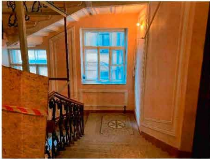
3. Общий вид на парадную лестницу объекта культурного наследия.
