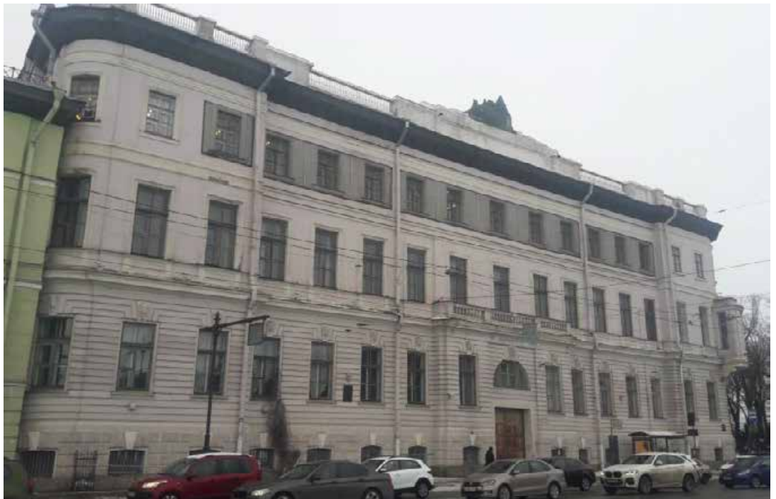
23. Дом Бецкого И.И. (принца Ольденбургского П.Г.). Миллионная улица, дом 1, литера А. Лицевой фасад. Фото мест установки оборудования и кабельных трасс. Штиглиц М.С. 10.01.2022.
