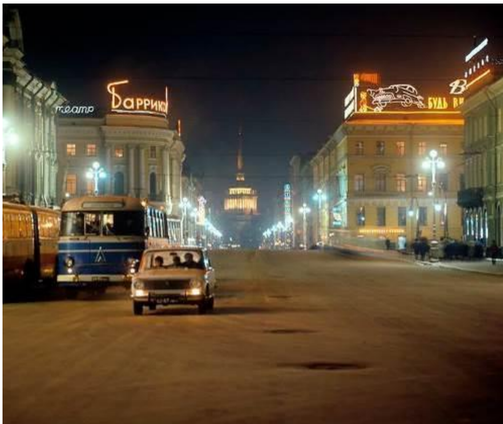
28. Дом Котомина К.Б. Большая Морская ул., д. 6, лит. А, опора освещения (Невский пр., д. 18, лит. А, опора освещения). Фото 1970-е гг. (25)
