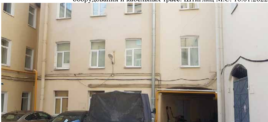
33. Дом жилой с дворовыми флигелями. Дом Пашковой Е.П. (посольство Франции). Набережная Кутузова, дом 10, литера А. Дворовые фасады. Фото мест установки оборудования и кабельных трасс. Штиглиц М.С. 10.01.2022.
