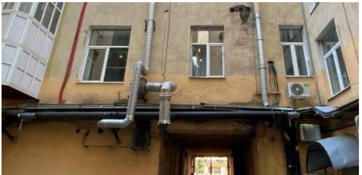
21. Дом Г.И. Гансена. Малая Конюшенная улица, дом 16/26, литера А. Дворовые фасады. Фото мест установки оборудования и кабельных трасс. Штиглиц М.С. 10.01.2022
