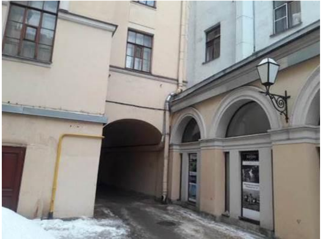
18. Корпус квартирный с флигелями. Капелла Придворная певческая. Большая Конюшенная улица, дом 11, литера Б. Дворовые фасады. Фото мест установки оборудования и кабельных трасс. Штиглиц М.С. 10.01.2022.
