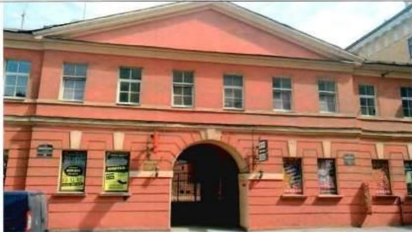
19. Фрагмент лицевого фасада
