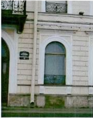
2. Окно 1-го этажа. Вид с наб. Кутузова.
