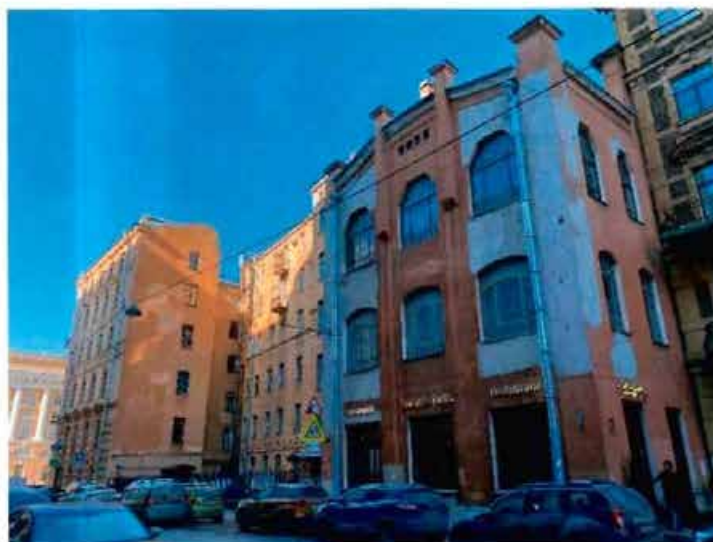
2. Общий вид на объект культурного наследия.
