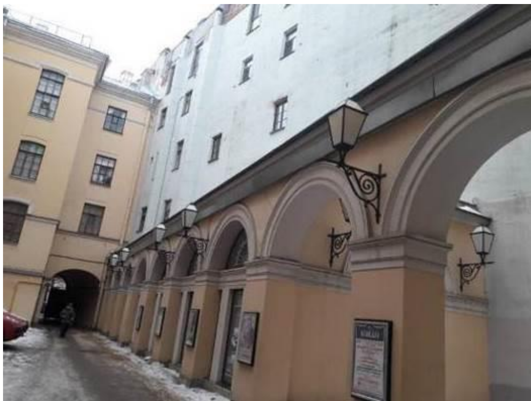
17. Корпус квартирный с флигелями. Капелла Придворная певческая. Большая Конюшенная улица, дом 11, литера Б. Дворовые фасады. Фото мест установки оборудования и кабельных трасс. Штиглиц М.С. 10.01.2022.
