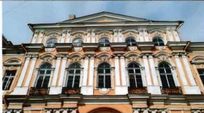
4. Фрагмент дворового фасада
