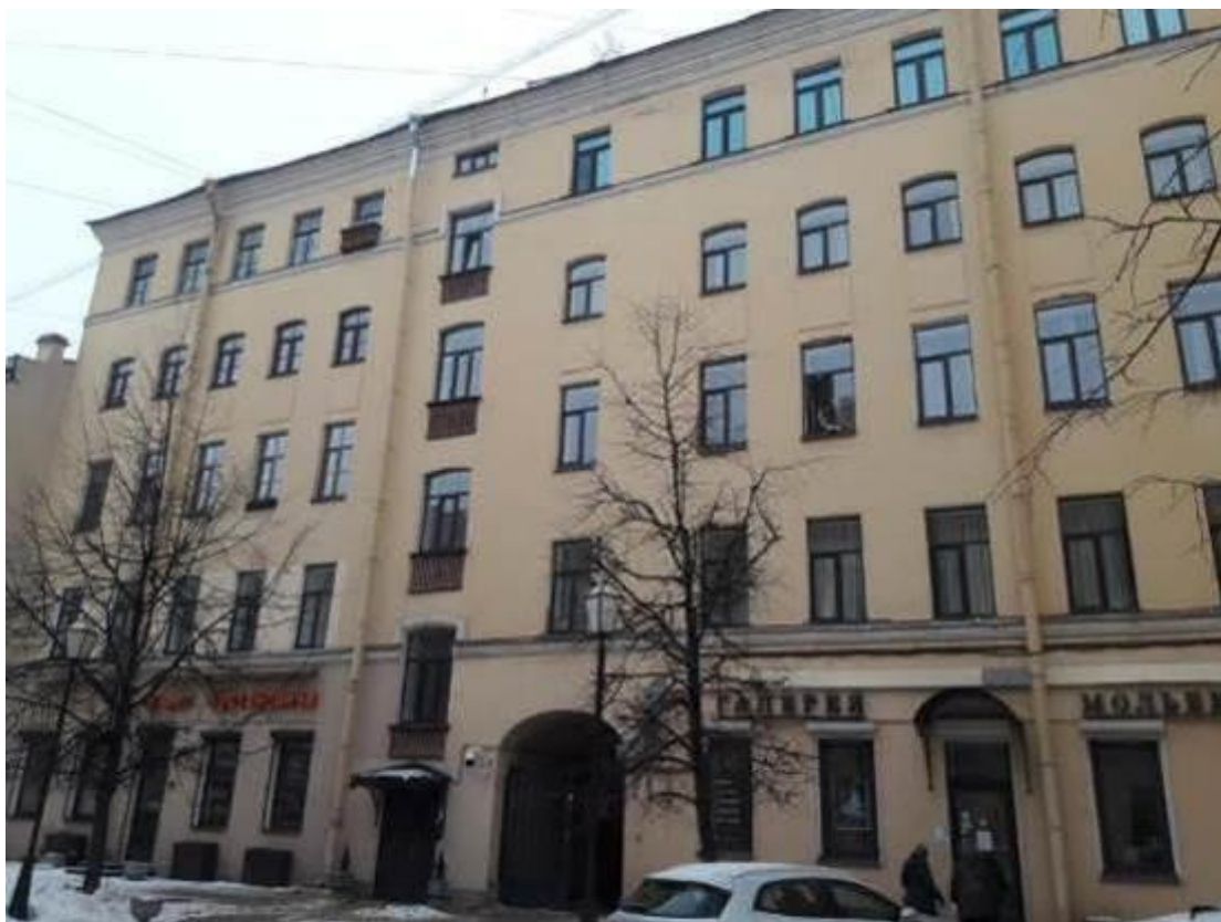
15. Корпус квартирный с флигелями. Капелла Придворная певческая. Большая Конюшенная улица, дом 11, литера Б. Западный фасад. Фото мест установки оборудования и кабельных трасс. Штиглиц М.С.
