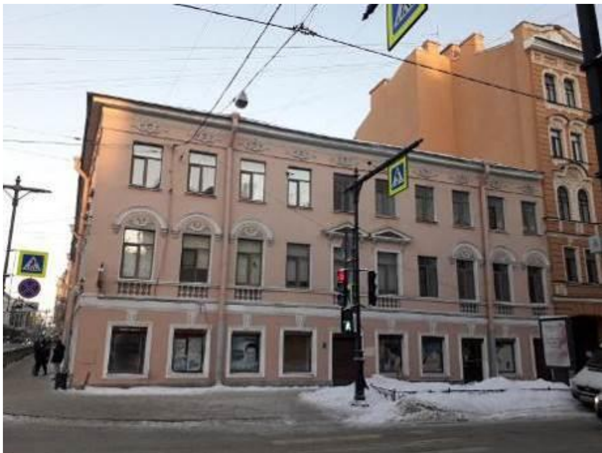
1. Дом А. Александровой. 3-я Советская ул., д. 20/5, лит. А. Лицевой фасад. Фото мест установки оборудования и кабельных трасс. Штиглиц М.С. 10.01.2022.
