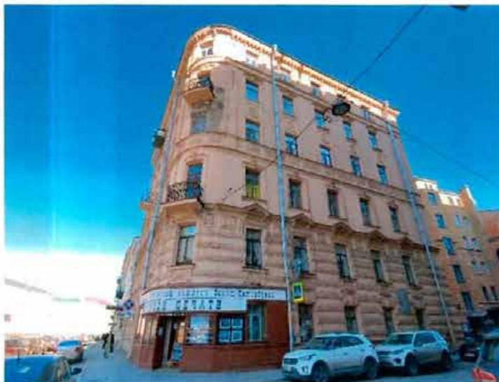
1. Общий вид на объект культурного наследия.
