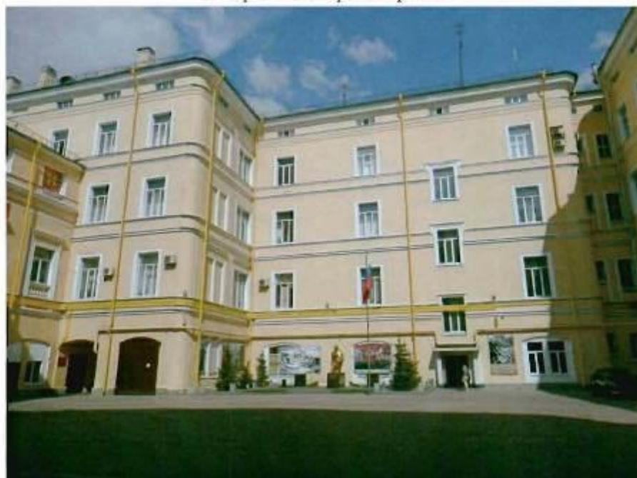
3. Фрагмент дворового фасада
