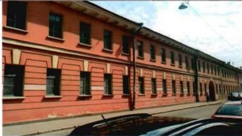
20. Фрагмент лицевого фасада
