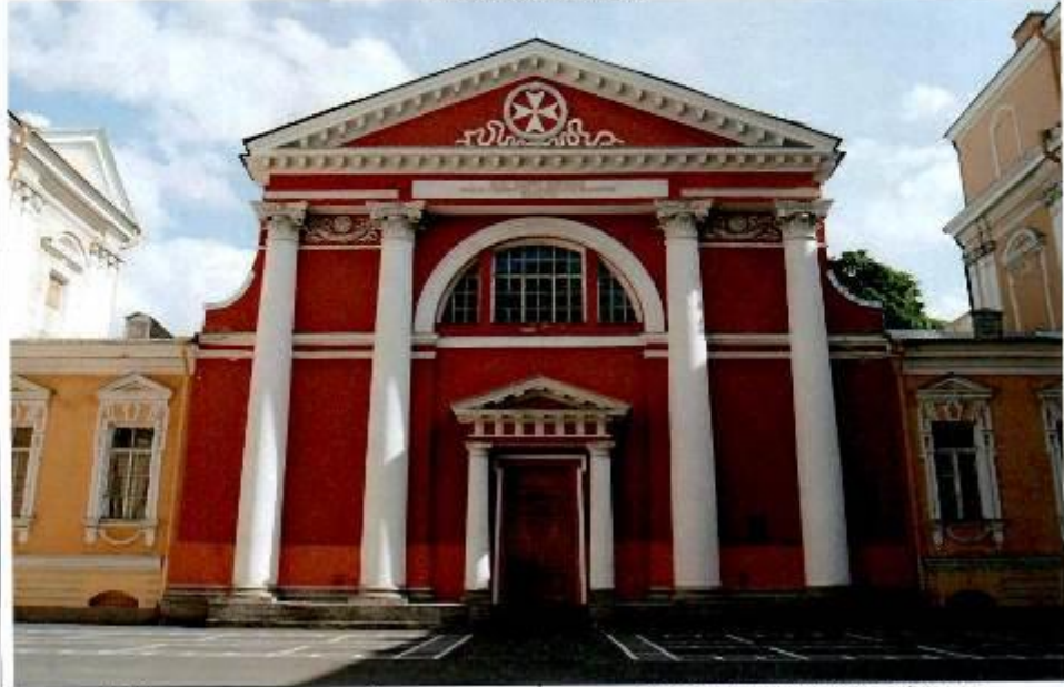
15. Фрагмент дворового фасада.
