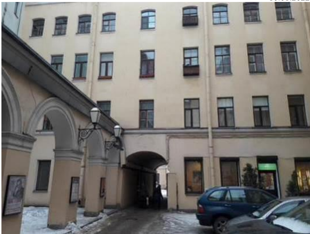
16. Корпус квартирный с флигелями. Капелла Придворная певческая. Большая Конюшенная улица, дом 11, литера Б. Дворовые фасады. Фото мест установки оборудования и кабельных трасс. Штиглиц М.С. 10.01.2022.
