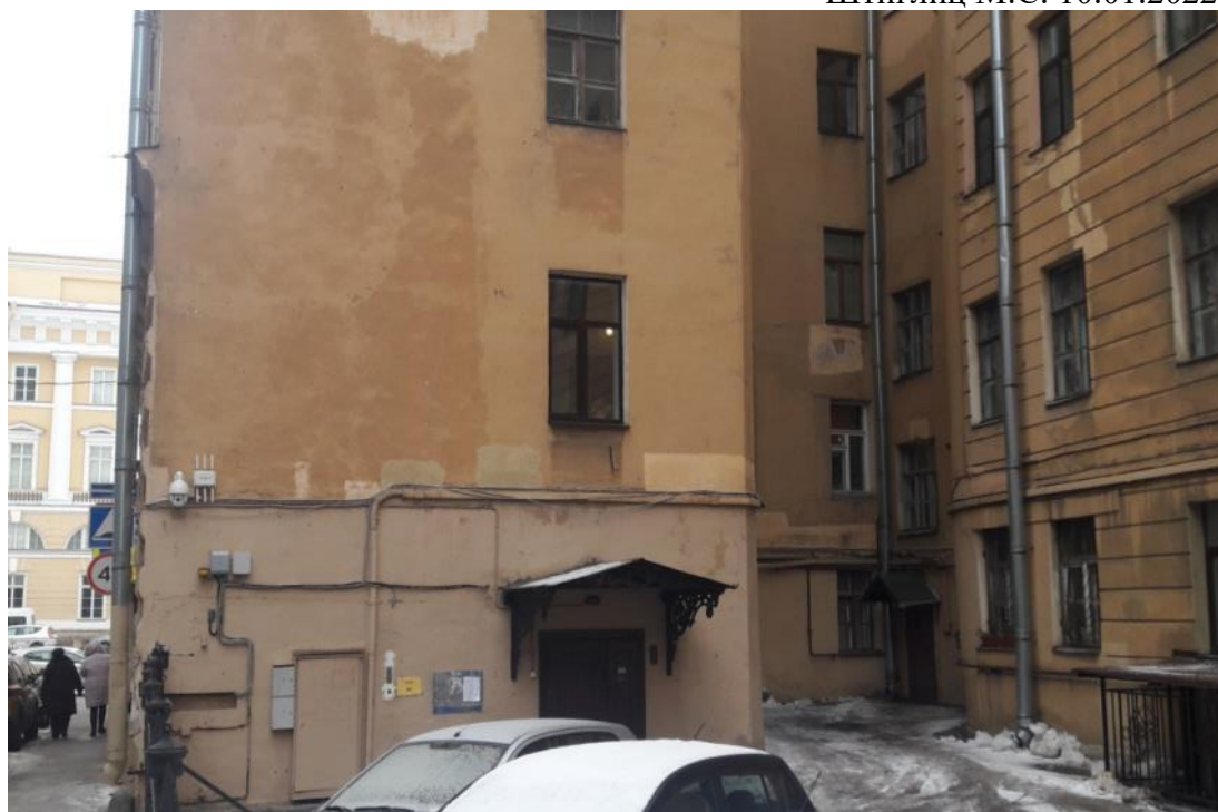
44. Типография Министерства внутренних дел. Набережная реки Мойки, дом 32, литера А. Дворовые фасады. Фото мест установки оборудования и кабельных трасс. Штиглиц М.С. 10.01.2022.
