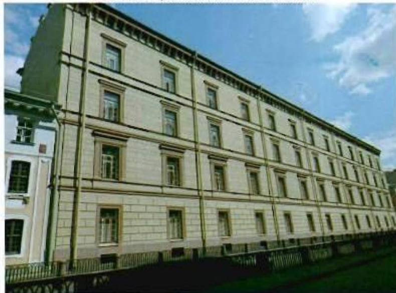
2. Лицевой фасад с наб. Зимней канавки
