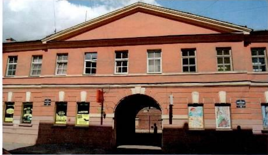
30. Фрагмент лицевого фасада.
