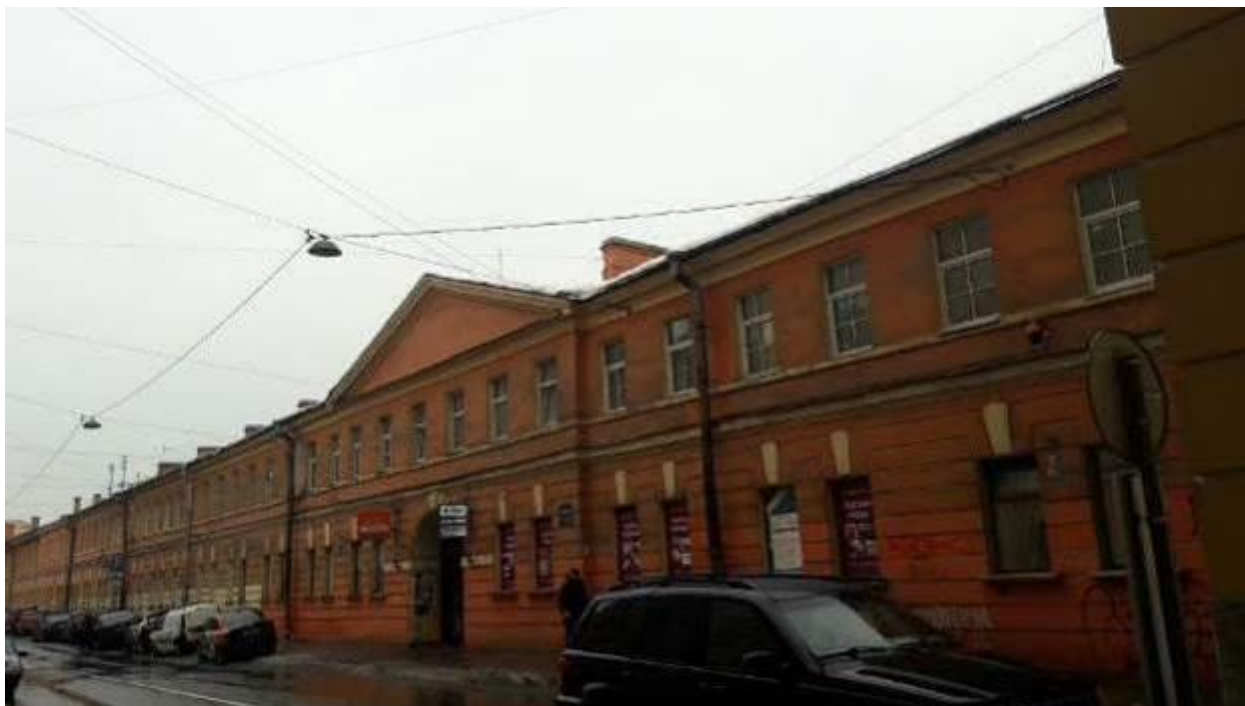
45. Службы (три корпуса). Дворец Воронцова М.И. (Пажеский корпус). Садовая улица, дом 26, литера А. Лицевой фасад. Фото мест установки оборудования и кабельных трасс. Штиглиц М.С. 10.01.2022.
