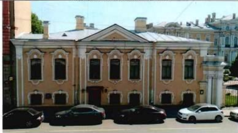
23. Фрагмент лицевого фасада
