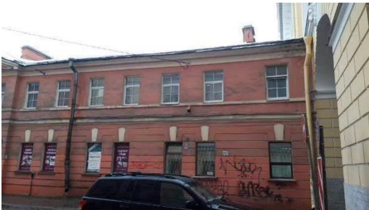
46. Службы (три корпуса). Дворец Воронцова М.И. (Пажеский корпус). Садовая улица, дом 26, литера А. Лицевой фасад. Фото мест установки оборудования и кабельных трасс. Штиглиц М.С. 10.01.2022.
