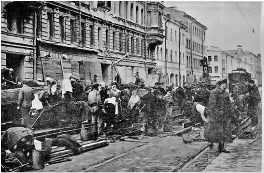
Первый налет фашистских стратегических бомбардировщиков на Ленинград. Восстановительные работы на мостовой пр. 25-го Октября напротив дома 121, куда попала авиабомба. 7 сентября 1941 г.
