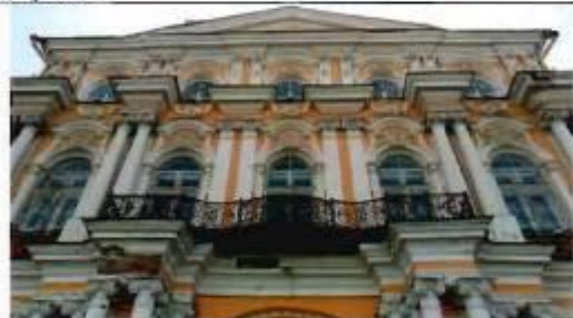
3. Фрагмент лицевого фасада
