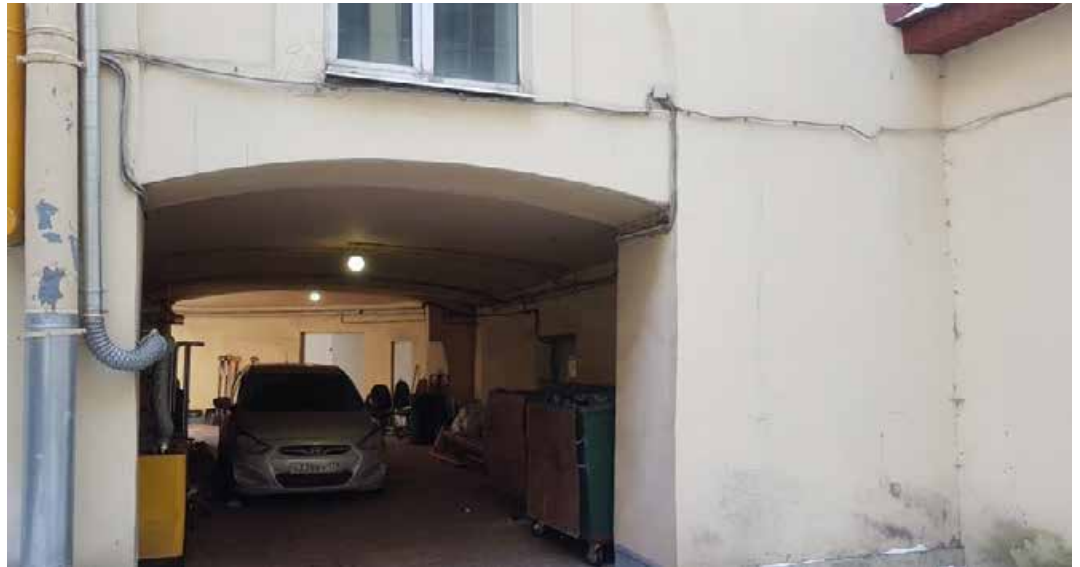
35. Дом жилой с дворовыми флигелями. Дом Пашковой Е.П. (посольство Франции). Набережная Кутузова, дом 10, литера А. Дворовые фасады. Фото мест установки оборудования и кабельных трасс. Штиглиц М.С. 10.01.2022.
