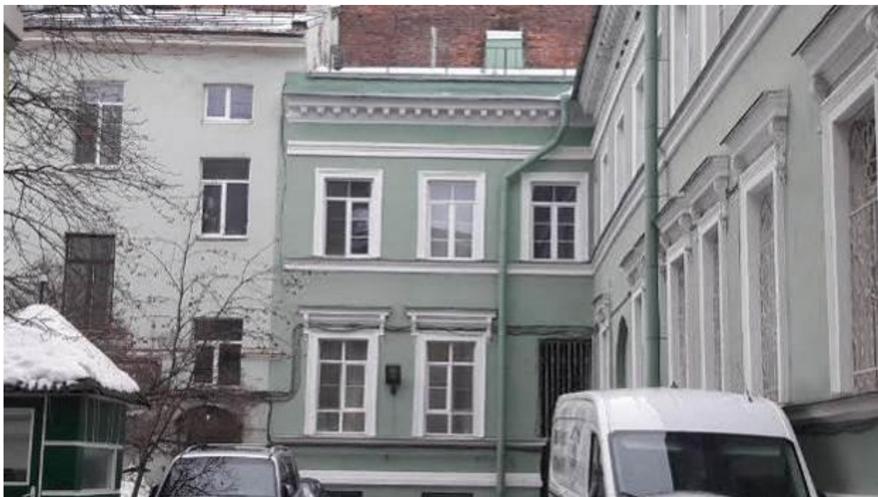
30. Главная аптека. Миллионная улица, дом 4/1, литера А. Дворовые фасады. Фото мест установки оборудования и кабельных трасс. Штиглиц М.С. 10.01.2022.
