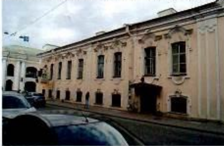
34. Фрагмент липового фасада западного флигеля.
