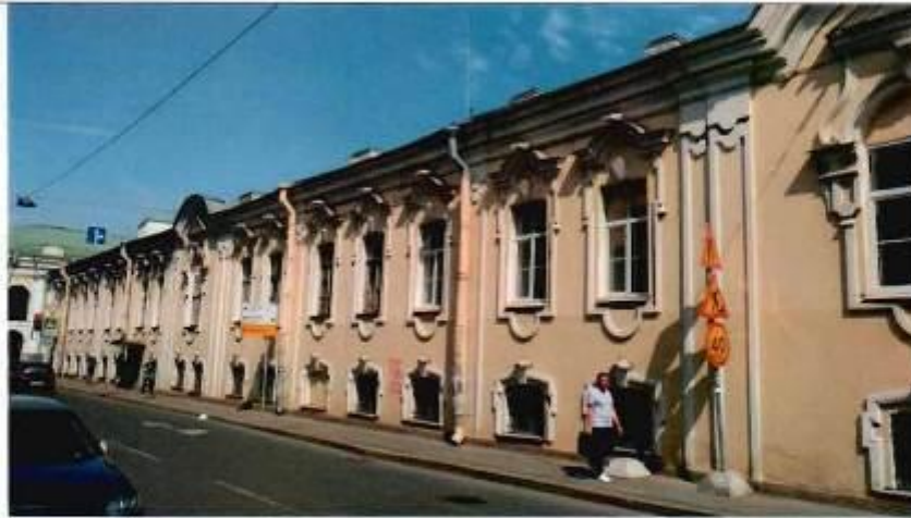
22. Фрагмент лицевого фасада
