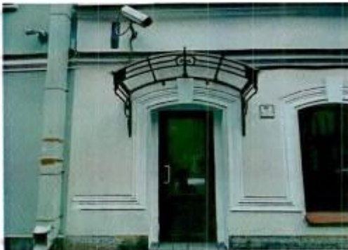
6. Вход. Вид с улицы Шпалерная.
