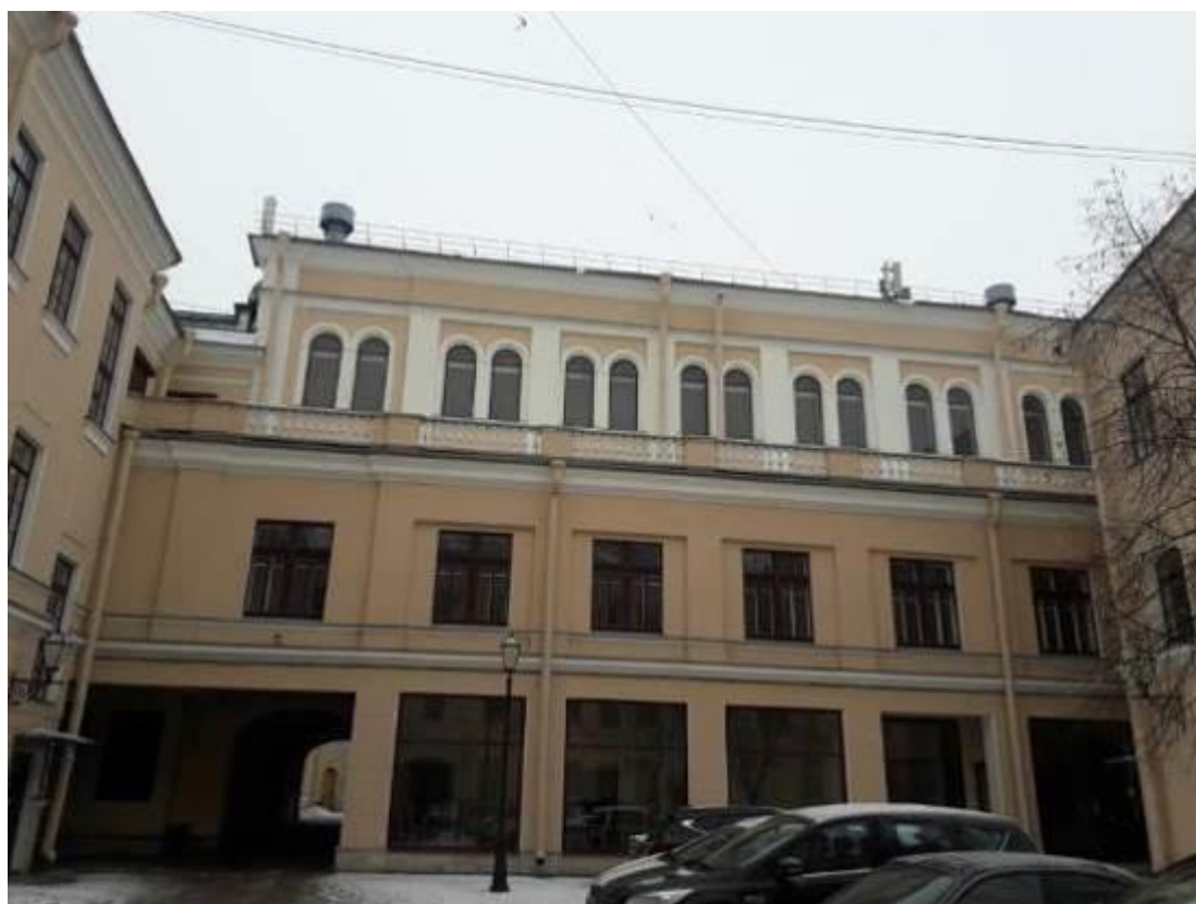
40. Главное здание (концертный зал с учебными флигелями). Капелла Придворная певческая. Набережная реки Мойки, дом 20, литера А. Дворовые фасады. Фото мест установки оборудования и кабельных трасс. Штиглиц М.С. 10.01.2022.
