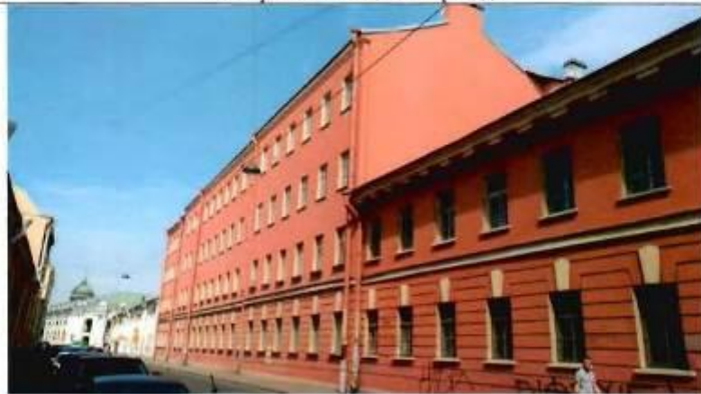
21. Фрагмент лицевого фасада
