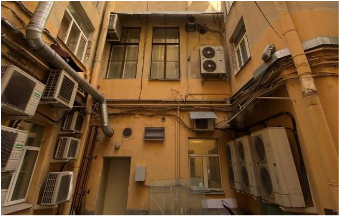
22. Дом Г.И. Гансена. Малая Конюшенная улица, дом 16/26, литера А. Дворовые фасады. Фото мест установки оборудования и кабельных трасс. Штиглиц М.С. 10.01.2022.
