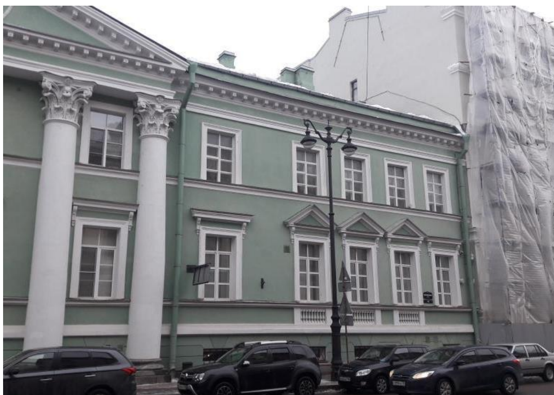
29. Главная аптека. Миллионная улица, дом 4/1, литера А. Лицевой фасад. Фото мест установки оборудования и кабельных трасс. Штиглиц М.С. 10.01.2022.
