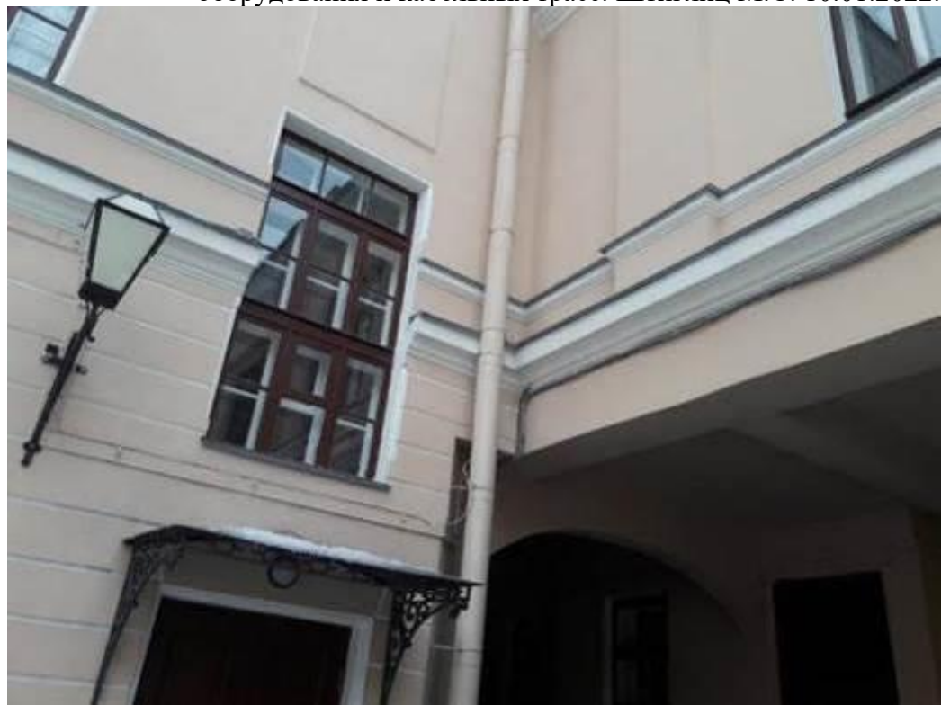
42. Главное здание (концертный зал с учебными флигелями). Капелла Придворная певческая. Набережная реки Мойки, дом 20, литера А. Дворовые фасады. Фото мест установки оборудования и кабельных трасс. Штиглиц М.С. 10.01.2022.
