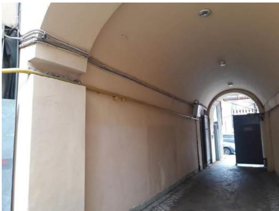
13. Корпус квартирный с флигелями. Капелла Придворная певческая. Большая Конюшенная улица, дом 11, литера А. Арочный проезд. Фото мест установки оборудования и кабельных трасс. Штиглиц М.С. 10.01.2022.
