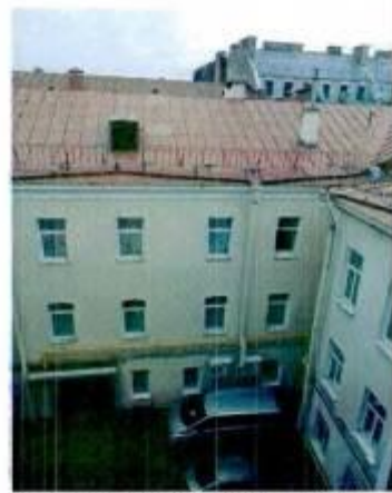
5. Фасады дворовых флигелей.
