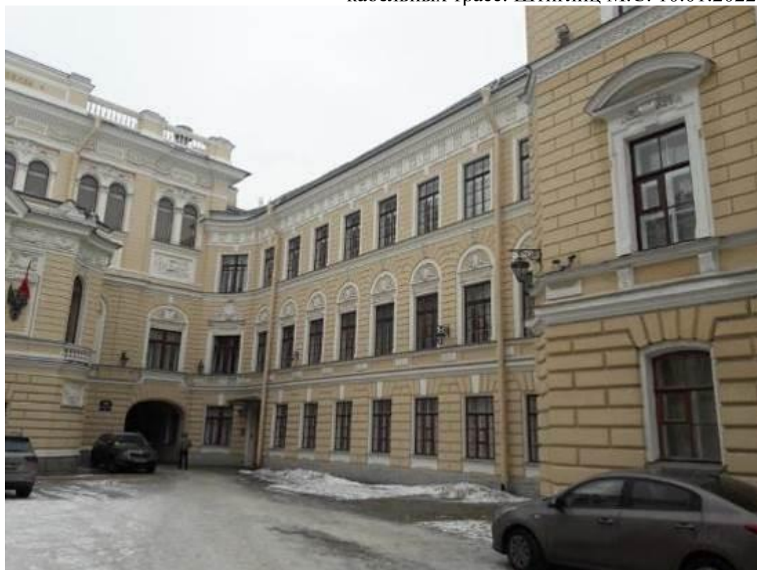
38. Главное здание (концертный зал с учебными флигелями). Капелла Придворная певческая. Набережная реки Мойки, дом 20, литера А. Лицевой фасад. Фото мест установки оборудования и кабельных трасс. Штиглиц М.С. 10.01.2022.
