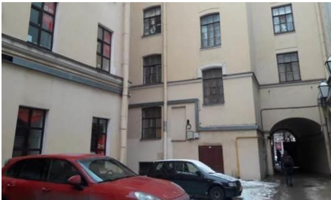
12. Корпус квартирный с флигелями. Капелла Придворная певческая. Большая Конюшенная улица, дом 11, литера А. Дворовые фасады. Фото мест установки оборудования и кабельных трасс. Штиглиц М.С. 10.01.2022.
