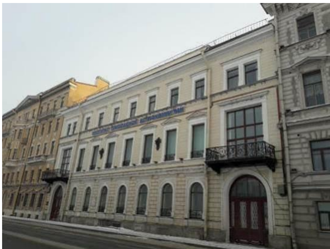
31. Дом жилой с дворовыми флигелями. Дом Пашковой Е.П. (посольство Франции). Набережная Кутузова, дом 10, литера А. Лицевой фасад. Фото мест установки оборудования и кабельных трасс. Штиглиц М.С. 10.01.2022.
