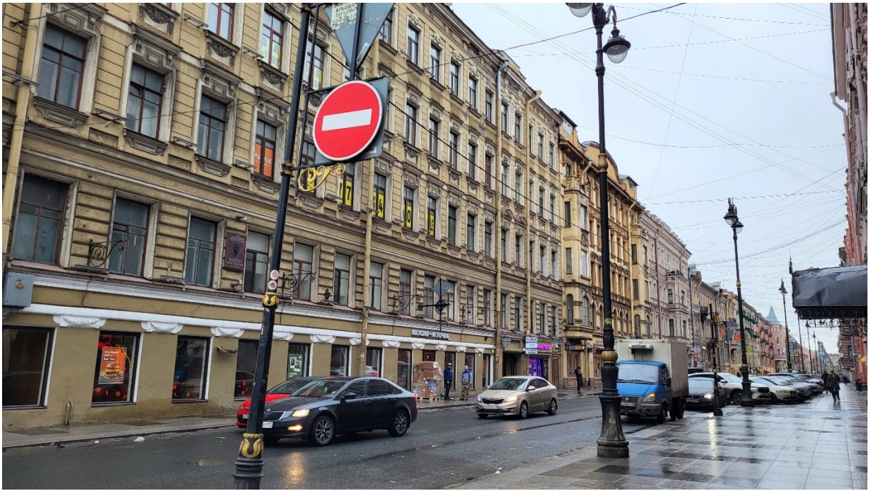
3. Выявленный объект культурного наследия «Дом И.И. Ростовцева» по адресу: Невский пр., 45; Рубинштейна ул., 2. Западный фасад. Дата съемки 01.03.2023.
