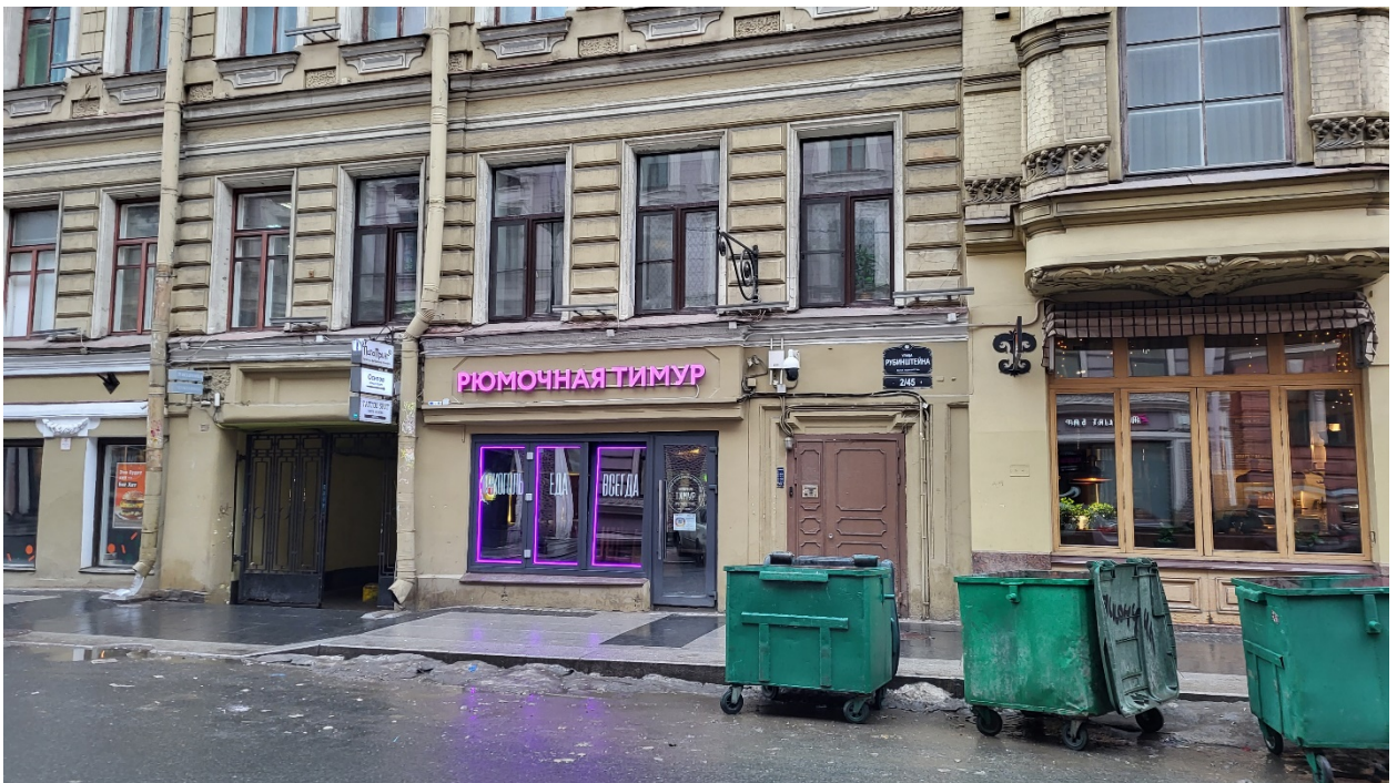
2. Выявленный объект культурного наследия «Дом И.И. Ростовцева» по адресу: Невский пр., 45; Рубинштейна ул., 2. Западный фасад. Дата съемки 01.03.2023.
