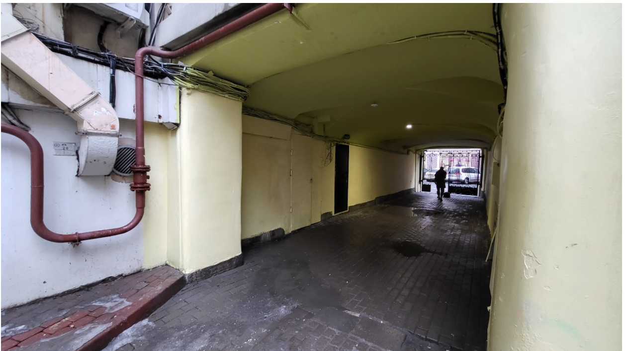
8. Выявленный объект культурного наследия «Дом И.И. Ростовцева» по адресу: Невский пр., 45; Рубинштейна ул., 2. Внутренний двор. Проход во двор. Дата съемки 01.03.2023.
