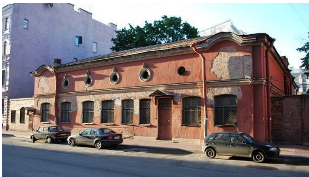
27. Особняк И.К. Мясникова (К.А. Варгунина). Служебный флигель. Общий вид с Гродненского переулка. Фотография. Начало 2000-х гг. http://www.citywalls.ru .
