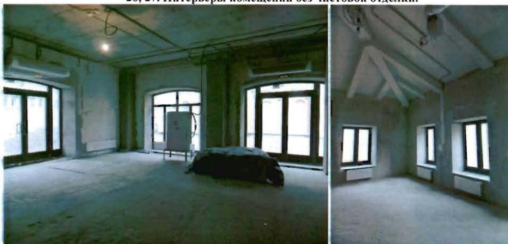
26, 27. Интерьеры помещений без чистовой отделки.
