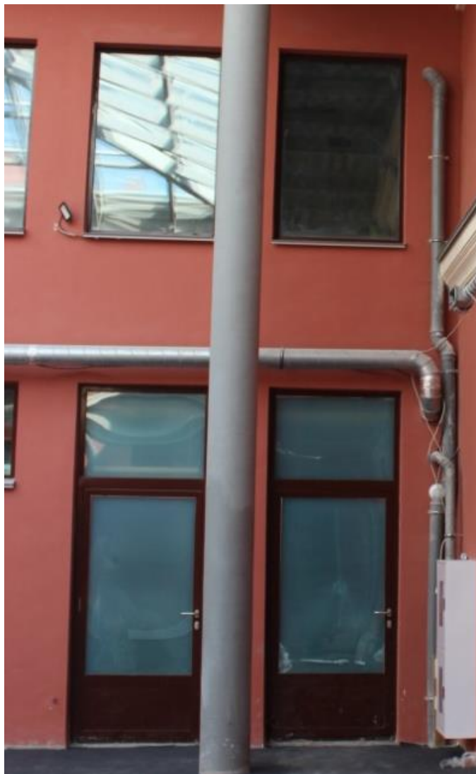
38. Здание по адресу: г. Санкт-Петербург, улица Восстания, дом 45, литера В. Фрагмент фасада со стороны внутреннего двора.
