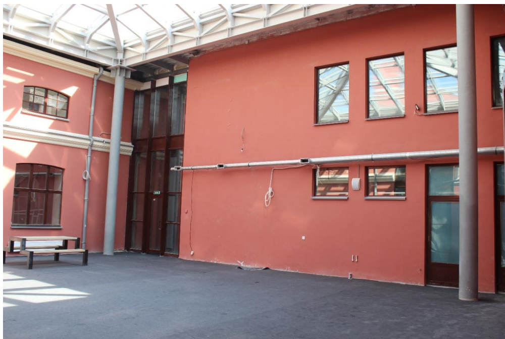
37. Здание по адресу: г. Санкт-Петербург, улица Восстания, дом 45, литера В. Вид со стороны внутреннего двора. Конструкции светового фонаря внутреннего двора.
