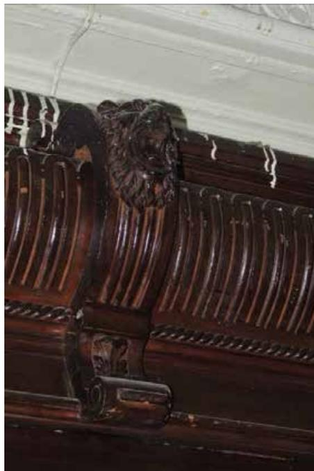
оформление плафона – кессоны, с профилированными карнизами с лепными пальметтами и пучками из листа аканта (чередуются через один); по периметру плафона – профилированный карниз декорированный ложчатым орнаментом;
