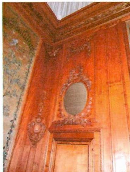
заполнение дверного проема (из Кленовой в Красную гостиную) – материал (клен), конструкция (двухстворчатые), оформление (профилированные филенки, по две на каждой створке, верхние вытянуты по вертикали, с резными композициями в виде: на гирлянды из листьев в виде волют опирается стебель с почками с завершением из вазона с букетом из цветов и листьев. К стеблю крепится картуш с монограммой Ф (?) Д, выше две бабочки, в верхней части – провисающая гирлянда с фестонами из цветов и листьев);
