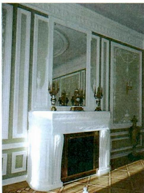
лентами. Топочный проем прямоугольный, закрыт двустворчатой дверцей (черного металла?) с ручкой-кнопкой. Справа на стене – дверца выюшки;
