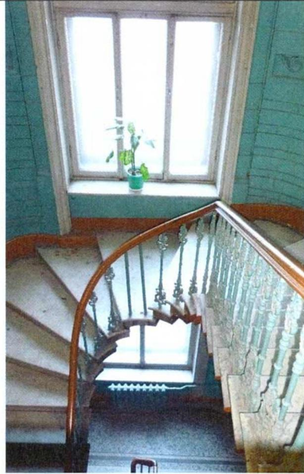
лестница черного хода – местоположение (в уровне цоколя и 1-го этажа), габариты, конфигурация, тип (одномаршевая), конструкция, материал ступеней и площадок (известняк).
