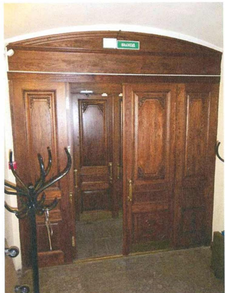
заполнение дверного проема – количество (два), материал (дерево), конструкция (двери двухстворчатые, с боковыми створками и фрамугой с лучковым завершением), количество (две), оформление (по три филенки на каждой створке, с двухсторонней резьбой, верхние филенки остекленные, средние – с поясом меандра, нижние, в центре – профилированные круглые детали);
