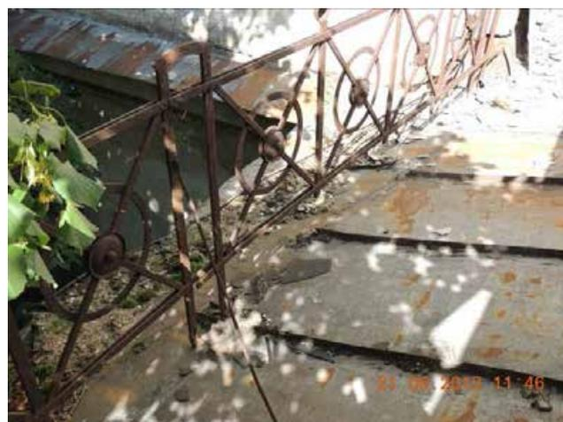
лестница поперечного дворового корпуса – местоположение (над воротным проездом), габариты, конфигурация, конструкция (средистенная, с забежными ступенями на промежуточных площадках), материал (известняк (?)) с металлической окантовкой профилей);
