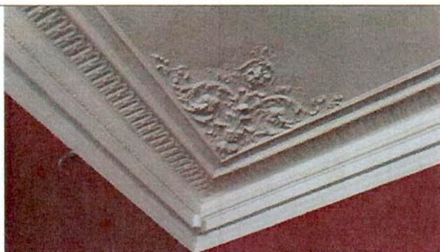
оформление потолка – падуга с профилированными рамами и карнизом с геометрическим орнаментом, в углах и в центральной розетке лепные композиции из цветов и листьев в виде волютообразных завитков;
