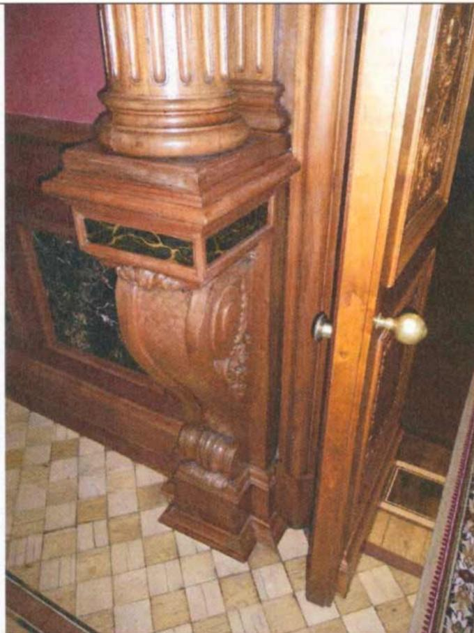
тамбур с дверным проемом – местоположение (в поперечный переход, разделяющий двор дома № 35), габариты, конфигурация (прямоугольная), материал (дуб), оформление (навершие в виде антаблемента с филенчатым фризом, декорированным вставками из зеленого с белыми прожилками мрамора (?) и профилированного выносного карниза, стенки тамбура обшиты филенчатыми панелями);
