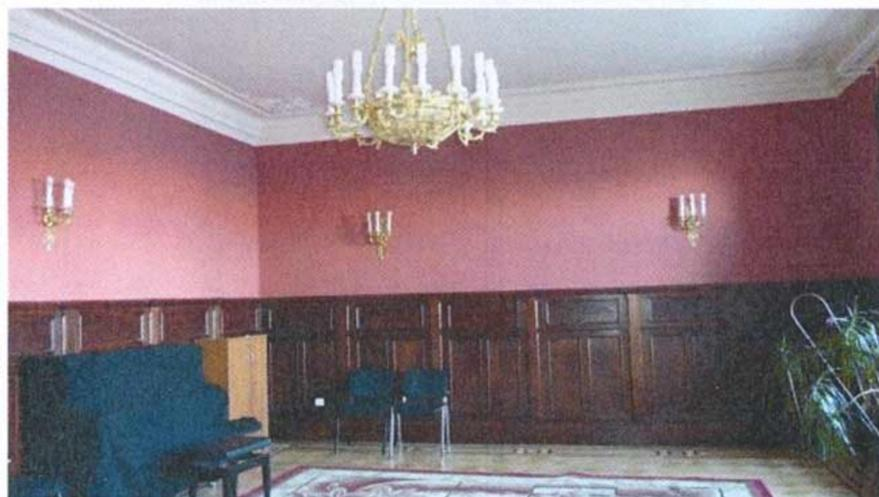
оформление (каждый модуль на три прямоугольные филенки, нижние – вертикальные, верхняя – горизонтальная, между модулями лопатки со стилизованными капителями, профилированные плинт и карниз);
