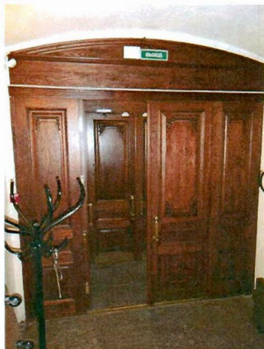
заполнение дверного проема – количество (два), материал (дерево), конструкция (двери двухстворчатые, с боковыми створками и фрамугой с лучковым завершением), количество (две), оформление (по три филенки на каждой створке, с двухсторонней резьбой, верхние филенки остекленные, средние – с поясом меандра, нижние, в центре – профилированные круглые детали);
