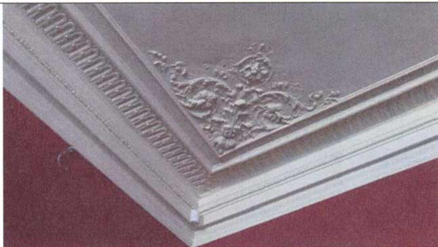
оформление потолка – падуга с профилированными рамами и карнизом с геометрическим орнаментом, в углах и в центральной розетке лепные композиции из цветов и листьев в виде волнитообразных завитков;
