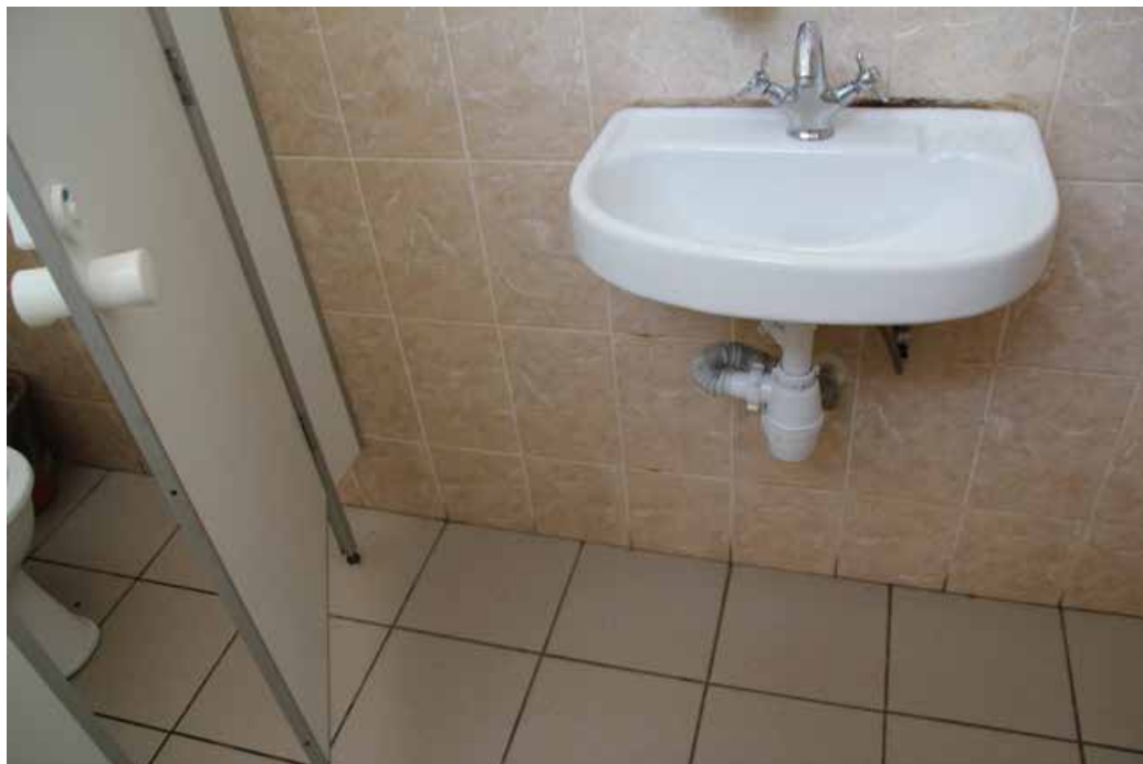
Фото №18. Общій вид санузла
