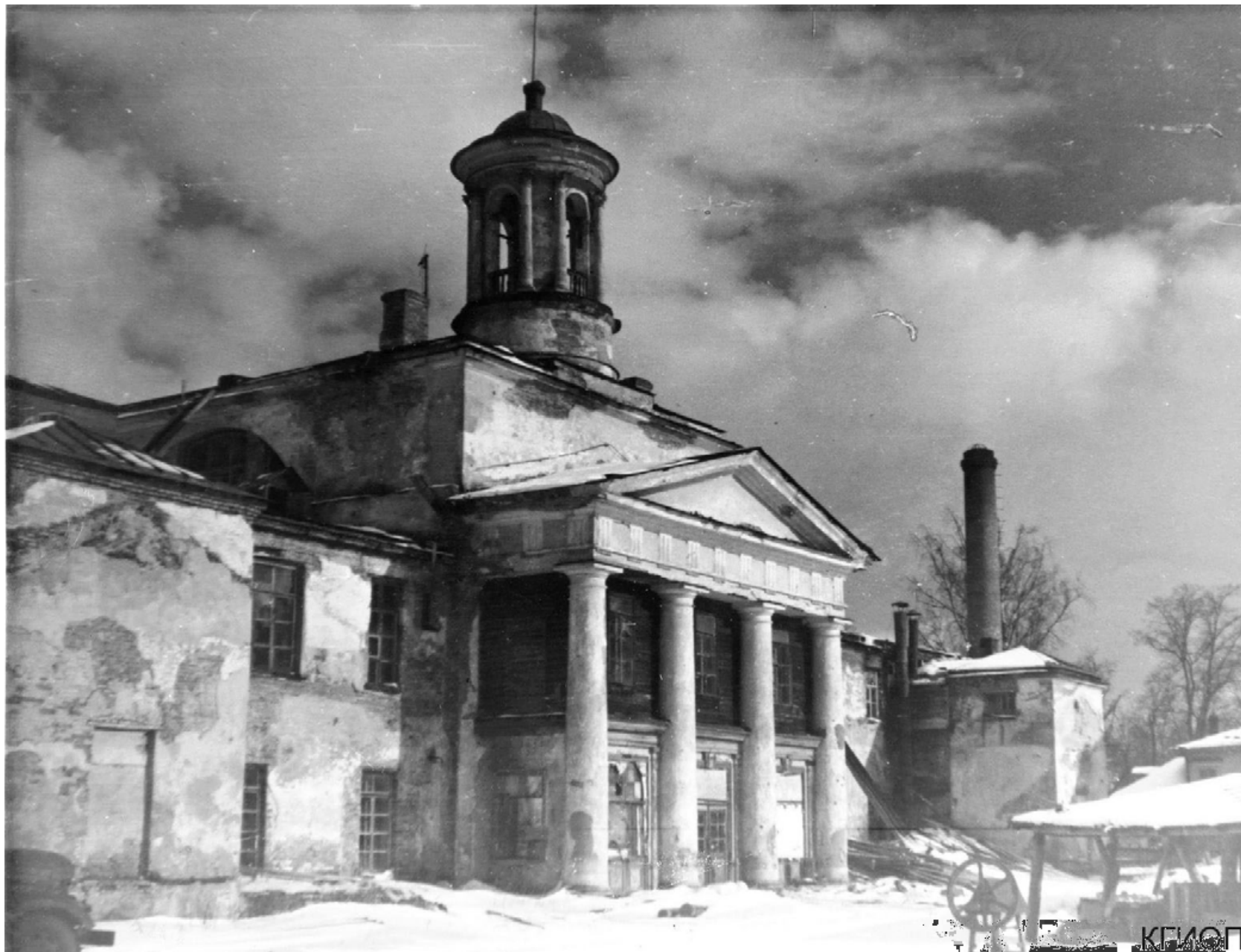
Ил. 26. Павловск. Бывшая церковь Св. Марии Магдалины в Павловске. Вид на западный фасад. Фото 1940 г. Из архива КГИОП.
