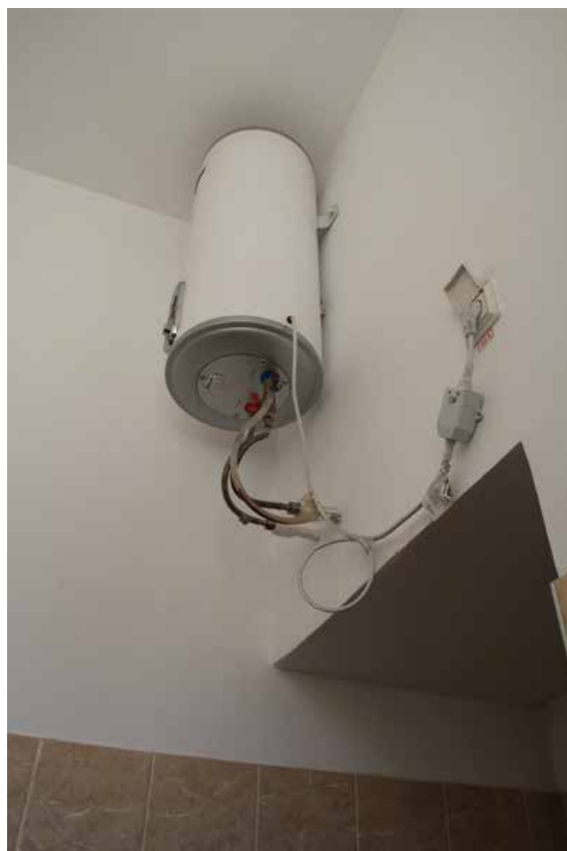
Фото №19. Общій вид санузла
