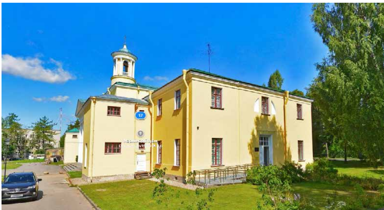
Фото №1. Общий вид объекта со стороны Просвещения и Садовой улиц
