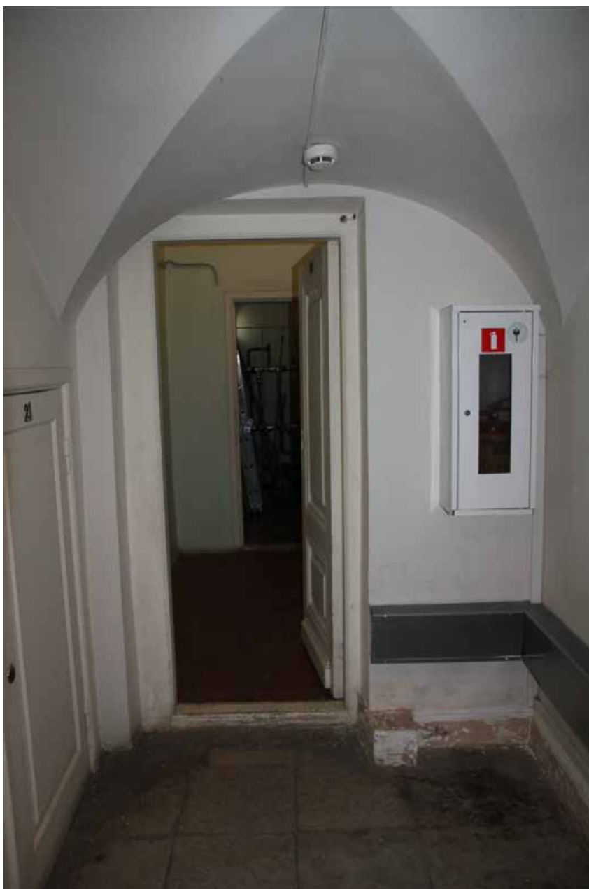
Фото №12. Общий вид на дверь под лестницей и кладовку
