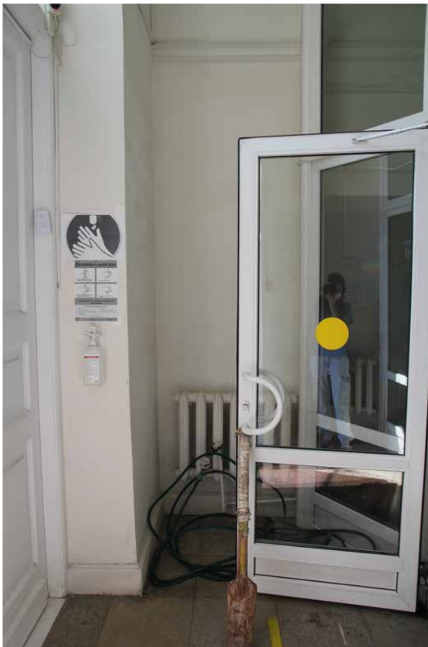
Фото №6. Тамбур внутри
