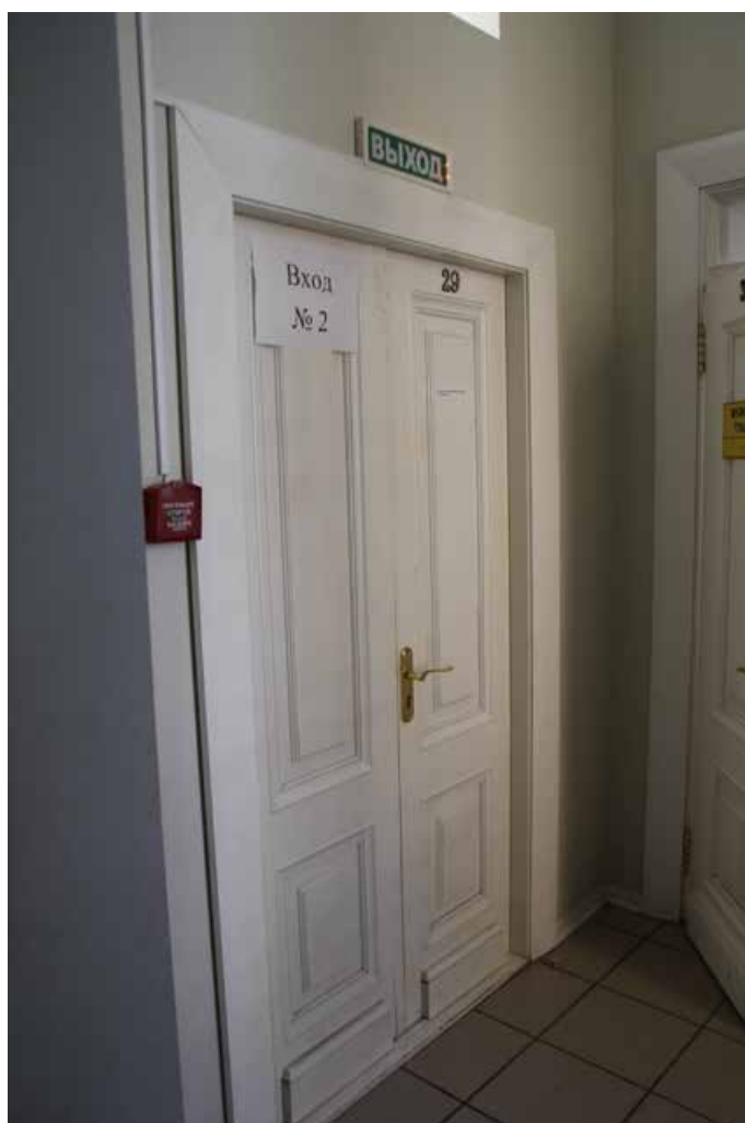
Фото №15. Общий вид на дверь в тамбуре (пом. №6)
