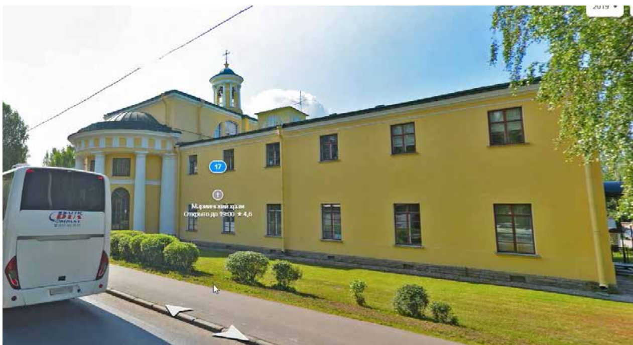
Фото №2. Общий вид объекта со стороны Садовой и Госпитальной улиц
