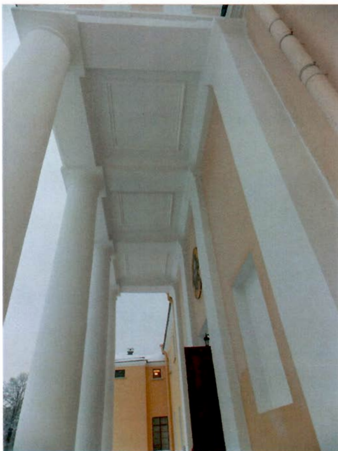
4. Кессоны с профилировками на потолке портика.
