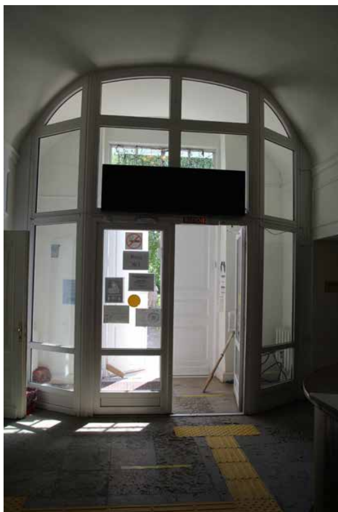
Фото №4. Общий вид на тамбур
