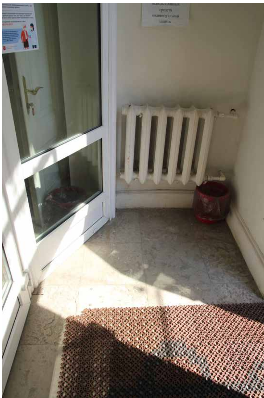
Фото №5. Тамбур внутри
