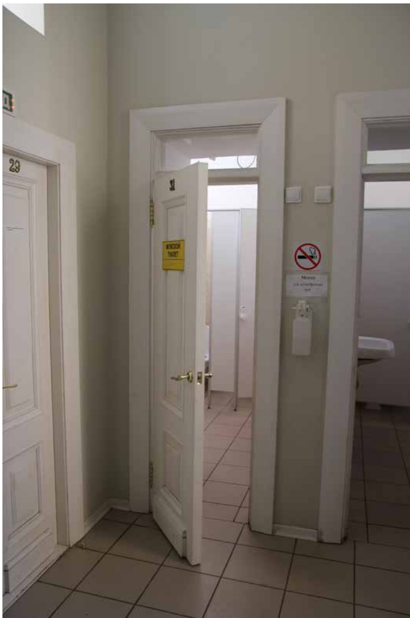
Фото №16. Общий вид на двери санузла
