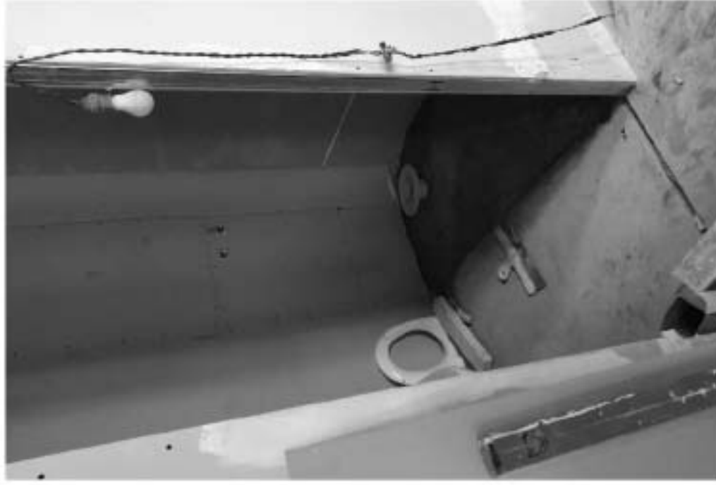
Фото 25. Квартира № 9. Возведение перегородок в помещении комнаты № 13 (по техпаспорту).
