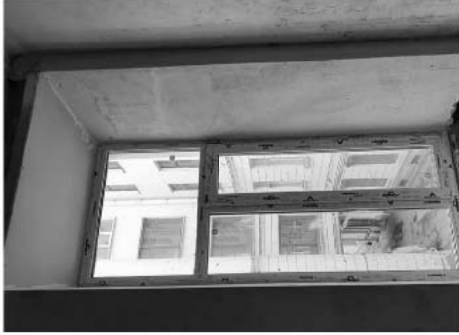
Фото 27. Квартира № 9. Оконный проем в помещении комнаты № 14.
