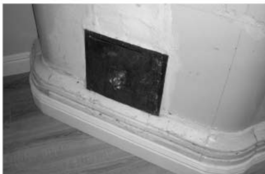
Фото 17. Квартира № 9. Помещение комнаты № 6. Фрагмент нижнего яруса с топочным проемом печи.
