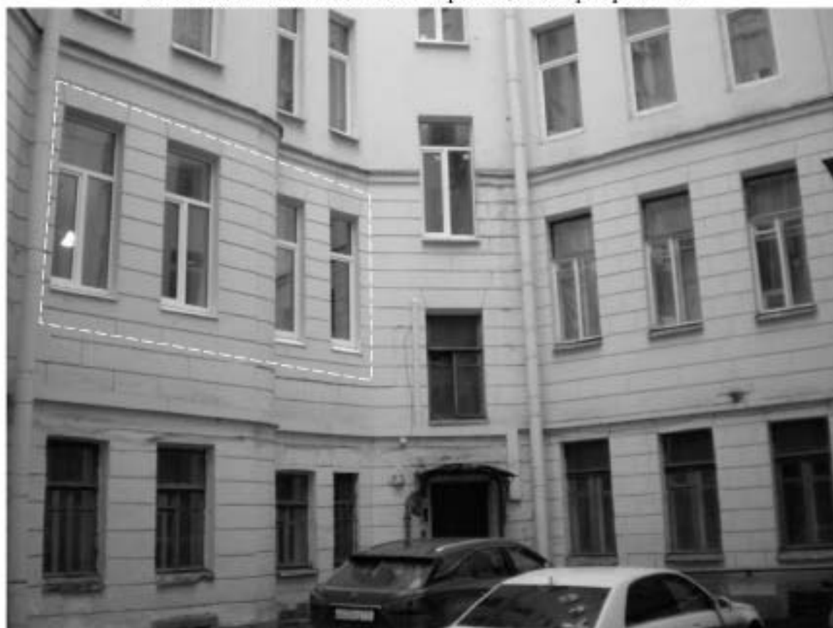
Фото 6. Фрагмент дворового фасада с обозначением окон квартиры № 9.
