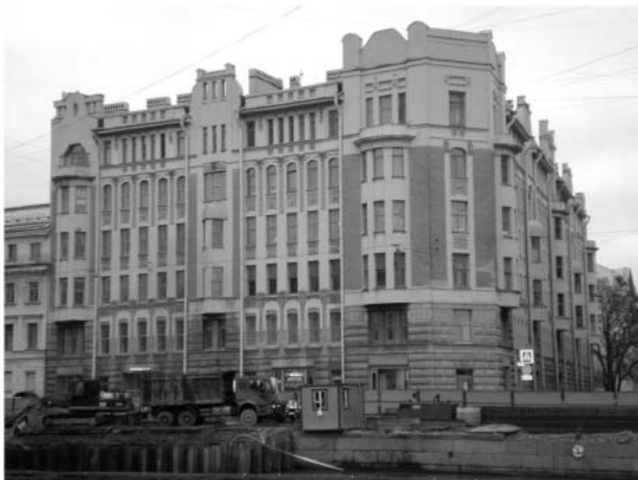
Фото 3. Вид здания с северо-запада.
