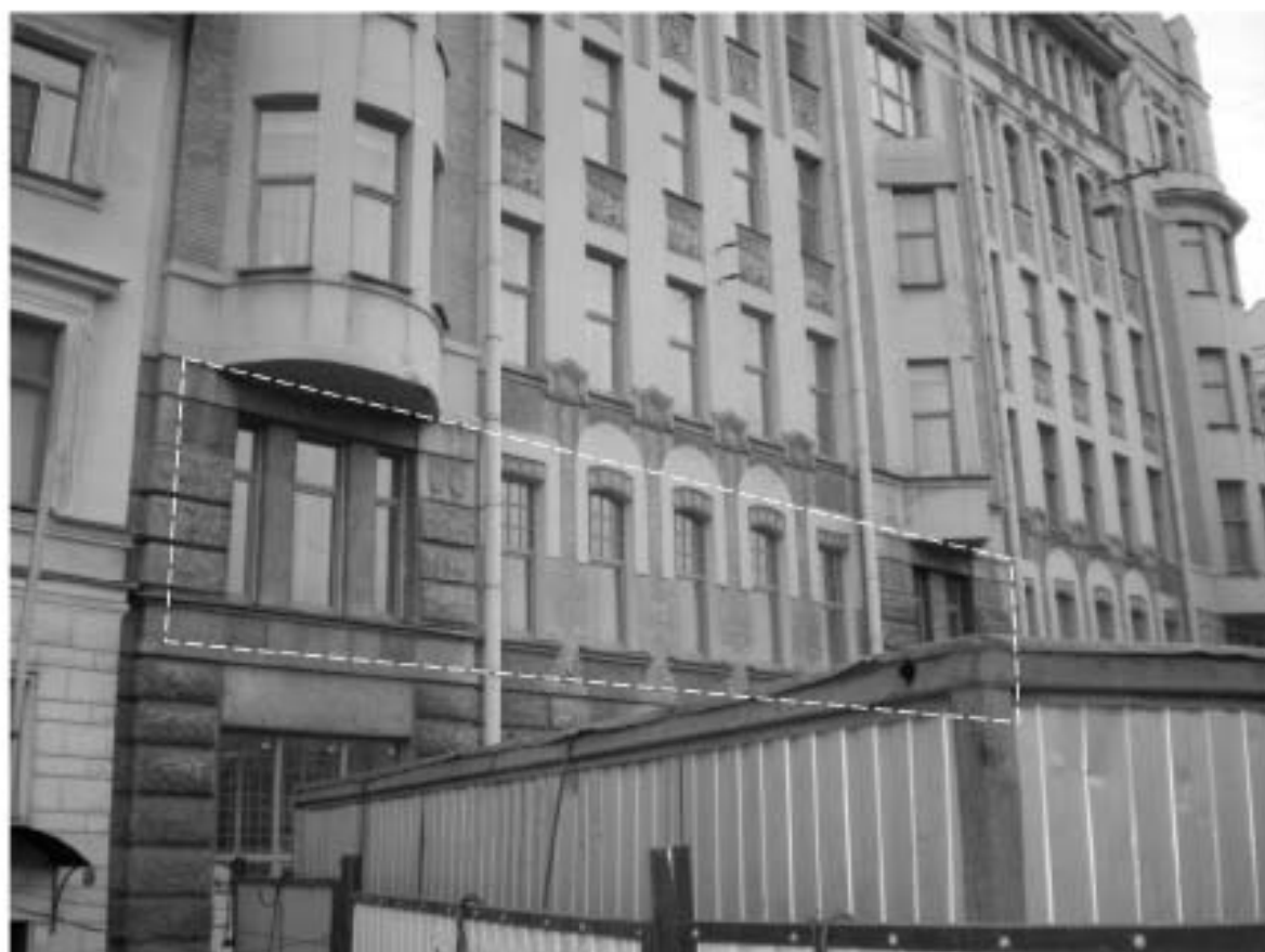
Фото 5. Фрагмент лицевого северо-западного фасада (по наб. р. Фонтанки) с оконными заполнениями в границах квартиры № 9.
