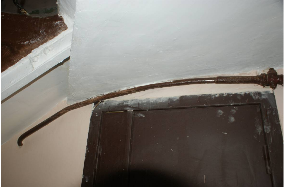
Фото 140. Лестница № 3. Площадка между 6-м и 7-м этажом. Свод. Съемка 19.04.2021 г. Трушковский В.Э.
