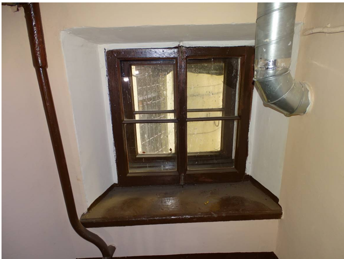
Фото 122. Лестница № 3. Площадка между 1-м и 2-м этажом. Съемка 19.04.2021 г. Трушковский В.Э.
