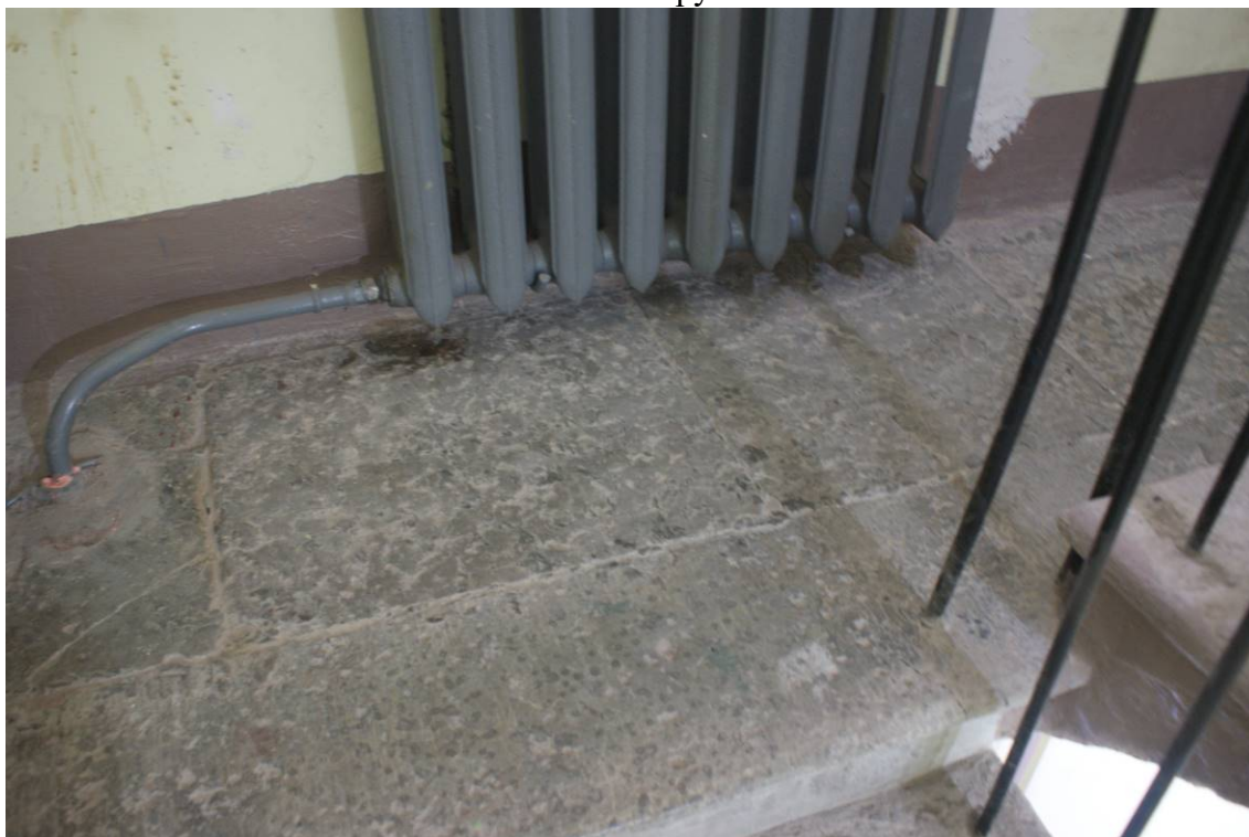
Фото 11. Лестница № 1. Площадка между 1-м и 2-м этажом. Известняковые плиты. Съемка 19.04.2021 г. Трушковский В.Э.
