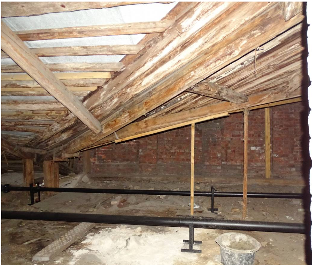
Фото 37. Лестница № 1. Чердачный этаж. Съемка 19.04.2021 г. Трушковский В.Э.
