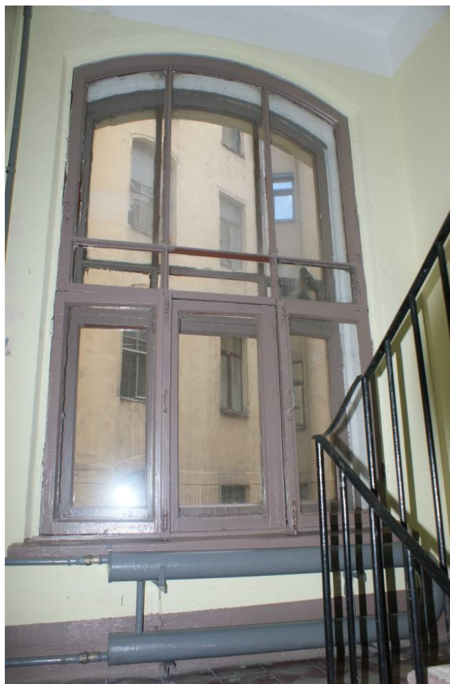
Фото 16. Лестница № 1. Площадка между 2-м и 3-м этажом. Съемка 19.04.2021 г. Трушковский В.Э.
