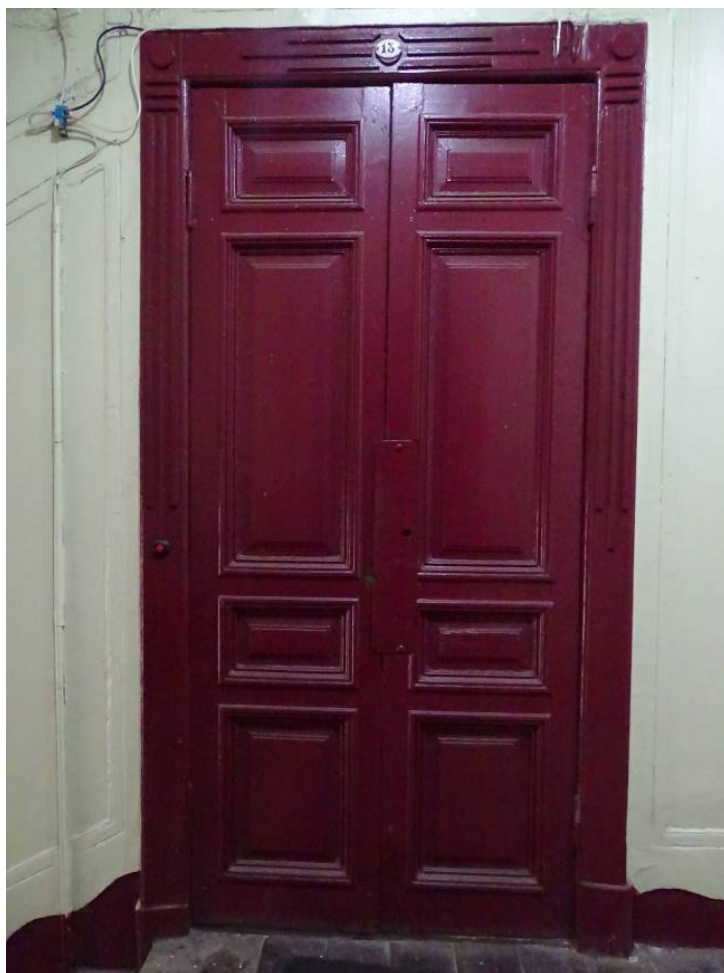
Фото 179. Лестница № 4. 2-й этаж. Съемка 19.04.2021 г. Трушковский В.Э.
