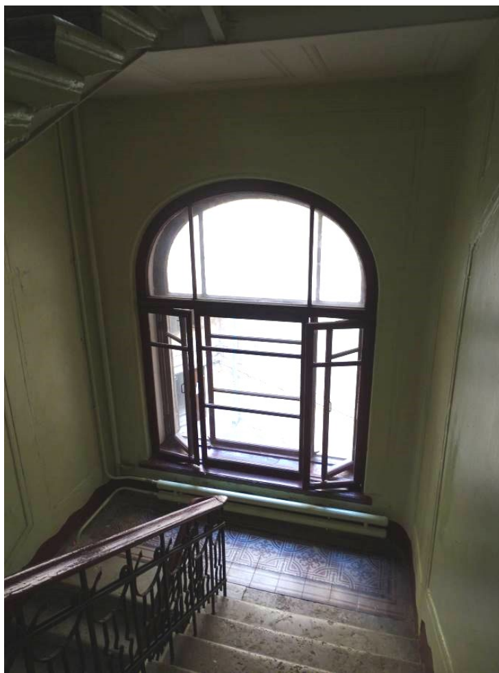
Фото 183. Лестница № 4. Площадка между 2-м и 3-м этажом. Съемка 19.04.2021 г. Трушковский В.Э.
