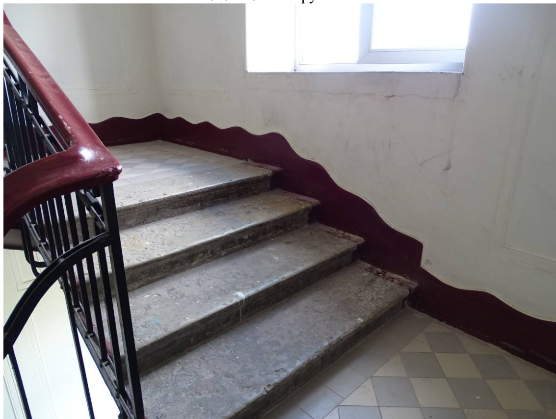
Фото 92. Лестница № 2. Площадка и лестничный марш между 3-м и 4-м этажом. Съемка 19.04.2021 г. Трушковский В.Э.
