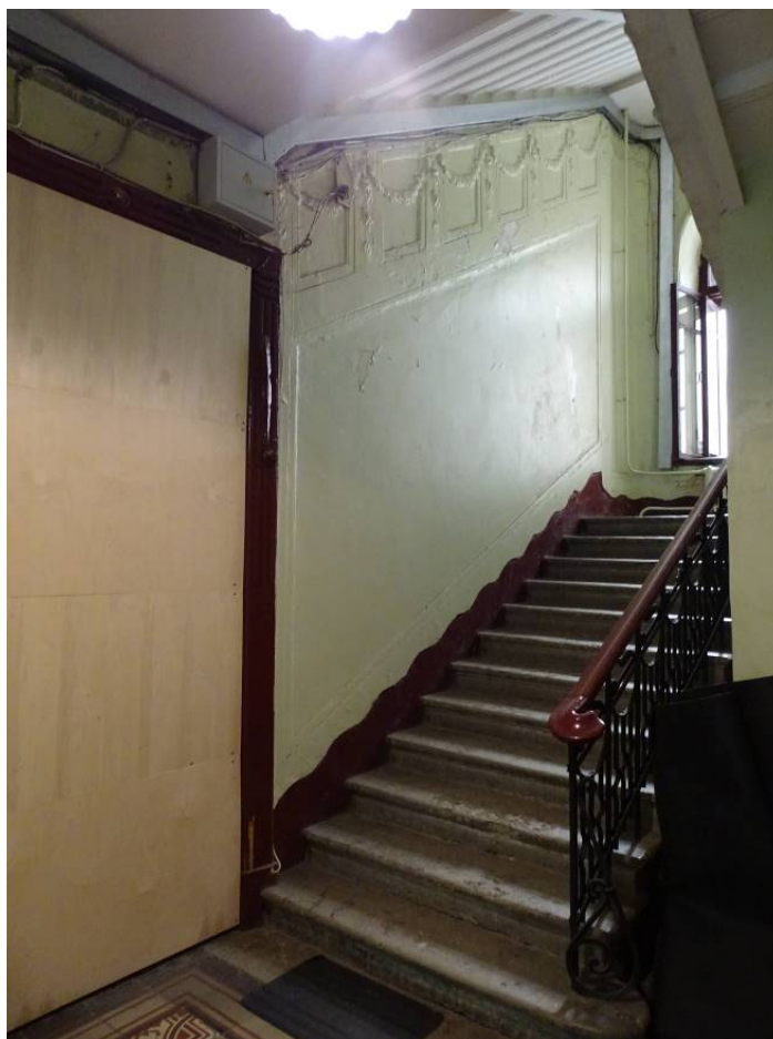
Фото 167. Лестница № 4. 1-й этаж. Парадная. Лестничный марш на площадку. Съемка 19.04.2021 г. Трушковский В.Э.
