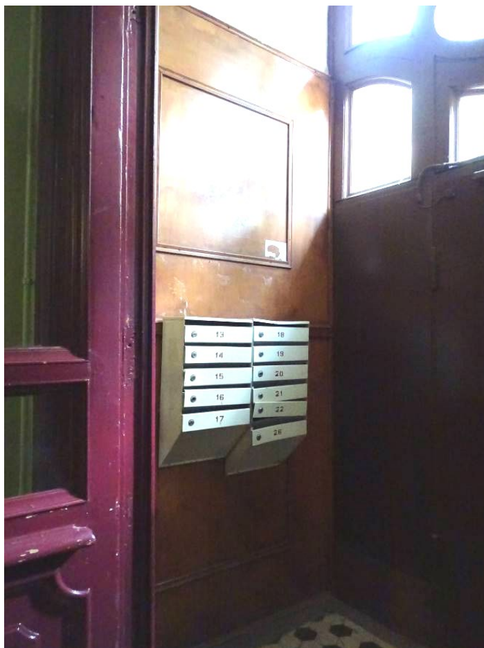
Фото 163. Лестница № 4. 1-й этаж. Входной тамбур. Съемка 19.04.2021 г. Трушковский В.Э.
