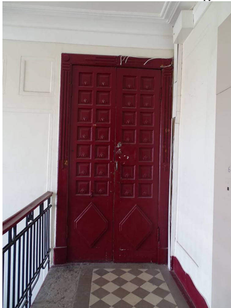
Фото 106. Лестница № 2. 6-й этаж. Съемка 19.04.2021 г. Трушковский В.Э.
