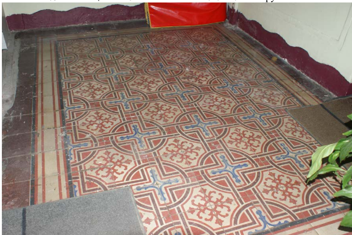
Фото 204. Лестница № 4. 6-й этаж. Покрытие пола. Съемка 19.04.2021 г. Трушковский В.Э.
