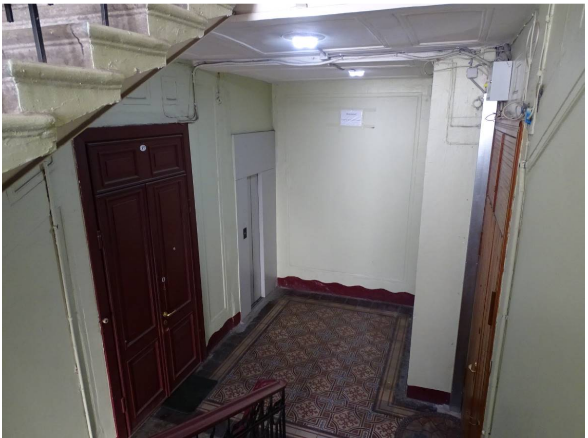
Фото 192. Лестница № 4. 4-й этаж. Съемка 19.04.2021 г. Трушковский В.Э.
