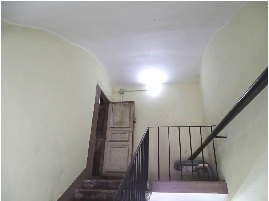
Фото 33. Лестница № 1. Чердачный этаж. Съемка 19.04.2021 г. Трушковский В.Э.
