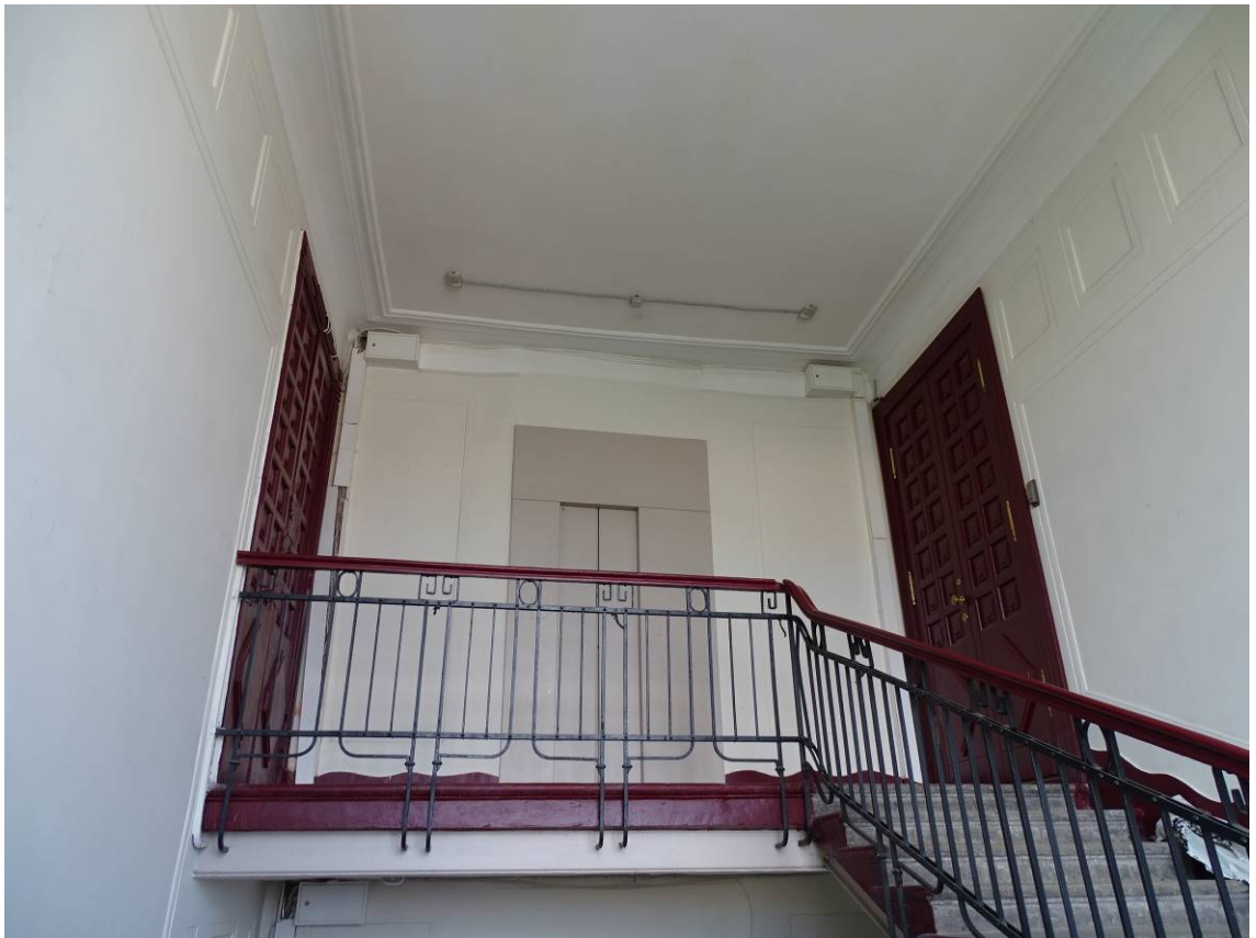
Фото 105. Лестница № 2. 6-й этаж. Съемка 19.04.2021 г. Трушковский В.Э.
