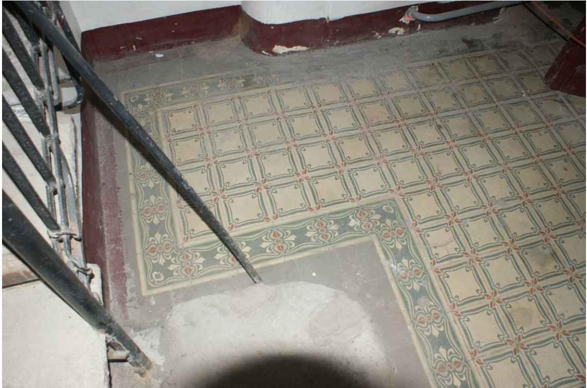
Фото 61. Лестница № 2. 1-й этаж. Парадная. Покрытие пола. Съемка 19.04.2021 г. Трушковский В.Э.
