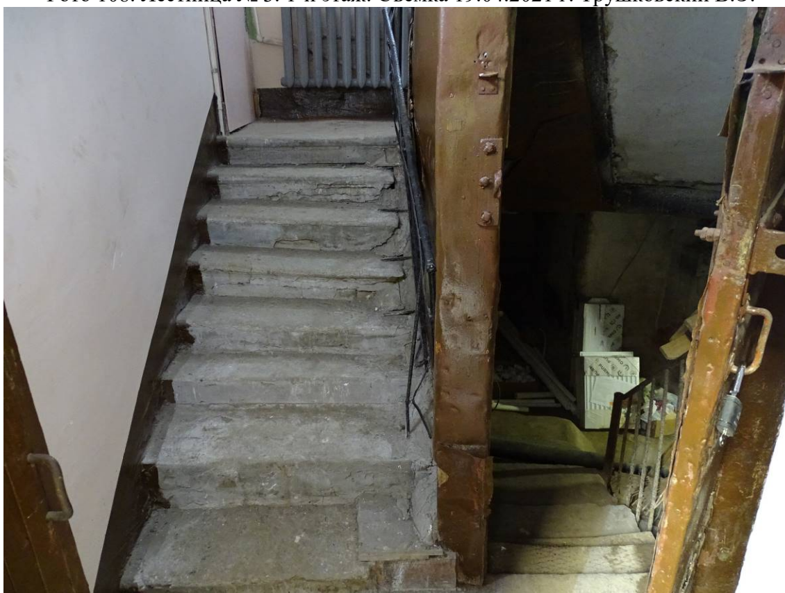
Фото 109. Лестница № 3. 1-й этаж. Вход в подвал. Съемка 19.04.2021 г. Трушковский В.Э.
