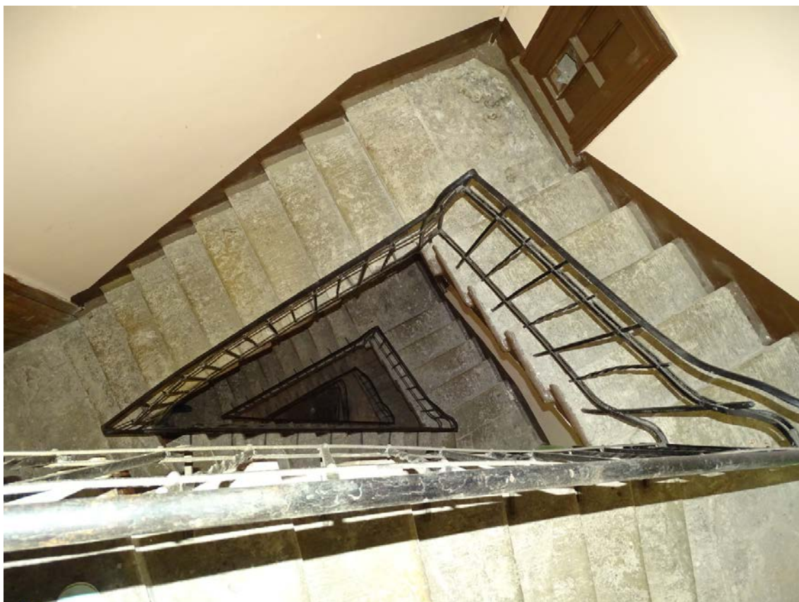
Фото 146. Лестница № 3. Конфигурация лестницы. Съемка 19.04.2021 г. Трушковский В.Э.
