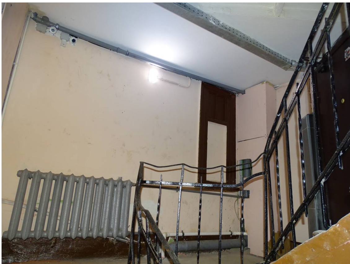
Фото 118. Лестница № 3. 1-й этаж. Съёмка 19.04.2021 г. Трушковский В.Э.
