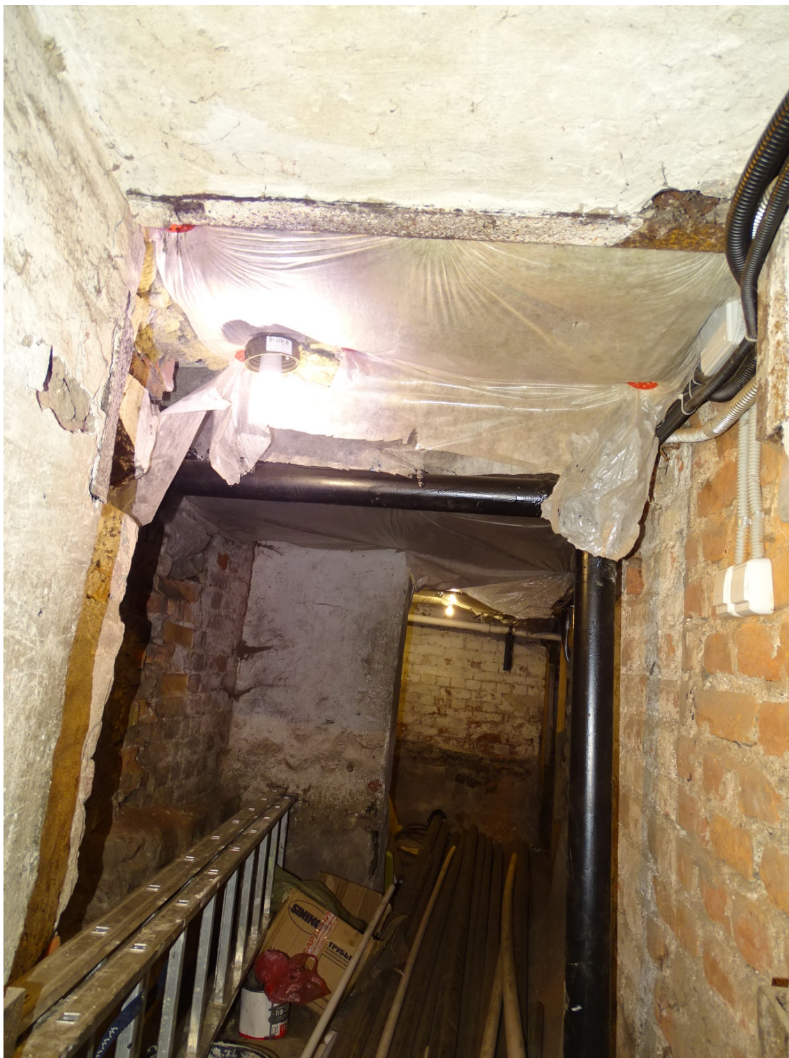
Фото 1. Подвал. Съемка 19.04.2021 г. Трушковский В.Э.
