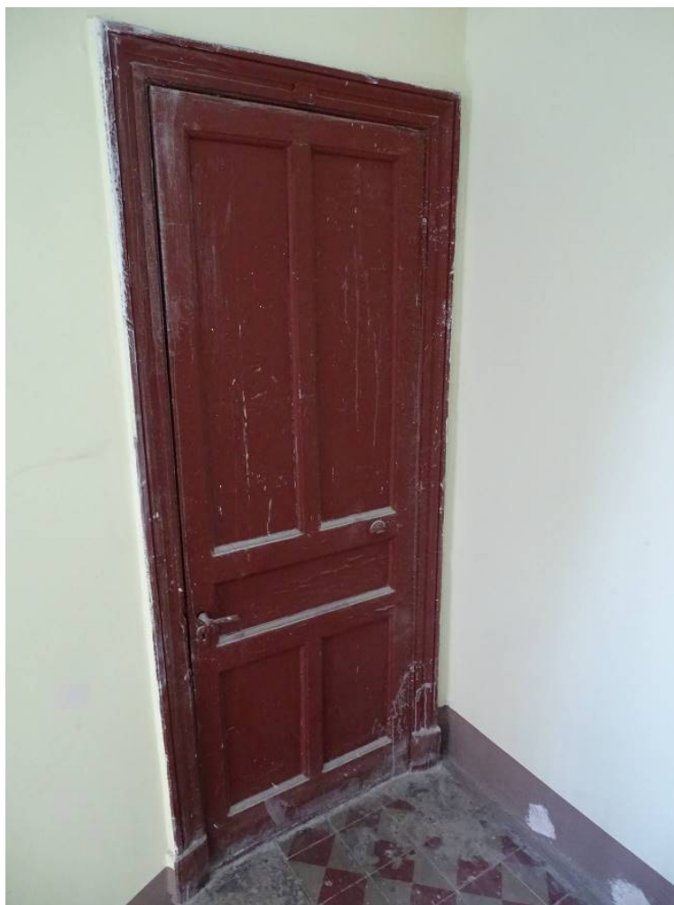
Фото 24. Лестница № 1. 4-й этаж. Съемка 19.04.2021 г. Трушковский В.Э.
