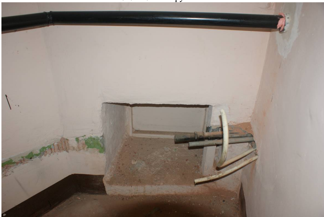
Фото 143. Лестница № 3. Площадка между 7-м и чердачным этажом. Съемка 19.04.2021 г. Трушковский В.Э.
