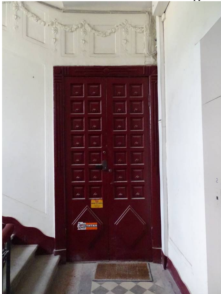
Фото 78. Лестница № 2. 2-й этаж. Съемка 19.04.2021 г. Трушковский В.Э.
