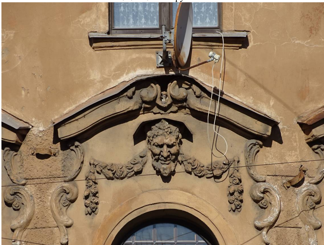
Фото 4. Здание по адресу: г. Санкт-Петербург, Большая Пушкарская ул., дом 1/8, литера А. Вид с пересечения Большой Пушкарской ул. и Съезжинской ул. Фрагмент. Съемка 19.04.2021 г. Трушковский В.Э.
