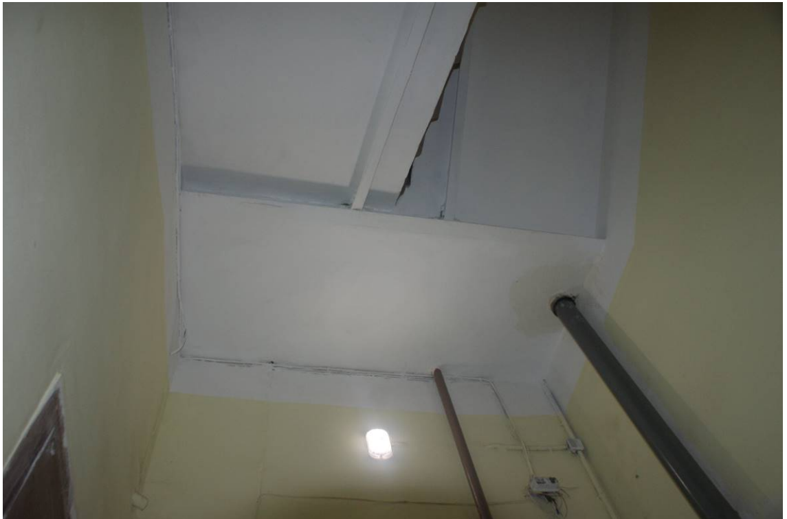
Фото 15. Лестница № 1. 2-й этаж. Съемка 19.04.2021 г. Трушковский В.Э.
