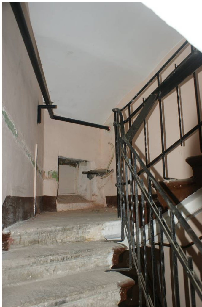
Фото 142. Лестница № 3. Площадка между 7-м и чердачным этажом. Съемка 19.04.2021 г. Трушковский В.Э.
