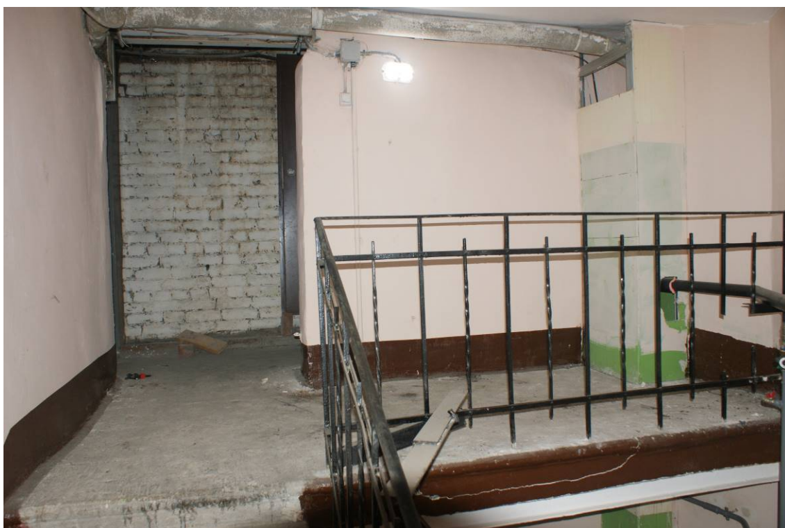
Фото 145. Лестница № 3. Чердачный этаж. Съемка 19.04.2021 г. Трушковский В.Э.
