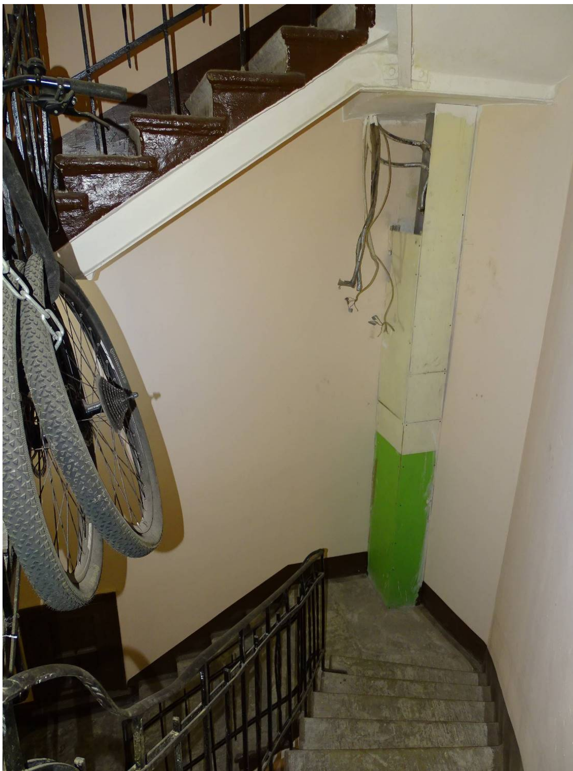
Фото 134. Лестница № 3. 5-й этаж. Съемка 19.04.2021 г. Трушковский В.Э.
