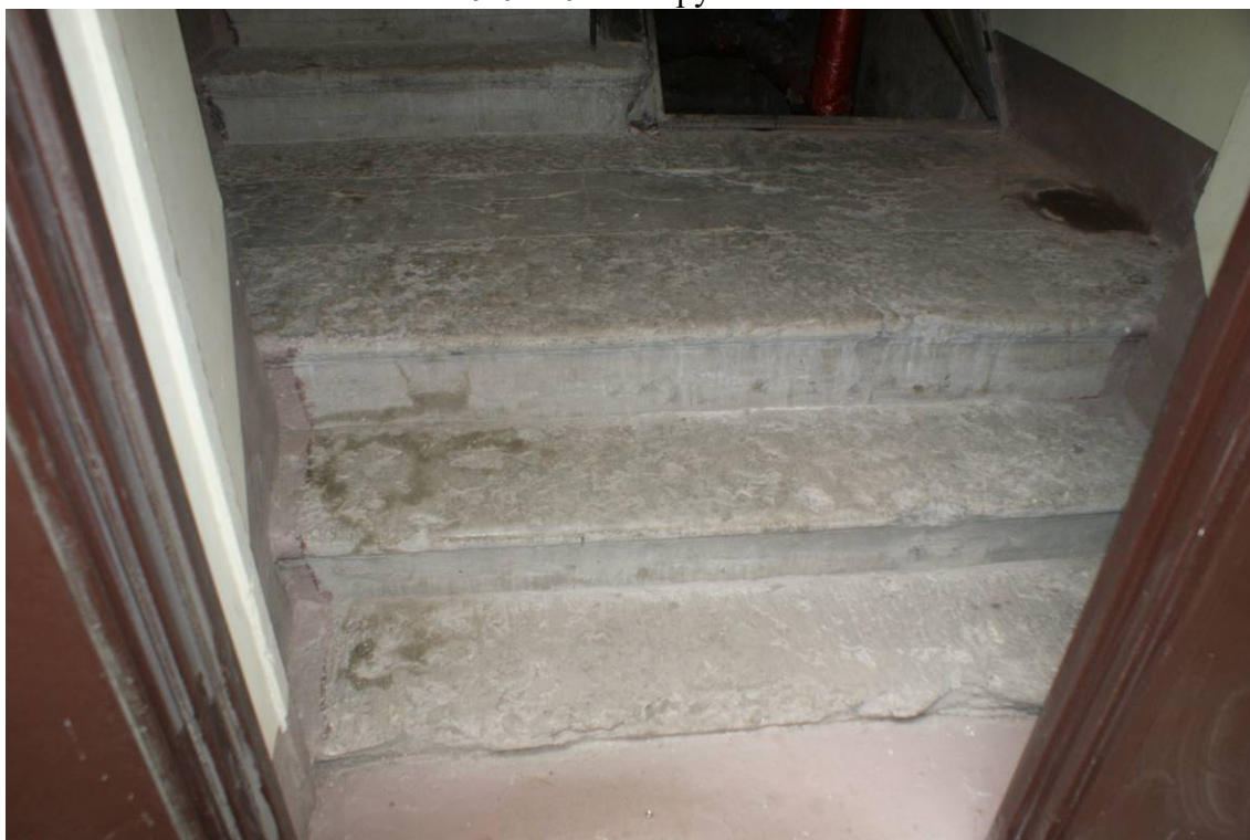
Фото 3. Лестница № 1. 1-й этаж. Вход в лестничную клетку. Ступени. Съемка 19.04.2021 г. Трушковский В.Э.
