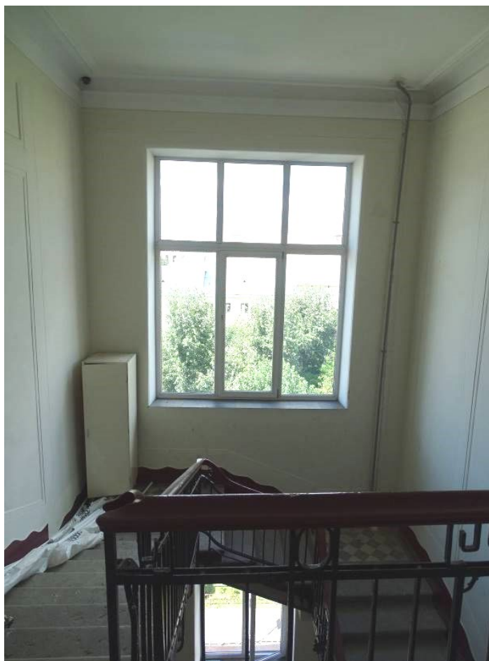
Фото 101. Лестница № 2. Площадка и лестничный марш между 5-м и 6-м этажом. Съемка 19.04.2021 г. Трушковский В.Э.
