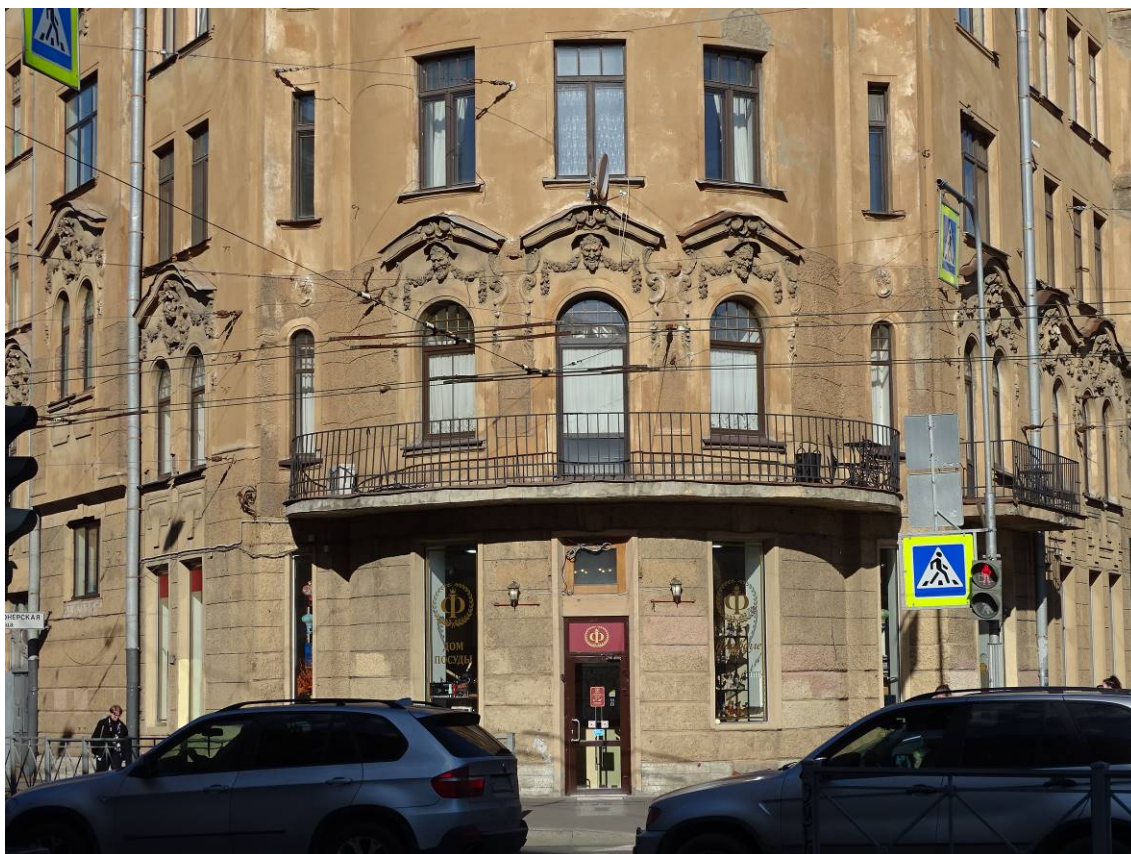
Фото 3. Здание по адресу: г. Санкт-Петербург, Большая Пушкарская ул., дом 1/8, литера А. Вид с пересечения Большой Пушкарской ул. и Съезжинской ул. Фрагмент. Съемка 19.04.2021 г. Трушковский В.Э.
