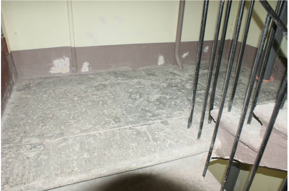
Фото 14. Лестница № 1. 2-й этаж. Известняковые плиты. Съемка 19.04.2021 г. Трушковский В.Э.
