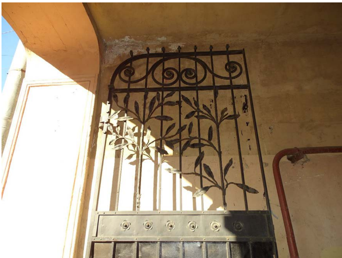
Фото 34. Здание по адресу: г. Санкт-Петербург, Большая Пушкарская ул., дом 1/8, литера А. Вид с Большой Пушкарской ул. Кованые ворота. Съемка 19.04.2021 г. Трушковский В.Э.
