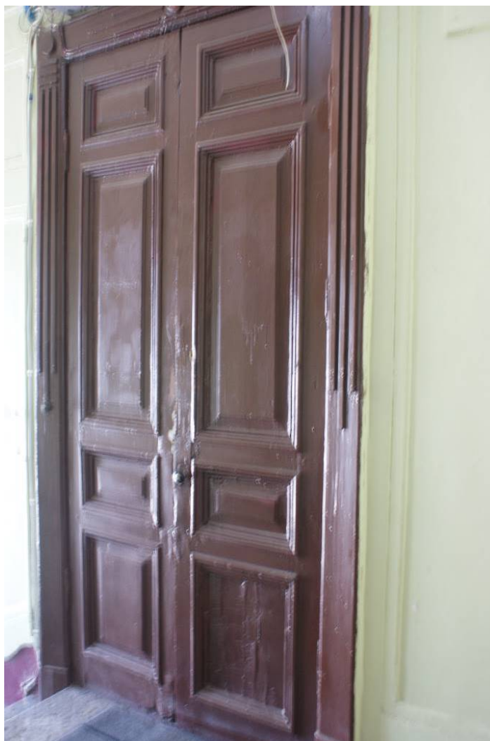
Фото 203. Лестница № 4. 6-й этаж. Съемка 19.04.2021 г. Трушковский В.Э.
