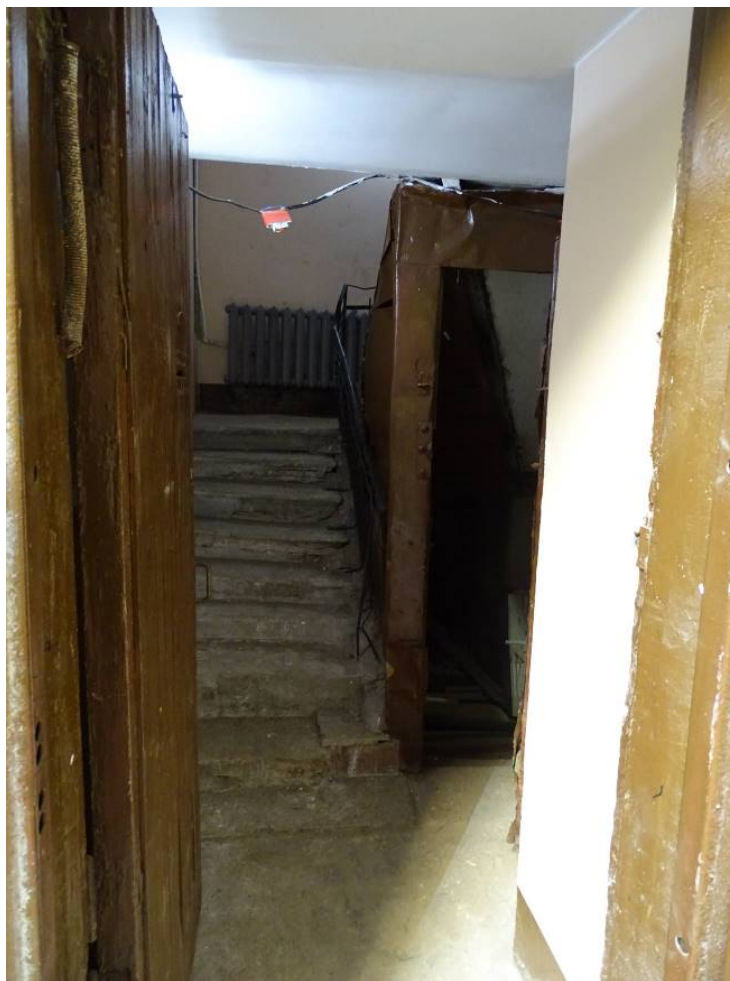
Фото 108. Лестница № 3. 1-й этаж. Съемка 19.04.2021 г. Трушковский В.Э.
