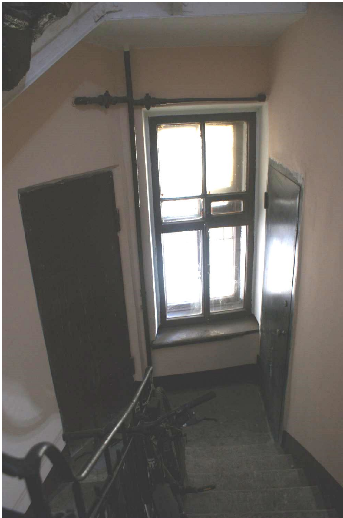
Фото 135. Лестница № 3. Площадка между 5-м и 6-м этажом. Съемка 19.04.2021 г. Трушковский В.Э.
