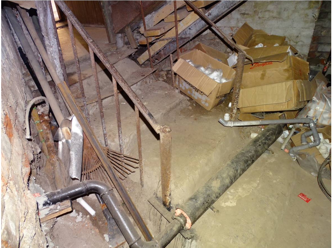
Фото 116. Лестница № 3. 1-й этаж. Подвал. Съемка 19.04.2021 г. Трушковский В.Э.
