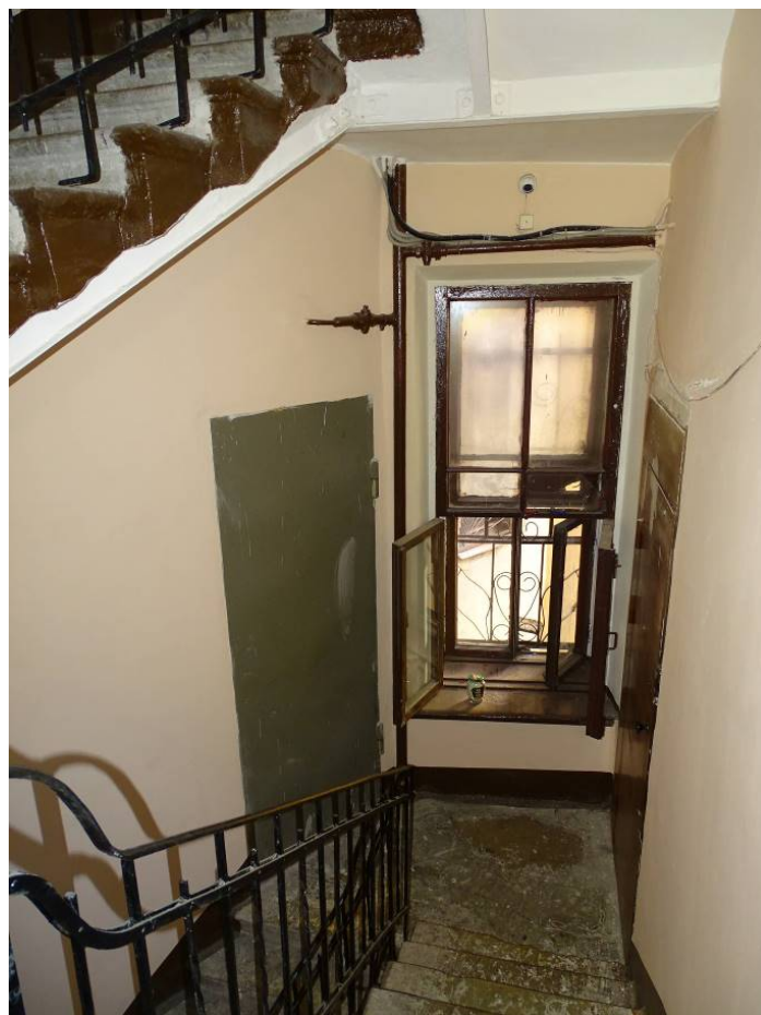
Фото 128. Лестница № 3. Площадка между 3-м и 4-м этажом. Съемка 19.04.2021 г. Трушковский В.Э.
