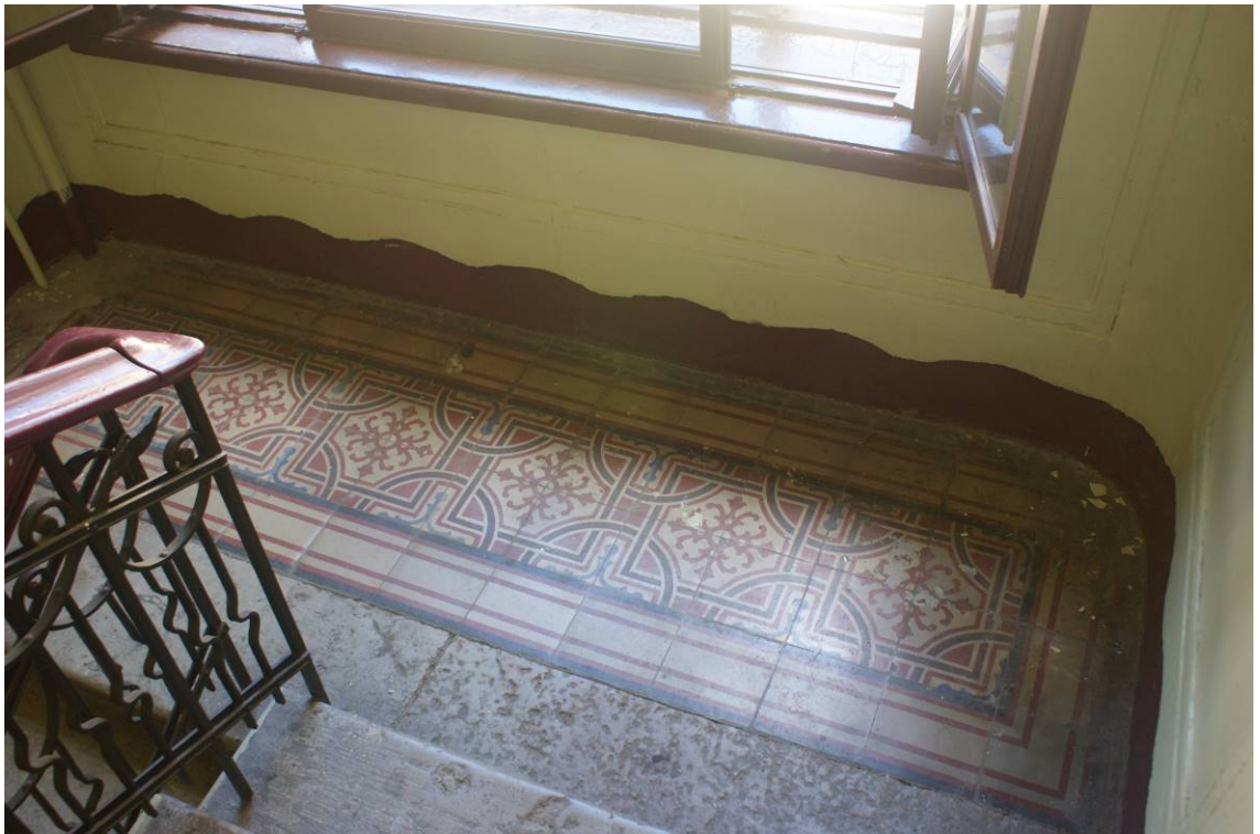
Фото 199. Лестница № 4. Площадка между 5-м и 6-м этажом. Покрытие пола. Съемка 19.04.2021 г. Трушковский В.Э.
