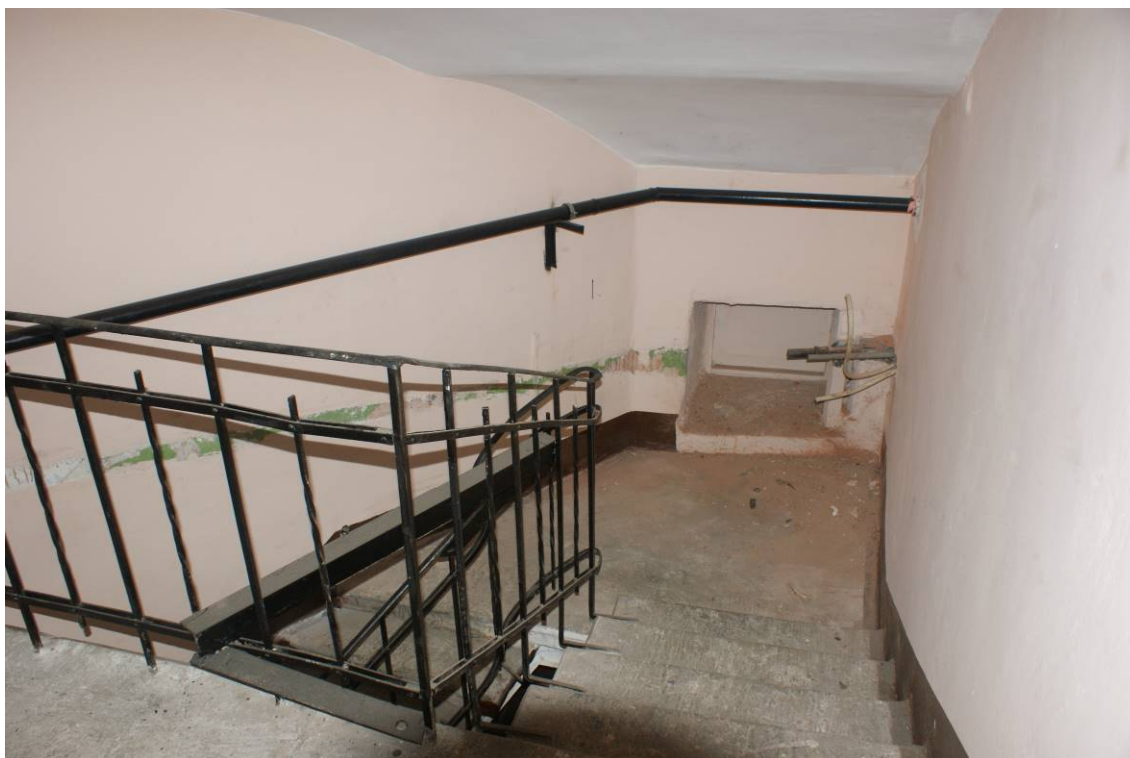
Фото 144. Лестница № 3. Площадка между 7-м и чердачным этажом. Съемка 19.04.2021 г. Трушковский В.Э.
