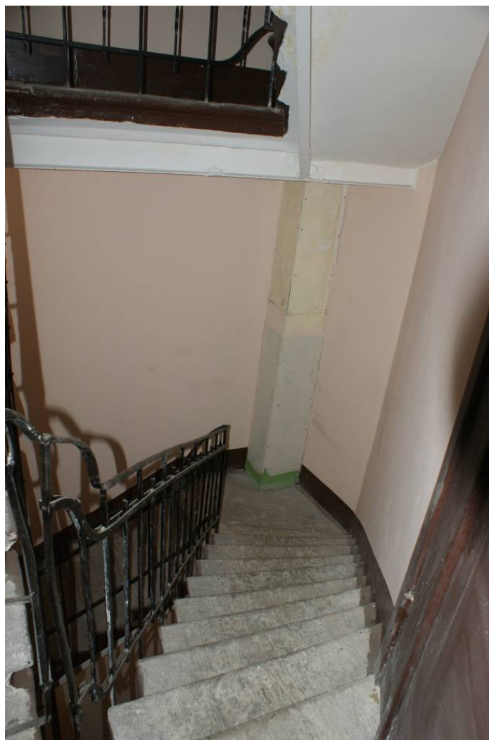
Фото 138. Лестница № 3. 6-й этаж. Съёмка 19.04.2021 г. Трушковский В.Э.
