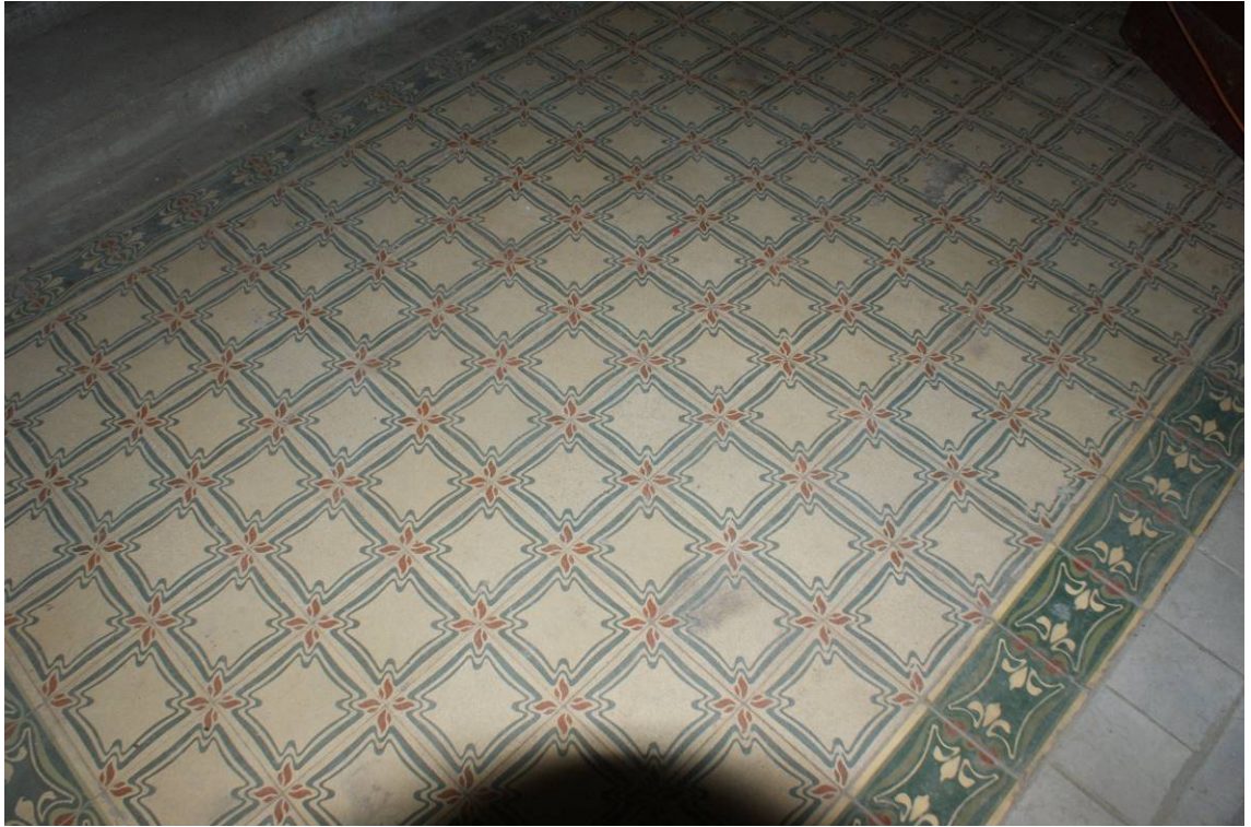
Фото 47. Лестница № 2. 1-й этаж. Покрытие пола. Съемка 19.04.2021 г. Трушковский В.Э.
