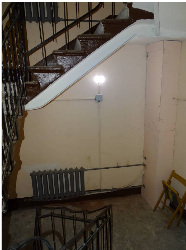
Фото 124. Лестница № 3. 2-й этаж. Съёмка 19.04.2021 г. Трушковский В.Э.
