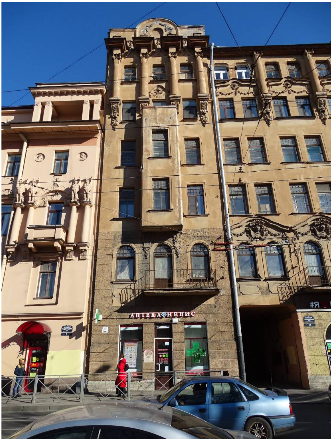
Фото 24. Здание по адресу: г. Санкт-Петербург, Большая Пушкарская ул., дом 1/8, литера А. Вид с Большой Пушкарской ул. Фрагмент. Съемка 19.04.2021 г. Трушковский В.Э.
