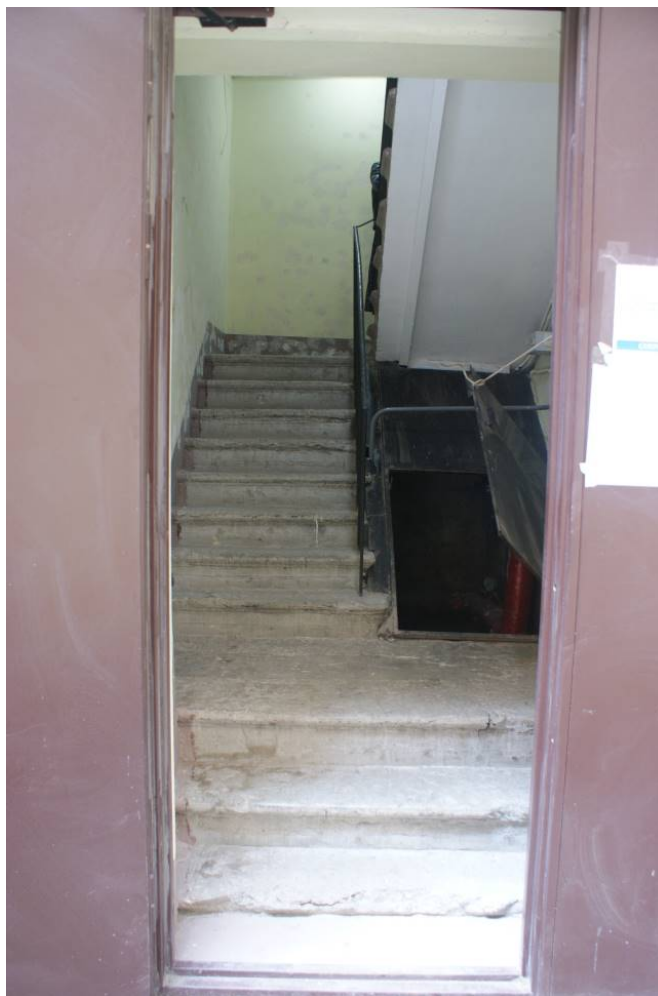
Фото 2. Лестница № 1. 1-й этаж. Вход в лестничную клетку. Съемка 19.04.2021 г. Трушковский В.Э.
