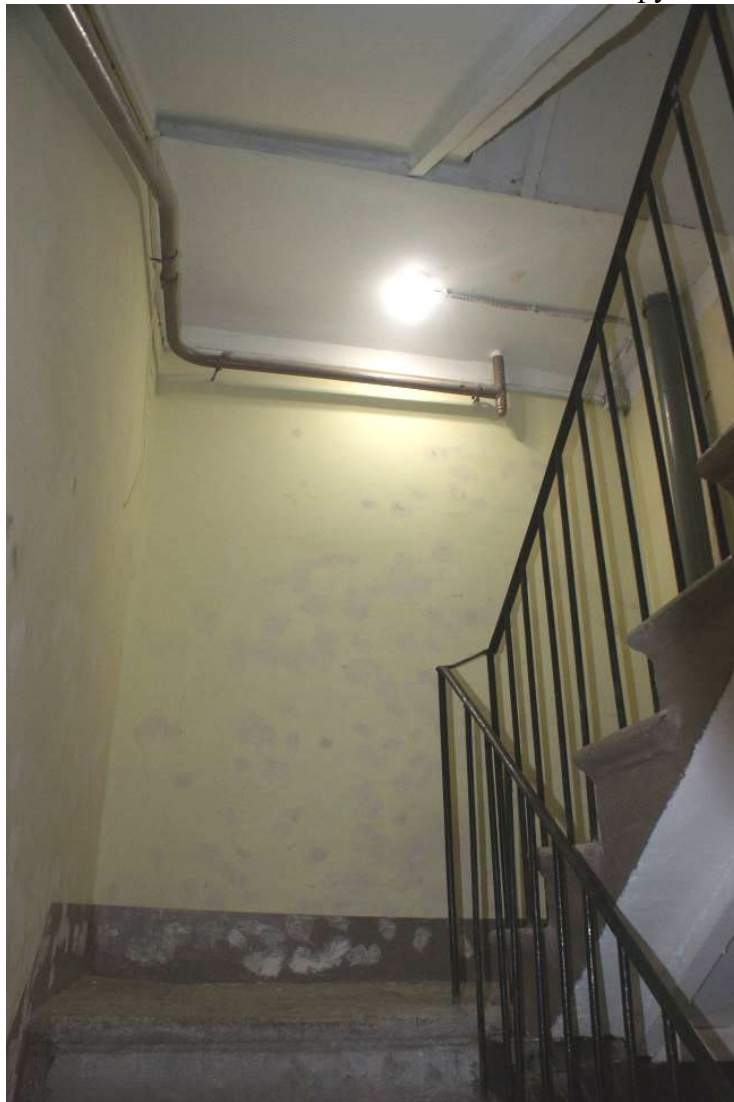
Фото 9. Лестница № 1. 1-й этаж. Съёмка 19.04.2021 г. Трушковский В.Э.
