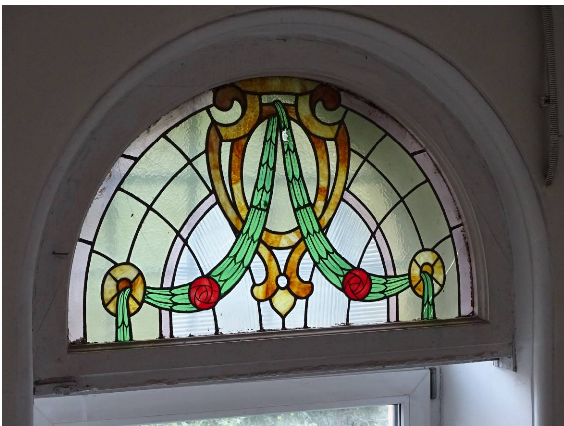
Фото 82. Лестница № 2. Площадка между 2-м и 3-м этажом. Витраж. Съемка 19.04.2021 г. Трушковский В.Э.
