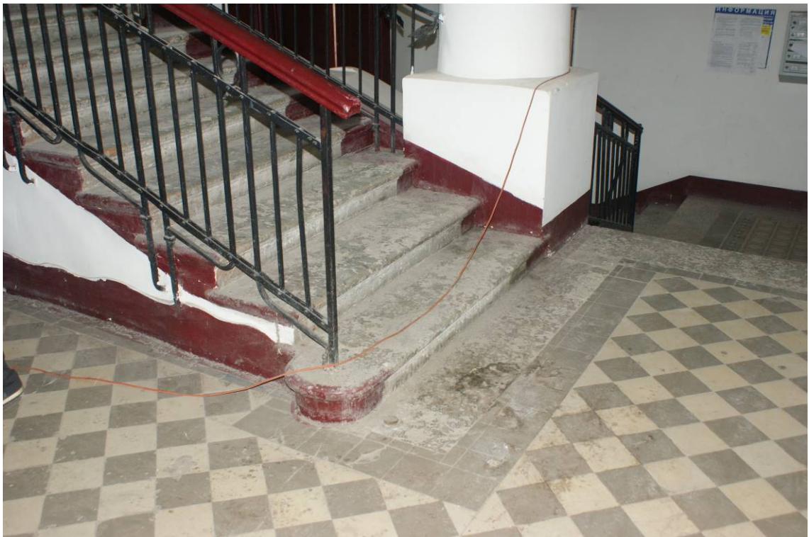
Фото 64. Лестница № 2. 1-й этаж. Парадная. Ступени лестничного марша. Съемка 19.04.2021 г. Трушковский В.Э.
