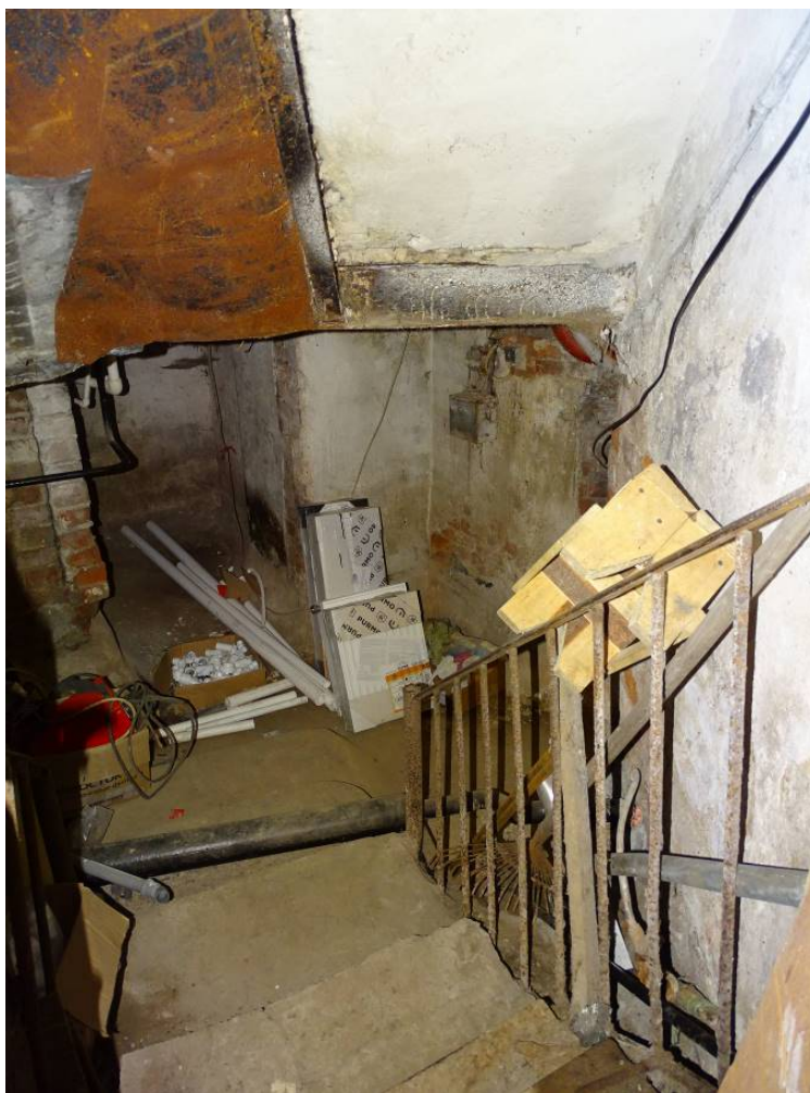
Фото 110. Лестница № 3. 1-й этаж. Подвал. Съемка 19.04.2021 г. Трушковский В.Э.
