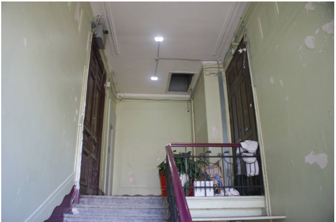
Фото 200. Лестница № 4. 6-й этаж. Съемка 19.04.2021 г. Трушковский В.Э.
