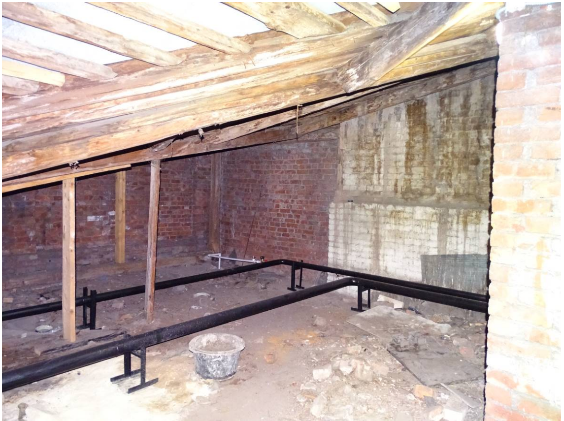
Фото 38. Лестница № 1. Чердачный этаж. Съемка 19.04.2021 г. Трушковский В.Э.
