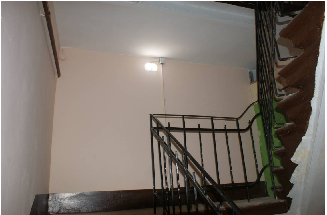
Фото 141. Лестница № 3. 7-й этаж. Съемка 19.04.2021 г. Трушковский В.Э.
