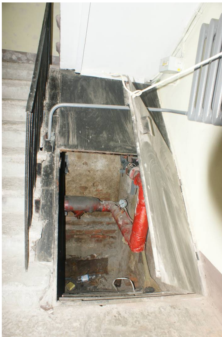
Фото 6. Лестница № 1. 1-й этаж. Вход в подвал. Съемка 19.04.2021 г. Трушковский В.Э.
