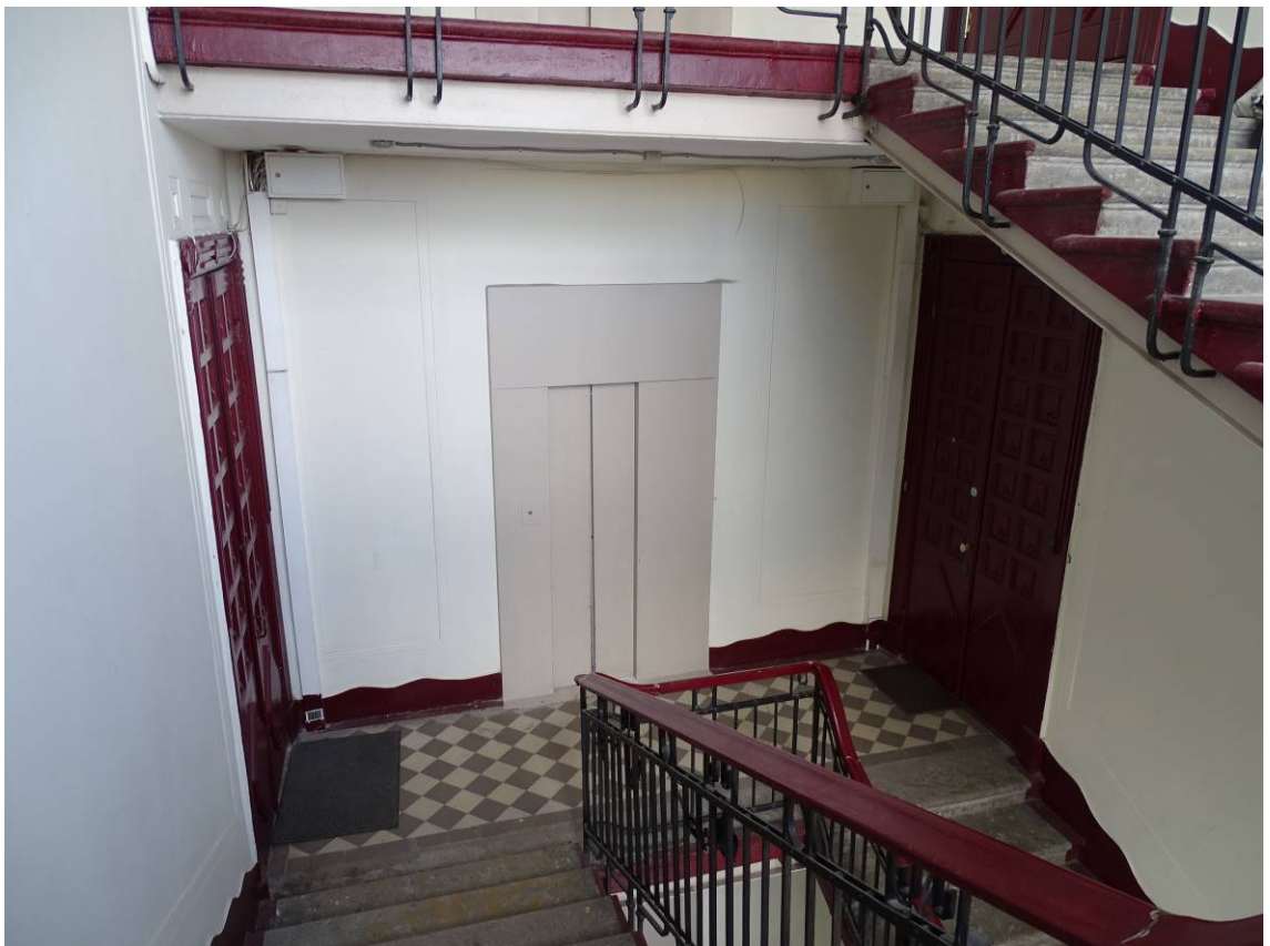
Фото 96. Лестница № 2. 5-й этаж. Съемка 19.04.2021 г. Трушковский В.Э.
