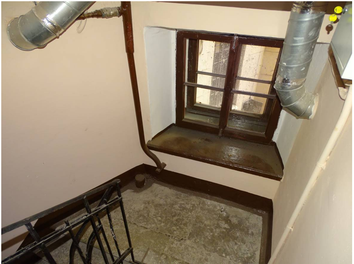
Фото 120. Лестница № 3. Площадка между 1-м и 2-м этажом. Съемка 19.04.2021 г. Трушковский В.Э.
