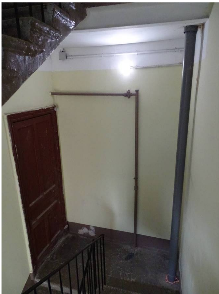
Фото 28. Лестница № 1. 5-й этаж. Съёмка 19.04.2021 г. Трушковский В.Э.
