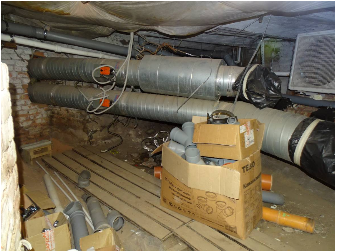
Фото 112. Лестница № 3. 1-й этаж. Подвал. Съёмка 19.04.2021 г. Трушковский В.Э.
