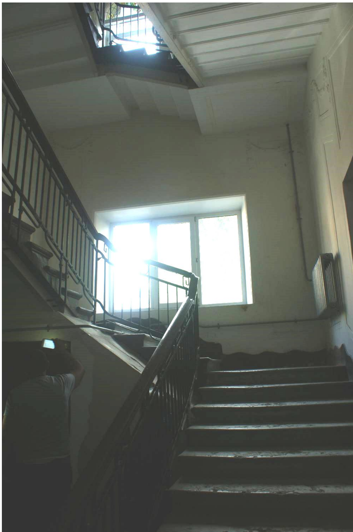
Фото 67. Лестница № 2. Площадка между 1-м и 2-м этажом. Съемка 19.04.2021 г. Трушковский В.Э.
