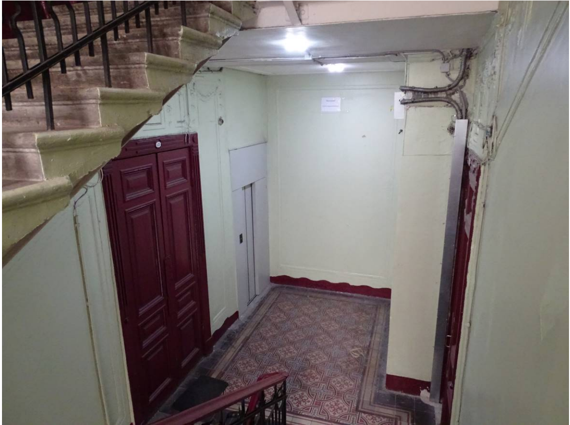
Фото 177. Лестница № 4. 2-й этаж. Съемка 19.04.2021 г. Трушковский В.Э.
