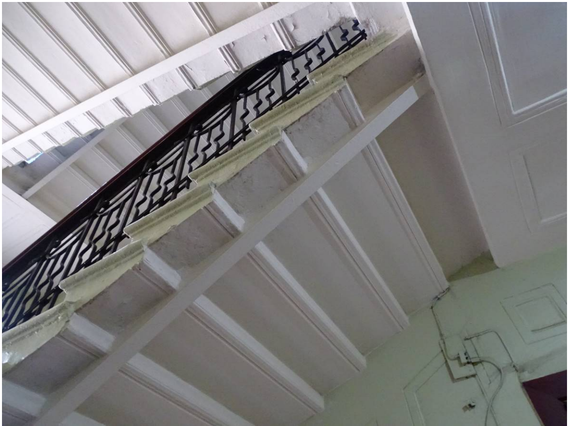
Фото 191. Лестница № 4. Лестничный марш. Съемка 19.04.2021 г. Трушковский В.Э.
