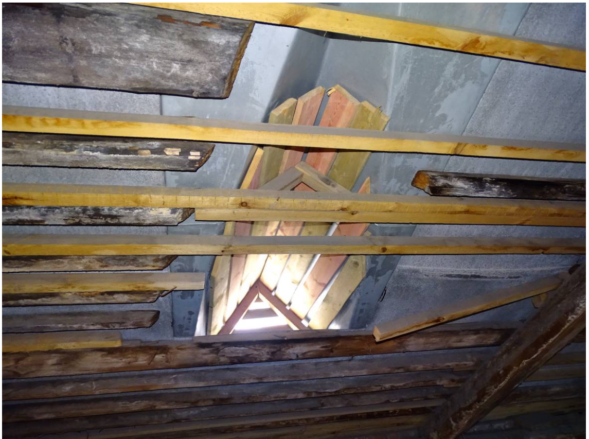
Фото 39. Лестница № 1. Чердачный этаж. Съемка 19.04.2021 г. Трушковский В.Э.
