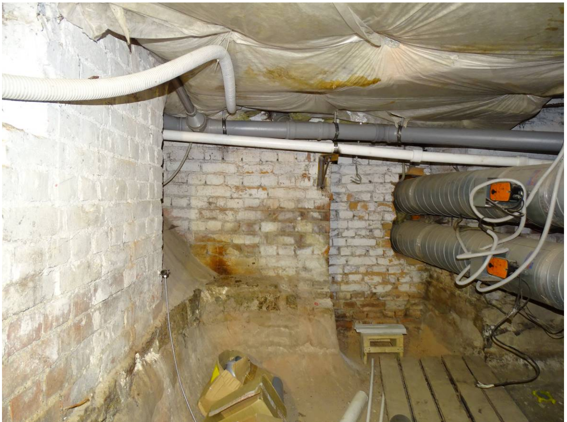
Фото 113. Лестница № 3. 1-й этаж. Подвал. Съёмка 19.04.2021 г. Трушковский В.Э.
