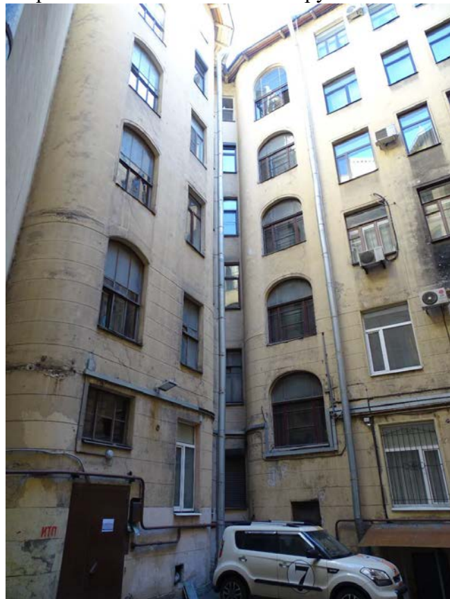
Фото 41. Здание по адресу: г. Санкт-Петербург, Большая Пушкарская ул., дом 1/8, литера А. Вид на Восточный и Южный фасад. Фрагмент. Съемка 19.04.2021 г. Трушковский В.Э.
