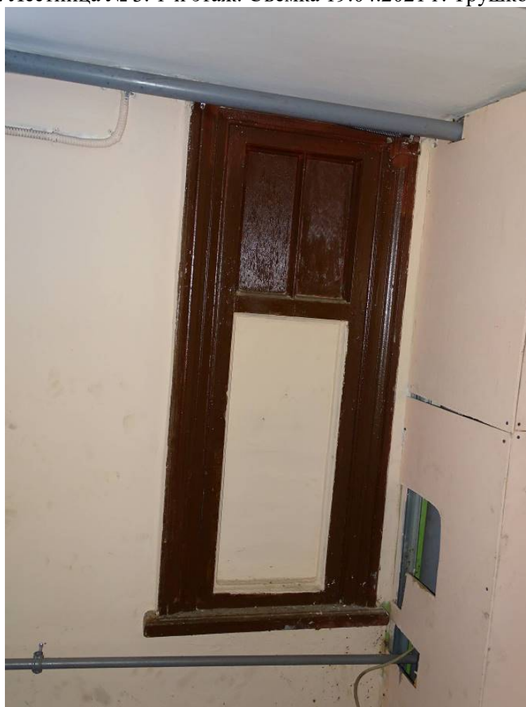
Фото 119. Лестница № 3. 1-й этаж. Съёмка 19.04.2021 г. Трушковский В.Э.
