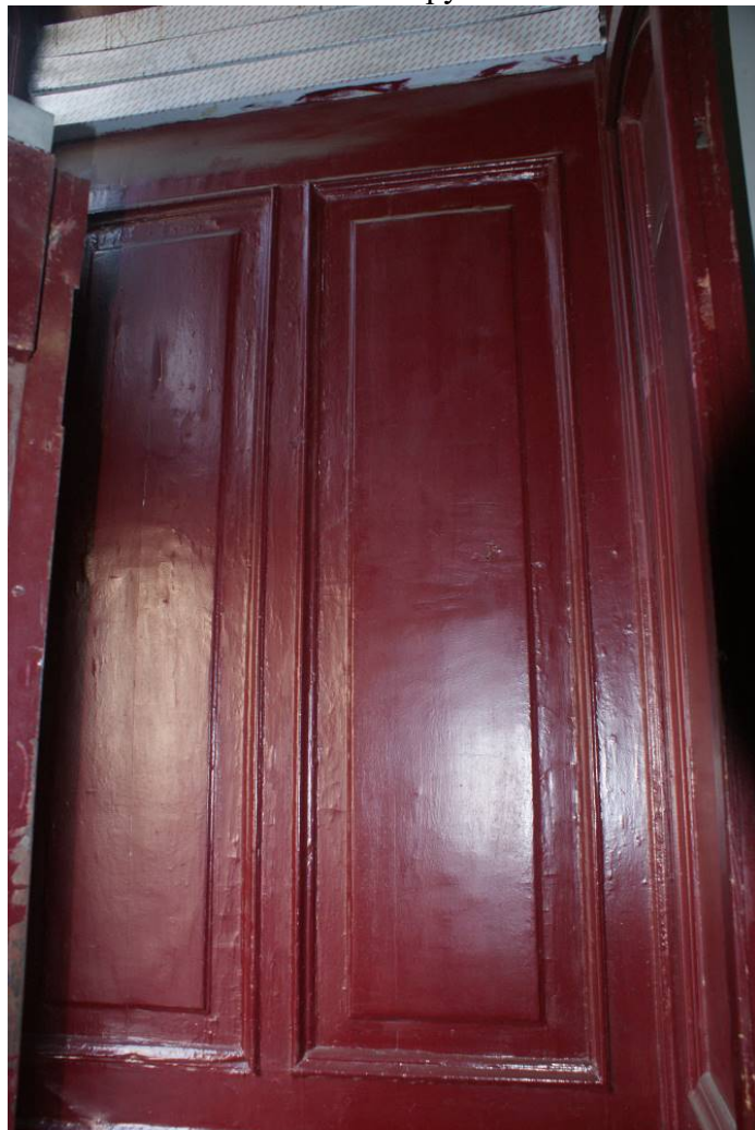
Фото 44. Лестница № 2. 1-й этаж. Входной тамбур. Съемка 19.04.2021 г. Трушковский В.Э.
