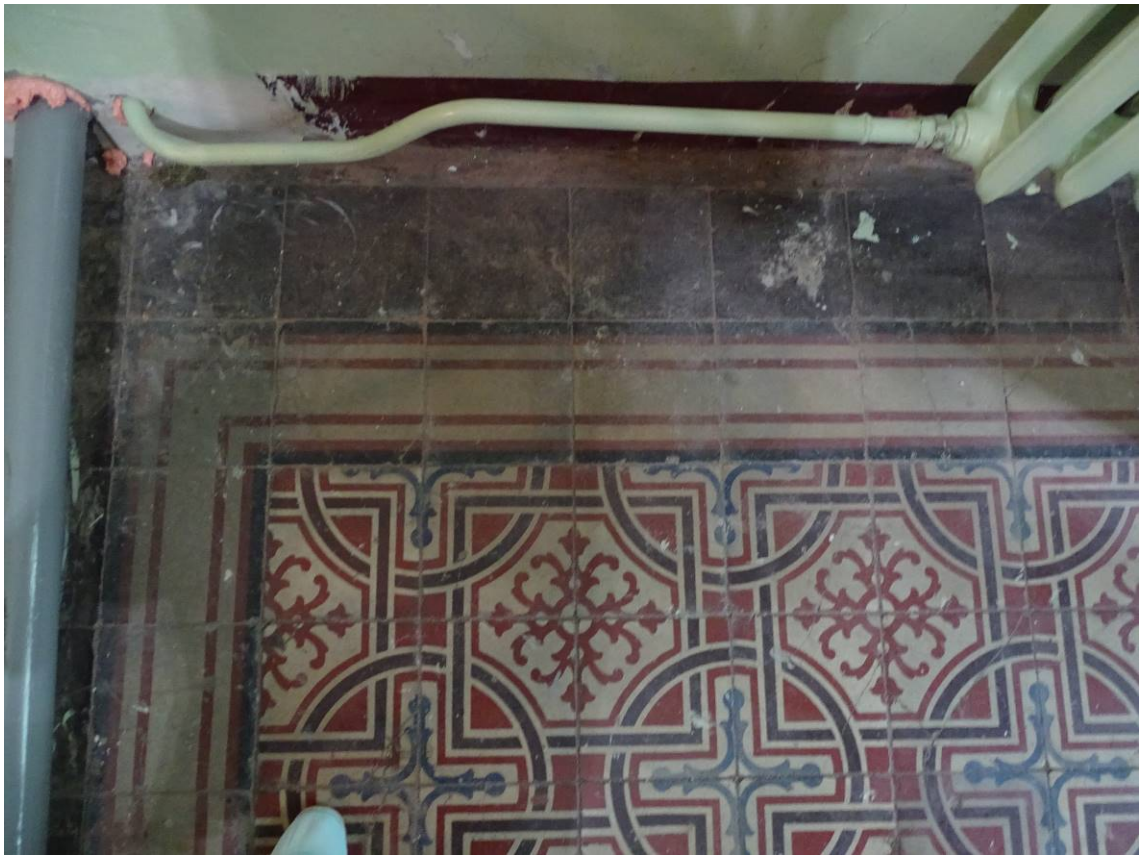
Фото 159. Лестница № 4. 1-й этаж. Парадная. Покрытие пола. Съемка 19.04.2021 г. Трушковский В.Э.
