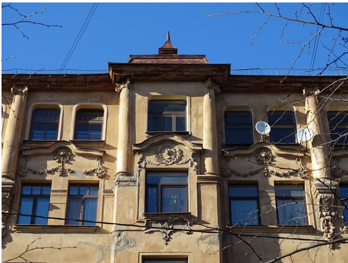
Фото 13. Здание по адресу: г. Санкт-Петербург, Большая Пушкарская ул., дом 1/8, литера А. Вид со Съезжинской ул. Фрагмент. Съемка 19.04.2021 г. Грушковский В.Э.
