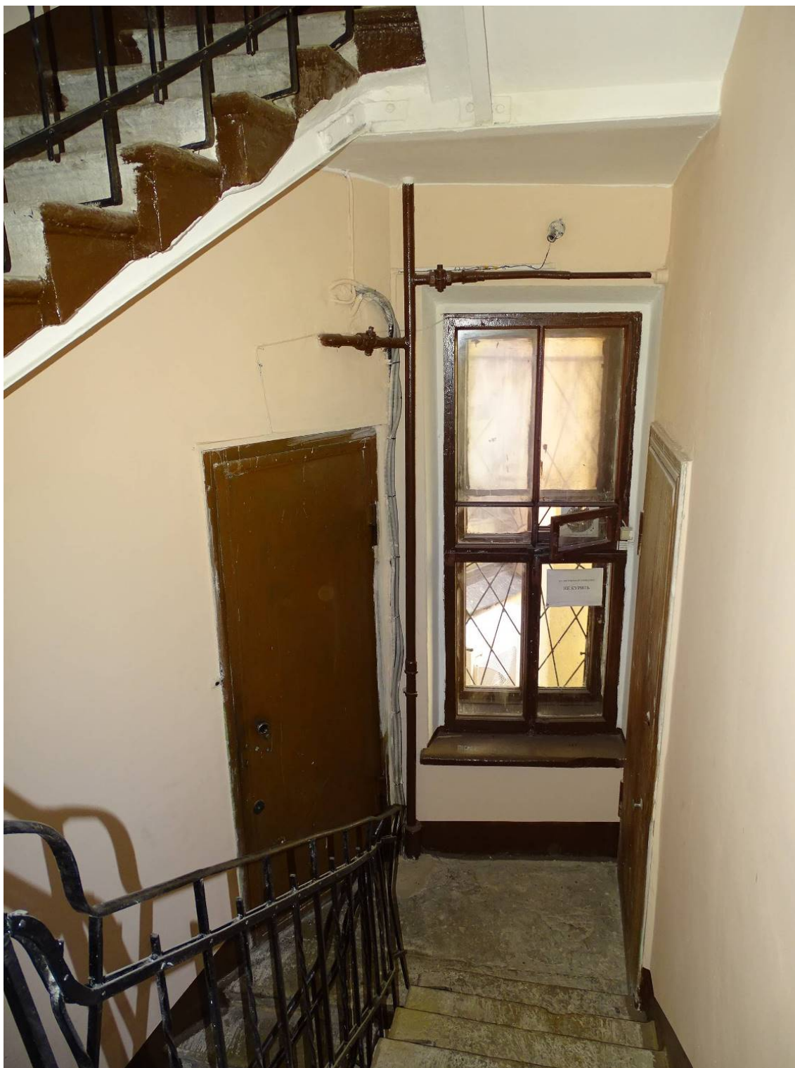
Фото 133. Лестница № 3. Площадка между 4-м и 5-м этажом. Съемка 19.04.2021 г. Трушковский В.Э.
