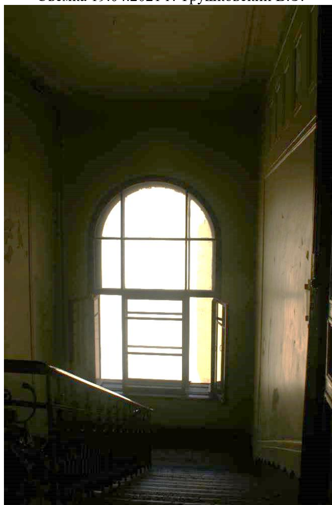
Фото 198. Лестница № 4. Площадка между 5-м и 6-м этажом. Съемка 19.04.2021 г. Трушковский В.Э.
