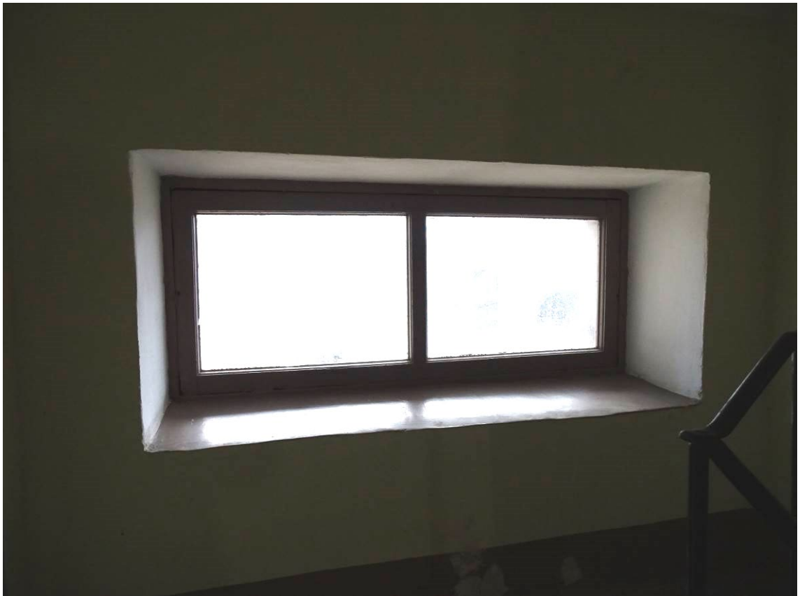
Фото 32. Лестница № 1. Площадка между 5-м и чердачным этажом. Съемка 19.04.2021 г. Трушковский В.Э.
