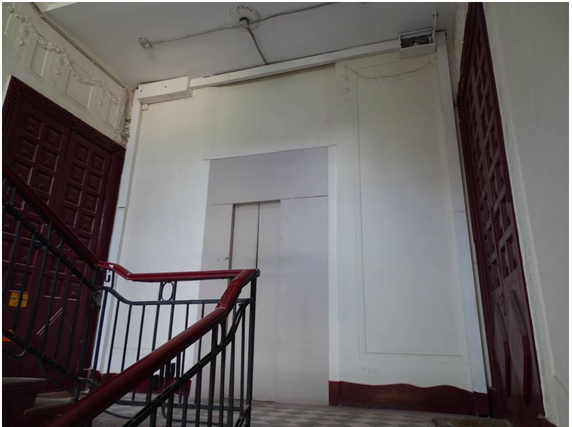
Фото 77. Лестница № 2. 2-й этаж. Съемка 19.04.2021 г. Трушковский В.Э.
