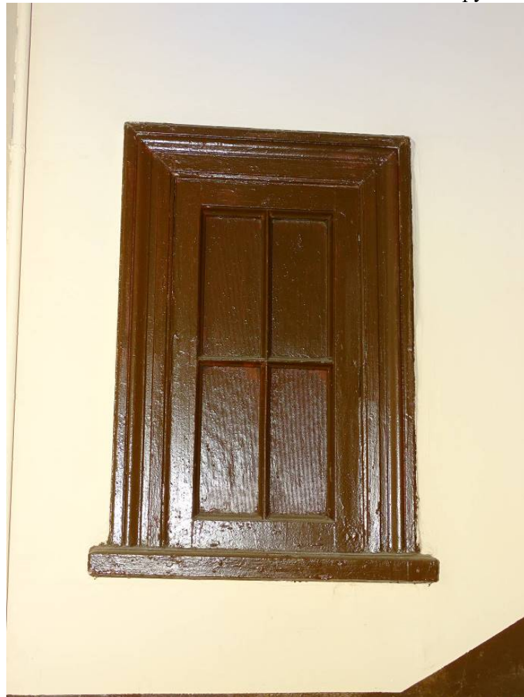
Фото 131. Лестница № 3. 4-й этаж. Съёмка 19.04.2021 г. Трушковский В.Э.
