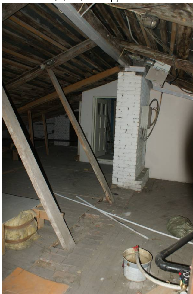
Фото 147. Лестница № 3. Чердак. Съемка 19.04.2021 г. Трушковский В.Э.
