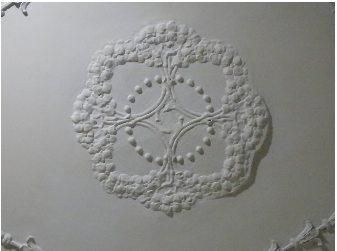
Фото 156. Лестница № 4. 1-й этаж. Парадная. Оформление потолка. Розетка. Съемка 19.04.2021 г. Трушковский В.Э.
