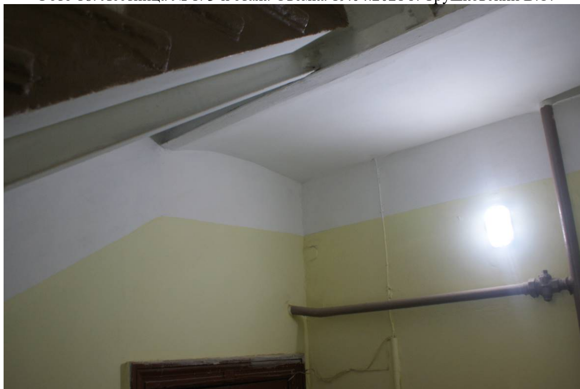
Фото 19. Лестница № 1. 3-й этаж. Свод. Съемка 19.04.2021 г. Трушковский В.Э.
