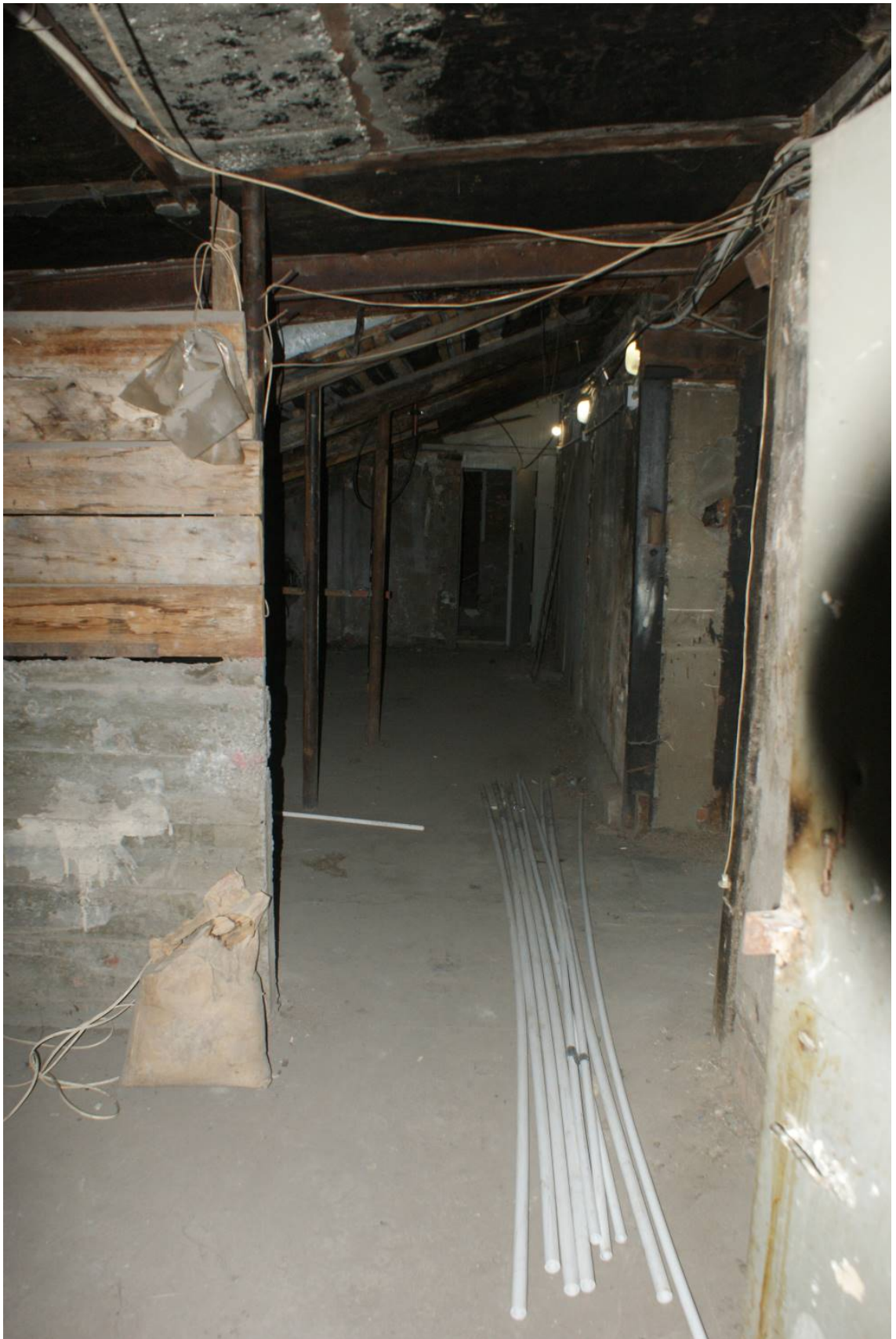
Фото 148. Лестница № 3. Чердак. Съемка 19.04.2021 г. Трушковский В.Э.
