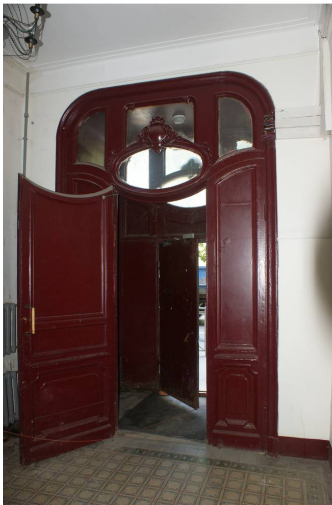
Фото 41. Лестница № 2. 1-й этаж. Заполнение дверного проема. Съемка 19.04.2021 г. Трушковский В.Э.
