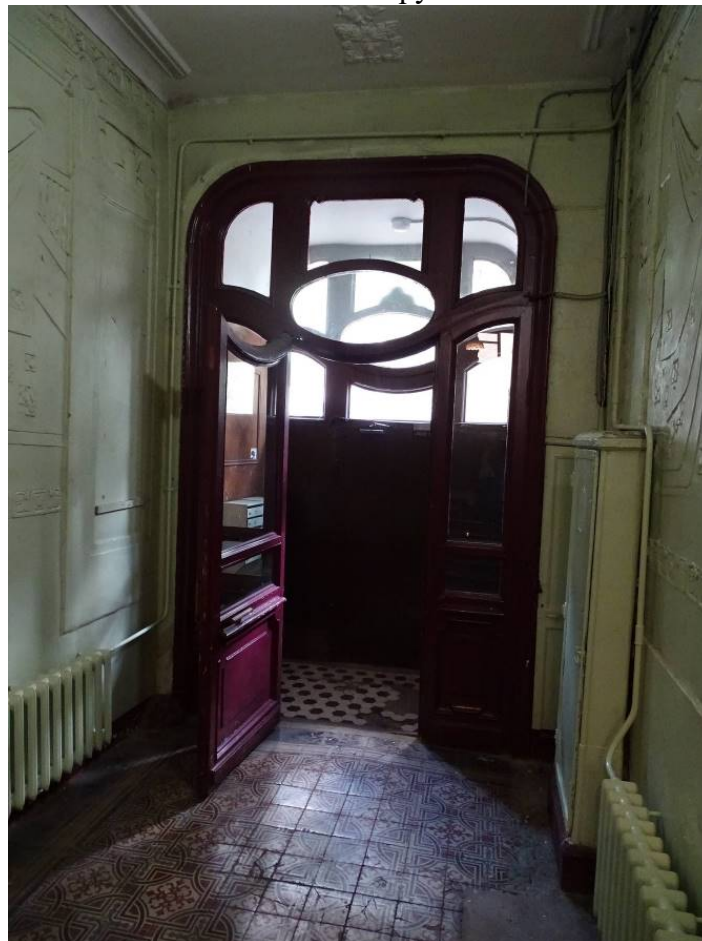
Фото 160. Лестница № 4. 1-й этаж. Парадная. Дверное заполнение. Съемка 19.04.2021 г. Трушковский В.Э.
