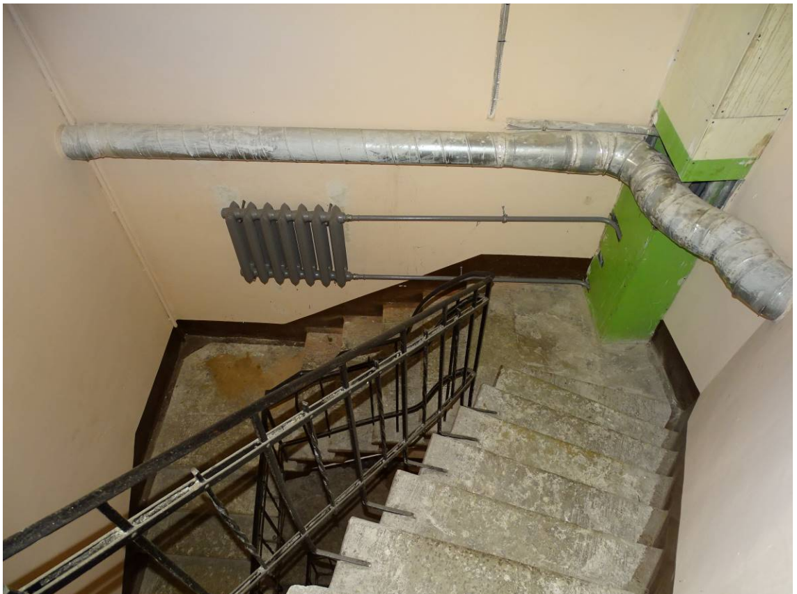
Фото 127. Лестница № 3. 3-й этаж. Съемка 19.04.2021 г. Трушковский В.Э.
