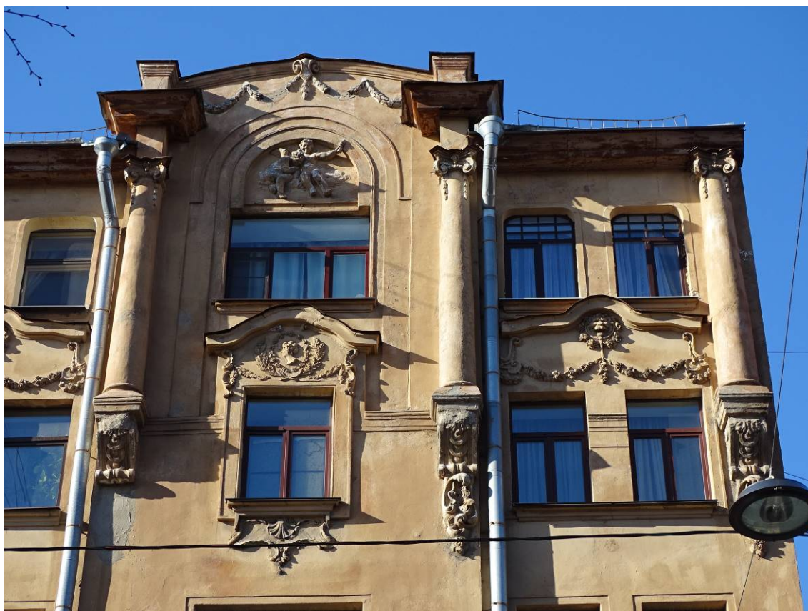
Фото 14. Здание по адресу: г. Санкт-Петербург, Большая Пушкарская ул., дом 1/8, литера А. Вид со Съезжинской ул. Фрагмент. Съемка 19.04.2021 г. Грушковский В.Э.
