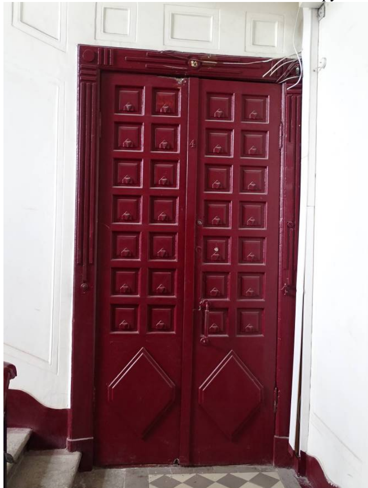
Фото 88. Лестница № 2. 3-й этаж. Съемка 19.04.2021 г. Трушковский В.Э.
