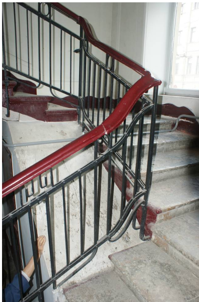
Фото 68. Лестница № 2. Площадка и лестничный марш между 1-м и 2-м этажом. Съемка 19.04.2021 г. Трушковский В.Э.
