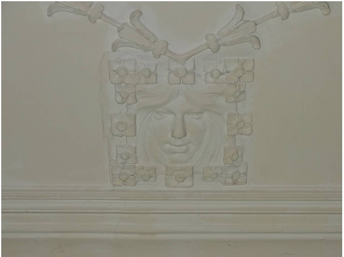
Фото 155. Лестница № 4. 1-й этаж. Парадная. Оформление потолка. Съемка 19.04.2021 г. Трушковский В.Э.
