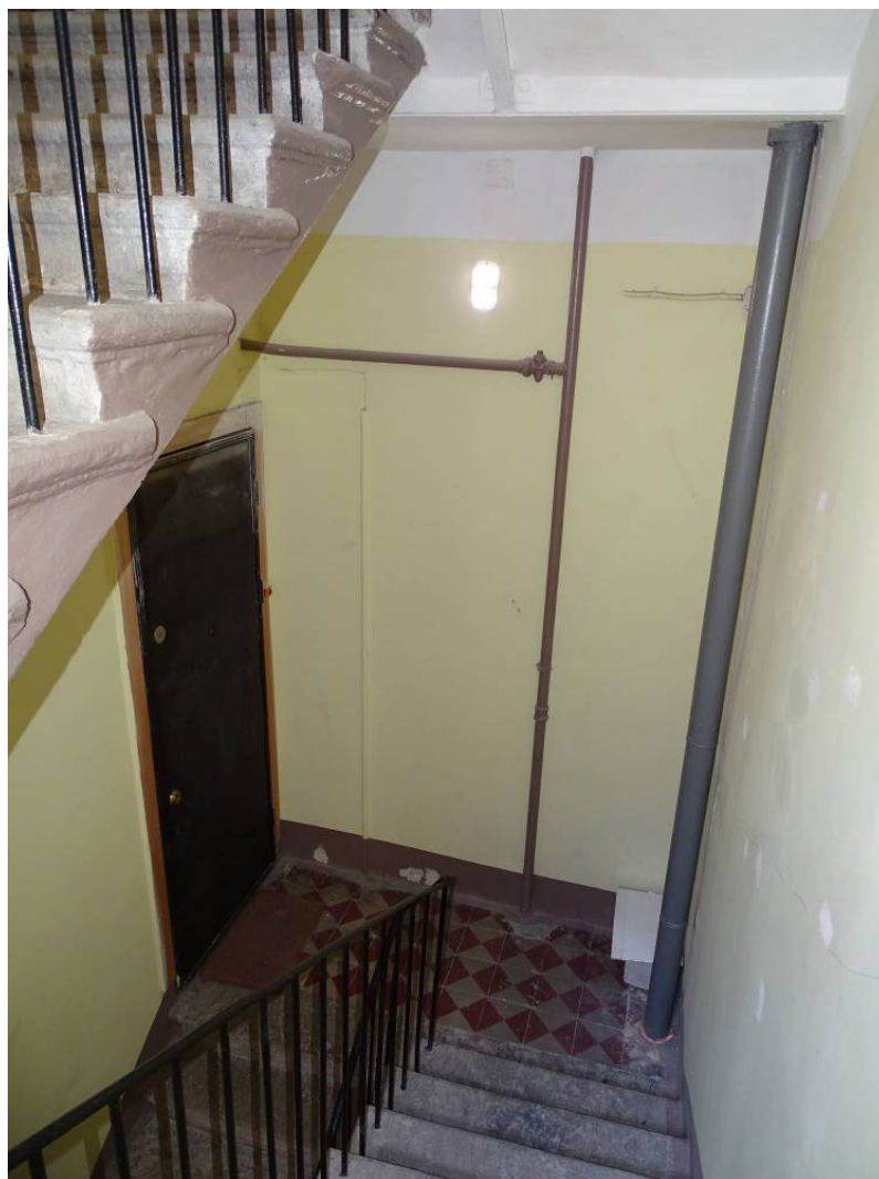
Фото 18. Лестница № 1. 3-й этаж. Съемка 19.04.2021 г. Трушковский В.Э.
