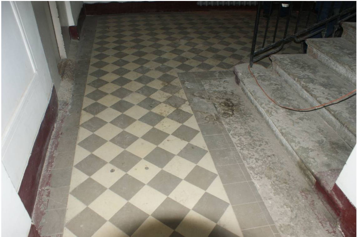
Фото 62. Лестница № 2. 1-й этаж. Парадная. Покрытие пола. Съемка 19.04.2021 г. Трушковский В.Э.
