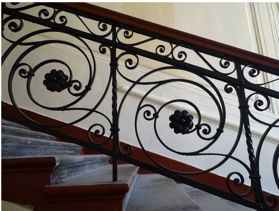
Фото 35. Лестница № 1. Площадка между 4-м и 5-м этажом. Покрытие пола. Съемка 19.04.2021 г. Трушковский В.Э.
