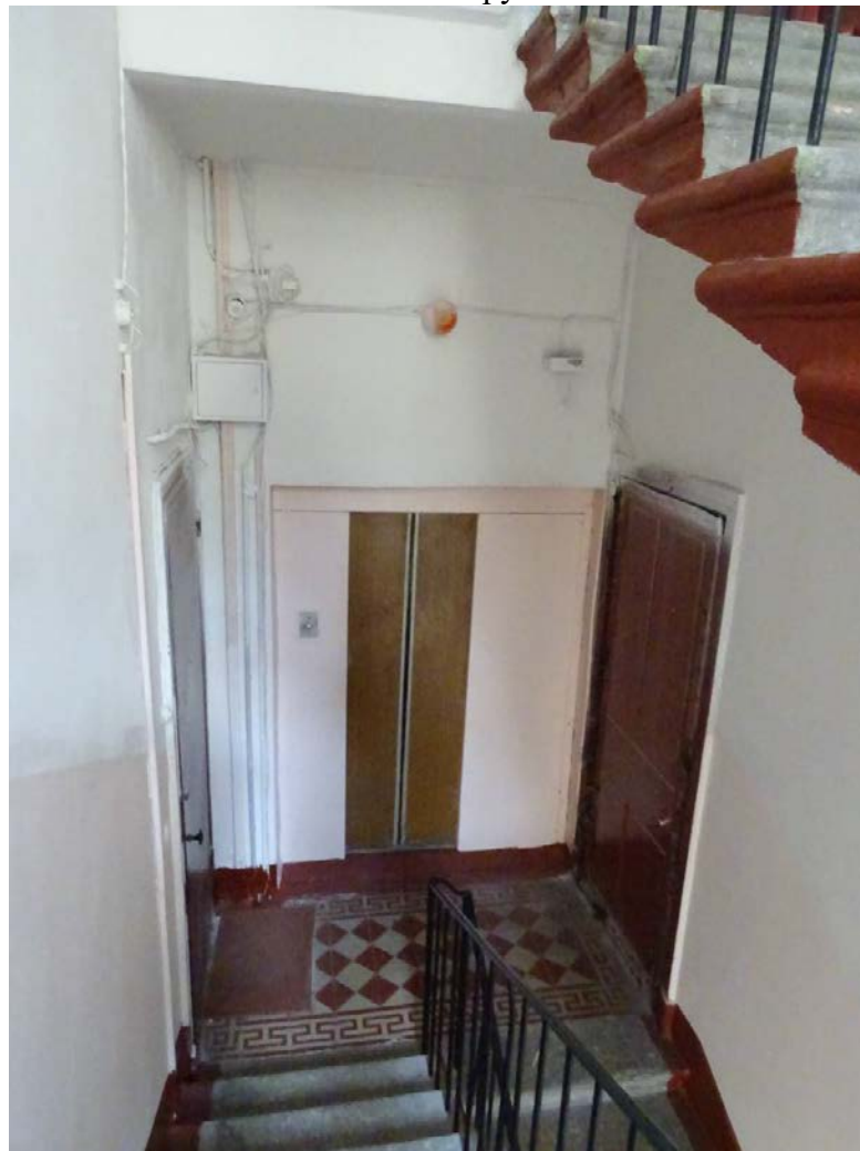
Фото 62. Лестница № 2. Вид на площадку 3-го этажа. Съемка 19.04.2021 г. Трушковский В.Э.
