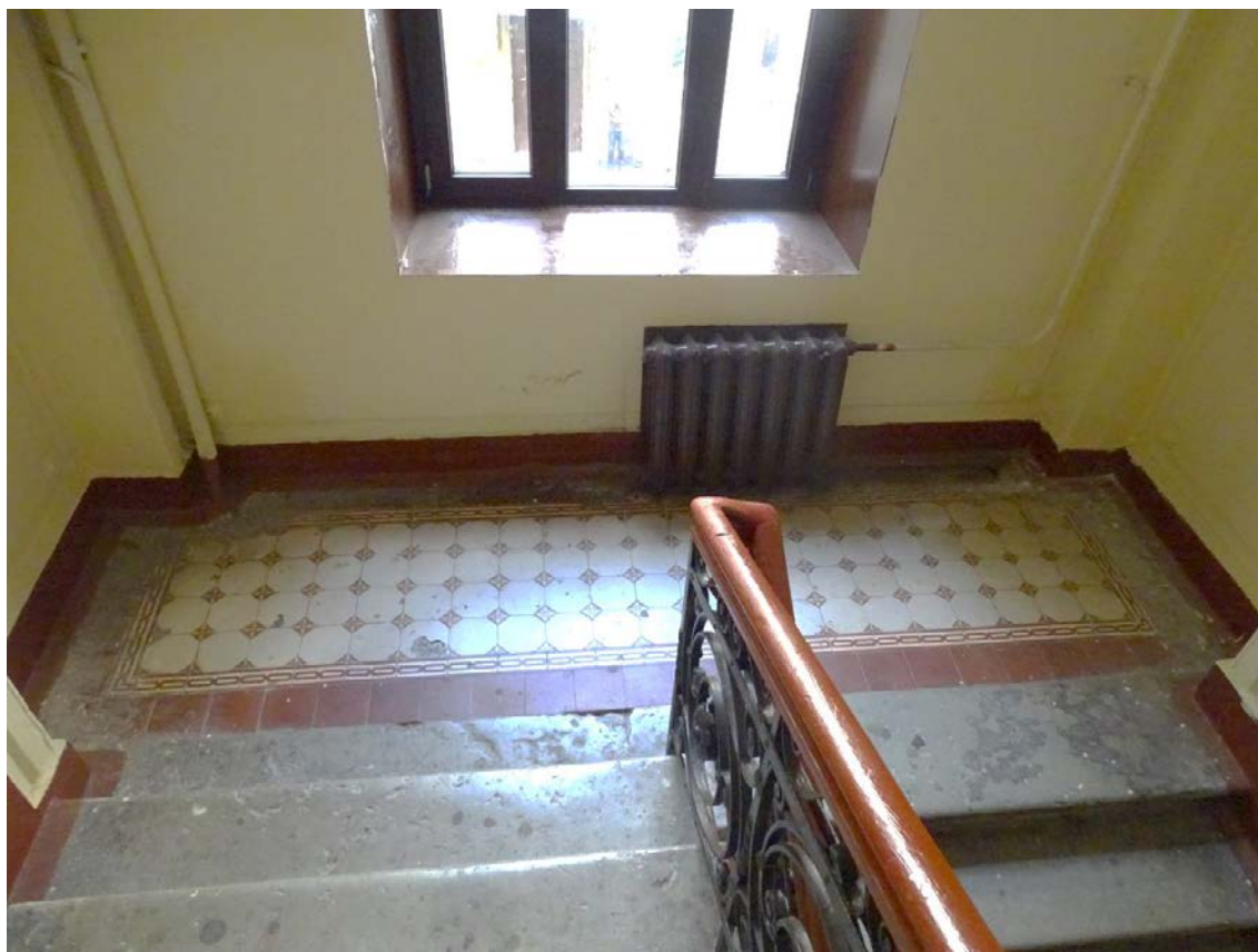
Фото 23. Лестница № 1. Площадка между 2-м и 3-м этажом. Покрытие пола. Съемка 19.04.2021 г. Трушковский В.Э.
