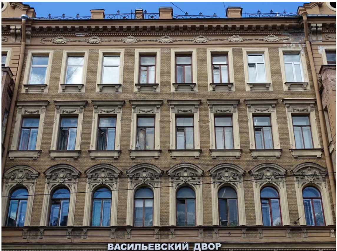
Фото 7. Здание по адресу: г. Санкт-Петербург, Средний пр. В. О., д. 11, литер А. Фрагмент лицевого фасада. Съемка 19.04.2021 г. Трушковский В.Э.
