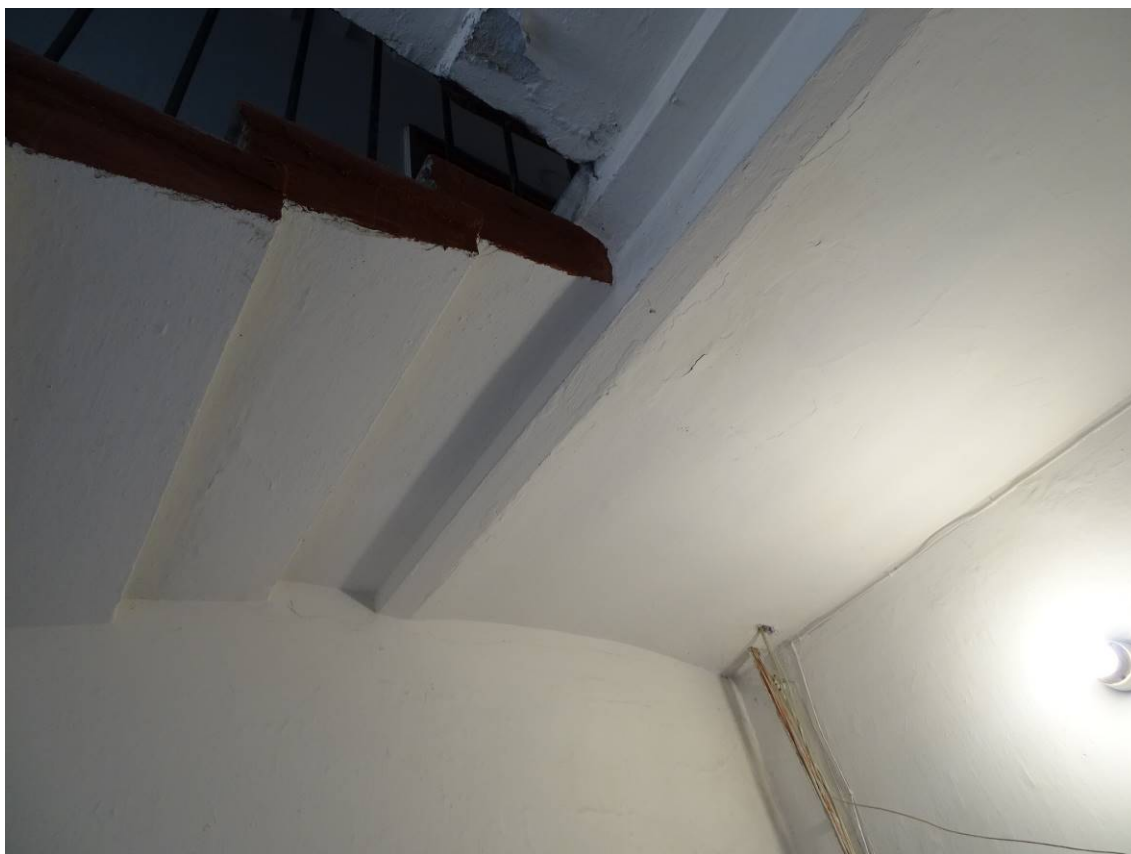
Фото 154. Лестница № 4. Площадка 5-го этажа. Съемка 19.04.2021 г. Трушковский В.Э.
