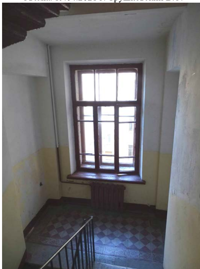
Фото 180. Лестница № 5. Вид на площадку между 3-м и 4-м этажом. Съемка 19.04.2021 г. Трушковский В.Э.
