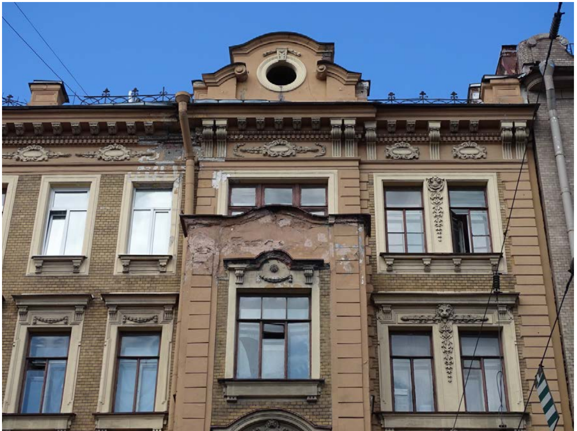
Фото 3. Здание по адресу: г. Санкт-Петербург, Средний пр. В. О., д. 11, литер А. Фрагмент лицевого фасада. 4-й, 5-й этаж. Съемка 19.04.2021 г. Трушковский В.Э.
