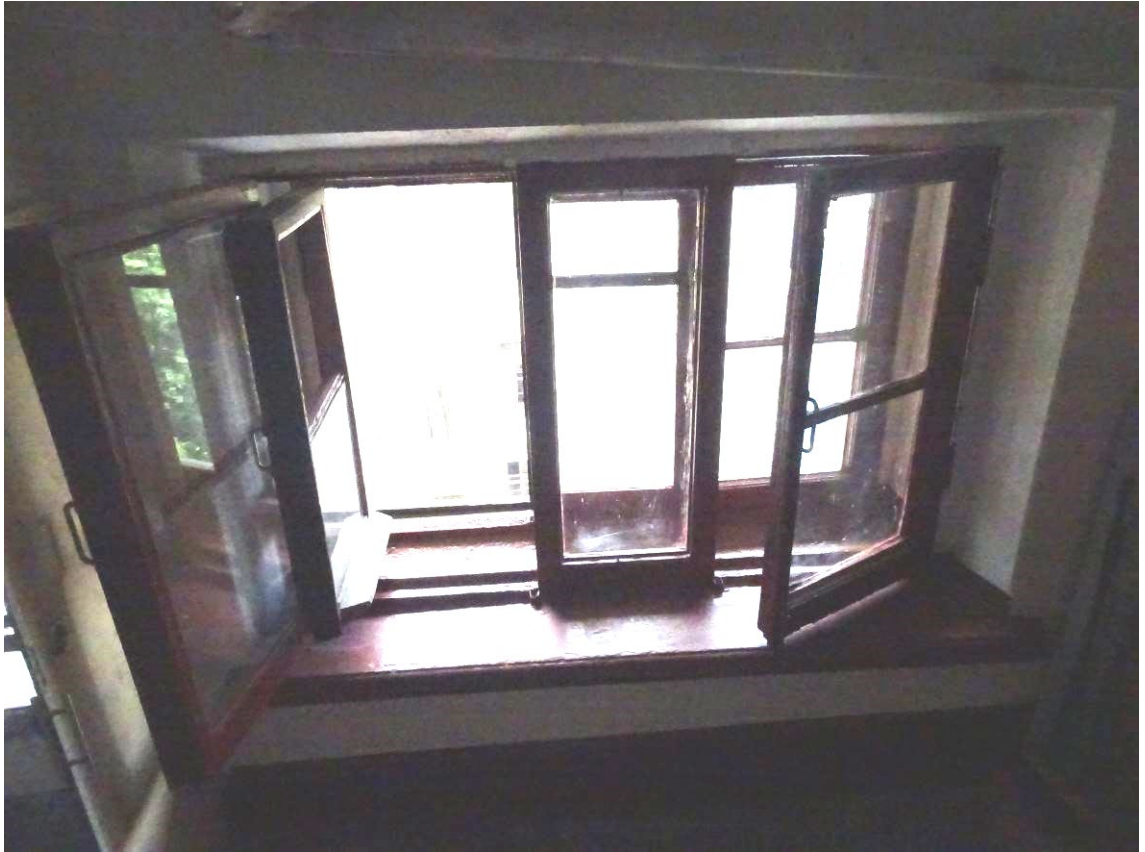
Фото 74. Лестница № 2. Площадка между 5-м и 6-м этажом. Оконный проем. Съемка 19.04.2021 г. Трушковский В.Э.
