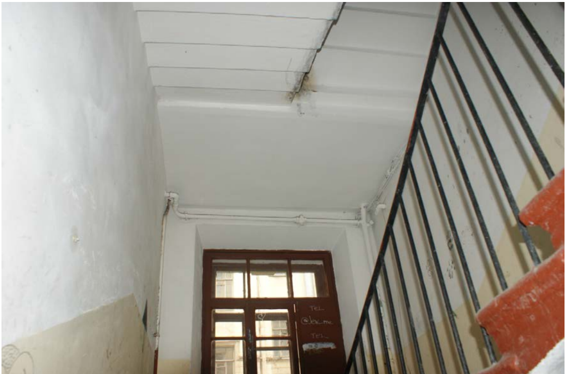
Фото 193. Лестница № 6. Вид на площадку между 1-м и 2-м этажом. Съемка 19.04.2021 г. Трушковский В.Э.
