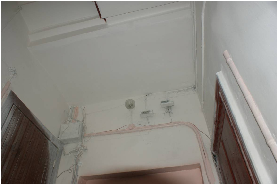
Фото 55. Лестница № 2. Площадка 2-го этажа. Съемка 19.04.2021 г. Трушковский В.Э.
