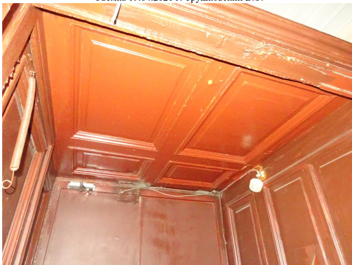
Фото 79. Лестница № 3. 1-й этаж. Вестибюль. Тамбур. Съемка 19.04.2021 г. Трушковский В.Э.
