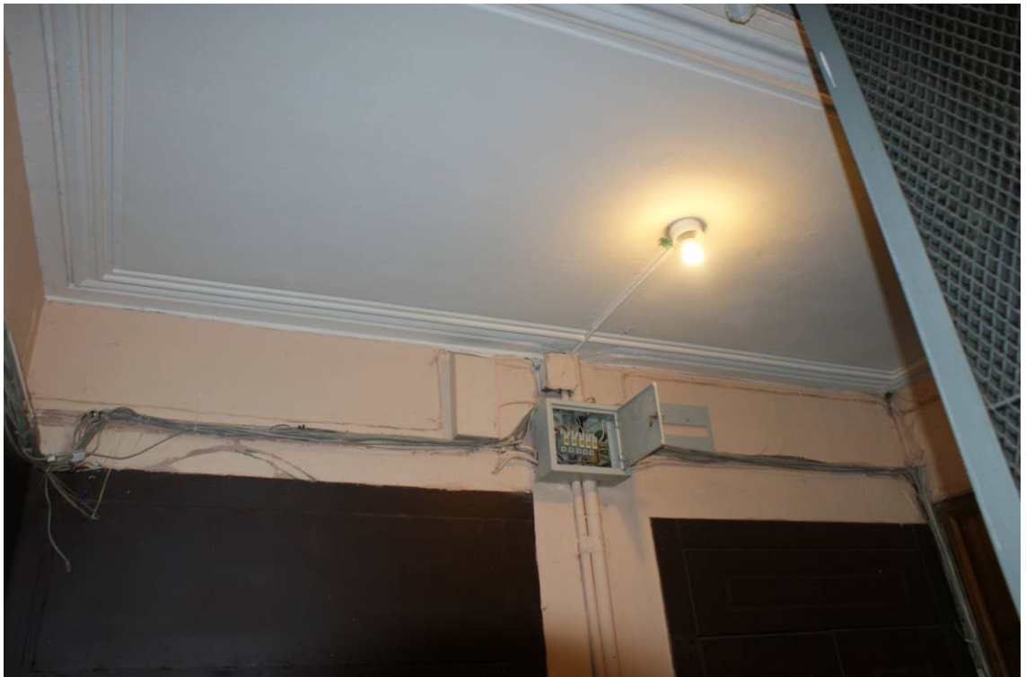
Фото 111. Лестница № 3. Площадка 5-го этажа. Оформление потолка. Съемка 19.04.2021 г. Трушковский В.Э.
