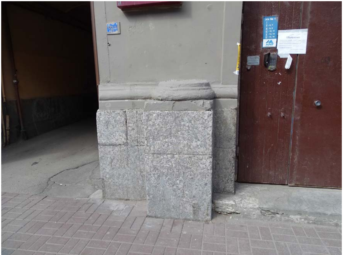
Фото 15. Здание по адресу: г. Санкт-Петербург, Средний пр. В. О., д. 11, литер А. Фрагмент лицевого фасада. Гранитный цоколь. Съемка 19.04.2021 г. Трушковский В.Э.
