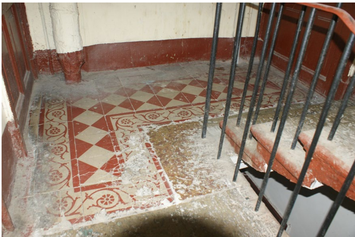
Фото 202. Лестница № 6. 3 этаж. Съемка 19.04.2021 г. Трушковский В.Э.
