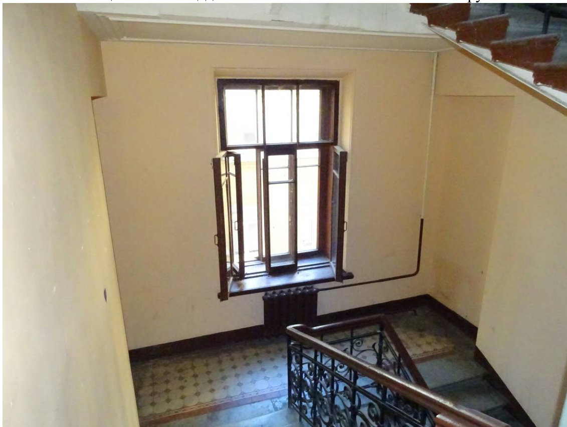
Фото 97. Лестница № 3. Вид на площадку между 2-м и 3-м этажом. Съемка 19.04.2021 г. Трушковский В.Э.
