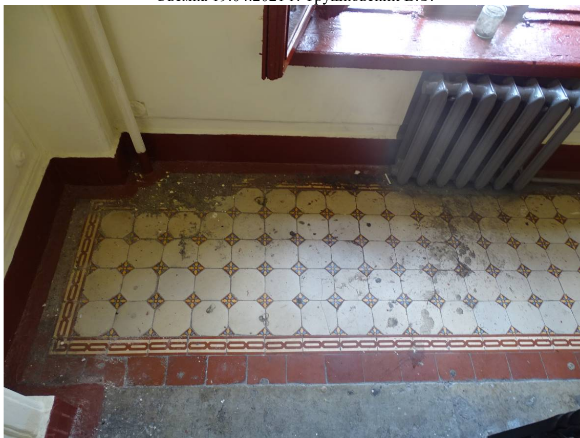
Фото 42. Лестница № 1. Площадка м/ду 5-м и 6-м этажом. Съемка 19.04.2021 г. Трушковский В.Э.
