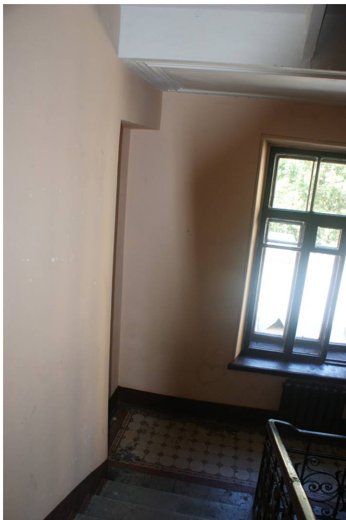
Фото 106. Лестница № 3. Вид на площадку между 4-м и 5-м этажом. Съемка 19.04.2021 г. Трушковский В.Э.
