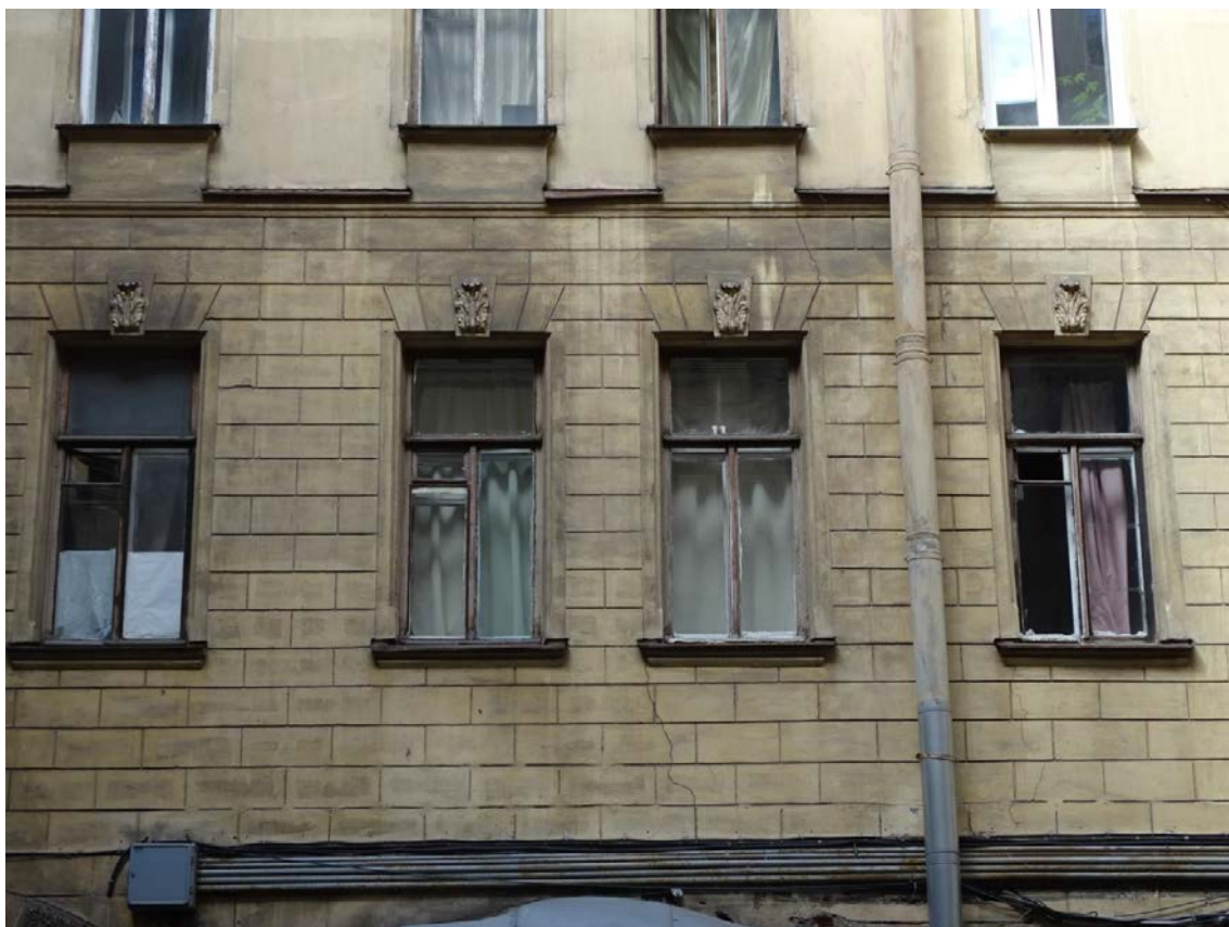
Фото 23. Здание по адресу: г. Санкт-Петербург, Средний пр. В. О., д. 11, литер А. Юго-восточный внутренний двор. Съемка 19.04.2021 г. Трушковский В.Э.
