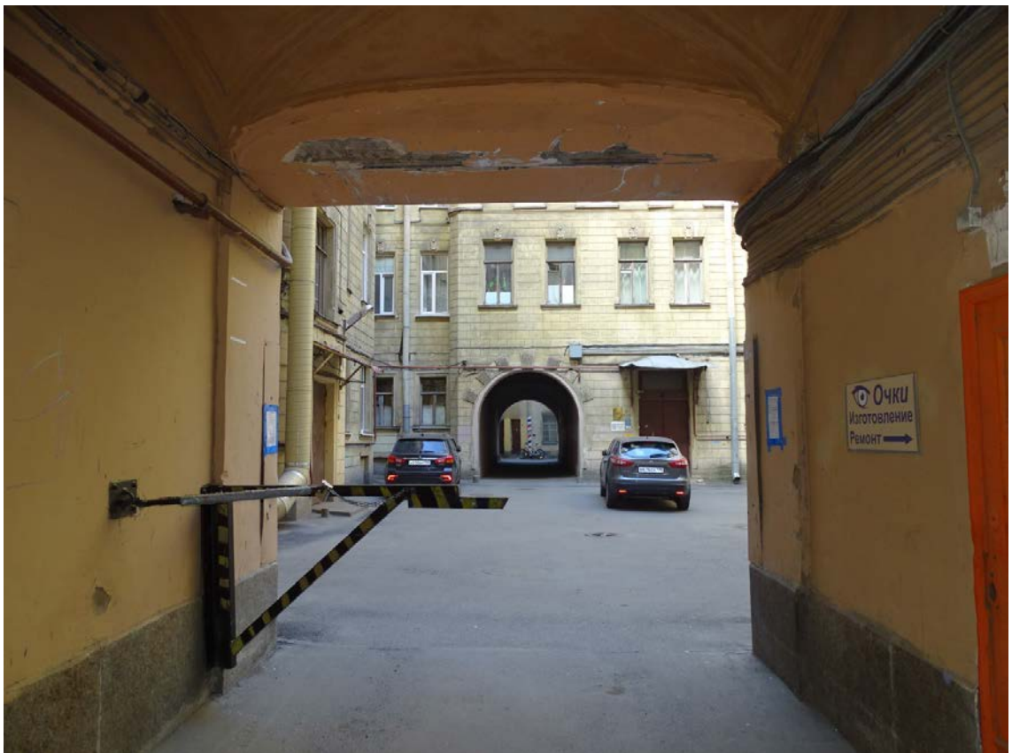
Фото 16. Здание по адресу: г. Санкт-Петербург, Средний пр. В. О., д. 11, литер А. Воротный проезд лицевого фасада. Съемка 19.04.2021 г. Трушковский В.Э.
