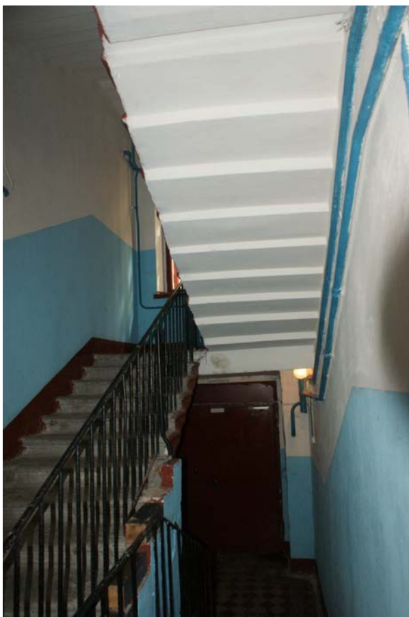
Фото 128. Лестница № 4. 1-й этаж. Вестибюль. Вид на входную дверь. Съемка 19.04.2021 г. Трушковский В.Э.
