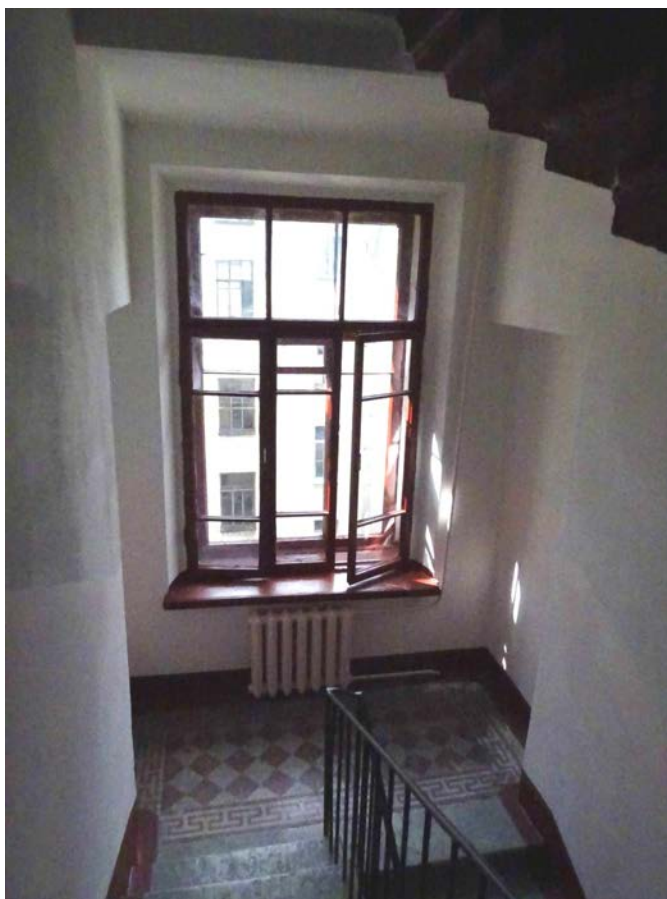
Фото 66. Лестница № 2. Вид на площадку между 4-м и 5-м этажом. Съемка 19.04.2021 г. Трушковский В.Э.
