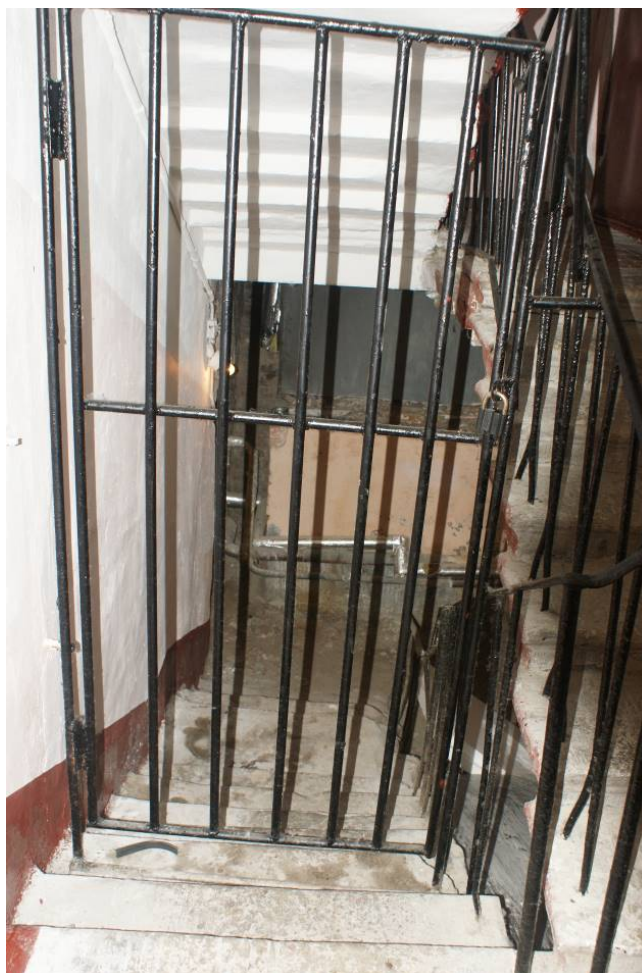
Фото 46. Лестница № 2. Подвальный этаж. Съемка 19.04.2021 г. Трушковский В.Э.
