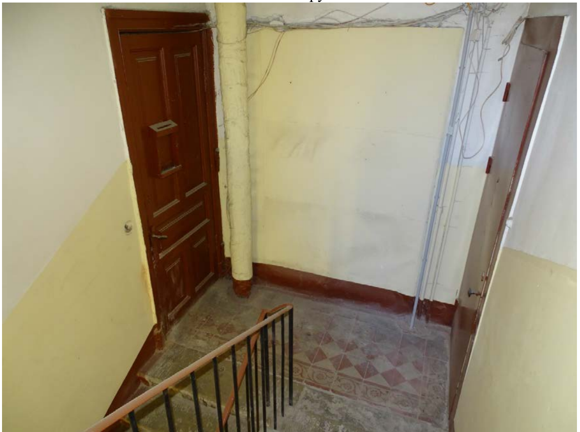
Фото 215. Лестница № 6. 5 этаж. Съемка 19.04.2021 г. Трушковский В.Э.
