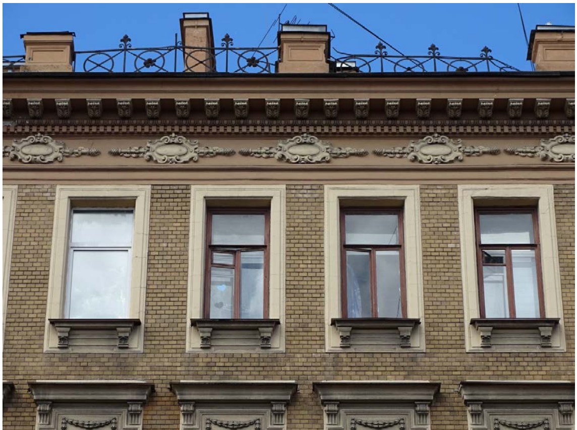
Фото 8. Здание по адресу: г. Санкт-Петербург, Средний пр. В. О., д. 11, литер А. Фрагмент лицевого фасада. 5-й этаж. Съемка 19.04.2021 г. Трушковский В.Э.
