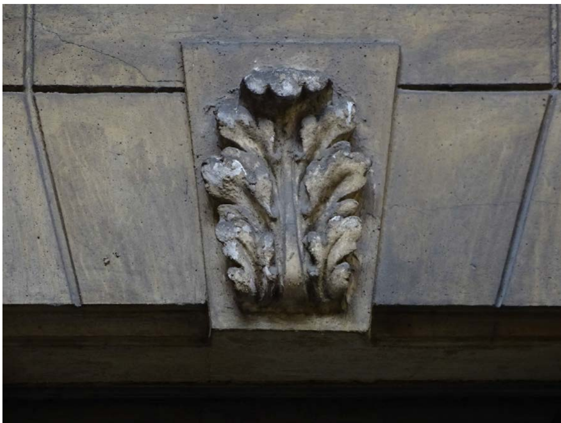
Фото 24. Здание по адресу: г. Санкт-Петербург, Средний пр. В. О., д. 11, литер А. Юго-восточный внутренний двор. Стилизованный замковый камень. Съемка 19.04.2021 г. Трушковский В.Э.
