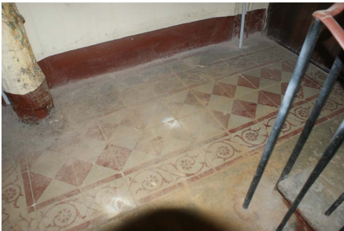
Фото 208. Лестница № 6. 4 этаж. Оформление пола. Съемка 19.04.2021 г. Трушковский В.Э.
