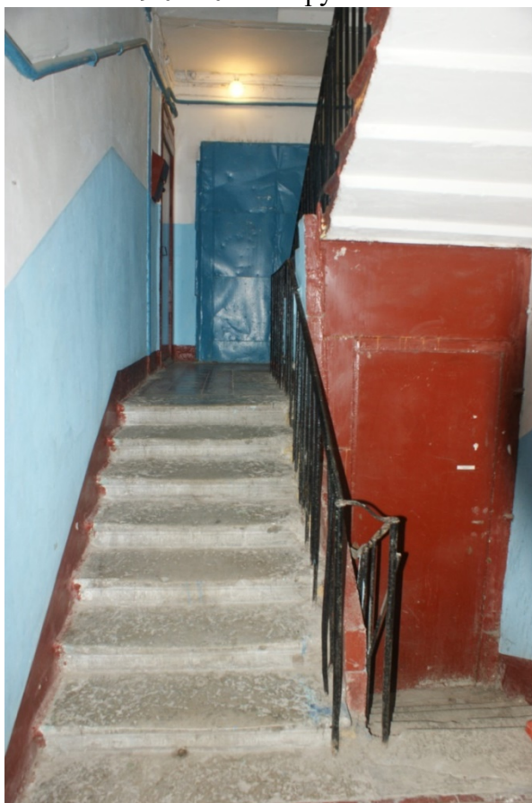
Фото 129. Лестница № 4. Вид на площадку 1-го этажа. Съемка 19.04.2021 г. Трушковский В.Э.
