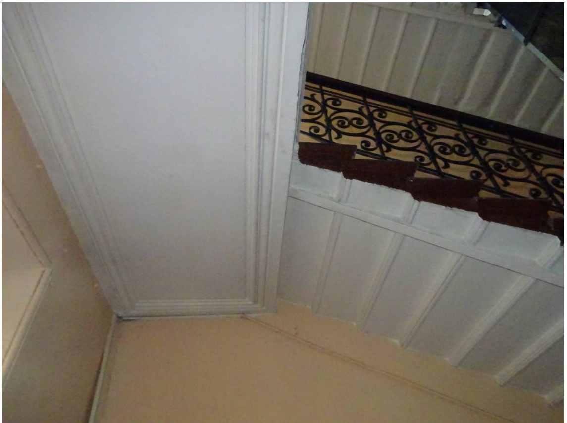
Фото 93. Лестница № 3. Площадку между 1-м и 2-м этажом. Съемка 19.04.2021 г. Трушковский В.Э.
