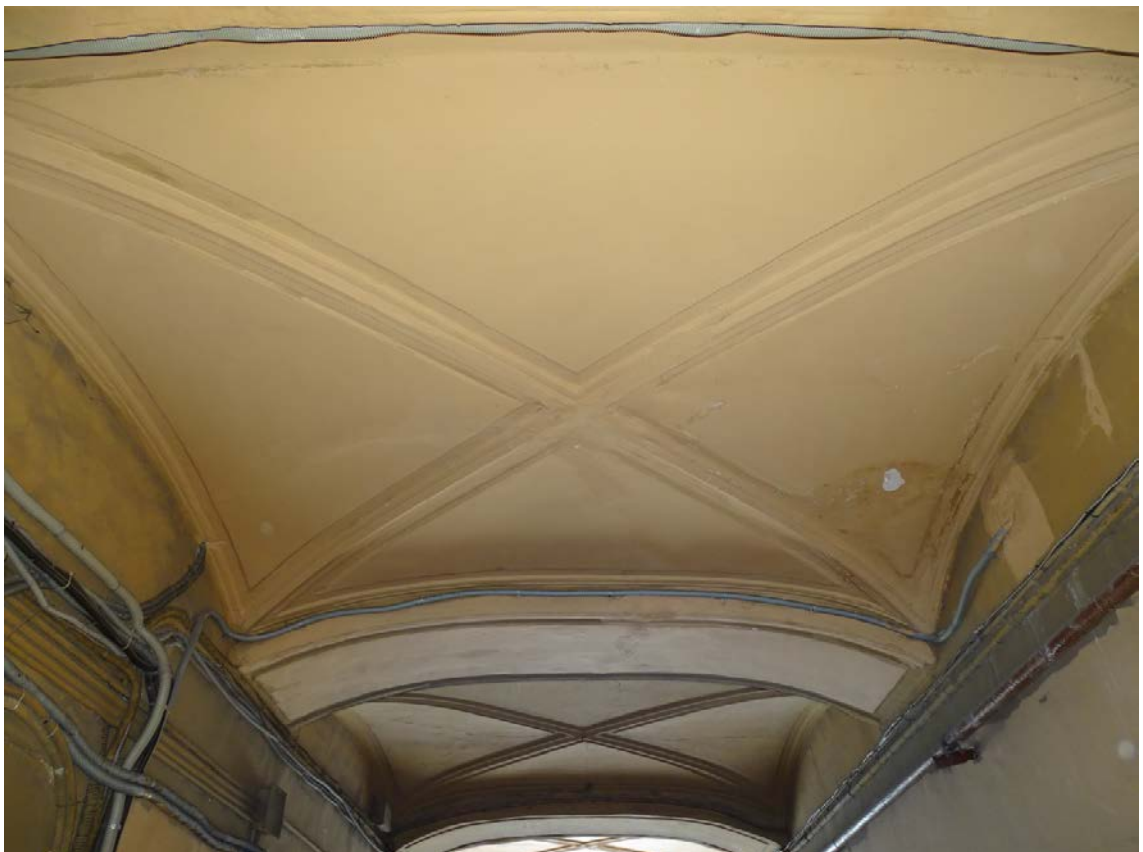
Фото 50. Здание по адресу: г. Санкт-Петербург, Средний пр. В. О., д. 11, литер А. Воротный проезд. Оформление перекрытия. Съемка 19.04.2021 г. Трушковский В.Э.
