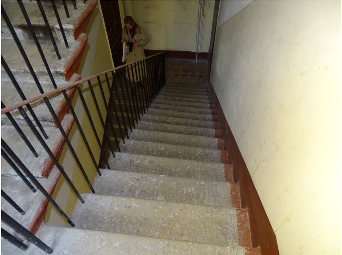
Фото 210. Лестница № 6. 4 этаж. Съемка 19.04.2021 г. Трушковский В.Э.
