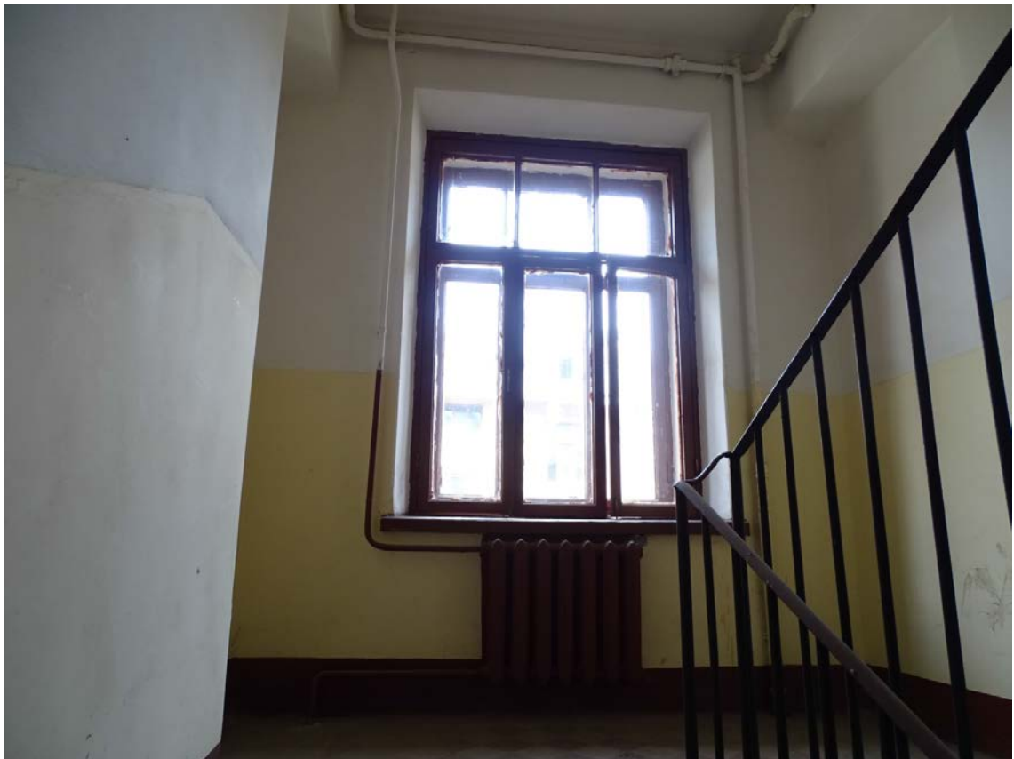
Фото 217. Лестница № 6. Вид на площадку между 5-м и 6-м этажом. Съемка 19.04.2021 г. Трушковский В.Э.
