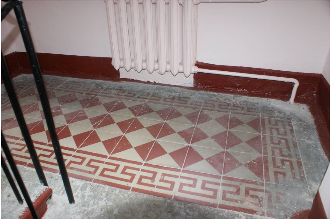
Фото 59. Лестница № 2. Площадка 2-го этажа. Покрытие пола. Съемка 19.04.2021 г. Трушковский В.Э.
