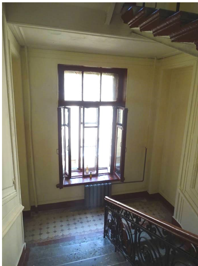
Фото 32. Лестница № 1. Вид на площадку между 4-м и 5-м этажом. Съемка 19.04.2021 г. Трушковский В.Э.
