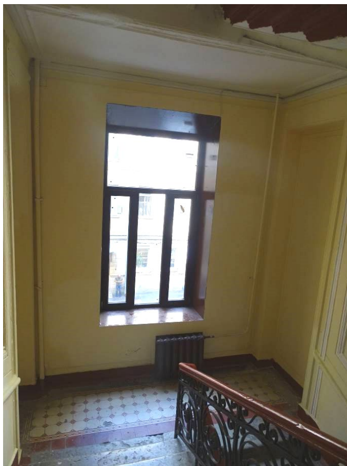
Фото 22. Лестница № 1. Вид на площадку между 2-м и 3-м этажом. Съемка 19.04.2021 г. Трушковский В.Э.
