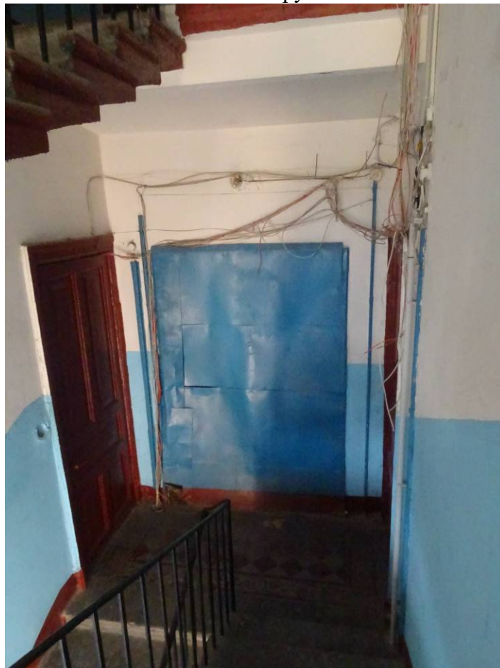
Фото 157. Лестница № 4. Вид на площадку 6-го этажа. Съемка 19.04.2021 г. Трушковский В.Э.
