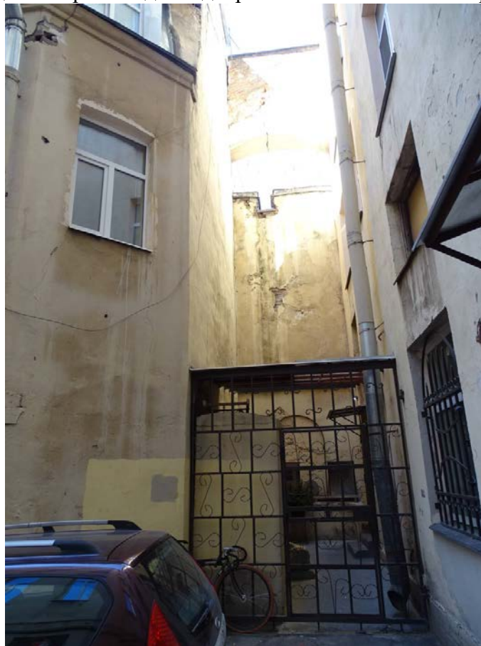
Фото 46. Здание по адресу: г. Санкт-Петербург, Средний пр. В. О., д. 11, литер А. Фрагмент фасада. Северо-западный двор. Съемка 19.04.2021 г. Трушковский В.Э.
