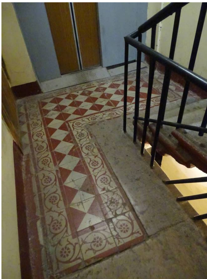
Фото 169. Лестница № 5. Площадка 1-го этажа. Покрытие пола. Съемка 19.04.2021 г. Трушковский В.Э.
