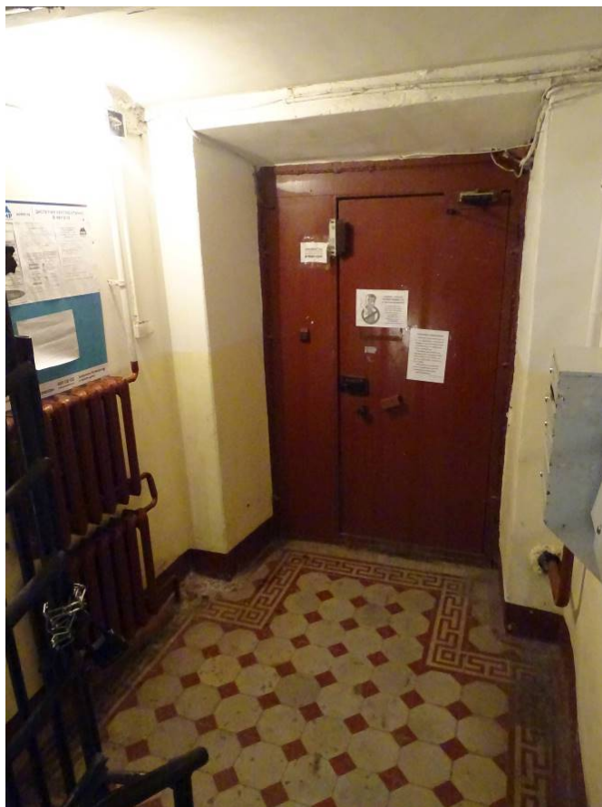
Фото 163. Лестница № 5. 1-й этаж. Вестибюль. Входная дверь. Съемка 19.04.2021 г. Трушковский В.Э.
