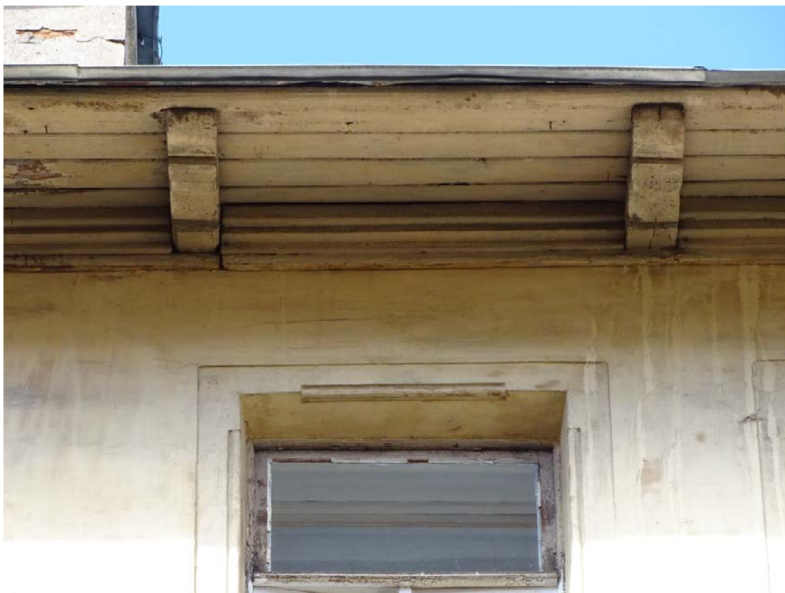
Фото 25. Здание по адресу: г. Санкт-Петербург, Средний пр. В. О., д. 11, литер А. Юго-восточный внутренний двор. Съемка 19.04.2021 г. Трушковский В.Э.
