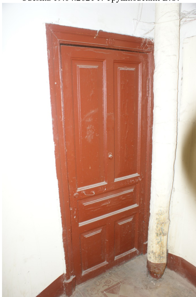
Фото 209. Лестница № 6. 4 этаж. Дверное заполнение. Съемка 19.04.2021 г. Трушковский В.Э.
