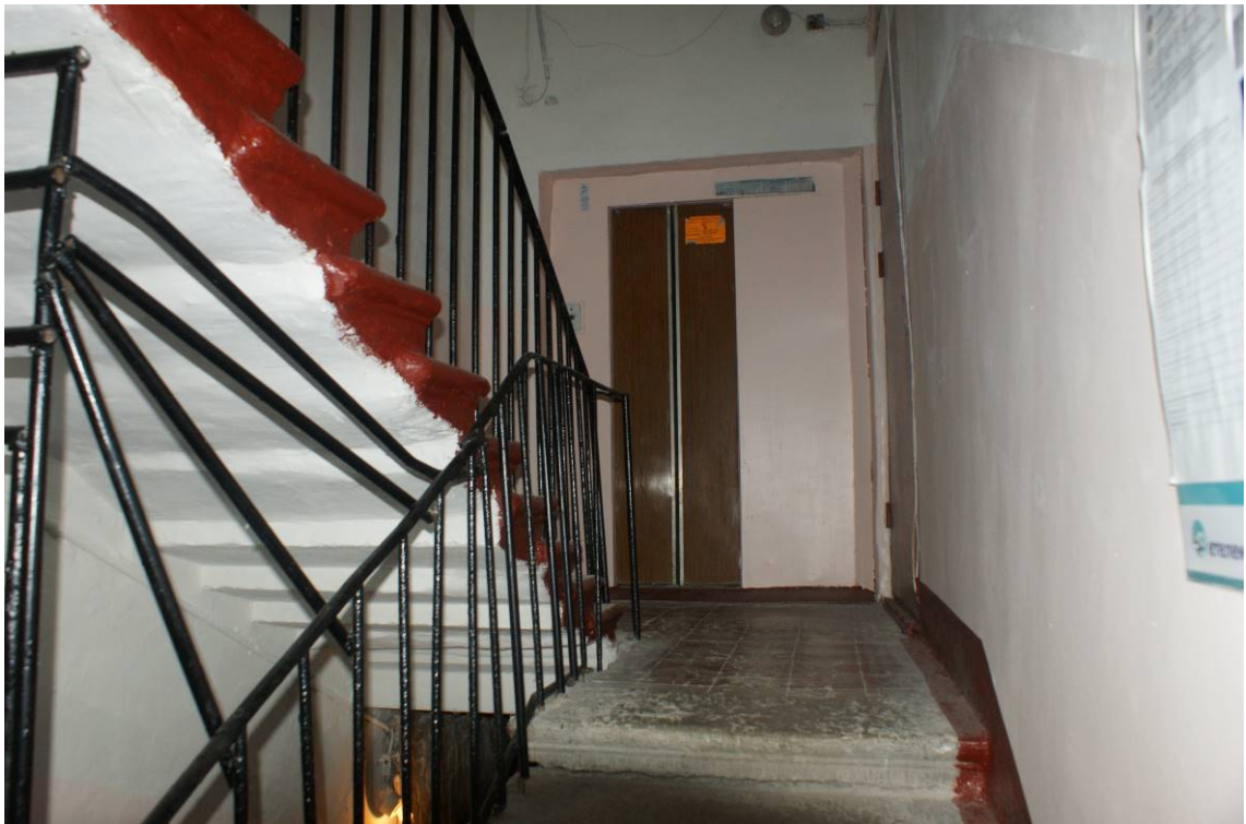
Фото 49. Лестница № 2. Вид на площадку 1-го этажа. Съемка 19.04.2021 г. Трушковский В.Э.
