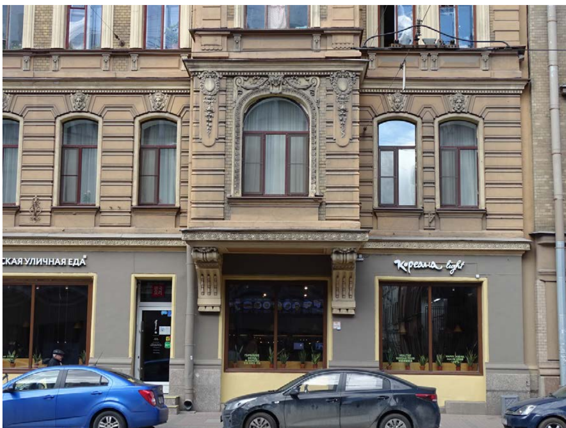
Фото 5. Здание по адресу: г. Санкт-Петербург, Средний пр. В. О., д. 11, литер А. Фрагмент лицевого фасада. 1-й, 2-й этаж. Съемка 19.04.2021 г. Трушковский В.Э.
