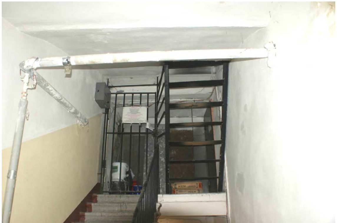
Фото 186. Лестница № 5. Вид на площадку чердачного этажа. Съемка 19.04.2021 г. Трушковский В.Э.
