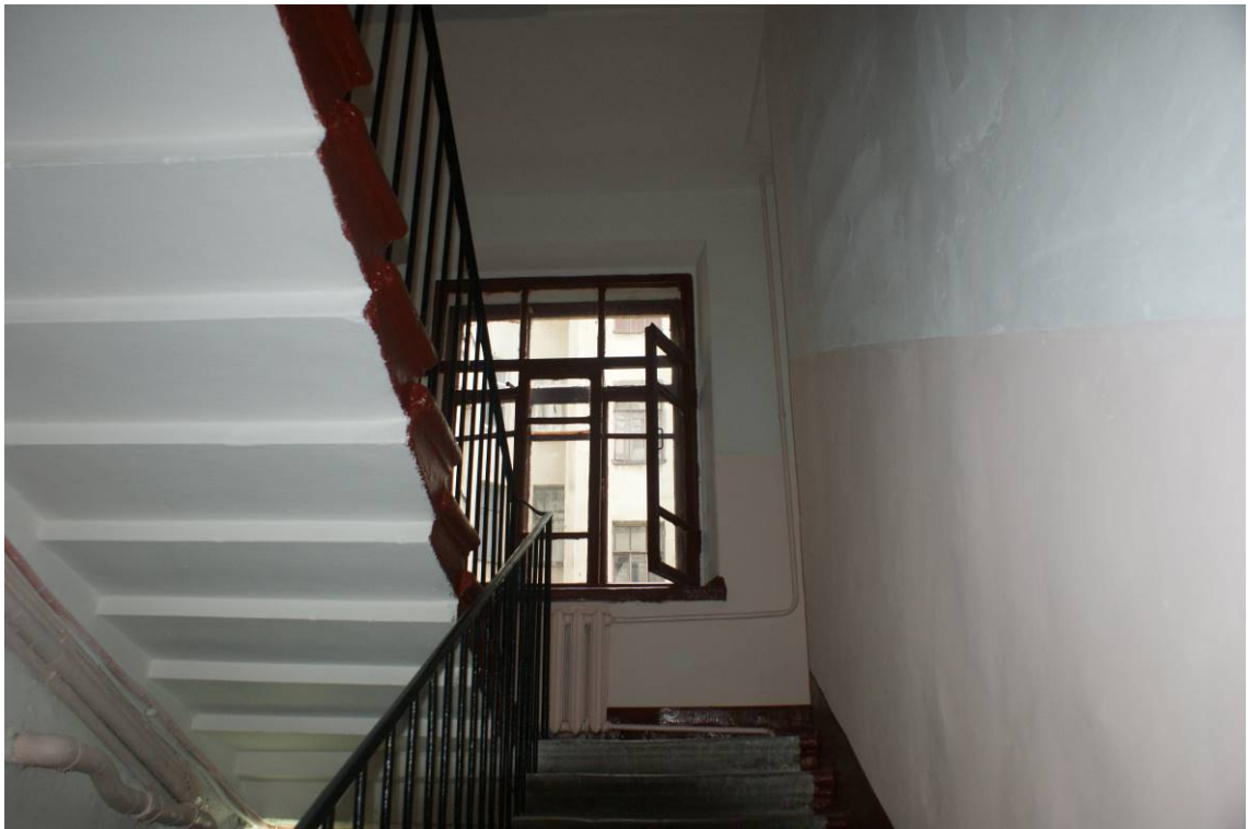
Фото 52. Лестница № 2. Вид на площадку между 1-м и 2-м этажом. Съемка 19.04.2021 г. Трушковский В.Э.
