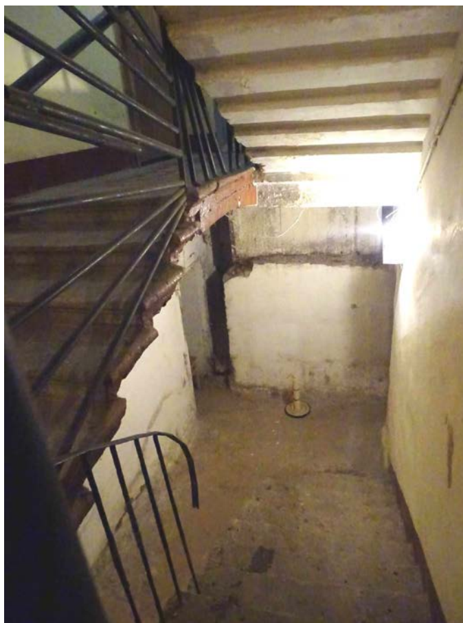
Фото 167. Лестница № 5. Подвальный этаж. Съемка 19.04.2021 г. Трушковский В.Э.
