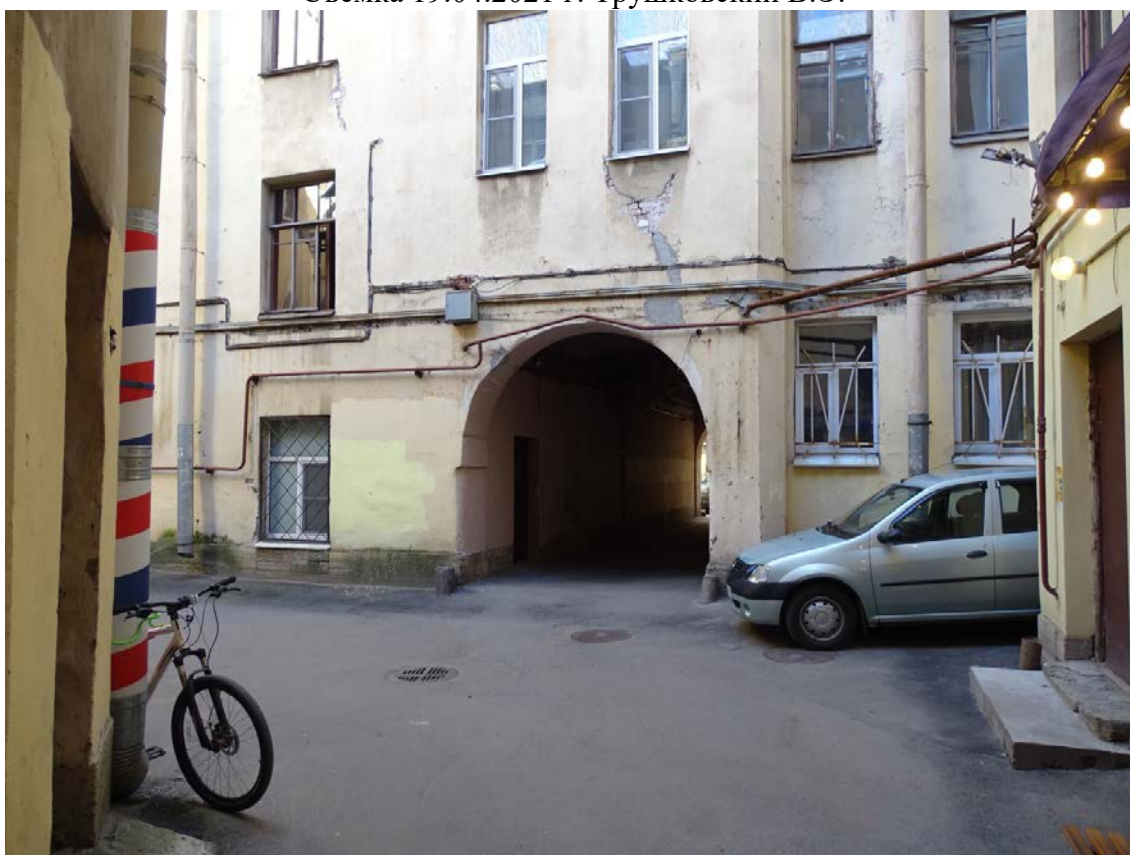
Фото 39. Здание по адресу: г. Санкт-Петербург, Средний пр. В. О., д. 11, литер А. Фрагмент фасада поперечного корпуса. Воротный проезд. Северо-западный двор. Съемка 19.04.2021 г. Трушковский В.Э.
