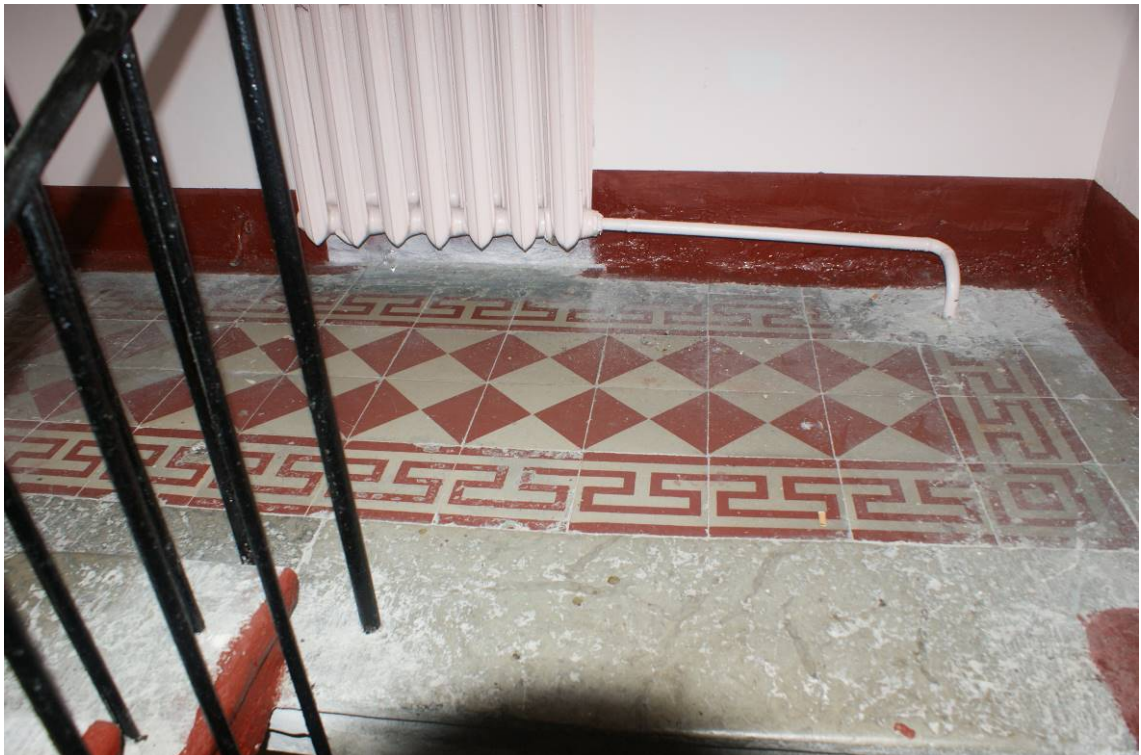
Фото 53. Лестница № 2. Площадка между 1-м и 2-м этажом. Покрытие пола. Съемка 19.04.2021 г. Трушковский В.Э.
