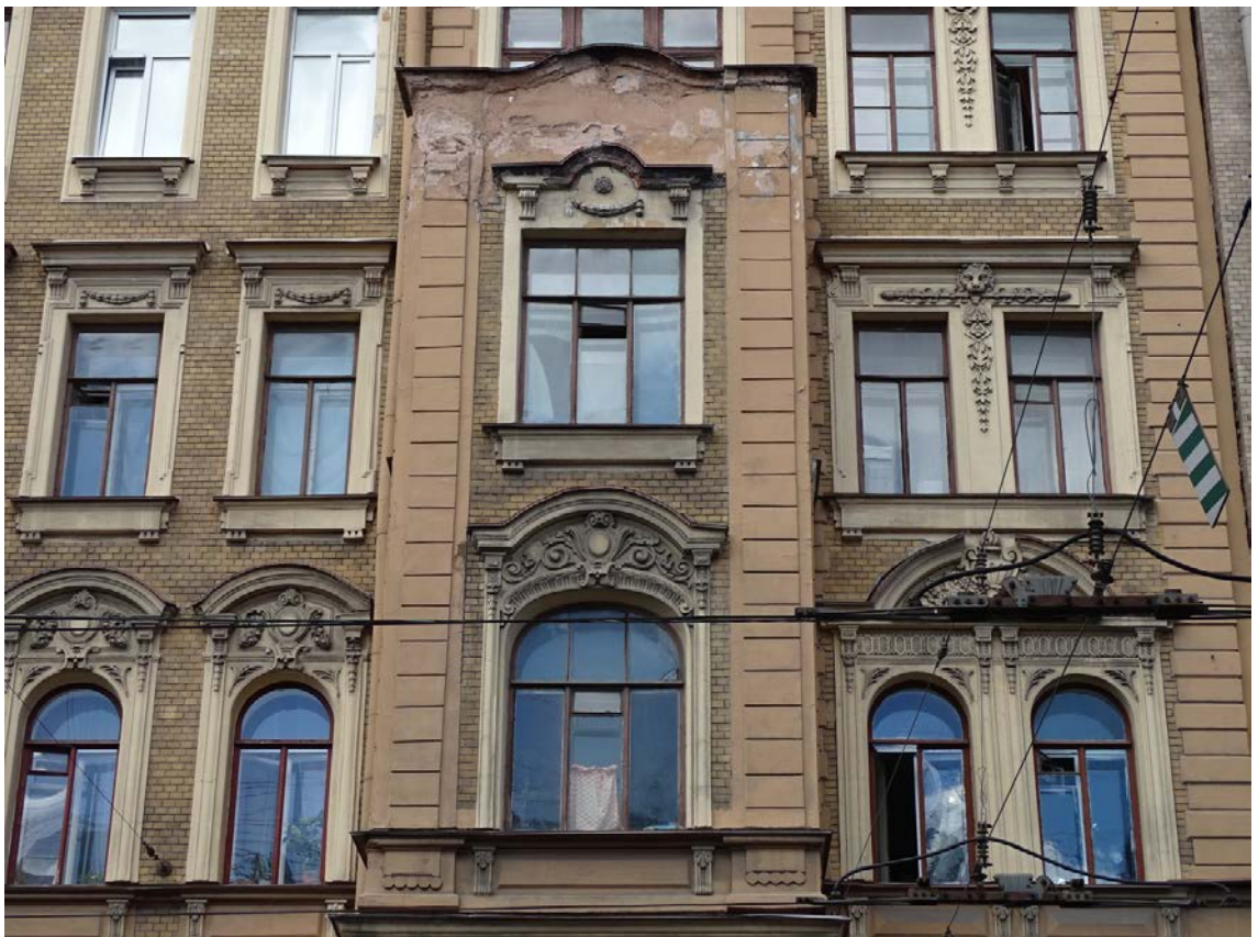
Фото 4. Здание по адресу: г. Санкт-Петербург, Средний пр. В. О., д. 11, литер А. Фрагмент лицевого фасада. Эркер. 3-й, 4-й этаж. Съемка 19.04.2021 г. Трушковский В.Э.
