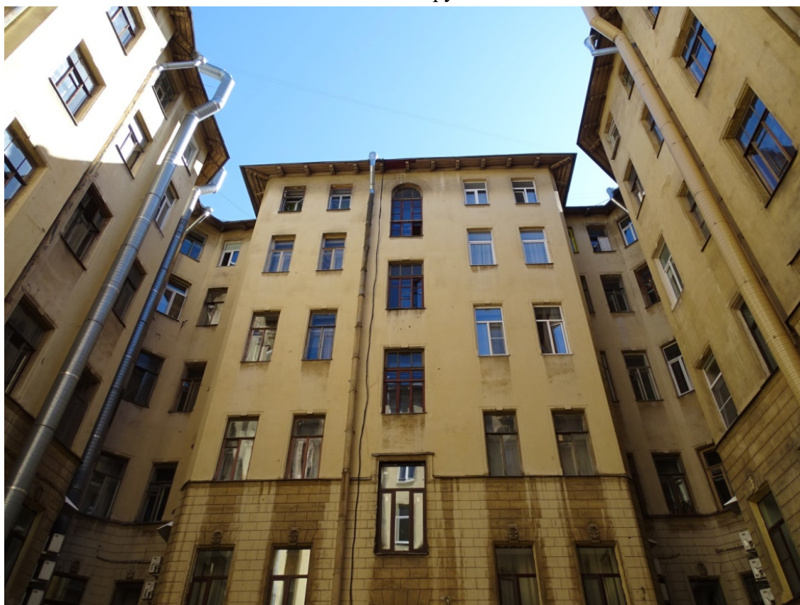
Фото 34. Здание по адресу: г. Санкт-Петербург, Средний пр. В. О., д. 11, литер А. Юго-восточный внутренний двор. Фрагмент дворового фасада лицевого корпуса. Съемка 19.04.2021 г. Трушковский В.Э.
