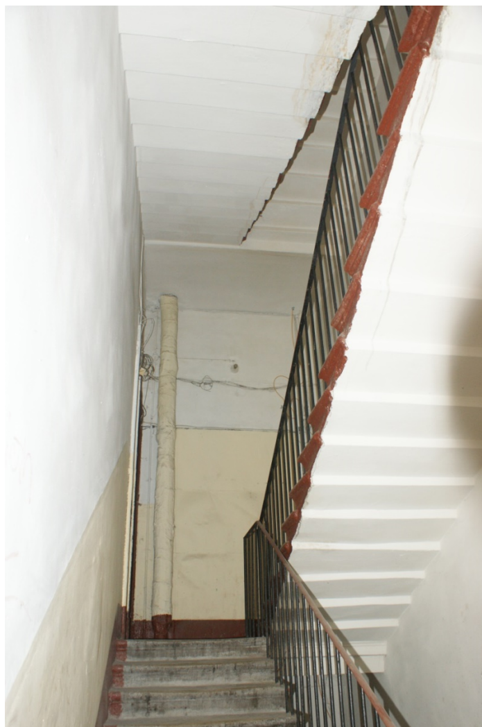
Фото 203. Лестница № 6. 3 этаж. Съемка 19.04.2021 г. Трушковский В.Э.
