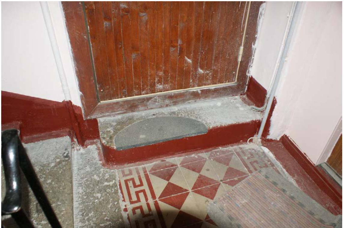
Фото 57. Лестница № 2. Площадка 2-го этажа. Съемка 19.04.2021 г. Трушковский В.Э.
