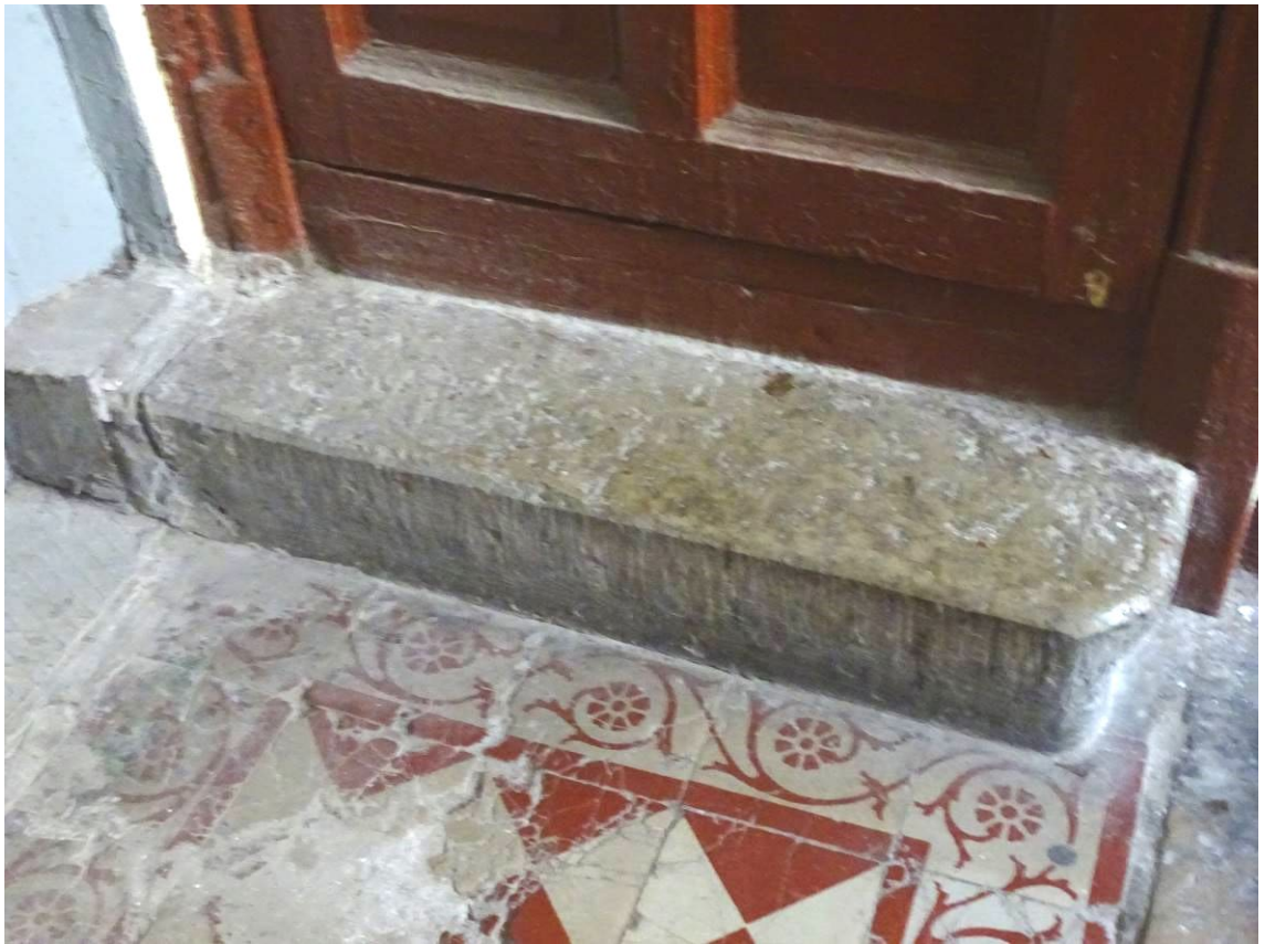
Фото 175. Лестница № 5. Площадка 2-го этажа. Покрытие пола. Съемка 19.04.2021 г. Трушковский В.Э.
