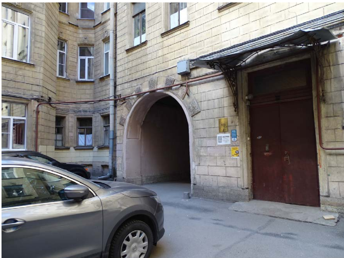
Фото 19. Здание по адресу: г. Санкт-Петербург, Средний пр. В. О., д. 11, литер А. Юго-восточный внутренний двор. Воротный проезд поперечного корпуса. Съемка 19.04.2021 г. Трушковский В.Э.
