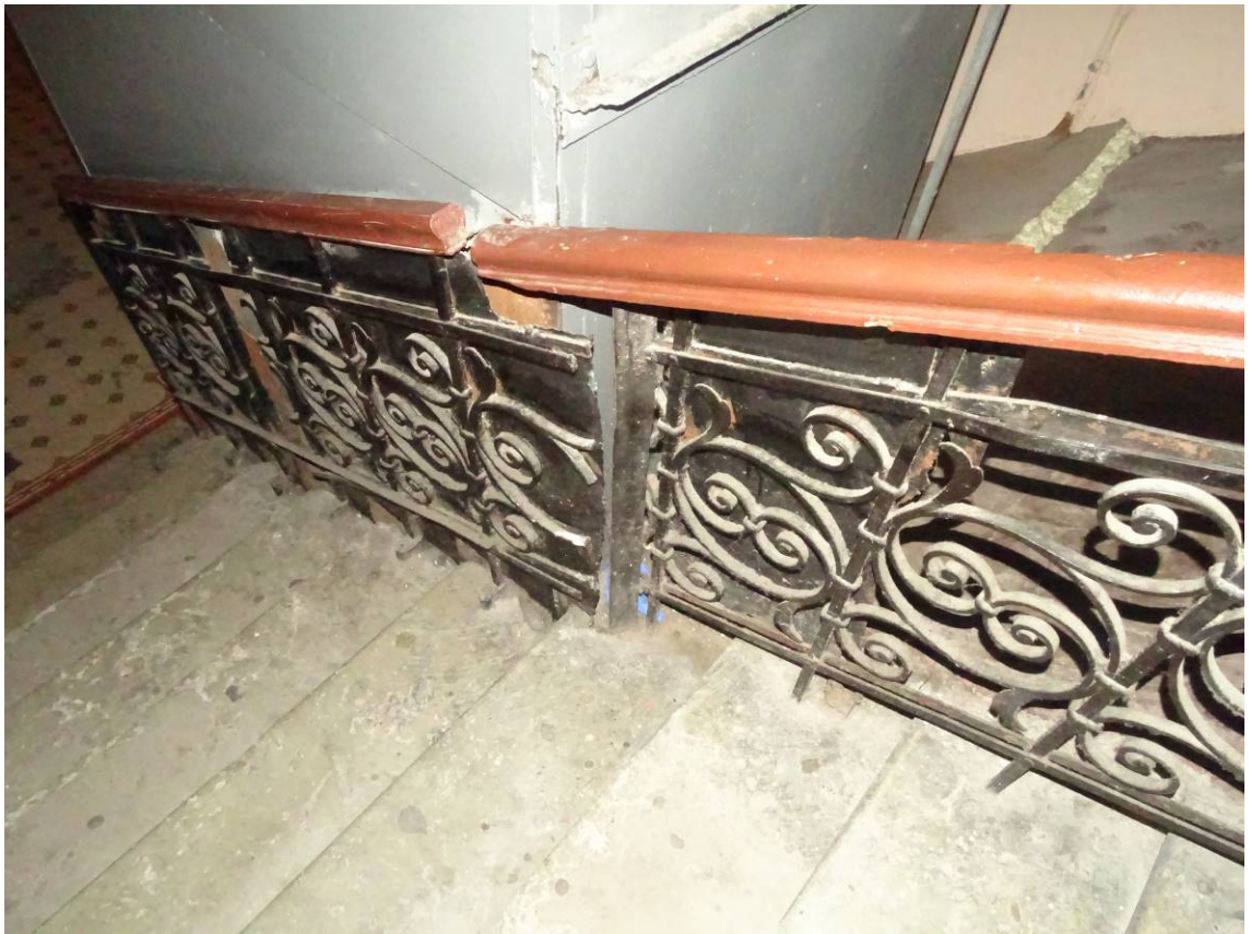
Фото 90. Лестница № 3. 1-й этаж. Лестничное ограждение. Съемка 19.04.2021 г. Трушковский В.Э.
