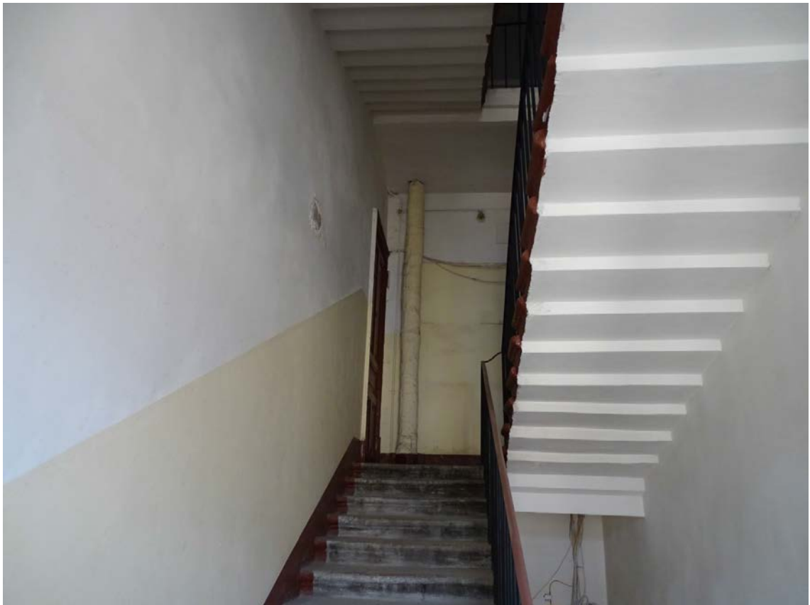
Фото 220. Лестница № 6. 6 этаж. Съёмка 19.04.2021 г. Трушковский В.Э.
