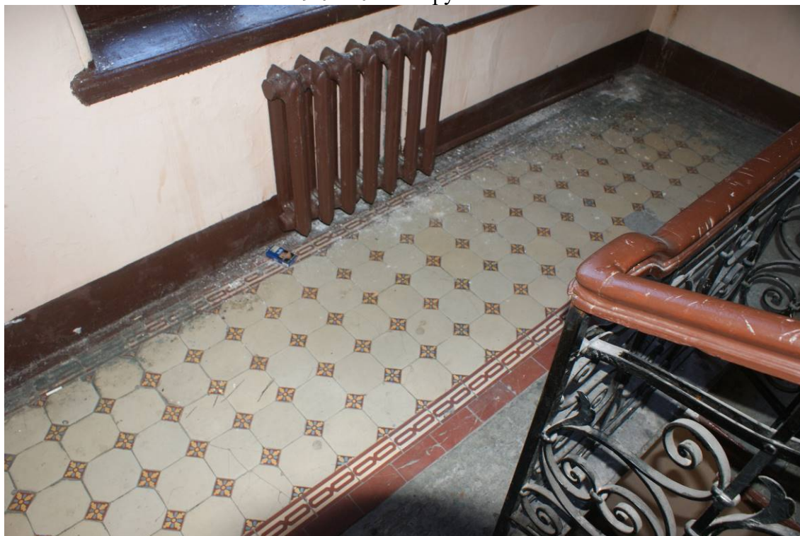
Фото 116. Лестница № 3. Площадка между 5-м и 6-м этажом. Покрытие пола. Съемка 19.04.2021 г. Трушковский В.Э.
