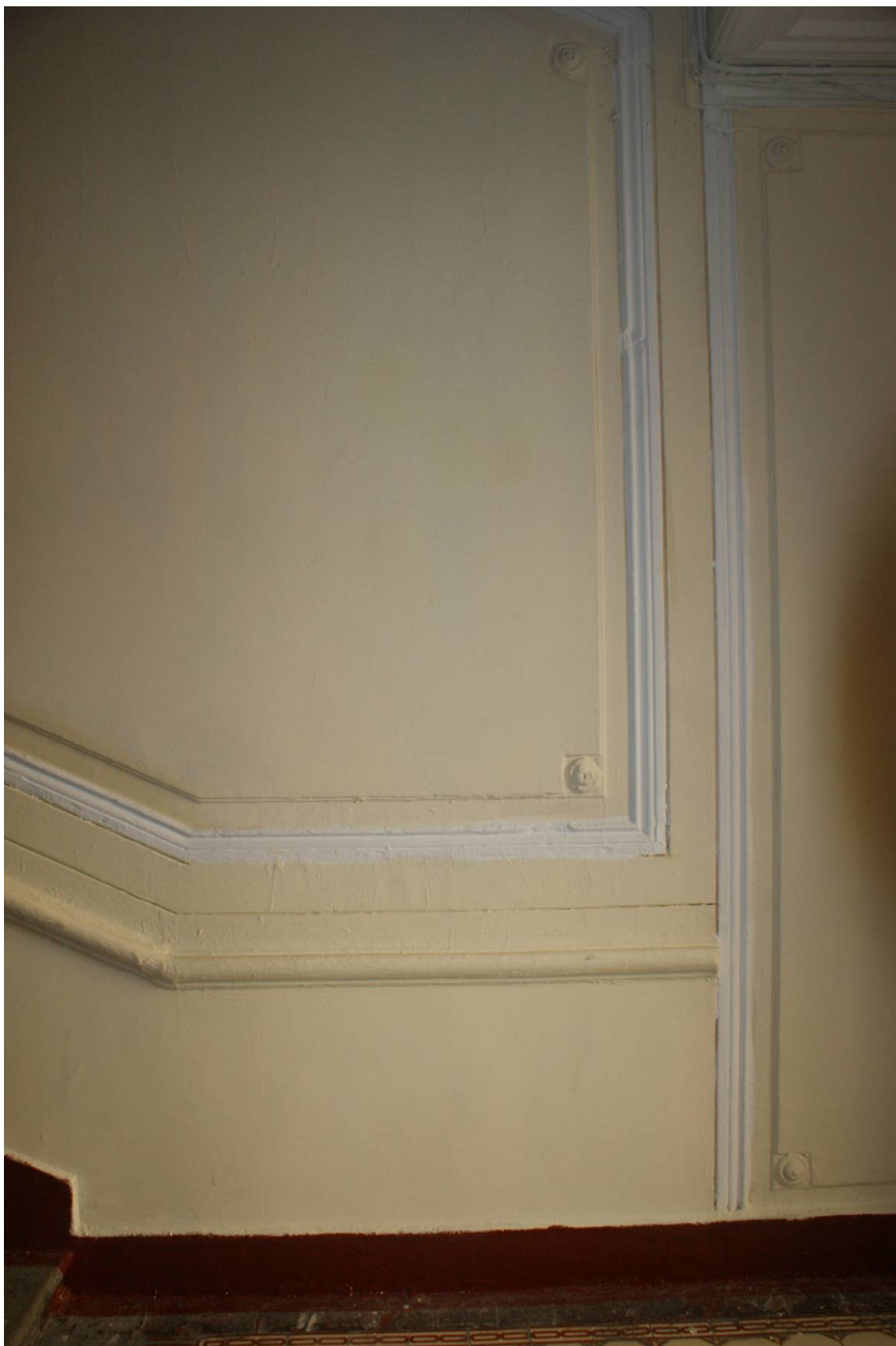
Фото 20. Лестница № 1. Площадка между 1-м и 2-м этажом. Профилированные рамы стен. Съемка 19.04.2021 г. Трушковский В.Э.
