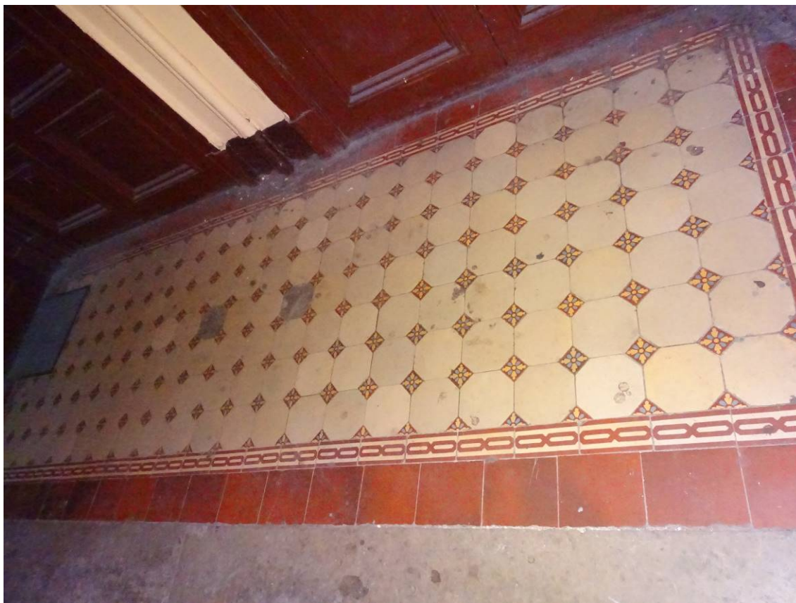
Фото 95. Лестница № 3. Площадка 2-го этажа. Покрытие пола. Съемка 19.04.2021 г. Трушковский В.Э.
