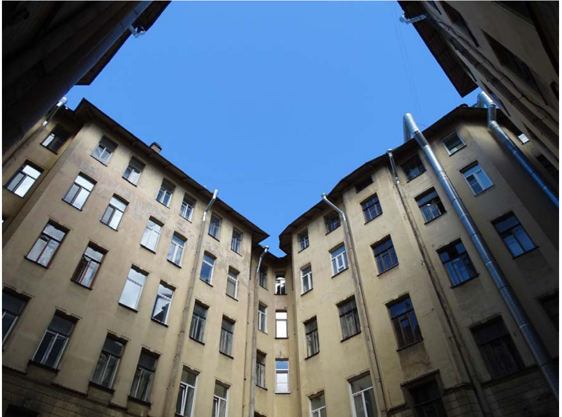
Фото 27. Здание по адресу: г. Санкт-Петербург, Средний пр. В. О., д. 11, литер А. Юго-восточный внутренний двор. Фрагмент фасада. Съемка 19.04.2021 г. Трушковский В.Э.
