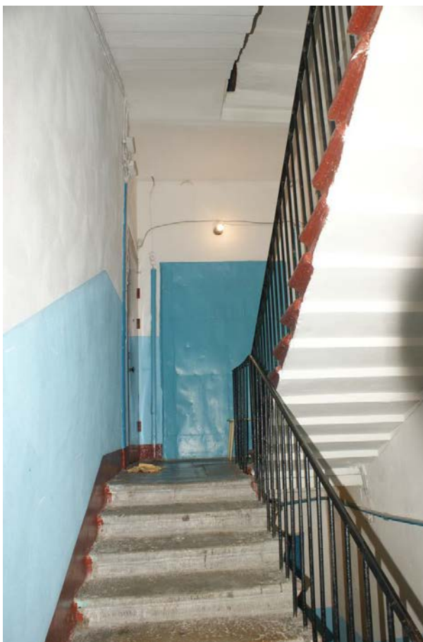
Фото 136. Лестница № 4. Вид на площадку 2-го этажа. Съемка 19.04.2021 г. Трушковский В.Э.
