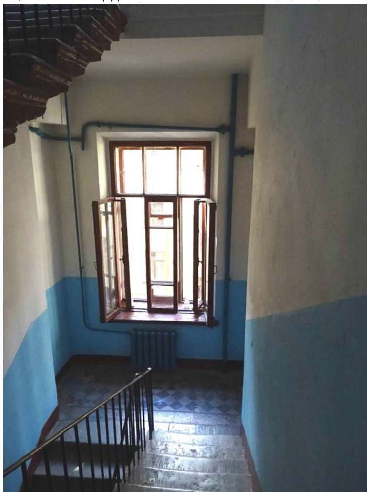
Фото 147. Лестница № 4. Вид на площадку между 3-м и 4-м этажом. Съемка 19.04.2021 г. Трушковский В.Э.
