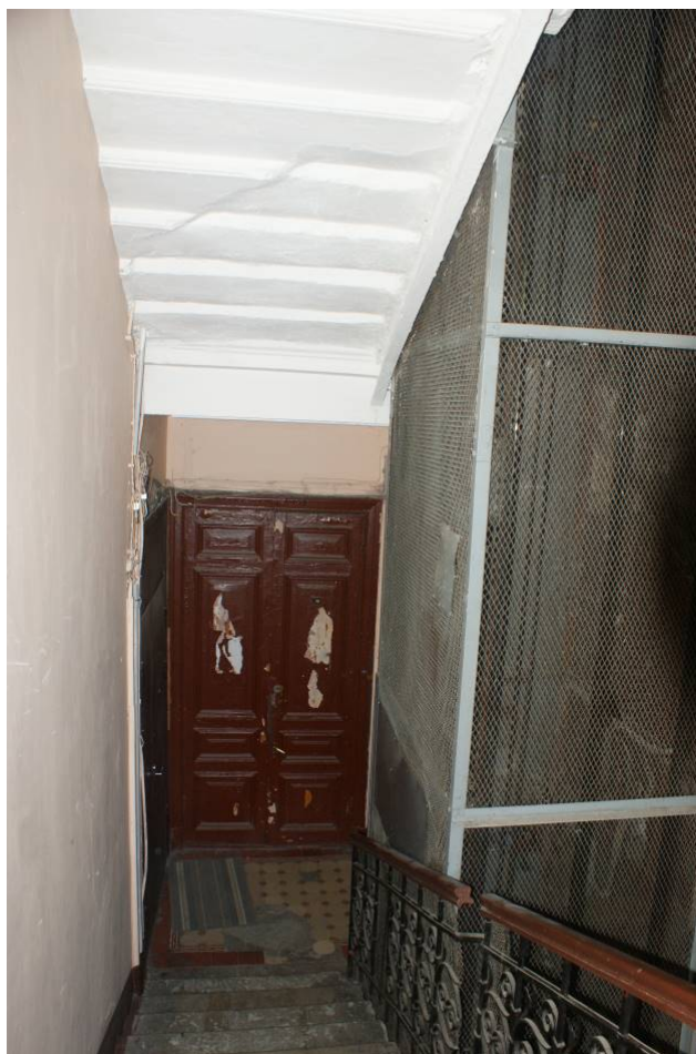
Фото 102. Лестница № 3. Вид на площадку 4-го этажа. Съемка 19.04.2021 г. Трушковский В.Э.
