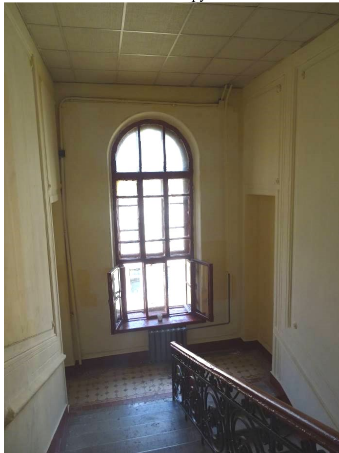
Фото 39. Лестница № 1. Вид на площадку между 5-м и 6-м этажом. Съемка 19.04.2021 г. Трушковский В.Э.
