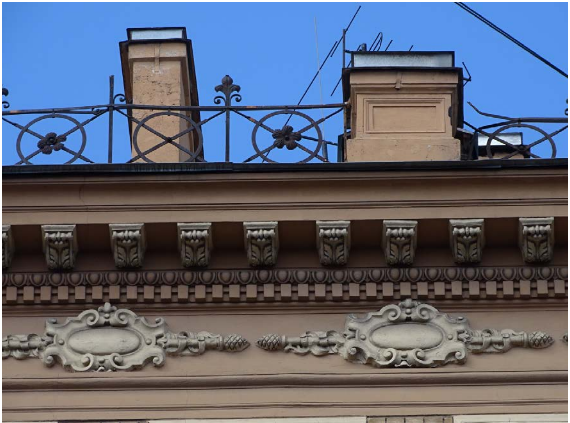
Фото 9. Здание по адресу: г. Санкт-Петербург, Средний пр. В. О., д. 11, литер А. Фрагмент лицевого фасада. Декорирование фриза. Съемка 19.04.2021 г. Трушковский В.Э.
