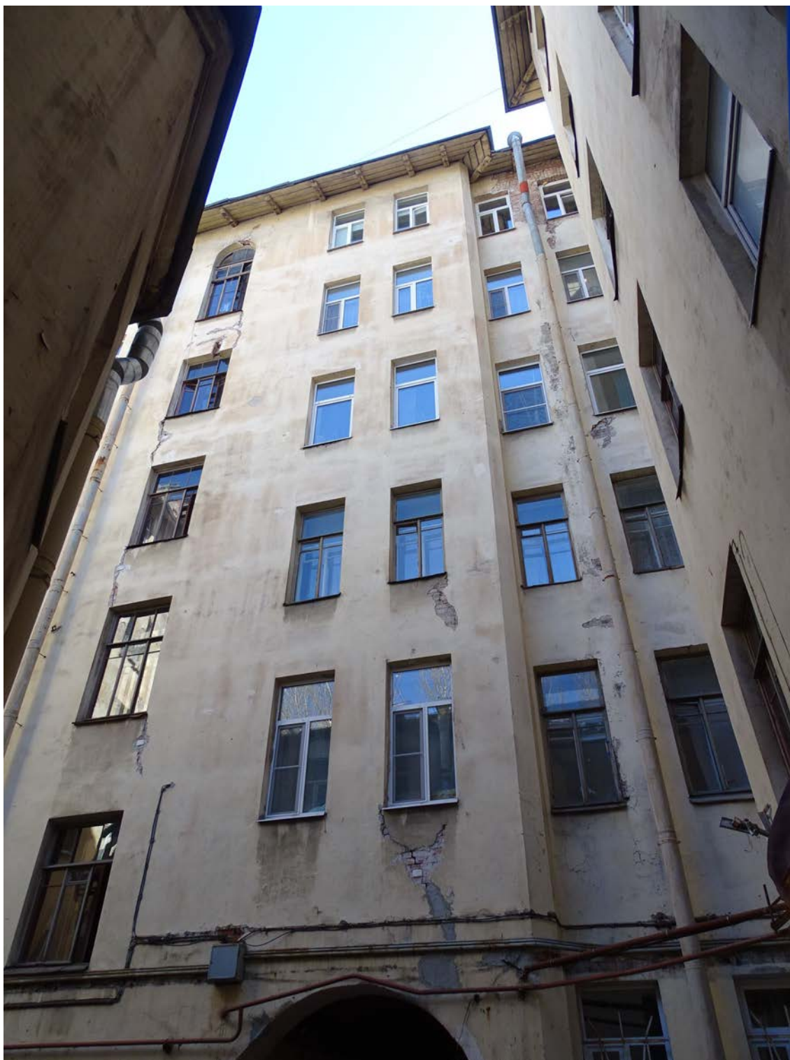
Фото 40. Здание по адресу: г. Санкт-Петербург, Средний пр. В. О., д. 11, литер А. Фрагмент фасада поперечного корпуса. Северо-западный двор. Съемка 19.04.2021 г. Трушковский В.Э.
