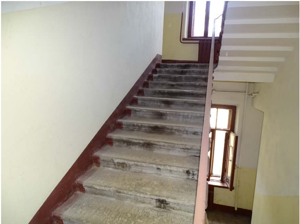
Фото 216. Лестница № 6. Вид на площадку между 5-м и 6-м этажом. Съемка 19.04.2021 г. Трушковский В.Э.
