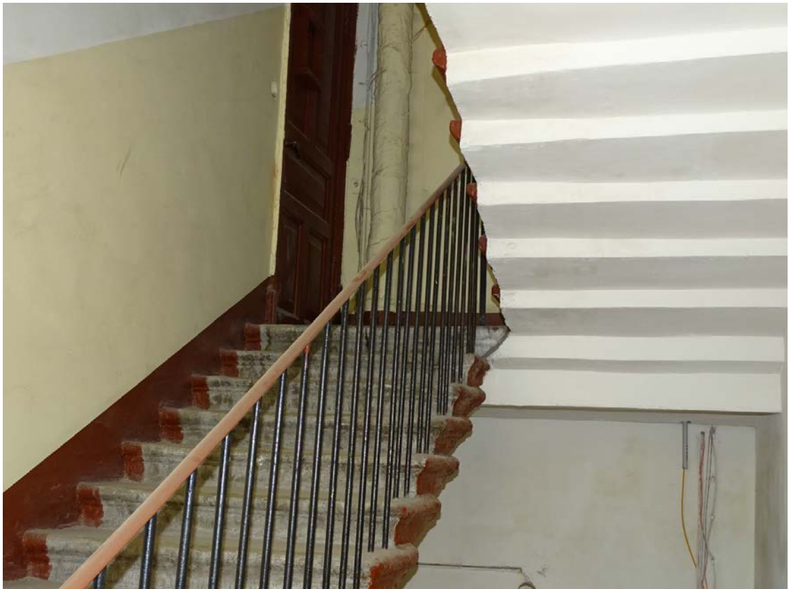
Фото 211. Лестница № 6. 5 этаж. Съемка 19.04.2021 г. Трушковский В.Э.
