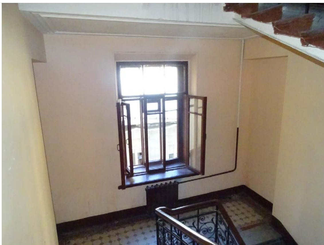
Фото 101. Лестница № 3. Вид на площадку между 3-м и 4-м этажом. Съемка 19.04.2021 г. Трушковский В.Э.
