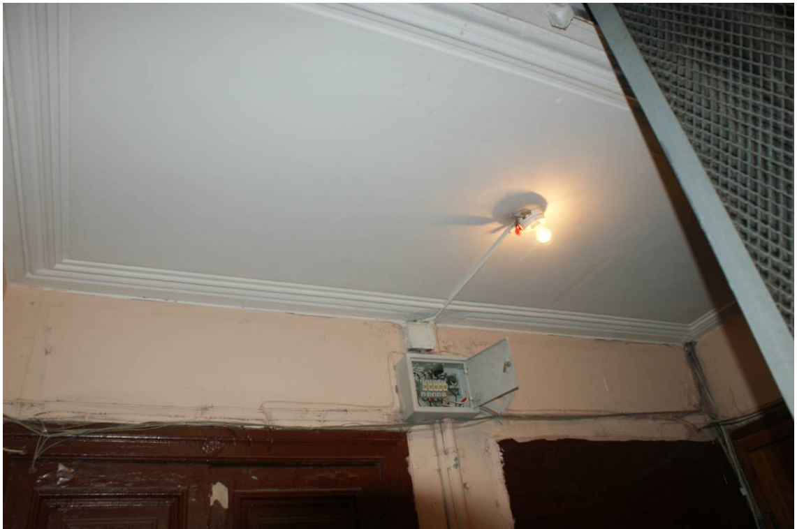
Фото 104. Лестница № 3. Площадка 4-го этажа. Оформление потолка. Съемка 19.04.2021 г. Трушковский В.Э.
