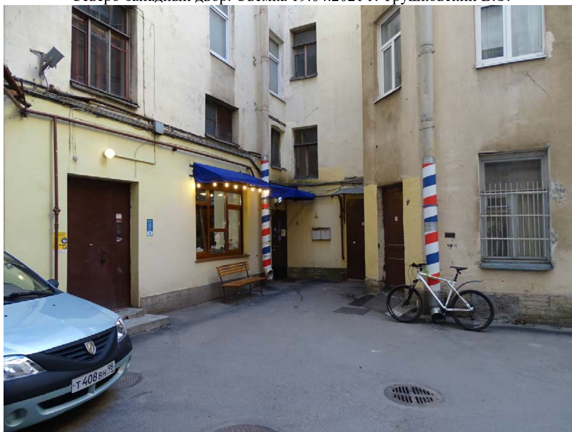
Фото 42. Здание по адресу: г. Санкт-Петербург, Средний пр. В. О., д. 11, литер А. Фрагмент фасада. Северо-западный двор. Съемка 19.04.2021 г. Трушковский В.Э.
