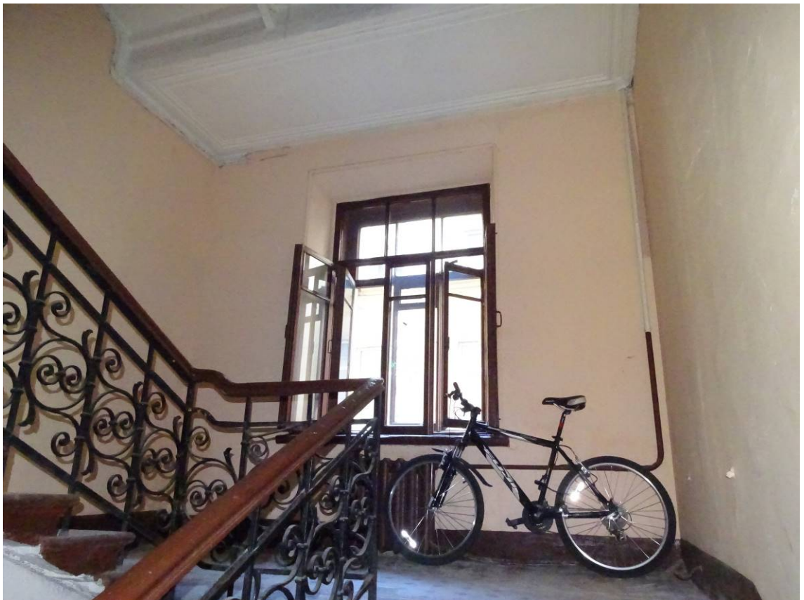
Фото 91. Лестница № 3. Вид на площадку между 1-м и 2-м этажом. Съемка 19.04.2021 г. Трушковский В.Э.
