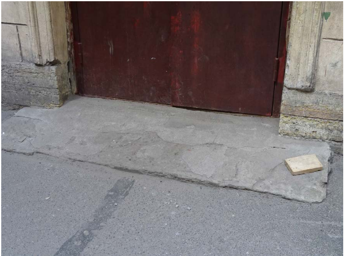
Фото 21. Здание по адресу: г. Санкт-Петербург, Средний пр. В. О., д. 11, литер А. Юго-восточный внутренний двор. Съемка 19.04.2021 г. Трушковский В.Э.
