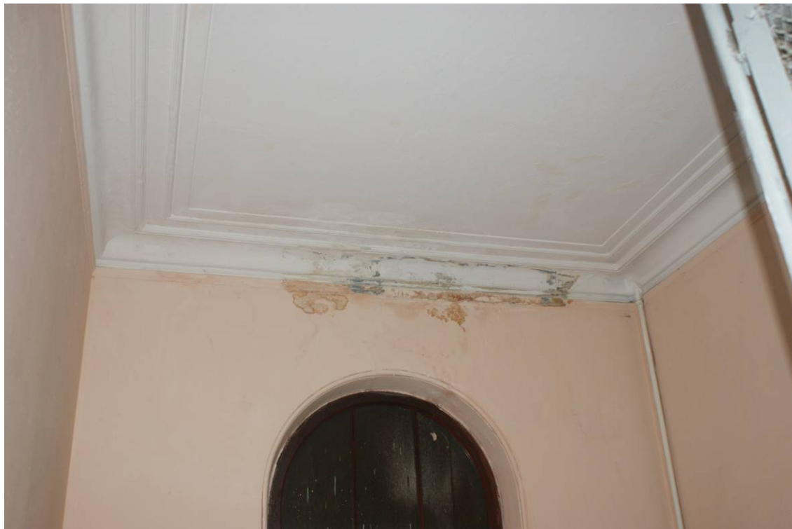
Фото 117. Лестница № 3. Площадка между 5-м и 6-м этажом. Оформление потолка. Съемка 19.04.2021 г. Трушковский В.Э.
