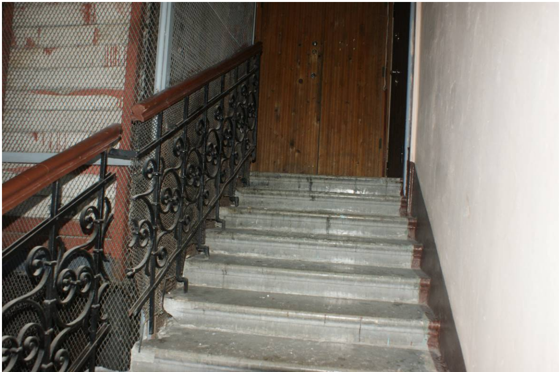
Фото 118. Лестница № 3. Вид на площадку 6-го этажа. Лестничное ограждение. Съемка 19.04.2021 г. Трушковский В.Э.
