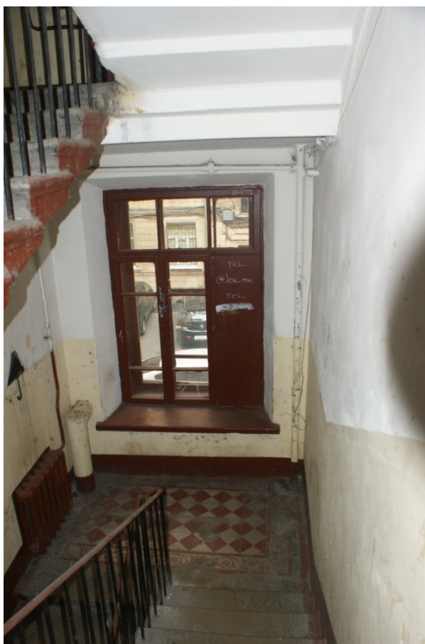
Фото 198. Лестница № 6. Вид на площадку между 1-м и 2-м этажом. Съемка 19.04.2021 г. Трушковский В.Э.
