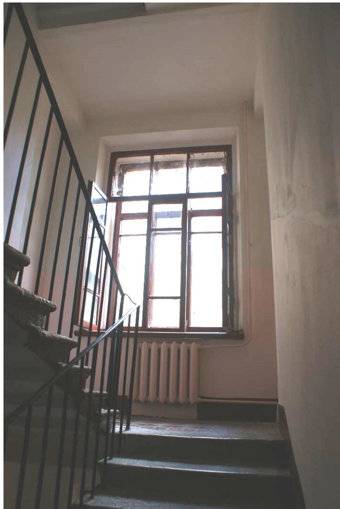
Фото 58. Лестница № 2. Вид на площадку между 2-м и 3-м этажом. Съемка 19.04.2021 г. Трушковский В.Э.
