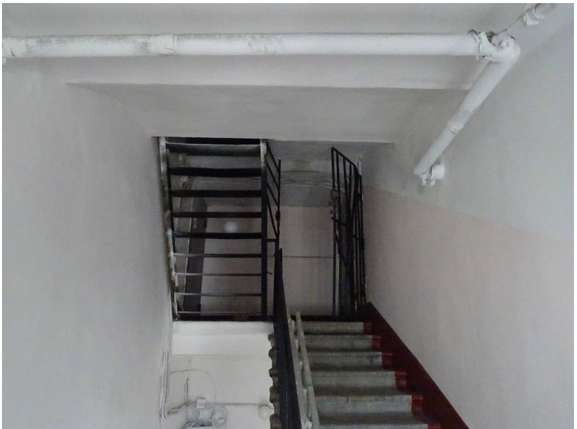
Фото 75. Лестница № 2. Чердачный этаж. Съемка 19.04.2021 г. Трушковский В.Э.
