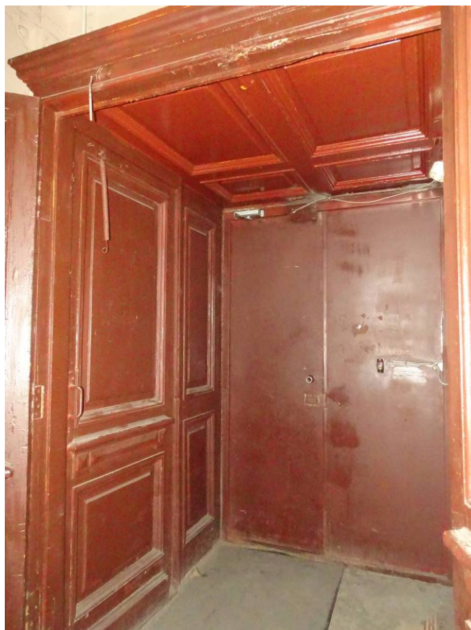
Фото 78. Лестница № 3. 1-й этаж. Вестибюль. Входная дверь. Съемка 19.04.2021 г. Трушковский В.Э.
