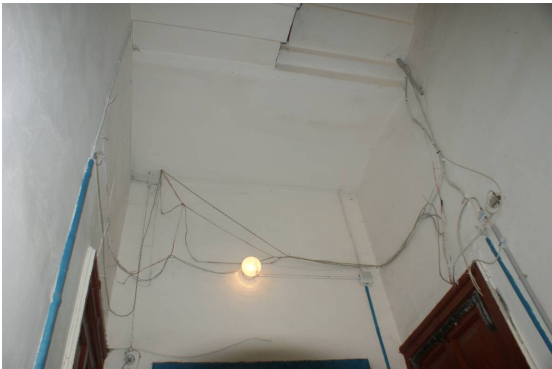
Фото 146. Лестница № 4. Площадка 3-го этажа. Съемка 19.04.2021 г. Трушковский В.Э.
