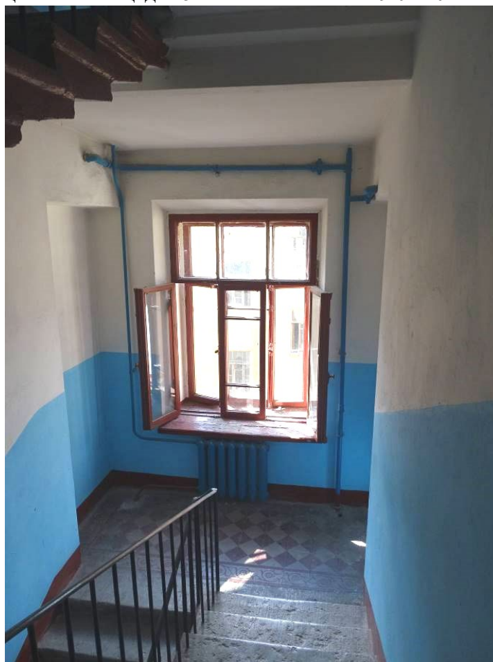
Фото 155. Лестница № 4. Вид на площадку между 5-м и 6-м этажом. Съемка 19.04.2021 г. Трушковский В.Э.
