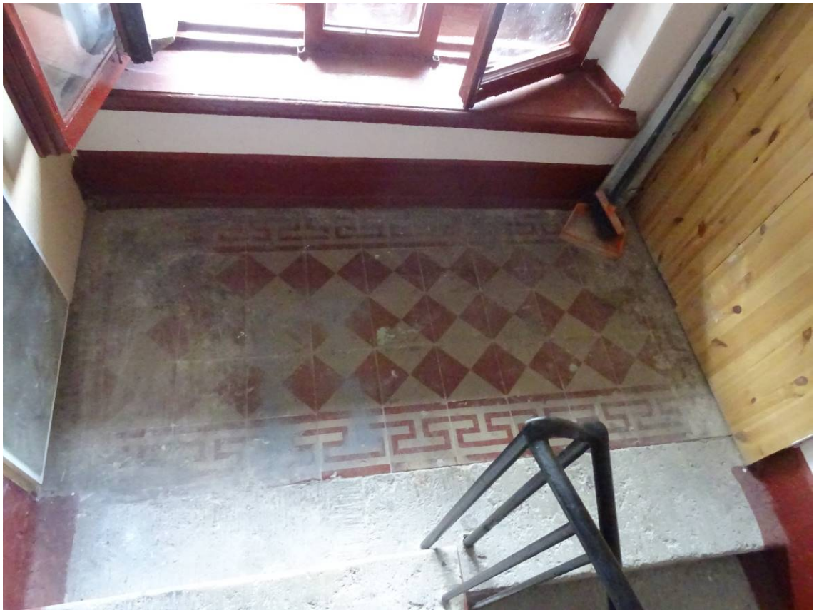
Фото 72. Лестница № 2. Площадка между 5-м и 6-м этажом. Покрытие пола. Съемка 19.04.2021 г. Трушковский В.Э.
