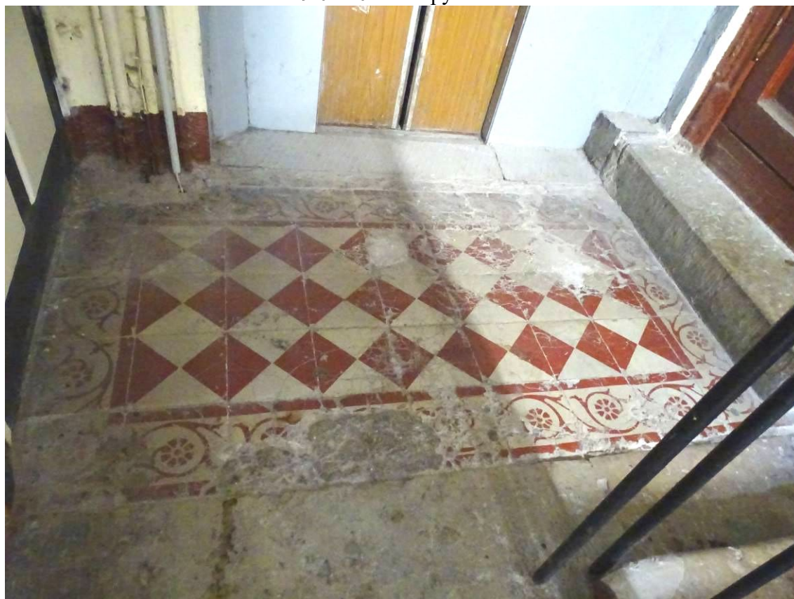
Фото 174. Лестница № 5. Площадка 2-го этажа. Покрытие пола. Съемка 19.04.2021 г. Трушковский В.Э.
