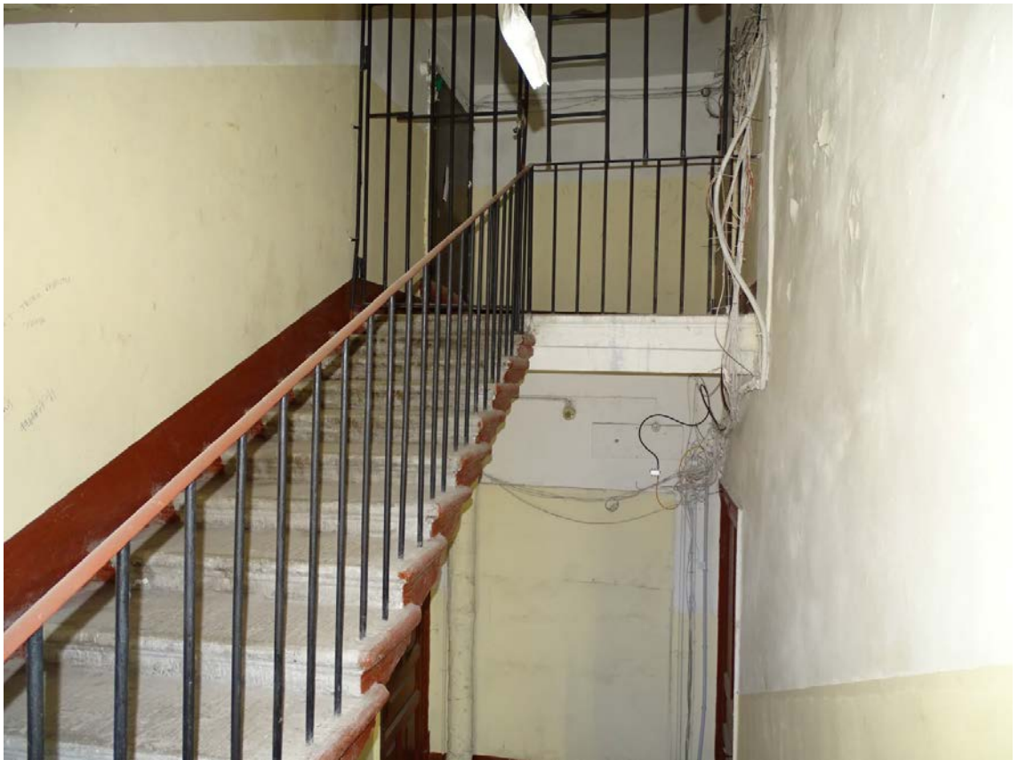
Фото 224. Лестница № 6. Чердачный этаж. Съемка 19.04.2021 г. Трушковский В.Э.
