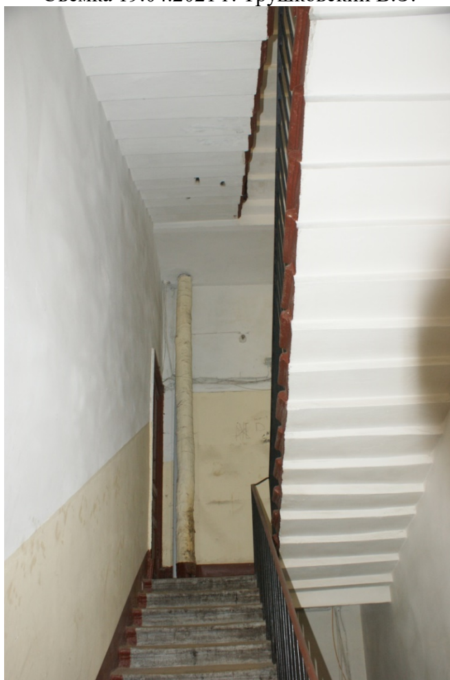
Фото 207. Лестница № 6. 4 этаж. Съемка 19.04.2021 г. Трушковский В.Э.
