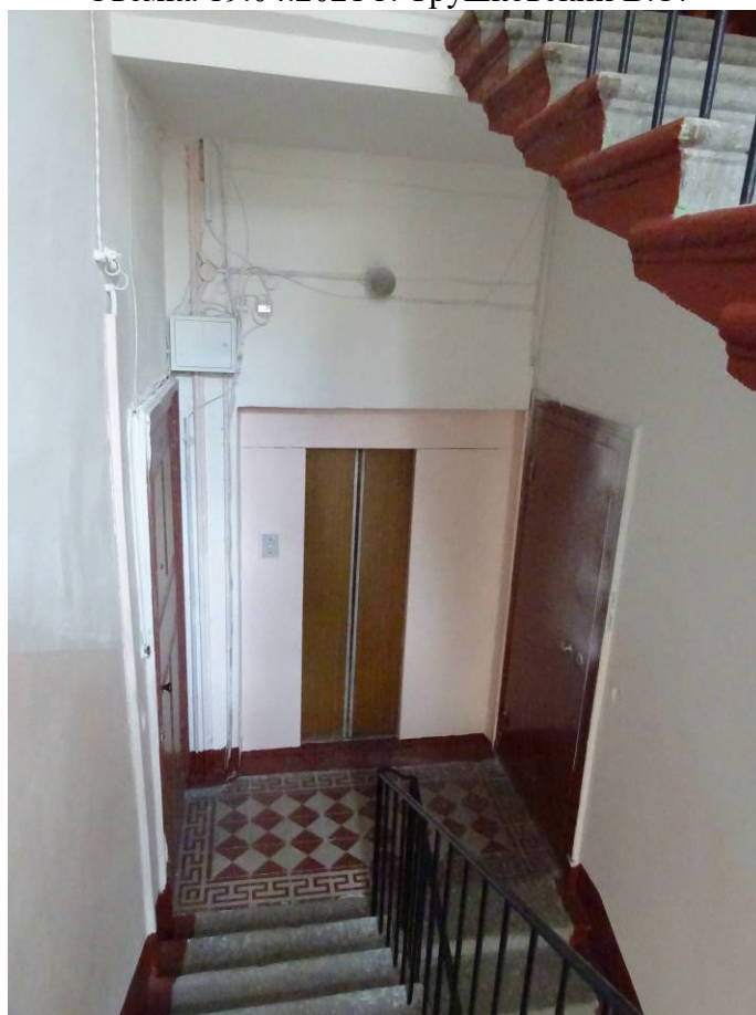
Фото 65. Лестница № 2. Вид на площадку 4-го этажа. Съемка 19.04.2021 г. Трушковский В.Э.
