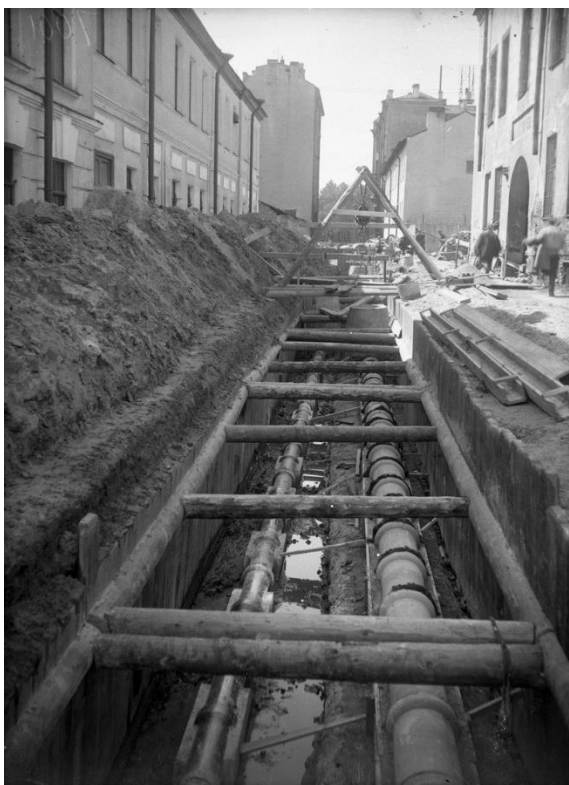
25. Сооружение канализации на Васильевском острове. Траншея на Иностранном переулке. 1928 г.
