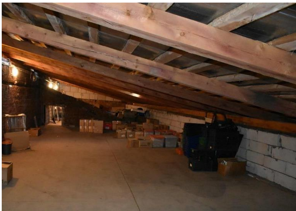
22. Объект культурного наследия федерального значения «Монастырь Воскресенский Новодевичий». «Хозяйственная постройка» - часть объекта культурного наследия федерального значения "Хозяйственная постройка (три)", 1868-1869 гг. по адресу: Санкт-Петербург, Московский просп., д. 100, лит. О». Чердачное пространство. Общий вид.
