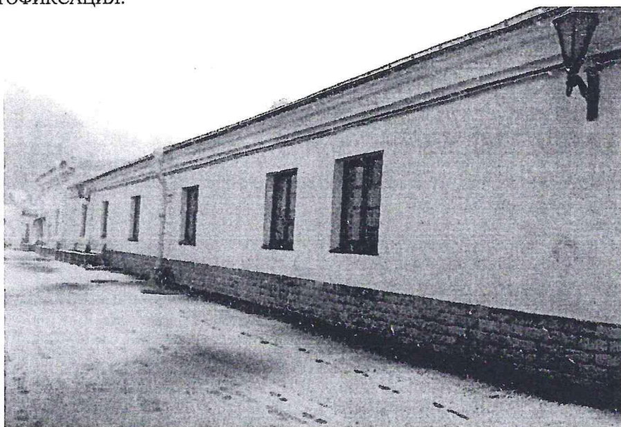
1. Монастырь Воскресенский Новодевичий. Хозяйственная постройка. Северный фасад
