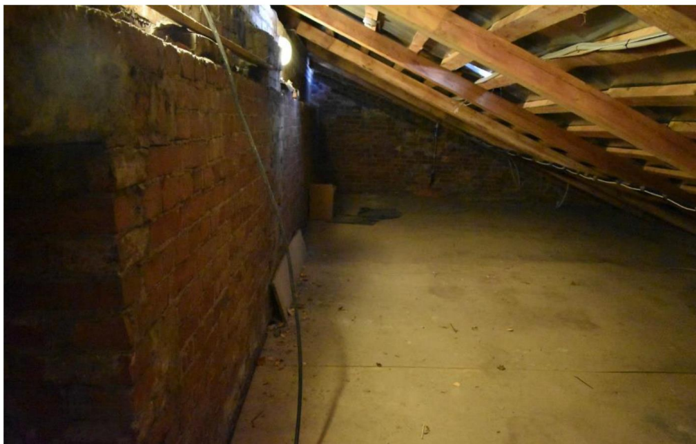
23. Объект культурного наследия федерального значения «Монастырь Воскресенский Новодевичий». «Хозяйственная постройка» - часть объекта культурного наследия федерального значения "Хозяйственная постройка (три)", 1868-1869 гг. по адресу: Санкт-Петербург, Московский просп., д. 100, лит. О». Чердачное пространство. Фрагмент.
