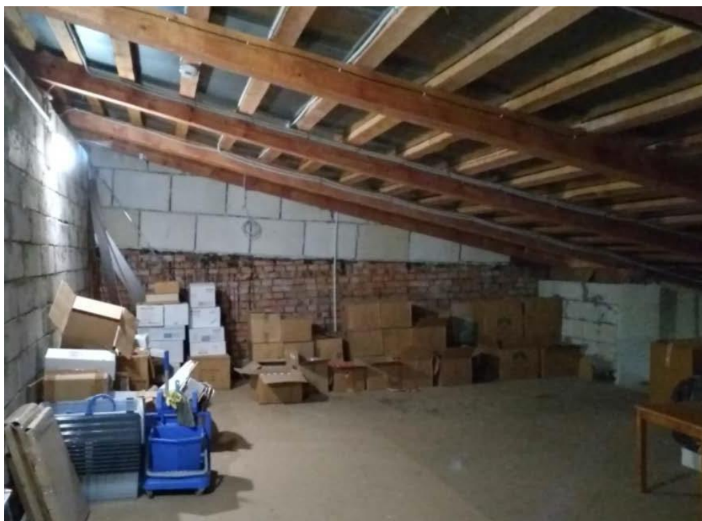
24. Объект культурного наследия федерального значения «Монастырь Воскресенский Новодевичий». «Хозяйственная постройка» - часть объекта культурного наследия федерального значения "Хозяйственная постройка (три)", 1868-1869 гг. по адресу: Санкт-Петербург, Московский просп., д. 100, лит. О». Чердачное пространство. Фрагмент.
