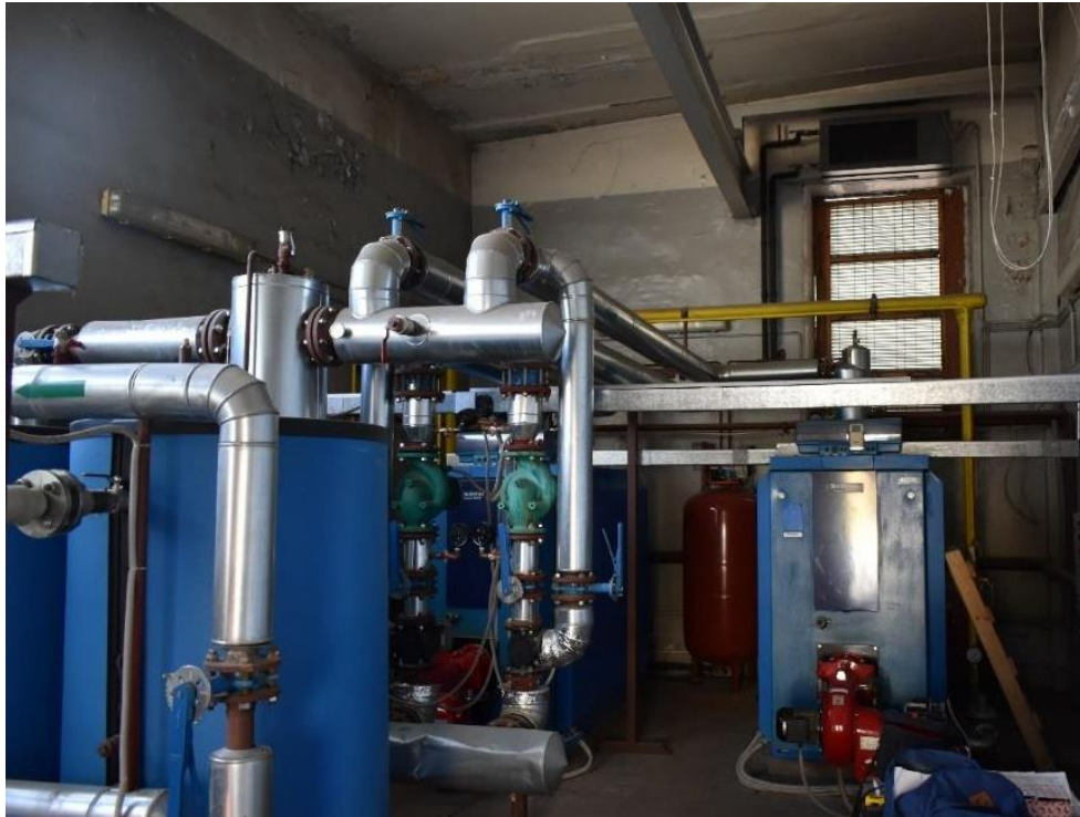
17. Объект культурного наследия федерального значения «Монастырь Воскресенский Новодевичий». «Хозяйственная постройка» - часть объекта культурного наследия федерального значения "Хозяйственная постройка (три)", 1868-1869 гг. по адресу: Санкт-Петербург, Московский просп., д. 100, лит. О». Техническое помещение. Фрагмент интерьера.
