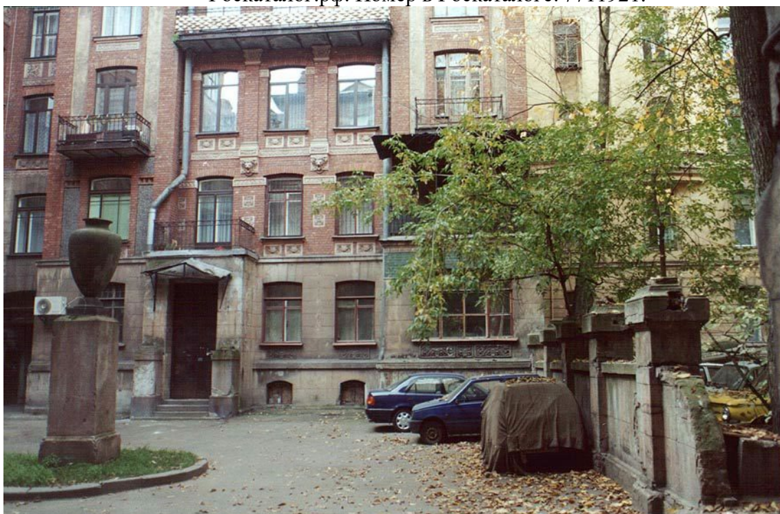
83. Двор дома №24 на Каменноостровском проспекте. Дата фото: 29 сентября 2000. https://pastvu.com/p/182617
