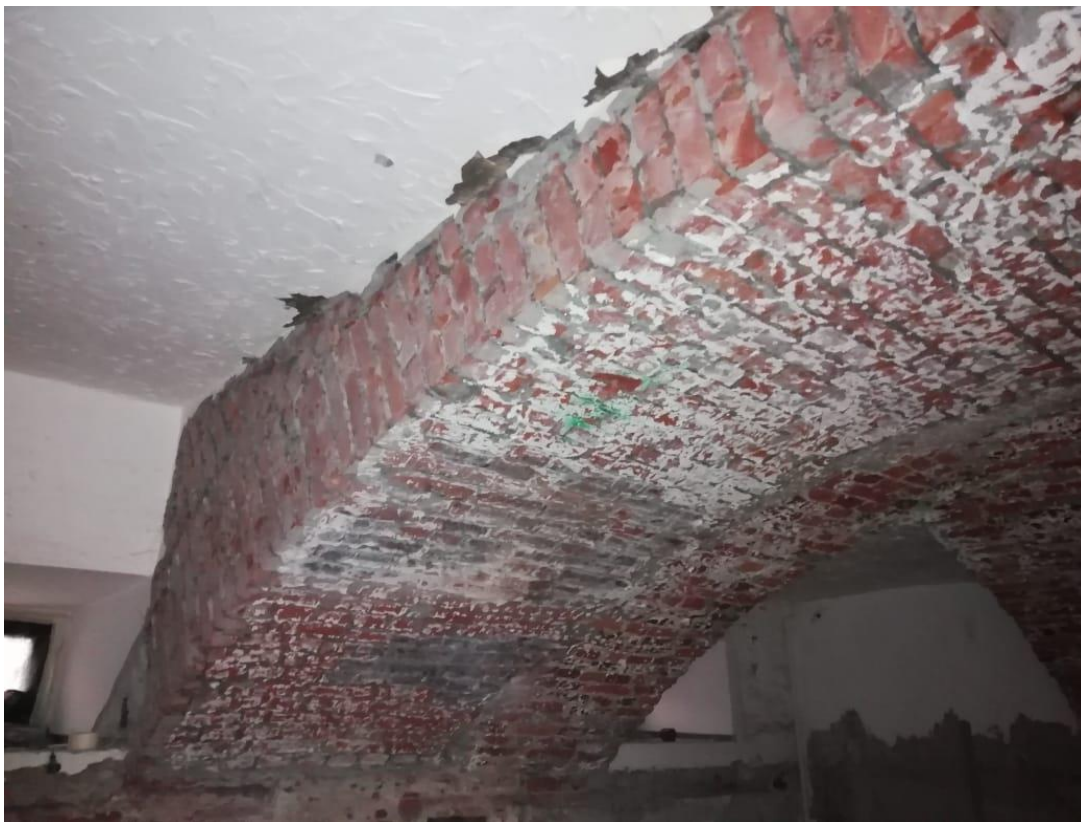
Фото 16. Орлово-Новосильцевская богадельня, пр. Энгельса, д.1, стр.2. Подвал в осях 7-8/Г-Е. Общий вид зоны опирания главной арки на кирпичную стену по оси Е. 19.05.2021г.
