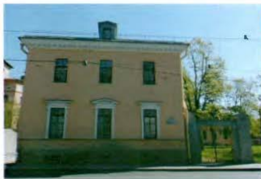
18. Лицевой (западный) фасад здания.
