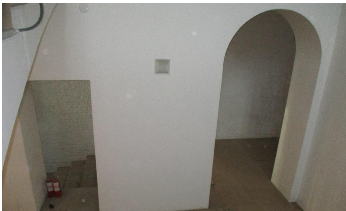
Фото 14. Орлово-Новосильцевская богадельня, пр. Энгельса, д.1, стр.2. Лестничная клетка в осях 7-8/Г-Е. Вход из коридора. (7-8/Г). 19.05.2021г.
