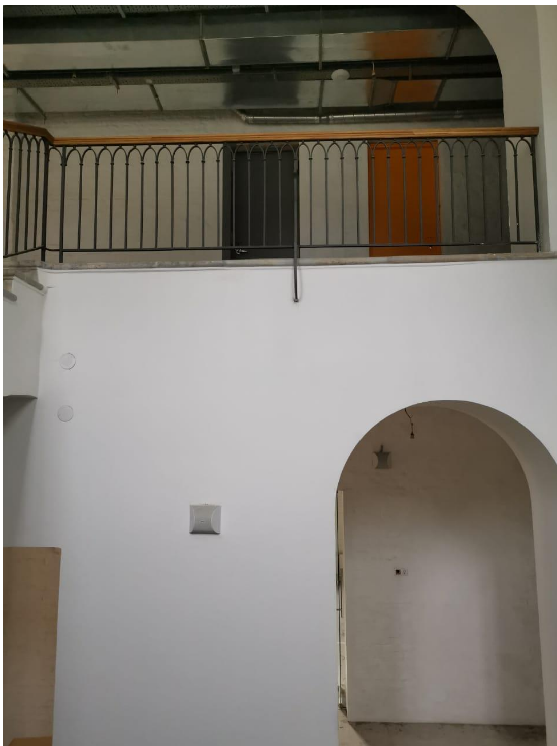
Фото 7. Орлово-Новосильцевская богадельня, пр. Энгельса, д.1, стр.2. Лестничная клетка в осях 7-8/Г-Е. Вход из центрального коридора 1-го этажа и вид на коридор 2-го этажа (7-8/Г). 19.05.2021г.
