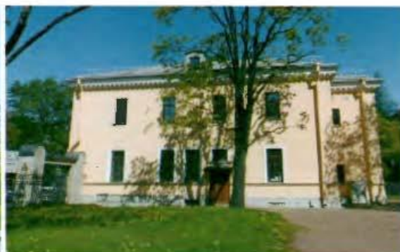
19. Южный фасад здания.
