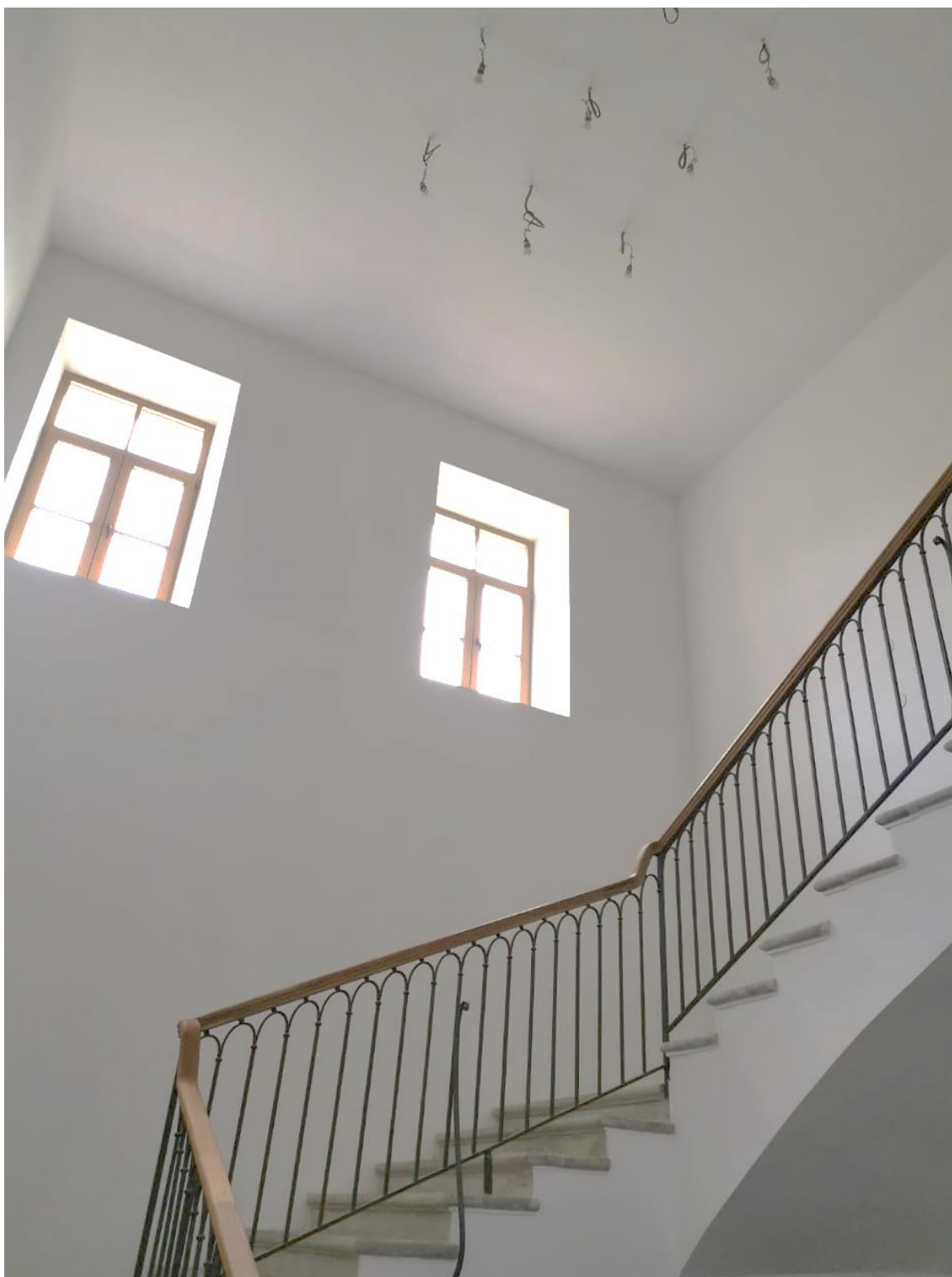
Фото 9. Орлово-Новосильцевская богадельня, пр. Энгельса, д.1, стр.2. Лестничная клетка в осях 7-8/Г-Е. Вид на средний марш. 19.05.2021г.
