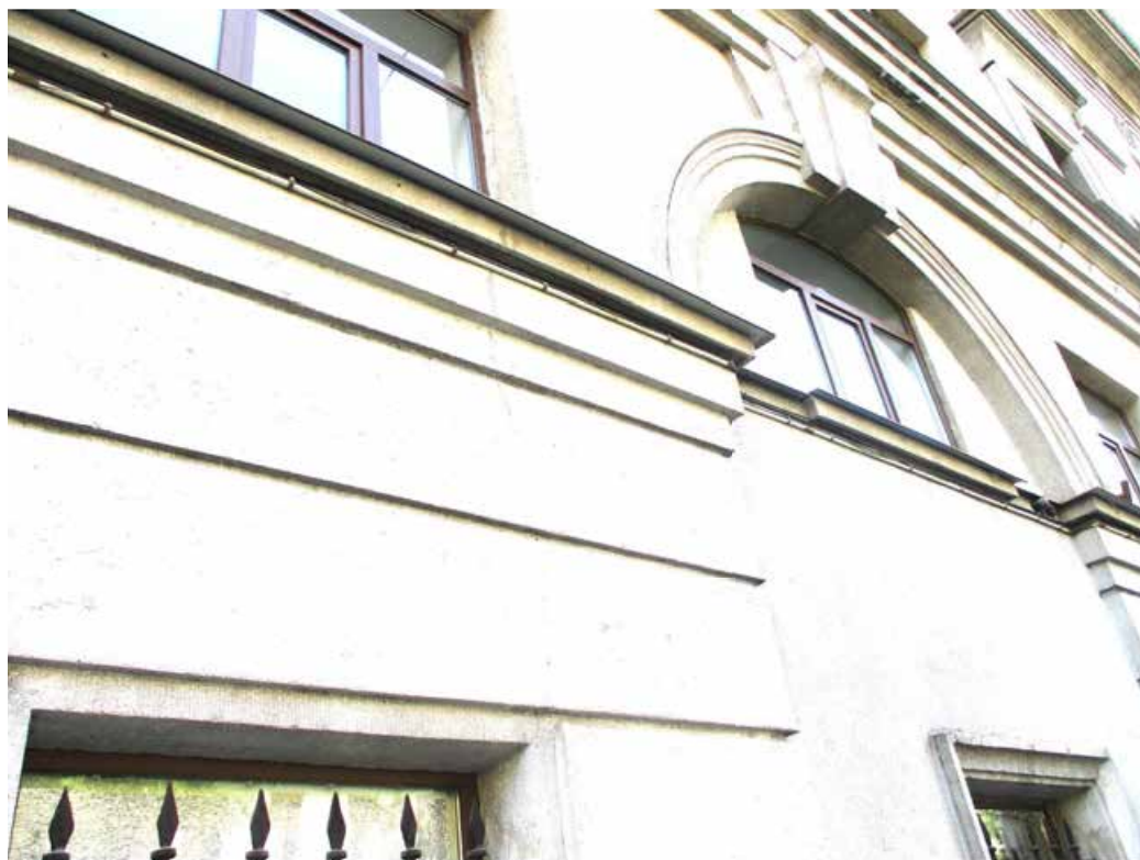
Фото 6. Биржевая линия, дом №16, фрагмент лицевого фасада, стены гладко оштукатурены, декоративное обрамление оконных проемов архивольтами с замковыми камнями, декоративный профилированный карниз.
