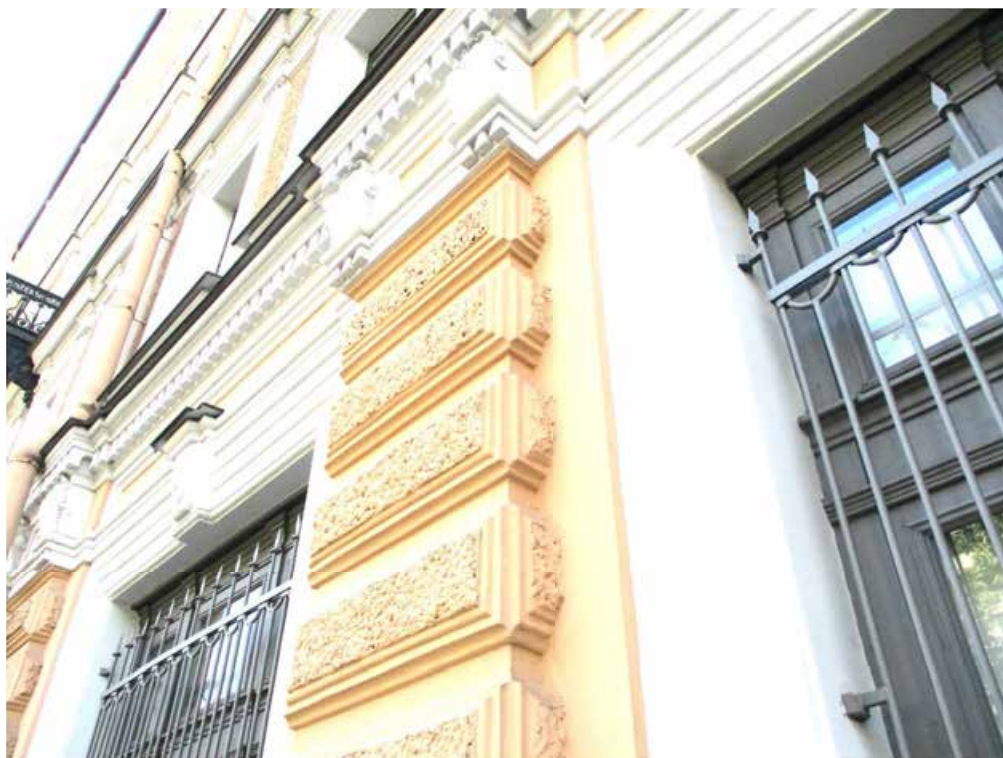
Фото 2. Биржевая линия, дом №14, фрагмент главного фасада, декорированного рустом с штукатуркой «под шубу», профилированными карнизами, наличниками и замковыми камнями.
