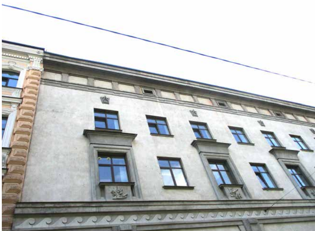
Фото 5. Биржевая линия, дом №16, фрагмент лицевого фасада, стены гладко оштукатурены, декоративное обрамление оконных проемов 3 этажа с сандриками, декоративный профилированный карниз.
