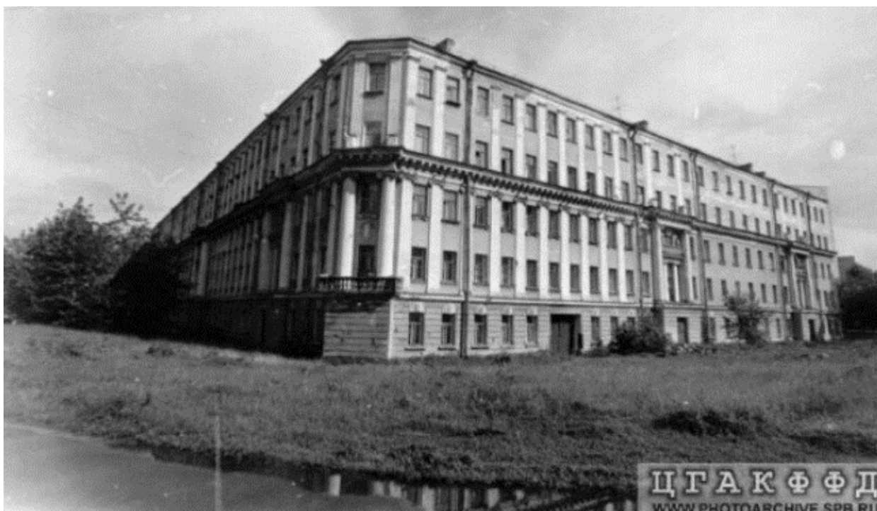
45. Дом по адресу: Переулок Каховского, д. 10. Фото 1983 г.
