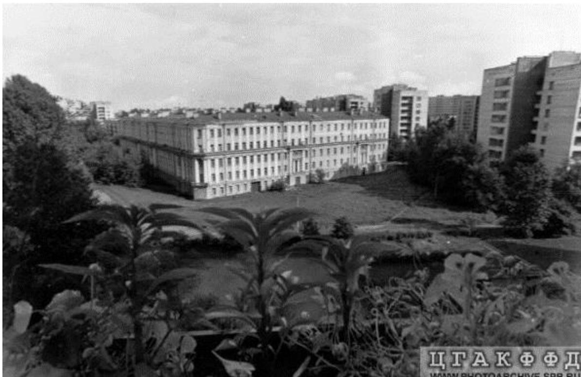
46. Дом по адресу: Переулок Каховского, д. 10. Фото 1983 г.
