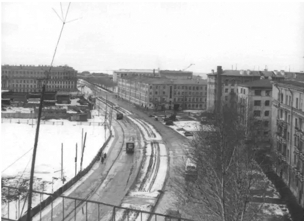
44. Дом по адресу: Переулок Каховского, д. 10. (слева). Фото С.И. Лавут. 1962 г.
