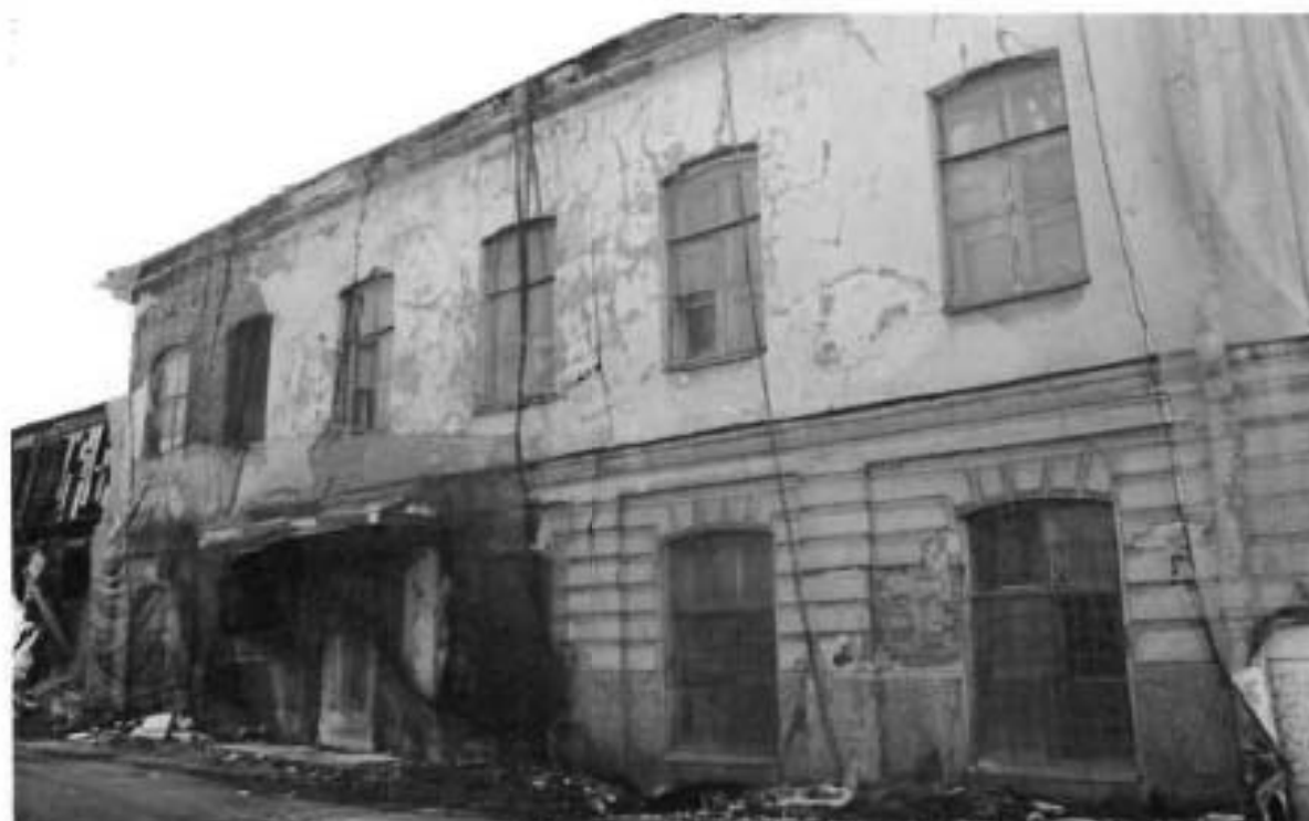
Фото №2. Северо-западный фасад.
