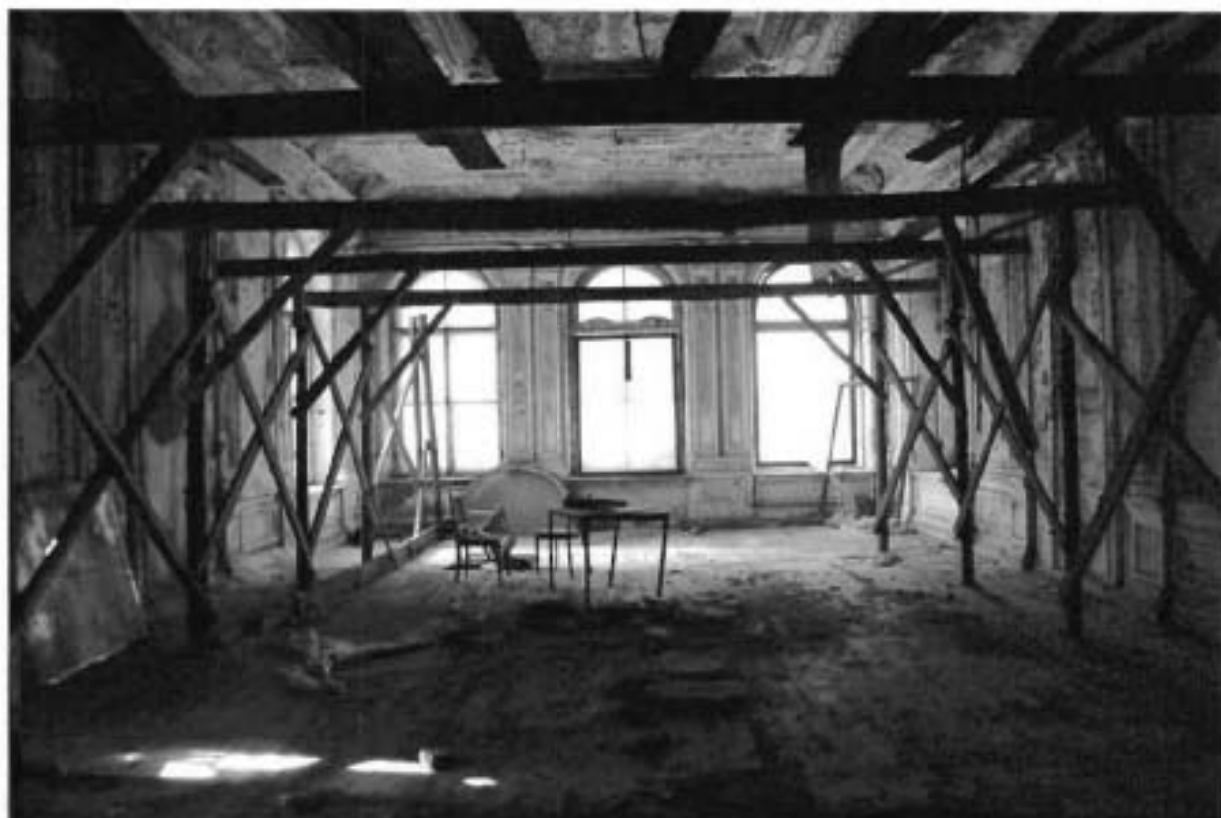
Фото №3. Помещение 2-Н/5 2-го этажа
