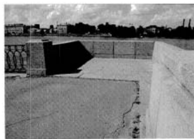
10. Смотровая площадка у широкого лестничного спуска
