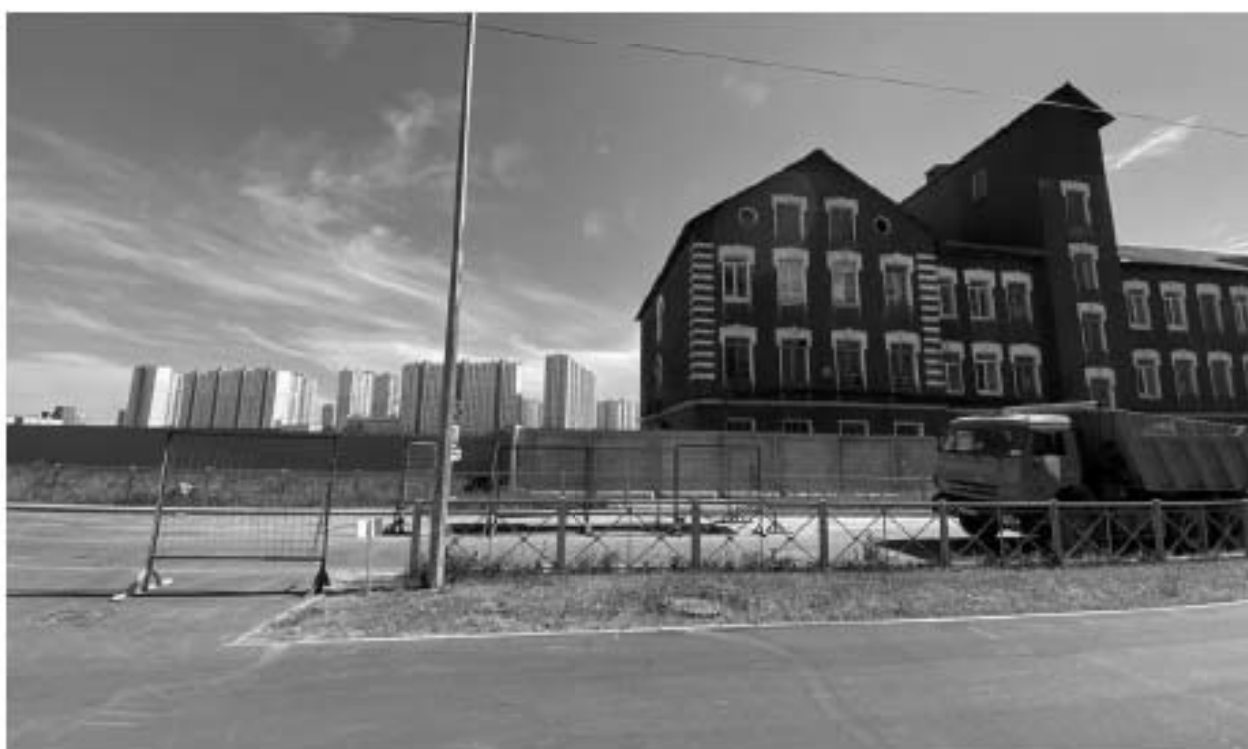
Фото 6. Вид с проезда на производственное здание (северный и западный фасад).
