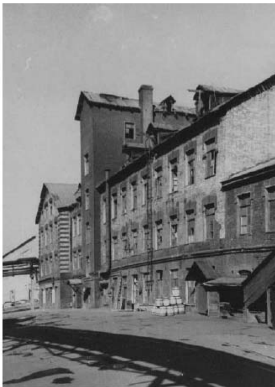
Илл. 42. Вид здания цеха по производству ультрамарина. 1973 г. ЦГАКФФД СПб, Ар 126085.
