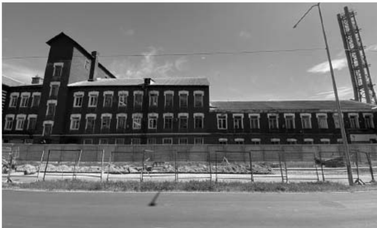
Фото 1. Вид с проезда на производственное здание (западный фасад).
