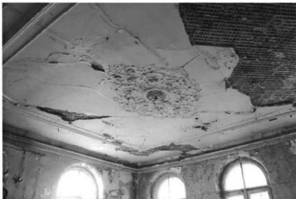
Фото №4. Помещение 3-Н/7 3-го этажа
