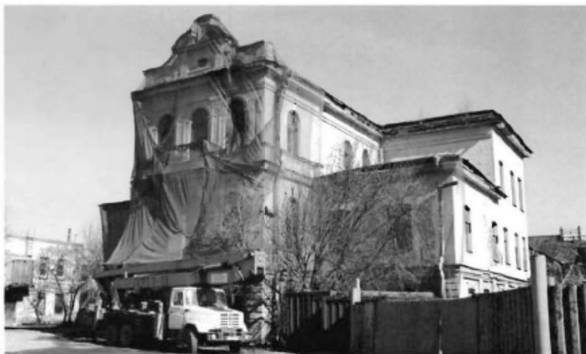
Фото №1. Юго-западный (парадный) и юго-восточный фасады.
