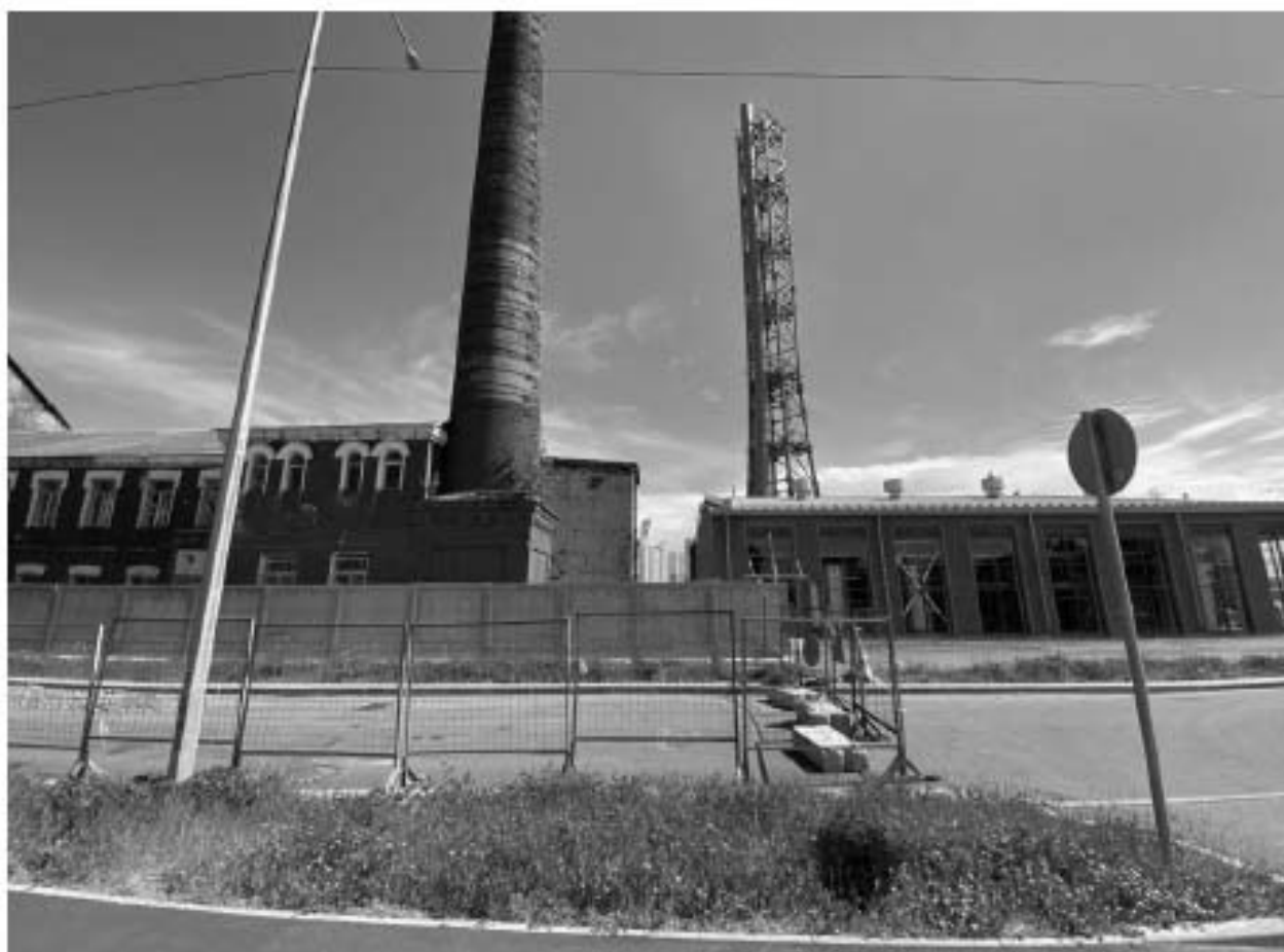
Фото 3. Вид с проезда на производственное здание с трубой (западный фасад) и особняк Вегги.
