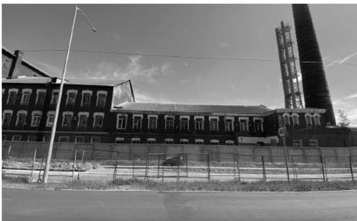
Фото 2. Вид с проезда на производственное здание с дымовой трубой (западный фасад).
