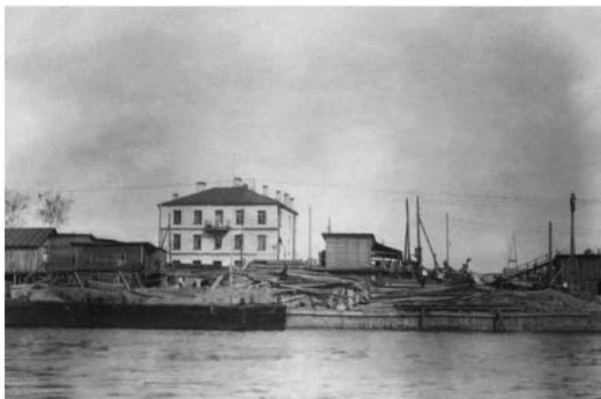
Илл. 48. Вид части строящейся набережной в районе Володарского моста. 1934 г.
