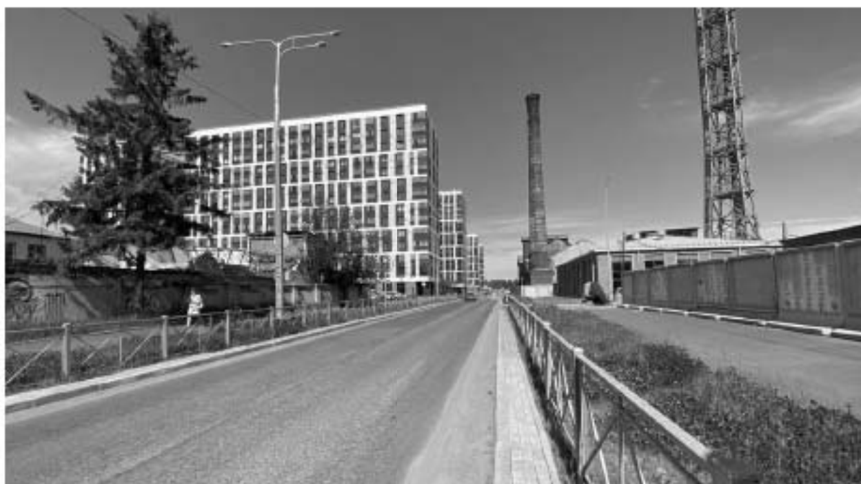
Фото 4. Вид по оси проезда в северном направлении на производственное здание с дымовой трубой.
