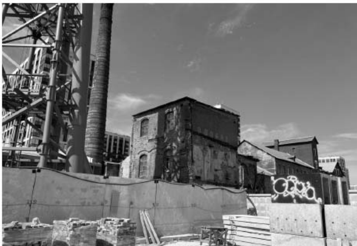
Фото 9. Вид на производственное здание с трубой с южной стороны.
