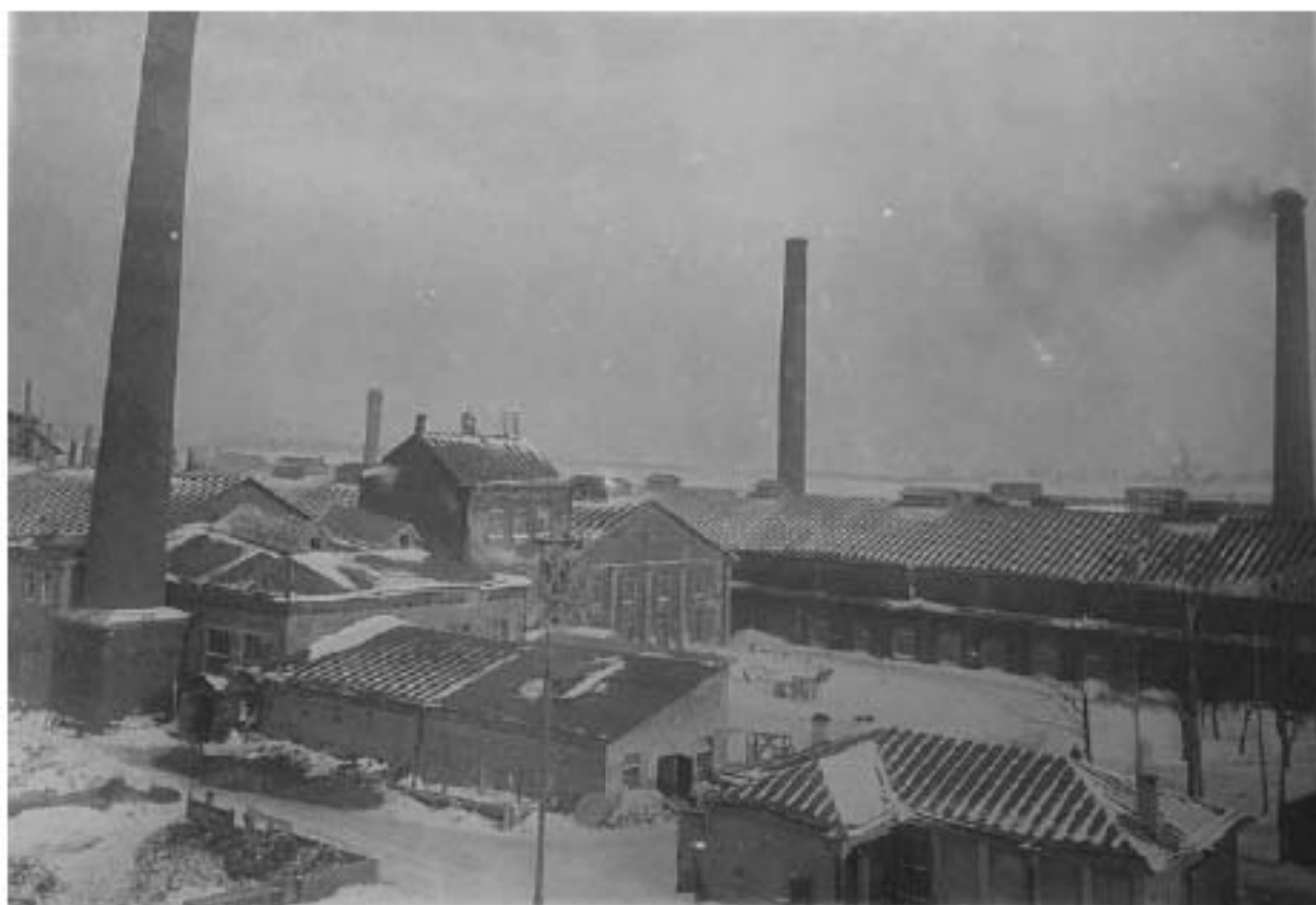
Илл. 38. Общий вид завода. 1932 г. ЦГАКФФД СПб. Гр 32650.
