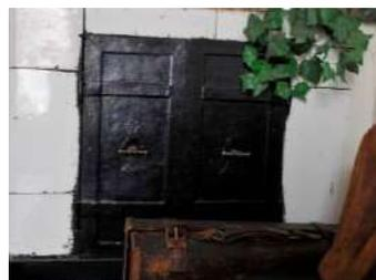
62. дверь – материал (дерево), полуторостворная; каждая створка на три фигурейные филенки; профилированные наличники в верхней и правой частях дверного заполнен
