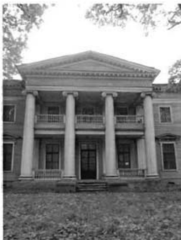
5. Портик со стороны северного фасада.
