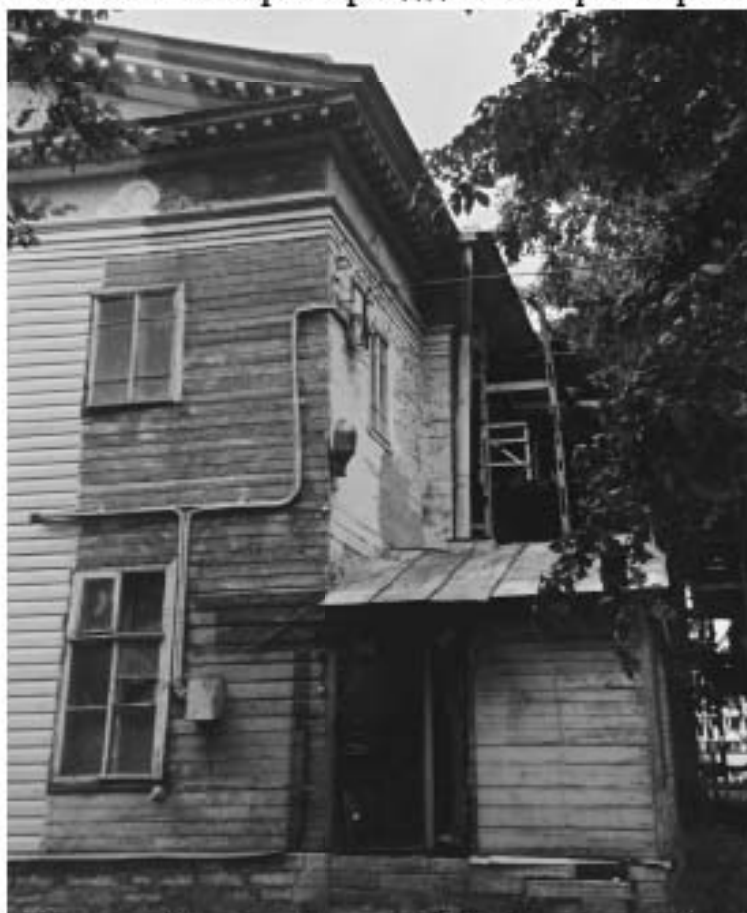
Илл. 59. Дача Головина. Восточный и северный фасады дачи (угол дома). Автор: Пекарева П.Д. 2005 г.
