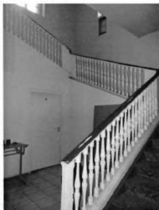
12. Ограждение лестничных маршей.
