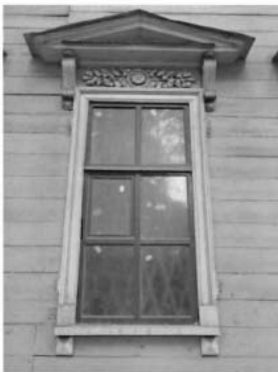
4. Оконный проем первого этажа.
