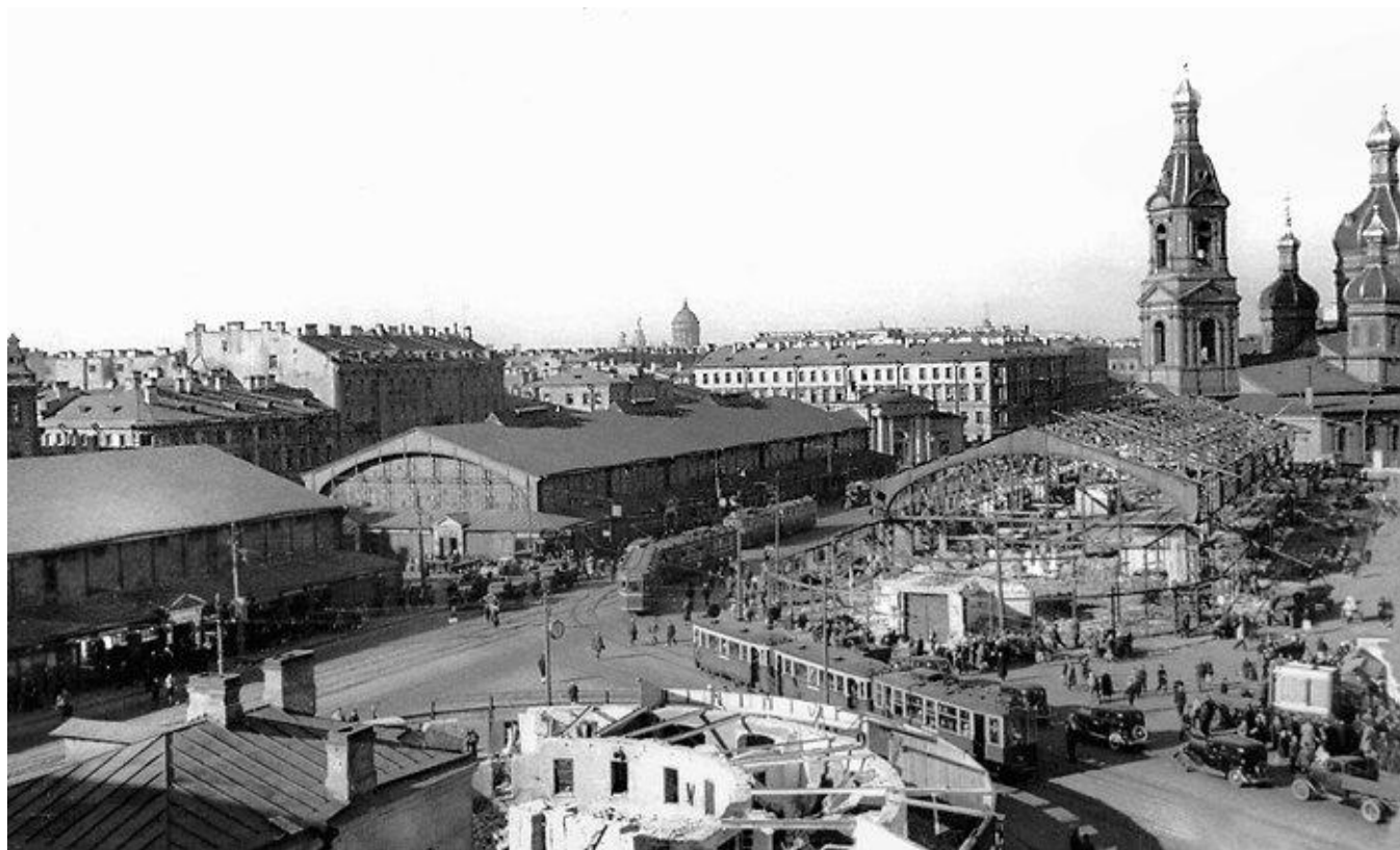
Илл. 25. Сенная площадь. Демонтаж торговых павильонов. 1930-е гг.//Сайт: oldsp.ru.
