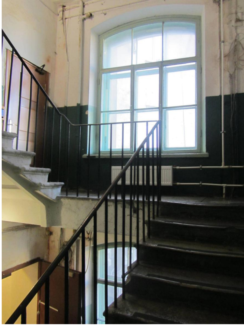
19. Площадка третьего этажа лестничной клетки. Фрагмент.
