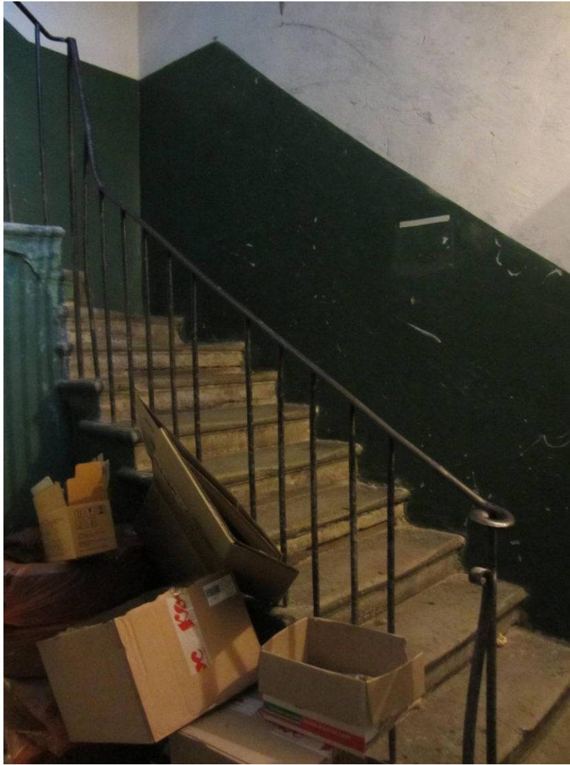
15. Марш лестничной клетки Фрагмент
