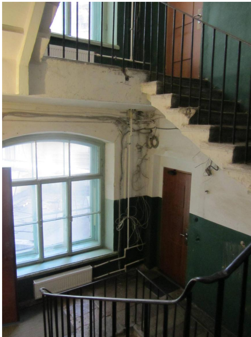
18. Лестничные марши между вторым и третьим этажами. Фрагмент.
