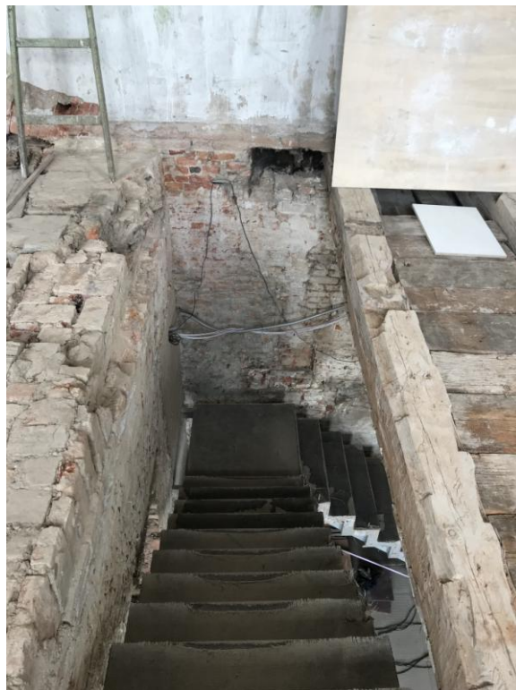
Фото 9. Интерьер квартиры №1, расположенной в объекте культурного наследия регионального значения «Дом № 48», входящем в состав объекта культурного наследия регионального значения «Дома П.К. Ферзена (А.Я. Прозорова)», 2 эт., лестница
