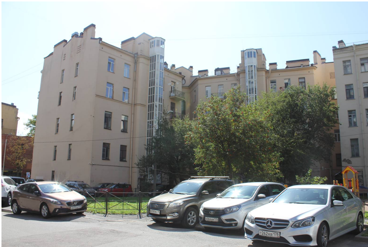
32. Объекты культурного наследия регионального значения: «Дом Д.И. Поршнева» (Черной речки наб., 51, лит. А), «Дом П.И. Поршневой» (Черной речки наб., 49, лит. А). Общий вид дворового пространства, дворовые фасады Дома П.И. Поршневой. Дата фотофиксации: 7 сентября 2021 г.
