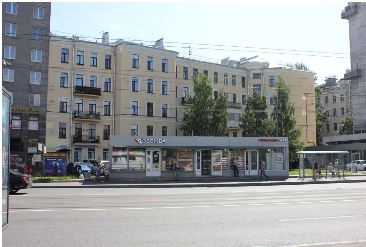
40. Объекты культурного наследия регионального значения: «Дом Д.И. Поршнева» (Черной речки наб., 51, лит. А), «Дом П.И. Поршневой» (Черной речки наб., 49, лит. А). Объект рядовой исторической застройки – флигель Дома Д.И. Поршнева (Черной речки наб., 51б, лит. Б). Вид с Торжковской ул. Дата фотофиксации: 7 сентября 2021 г.
