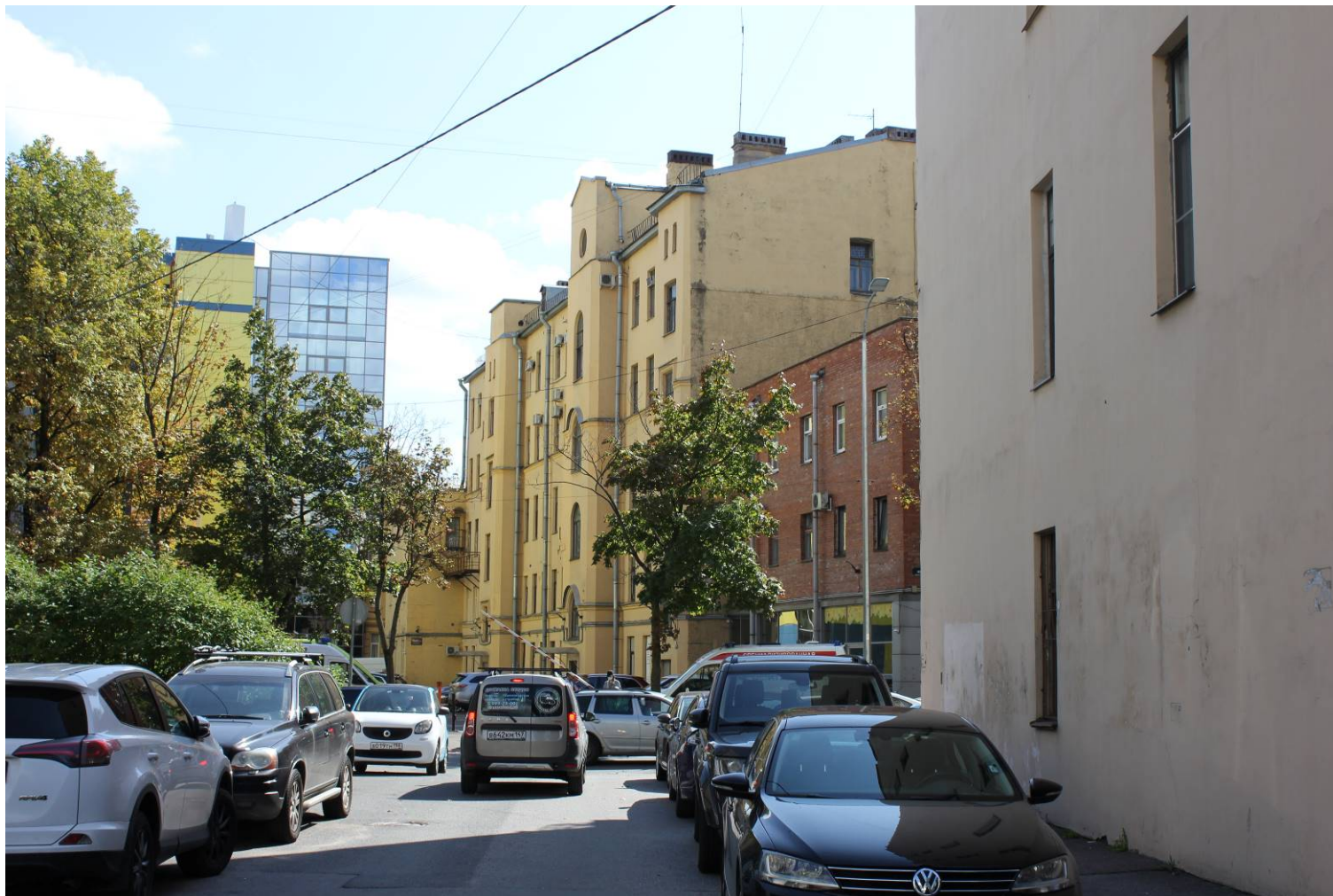
35. Объекты культурного наследия регионального значения: «Дом Д.И. Поршнева» (Черной речки наб., 51, лит. А), «Дом П.И. Поршневой» (Черной речки наб., 49, лит. А). Вид от Дома П.И. Поршневой (ОКН(Р)) в сторону доходного дома П.И. Поршневой (объект рядовой исторической застройки, расположенный по адресу: Черной речки наб., 41, лит. В). Дата фотофиксации: 7 сентября 2021 г.
