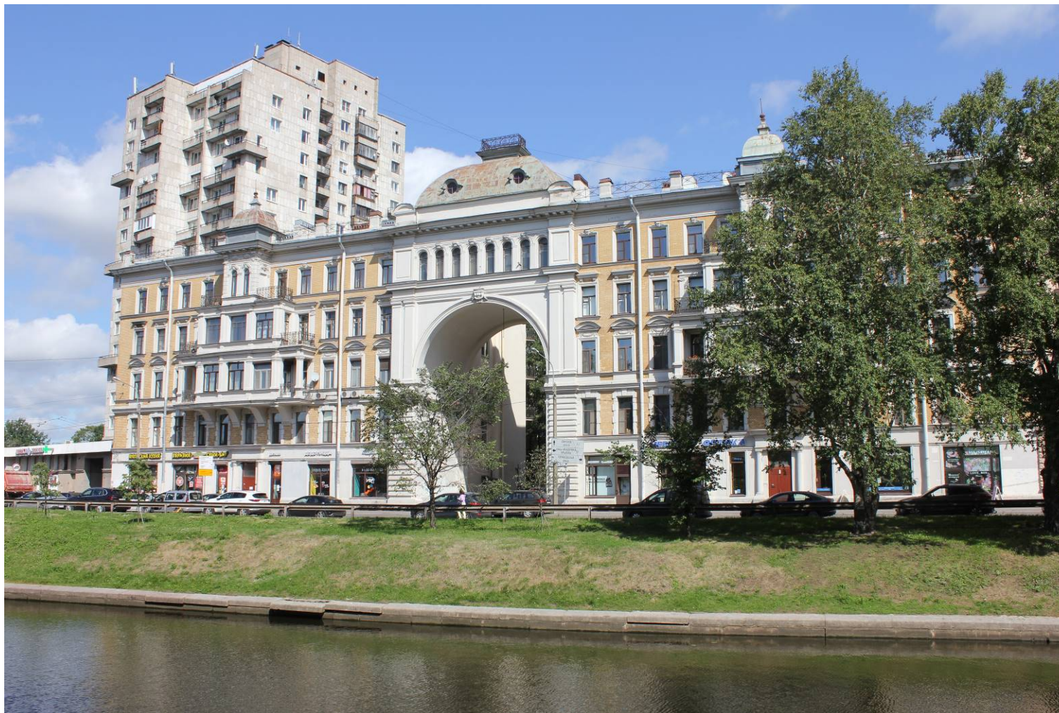
11. Объекты культурного наследия регионального значения: «Дом Д.И. Поршнева» (Черной речки наб., 51, лит. А), «Дом П.И. Поршневой» (Черной речки наб., 49, лит. А). Лицевой фасад Дома Д.И. Поршнева. Вид с противоположного берега Черной речки (с территории Строгановского сада (объект культурного наследия регионального значения)). Дата фотофиксации: 7 сентября 2021 г.
