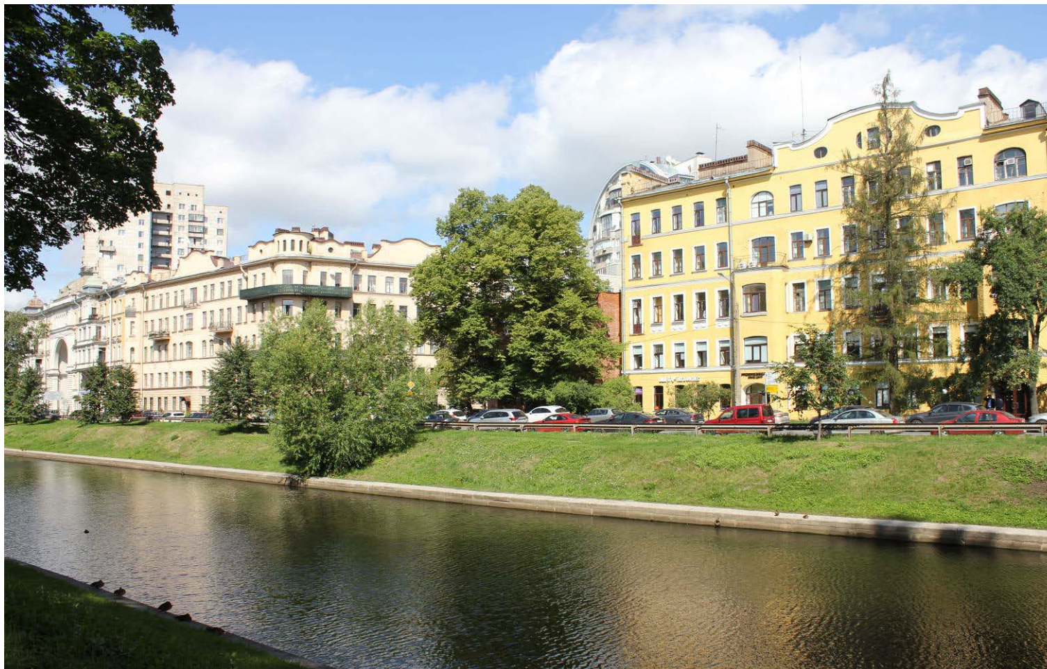
16. Объекты культурного наследия регионального значения: «Дом Д.И. Поршнева» (Черной речки наб., 51, лит. А), «Дом П.И. Поршневой» (Черной речки наб., 49, лит. А). Общий вид застройки наб. Черной речки с противоположного берега (с территории Строгановского сада (ОКН(Р)). Слева – Дома Д.И. Поршнева и П.И. Поршневой (ОКН(Р)). Справа – доходный дом П.И. Поршневой (объект рядовой исторической застройки, расположенный по адресу: Черной речки наб., 41, лит. В). Дата фотофиксации: 7 сентября 2021 г.
