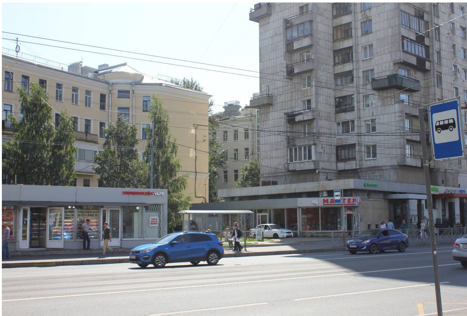
41. Объекты культурного наследия регионального значения: «Дом Д.И. Поршнева» (Черной речки наб., 51, лит. А), «Дом П.И. Поршневой» (Черной речки наб., 49, лит. А). Вид в сторону Дома Д.И. Поршнева с Торжковской ул. Слева – фрагмент фасада флигеля Дома Д.И. Поршнева (объект рядовой исторической застройки, расположенный по адресу: Черной речки наб., 51б, лит. Б). Дата фотофиксации: 7 сентября 2021 г.
