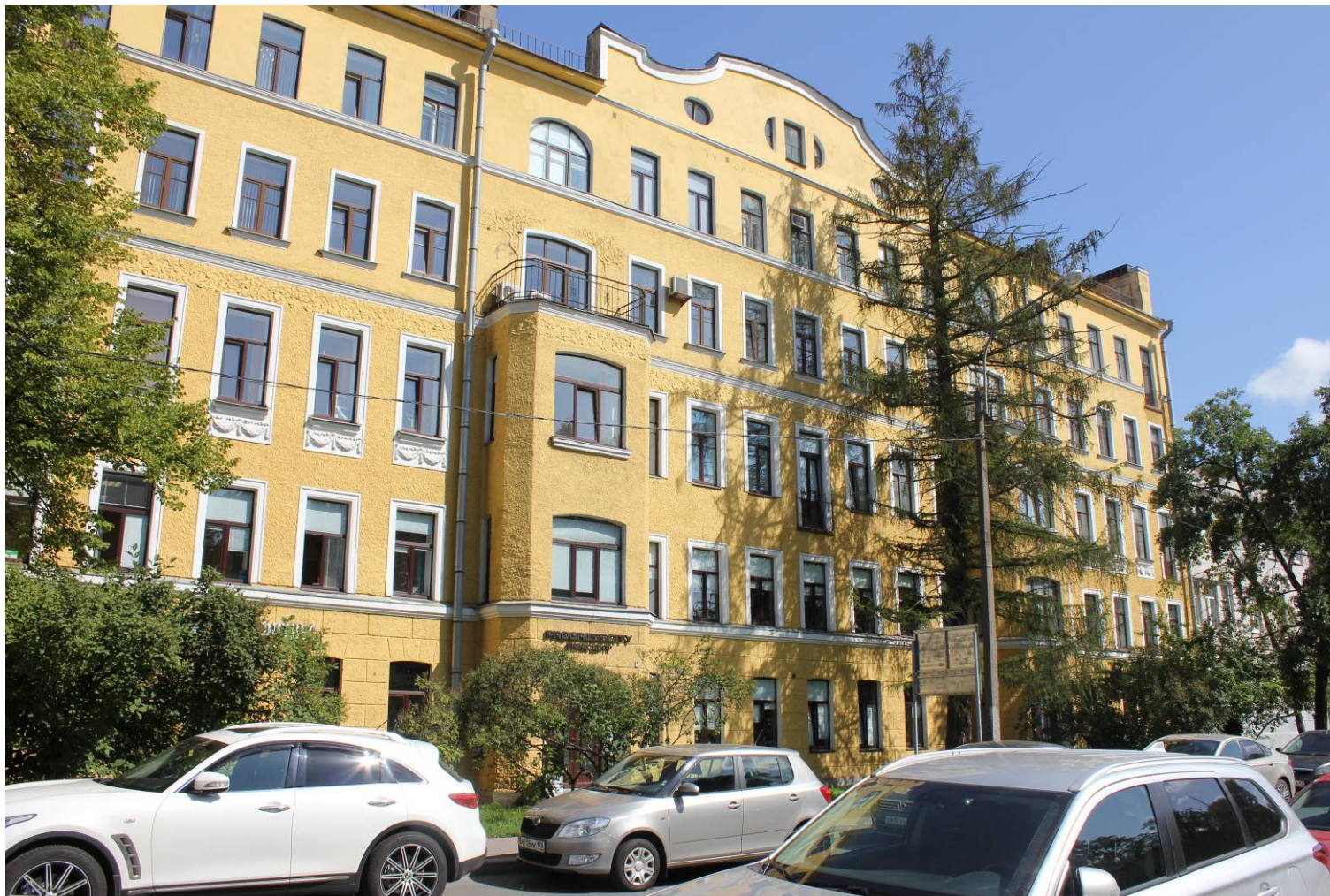
20. Объекты культурного наследия регионального значения: «Дом Д.И. Поршнева» (Черной речки наб., 51, лит. А), «Дом П.И. Поршневой» (Черной речки наб., 49, лит. А). Лицевой фасад доходного дома П.И. Поршневой (объект рядовой исторической застройки, расположенный по адресу: Черной речки наб., 41, лит. В). Дата фотофиксации: 7 сентября 2021 г.
