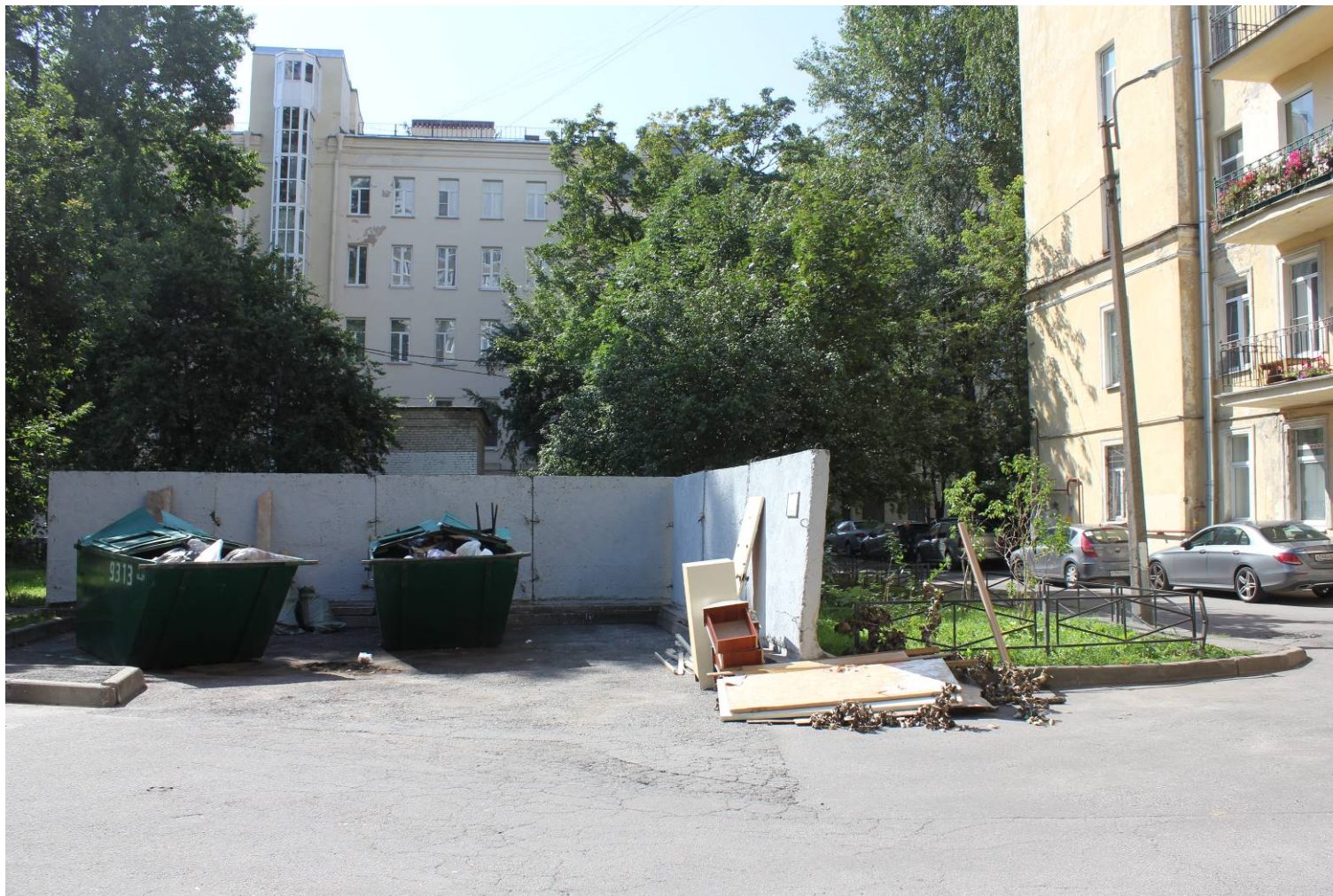
30. Объекты культурного наследия регионального значения: «Дом Д.И. Поршнева» (Черной речки наб., 51, лит. А), «Дом П.И. Поршневой» (Черной речки наб., 49, лит. А). Общий вид дворового пространства. Дата фотофиксации: 7 сентября 2021 г.
