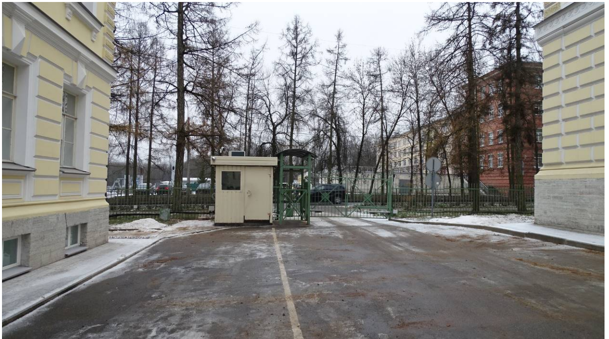
06. Главный въезд. Пост охраны. Вид с северной стороны. Съемка 18.12.2020 г. Полетайкин В. В.
