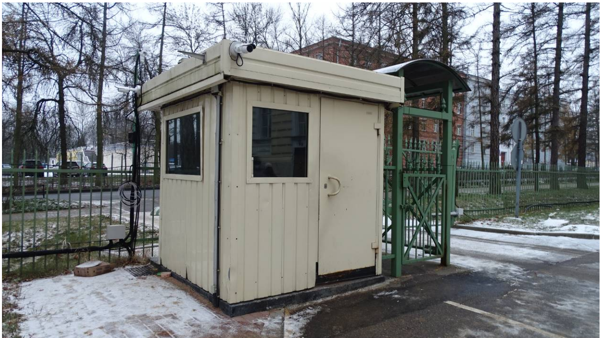
04. Главный въезд. Пост охраны. Вид с северной стороны. Съемка 18.12.2020 г. Полетайкин В. В.
