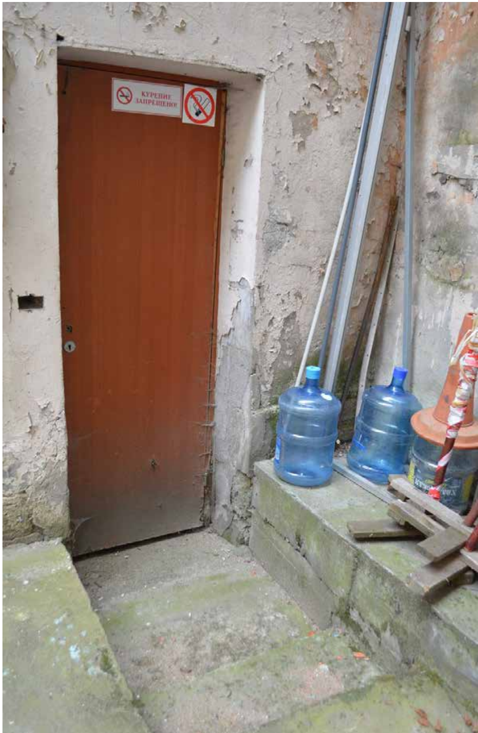
Фото 25. ОКН регионального значения «Особняк Строгановой А.Д.». Дворовые фасады. Фрагмент. Съёмка 21.06.2021 г.
