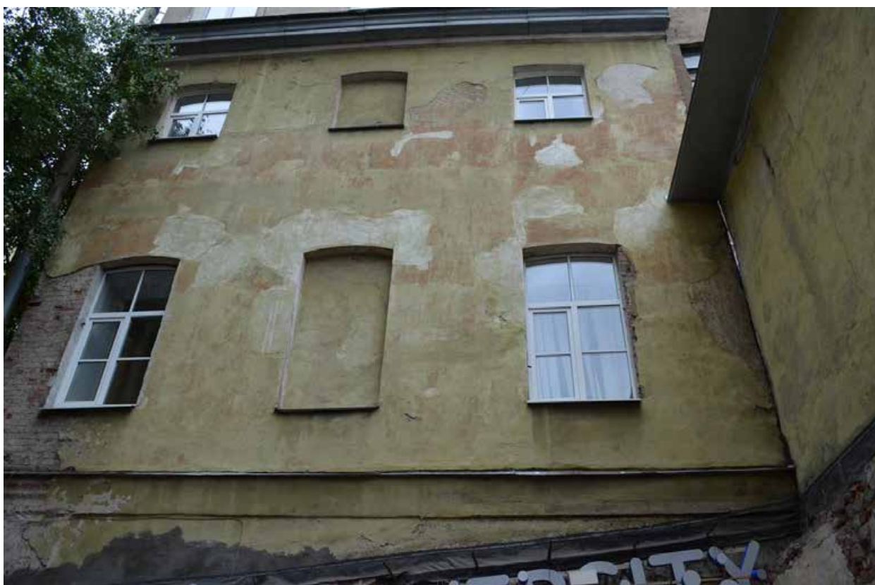
Фото 22. ОКН регионального значения «Особняк Строгановой А.Д.». Дворовые фасады. Фрагмент. Съёмка 21.06.2021 г.
