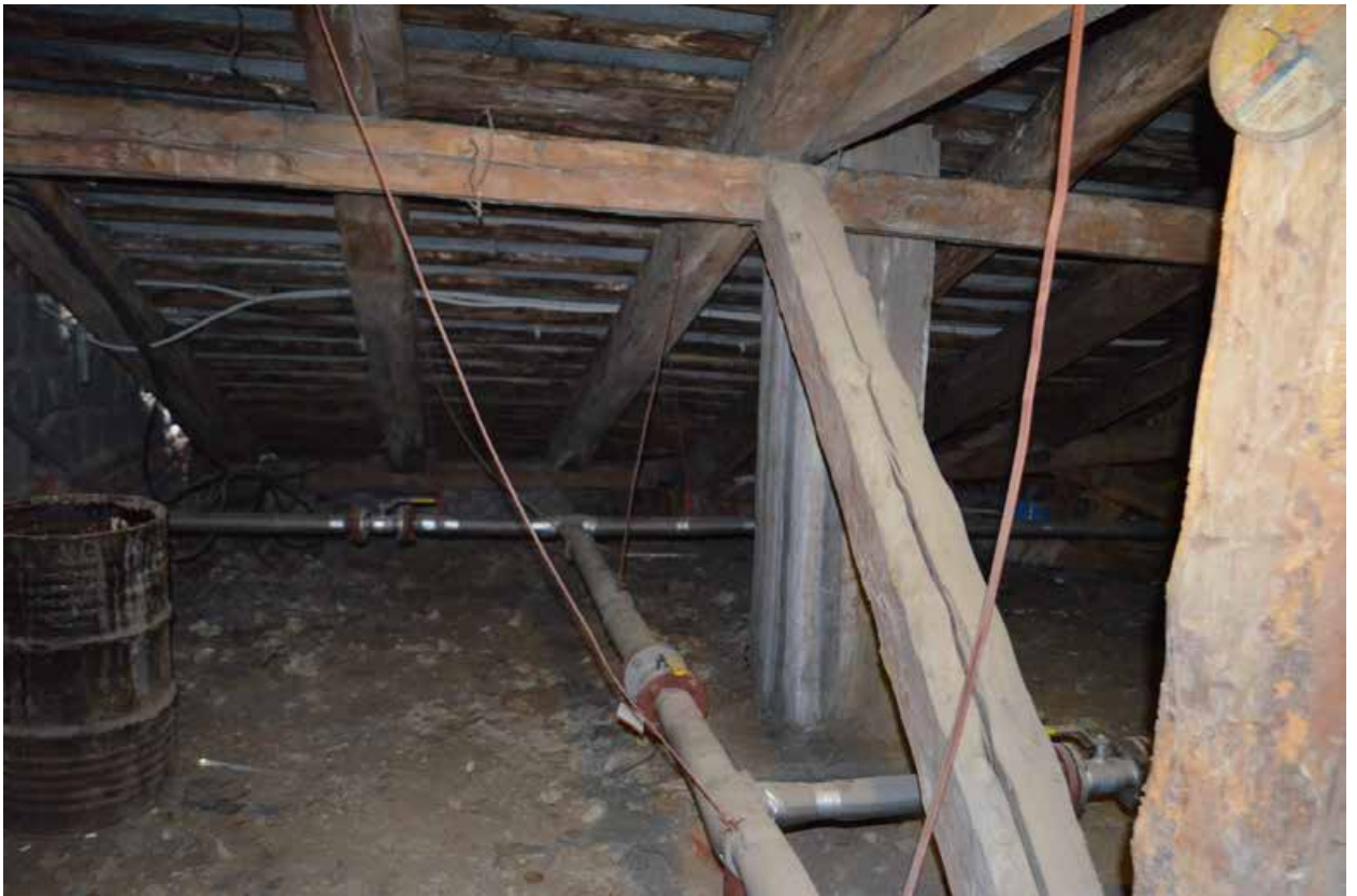
Фото 49. ОКН регионального значения «Особняк Строгановой А.Д.». Чердак. Стропильная система. Фрагмент. Съёмка 21.06.2021 г.
