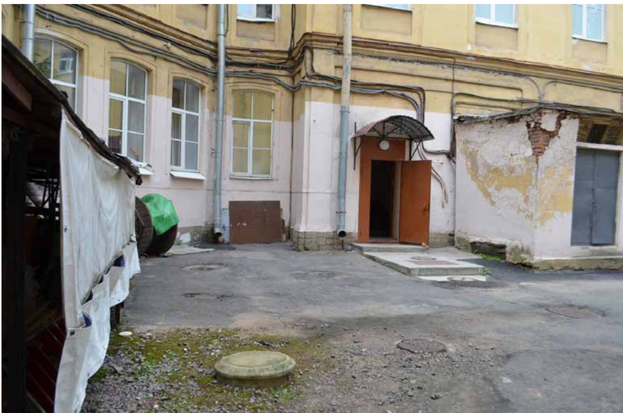
Фото 05. ОКН регионального значения «Особняк Строгановой А.Д.». Дворовые фасады. Фрагмент. Съёмка 21.06.2021 г.
