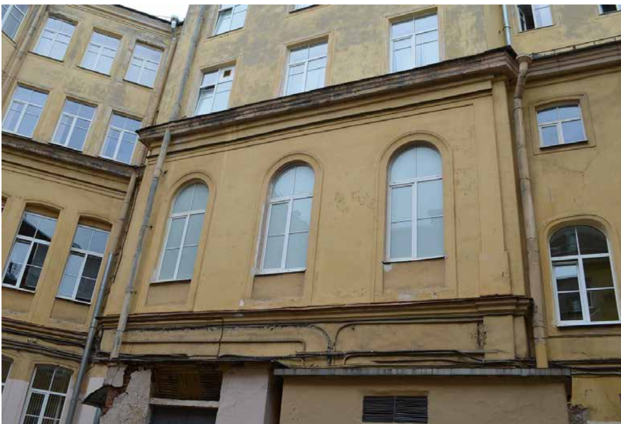
Фото 08. ОКН регионального значения «Особняк Строгановой А.Д.». Дворовые фасады. Фрагмент. Съёмка 21.06.2021 г.
