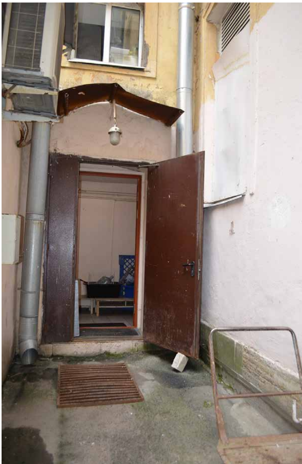
Фото 31. ОКН регионального значения «Особняк Строгановой А.Д.». Дворовые фасады. Двор. Фрагмент. Съёмка 21.06.2021 г.
