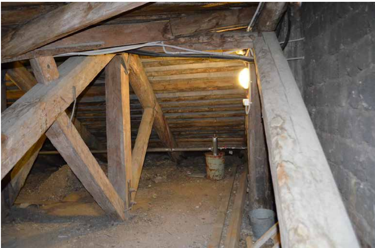
Фото 41. ОКН регионального значения «Особняк Строгановой А.Д.». Чердак. Стропильная система. Фрагмент. Съёмка 21.06.2021 г.
