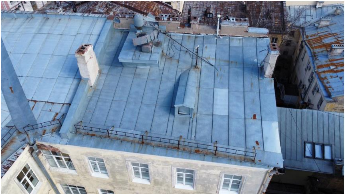
Фото 35. ОКН регионального значения «Особняк Строгановой А.Д.». Кровля. Общий вид. Съёмка 21.06.2021 г.
