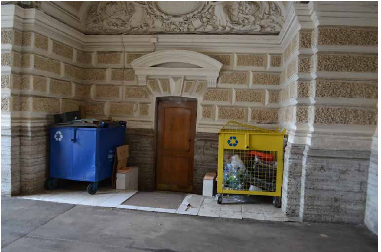
Фото 15. ОКН регионального значения «Особняк Строгановой А.Д.». Воротный проезд. Фрагмент. Съёмка 21.06.2021 г.
