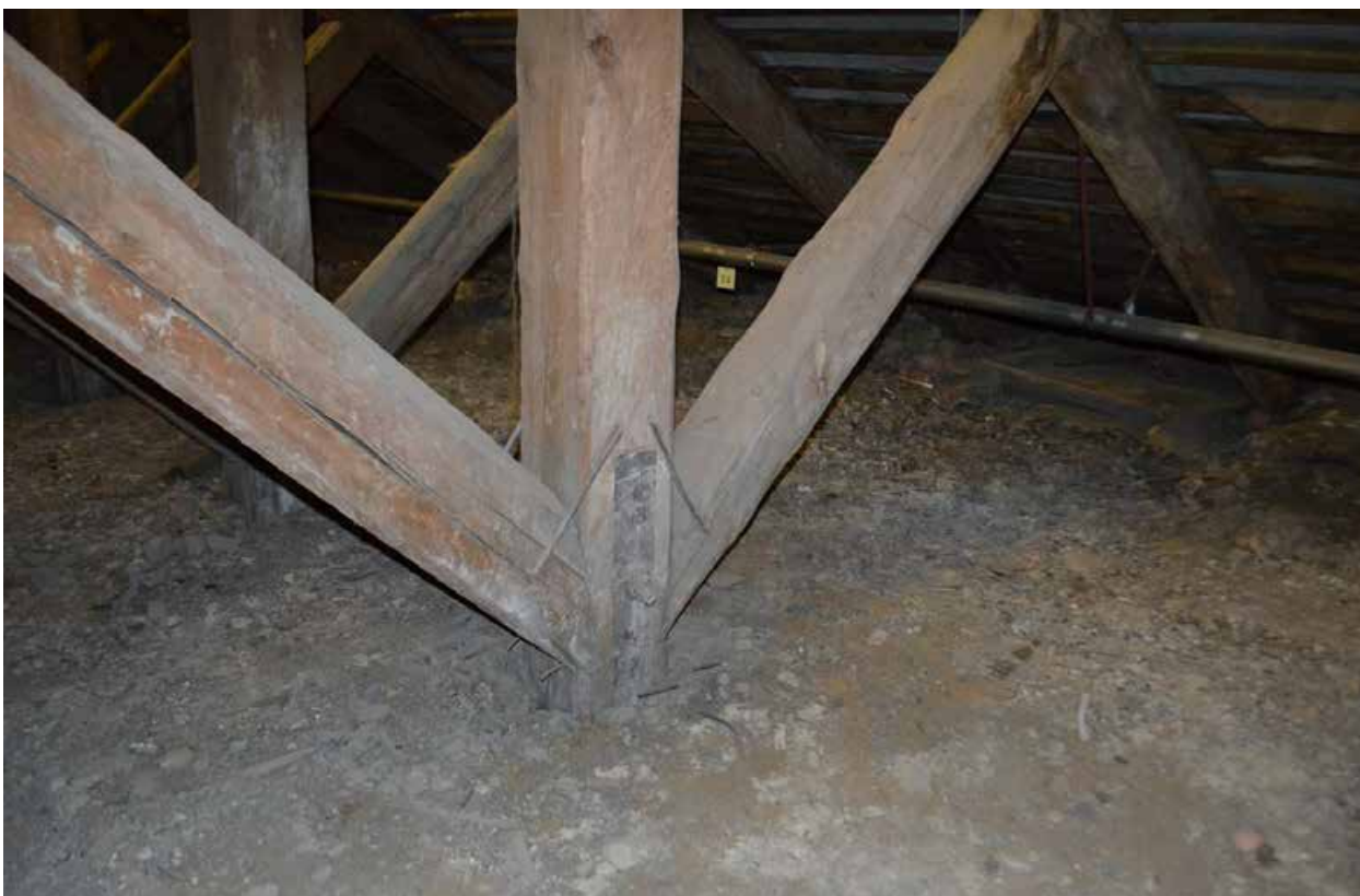
Фото 43. ОКН регионального значения «Особняк Строгановой А.Д.». Чердак. Стропильная система. Фрагмент. Съёмка 21.06.2021 г.
