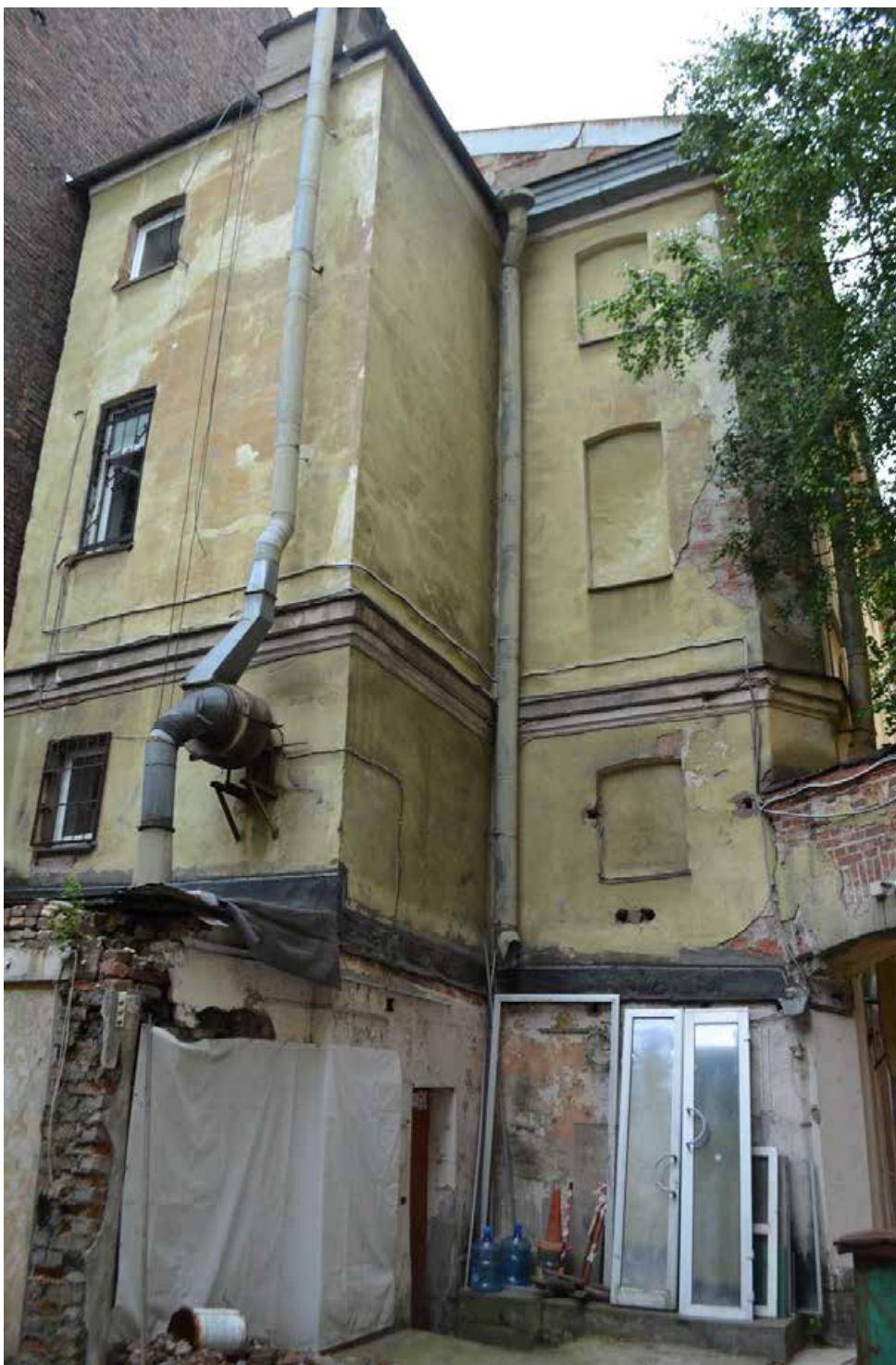
Фото 24. ОКН регионального значения «Особняк Строгановой А.Д.». Дворовые фасады. Фрагмент. Съёмка 21.06.2021 г.
