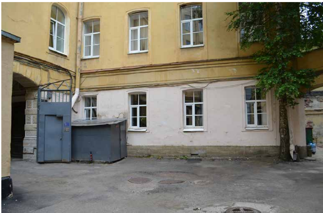
Фото 17. ОКН регионального значения «Особняк Строгановой А.Д.». Дворовые фасады. Фрагмент. Съёмка 21.06.2021 г.
