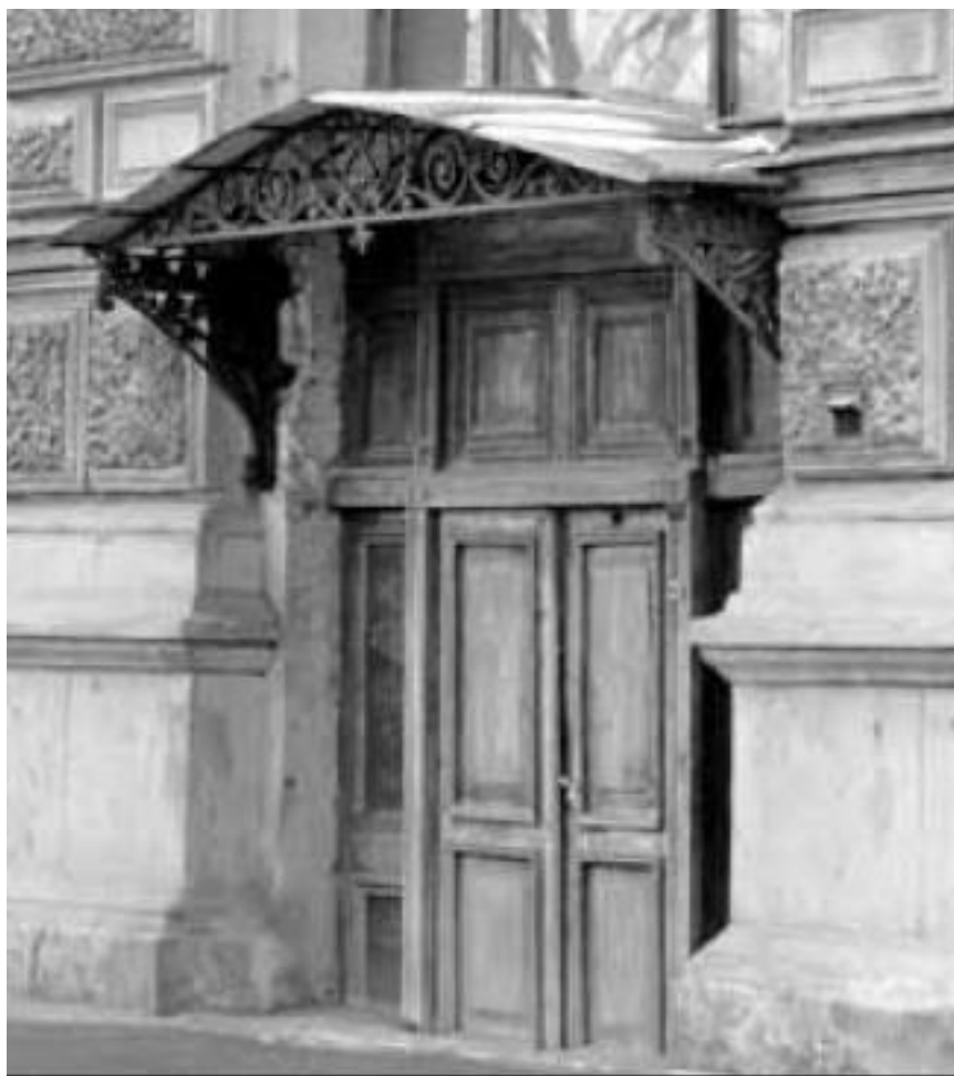
Илл. 48. Козырек дома П.А. Зубова. 1870. Архитектор К.К. Шульц. Железо. Исаакиевская пл., 5. Аналог кованого козырька.
