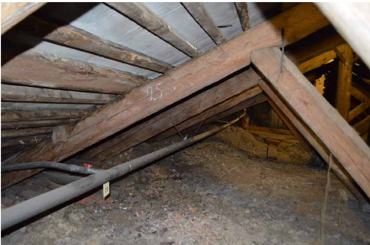
Фото 44. ОКН регионального значения «Особняк Строгановой А.Д.». Чердак. Стропильная система. Фрагмент. Съёмка 21.06.2021 г.
