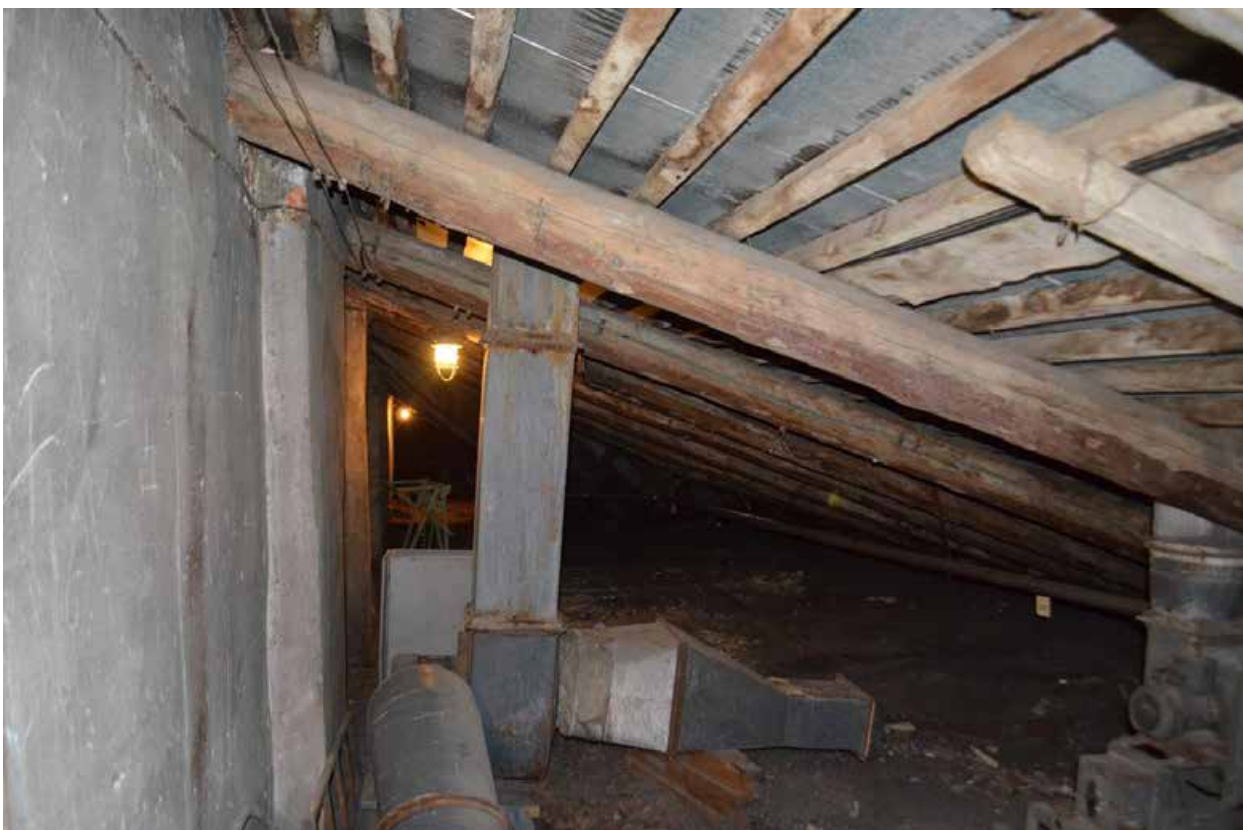
Фото 38. ОКН регионального значения «Особняк Строгановой А.Д.». Чердак. Стропильная система. Фрагмент. Съёмка 21.06.2021 г.
