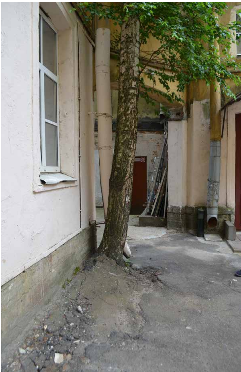
Фото 18. ОКН регионального значения «Особняк Строгановой А.Д.». Дворовые фасады. Фрагмент. Съёмка 21.06.2021 г.
