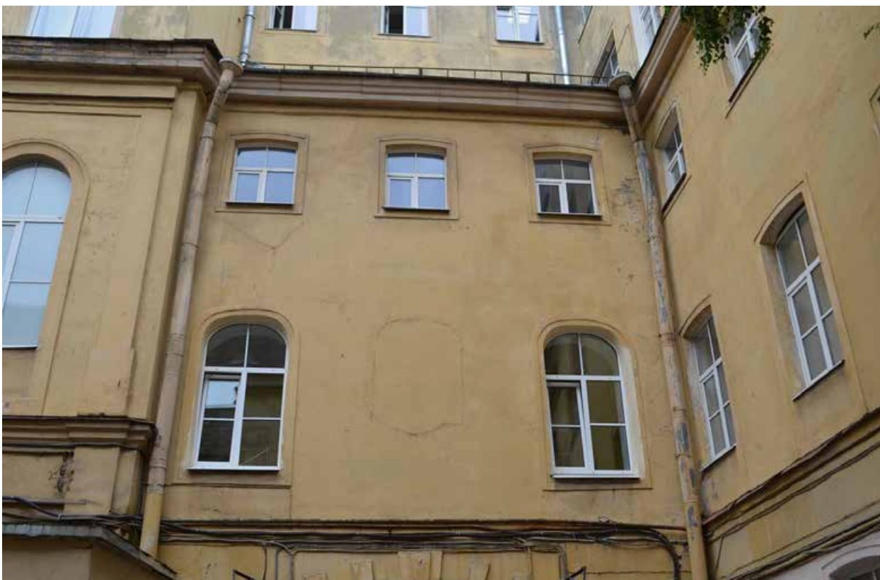
Фото 11. ОКН регионального значения «Особняк Строгановой А.Д.». Дворовые фасады. Фрагмент. Съёмка 21.06.2021 г.
