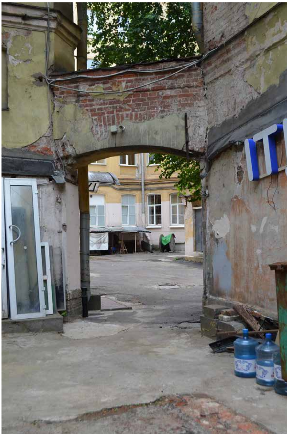
Фото 26. ОКН регионального значения «Особняк Строгановой А.Д.». Дворовые фасады. Фрагмент. Съёмка 21.06.2021 г.
