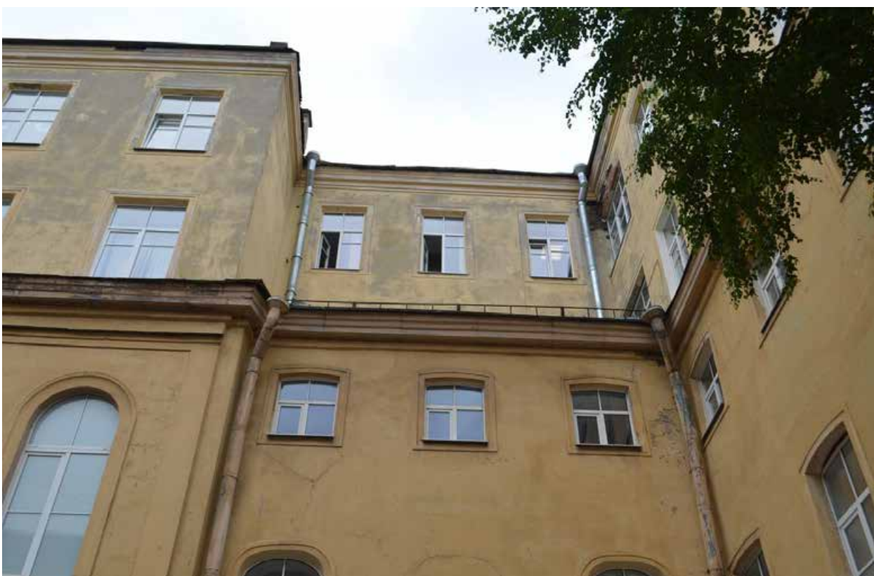
Фото 12. ОКН регионального значения «Особняк Строгановой А.Д.». Дворовые фасады. Фрагмент. Съёмка 21.06.2021 г.
