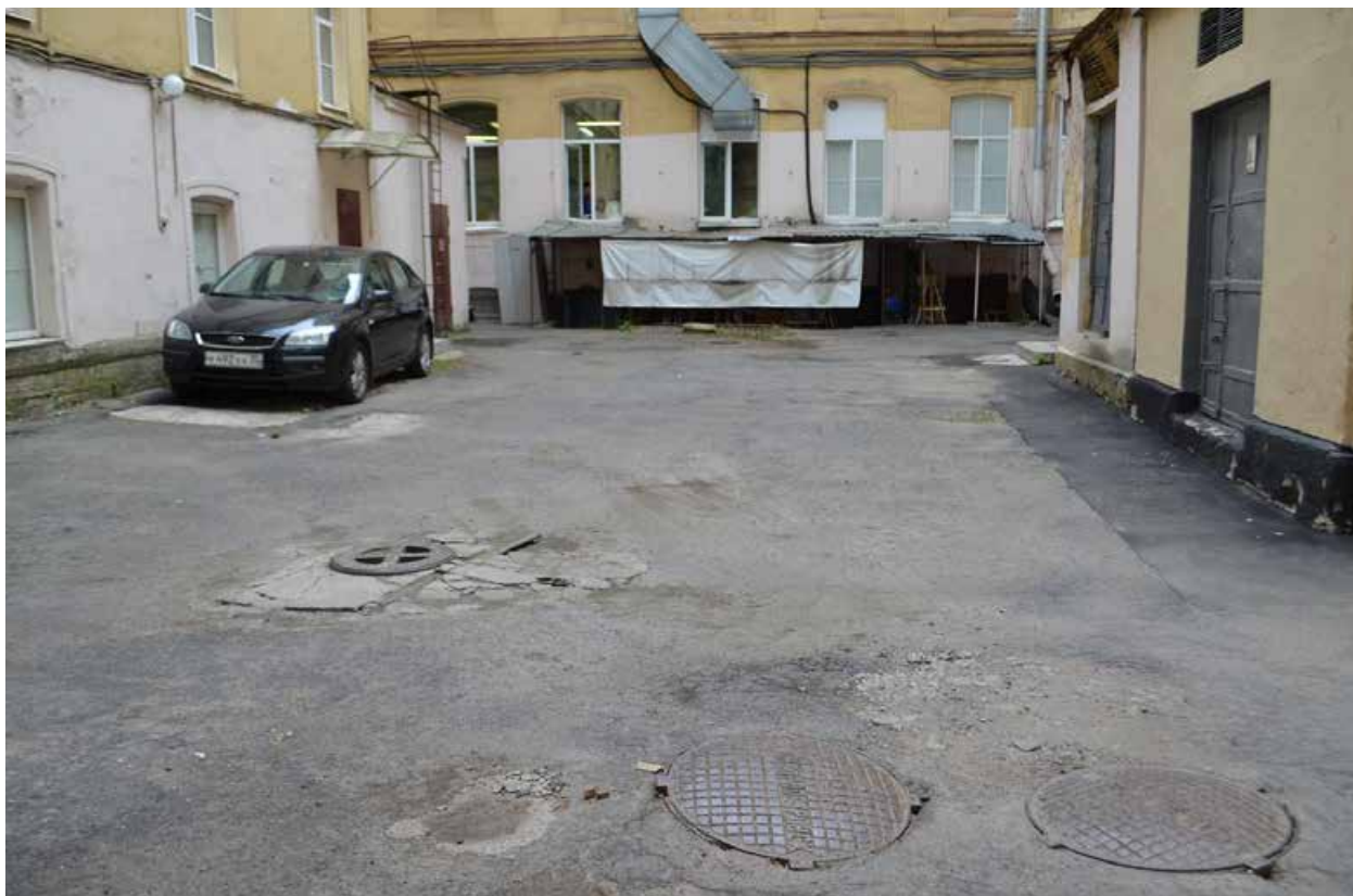
Фото 30. ОКН регионального значения «Особняк Строгановой А.Д.». Дворовые фасады. Двор. Фрагмент. Съёмка 21.06.2021 г.
