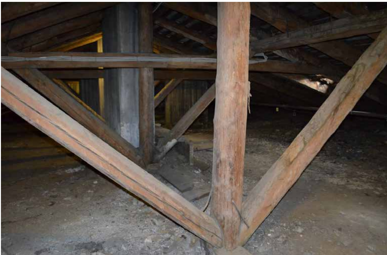
Фото 51. ОКН регионального значения «Особняк Строгановой А.Д.». Чердак. Стропильная система. Фрагмент. Съёмка 21.06.2021 г.
