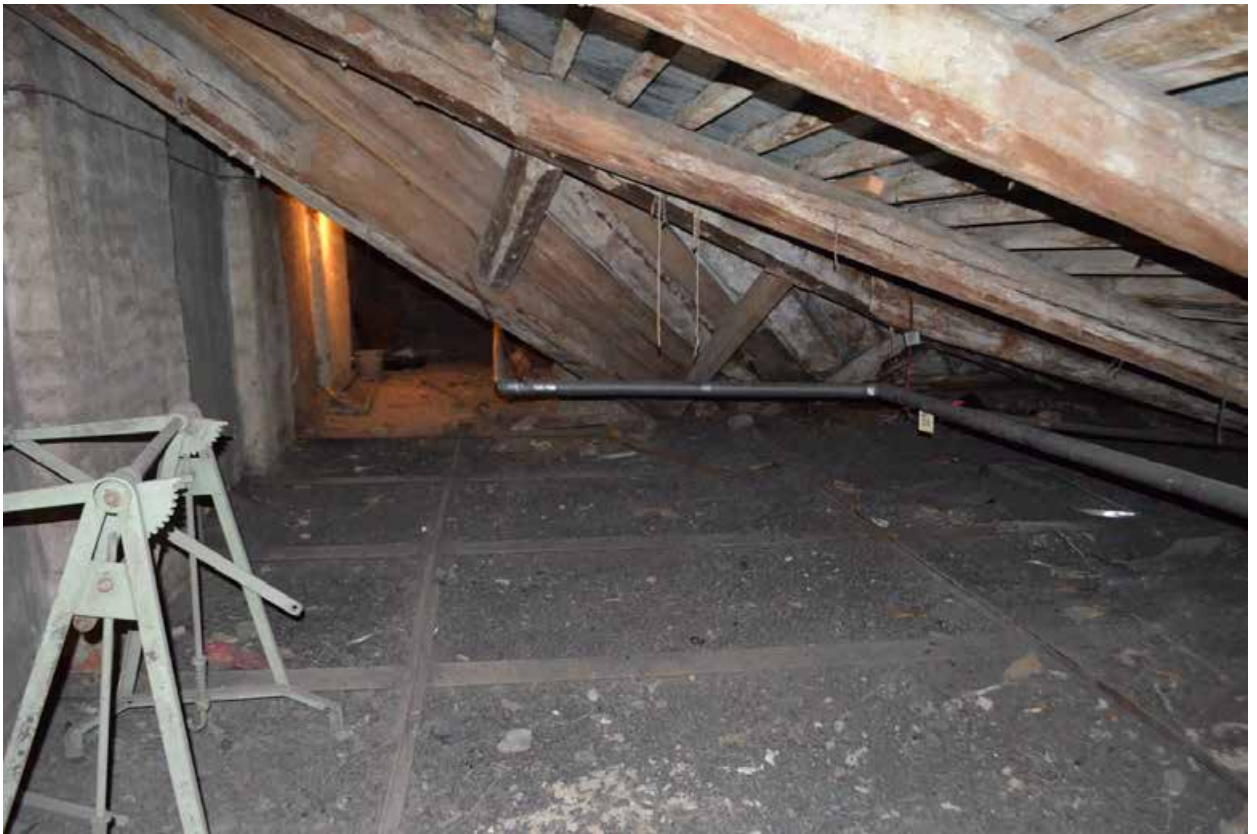
Фото 39. ОКН регионального значения «Особняк Строгановой А.Д.». Чердак. Стропильная система. Фрагмент. Съёмка 21.06.2021 г.
