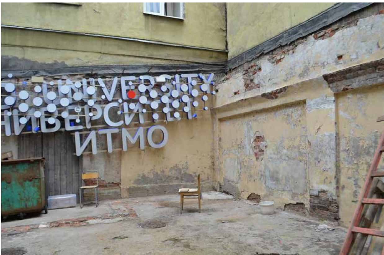
Фото 21. ОКН регионального значения «Особняк Строгановой А.Д.». Дворовые фасады. Фрагмент. Съёмка 21.06.2021 г.
