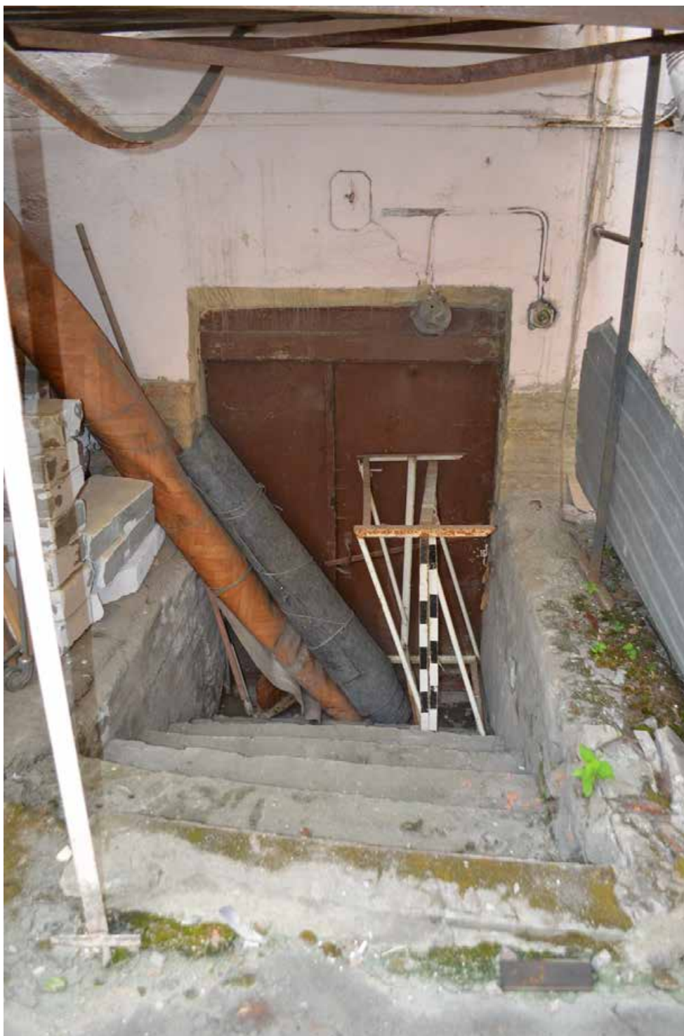
Фото 06. ОКН регионального значения «Особняк Строгановой А.Д.». Дворовые фасады. Фрагмент. Съёмка 21.06.2021 г.
