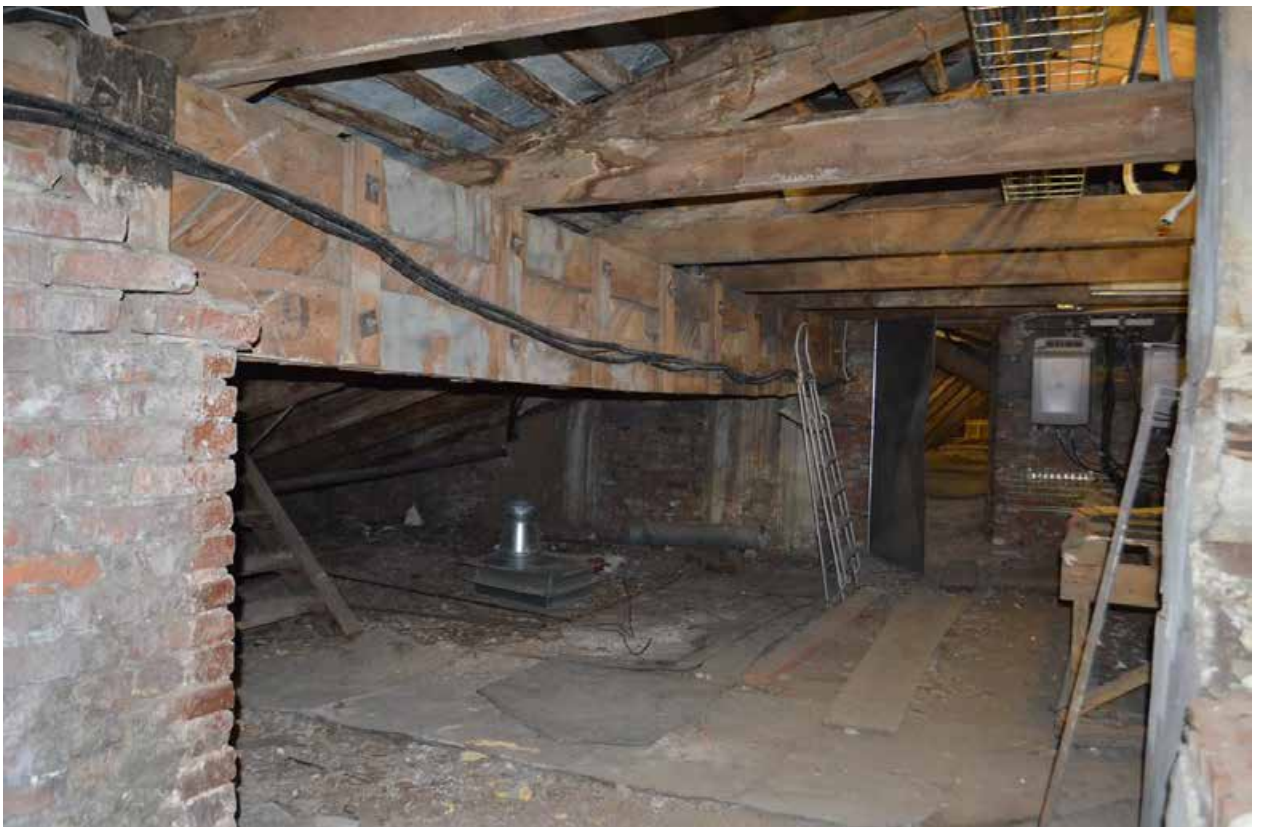
Фото 48. ОКН регионального значения «Особняк Строгановой А.Д.». Чердак. Стропильная система. Фрагмент. Съёмка 21.06.2021 г.
