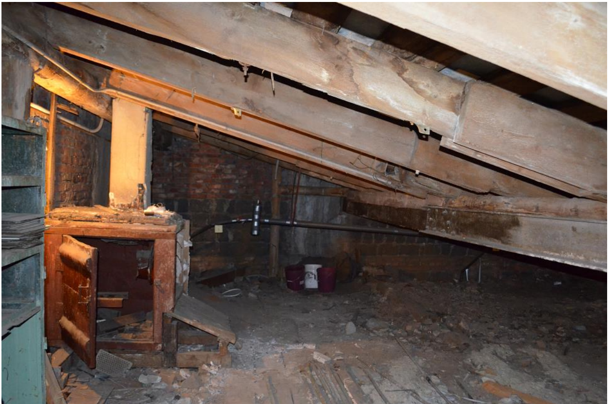
Фото 40. ОКН регионального значения «Особняк Строгановой А.Д.». Чердак. Стропильная система. Фрагмент. Съёмка 21.06.2021 г.
