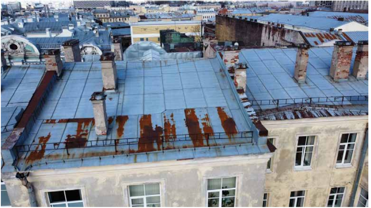
Фото 34. ОКН регионального значения «Особняк Строгановой А.Д.». Кровля. Общий вид. Съёмка 21.06.2021 г.
