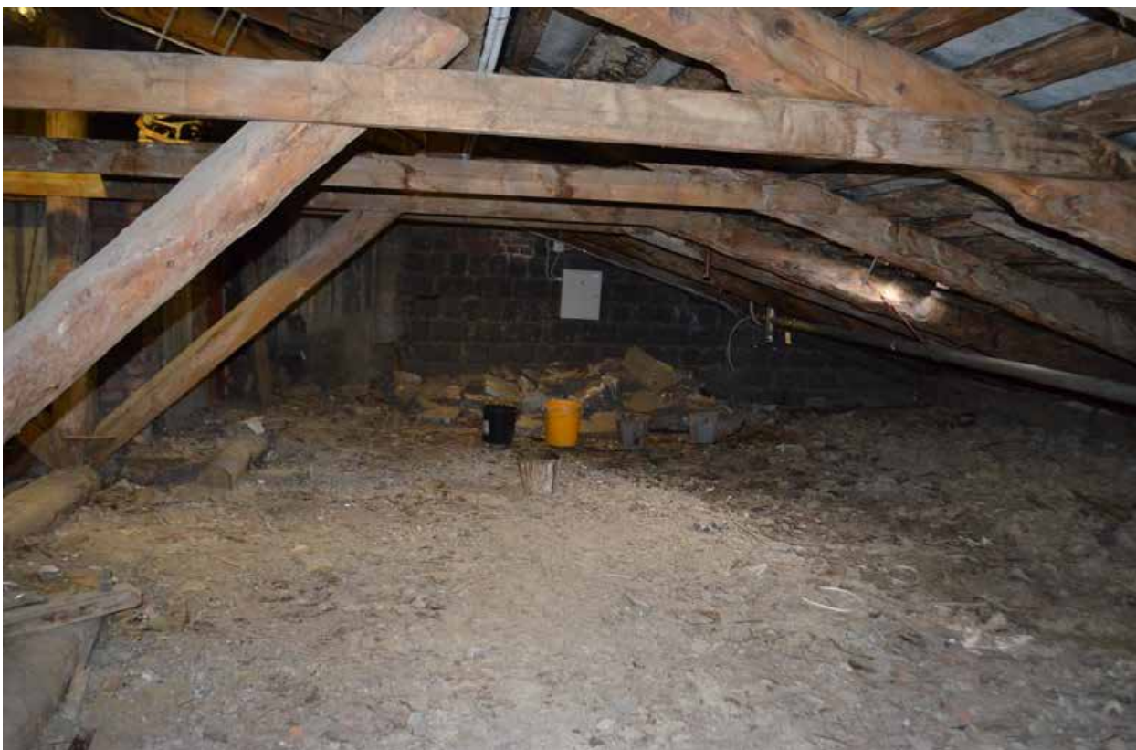
Фото 52. ОКН регионального значения «Особняк Строгановой А.Д.». Чердак. Стропильная система. Фрагмент. Съёмка 21.06.2021 г.
