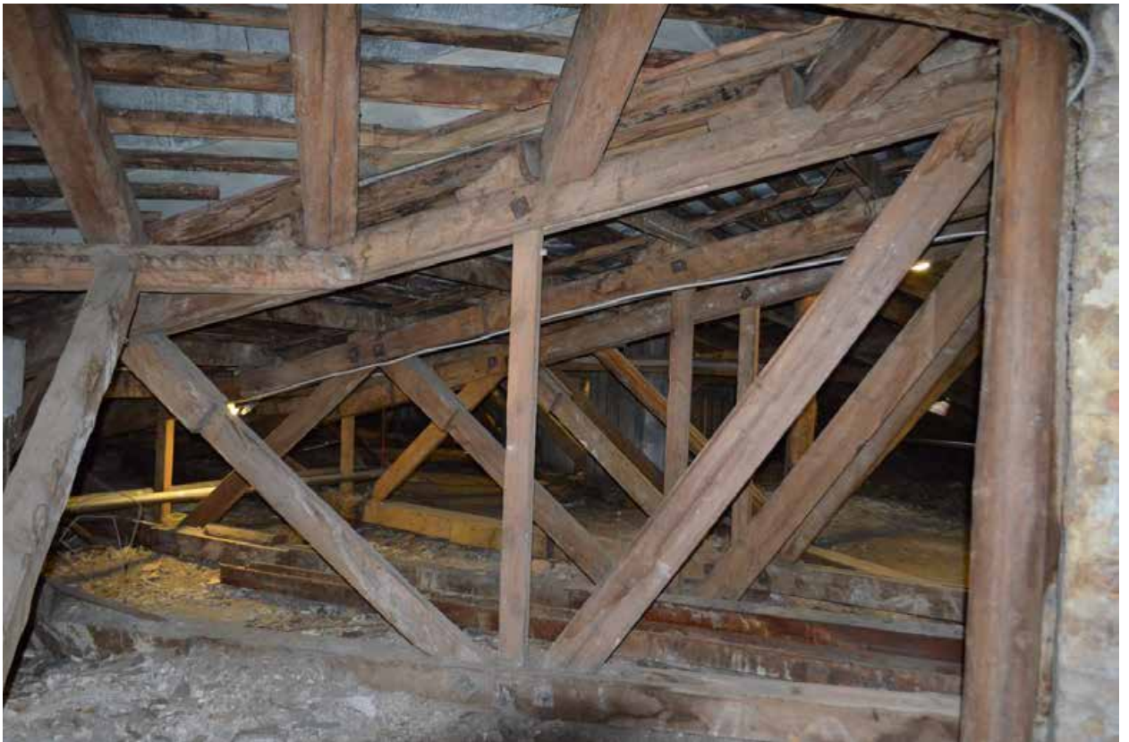
Фото 50. ОКН регионального значения «Особняк Строгановой А.Д.». Чердак. Стропильная система. Фрагмент. Съёмка 21.06.2021 г.
