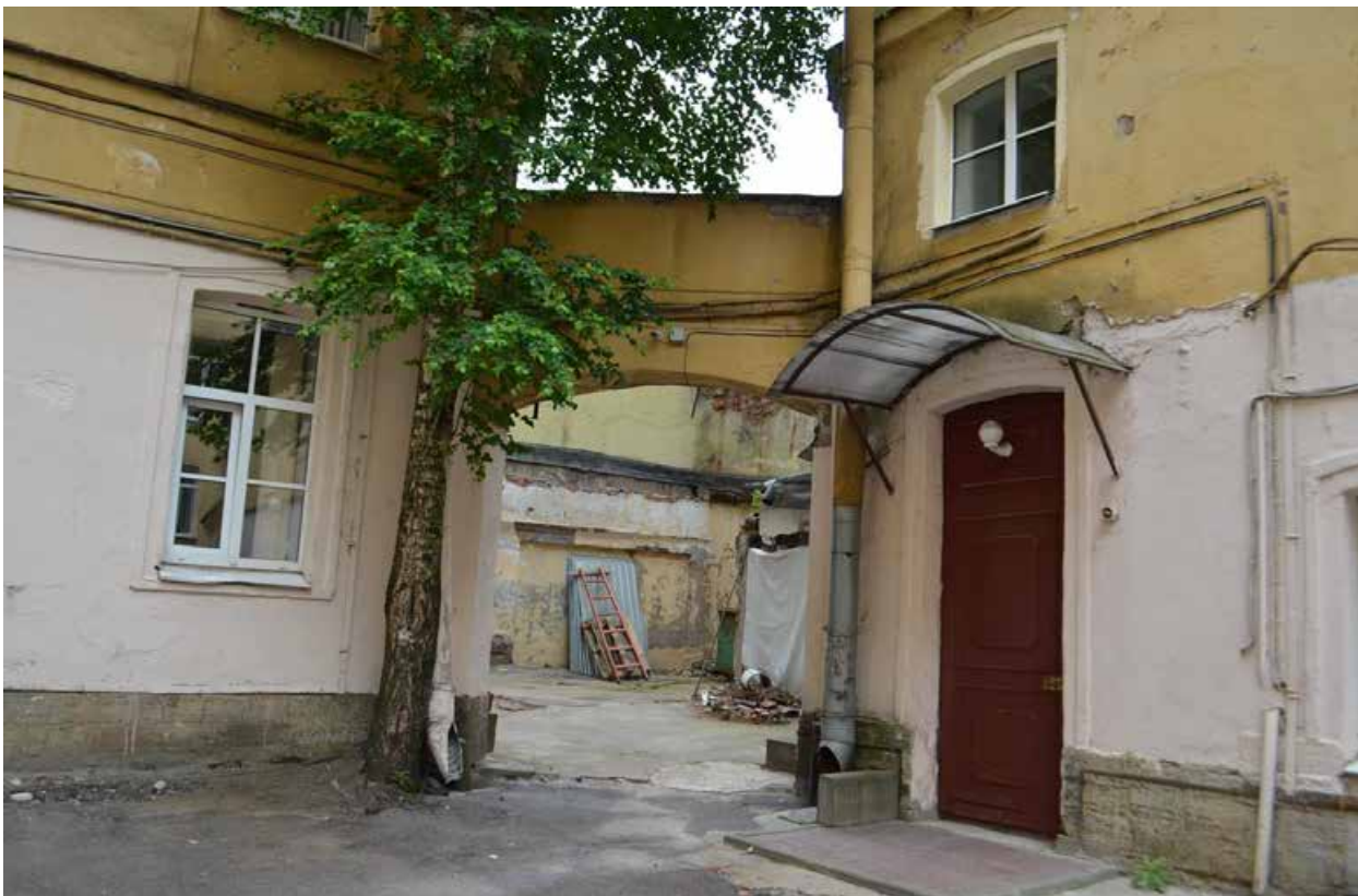
Фото 19. ОКН регионального значения «Особняк Строгановой А.Д.». Дворовые фасады. Фрагмент. Съёмка 21.06.2021 г.
