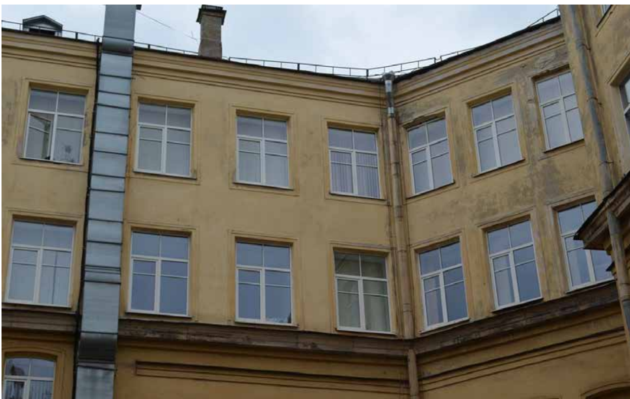
Фото 03. ОКН регионального значения «Особняк Строгановой А.Д.». Дворовые фасады. Фрагмент. Съёмка 21.06.2021 г.
