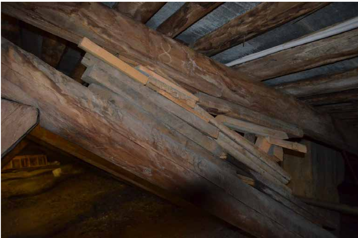
Фото 45. ОКН регионального значения «Особняк Стrogановой А.Д.». Чердак. Стрoпилная система. Фрагмент. Съёмка 21.06.2021 г.
