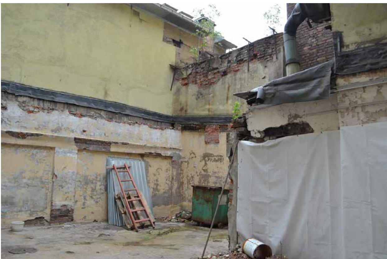
Фото 20. ОКН регионального значения «Особняк Строгановой А.Д.». Дворовые фасады. Фрагмент. Съёмка 21.06.2021 г.
