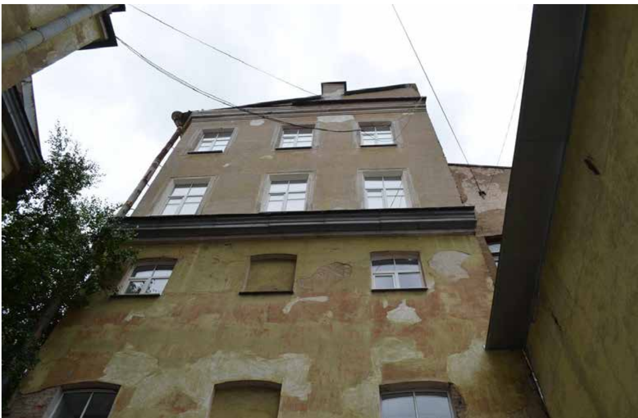
Фото 23. ОКН регионального значения «Особняк Строгановой А.Д.». Дворовые фасады. Фрагмент. Съёмка 21.06.2021 г.
