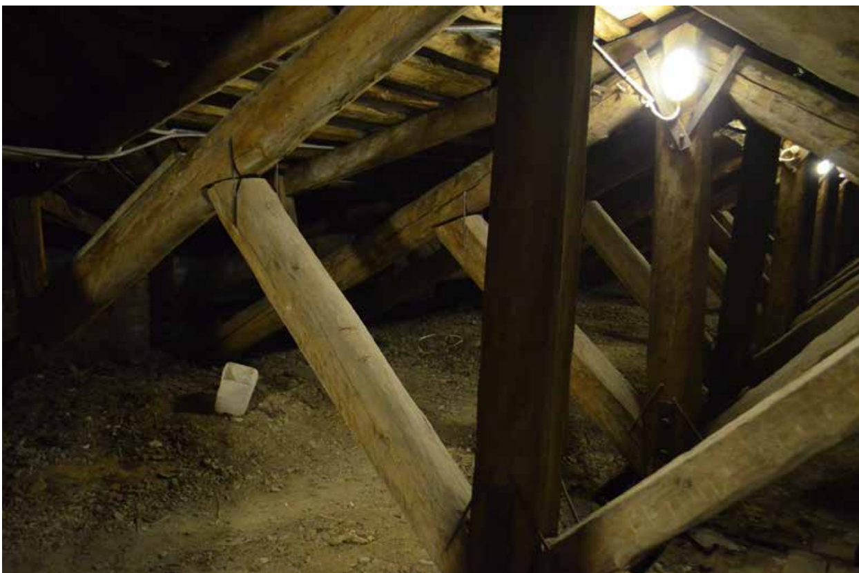
Фото 42. ОКН регионального значения «Особняк Строгановой А.Д.». Чердак. Стропильная система. Фрагмент. Съёмка 21.06.2021 г.
