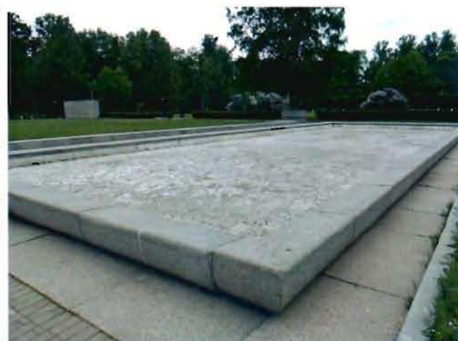
13. Декоративный бассейн, расположенный в центральной части территории.
