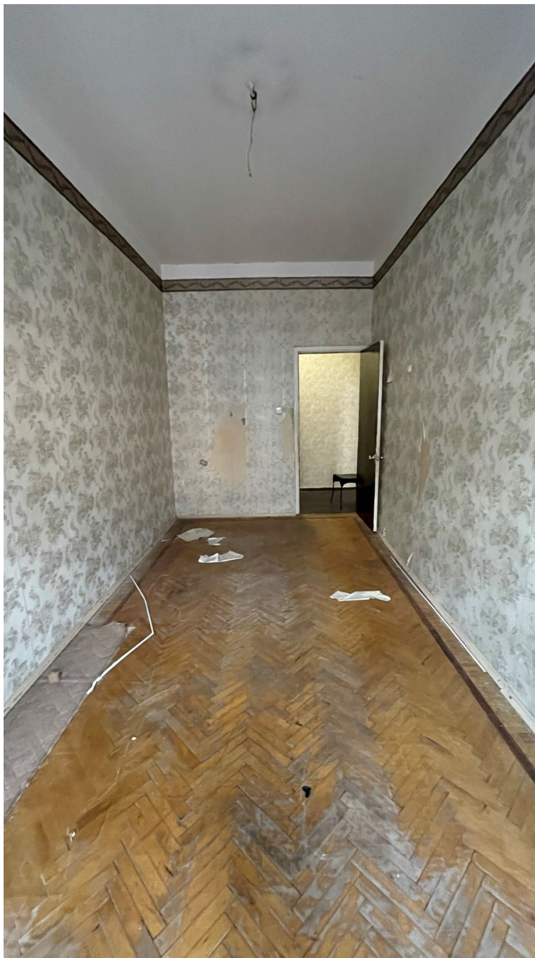
20.Фрагмент интерьера комнаты (помещение №3/17.4);
