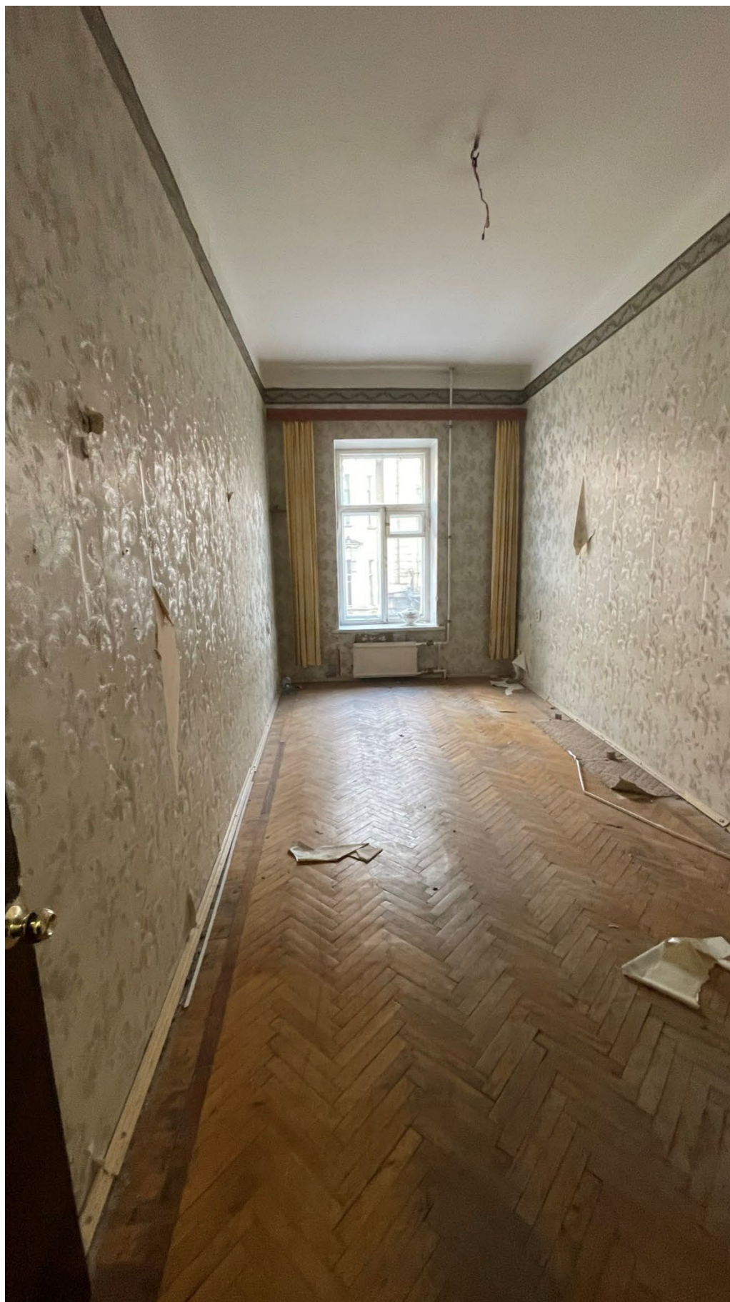
19.Фрагмент интерьера комнаты (помещение №3/17.4);
