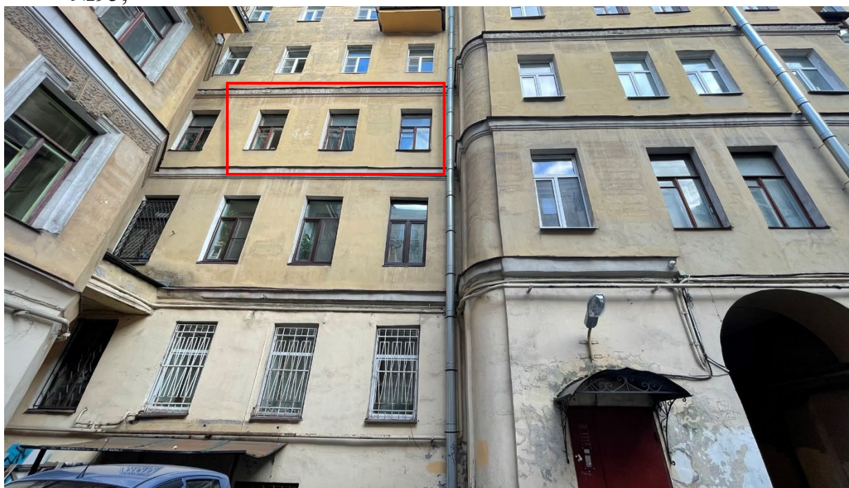
2. Вид на дворовой фасад здания и окна квартиры №95;
