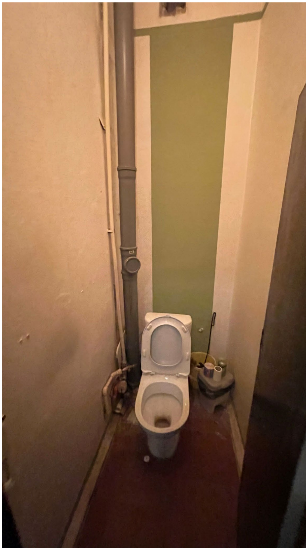
11. Фрагмент интерьера туалета (помещение №10);
