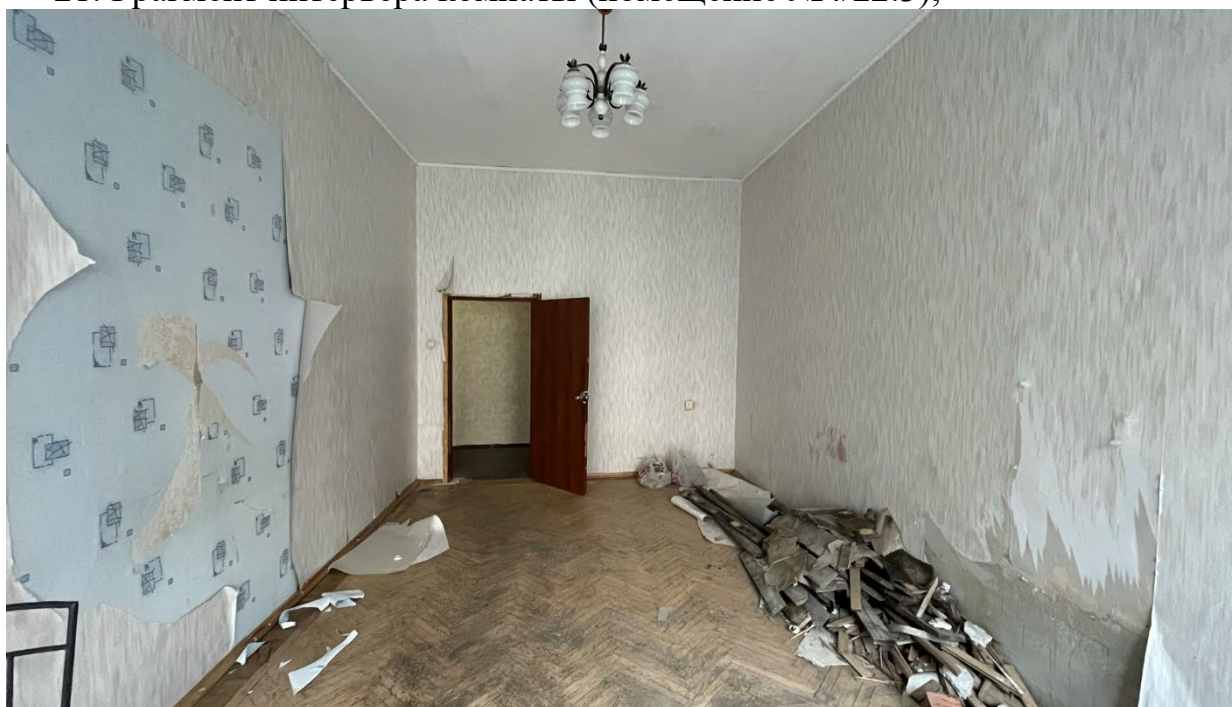
22.Фрагмент интерьера комнаты (помещение №4/22.3).
