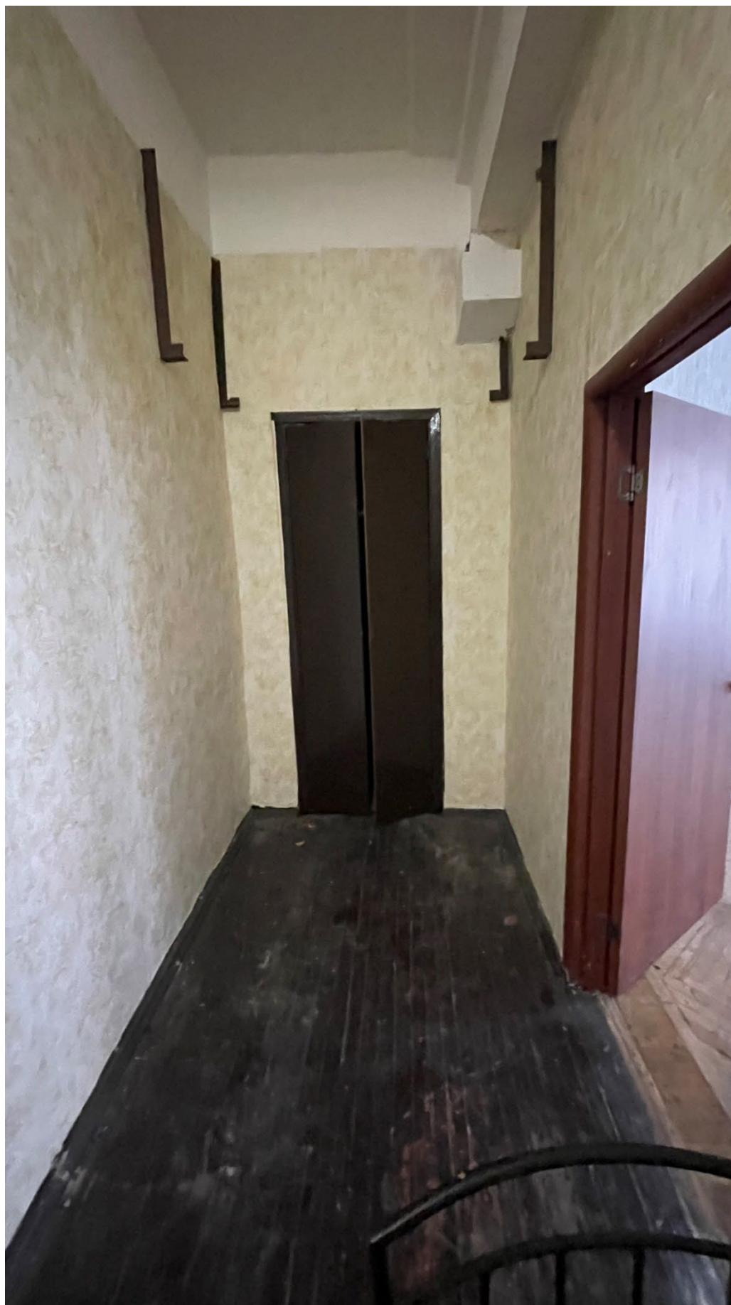
17. Фрагмент интерьера коридора (помещение 5/25.2);
