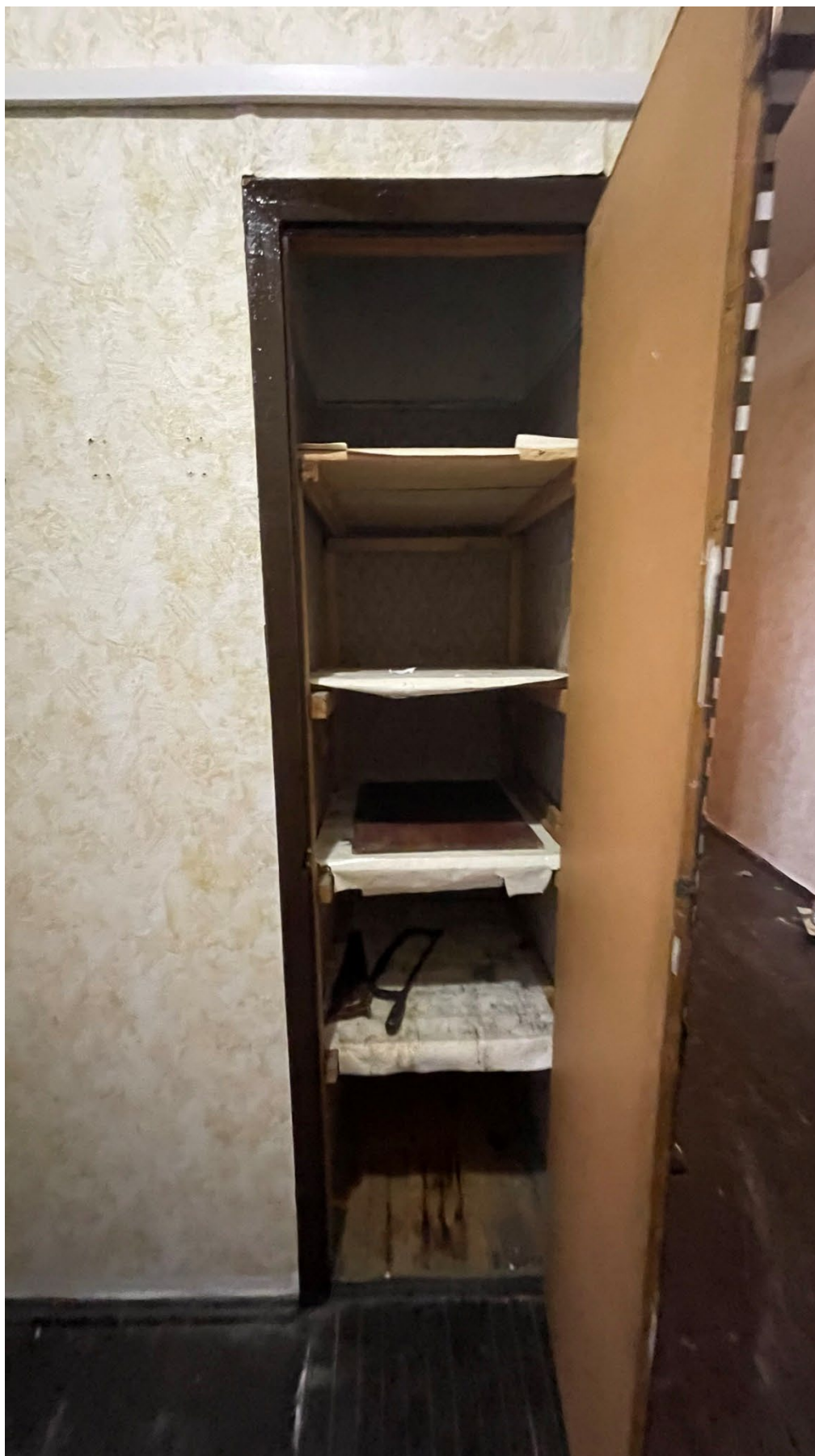
7. Вид на шкаф (помещение №7);
