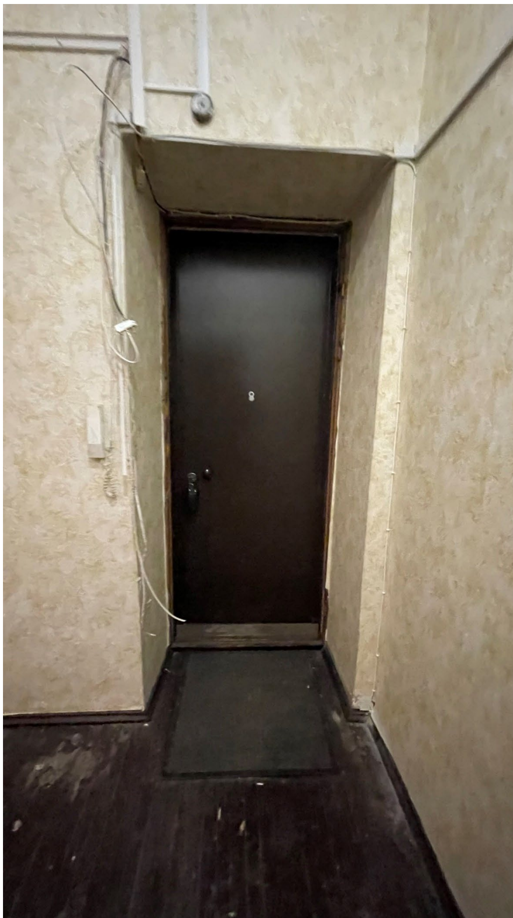
4. Вид на входную дверь в квартире;
