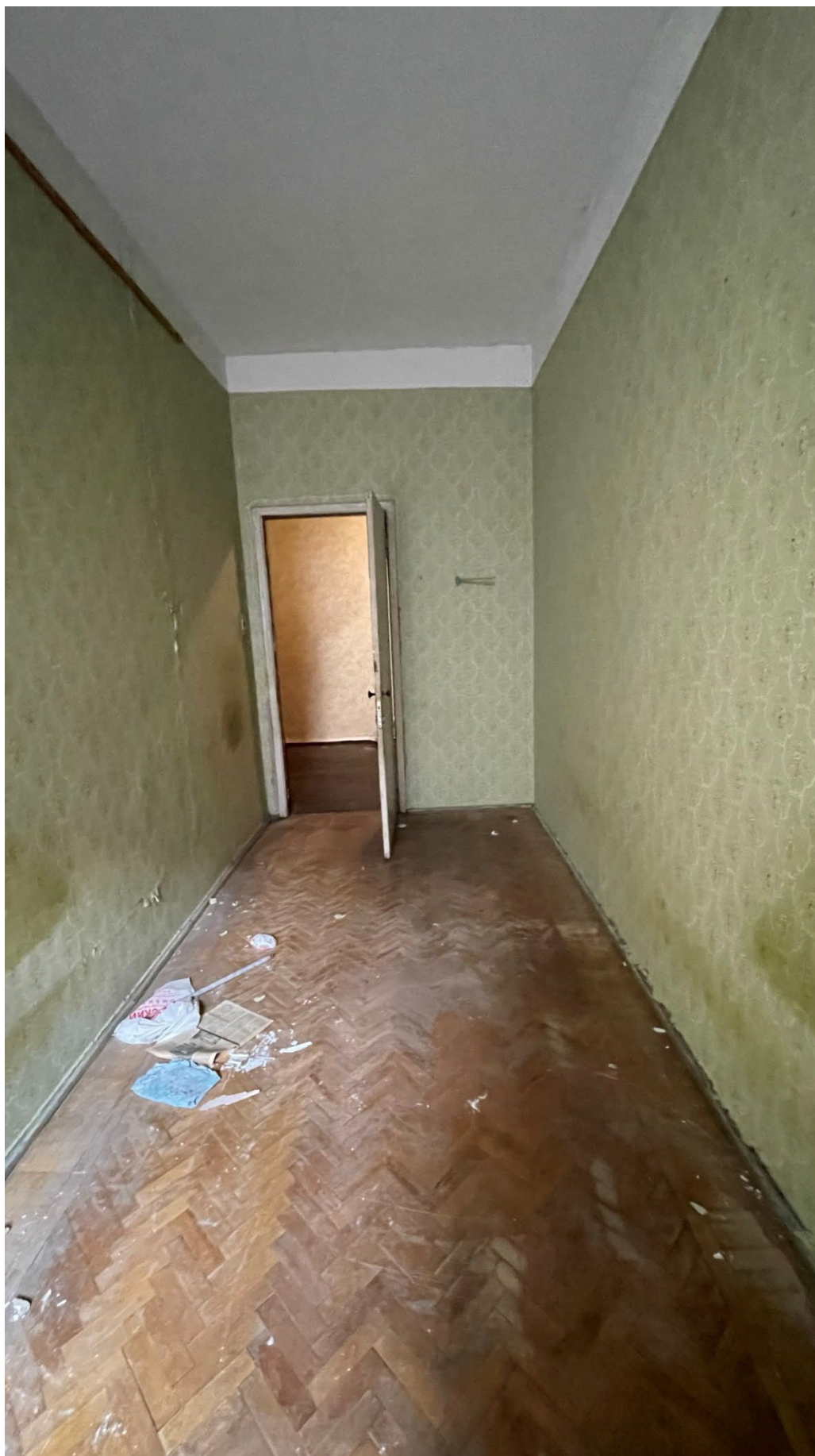
10.Фрагмент интерьера комнаты (помещение №2/11.5);
