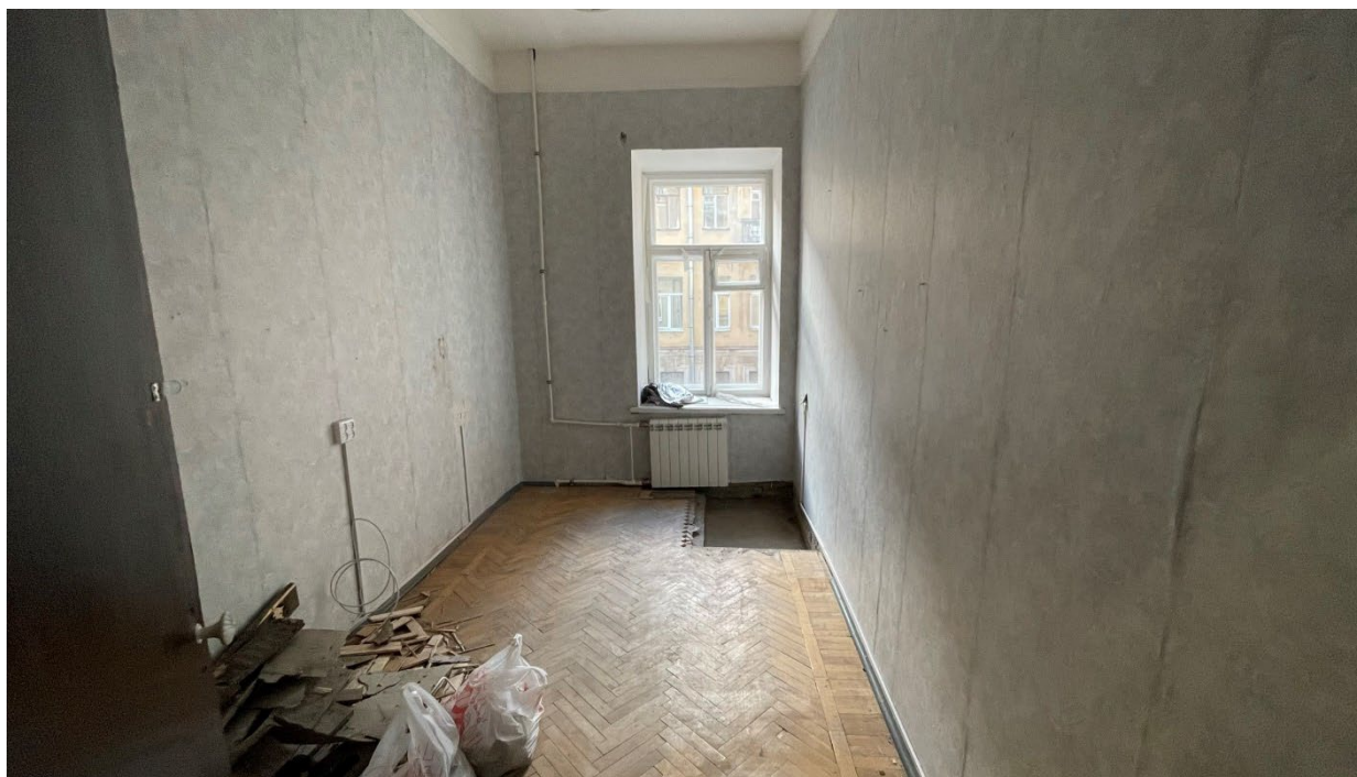
5. Фрагмент интерьера комнаты (помещение №1/10.7);
