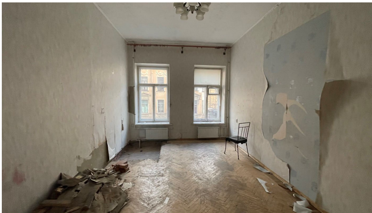
21.Фрагмент интерьера комнаты (помещение №4/22.3);
