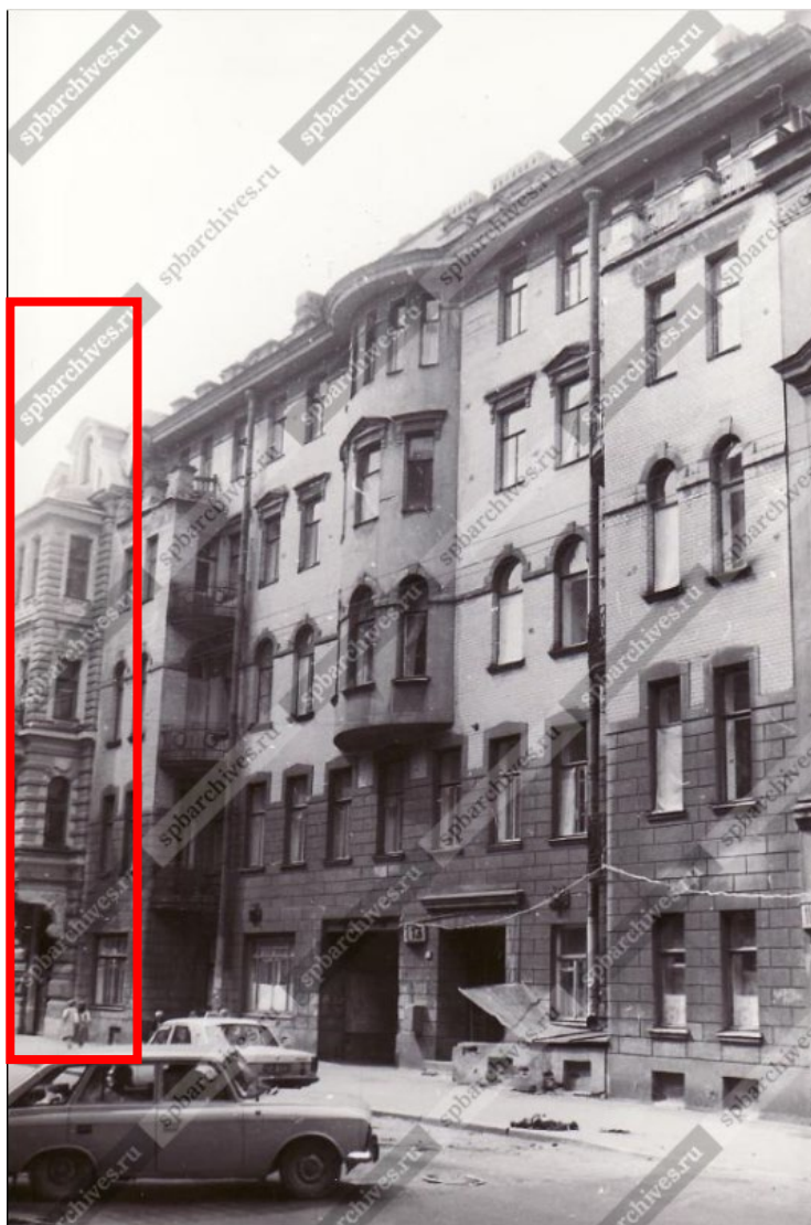
15.Общий вид центрального фасада жилого дома № 13 на улице Коломенской (архитектор Л.В.Богусский, 1912- 1913 гг. Дата съёмки: 19 июля 1992 г. Архивный шифр: ЦГАКФФД СПб Ар 212009 // Архивы Санкт-Петербурга URL: https://spbarchives.ru/infres/-/archive/cgakffd/photo/ar212009 .
