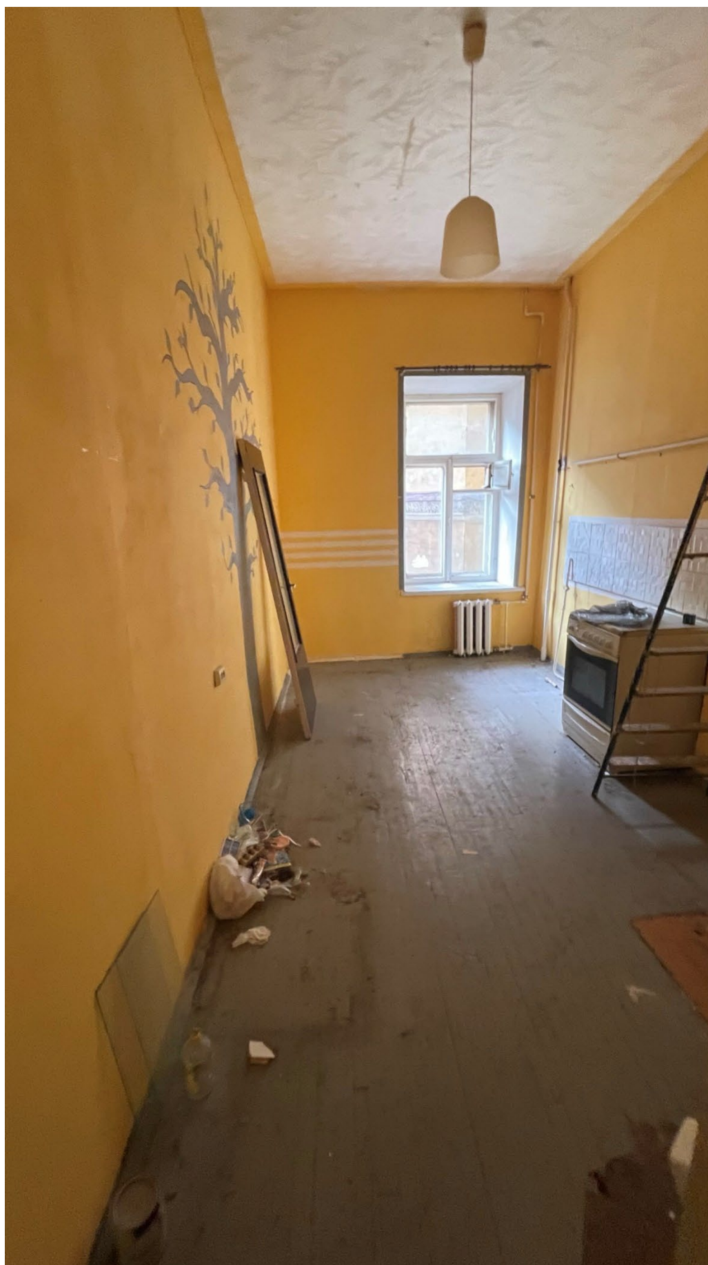
13.Фрагмент интерьера кухни (помещение №8/12.8);
