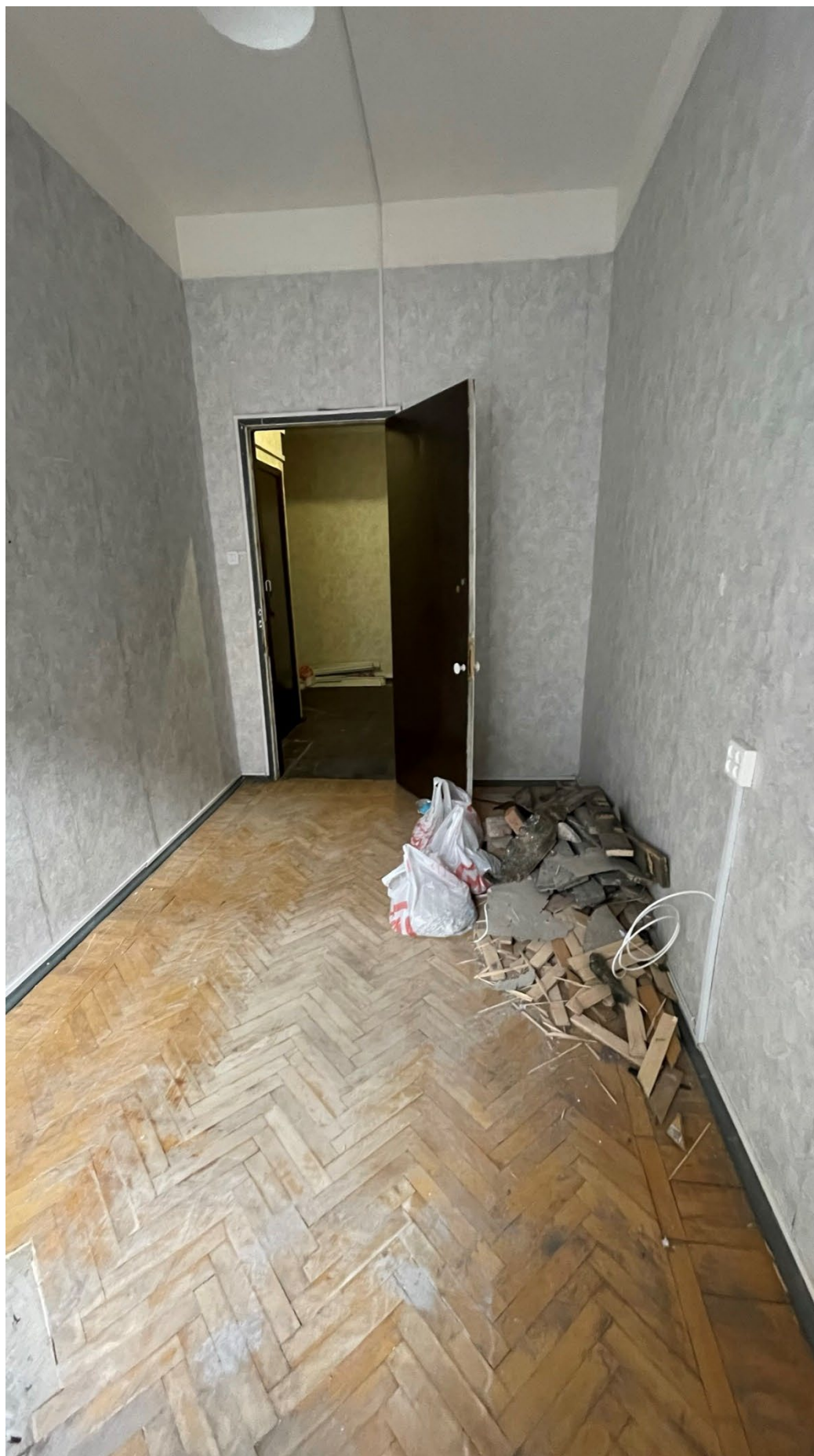
6. Фрагмент интерьера комнаты (помещение №1/10.7);
