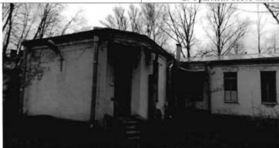
3. Фрагмент западного фасада
