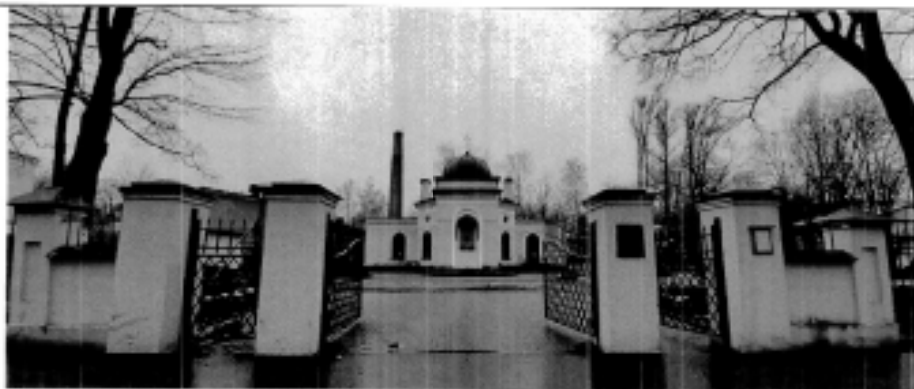
1. Фрагмент исторической ограды (в юго-восточной части территории со стороны Софийского бульвара)
