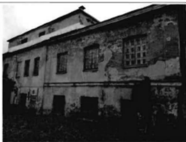
2. Фрагмент северного фасада
