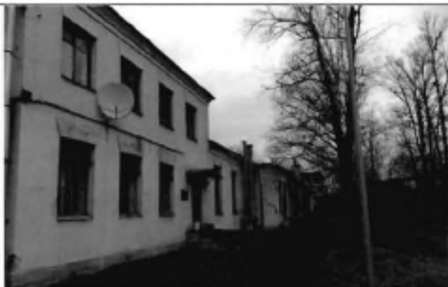
2. Фрагмент восточного фасада
