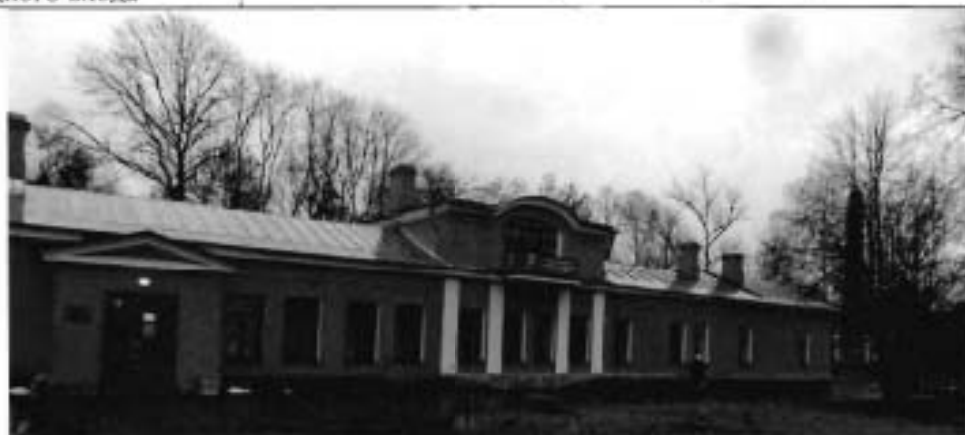
4. Южный фасад одноэтажного корпуса
