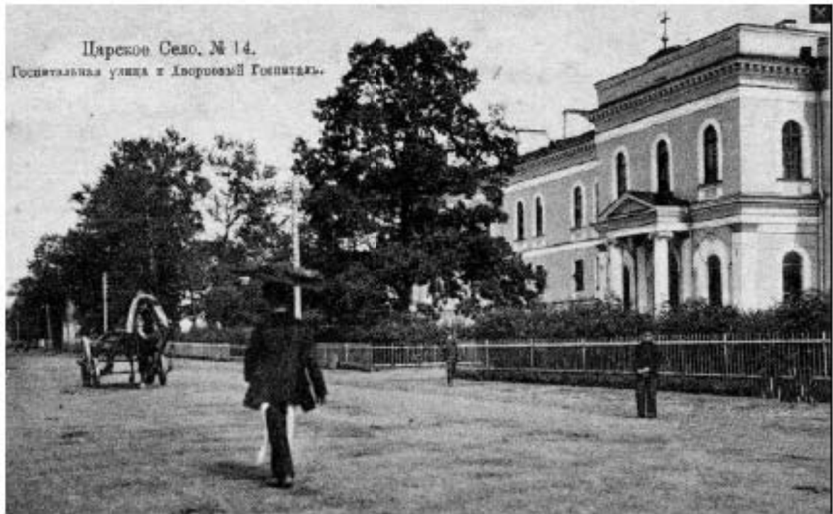
Илл. 4. Вид со стороны Госпитальной улицы на Дворцовый Госпиталь. 1900-1917 гг. Автор неизвестен. Направление съемки северо-восток. // https://pastvu.com/p/1406673
