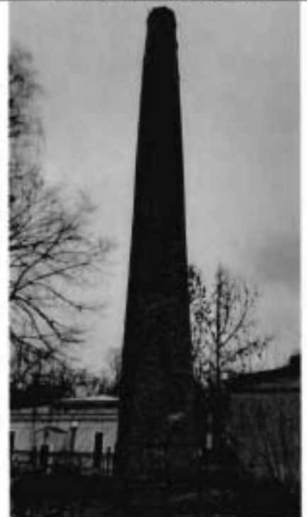
10. Историческая дымовая труба
