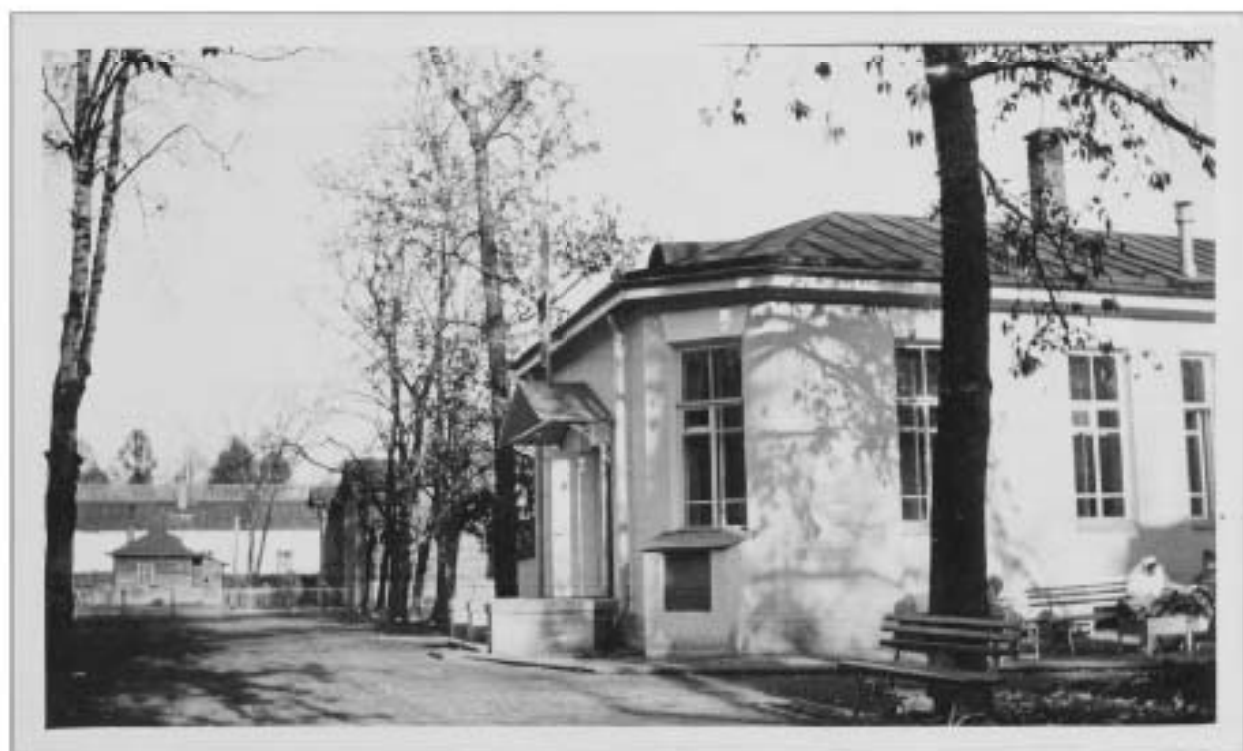
Илл. 7. Дворцовый лазарет в Царском селе 1914 г. Автор неизвестен. Направление съемки северо-восток. // https://pastvu.com/p/123230
