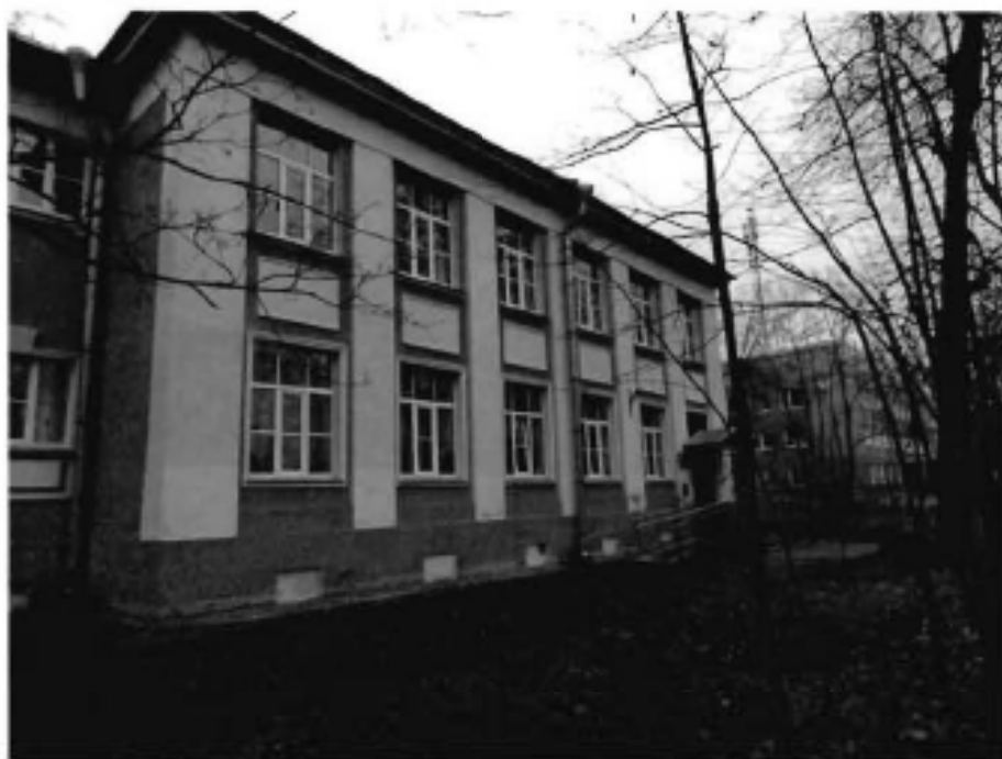
1. Фрагмент восточного фасада
