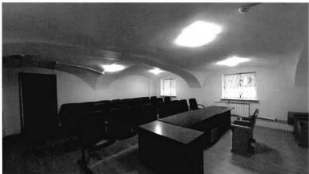
5. Своды в уровне цокольного этажа
