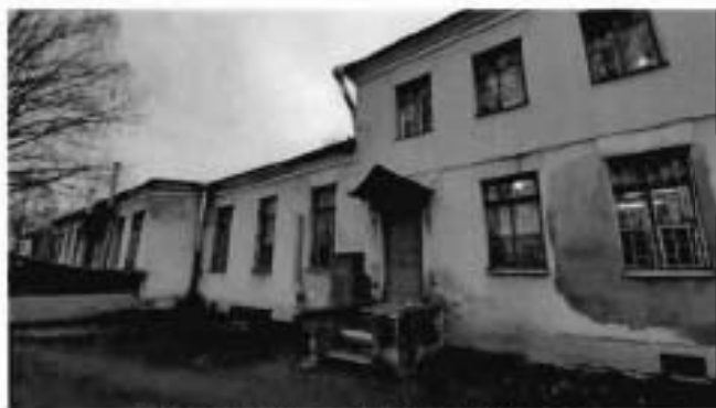
1. Фрагмент восточного фасада
