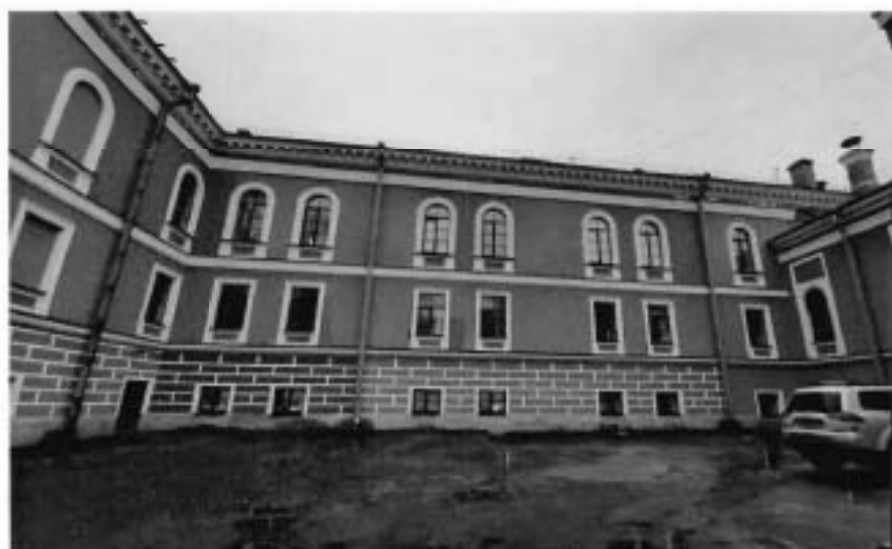
3. Фрагмент дворового фасада
