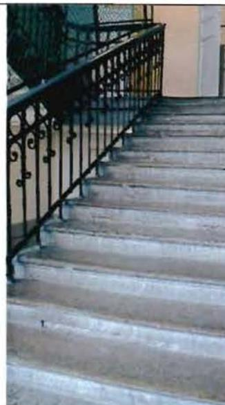
лестница парадная, 6ЛК, помещения №№ 55 (площадь 102 кв.м.), 108 (площадь 116,9 кв.м.) – конструкция (многомаршевая) распашная; на косоурах; ограждение в виде балясин; с боковыми галереями, отделенными от основного пространства арками на пилонах с ограждением в виде балясин;
