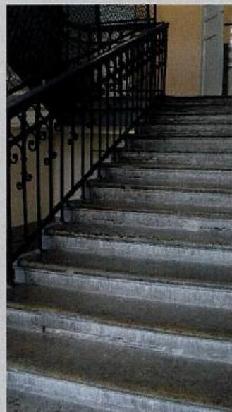
лестница парадная, 6ЛК, помещения №№ 55 (площадь 102 кв.м.), 108 (площадь 116,9 кв.м.) – конструкция (многомаршевая) распашная; на косоурах; ограждение в виде балясин; с боковыми галереями, отделенными от основного пространства арками на пилонах с ограждением в виде балясин;
