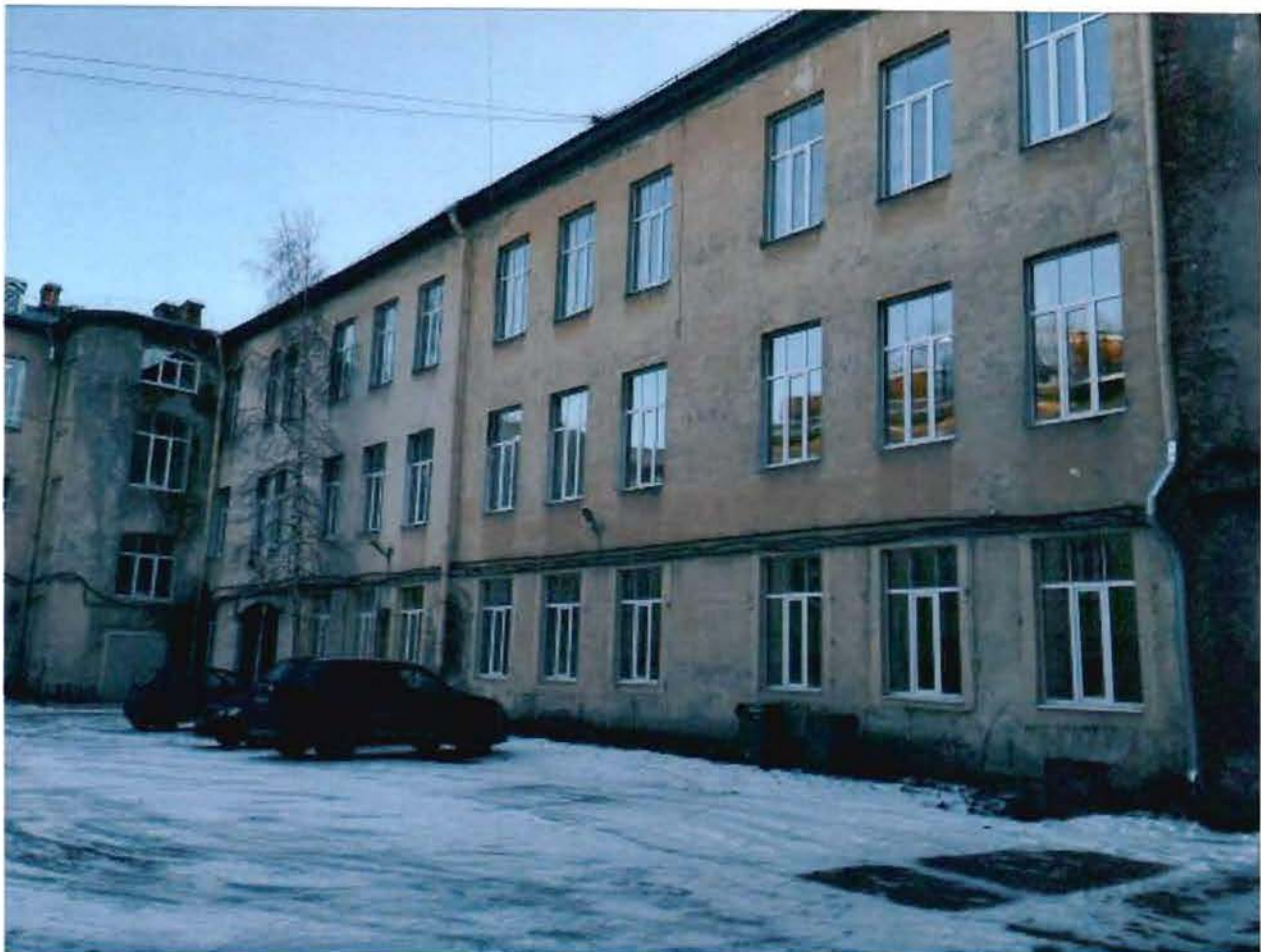
Фото 9. Дворовый фасад (южный).
