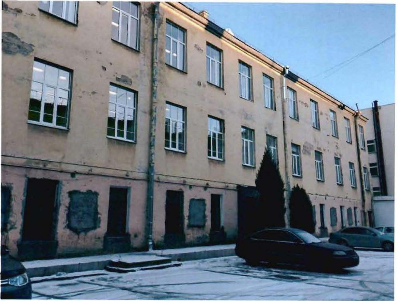
Фото 11. Дворовый фасад (северный).
