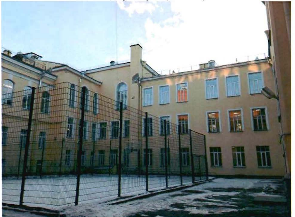
Фото 6. Дворовый фасад (южный).
