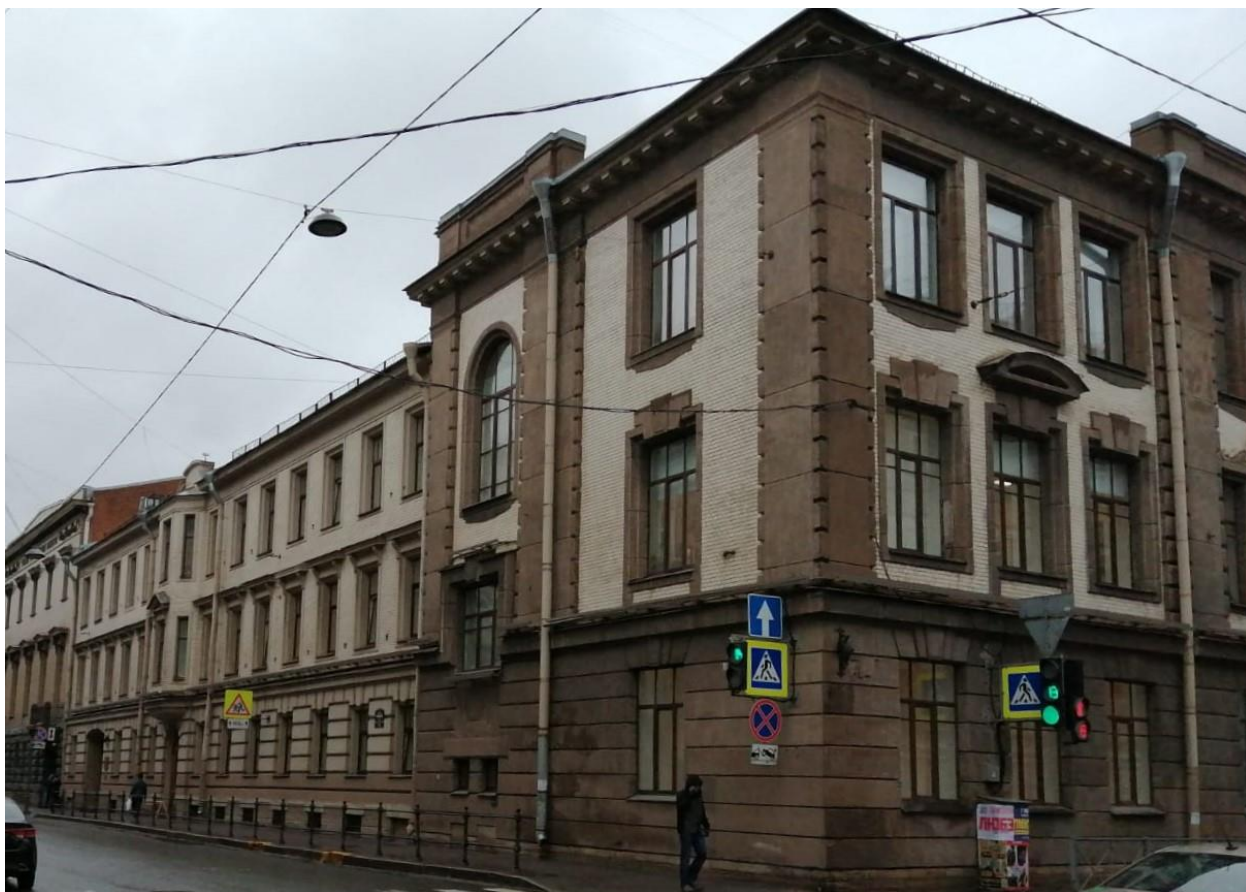
Фото 2. Объект культурного наследия регионального значения «Здание второй гимназии императора Александра I с жилым домом», Санкт-Петербург, Казанская улица, дом 27, литера А. Фасад по переулку Гривцова.
