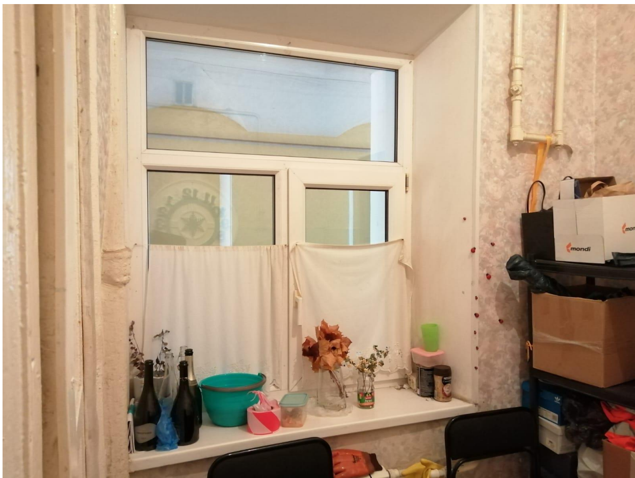
Фото 8. Объект культурного наследия регионального значения «Здание второй гимназии императора Александра I с жилым домом», Санкт-Петербург, Казанская улица, дом 27, литера А. Квартира 1, помещение 1. Заполнение оконного проема, выходящего в арочный проезд.
