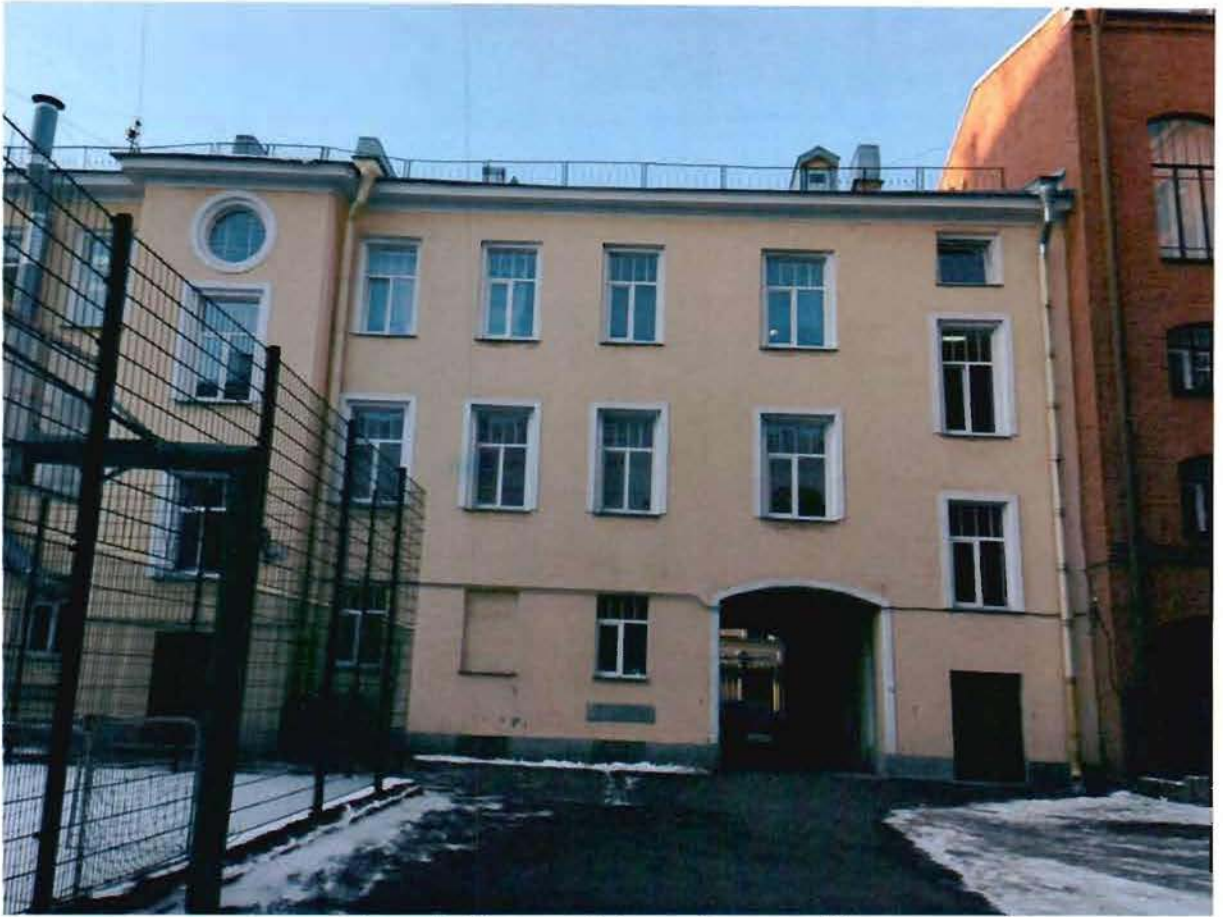
Фото 7. Дворовый фасад (западный).
