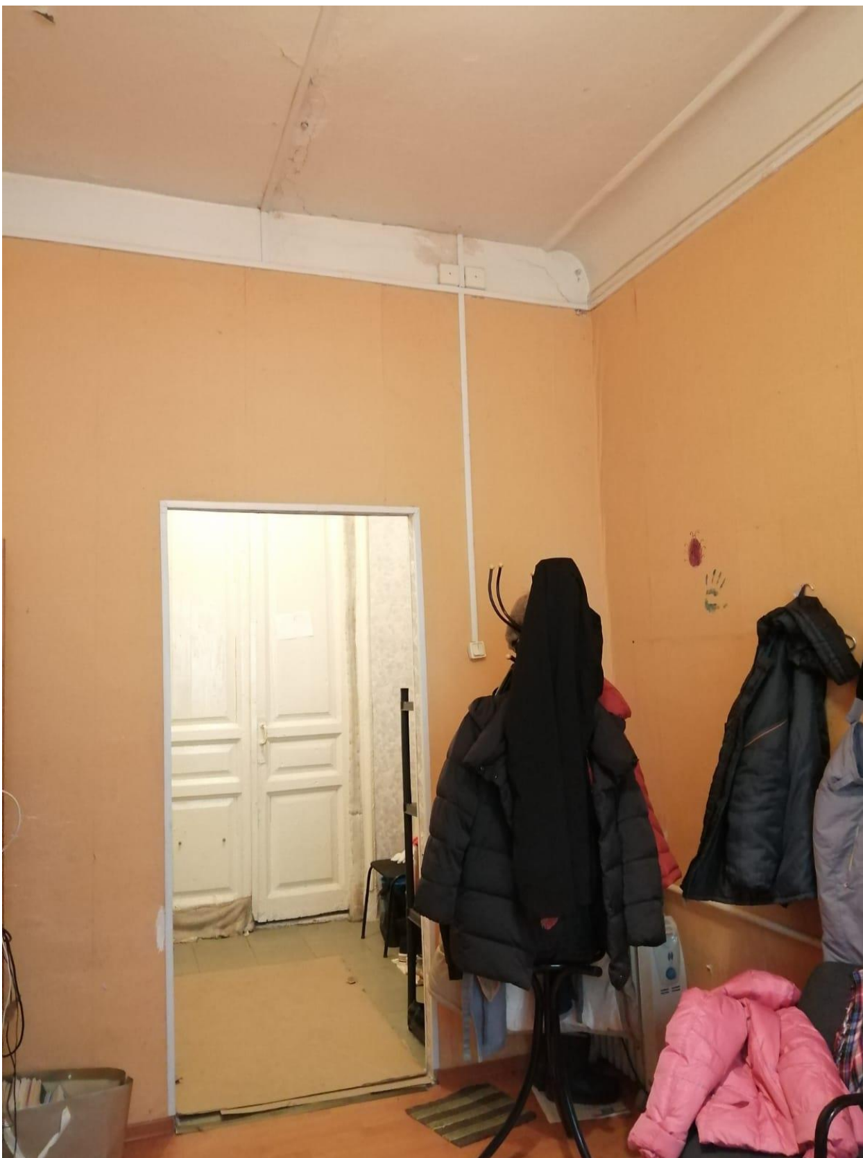
Фото 7. Объект культурного наследия регионального значения «Здание второй гимназии императора Александра I с жилым домом», Санкт-Петербург, Казанская улица, дом 27, литера А. Квартира 1, помещение 3. Ненесущая перегородка между помещением 2 и помещением 1.
