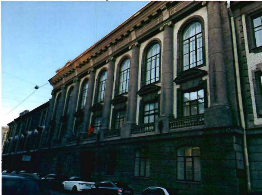
Фото 2. Часть южного фасада.
