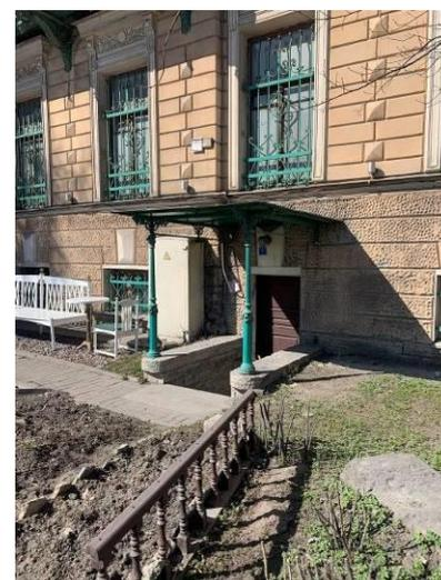
историческое деревянное дверное заполнение и тамбур парадного входа (двустворчатое, полусветлое, с прямоугольной фрамугой, с нижними фигурными филенками и малыми филенками, украшенными провисающими гирляндами, с нижним краем, обитым латунным листом;
