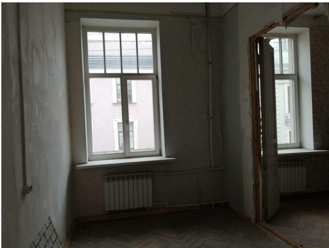
Фото 23. Объект культурного наследия регионального значения «Здание второй гимназии императора Александра I с жилым домом», Санкт-Петербург, Казанская улица, дом 27, литера А. Квартира 3, помещение 15. Заполнение оконного проема.
