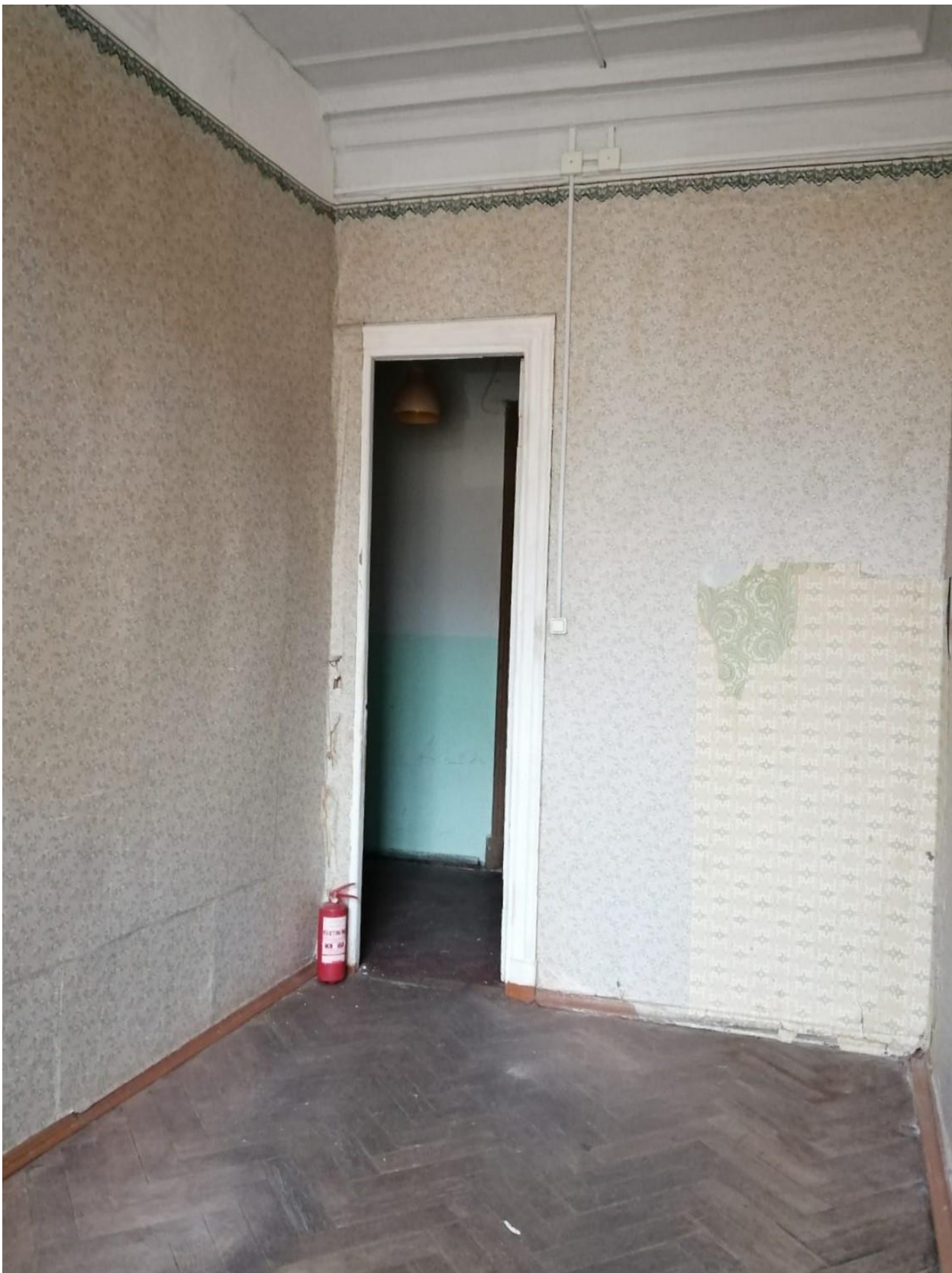
Фото 12. Объект культурного наследия регионального значения «Здание второй гимназии императора Александра I с жилым домом», Санкт-Петербург, Казанская улица, дом 27, литера А. Квартира 3, помещение 6.
