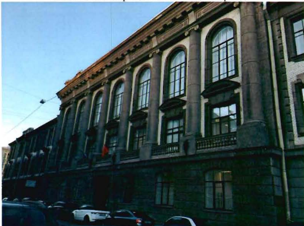
Фото 2. Часть южного фасада.
