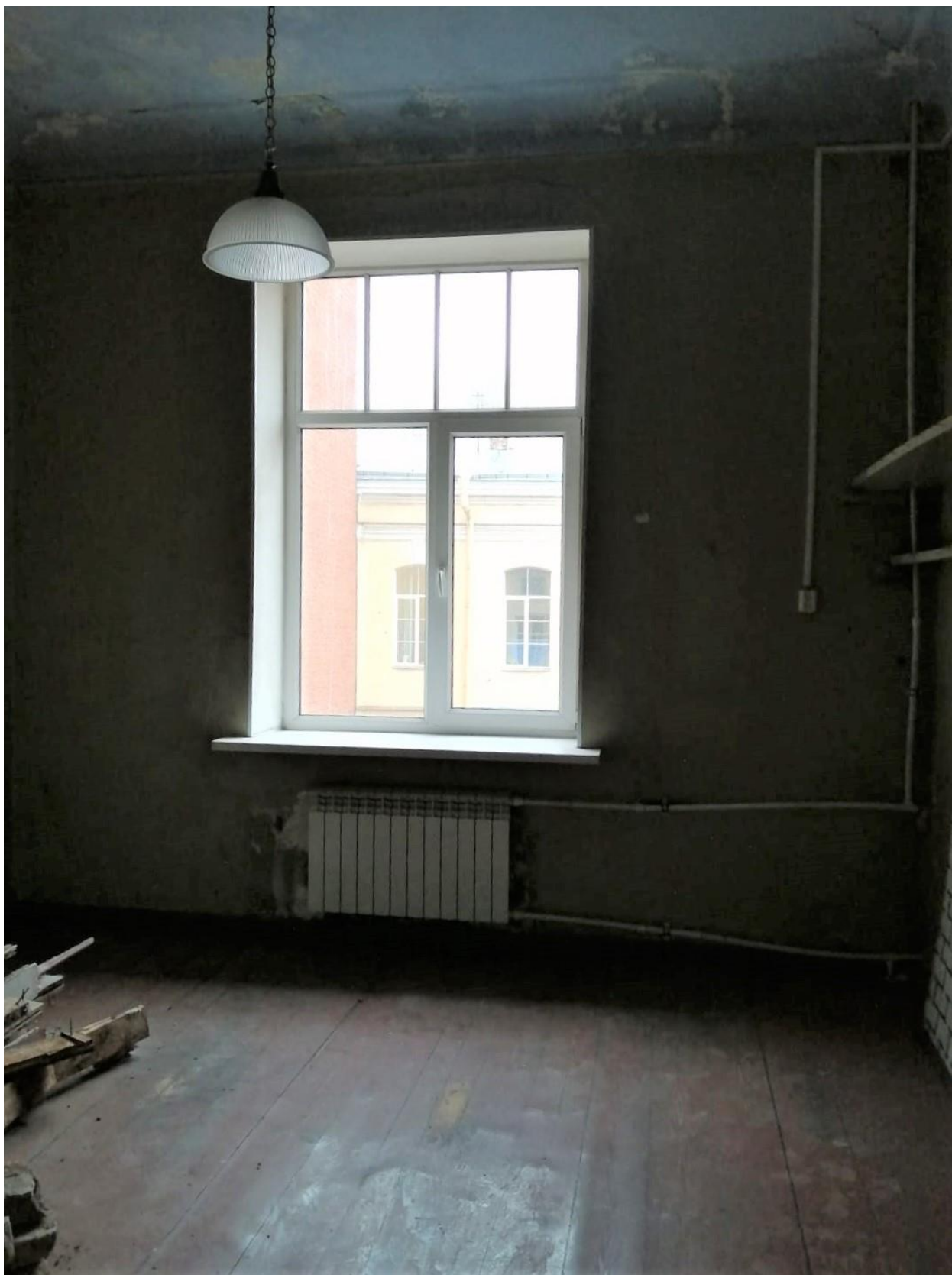
Фото 8. Объект культурного наследия регионального значения «Здание второй гимназии императора Александра I с жилым домом», Санкт-Петербург, Казанская улица, дом 27, литера А. Квартира 3, помещение 2. Заполнение оконного проема.
