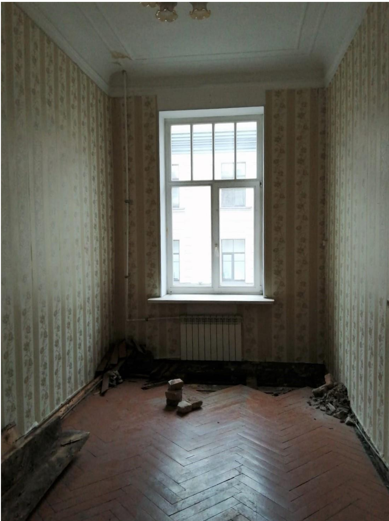
Фото 18. Объект культурного наследия регионального значения «Здание второй гимназии императора Александра I с жилым домом», Санкт-Петербург, Казанская улица, дом 27, литера А. Квартира 3, помещение 12. Заполнение оконного проема.
