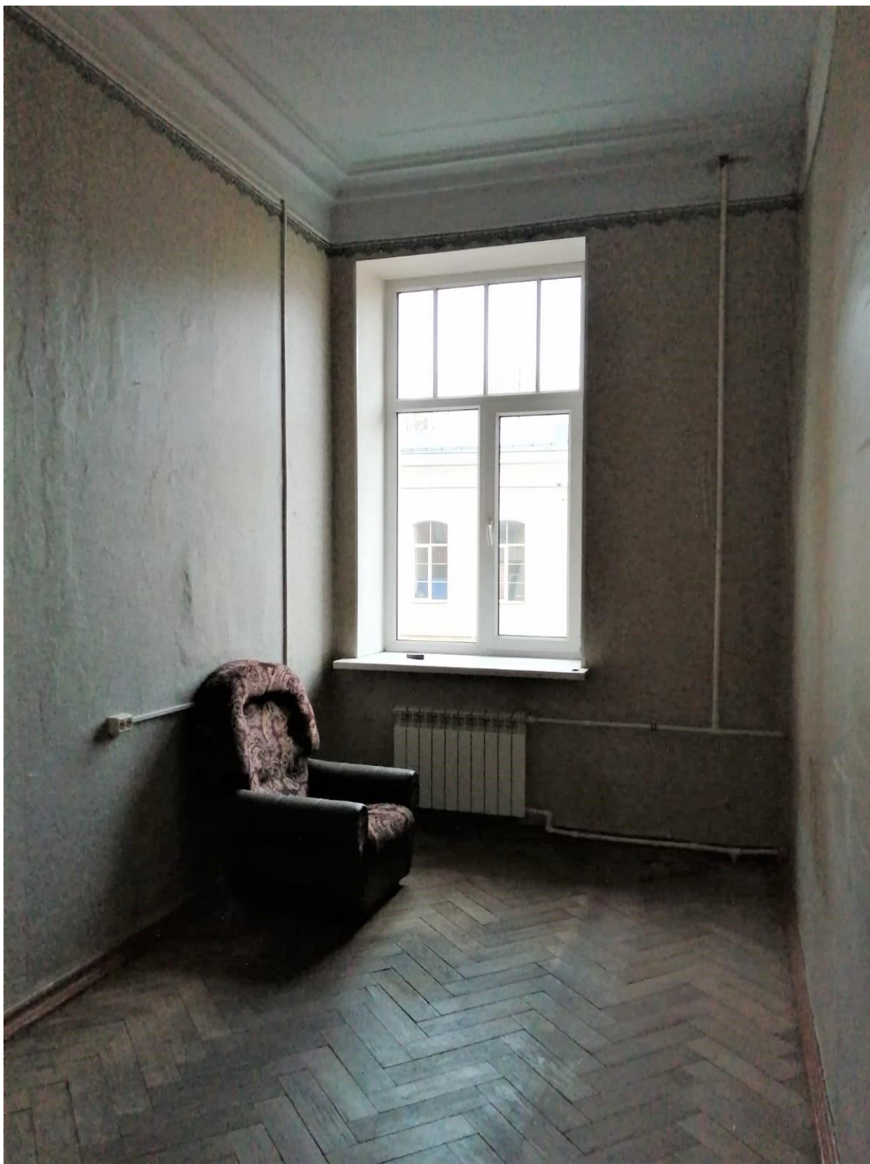
Фото 11. Объект культурного наследия регионального значения «Здание второй гимназии императора Александра I с жилым домом», Санкт-Петербург, Казанская улица, дом 27, литера А. Квартира 3, помещение 6. Заполнение оконного проема.
