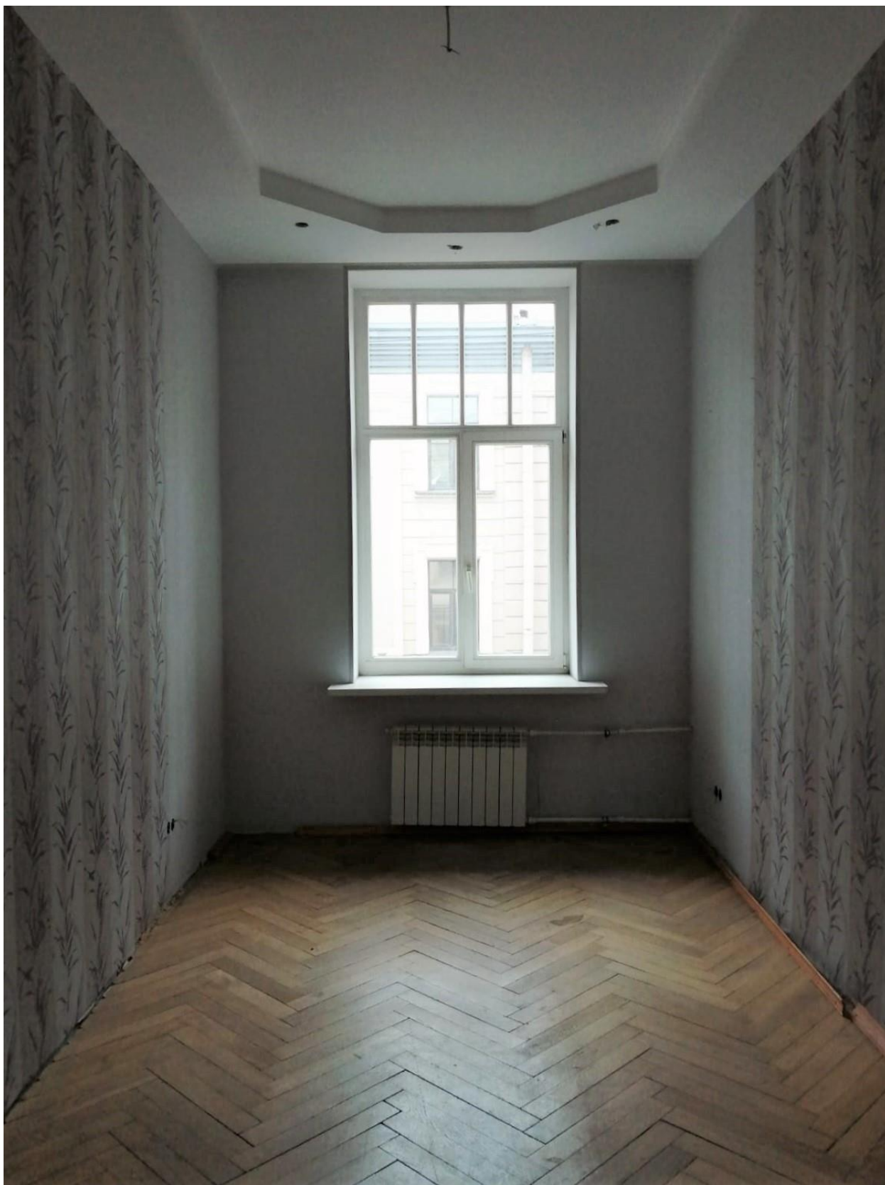
Фото 16. Объект культурного наследия регионального значения «Здание второй гимназии императора Александра I с жилым домом», Санкт-Петербург, Казанская улица, дом 27, литера А. Квартира 3, помещение 11. Заполнение оконного проема.
