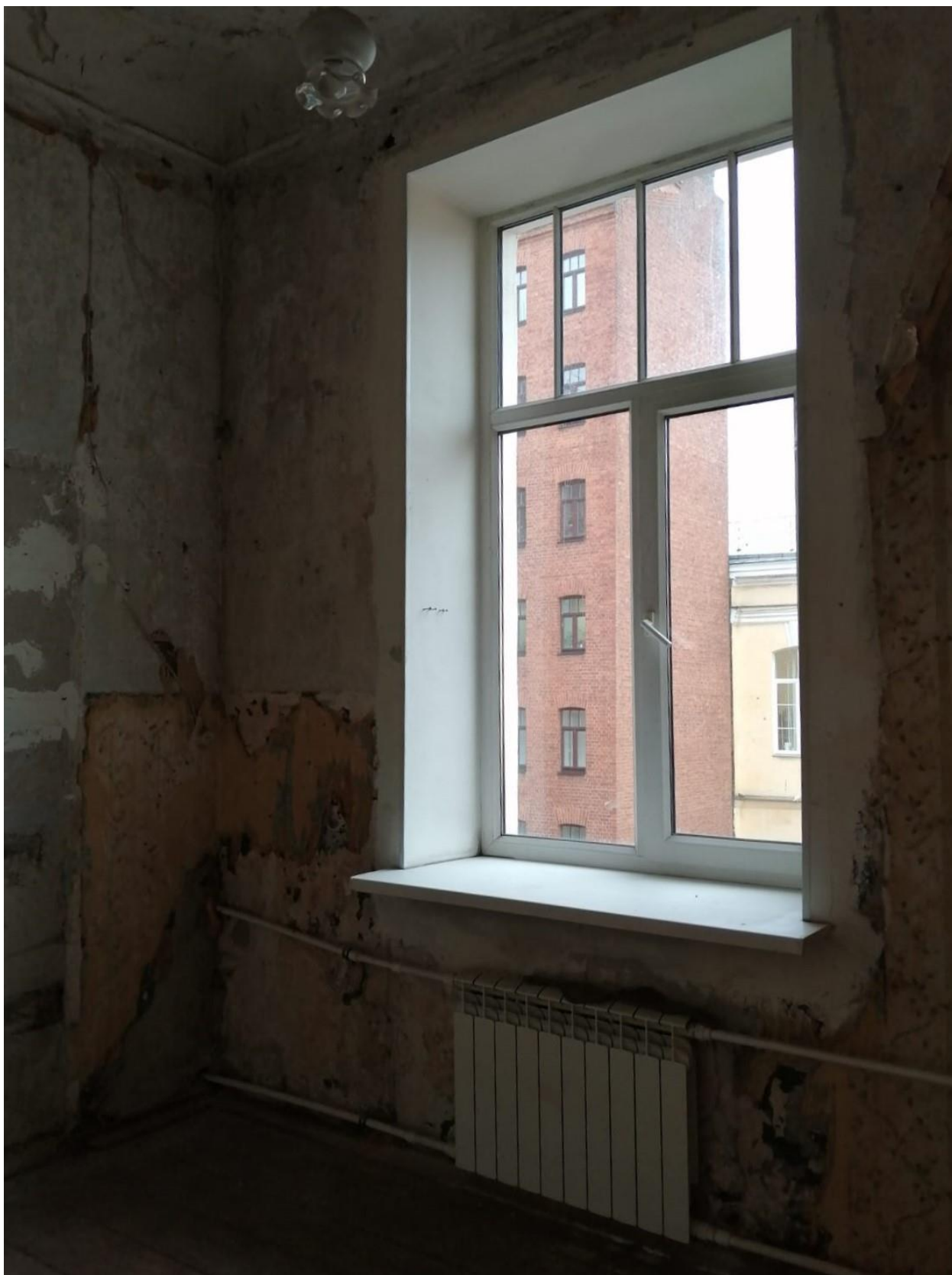
Фото 9. Объект культурного наследия регионального значения «Здание второй гимназии императора Александра I с жилым домом», Санкт-Петербург, Казанская улица, дом 27, литера А. Квартира 3, помещение 5. Заполнение оконного проема.
