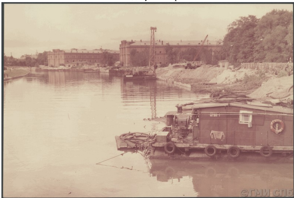
20. Строительство набережной реки Кронверки, 1978-1979 гг. – Госкаталог – Фотодокумент ГМИ СПб Инв. №-II-Б-40543 ф
