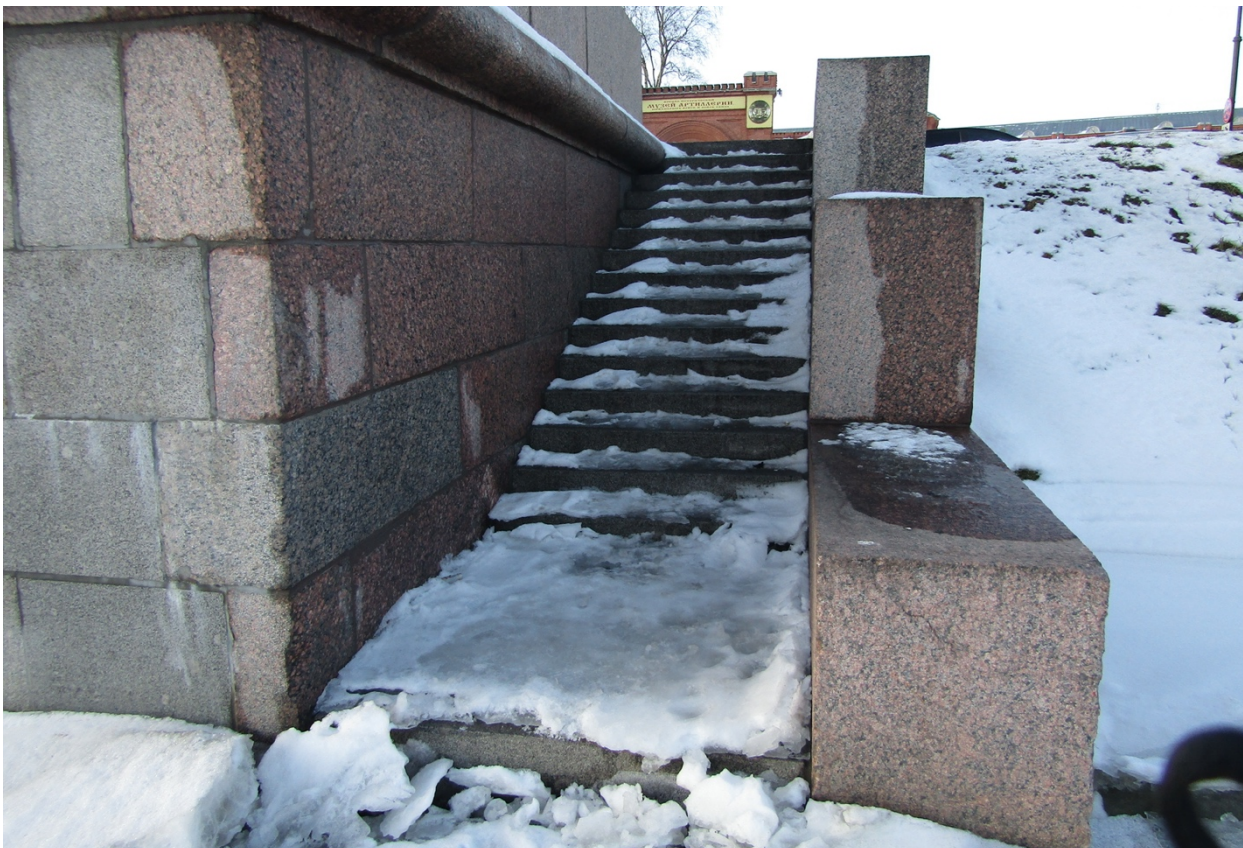
Фото 7. Вид на лестницу спуска объекта культурного наследия федерального значения «Набережные Кронверкского пролива»
