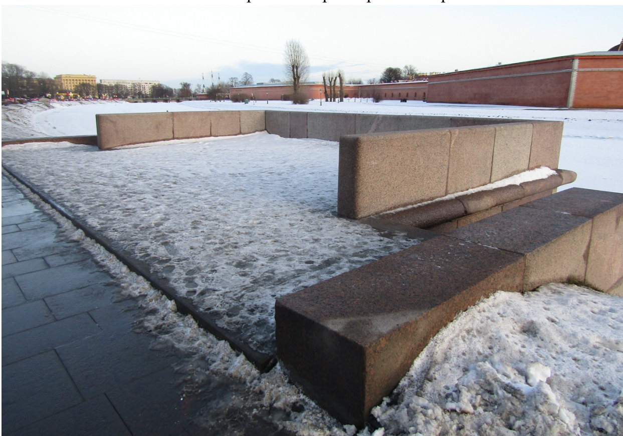
Фото 8. Вид на спуск объекта культурного наследия федерального значения «Набережные Кронверкского пролива»
