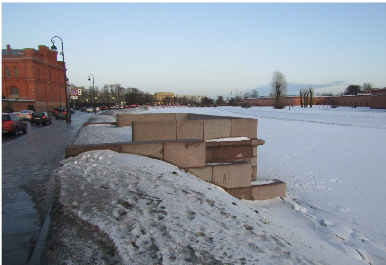
Фото 13. Вид на спуск объекта культурного наследия федерального значения «Набережные Кронверкского пролива»
