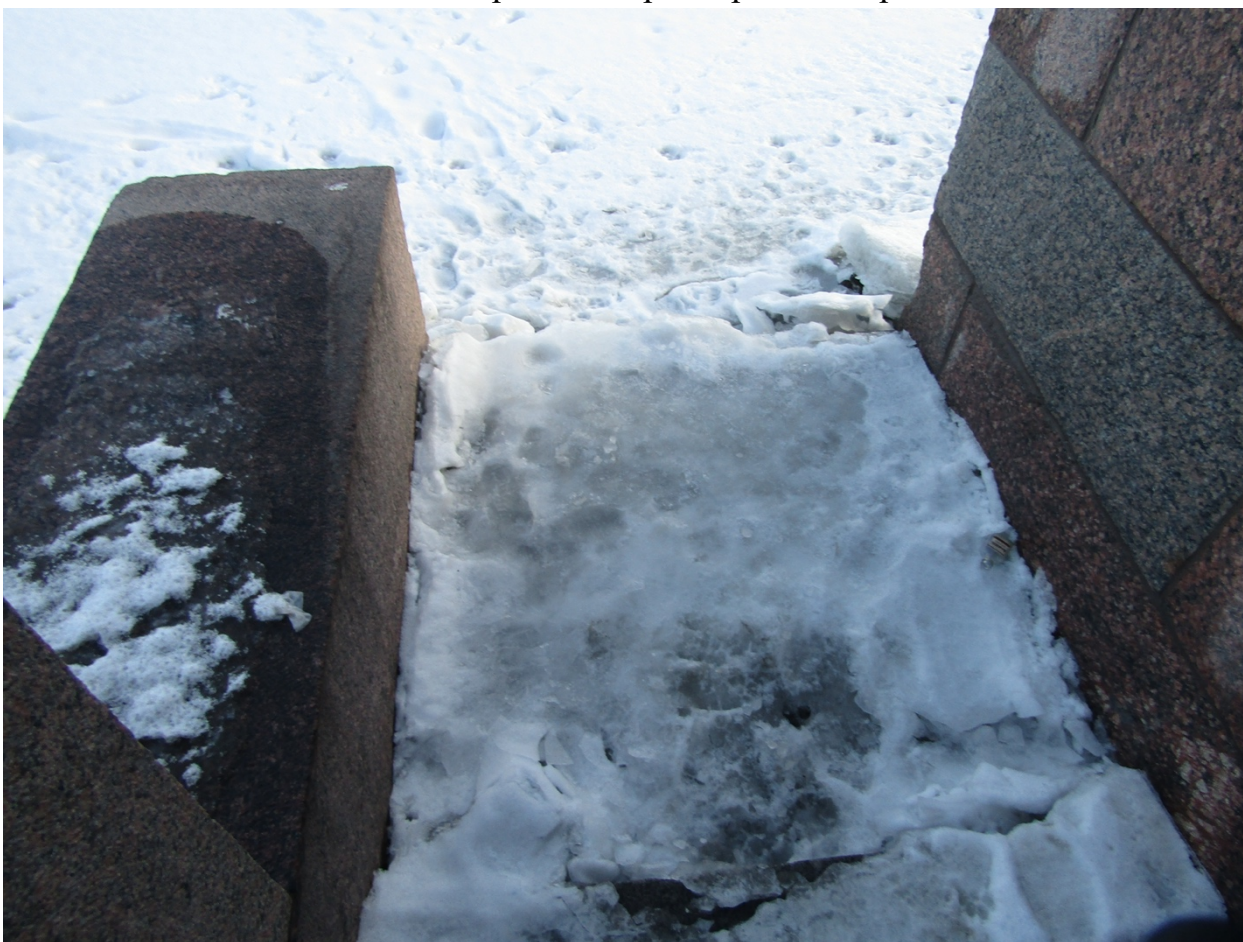
Фото 4. Вид на нижнюю площадку лестницы спуска объекта культурного наследия федерального значения «Набережные Кронверкского пролива»
