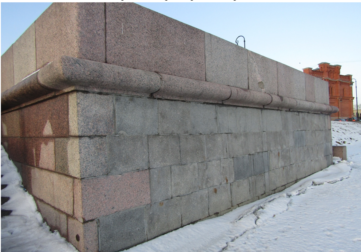
Фото 12. Вид на стенки спуска объекта культурного наследия федерального значения «Набережные Кронверкского пролива»
