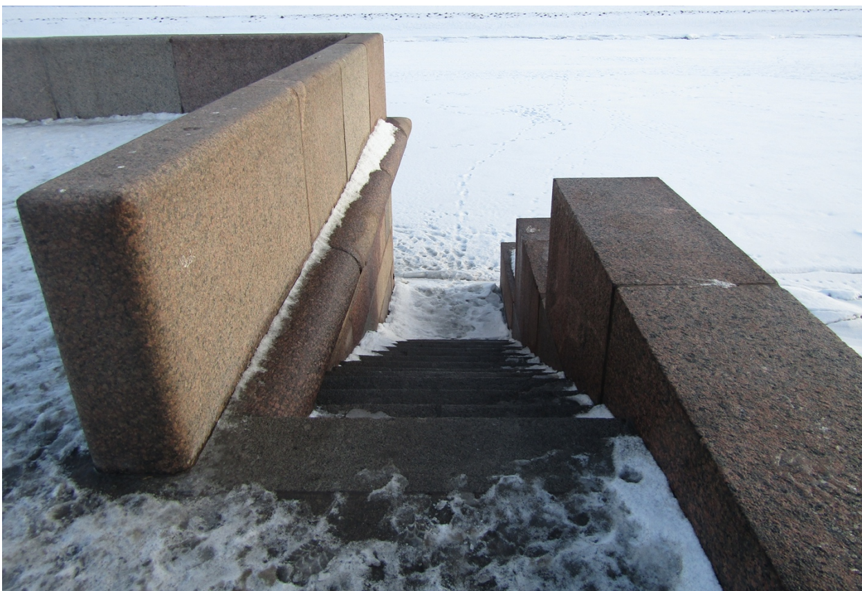
Фото 9. Вид на лестницу спуска объекта культурного наследия федерального значения «Набережные Кронверкского пролива»
