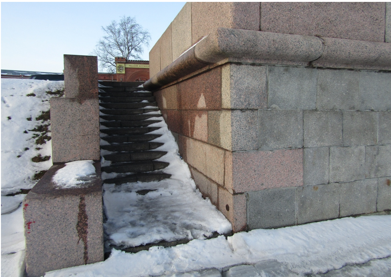
Фото 11. Вид на спуск объекта культурного наследия федерального значения «Набережные Кронверкского пролива»
