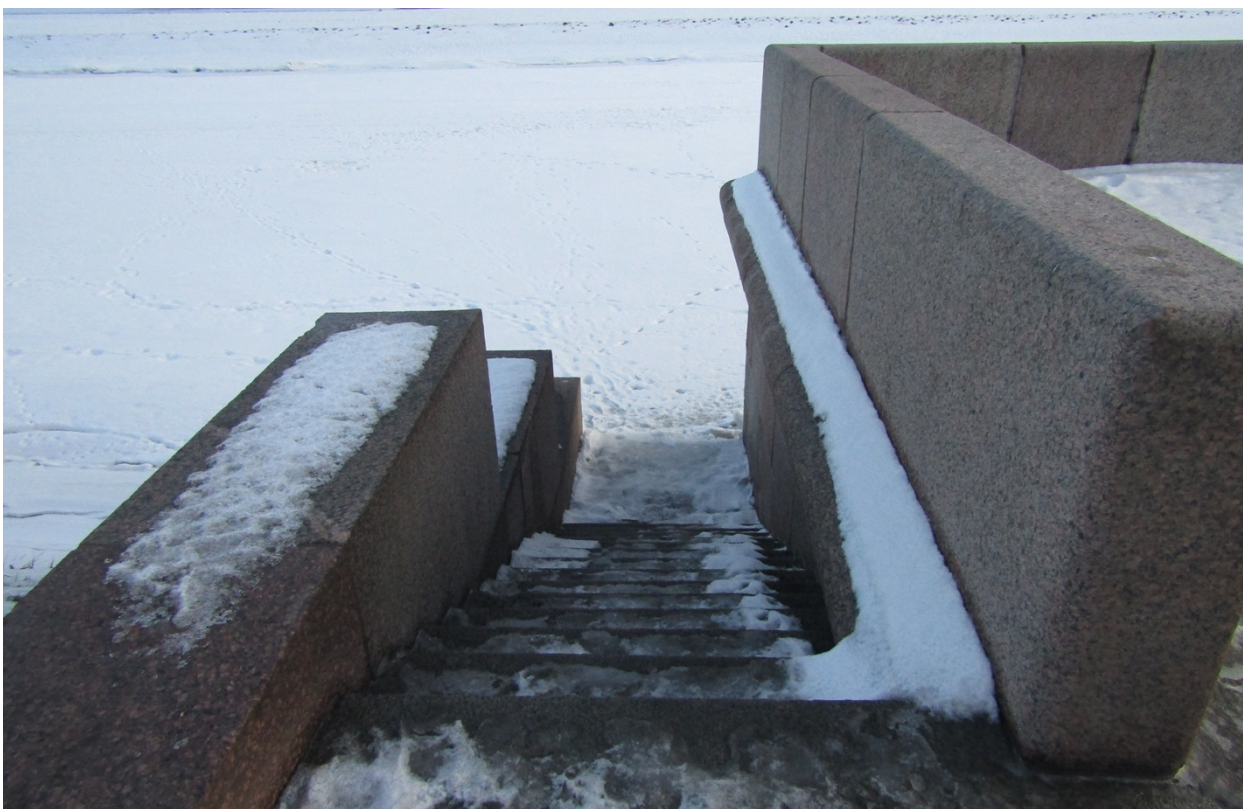
Фото 3. Вид на лестницу спуска объекта культурного наследия федерального значения «Набережные Кронверкского пролива»
