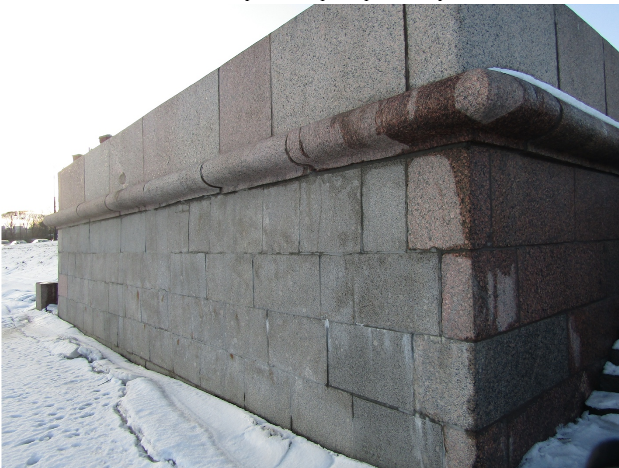
Фото 6. Вид на стенки спуска объекта культурного наследия федерального значения «Набережные Кронверкского пролива»
