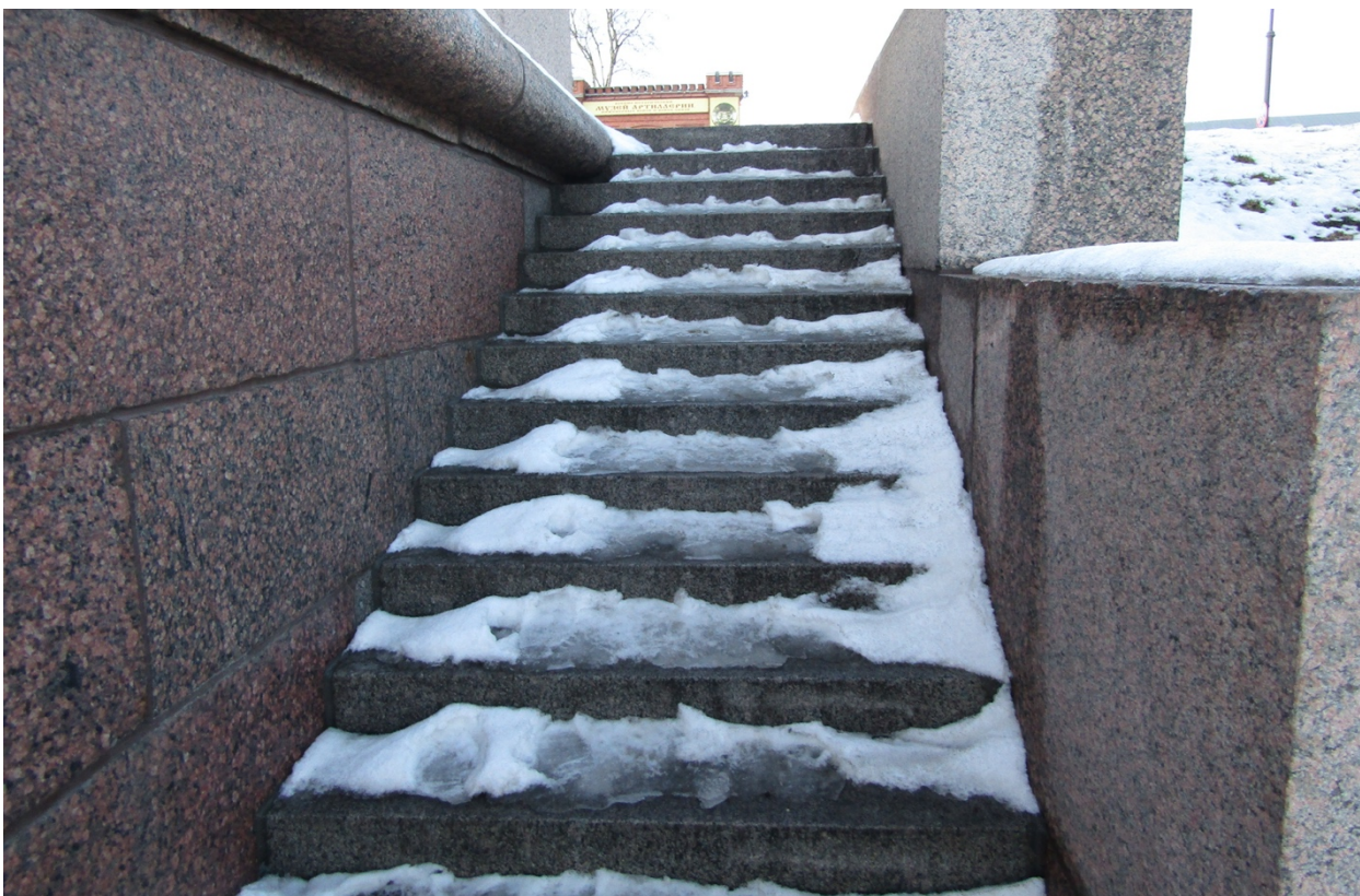
Фото 5. Вид на лестницу спуска объекта культурного наследия федерального значения «Набережные Кронверкского пролива»
