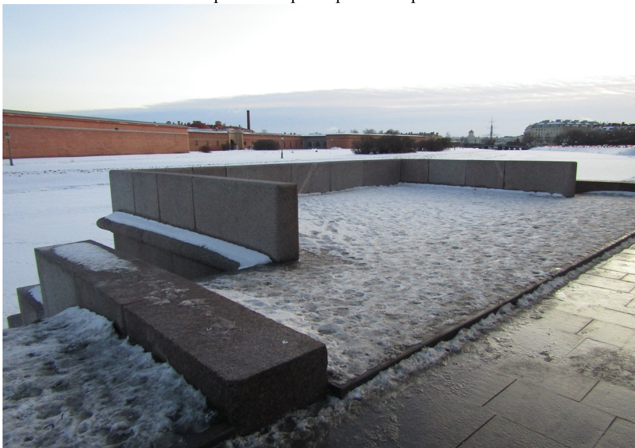
Фото 2. Вид на спуск объекта культурного наследия федерального значения «Набережные Кронверкского пролива»
