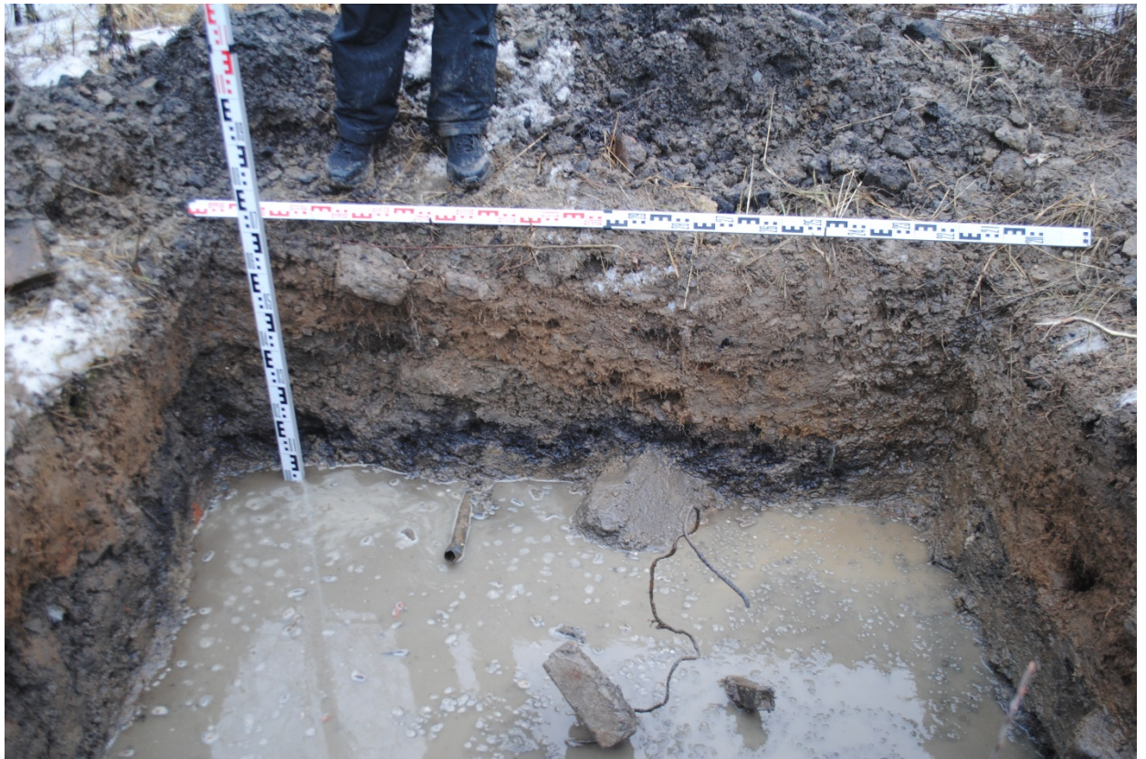
Рис. 45. Санкт-Петербург, Кубинская улица. Шурф 2. Фотофиксация стратиграфии южной стенки.
