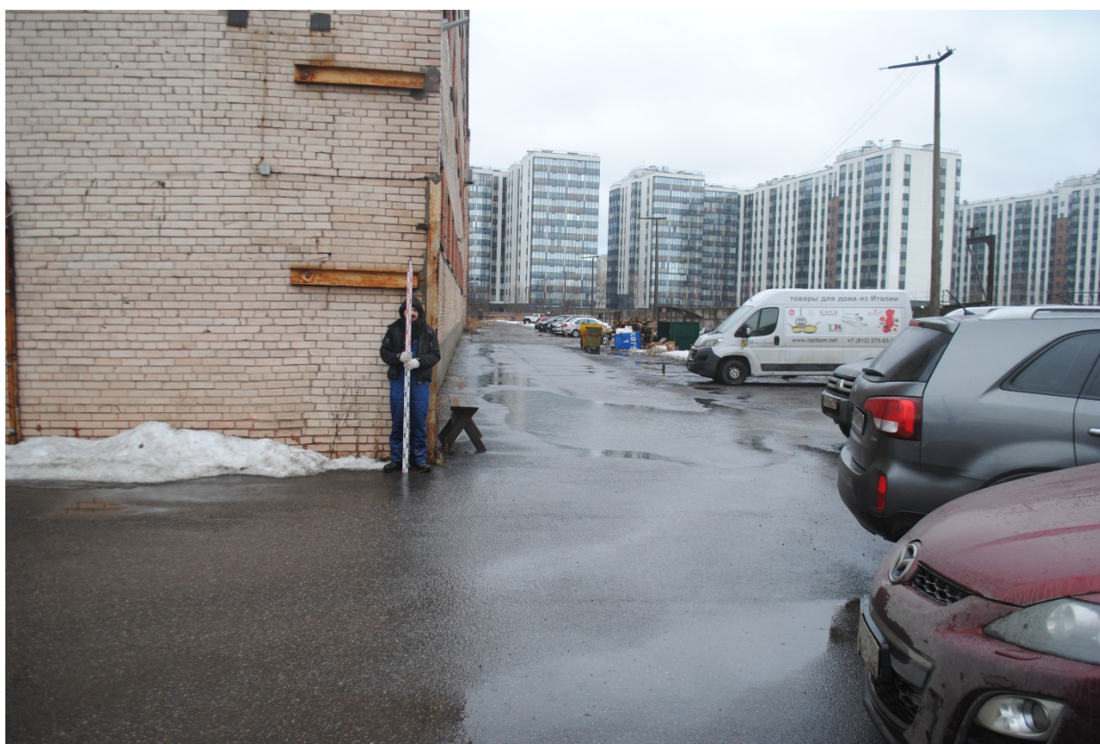
Рис. 25. Санкт-Петербург, Кубинская улица. Общий вид участка обследования. Точка съемки 7. Вид на северо-восток.
