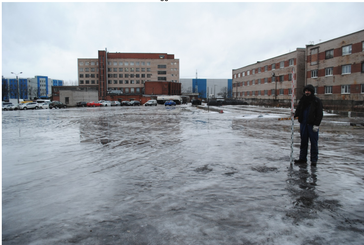
Рис. 22. Санкт-Петербург, Кубинская улица. Общий вид участка обследования. Точка съемки 4. Вид на запад.
