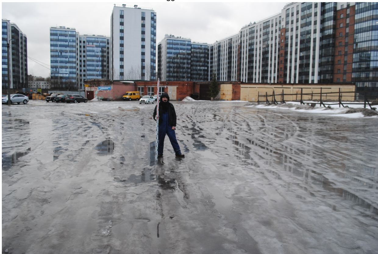
Рис. 18. Санкт-Петербург, Кубинская улица. Общий вид участка обследования. Точка съемки 3. Вид на северо-восток.
