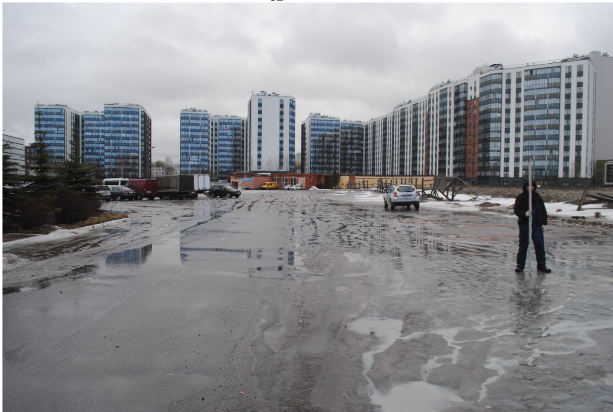
Рис. 16. Санкт-Петербург, Кубинская улица. Общий вид участка обследования. Точка съемки 2. Вид на северо-восток.
