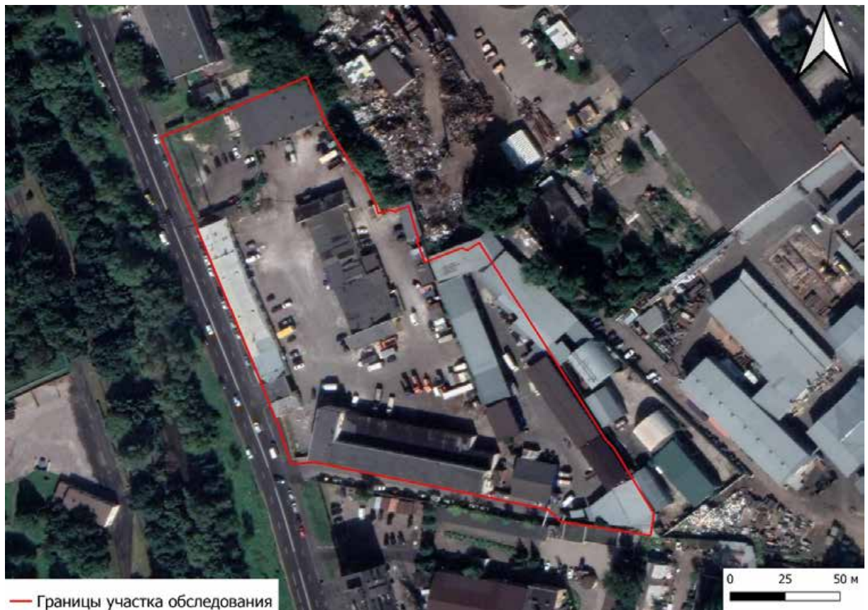
Рис. 4. Санкт-Петербург, набережная реки Волковки, земельный участок 15а (кадастровый номер: 78:13:0007322:1753). Расположение участка обследования на спутниковом снимке.
