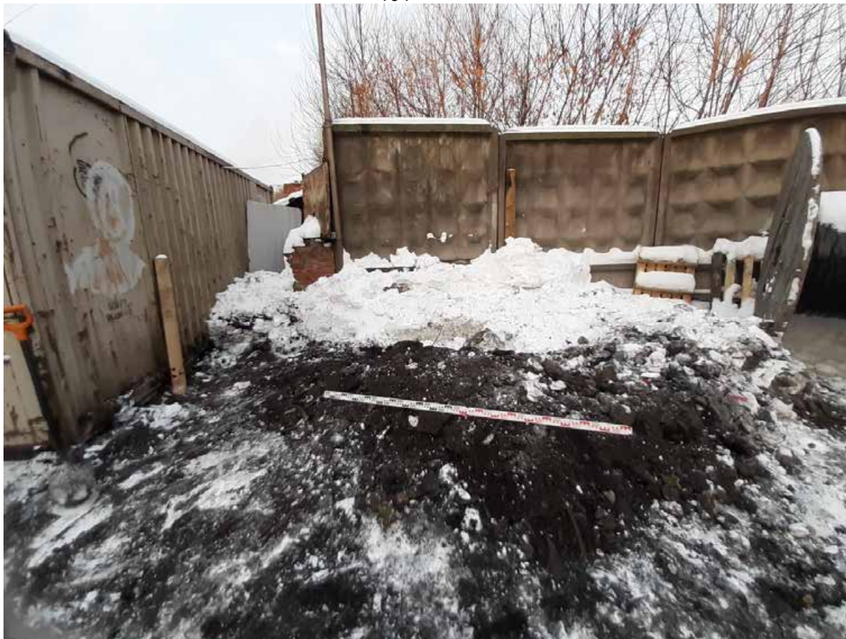
Рис. 57. Санкт-Петербург, набережная реки Волковки, земельный участок 15а (кадастровый номер: 78:13:0007322:1753). Шурф 2. Фотофиксация после рекультивации. Вид на северо-запад.
