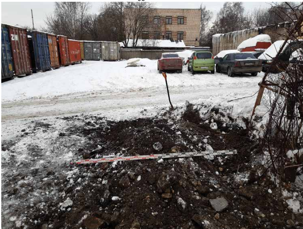
Рис. 47. Санкт-Петербург, набережная реки Волковки, земельный участок 15а (кадастровый номер: 78:13:0007322:1753). Шурф 1. Фотофиксация после рекультивации. Вид на северо-запад.
