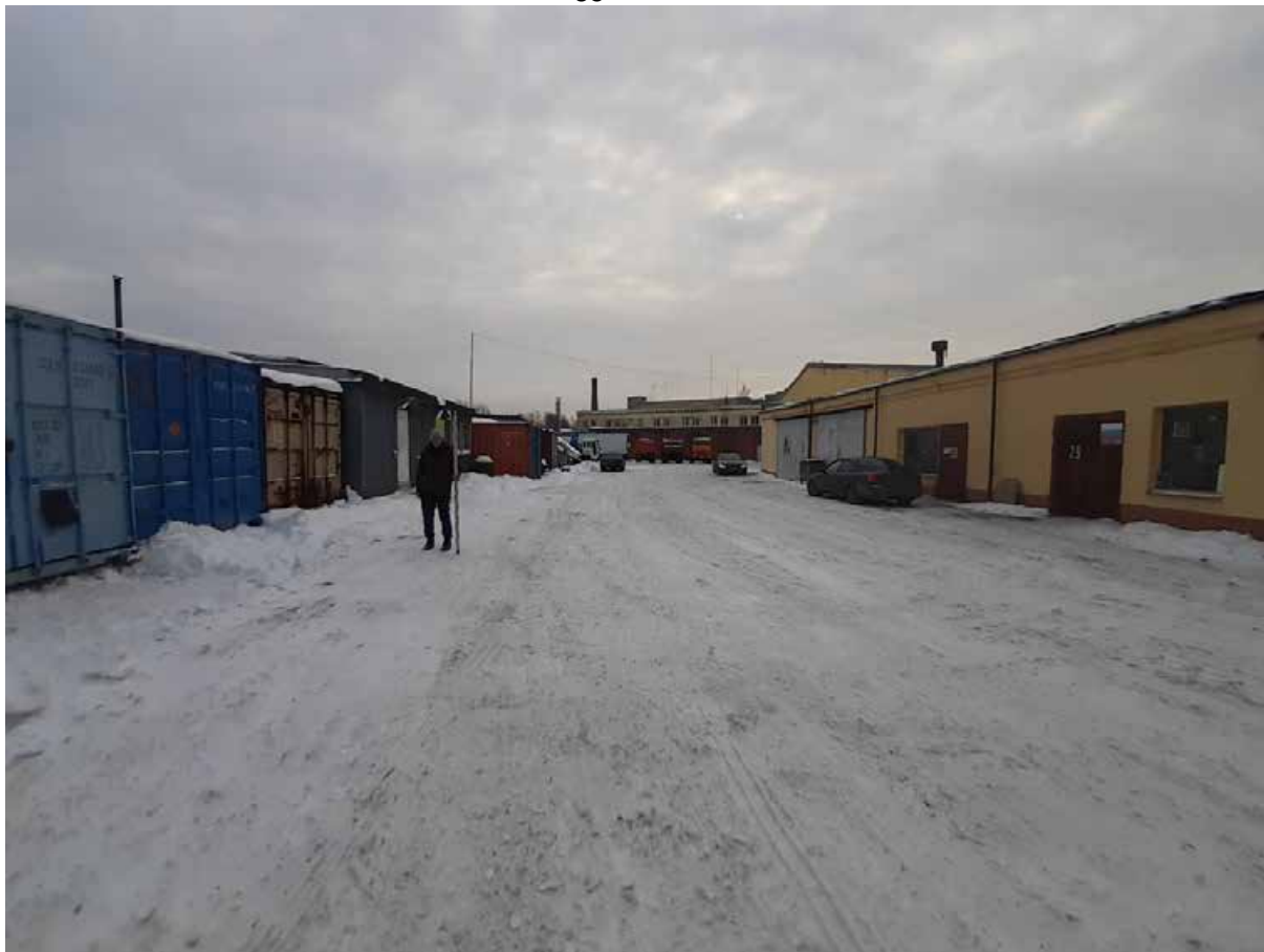
Рис. 24. Санкт-Петербург, набережная реки Волковки, земельный участок 15а (кадастровый номер: 78:13:0007322:1753). Общий вид Участка. Точка съемки 1 Вид на юг.
