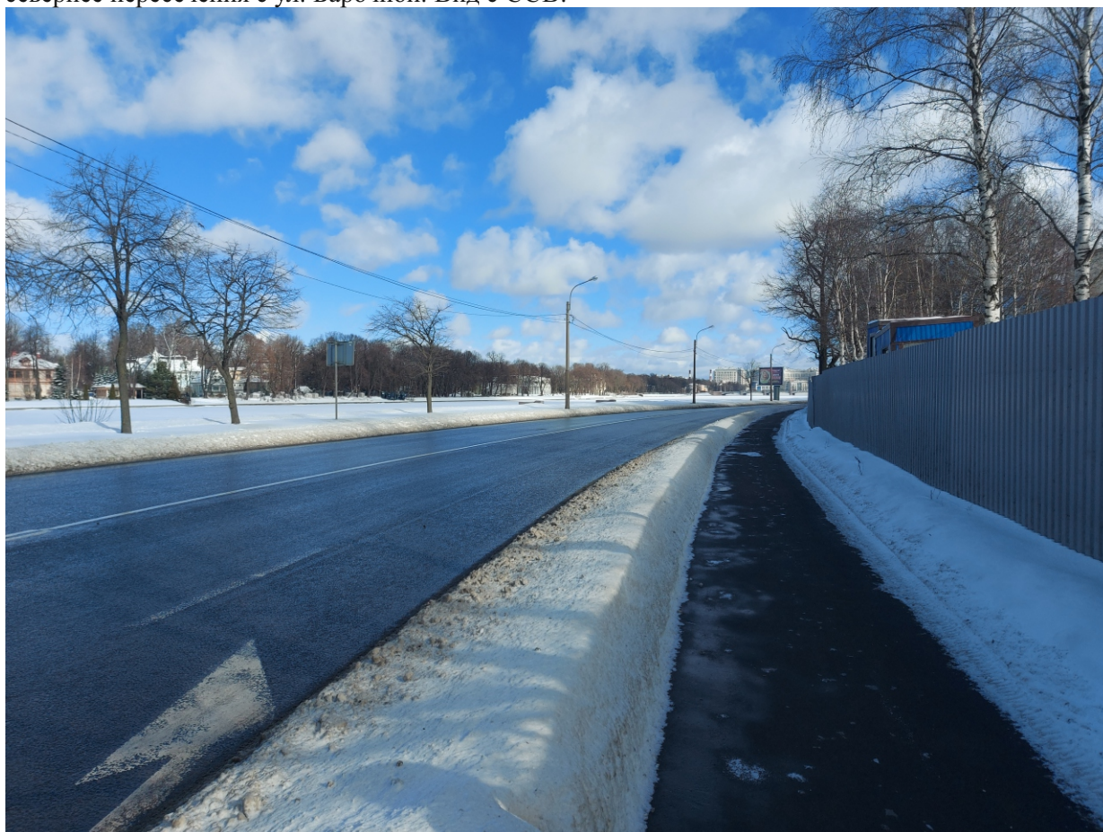
Точка фотофиксации 14. Центральная часть участка обследования по Песочной набережной севернее пересечения с ул. Барочной. Вид с ЮЮЗ.
