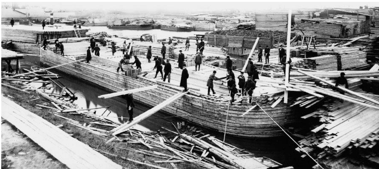
Рис. 20. Лесопильный завод Колобовых. 1900 г // [Электронный ресурс] – режим доступа: http://kn.sobaka.ru/n75/01.html // (Дата обращения: 12.03.2023).
