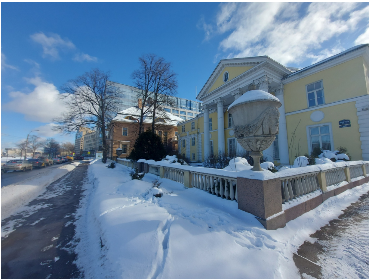
Точка фотофиксации 19. Северная часть участка обследования по Песочной набережной на пересечении с ул. Дала напротив здания, расположенного по адресу: Песочная наб., 24. Вид с З.
