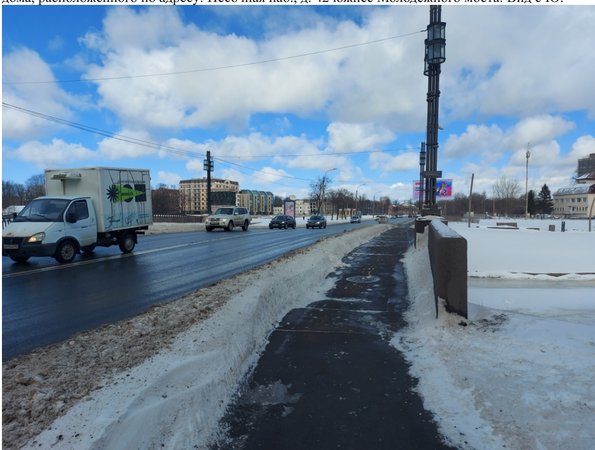
Точка фотофиксации 8. Южная часть участка обследования по Песочной набережной южнее Молодежного моста. Вид с Ю.
