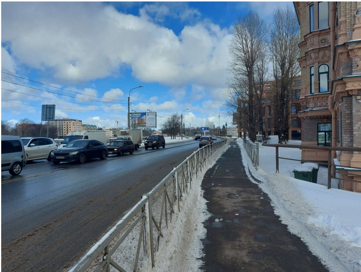
Точка фотофиксации 3. Южная часть участка обследования по Песочной набережной от дома, расположенного по адресу: ул. Большая Зеленина, д. 43. Вид с ЮЮЗ.
