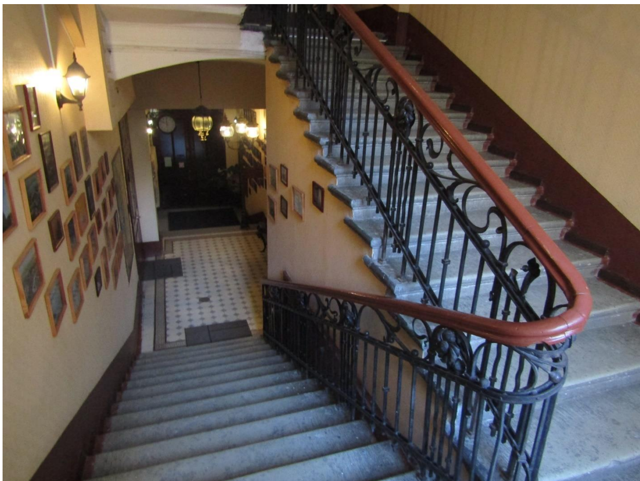
Фото 28. Вид на лестницу 1ЛК в уровне 1-го – 2-го этажей.
