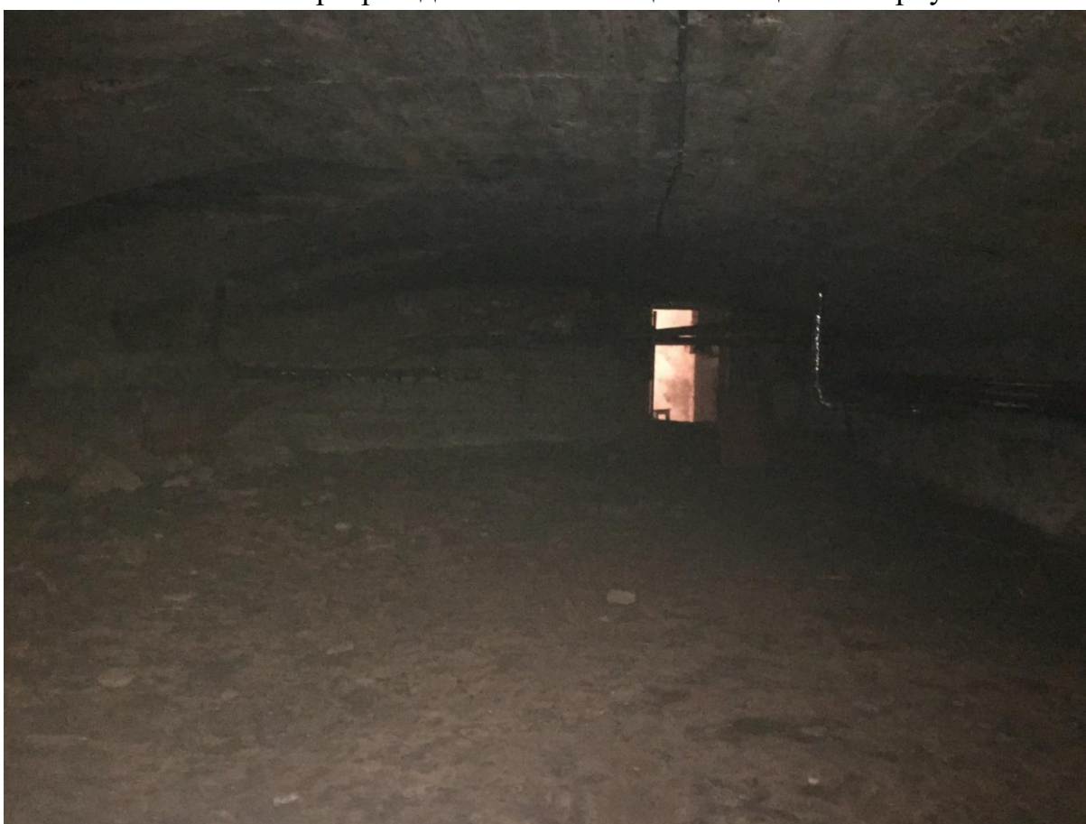
Фото 21. Интерьер подвальных помещений дворового корпуса.
