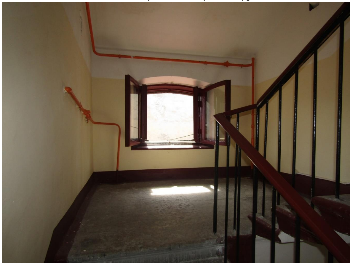
Фото 45. Вид на междуэтажную площадку в уровне 4-го – 5-го этажей.
