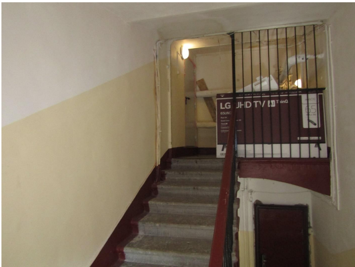
Фото 46. Вид на выход в чердачные помещения 2ЛК.
