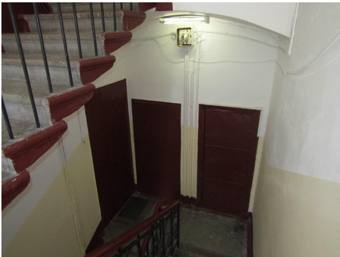
Фото 44. Вид на лестничную площадку 2ЛК в уровне 4-го этажа.
