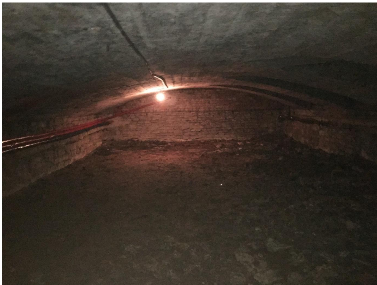
Фото 22. Интерьер подвальных помещений дворового корпуса.
