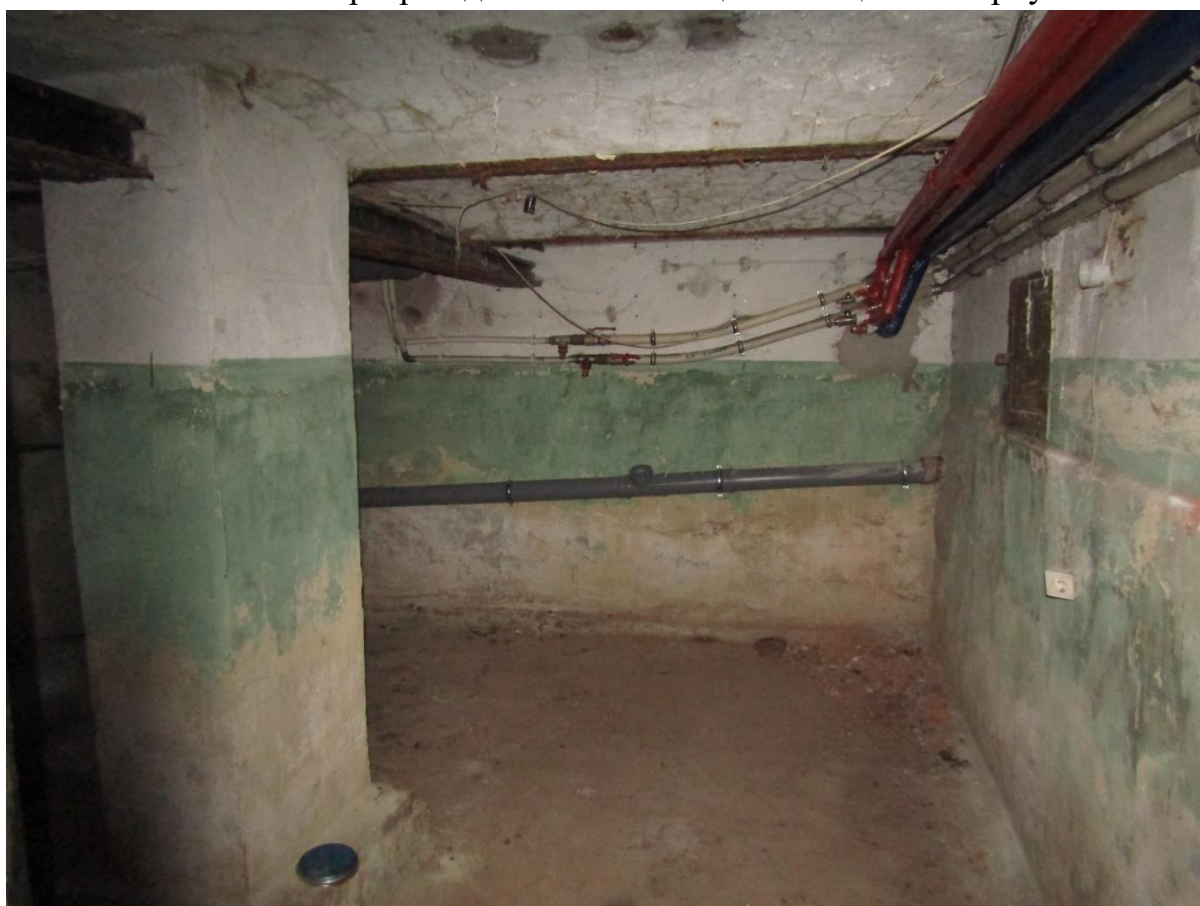
Фото 17. Интерьер подвальных помещений лицевого корпуса.
