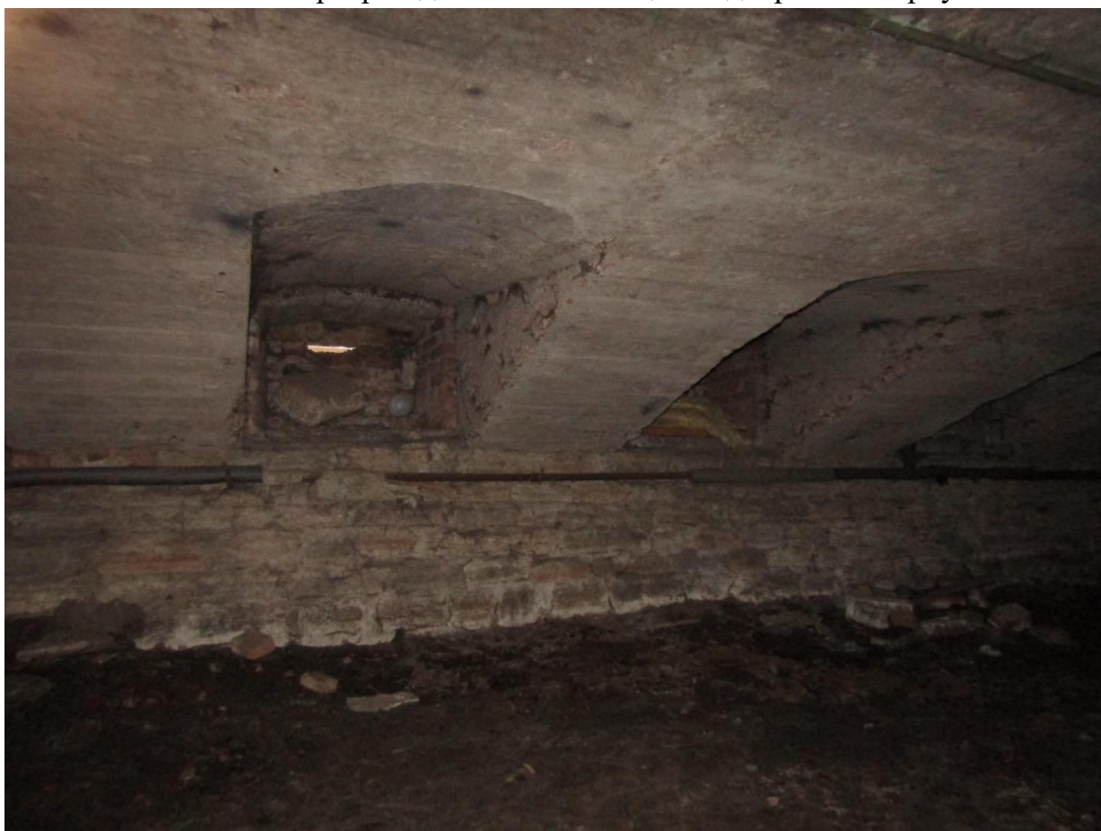
Фото 23. Интерьер подвальных помещений дворового корпуса.
