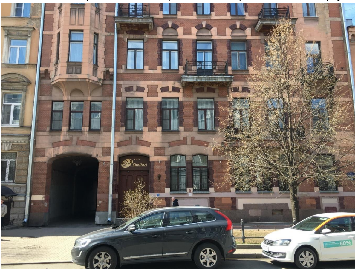
Фото 3. Вид на нижнюю часть северо-восточного фасада лицевого корпуса.
