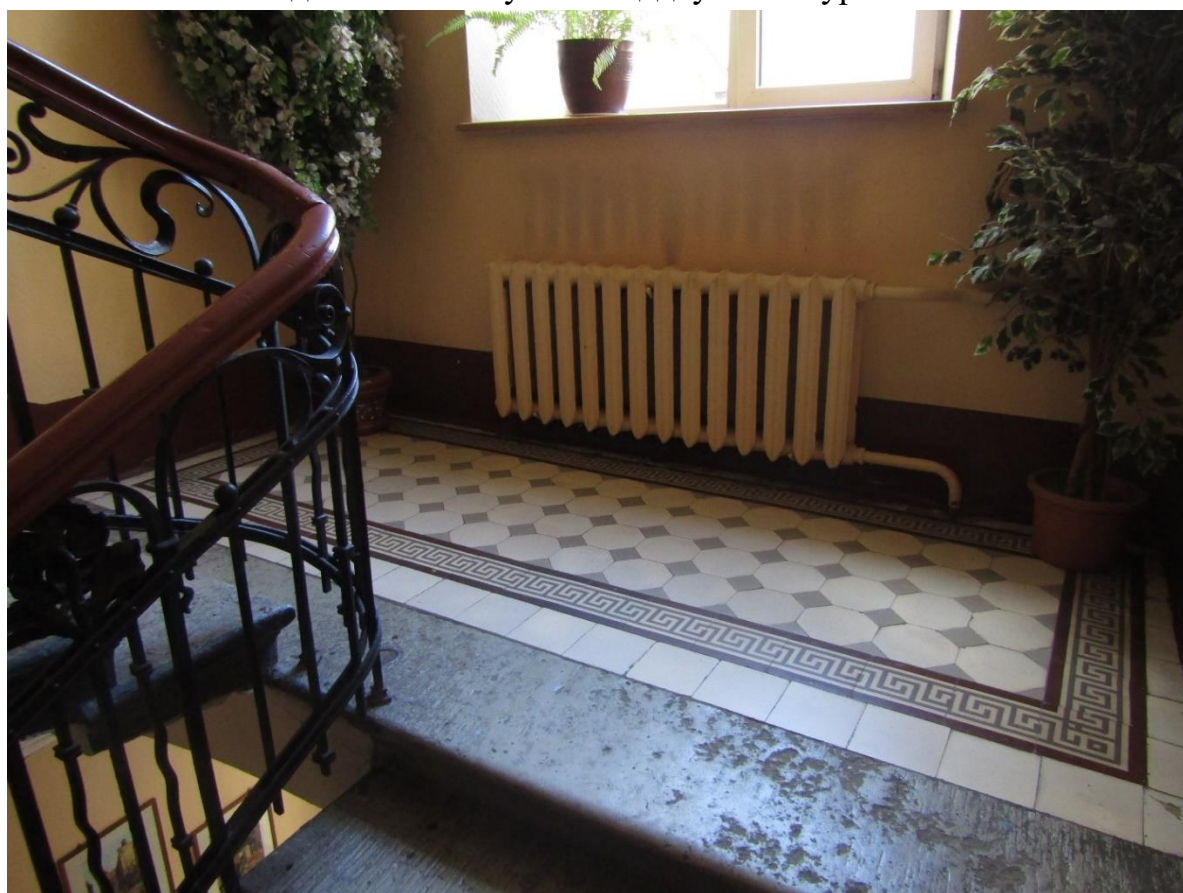
Фото 31. Вид на междуэтажную площадку 1ЛК в уровне 2-го – 3-го этажей.
