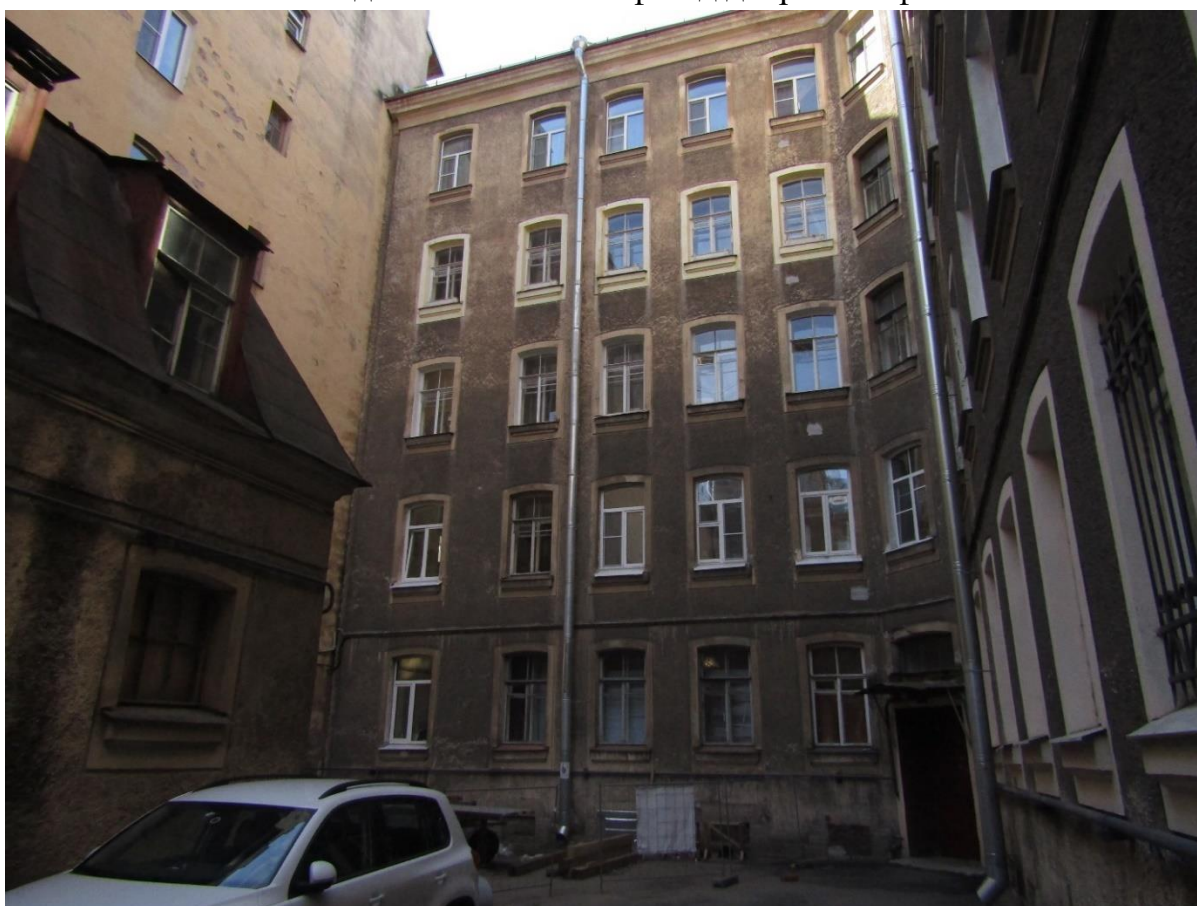
Фото 9. Вид на северо-восточный фасад дворового флигеля.
