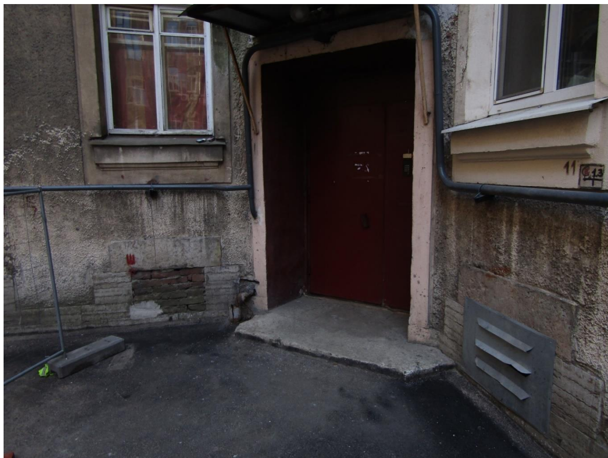
Фото 10. Вход в ЛК-3.
