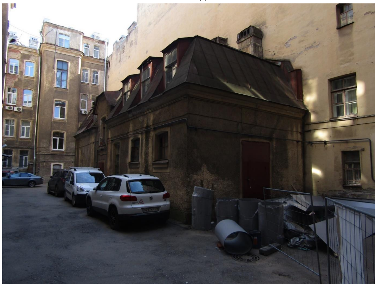
Фото 11. Вид на юго-западный фасад здания служб.
