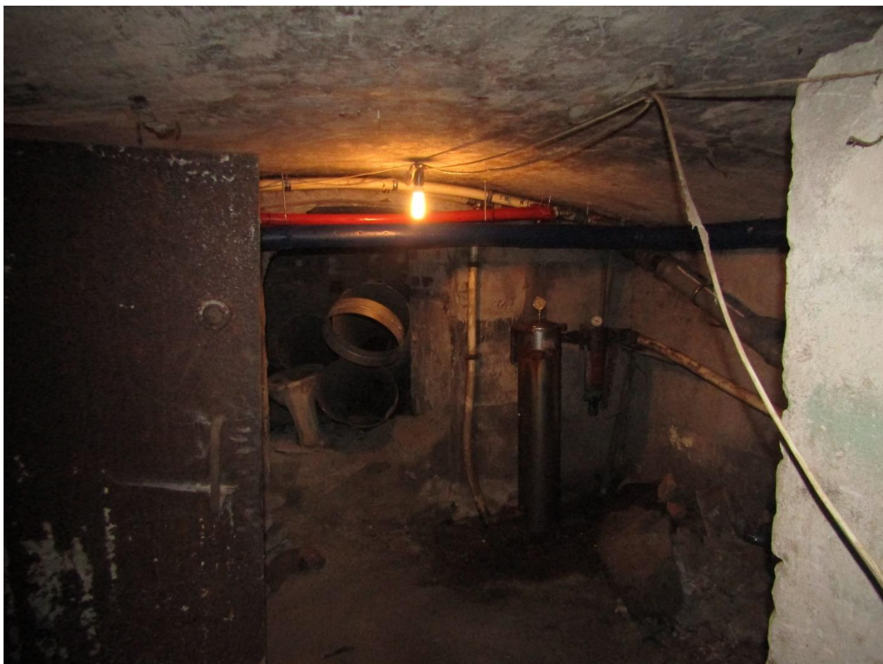
Фото 16. Интерьер подвальных помещений лицевого корпуса.
