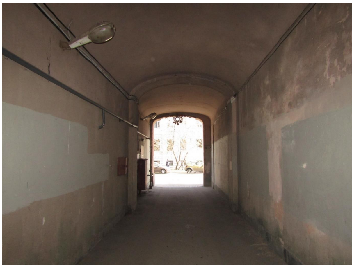
Фото 5. Арка воротного проезда, вид с юго-запада.
