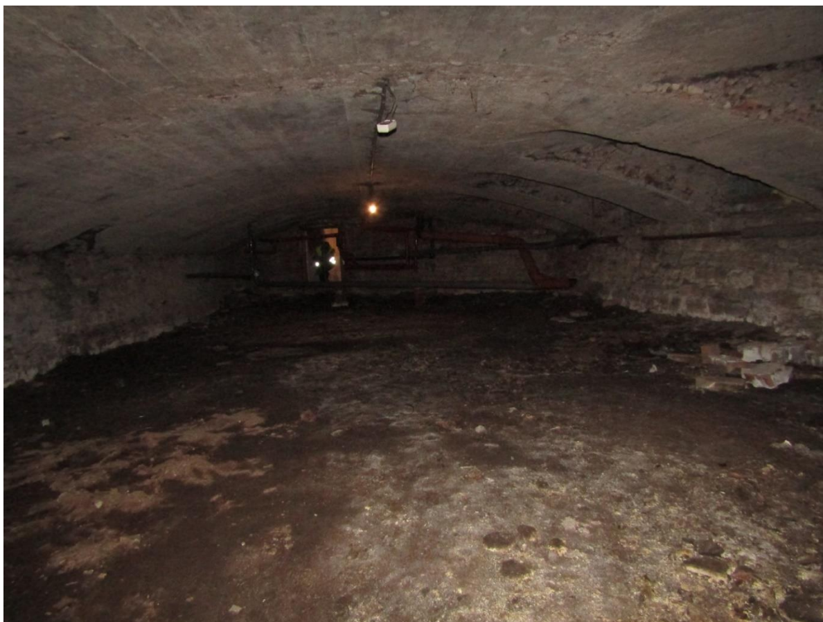
Фото 24. Интерьер подвальных помещений дворового корпуса.
