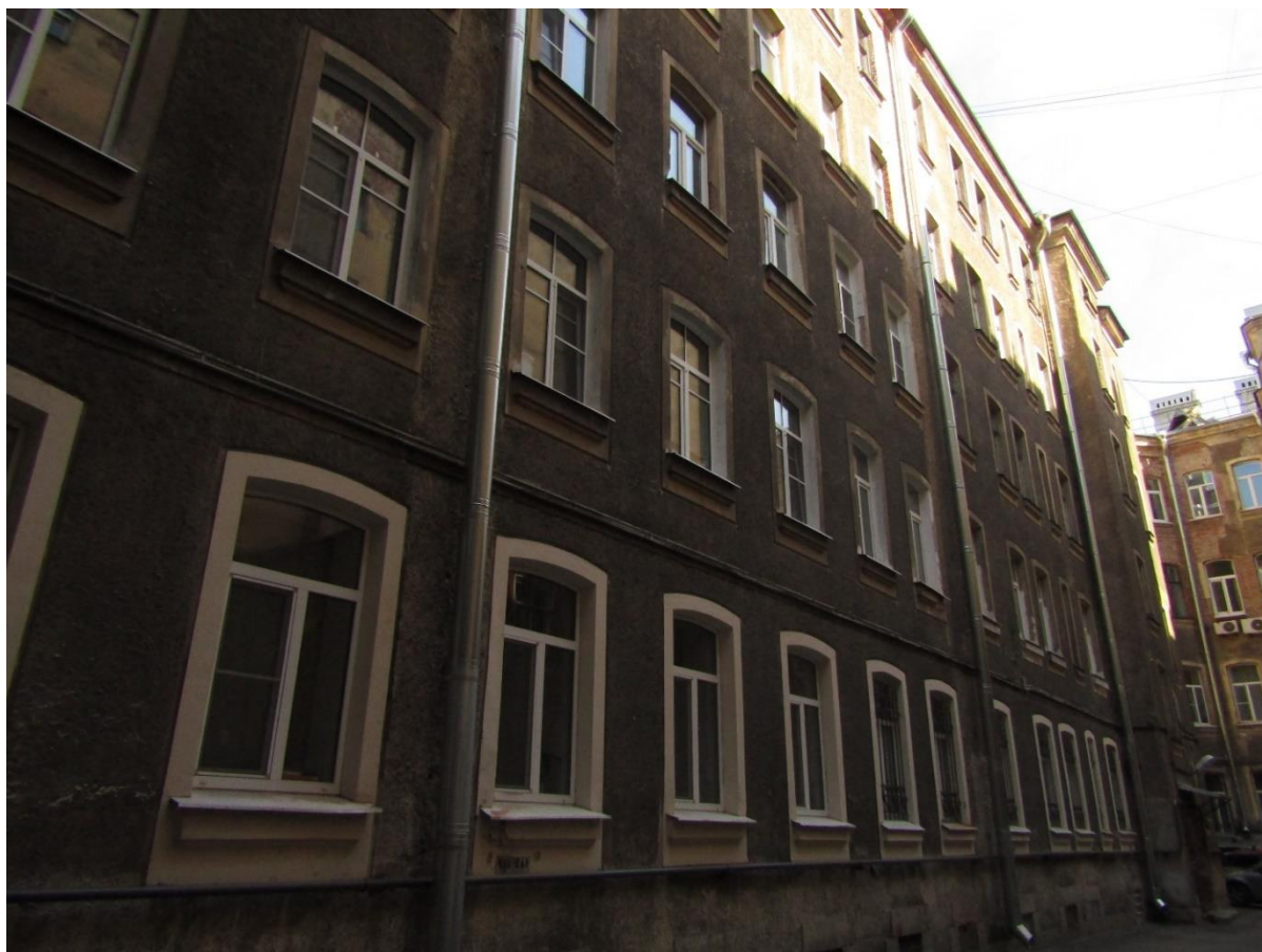
Фото 8. Вид юго-восточный фасад дворового флигеля.
