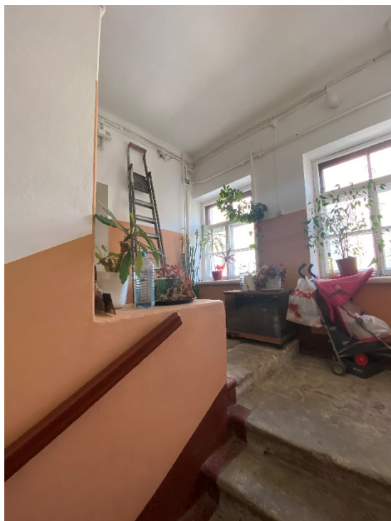
33. Лестница 2ЛК в уровне третьего этажа
