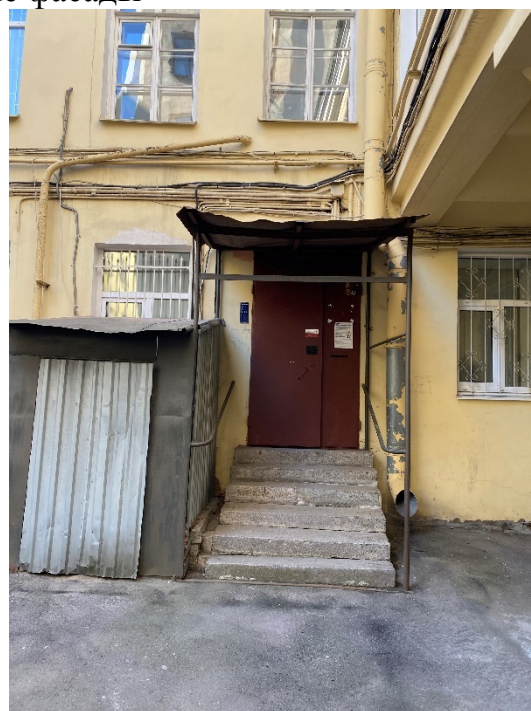
25. Вход на лестницу 2ЛК
