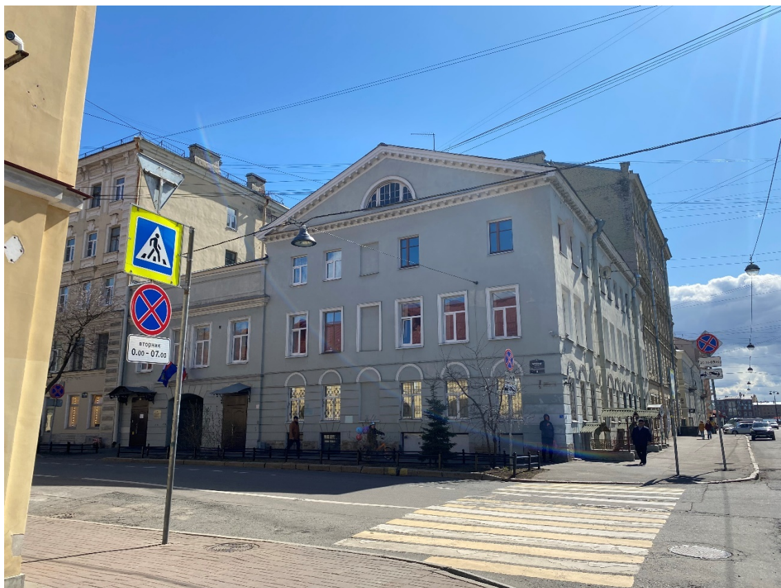
1. Вид на фасад со стороны Бугского переулка
