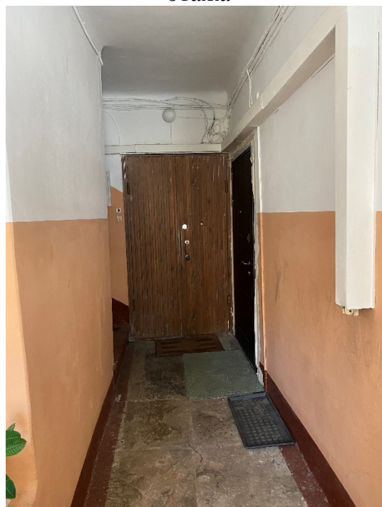
35. Лестница 2ЛК в уровне третьего этажа
