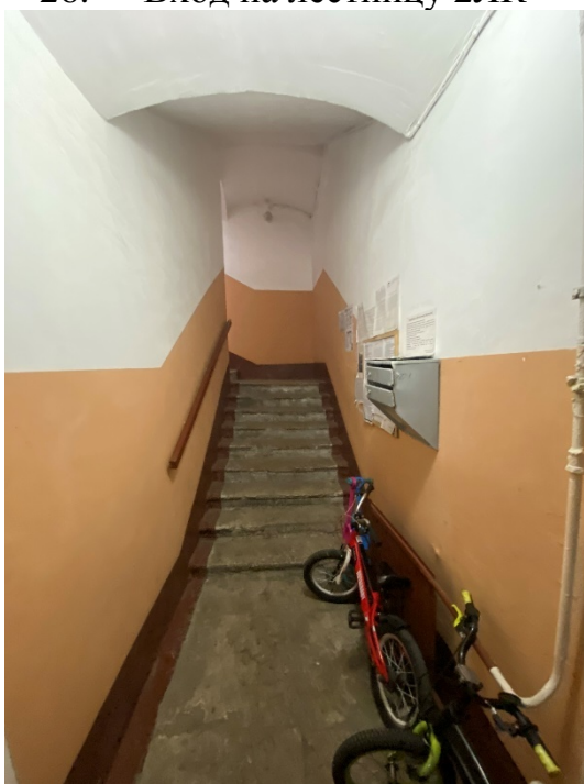
28. Лестница 2ЛК в уровне первого этажа
