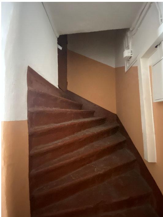
37. Лестница 2ЛК в уровне чердака
