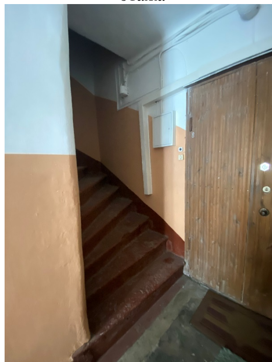
36. Лестница 2ЛК в уровне третьего этажа
