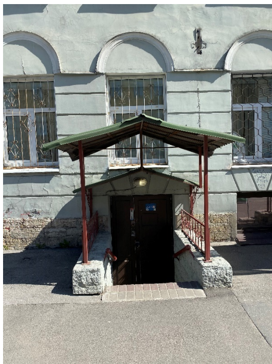
9. Входная группа в помещение 2-Н цокольного этажа со стороны 6-ой линии В.О.
