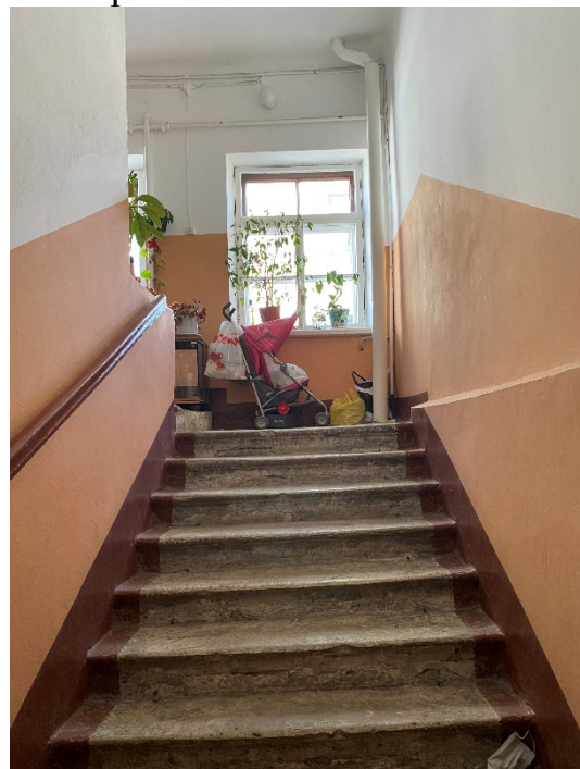
32. Лестница 2ЛК в уровне третьего этажа
