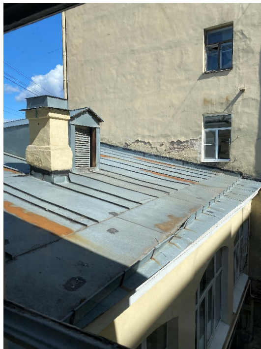
38. Вид на крышу
