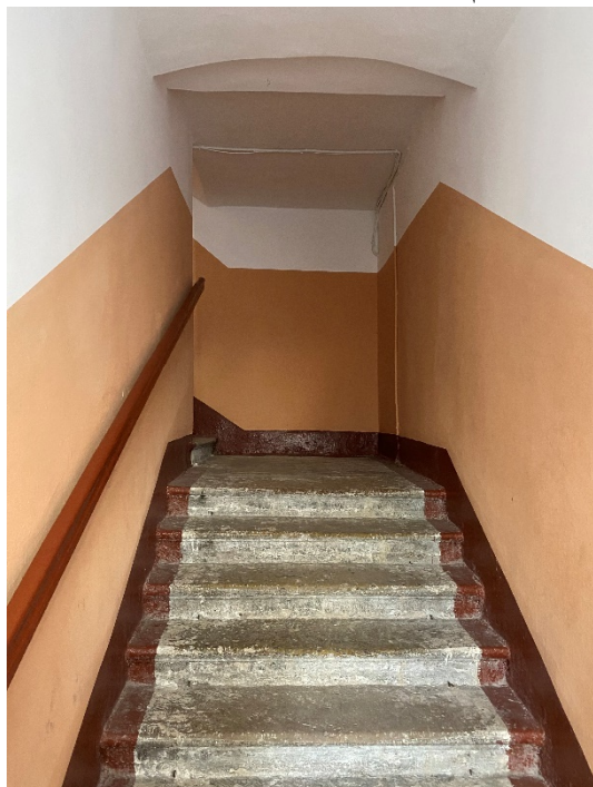
31. Лестница 2ЛК в уровне второго этажа
