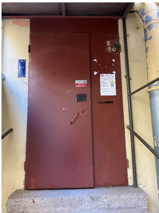
26. Вход на лестницу 2ЛК
