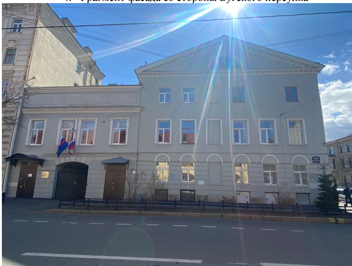
5. Вид на фасад со стороны Бугского переулка
