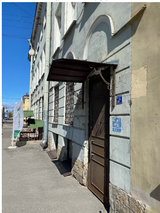
11. Дверной проем в помещение 3-Н на 6-ой линии В.О.
