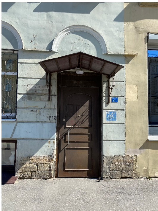
10. Дверной проем в помещение 3-Н на 6-ой линии В.О.
