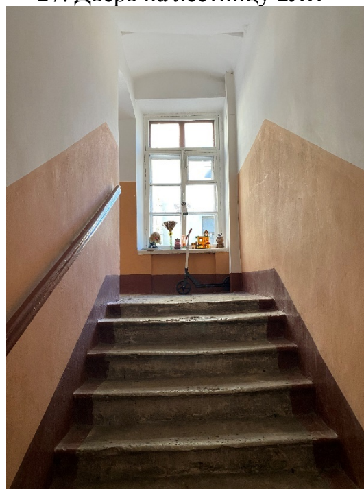
29. Лестница 2ЛК в уровне второго этажа
