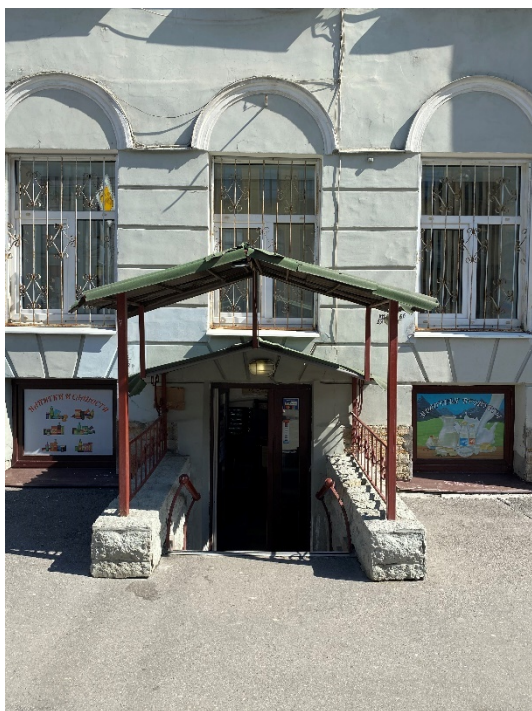
8. Входная группа в помещение 2-Н цокольного этажа со стороны 6-ой линии В.О.
