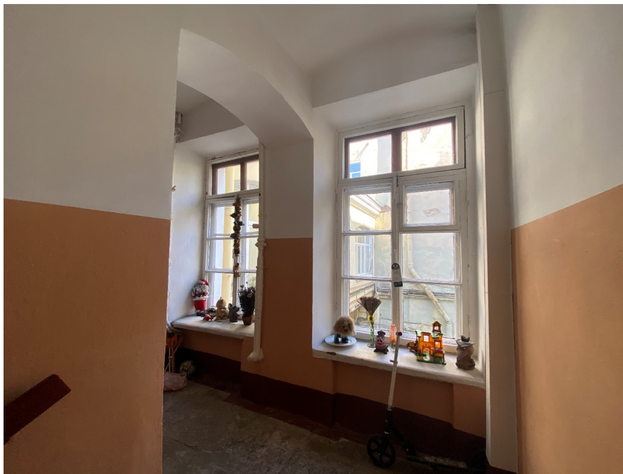
30. Лестница 2ЛК в уровне второго этажа
