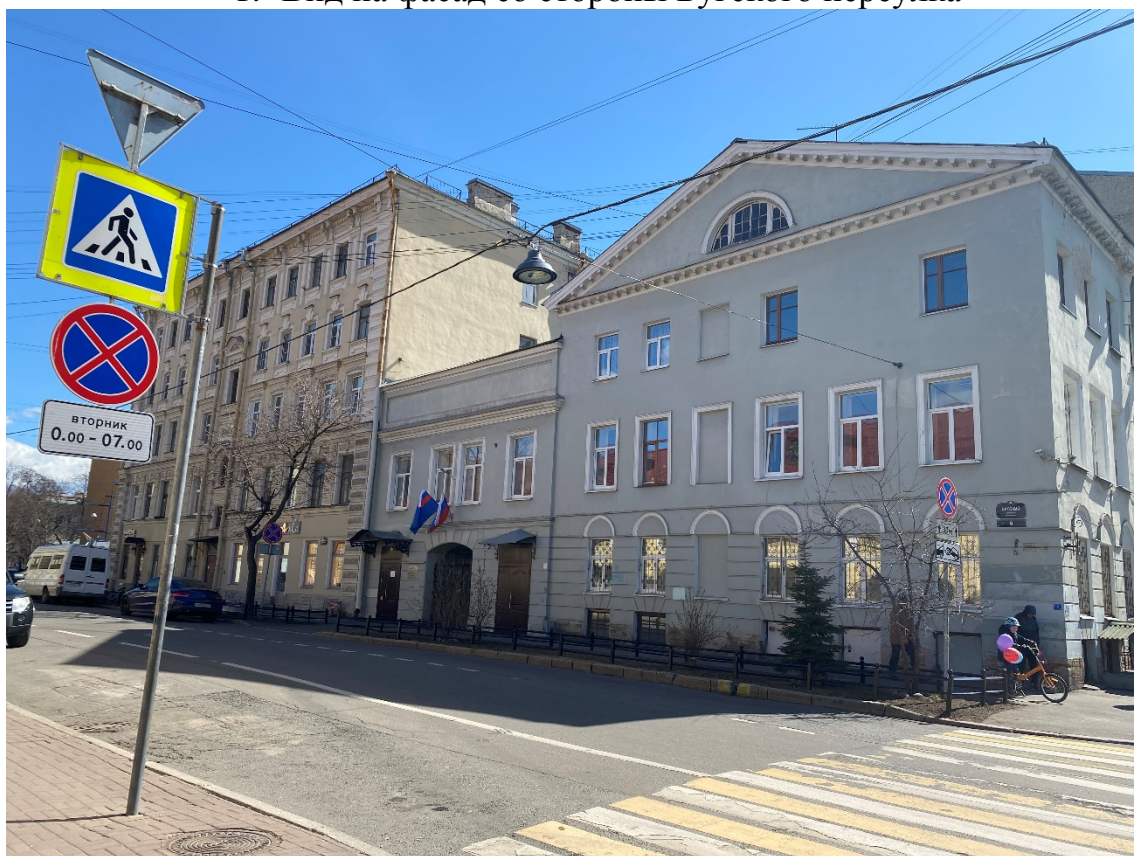
2. Вид на фасад со стороны Бугского переулка
