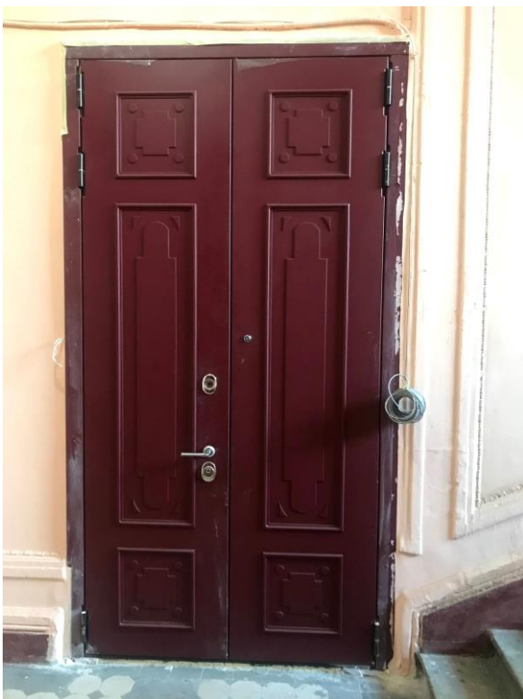
Фото 4. Входная дверь в кв. 2 с главной лестницы.
