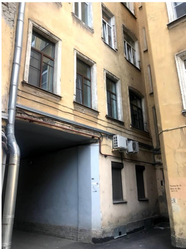
Фото 3. Дворовой фасад здания по ул. 12 я Красноармейская
