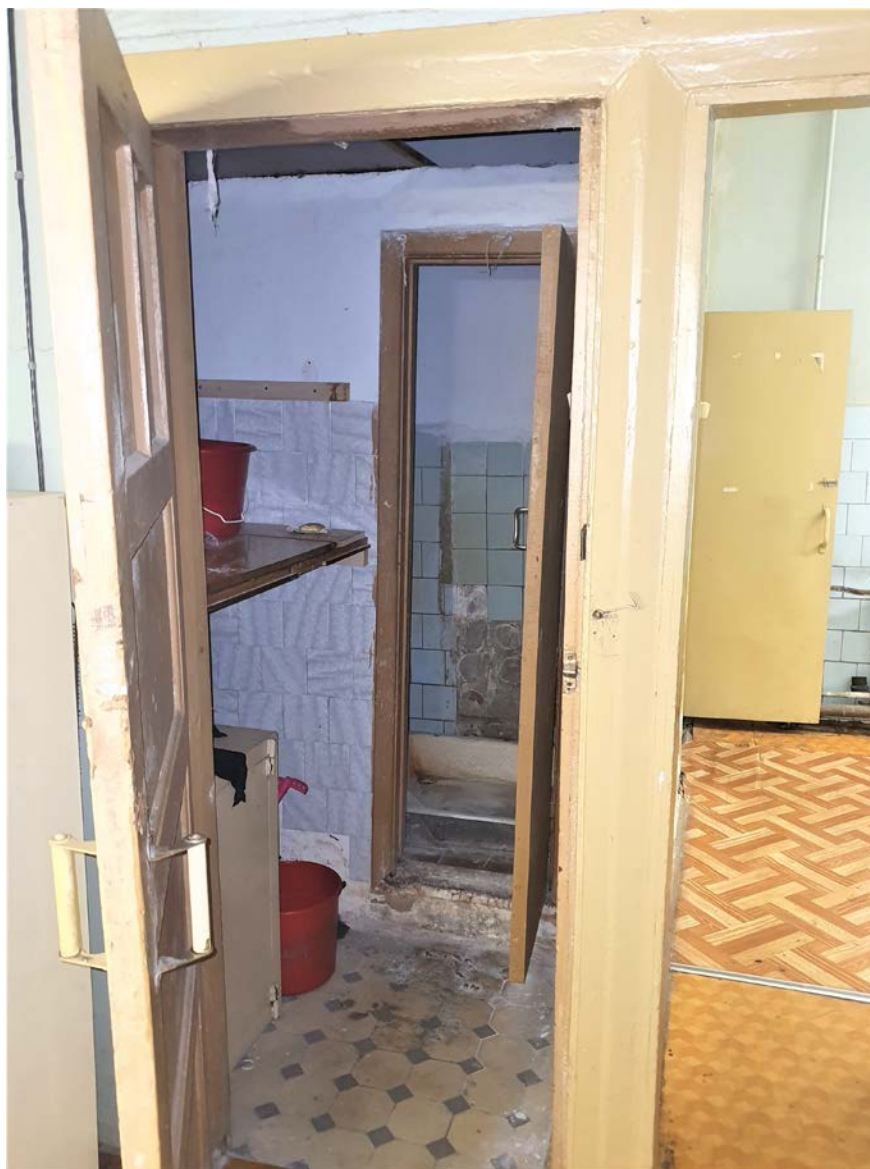
Фото 9. Выявленный объект культурного наследия «Дом М.С. Мальцева (Общества для заклада движимых имуществ)», по адресу: Санкт-Петербург, Литейный пр. д.29, Литер А (Литейный пр. 29). Квартира 33. Дата съемки: 01 сентября 2021 г.
