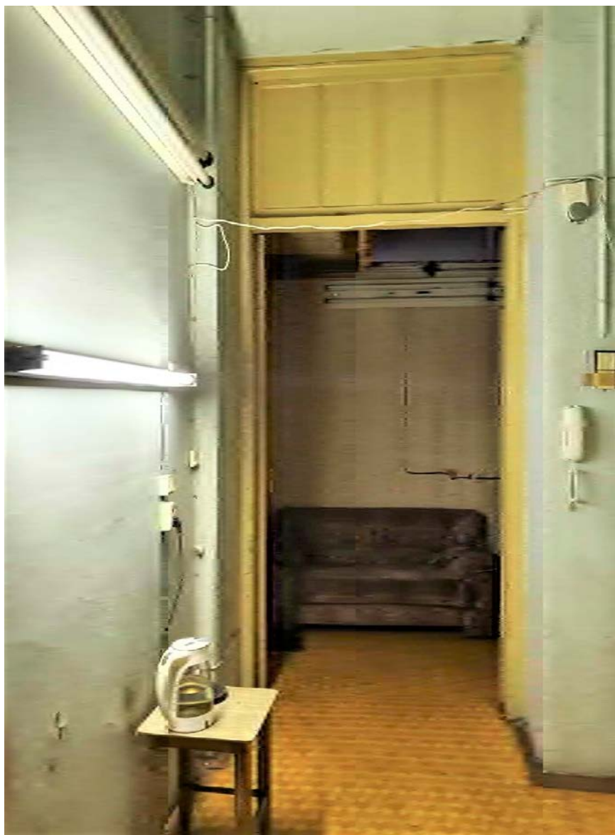
Фото 6. Выявленный объект культурного наследия «Дом М.С. Мальцева (Общества для заклада движимых имуществ)», по адресу: Санкт-Петербург, Литейный пр. д.29, Литер А (Литейный пр. 29). Квартира 33. Дата съемки: 01 сентября 2021 г.
