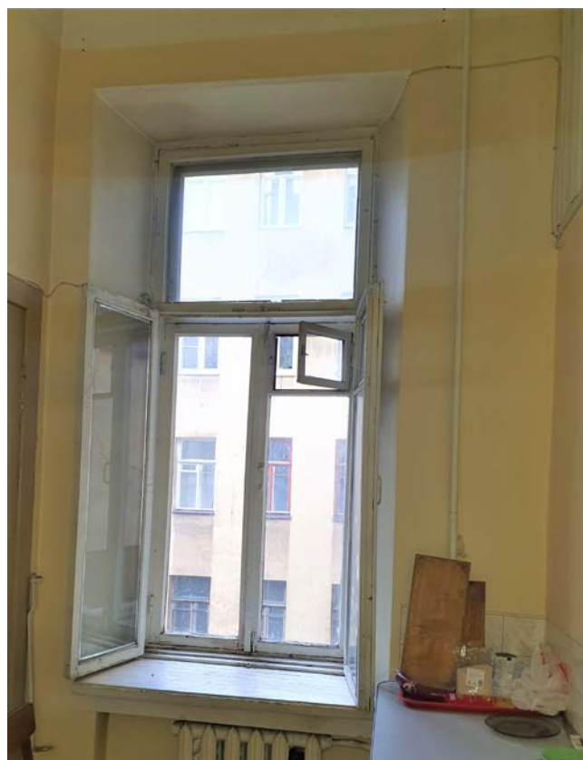
Фото 12. Выявленный объект культурного наследия «Дом М.С. Мальцева (Общества для заклада движимых имуществ)», по адресу: Санкт-Петербург, Литейный пр. д.29, Литер А (Литейный пр. 29). Квартира 33. Дата съемки: 01 сентября 2021 г.
