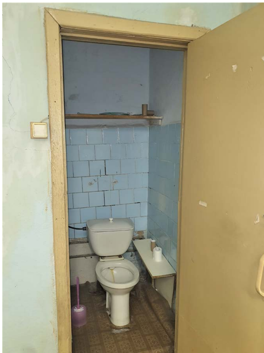
Фото 8. Выявленный объект культурного наследия «Дом М.С. Мальцева (Общества для заклада движимых имуществ)», по адресу: Санкт-Петербург, Литейный пр. д.29, Литер А (Литейный пр. 29). Квартира 33. Дата съемки: 01 сентября 2021 г.
