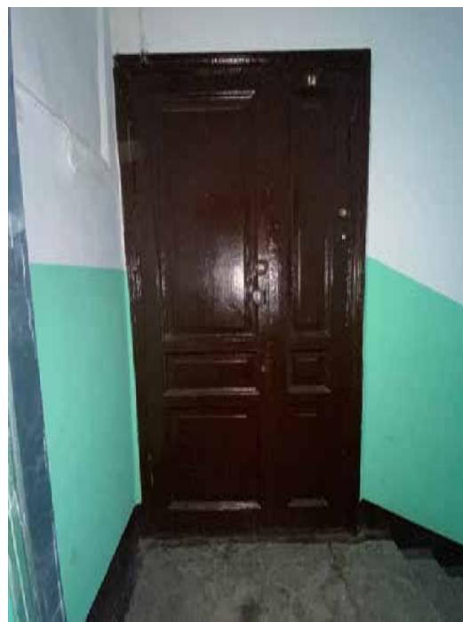
94. Лестница ЗЛК в уровне третьего этажа
