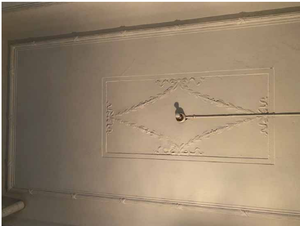
70. Потолок вестибюля лестницы 2ЛК
