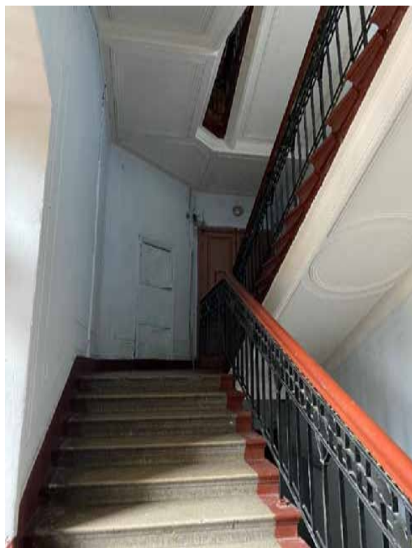
81. Лестница 2ЛК в уровне третьего этажа
