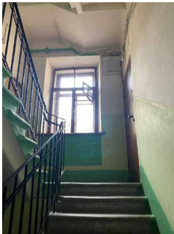
120. Лестница 5ЛК в уровне второго этажа
