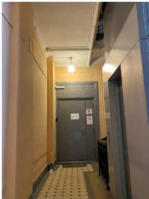
52. Лестница 1ЛК в уровне третьего этажа
