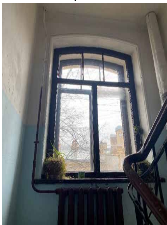
111. Оконный проем на лестнице 4ЛК
