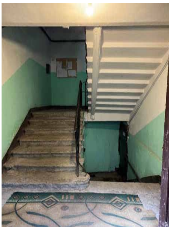
149. Лестница 8ЛК в уровне первого этажа
