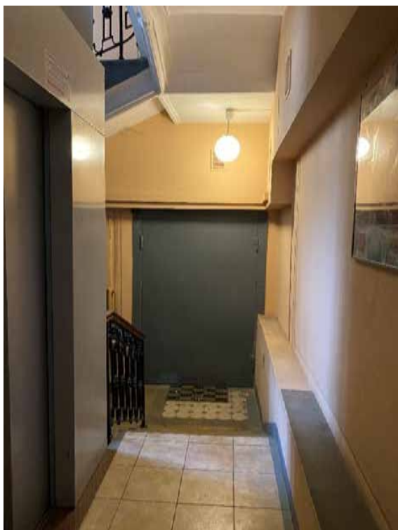
41. Лестница 1ЛК в уровне первого этажа
