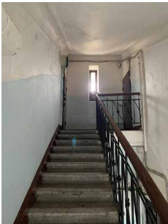
116. Лестница 4ЛК в уровне чердака
