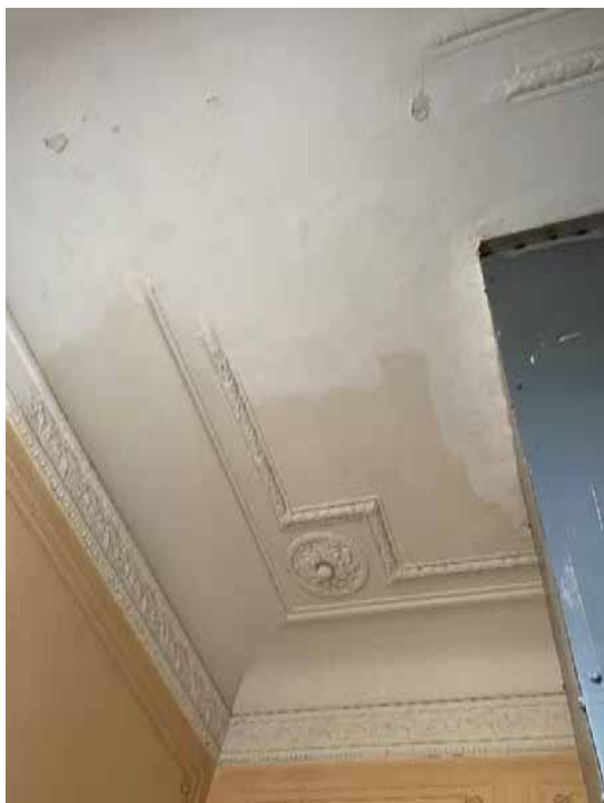
61. Лестница 1ЛК в уровне пятого этажа
