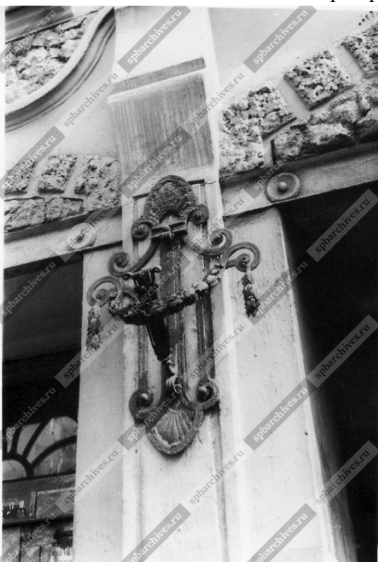
83. Флагодержатель на фасаде дома № 37 на 6-й линии Васильевского острова (бывший дом С.Х.Мельцер, военный инженер Э.Ф.Мельцер, 1909-
