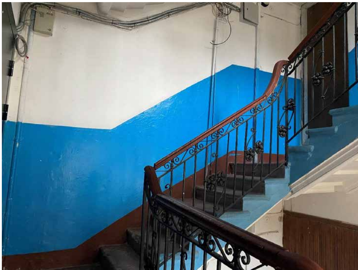
144. Лестница БЛК в уровне четвертого этажа
