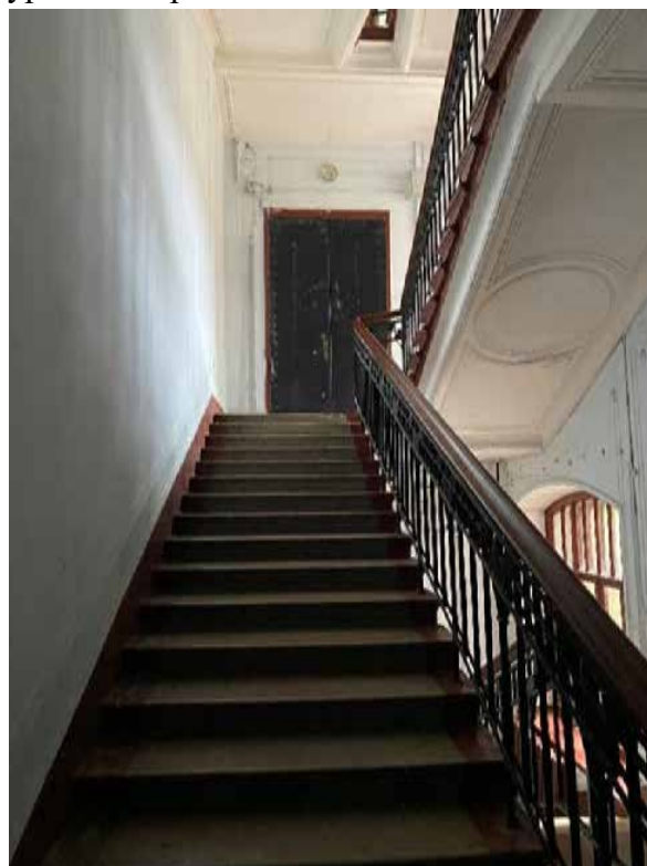
79. Лестница 2ЛК в уровне третьего этажа
