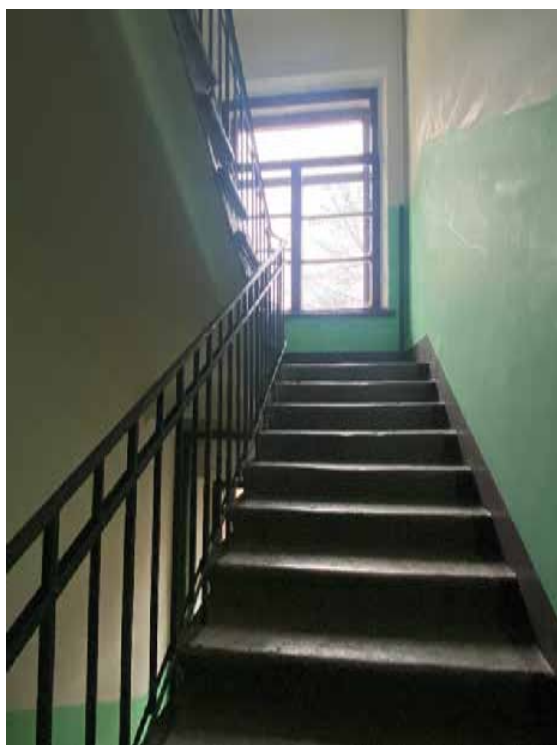
95. Лестница ЗЛК в уровне третьего этажа
