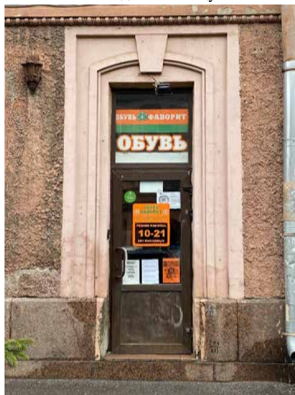
7. Дверь в помещении 5-Н
