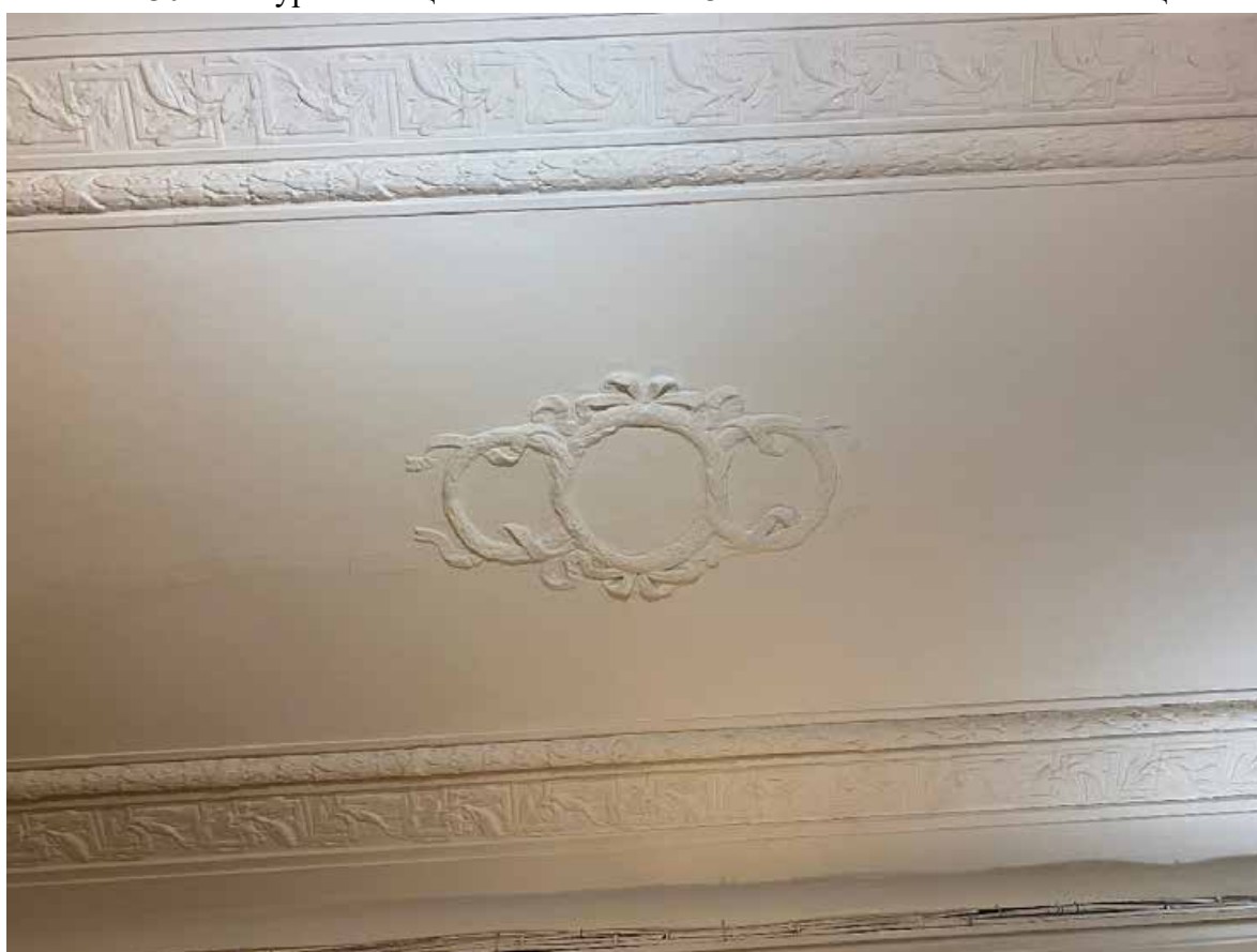
32. Потолок вестибюля 1ЛК
