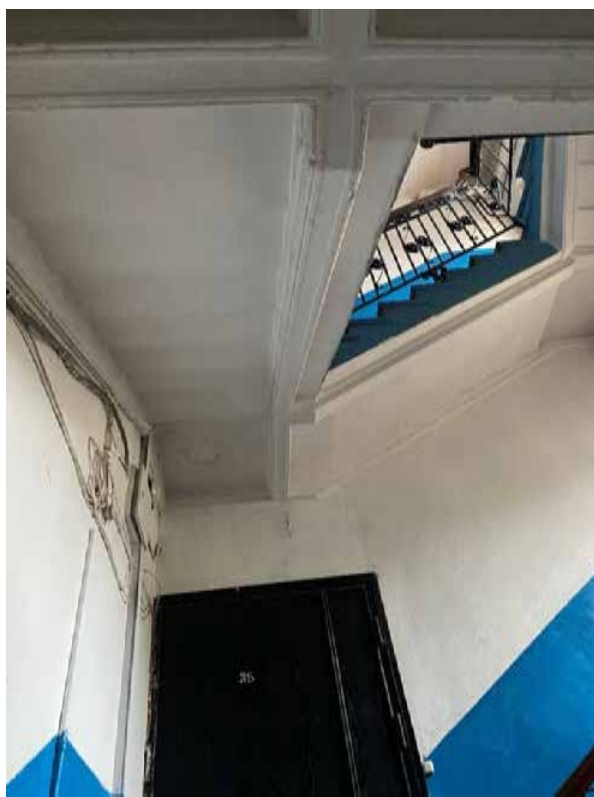
136. Лестница БЛК в уровне второго этажа
