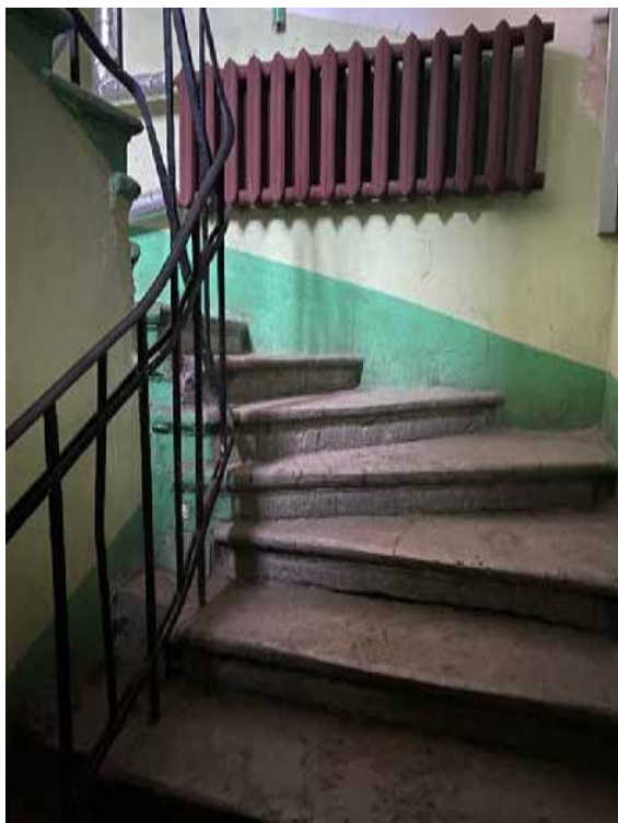
119. Лестница 5ЛК в уровне первого этажа
