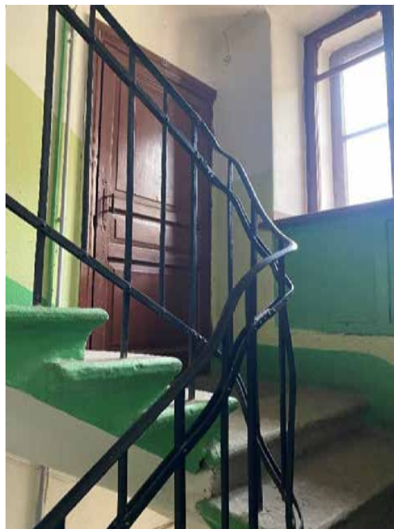
124. Лестница 5ЛК в уровне третьего этажа
