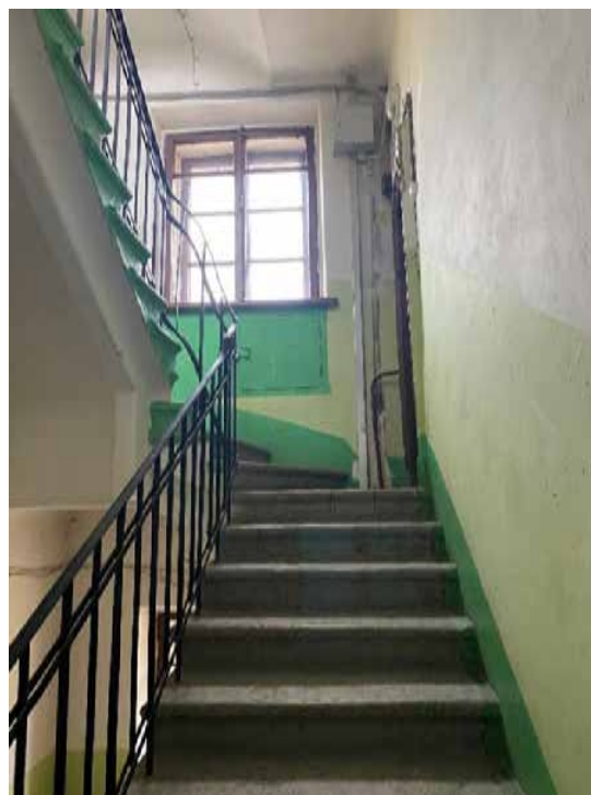
128. Лестница 5ЛК в уровне пятого этажа
