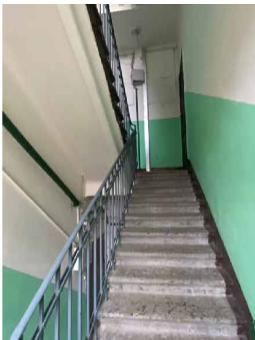
93. Лестница ЗЛК в уровне третьего этажа
