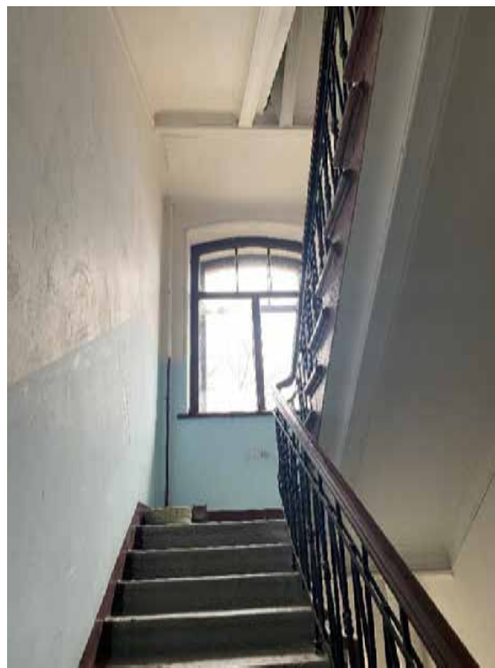
113. Лестница 4ЛК в уровне пятого этажа
