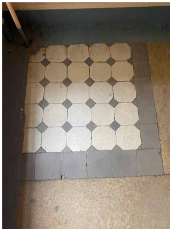
44. Напольное покрытие площадки лестницы 1ЛК
