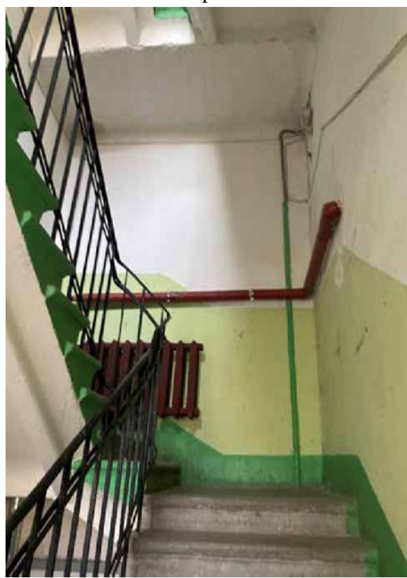
122. Лестница 5ЛК в уровне второго этажа
