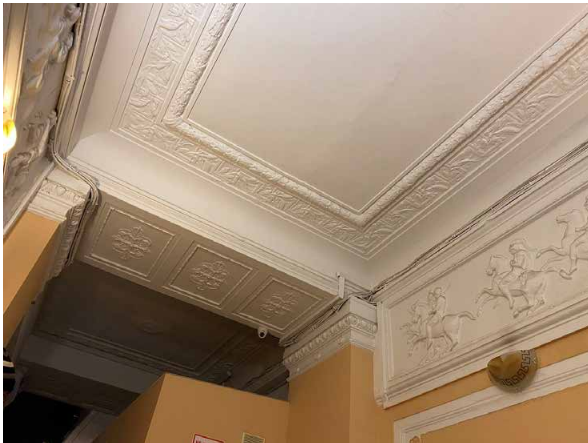
35. Вестибюль лестницы 1ЛК
