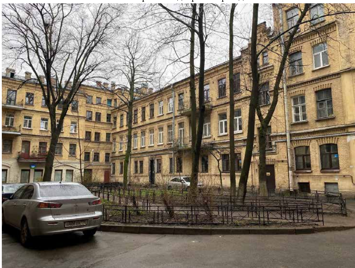
21. Фрагмент дворовых фасадов
