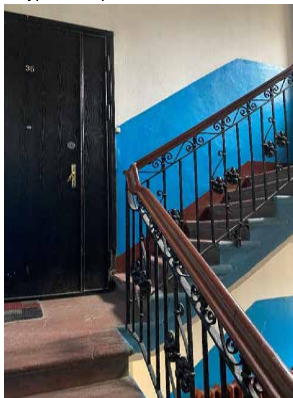
137. Лестница БЛК в уровне второго этажа
