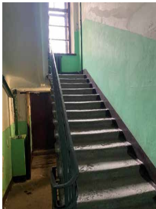
90. Лестница ЗЛК в уровне первого этажа
