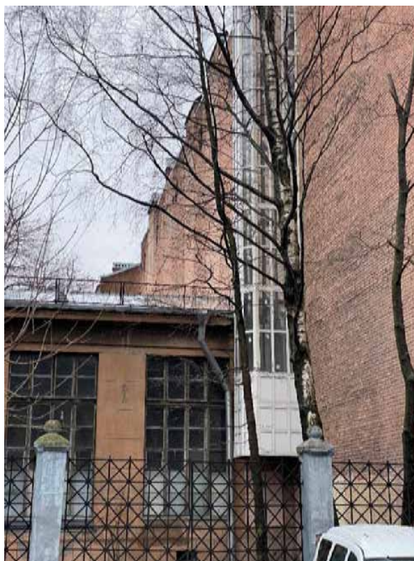
11. Вид на пристроенную шахту лифта
