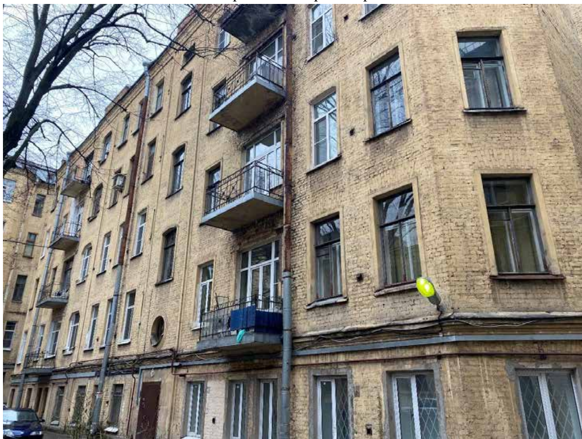
25. Фрагмент дворовых фасадов
