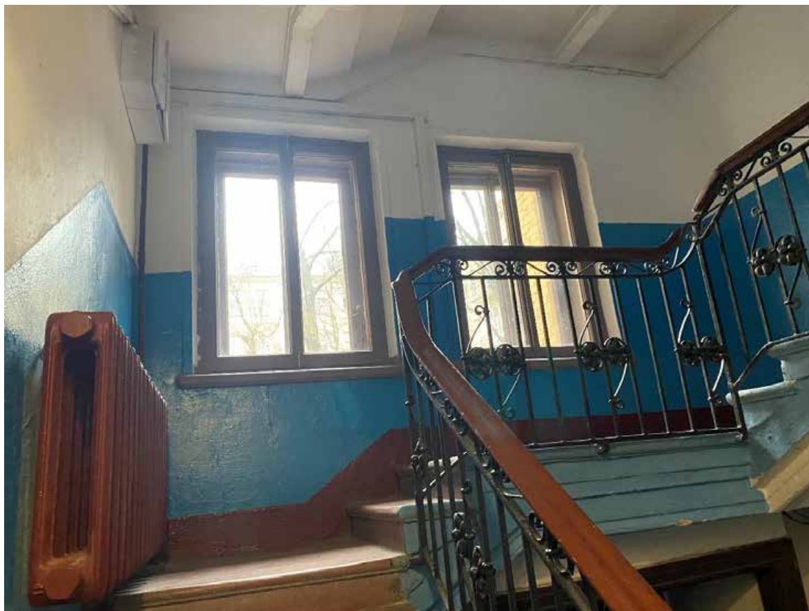
133. Лестница БЛК в уровне второго этажа
