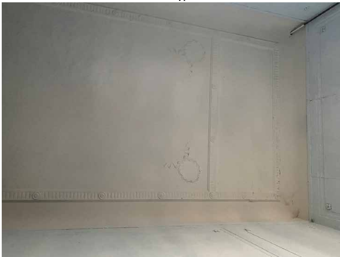
88. Потолок лестницы 2ЛК
