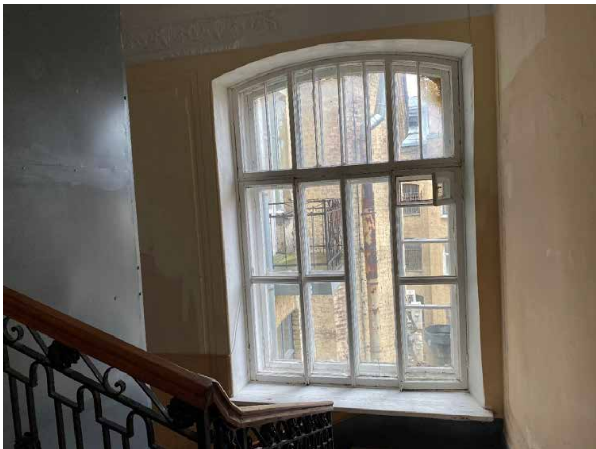
67. Лестница 1ЛК в уровне пятого этажа
