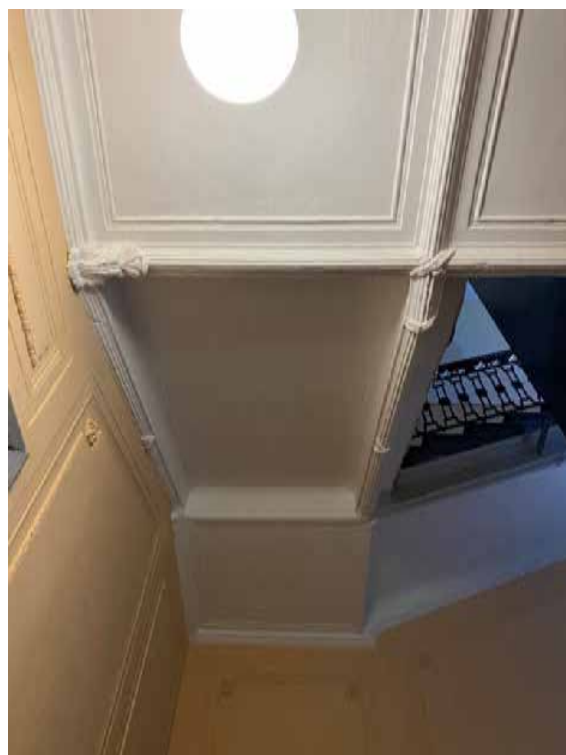
54. Лестница 1ЛК в уровне третьего этажа
