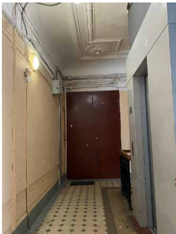
63. Лестница 1ЛК в уровне пятого этажа
