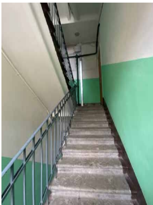
91. Лестница ЗЛК в уровне второго этажа
