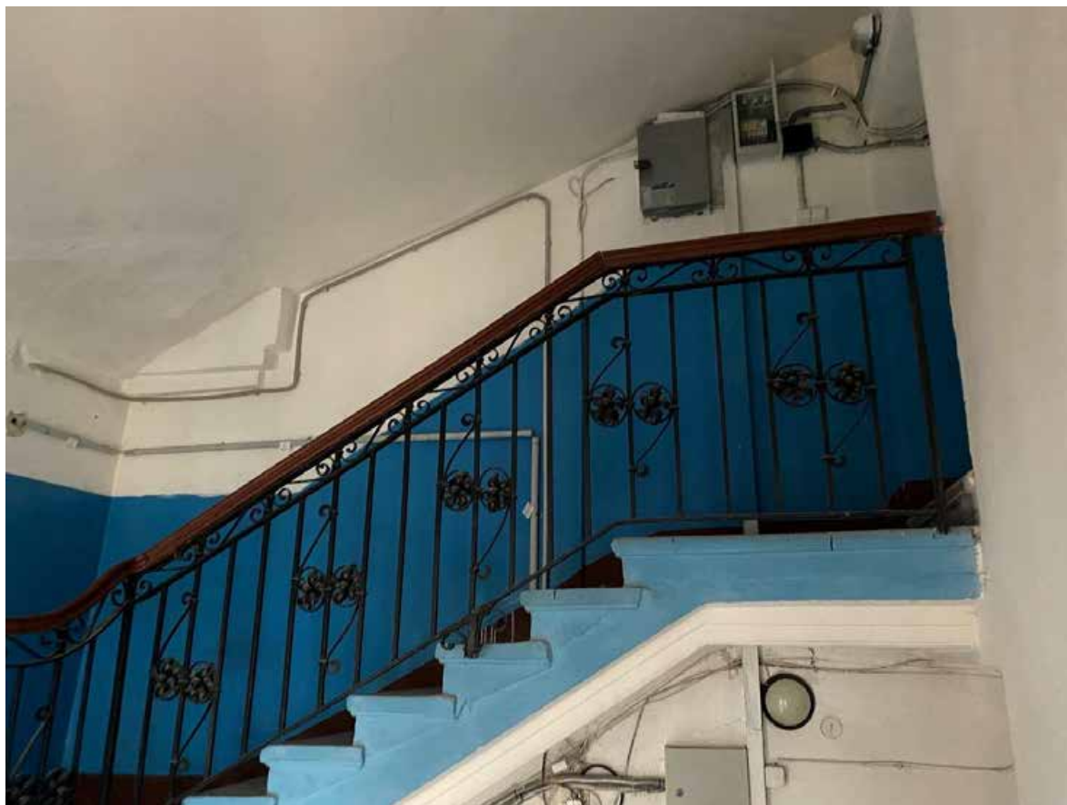
146. Лестница БЛК в уровне чердака
