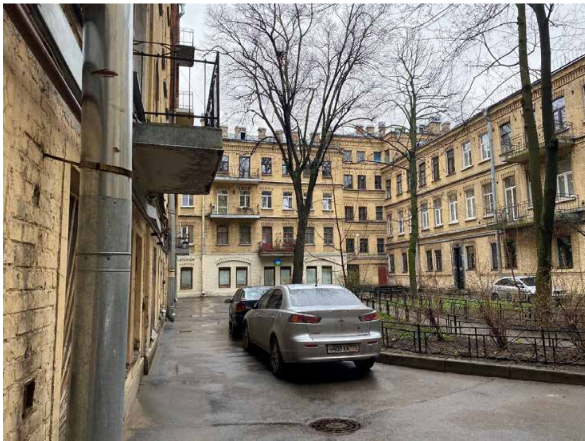
22. Фрагмент дворовых фасадов
