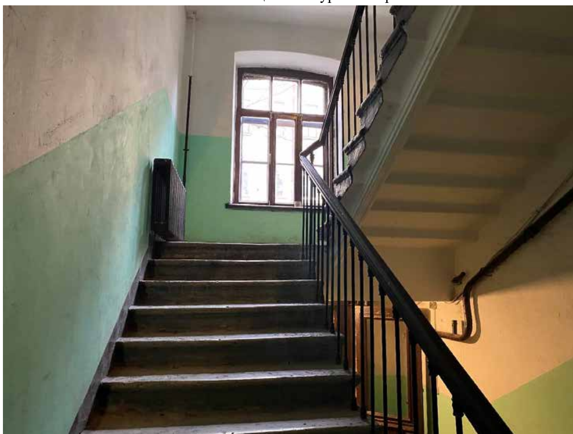
152. Лестница 8ЛК в уровне второго этажа
