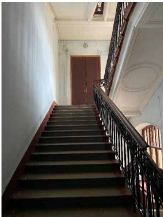
83. Лестница 2ЛК в уровне четвертого этажа
