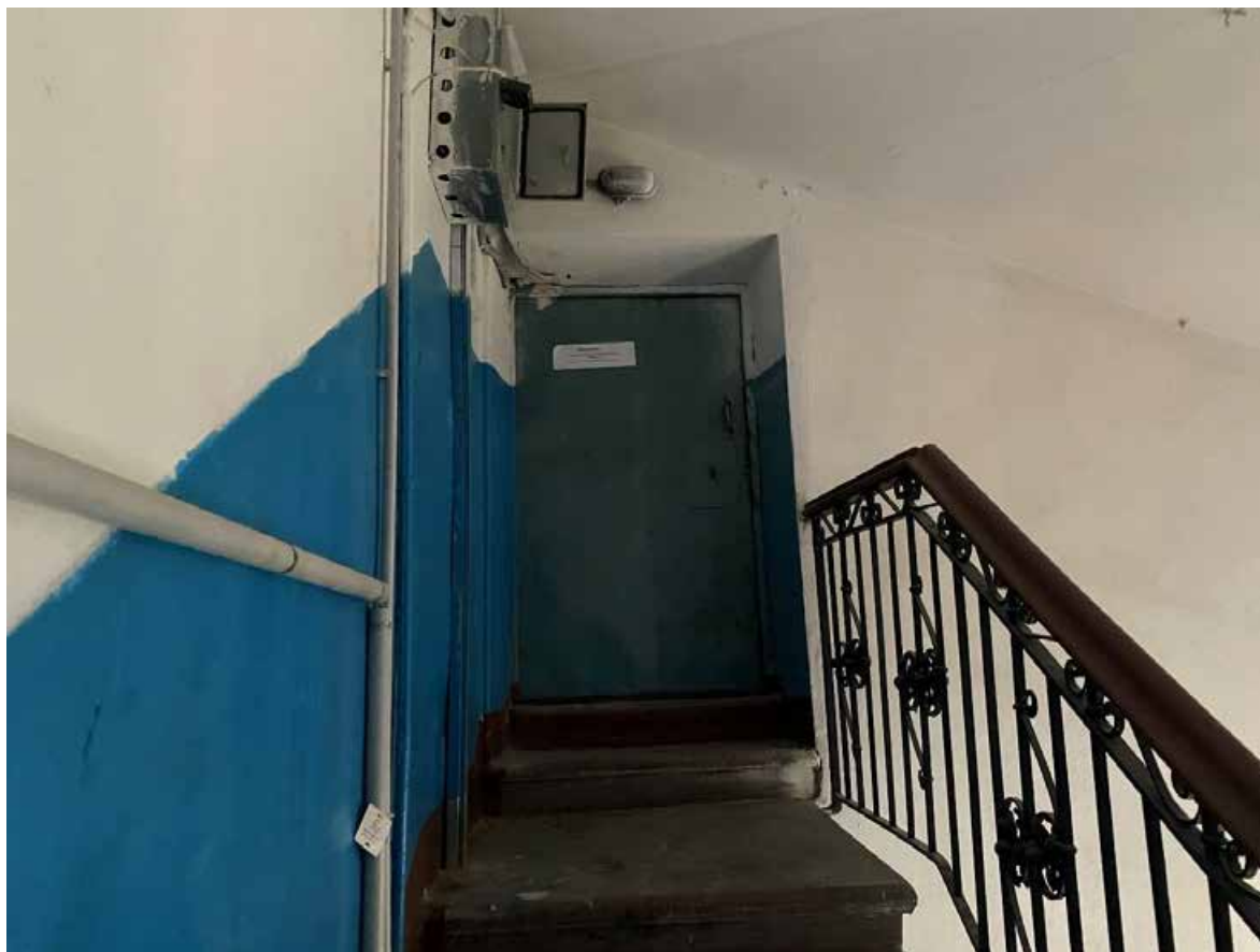
148. Лестница 6ЛК в уровне чердака
