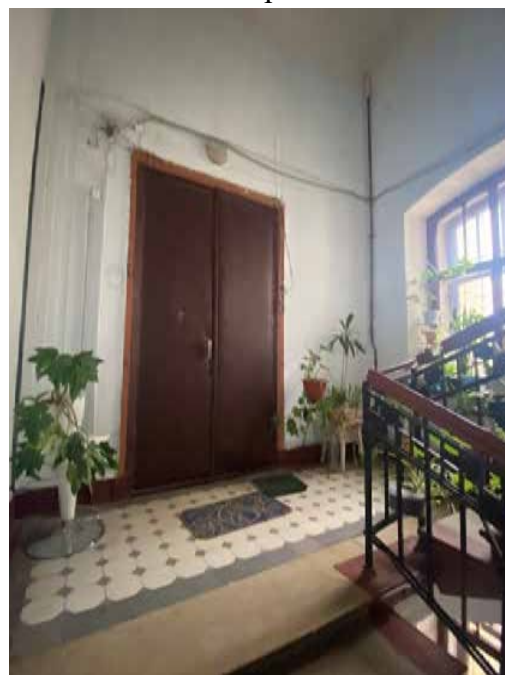
86. Лестница 2ЛК в уровне пятого этажа
