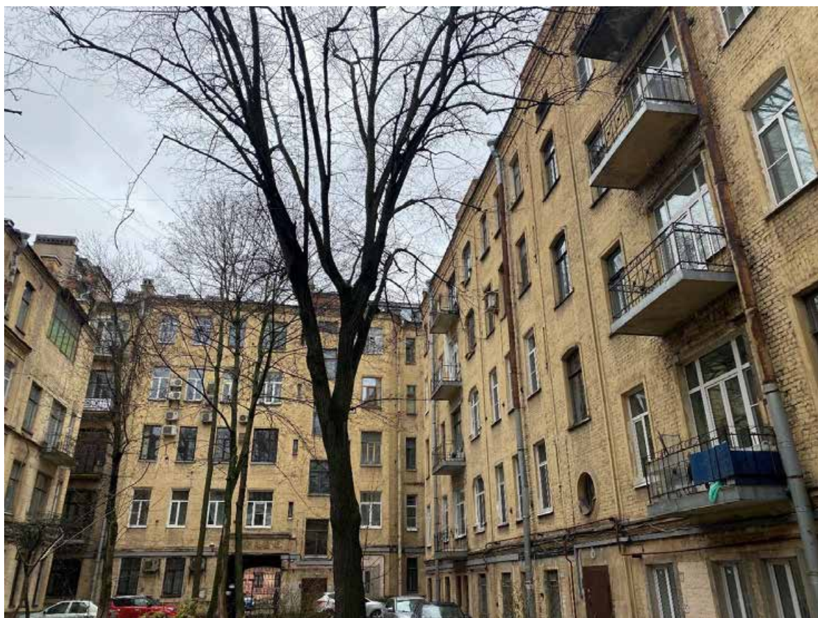
26. Фрагмент дворовых фасадов
