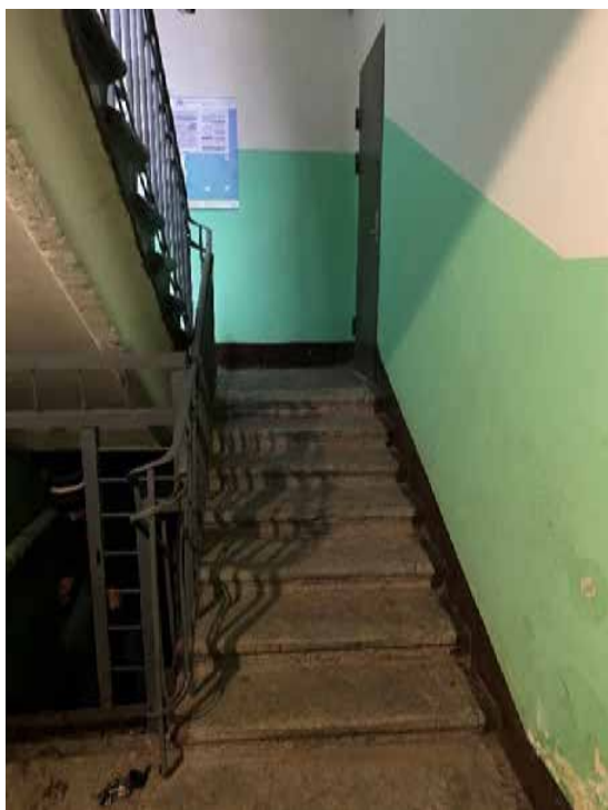
89. Лестница ЗЛК в уровне первого этажа
