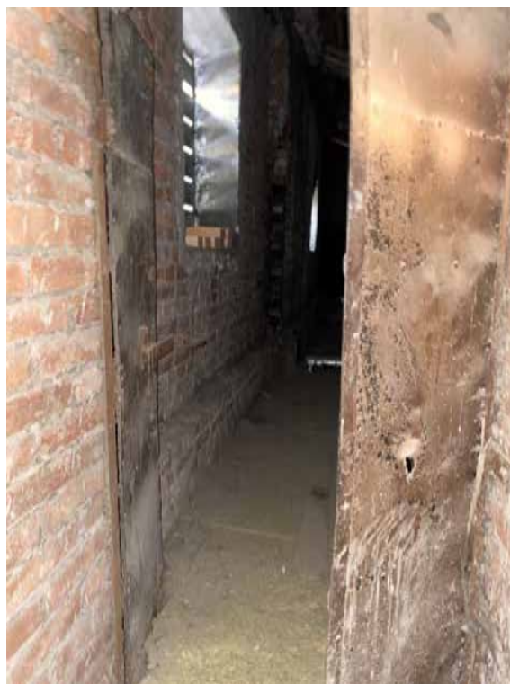
117. Вход на чердак
