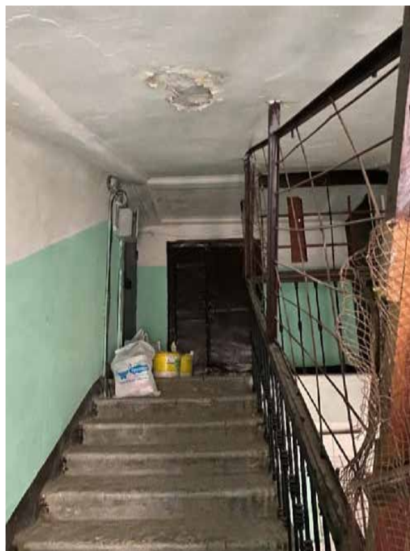
157. Лестница 8ЛК в уровне четвертого этажа
