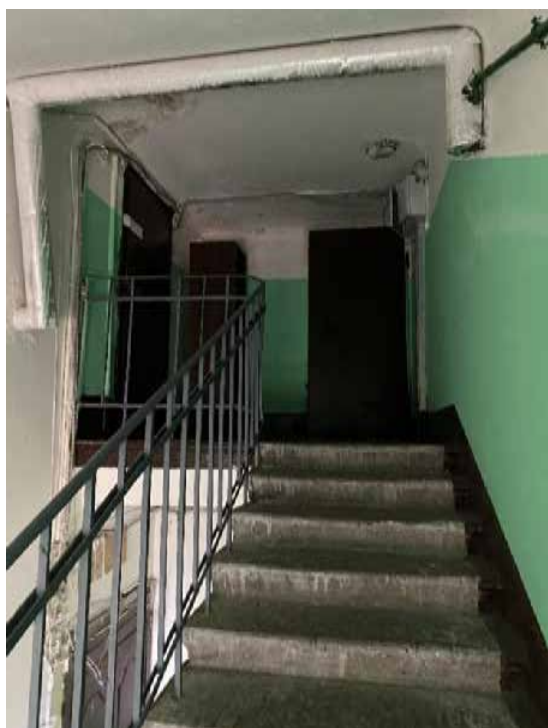
102. Лестница 3ЛК в уровне мансарды
