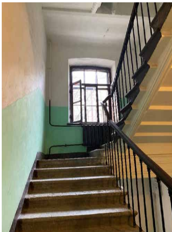
154. Лестница 8ЛК в уровне третьего этажа
