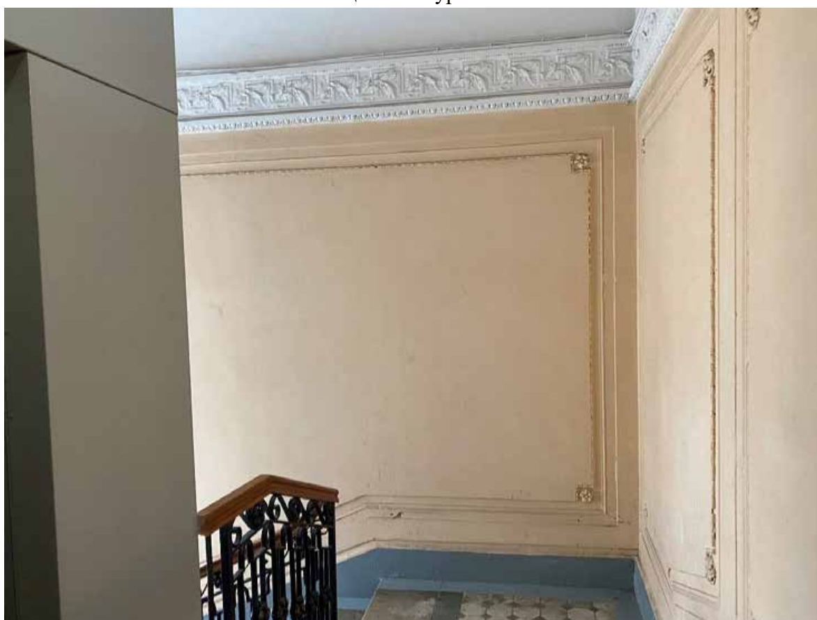
66. Лестница 1ЛК в уровне пятого этажа
