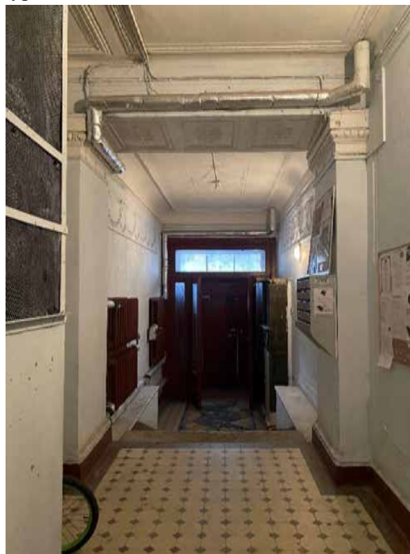
69. Вестибюль лестницы 2ЛК
