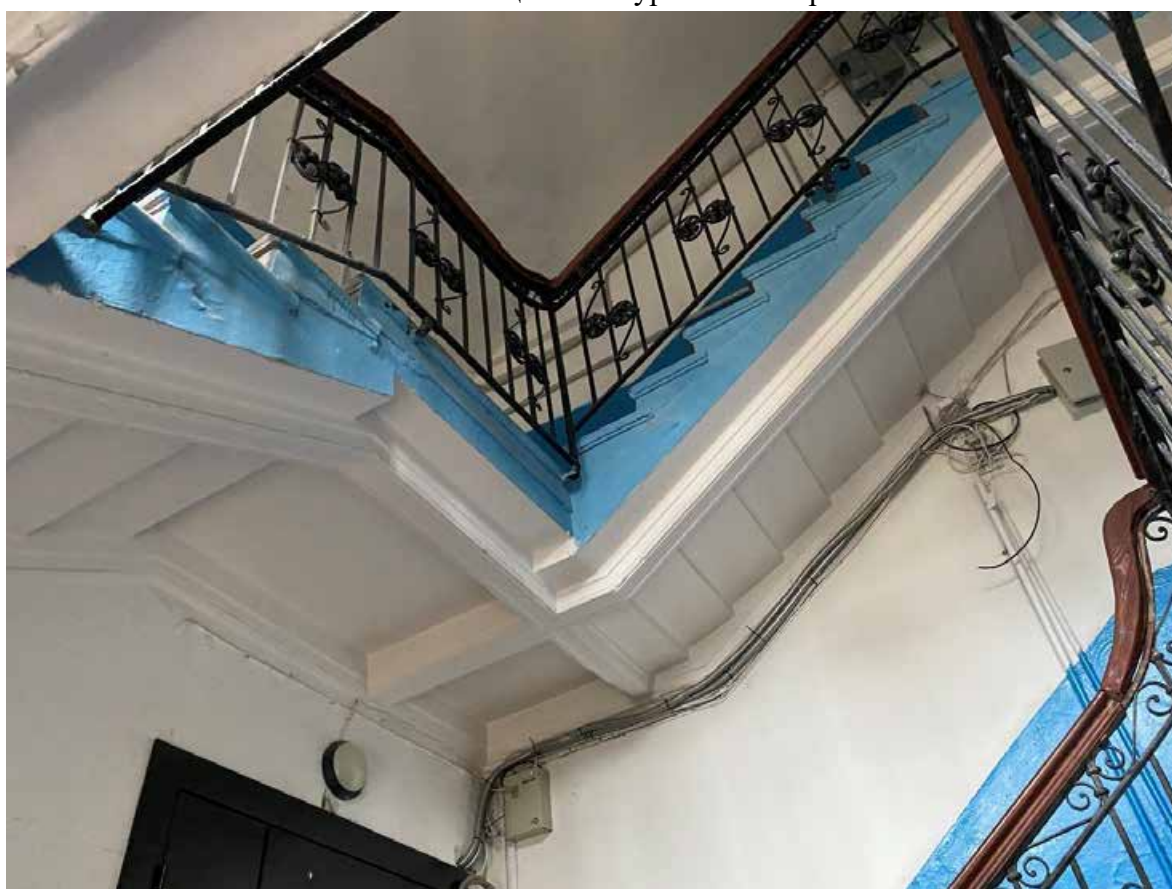
143. Лестница БЛК в уровне четвертого этажа
