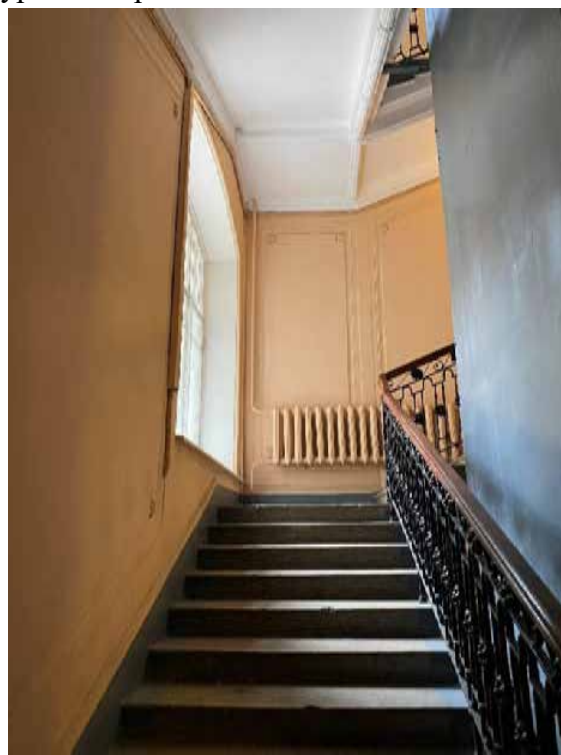
42. Лестница 1ЛК в уровне первого этажа
