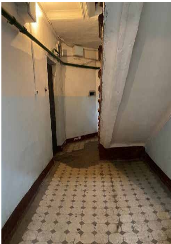
104. Лестница 4ЛК в уровне первого этажа
