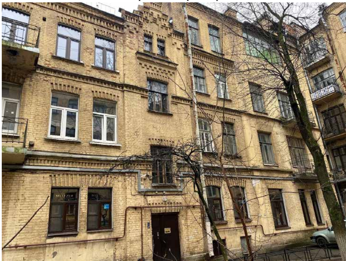
27. Фрагмент дворовых фасадов
