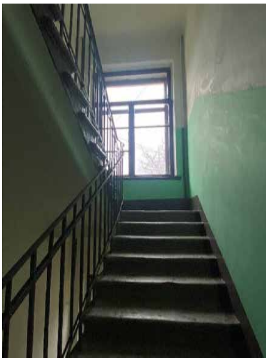
97. Лестница ЗЛК в уровне четвертого этажа
