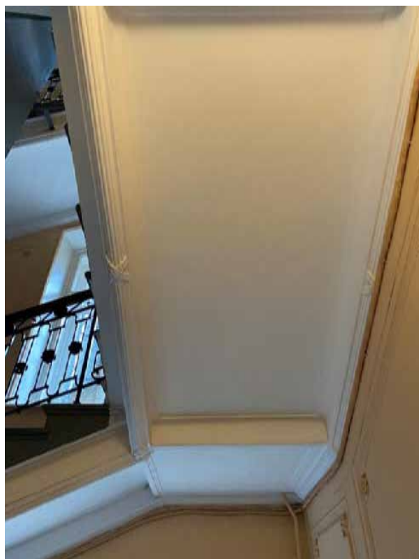
47. Лестница 1ЛК в уровне второго этажа
