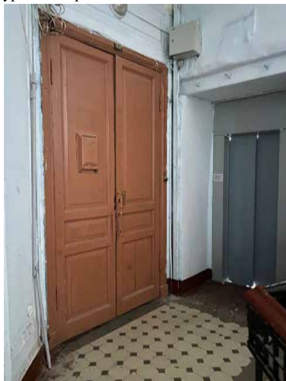
82. Лестница 2ЛК в уровне третьего этажа
