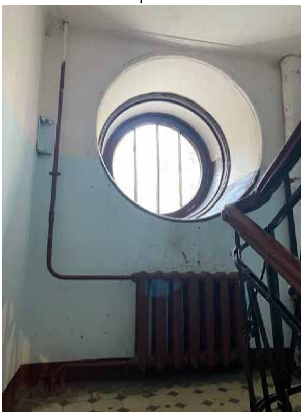
106. Лестница 4ЛК в уровне второго этажа
