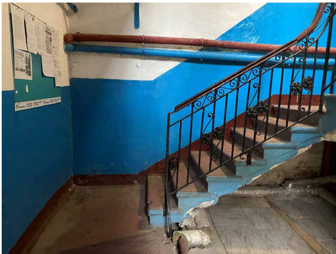
131. Лестница БЛК в уровне первого этажа
