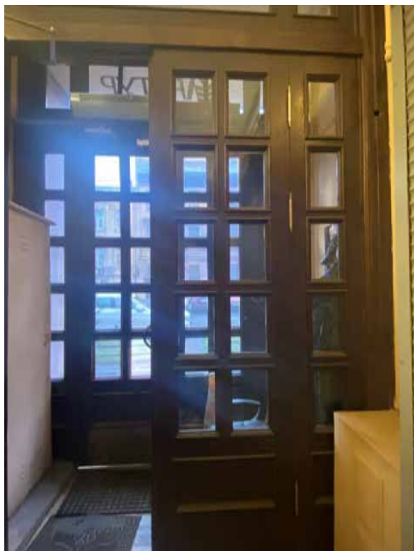
30. Тамбур лестницы 1ЛК
