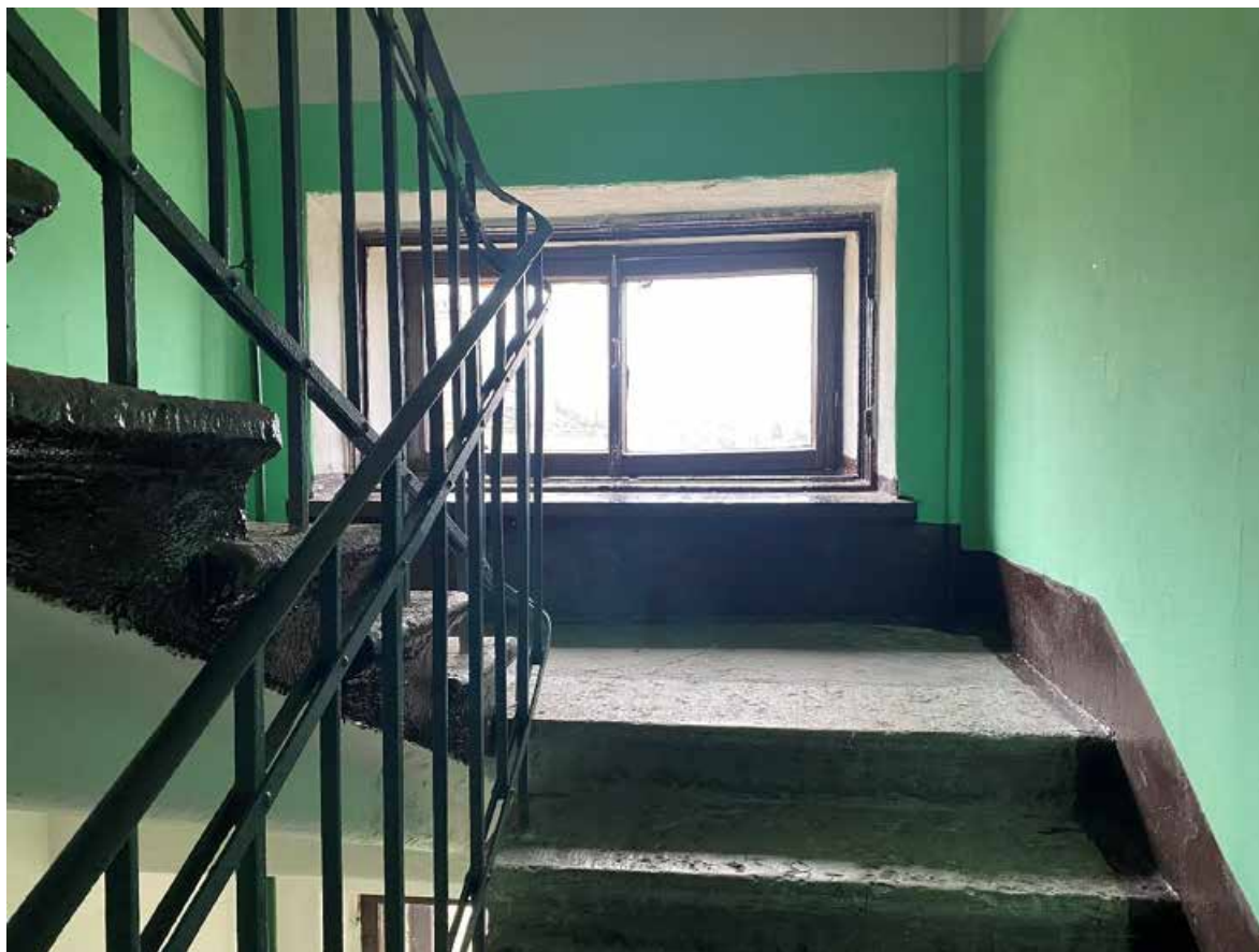
101. Лестница 3ЛК в уровне пятого этажа
