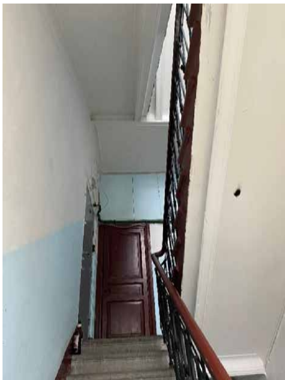
112. Лестница 4ЛК в уровне четвертого этажа
