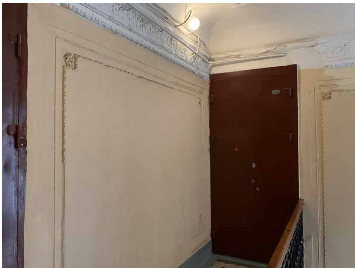
65. Лестница 1ЛК в уровне пятого этажа
