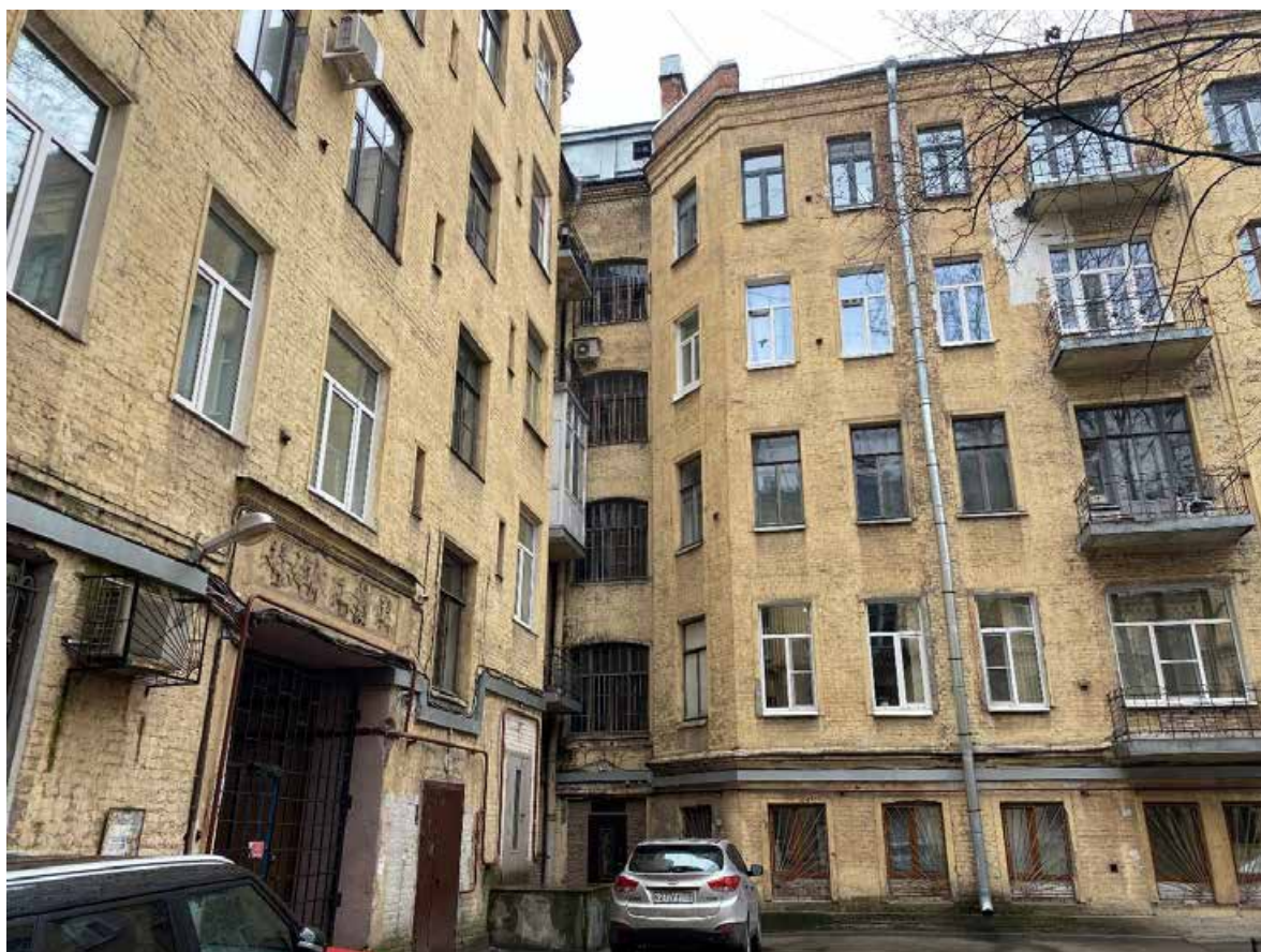
18. Фрагмент дворовых фасадов
