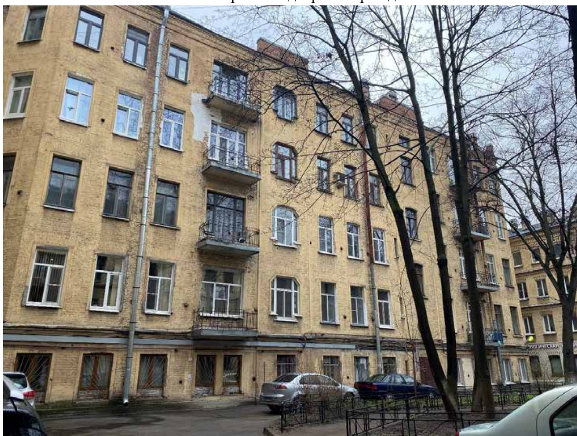
19. Фрагмент дворовых фасадов
