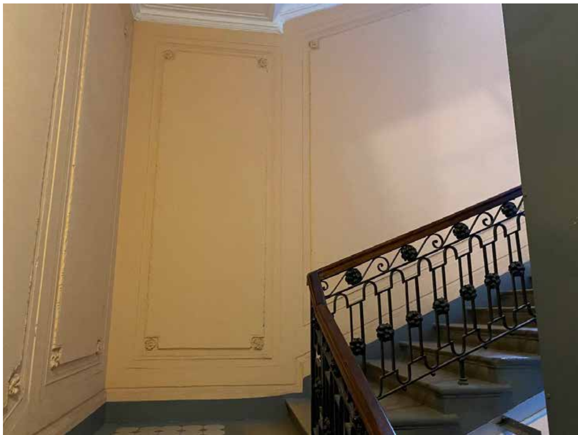
49. Лестница 1ЛК в уровне второго этажа
