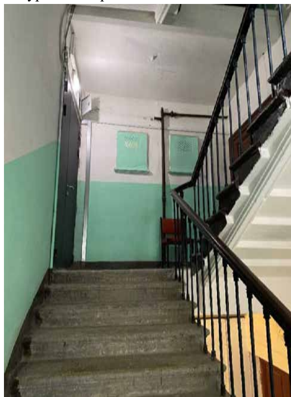
155. Лестница 8ЛК в уровне третьего этажа
