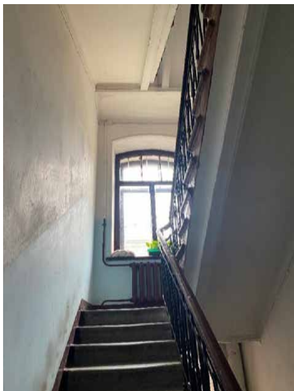
108. Лестница 4ЛК в уровне третьего этажа
