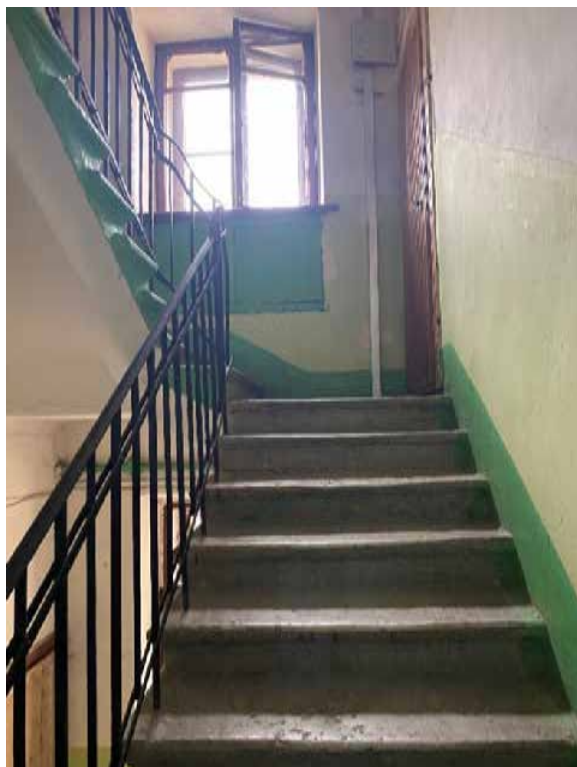
123. Лестница 5ЛК в уровне третьего этажа
