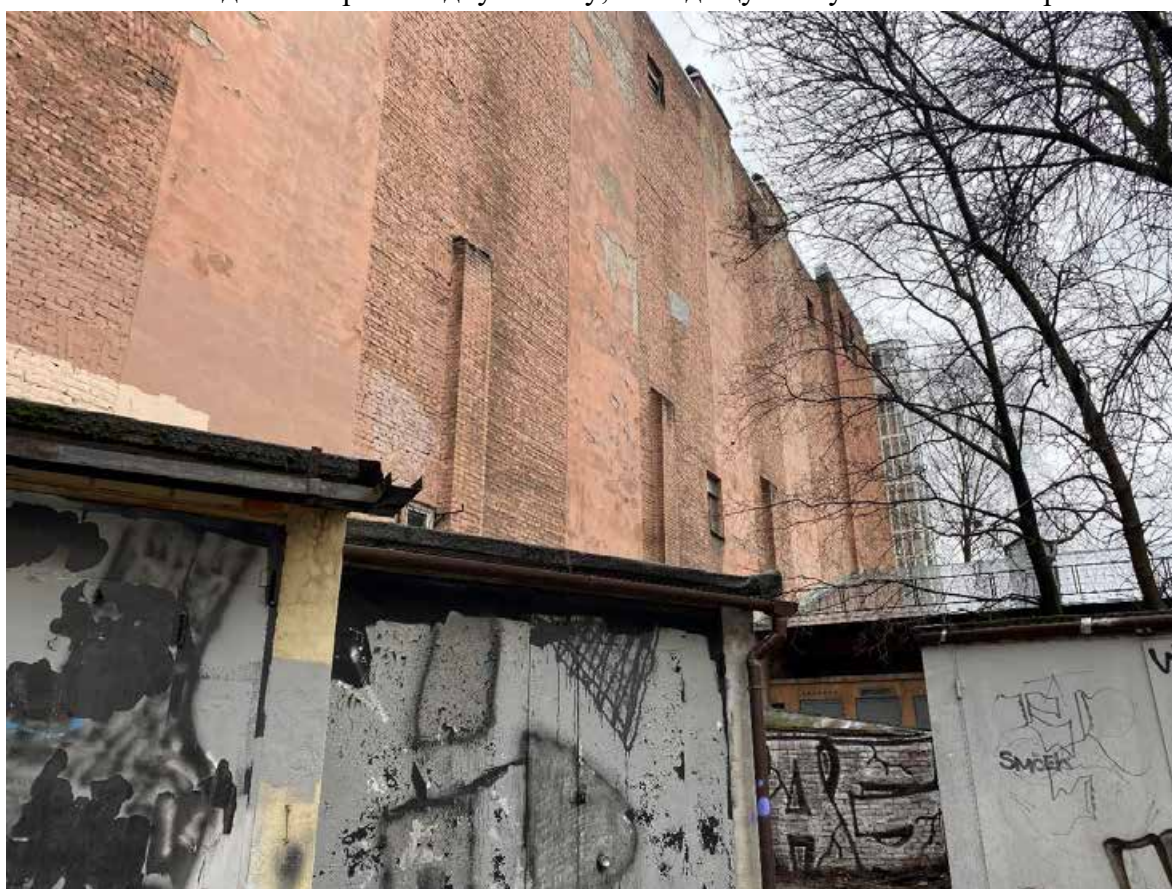
13. Вид на северо-западную стену, выходящую на участок 37 литера Б
