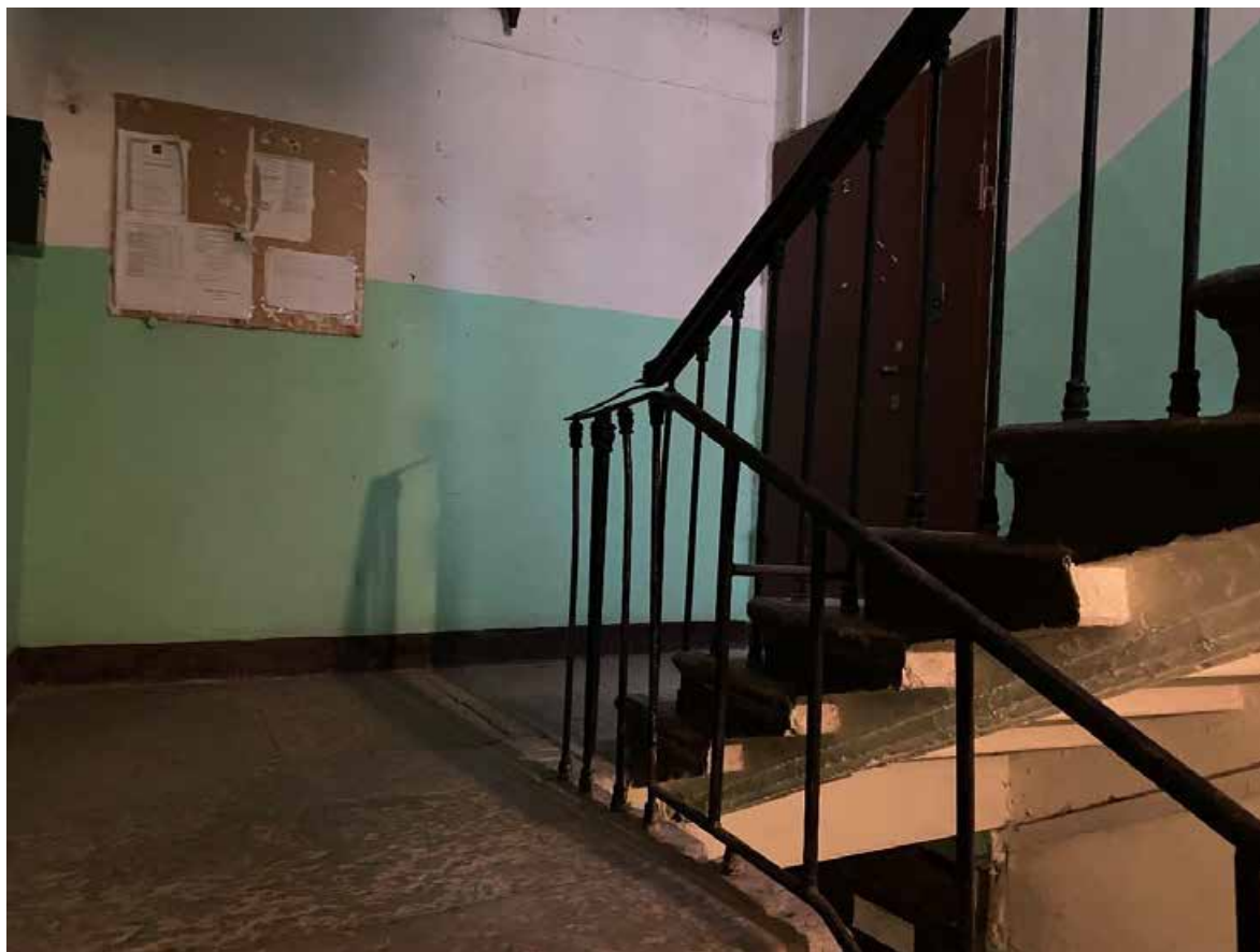
151. Лестница 8ЛК в уровне первого этажа
