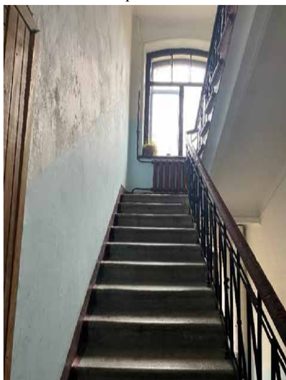
110. Лестница 4ЛК в уровне четвертого этажа
