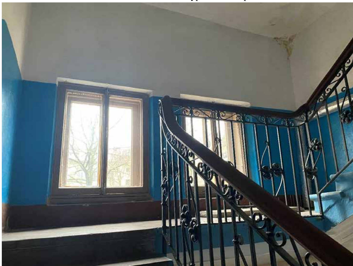
145. Лестница БЛК в уровне чердака
