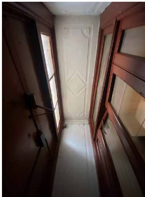
74. Тамбур лестницы 2ЛК
