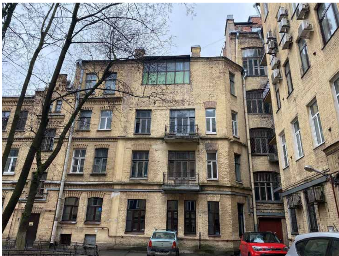
20. Фрагмент дворовых фасадов
