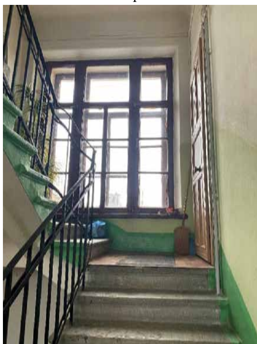
129. Лестница 5ЛК в уровне пятого этажа
