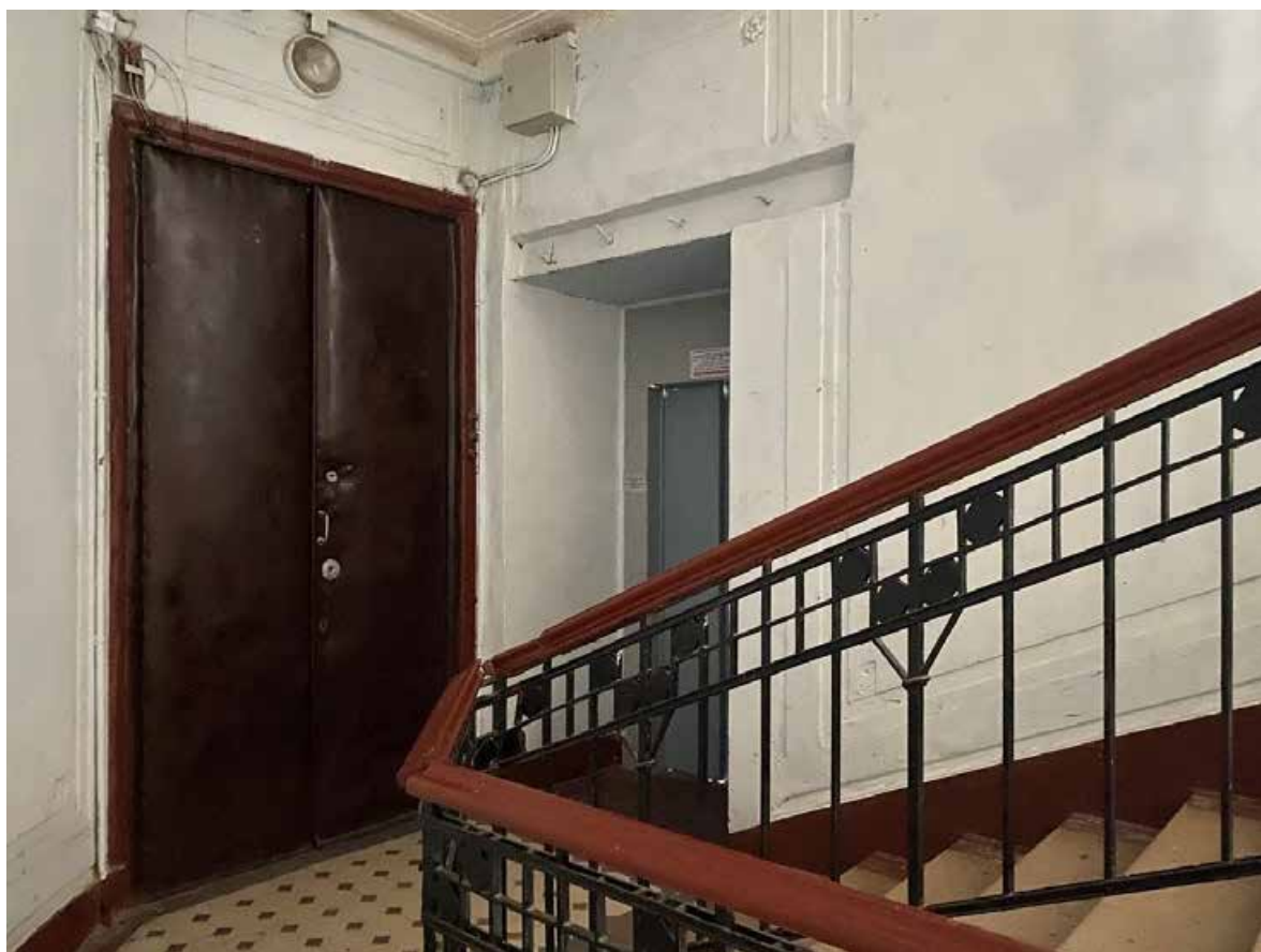
80. Лестница 2ЛК в уровне второго этажа
