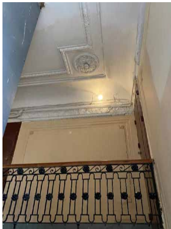
62. Лестница 1ЛК в уровне пятого этажа
