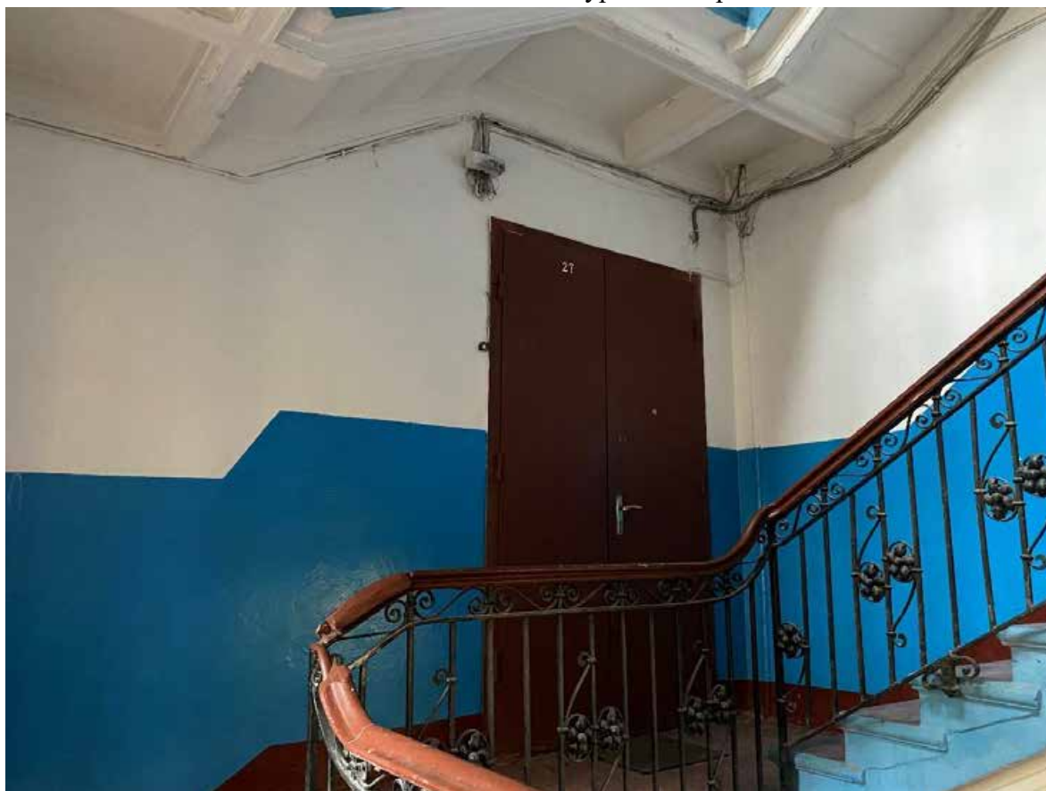
134. Лестница БЛК в уровне второго этажа
