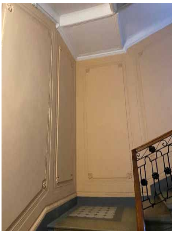
53. Лестница 1ЛК в уровне третьего этажа
