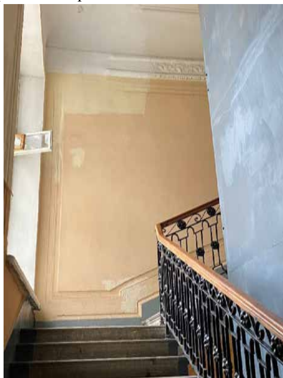
60. Лестница 1ЛК в уровне четвертого этажа
