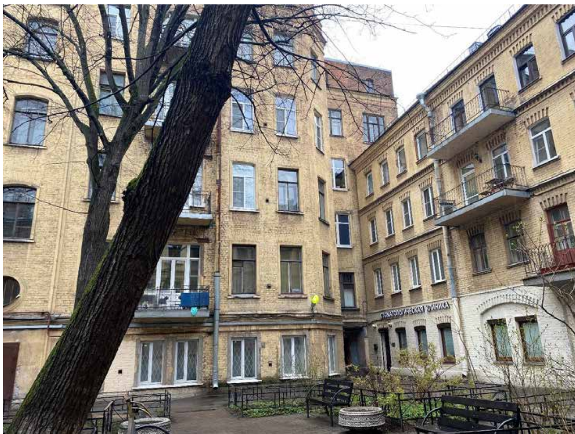
24. Фрагмент дворовых фасадов
