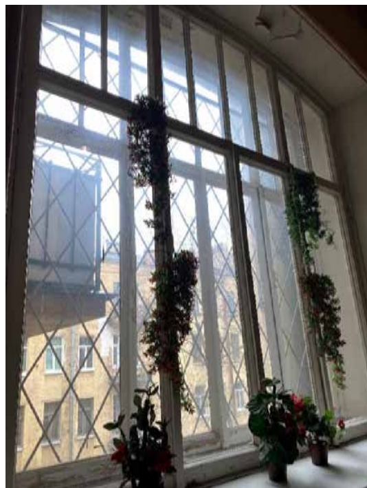
56. Оконный проем на лестнице 1ЛК
