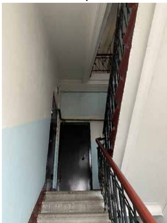
114. Лестница 4ЛК в уровне пятого этажа
