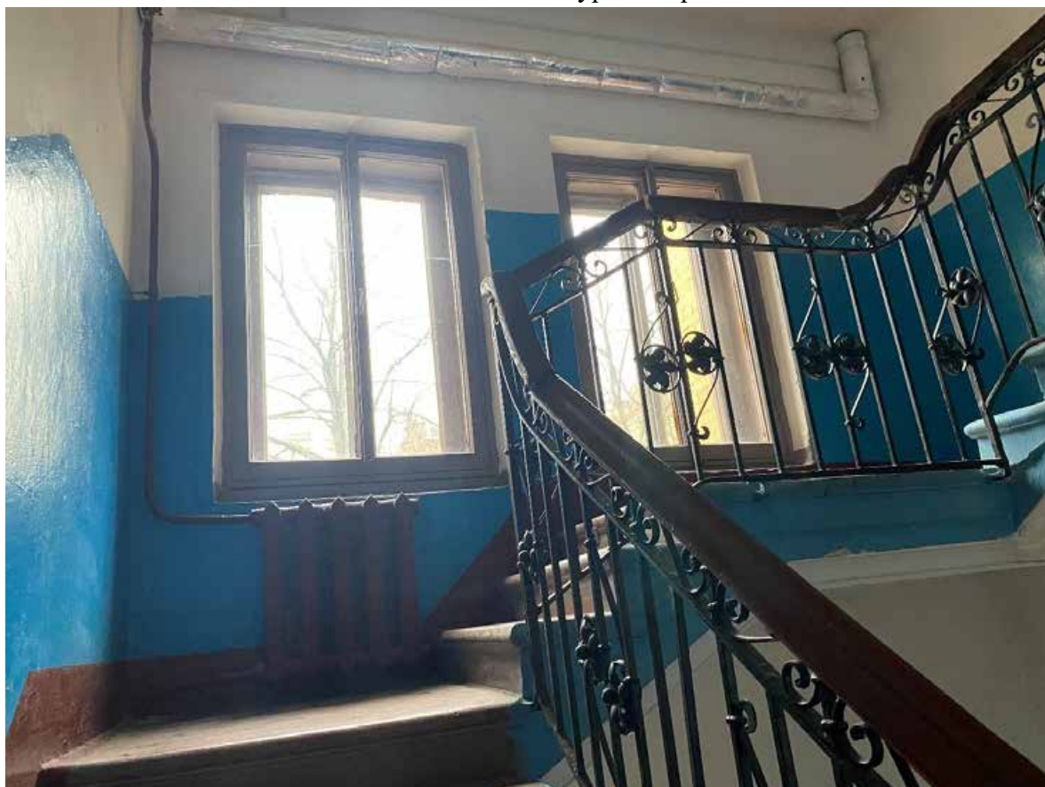
141. Лестница БЛК в уровне четвертого этажа
