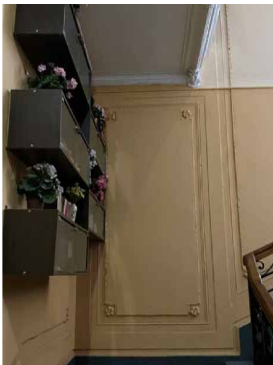
59. Лестница 1ЛК в уровне четвертого этажа
