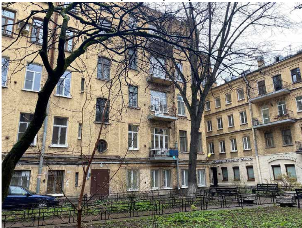
23. Фрагмент дворовых фасадов
