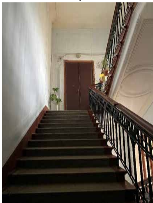
85. Лестница 2ЛК в уровне пятого этажа
