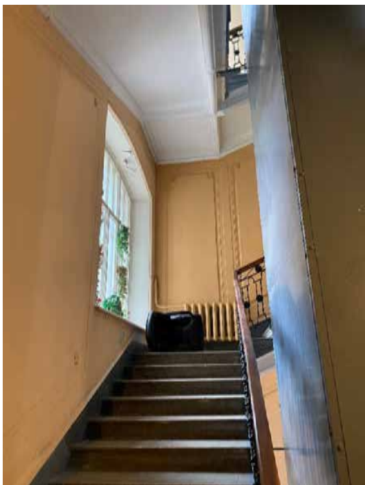
55. Лестница 1ЛК в уровне третьего этажа
