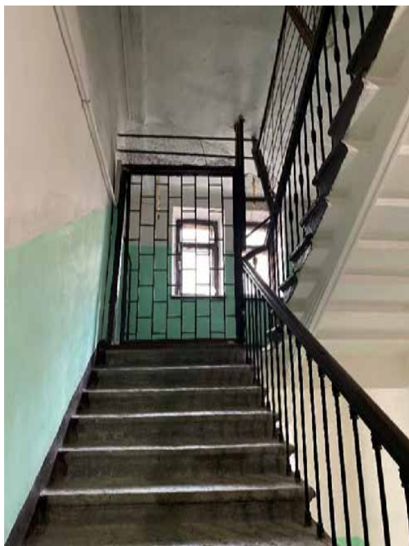
156. Лестница 8ЛК в уровне четвертого этажа
