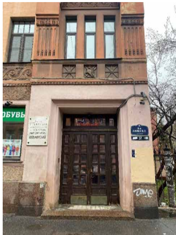
5. Вход на лестницу 1ЛК
