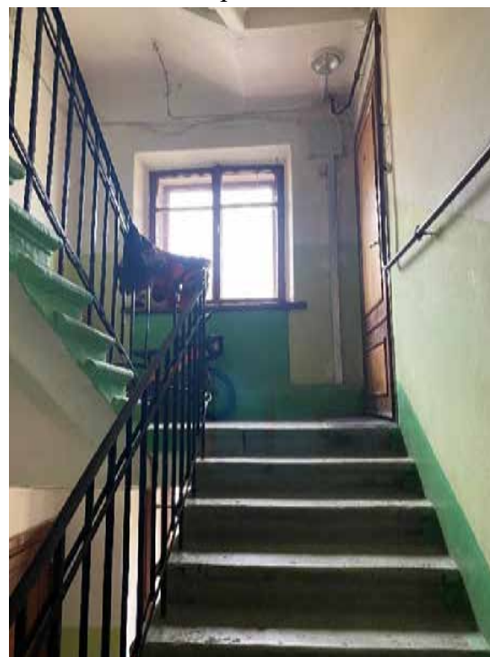
126. Лестница 5ЛК в уровне четвертого этажа
