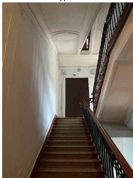
76. Лестница 2ЛК в уровне второго этажа
