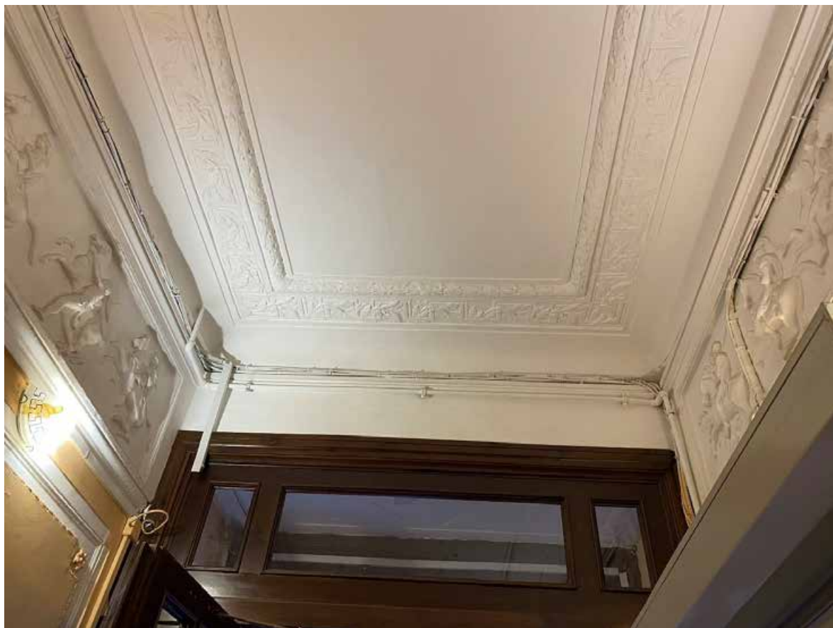
33. Потолок вестибюля 1ЛК
