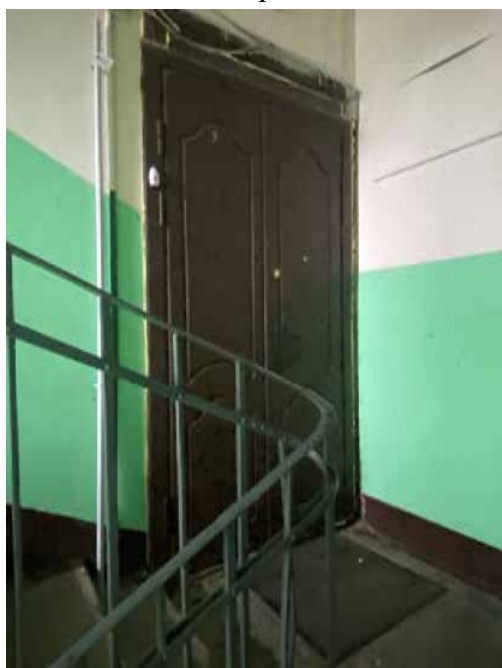
99. Лестница ЗЛК в уровне пятого этажа
