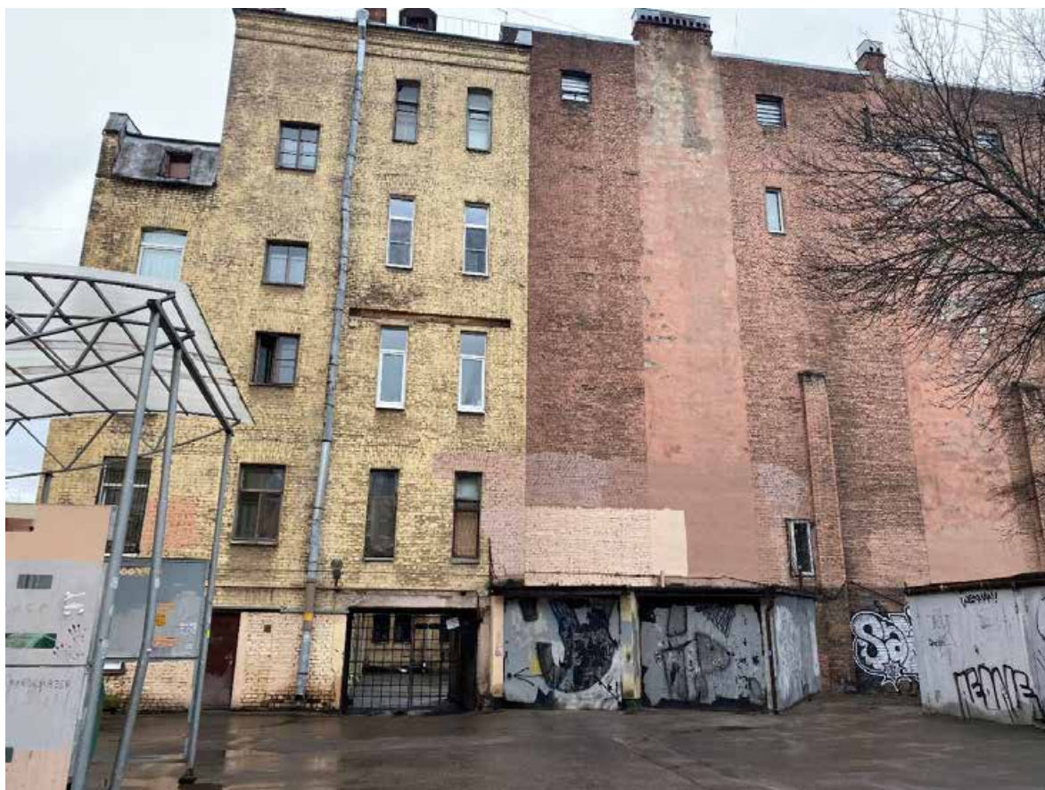
12. Вид на северо-западную стену, выходящую на участок 37 литера Б
