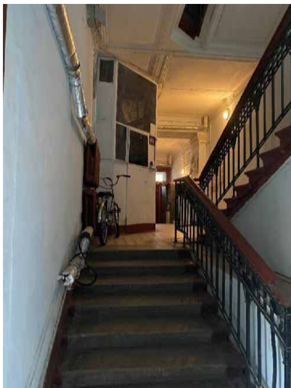
68. Лестница 2ЛК в уровне первого этажа
