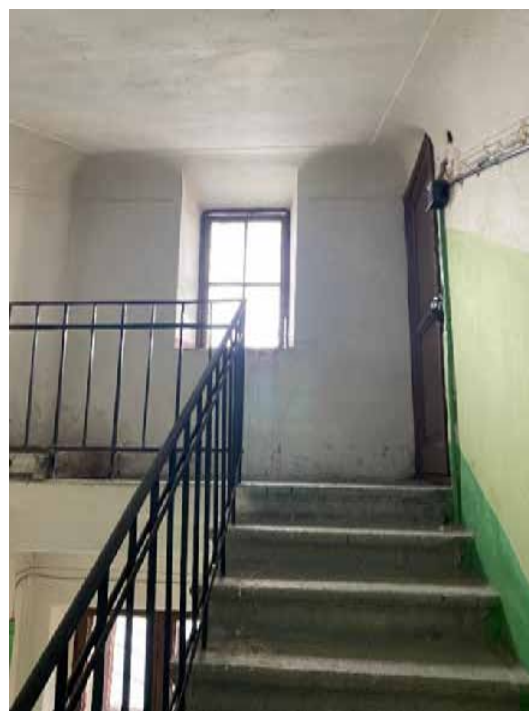
130. Лестница 5ЛК в уровне чердака
