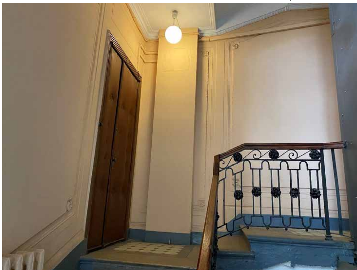
45. Лестница 1ЛК в уровне второго этажа
