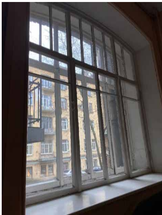
43. Оконный проем на лестнице 1ЛК
