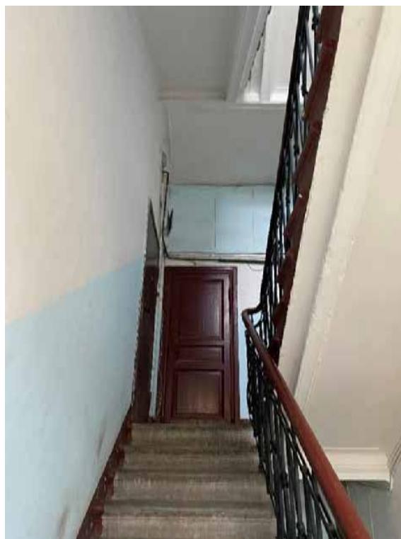
109. Лестница 4ЛК в уровне третьего этажа
