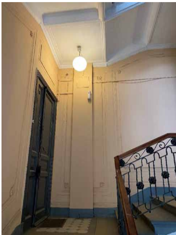
51. Лестница 1ЛК в уровне третьего этажа
