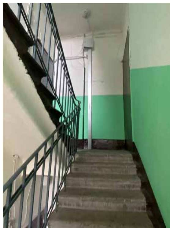
96. Лестница ЗЛК в уровне четвертого этажа
