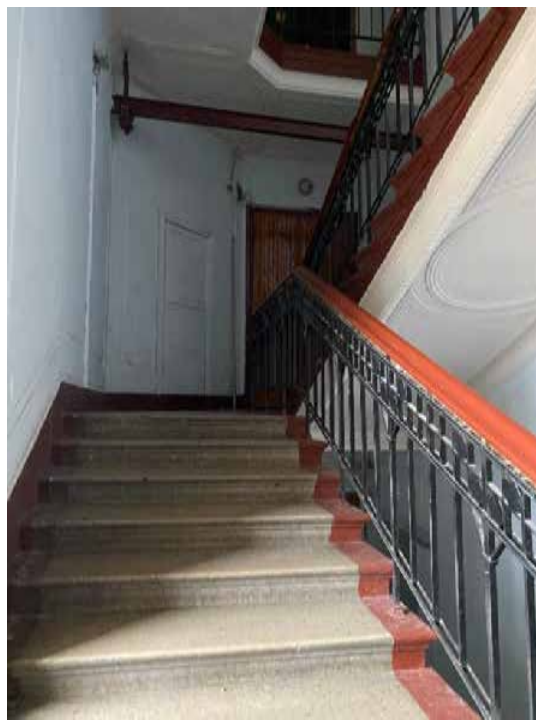
84. Лестница 2ЛК в уровне четвертого этажа
