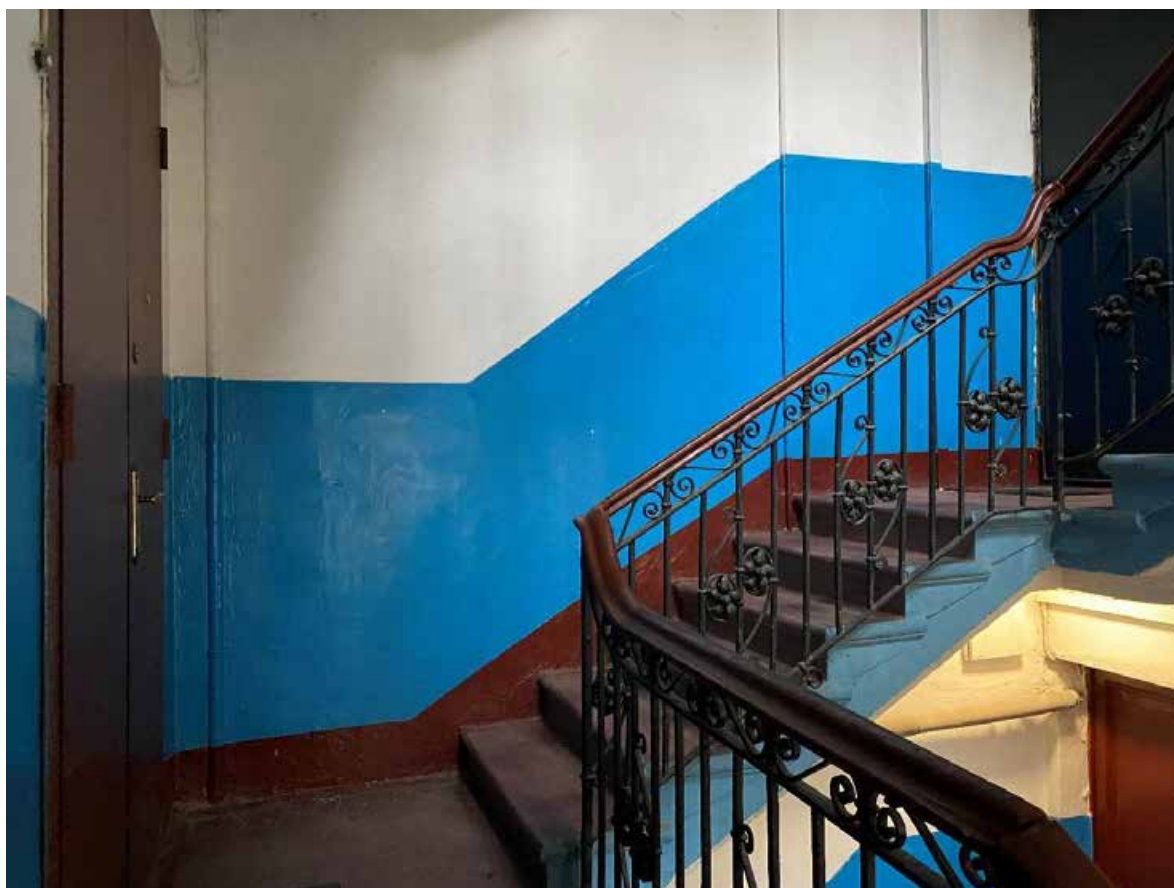
135. Лестница БЛК в уровне второго этажа
