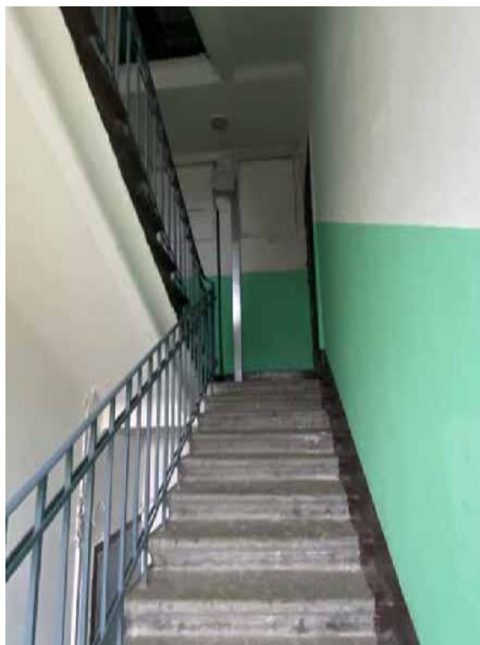
98. Лестница ЗЛК в уровне пятого этажа
