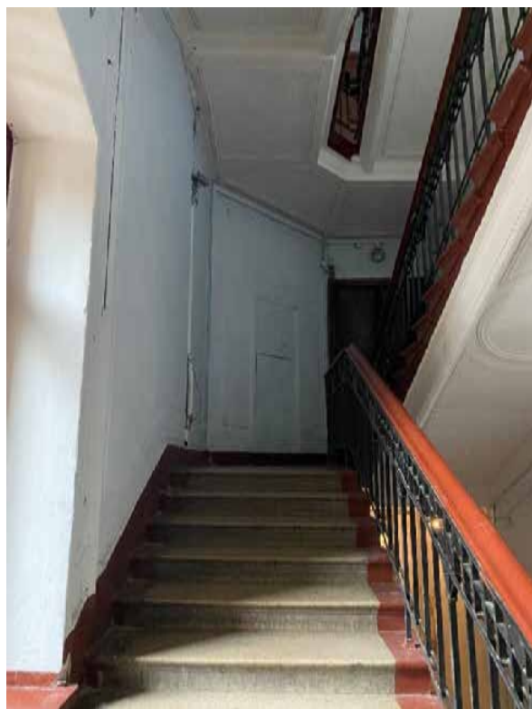
78. Лестница 2ЛК в уровне второго этажа
