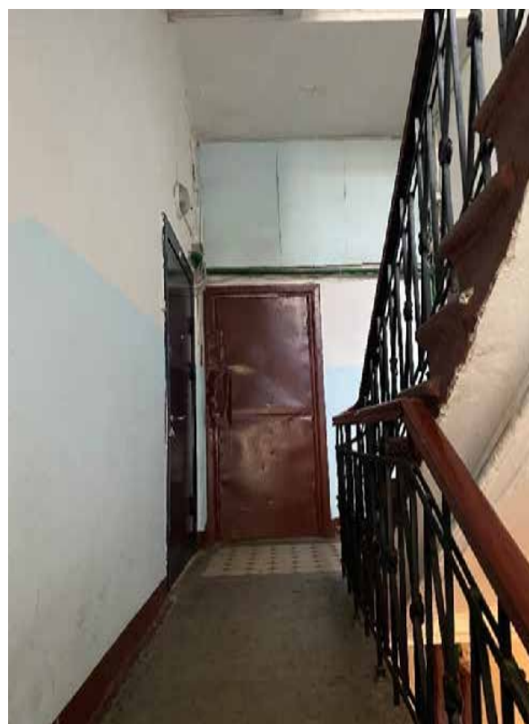
107. Лестница 4ЛК в уровне второго этажа
