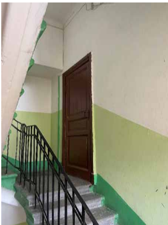
127. Лестница 5ЛК в уровне четвертого этажа
