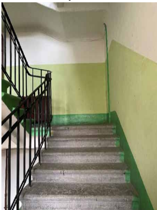
125. Лестница 5ЛК в уровне третьего этажа
