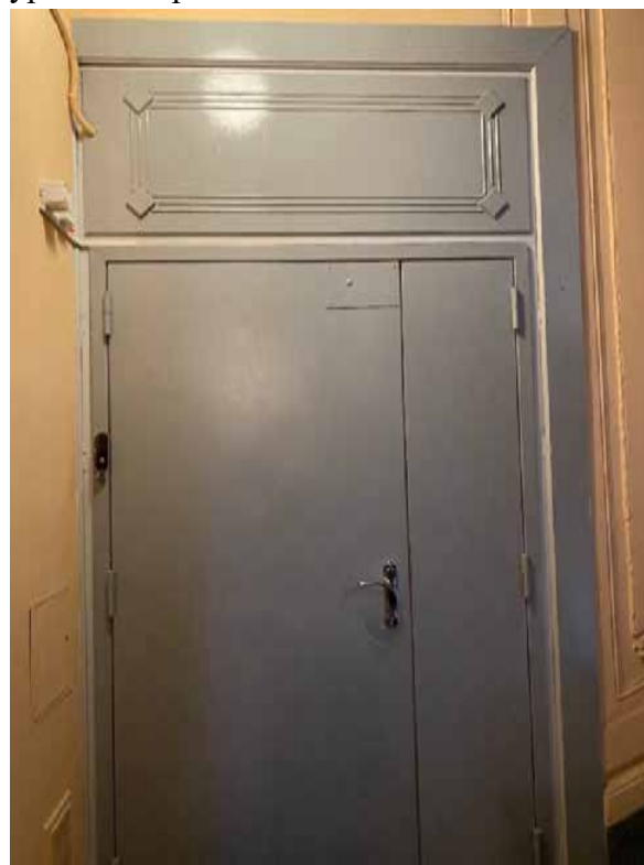
48. Дверь в помещение 10-Н
