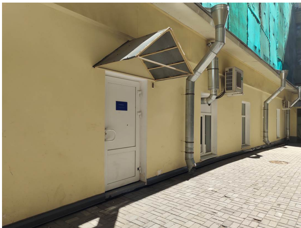
8. Выявленный ОКН «Склады торгового дома «Братья Елисеевы»» (здание ГОИ им. С.И. Вавилова). Первый этаж.
