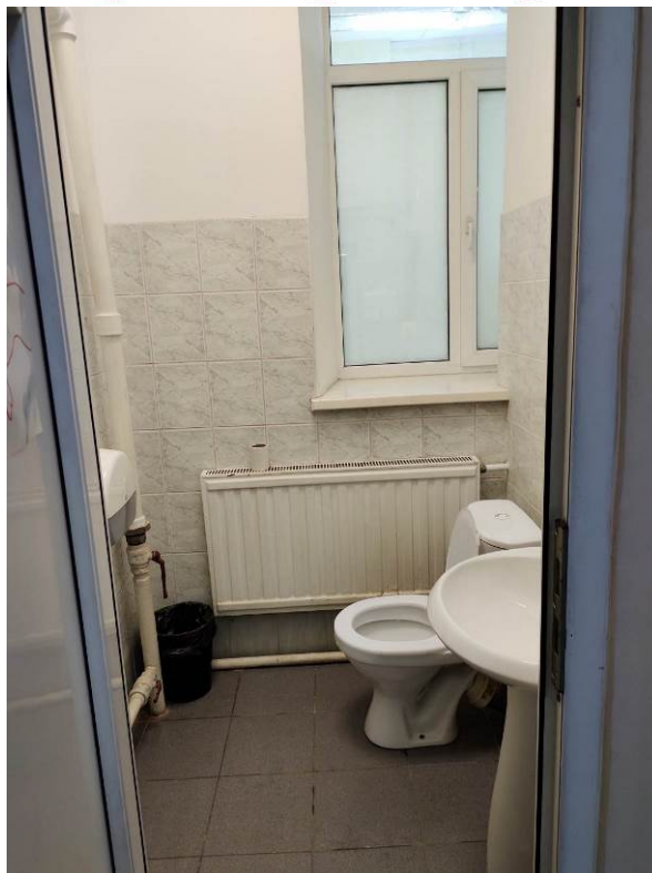
14. Выявленный ОКН «Склады торгового дома «Братья Елисеевы»» (здание ГОИ им. С.И. Вавилова). Первый этаж.
