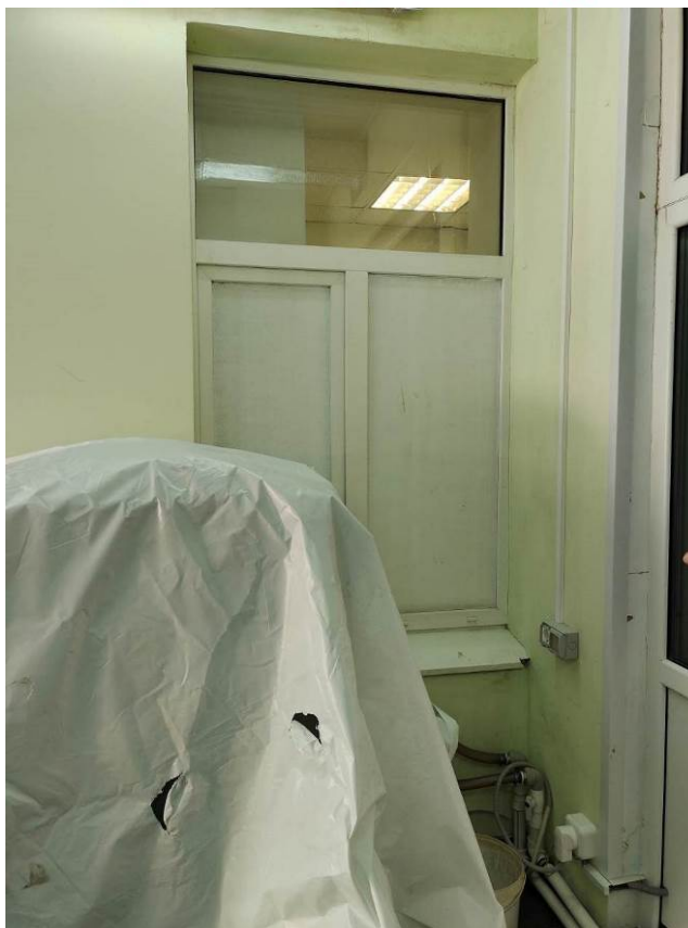
12. Выявленный ОКН «Склады торгового дома «Братья Елисеевы»» (здание ГОИ им. С.И. Вавилова). Первый этаж.
