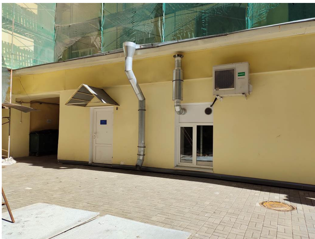
4. Выявленный ОКН «Склады торгового дома “Братья Елисеевы”» (здание ГОИ им. С.И. Вавилова).
