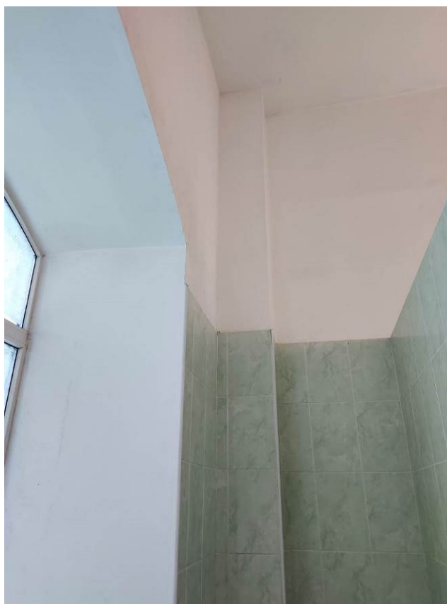
17. Выявленный ОКН «Склады торгового дома «Братья Елисеевы»» (здание ГОИ им. С.И. Вавилова). Второй этаж.
