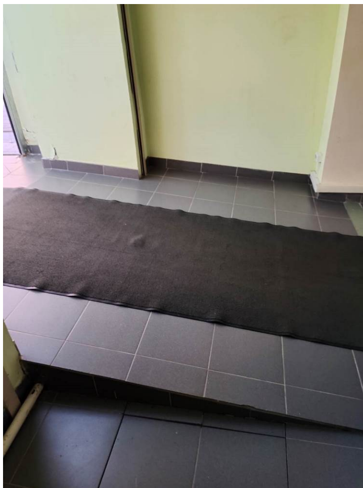
13. Выявленный ОКН «Склады торгового дома «Братья Елисеевы»» (здание ГОИ им. С.И. Вавилова). Первый этаж.
