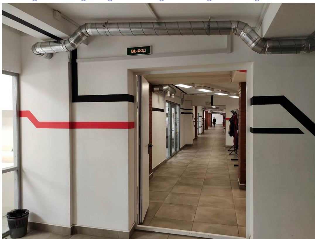
32. Выявленный ОКН «Склады торгового дома «Братья Елисеевы»» (здание ГОИ им. С.И. Вавилова). Мансардный этаж.
