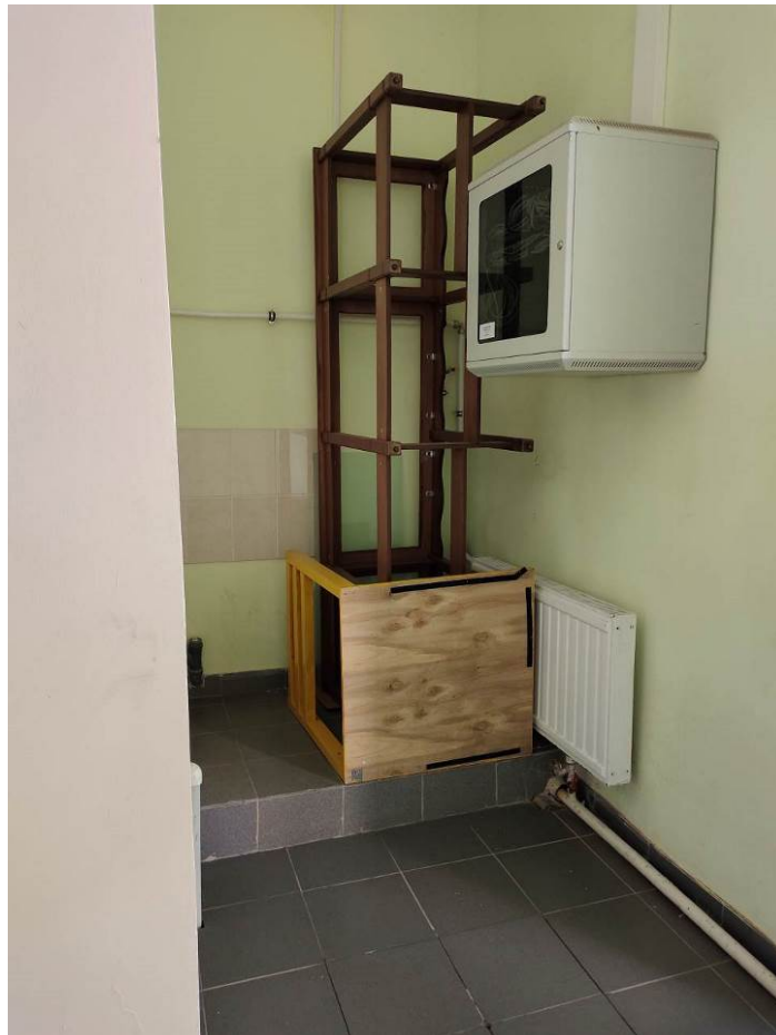
11. Выявленный ОКН «Склады торгового дома “Братья Елисеевы”» (здание ГОИ им. С.И. Вавилова). Первый этаж.
