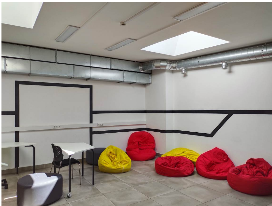
29. Выявленный ОКН «Склады торгового дома «Братья Елисеевы»» (здание ГОИ им. С.И. Вавилова). Мансардный этаж.
