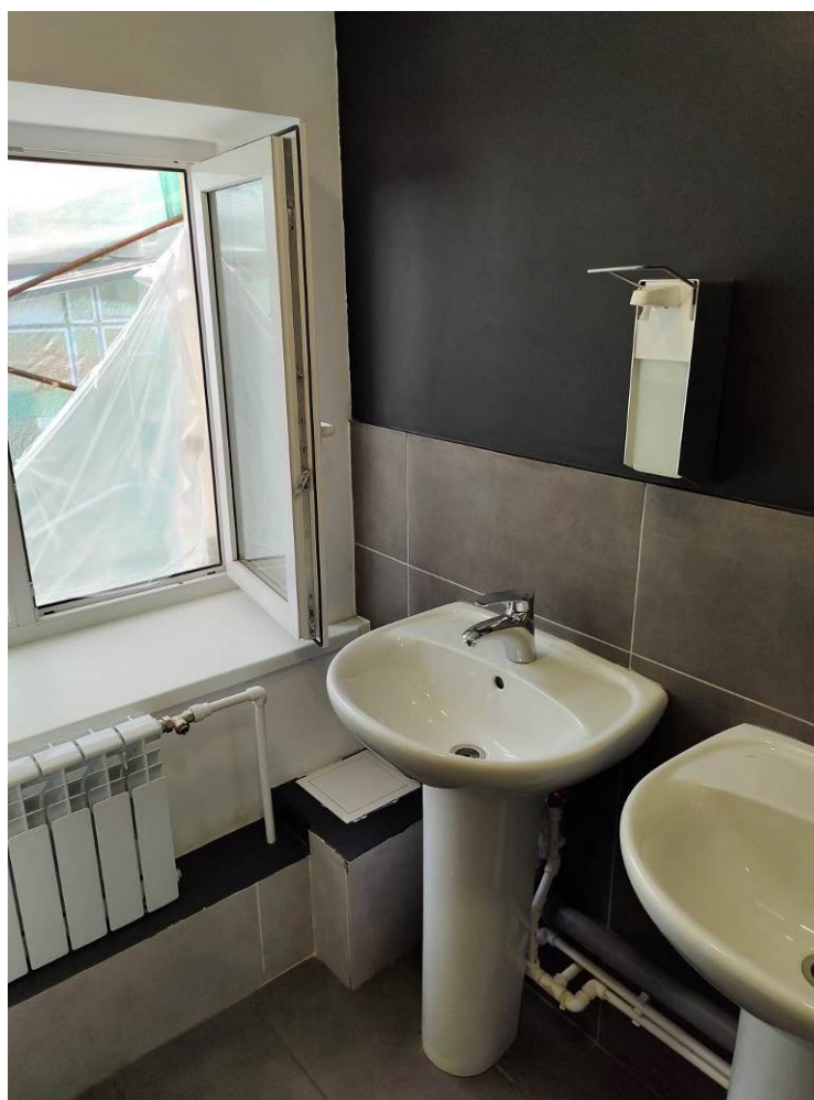
30. Выявленный ОКН «Склады торгового дома «Братья Елисеевы»» (здание ГОИ им. С.И. Вавилова). Мансардный этаж.
