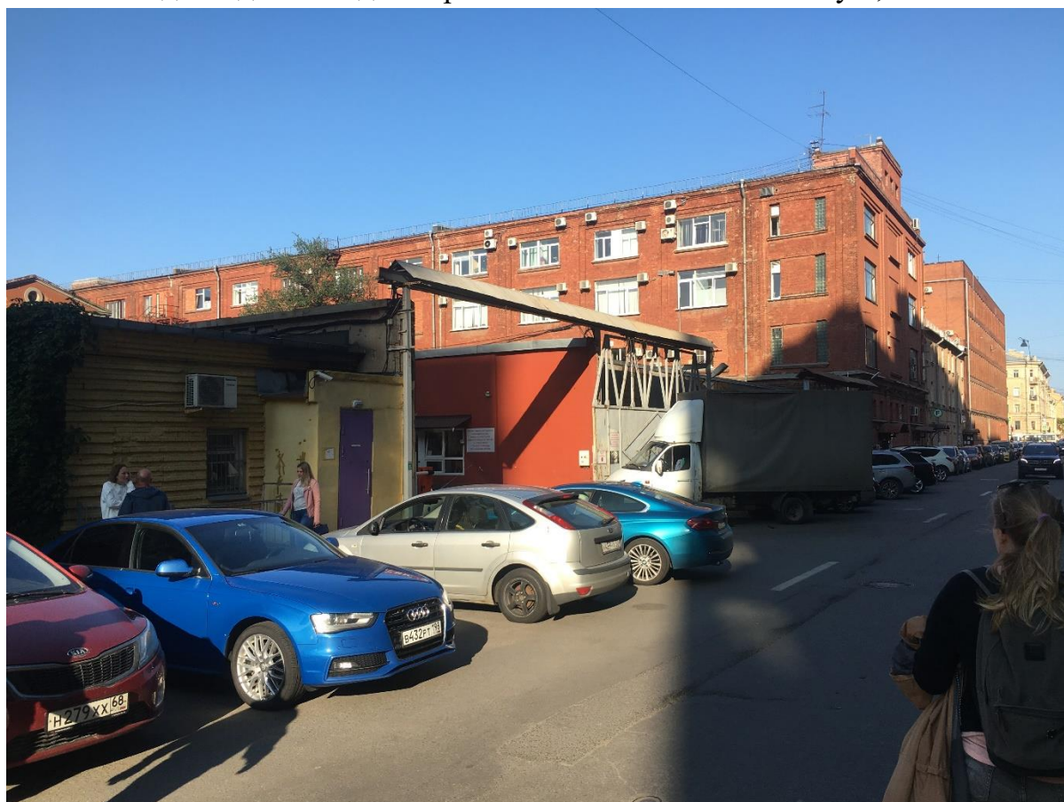
Фото 2. Вид на здания под литерами ББ и БВ по Заставской ул., 33 с запада.
