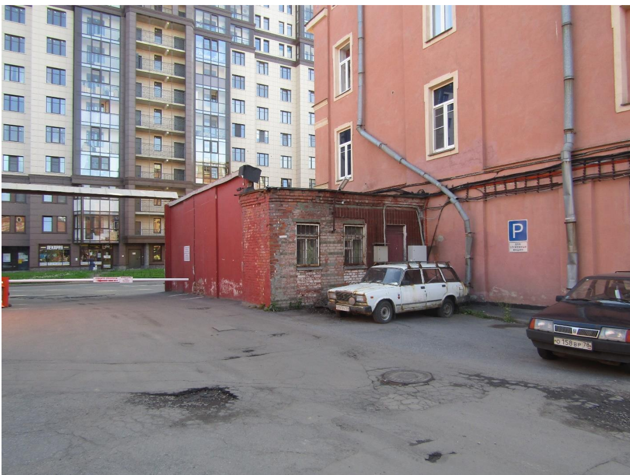
Фото 3. Вид на здание под литерой БВ по Заставской ул., 33 с северо-востока.
