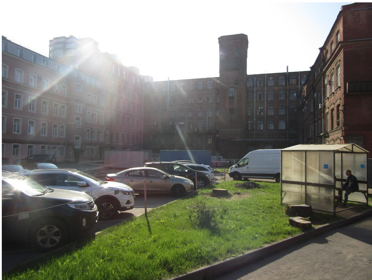
Фото 11. Вид на участок в границах проектирования с северо-востока.
