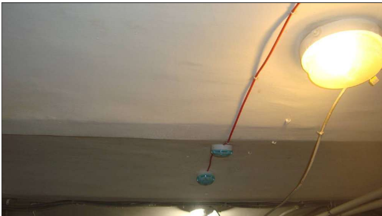
11. Подвальная часть помещения 1-Н. Прусские сводики по металлическим балкам*.
