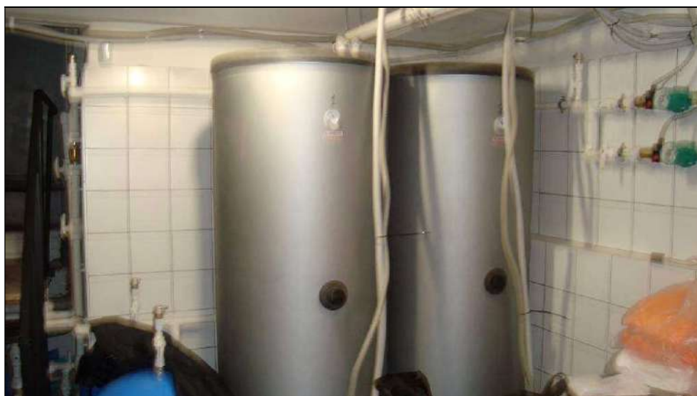
7. Подвальная часть помещения 1-Н. Накопительный блок ГВС.
