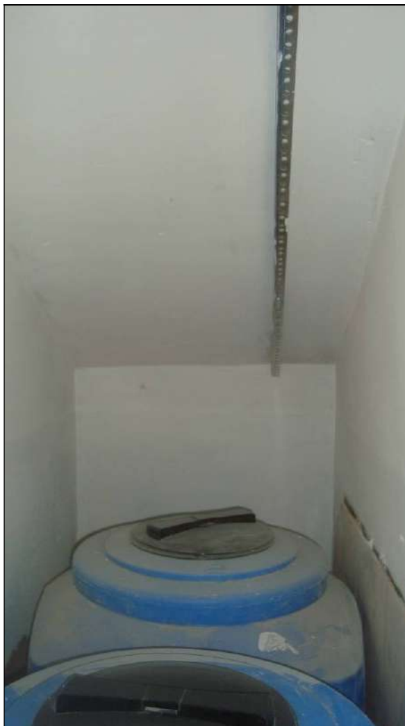
6. Подвальная часть помещения 1-Н. Накопительный блок ХВС.
