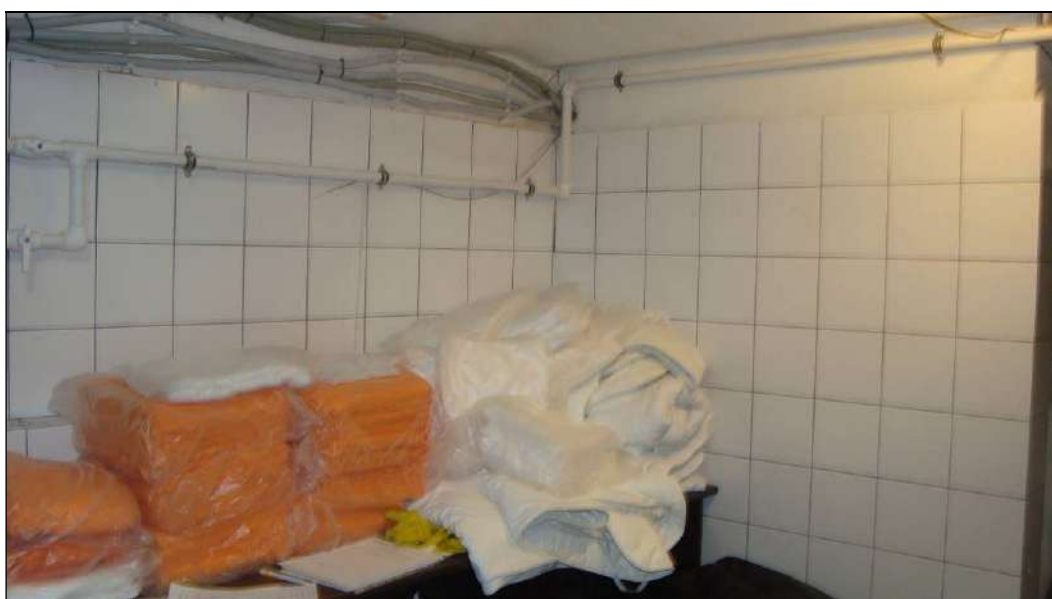
9. Подвальная часть помещения 1-Н. Общий вид на стену по оси «Б».
